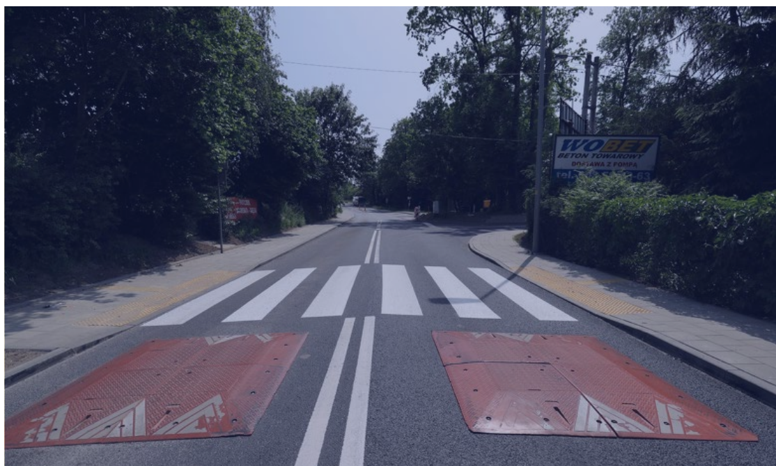
ryc. 11. Ulica Niepołomicka po remoncie; fot. Grzegorz Mehring /gdansk.pl
