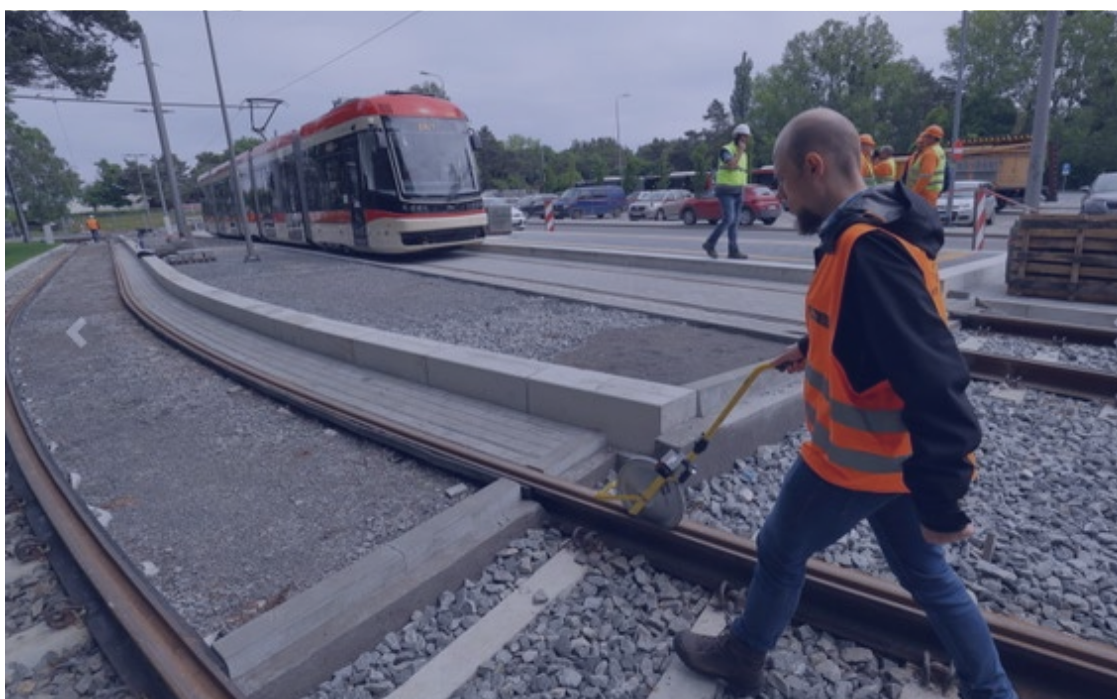
ryc. 7. Przebudowa linii tramwajowej na Stogi; fot. Grzegorz Mehring /gdansk.pl
