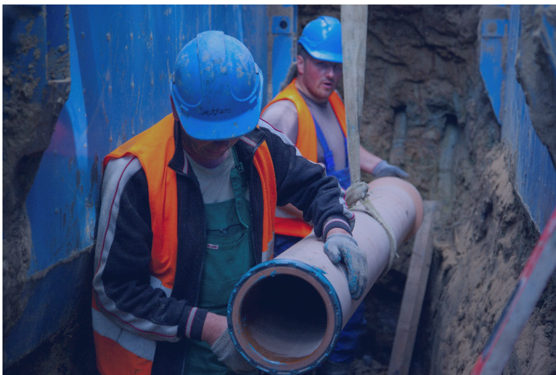
ryc. 10. Budowa kanalizacji sanitarnej w ramach „Gdańskiego projektu wodno-ściekowego”; fot. Gdańska Infrastruktura Wodociągowo-Kanalizacyjna Sp. z o.o.
