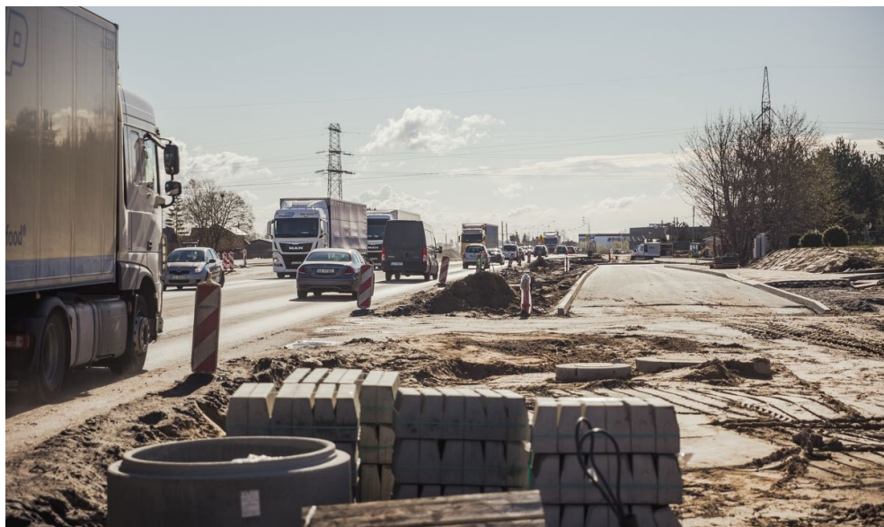
Zakres prac obejmuje budowę dwóch pasów jezdni w każdym kierunku
