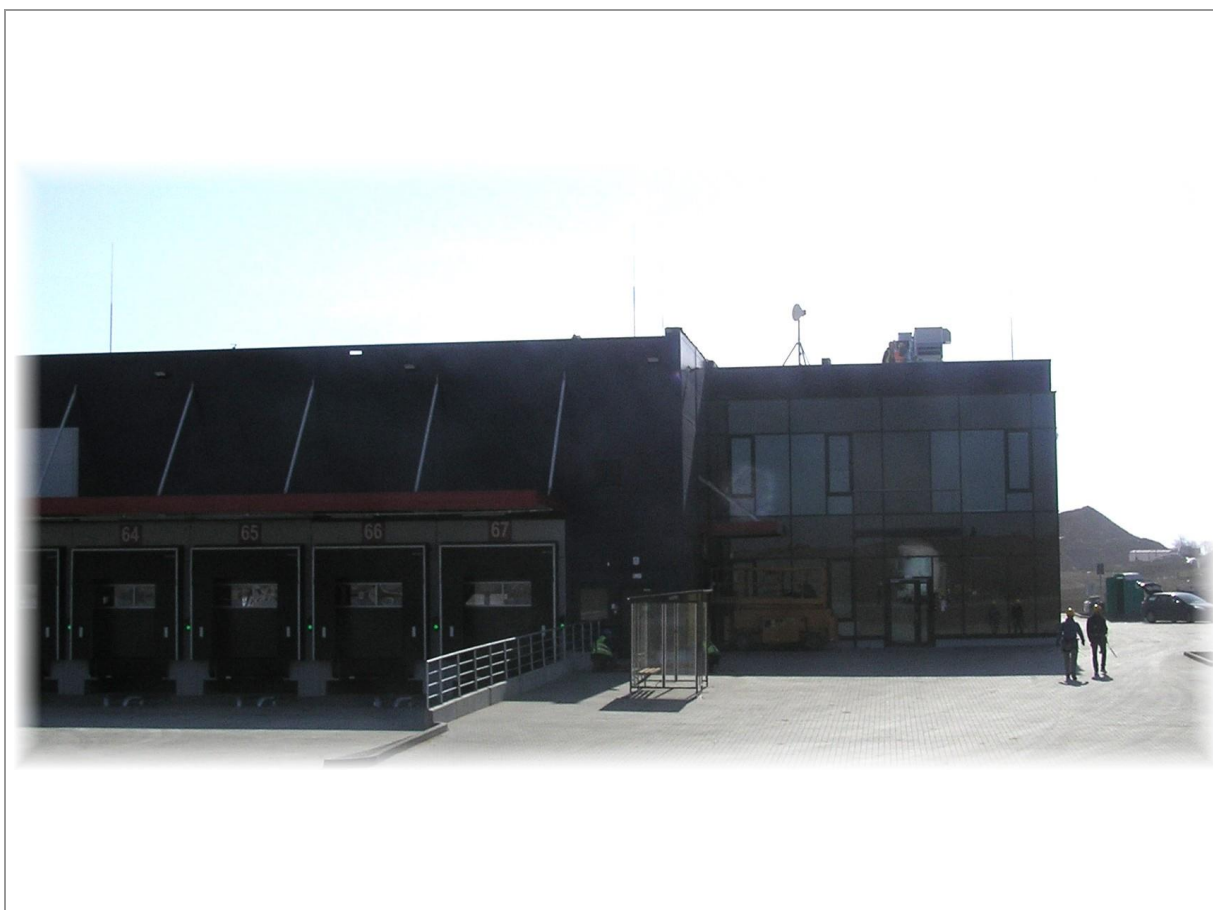
Fot. 1. OM Gdańsk / Bysewo - DPD – widok anteny linii radiowej na dachu budynku
