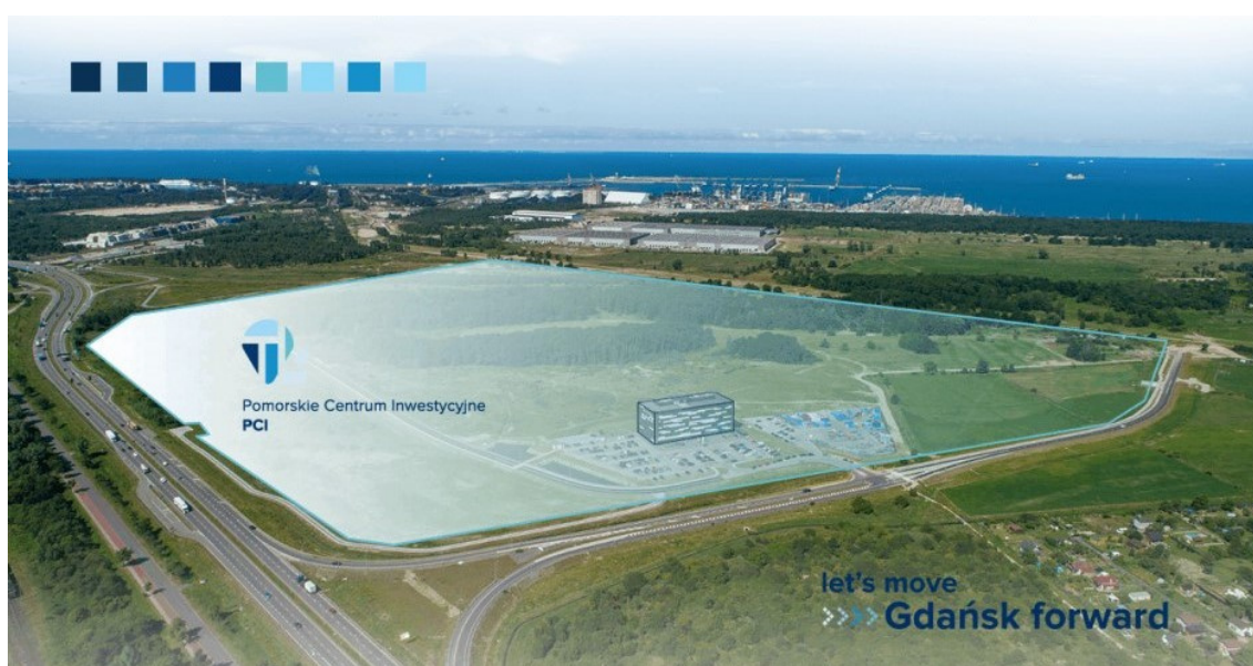
ryc.1. Obszar Pomorskiego Centrum Inwestycyjnego (PCI). Mat. GARG
