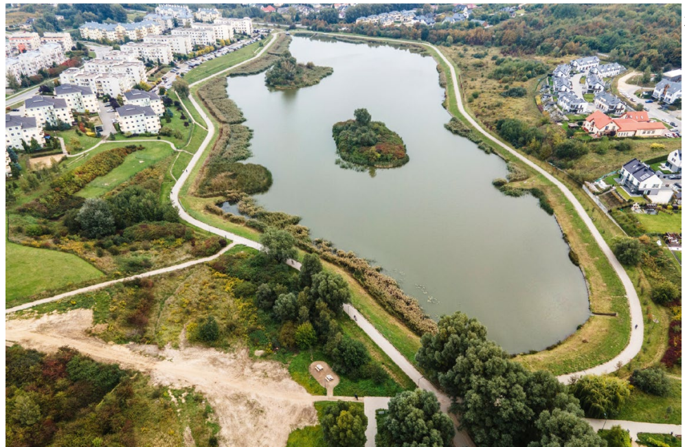
Zbiornik retencyjny Świętokrzyska I na terenach, na których powstanie Park Południowy
