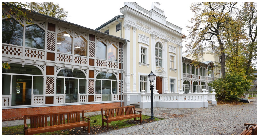
Remont generalny Domu Zdrojowego trwał ponad dwa lata
