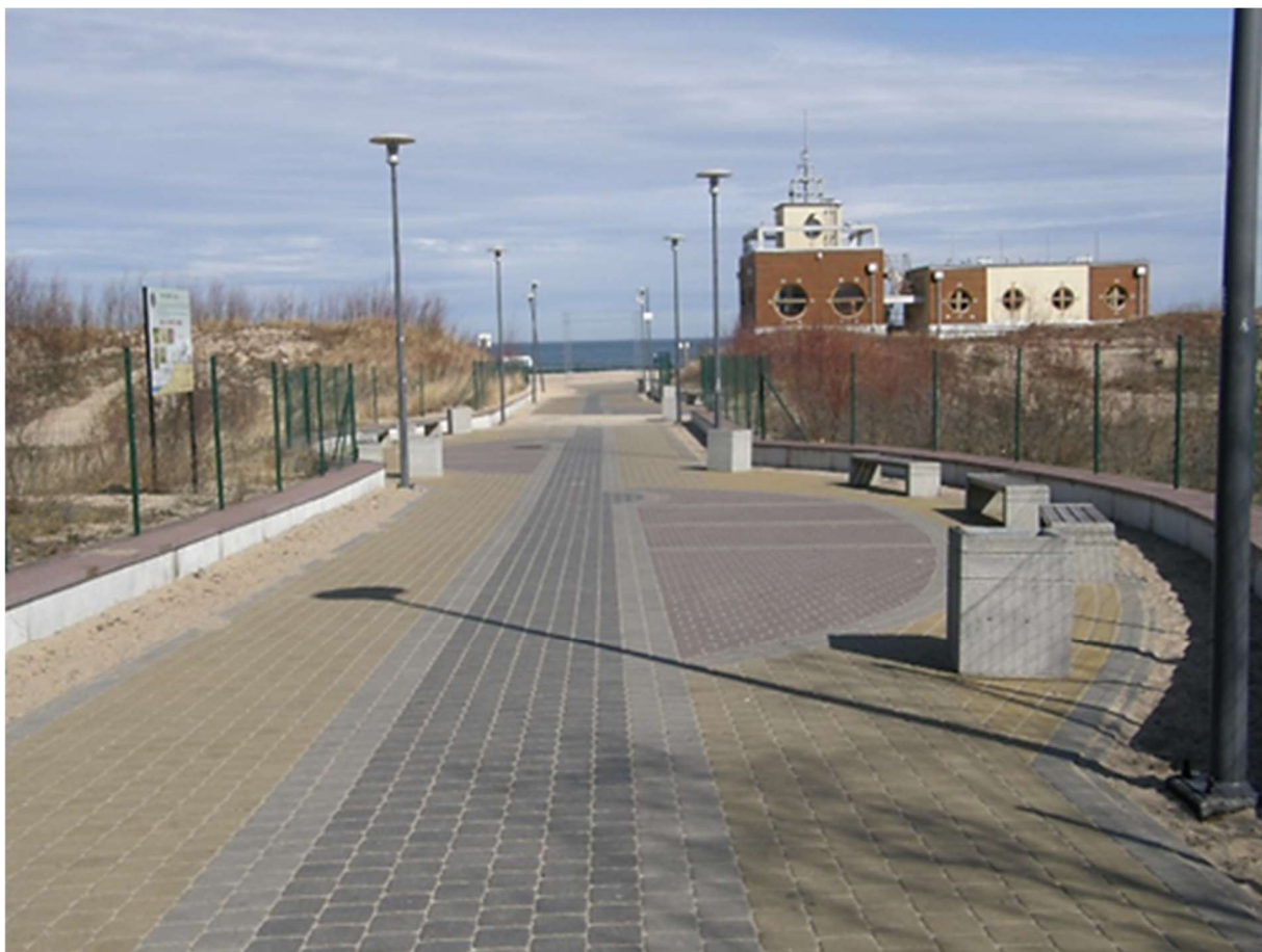
il. 14. Wejście na plażę w Stogach wyposażone w stały obiekt WOPR (fot. BRG).
