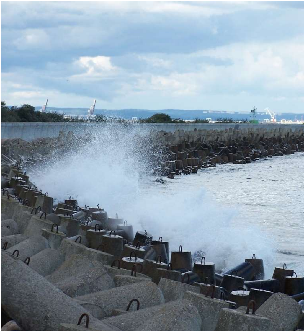
il. 11. Brzeg Zatoki Gdańskiej w rejonie falochronu wschodniego ujścia Wisły Śmiałej (fot. BRG).
