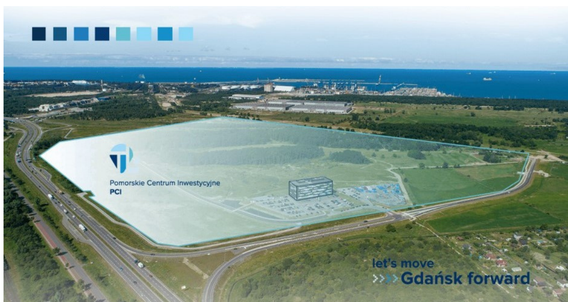
ryc.1. Obszar Pomorskiego Centrum Inwestycyjnego (PCI). Mat. GARG
