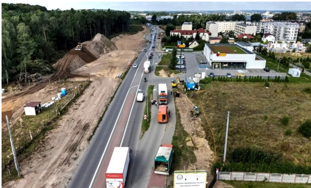
Rycina 6. Rozbudowa ul. Kartuskiej na odcinku od ulicy Otomińskiej do skrzyżowania z ulicą Nowatorów. Fotograf: DRMG
