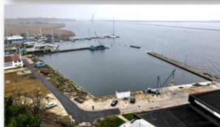
Fot. Dyrekcja Rozbudowy Miasta Gdańska
