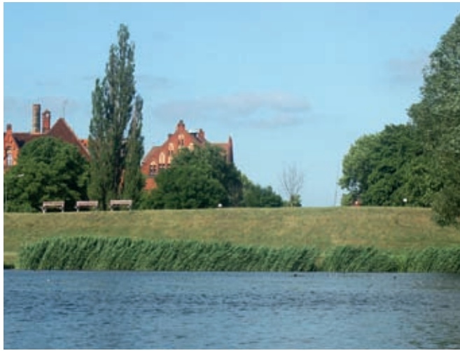
Zrewitalizowana przestrzeń dawnych fortyfikacji przy Opłynie Motławy
