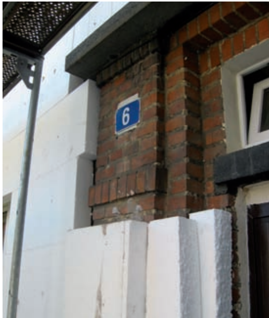
Przykłady „ulepszeń” modernistycznej architektury
