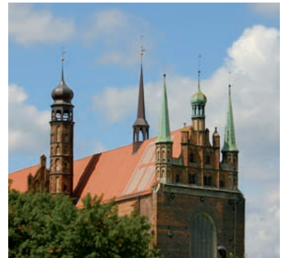
Kościół św. Trójcy. Zrekonstruowane hełmy sygnaturek oraz oryginalne sklepienia
