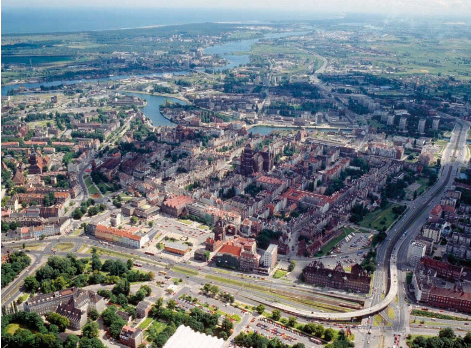
Odcinek wschodni trasy (prawa część zdjęcia)
