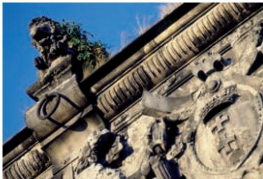
Brama Wyżynna. Stan przed i po renowacji
