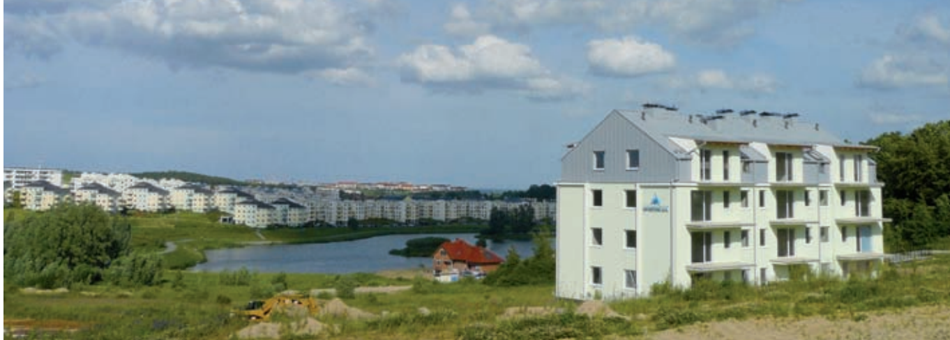
Na pierwszym planie osiedle Nad Jarem, w głębi zabudowa przy ul. Kazimierza Porębskiego
