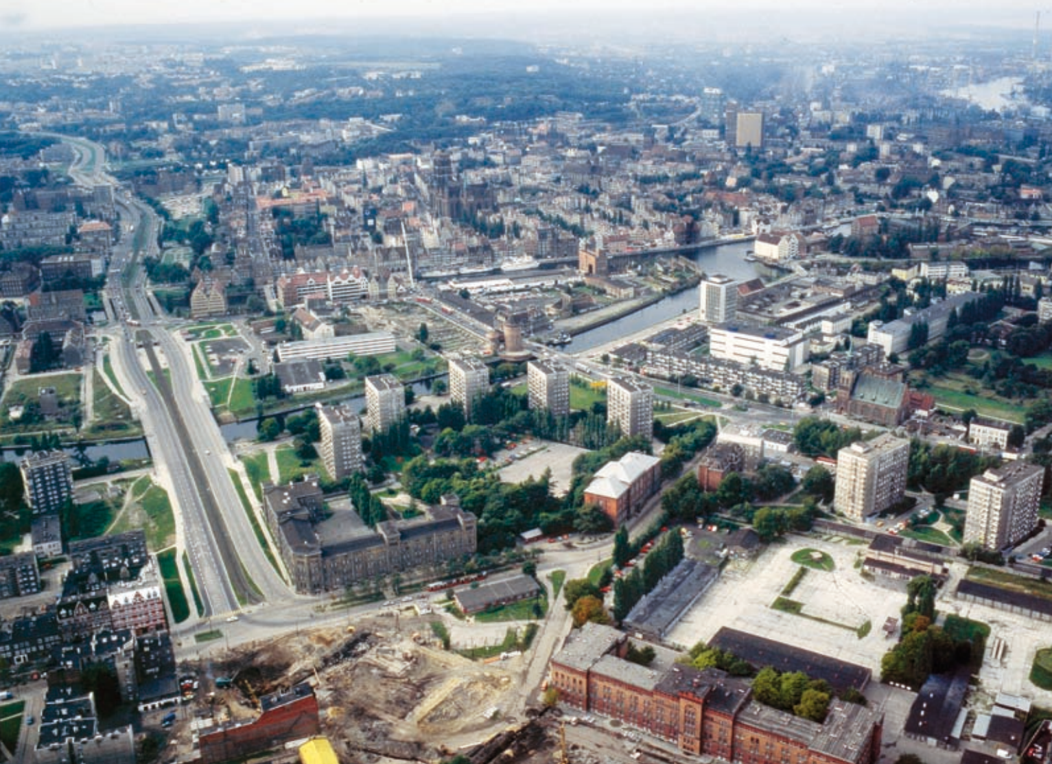
Budowa odcinka wschodniego trasy W-Z. Skrzyżowanie z ul. Łąkową
