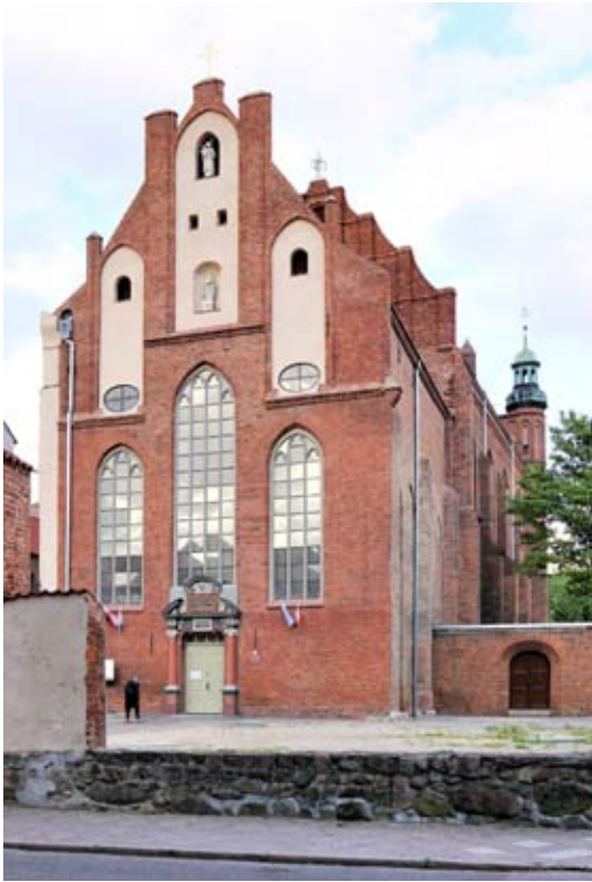
Kościół św. Józefa, widok od strony zach. oraz widok wnętrza po renowacji.
