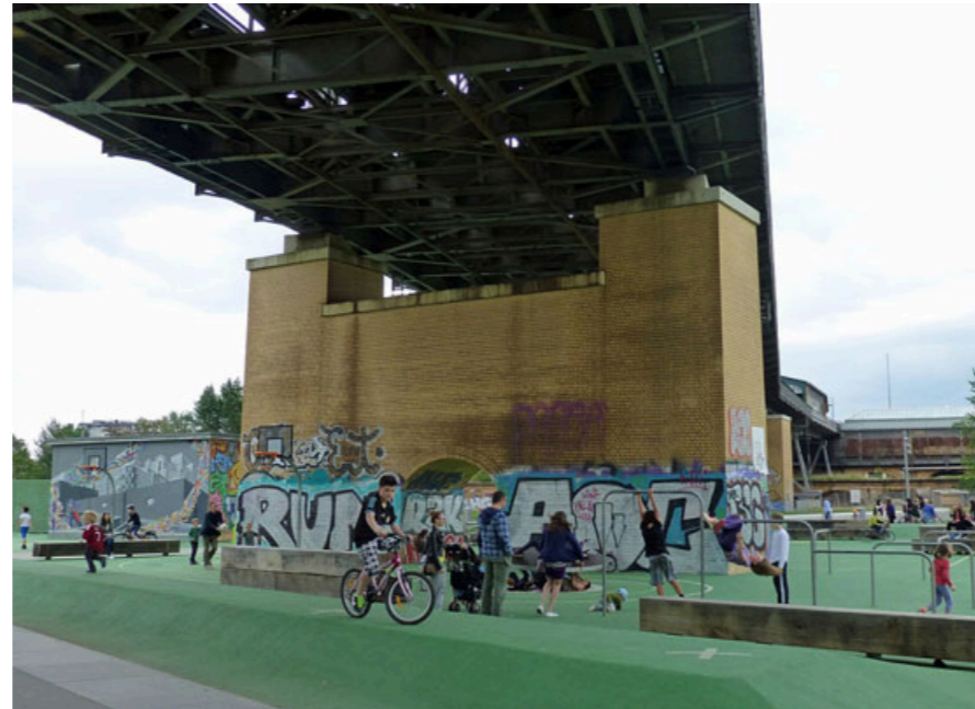
Zagospodarowanie sportowe pod estakadą w Park am Gleisdreieck w Berlinie źródło: Ji-elle, Wikipedia
