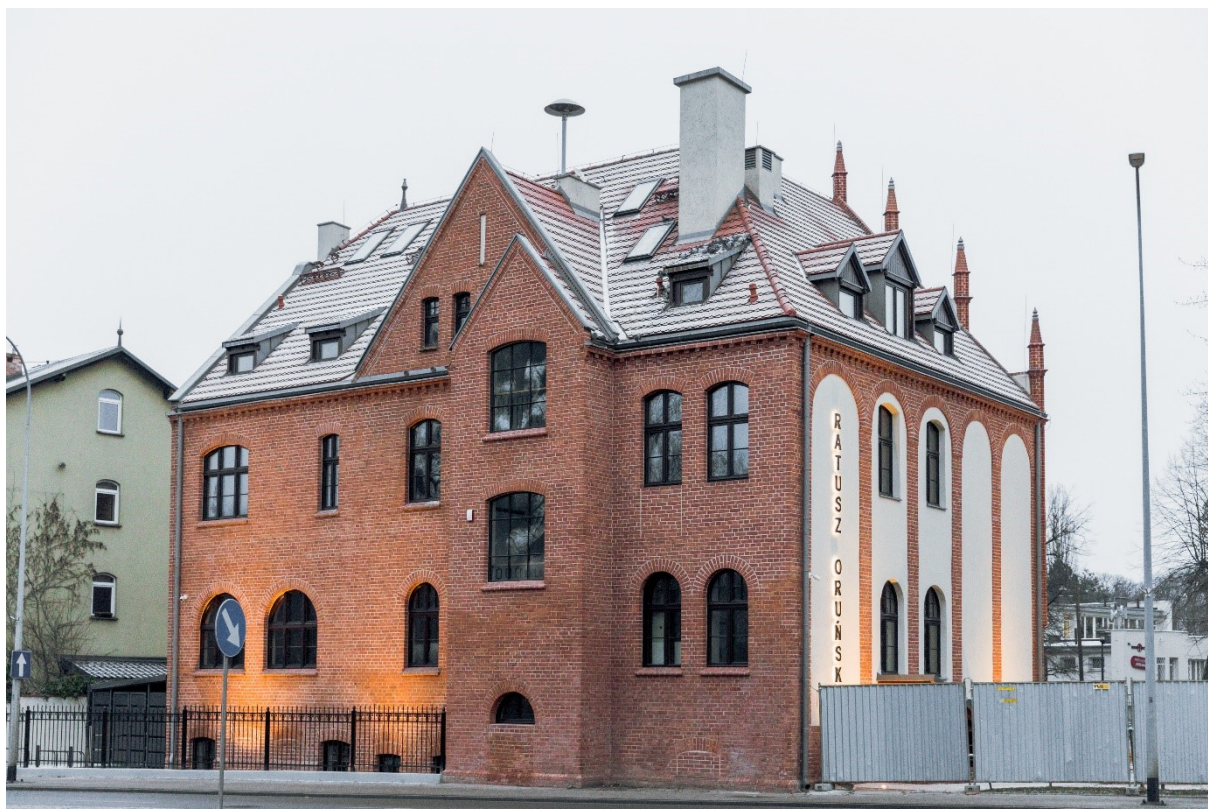
Rycina 2. Budynek dawnego ratusza przy ulicy Gościńskiej 1 po zakończeniu robót budowlanych i adaptacji budynku na cele społeczne. Fotograf: Dominik Paszliński / www.gdansk.pl
