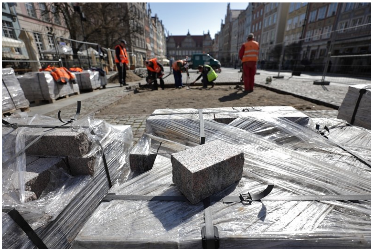
Rycina 1. Prace nad wymianą nawierzchni na ulicy Długi Targ. Fotograf: Grzegorz Mehring / www.gdansk.pl
