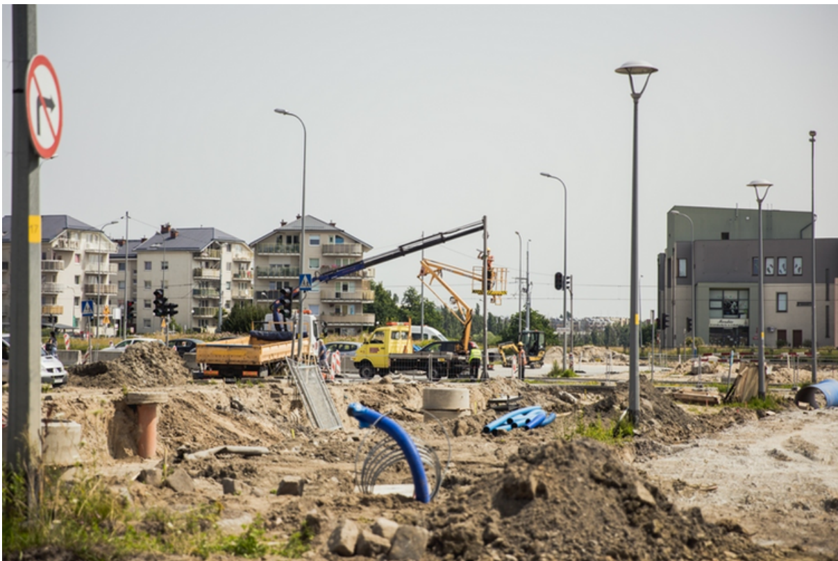
ryc. 3. Prace budowlane linii tramwajowej Nowa Warszawska. Fot. D. Paszliński / gdansk.pl
