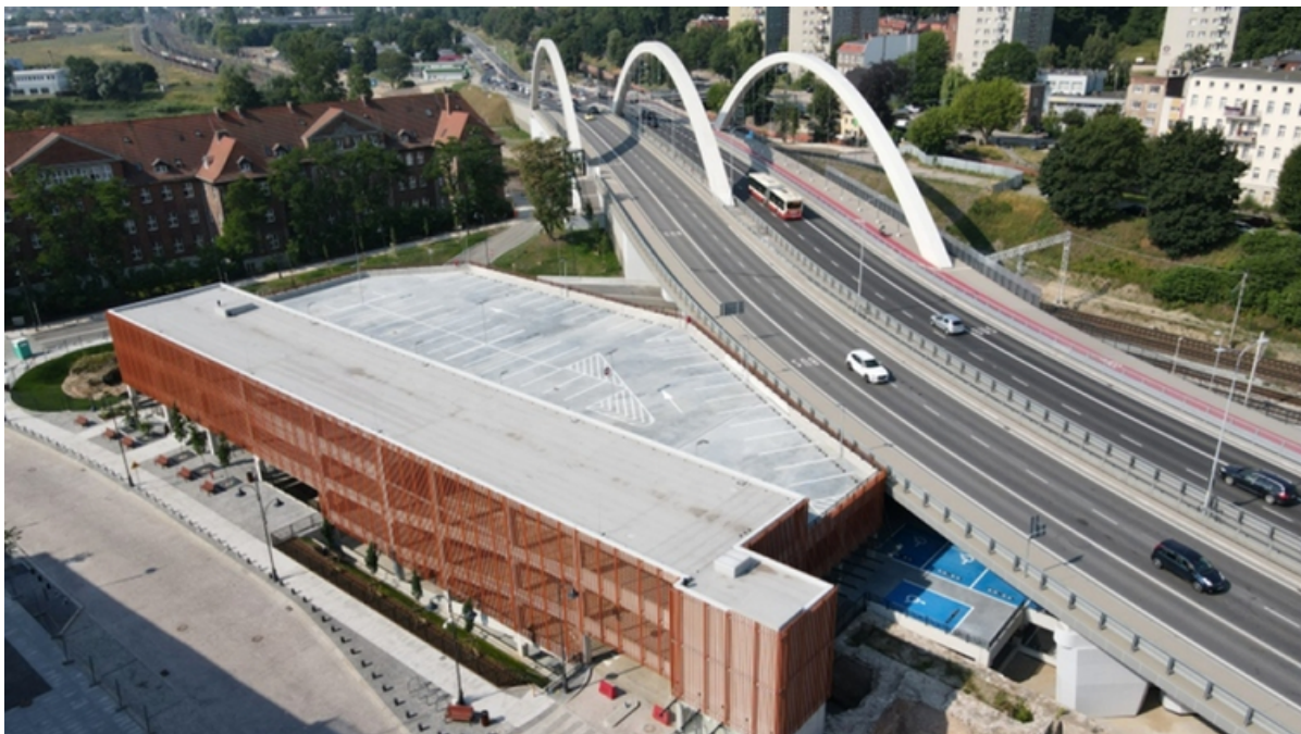
ryc. 5. Wiadukt Biskupia Górka po zakończeniu przebudowy. Fot. DRMG
