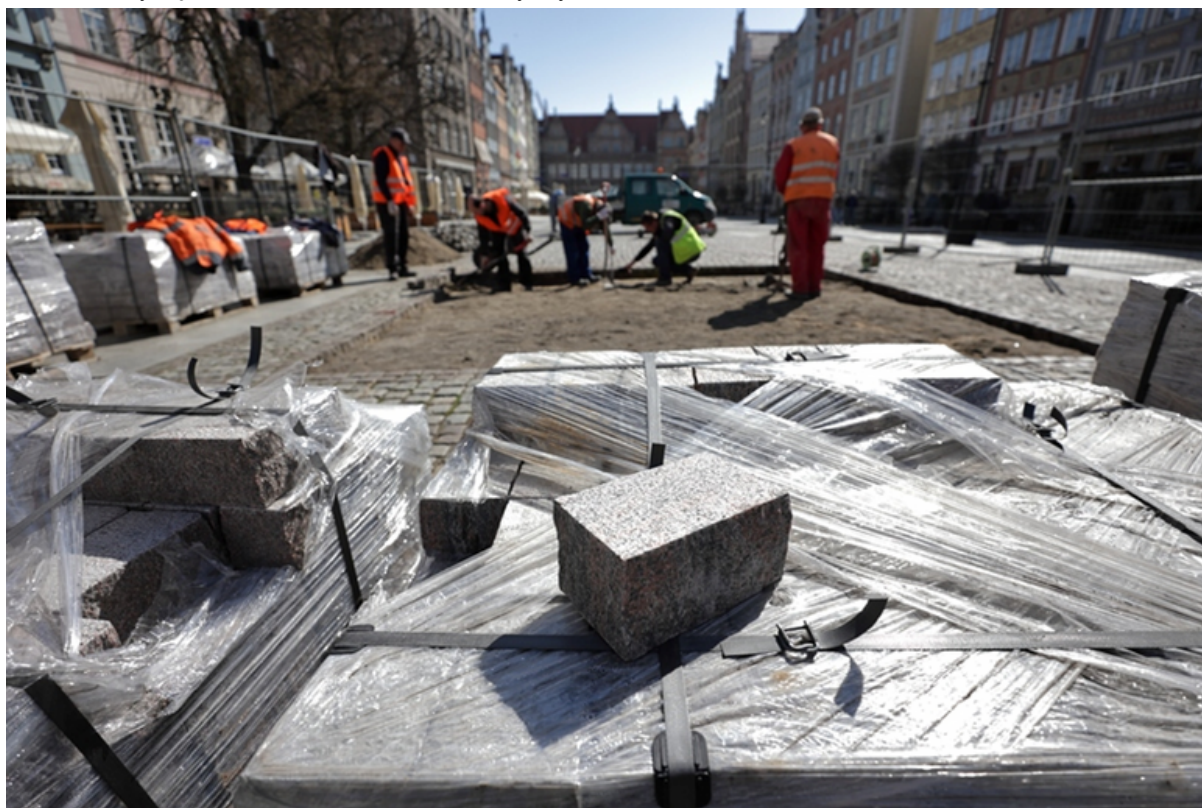
ryc. 1. Prace nad wymianą nawierzchni na ul. Długi Targ. Fot. G. Mehring / gdansk.pl
