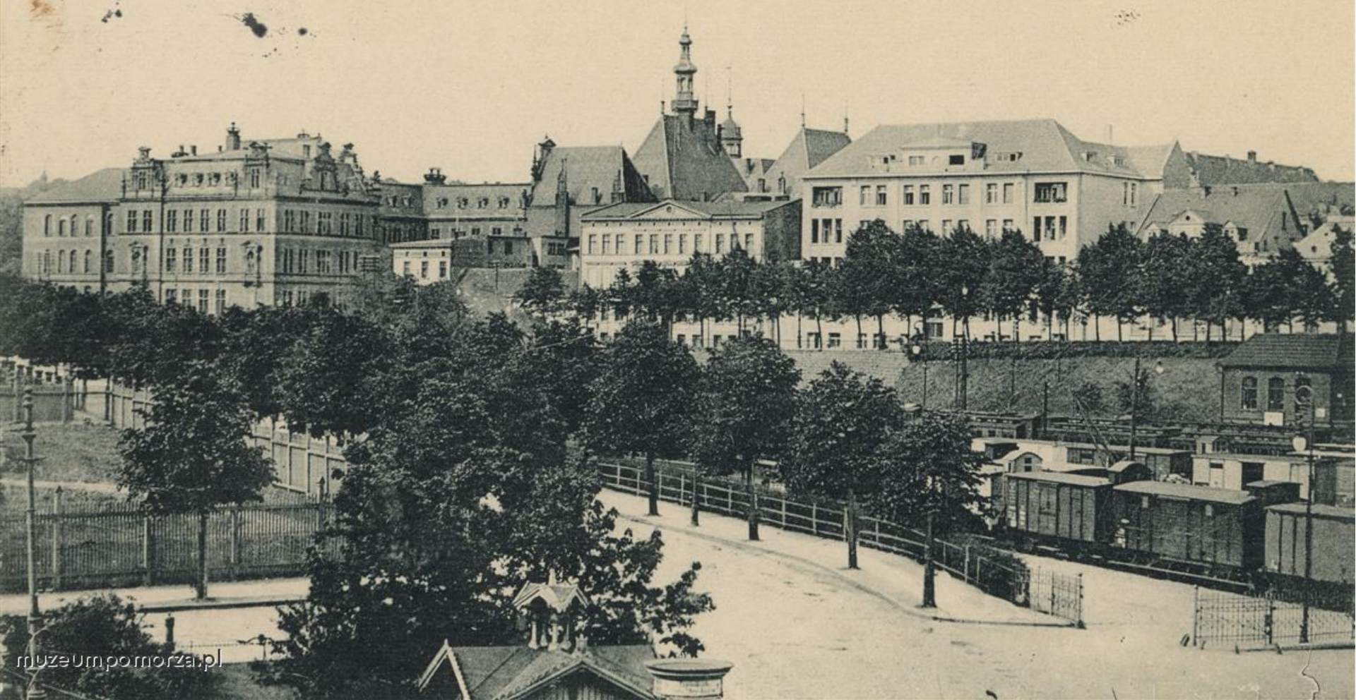
Podwale Grodzkie. W tle Promenada Północna
