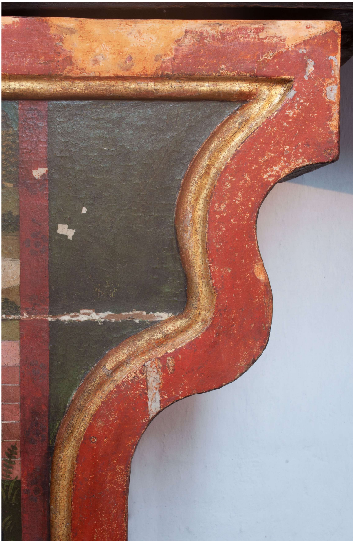
Fragment ramy predelli po usunięciu uzupełnień warstwy malarskiej z 1996 roku. Farbę retuszerską rozpuszczono wodą dejonizowaną. Zabieg prowadzono z zastosowaniem szkieł powiększających. Były konieczne ze względu na ślady srebrzonego ornamentu patronowego na ramie predelli.
