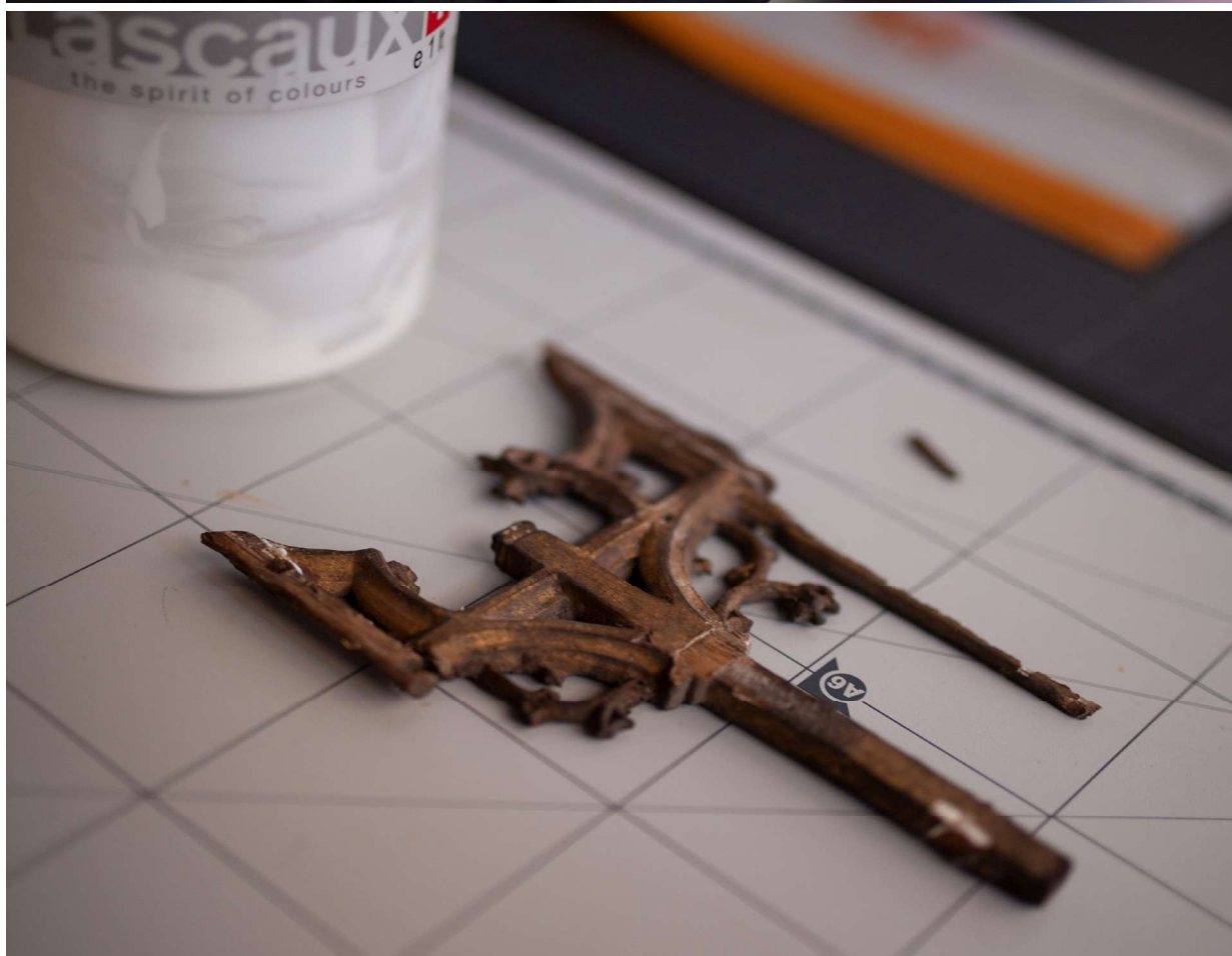
Filigranowe elementy rzeźbionej architektury zdublowano bibułą japońską. Luźne części i te których pozycja była inna od pierwotnej zdemontowano, zabezpieczono i wklejono na oryginalne miejsce.
