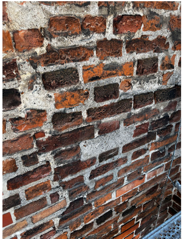
Przed konserwacją - stan zachowania elewacji: odspojenia, uzupełnienia ubytków cegieł i spoin wtórną zaprawą.
