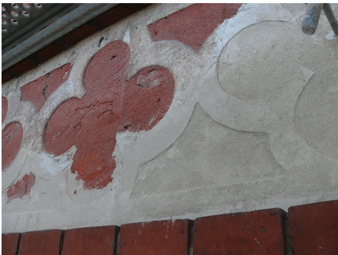
W trakcie prac - uzupełnianie ubytków w partii fryzu.
