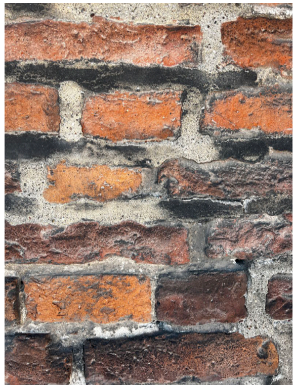
Przed konserwacją - stan zachowania elewacji: charakter zanieczyszczeń i wtórna spoina.
