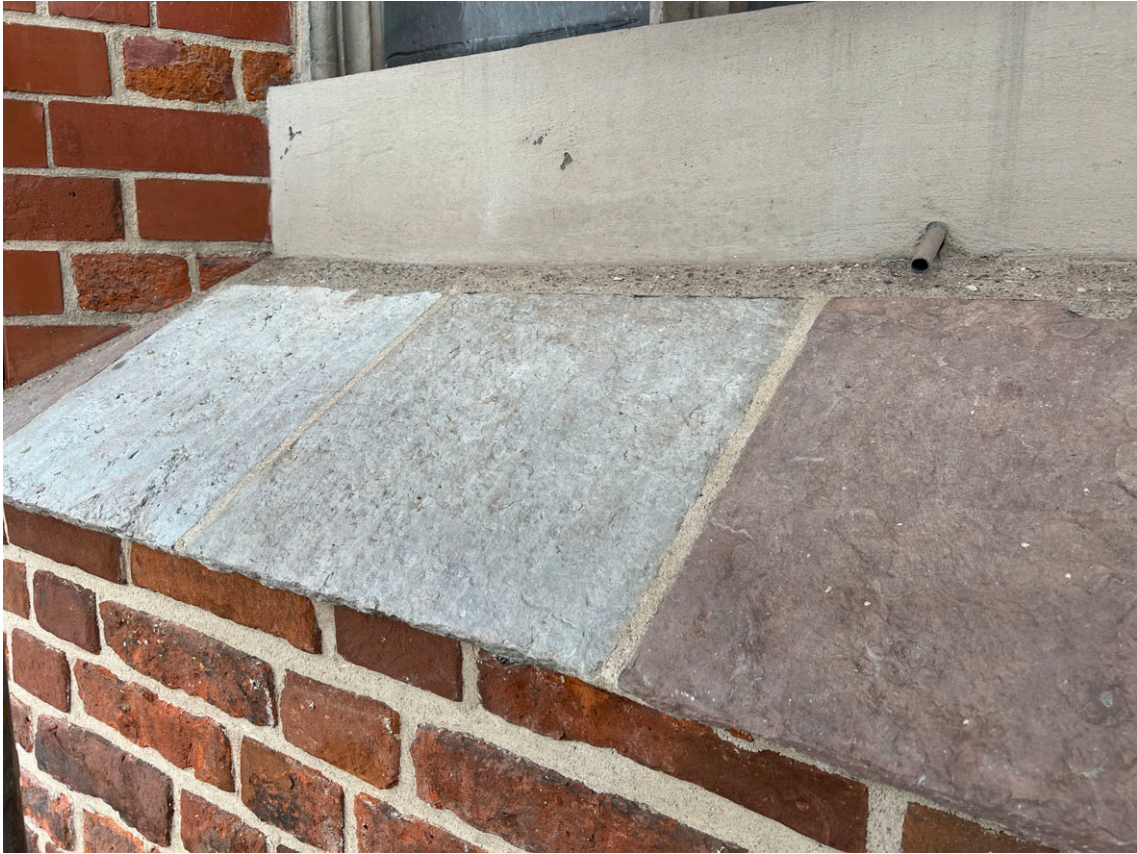
Po konserwacji - parapety z wapienia olandzkiego po dezynfekcji, wzmocnieniu, oczyszczeniu i uzupełnieniu ubytków.
