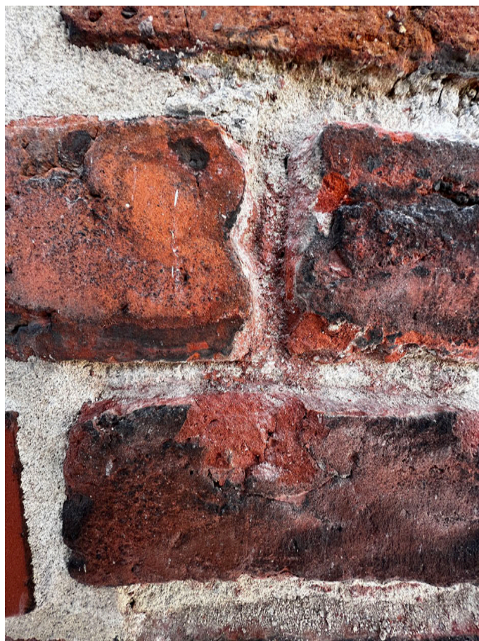
W trakcie prac - odsłonięte, po usunięciu wtórnych spoin, relikty czerwonej monochromii.
