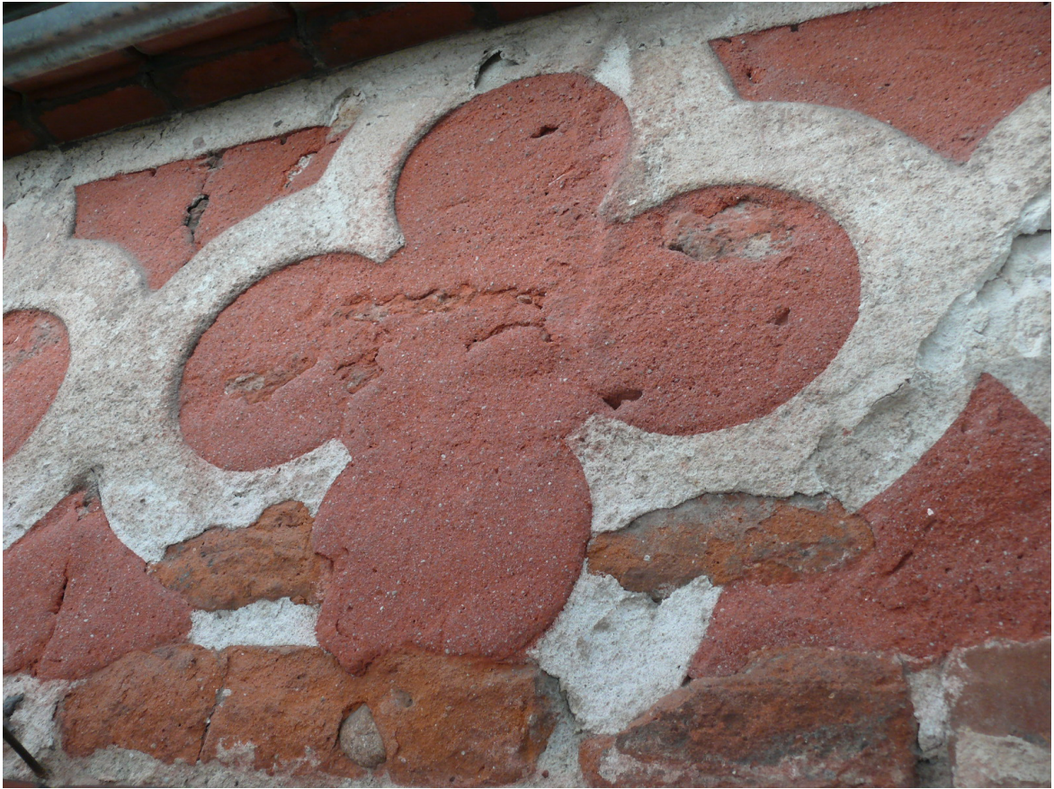
Przed konserwacją - oryginalna technika wykonania dekoracji fryzu.
