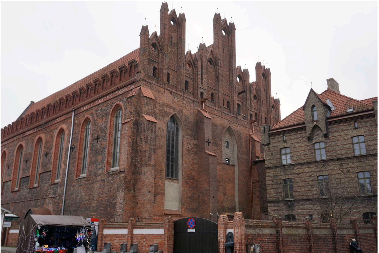
Przed konserwacją - widok północno-zachodni na bryłę kościoła.
