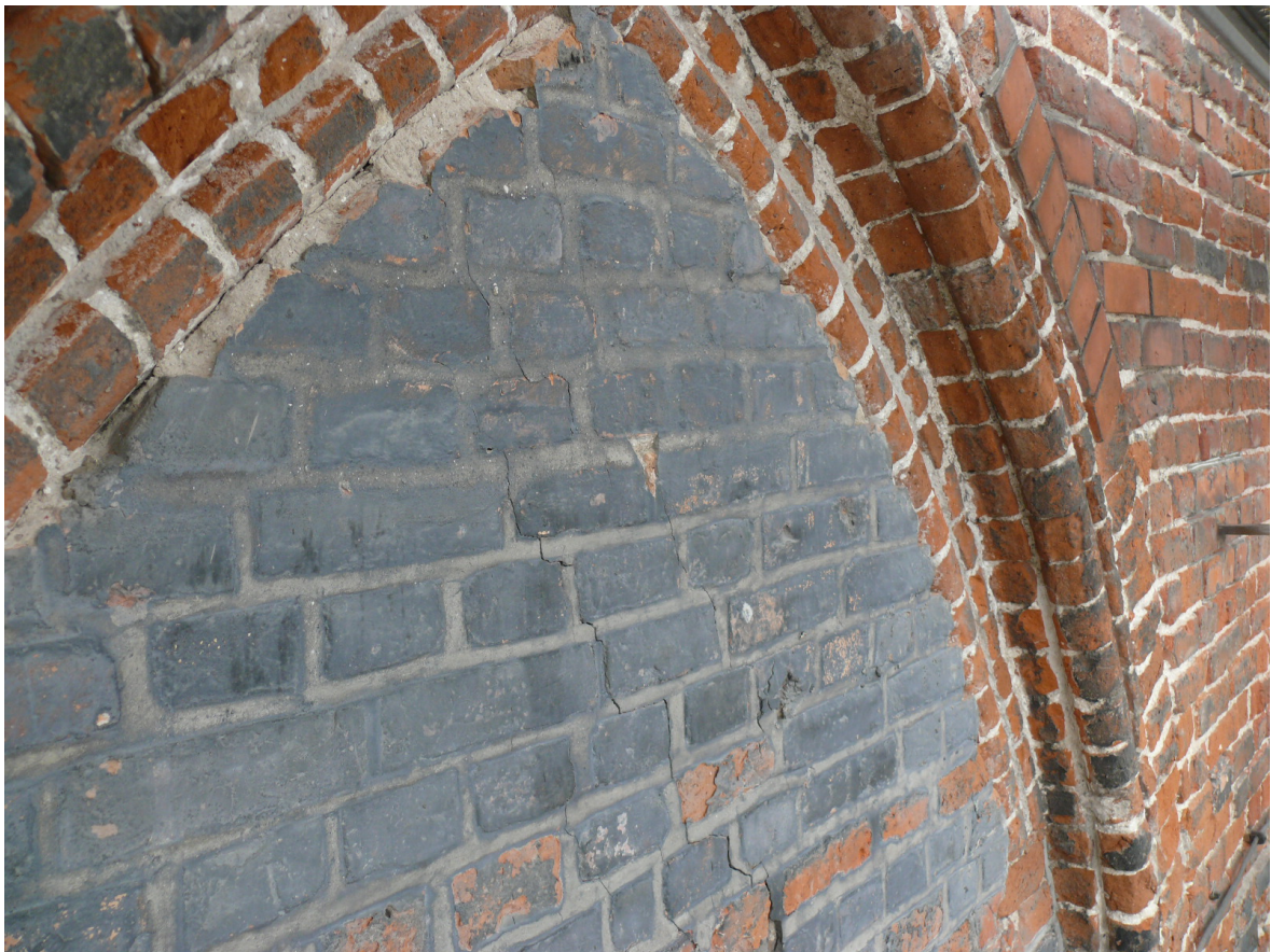
W trakcie prac - usuwanie spoin w obrębie przyziemia i reliktów dawnej zabudowy klasztoru.
