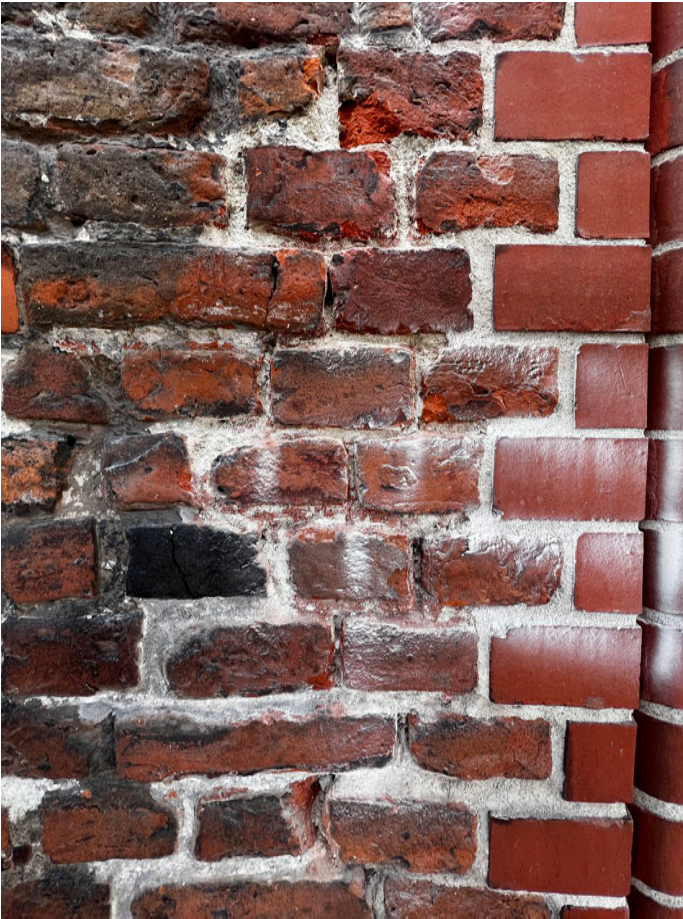
W trakcie prac - usuwanie wtórnych spoin.
