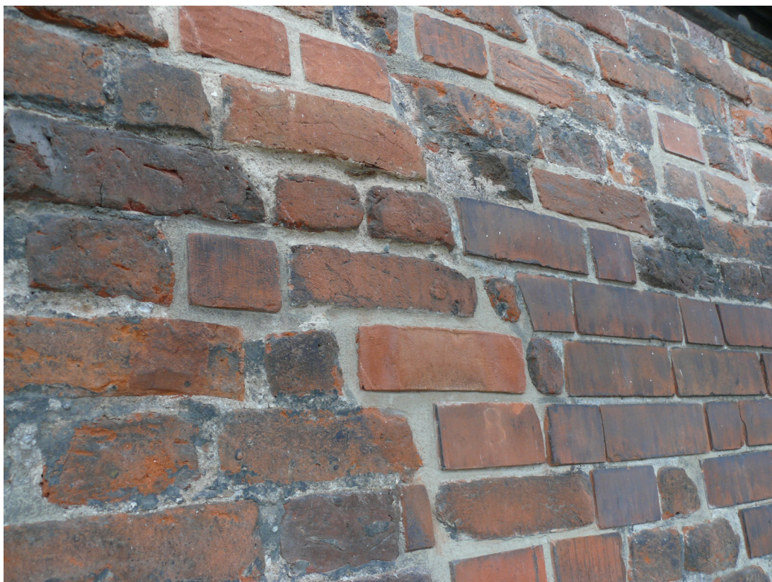
W trakcie prac - uzupełnianie spoin w obrębie śladów po zabudowie klasztornej.
