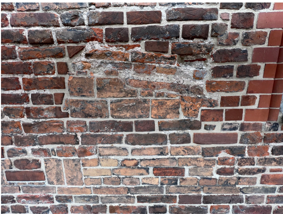
Po konserwacji - fragmenty elewacji z uczytelnieniem śladów po zabudowie klasztornej.
