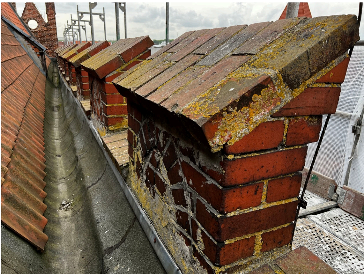
Przed konserwacją - porosty na powierzchni krenelażu.
