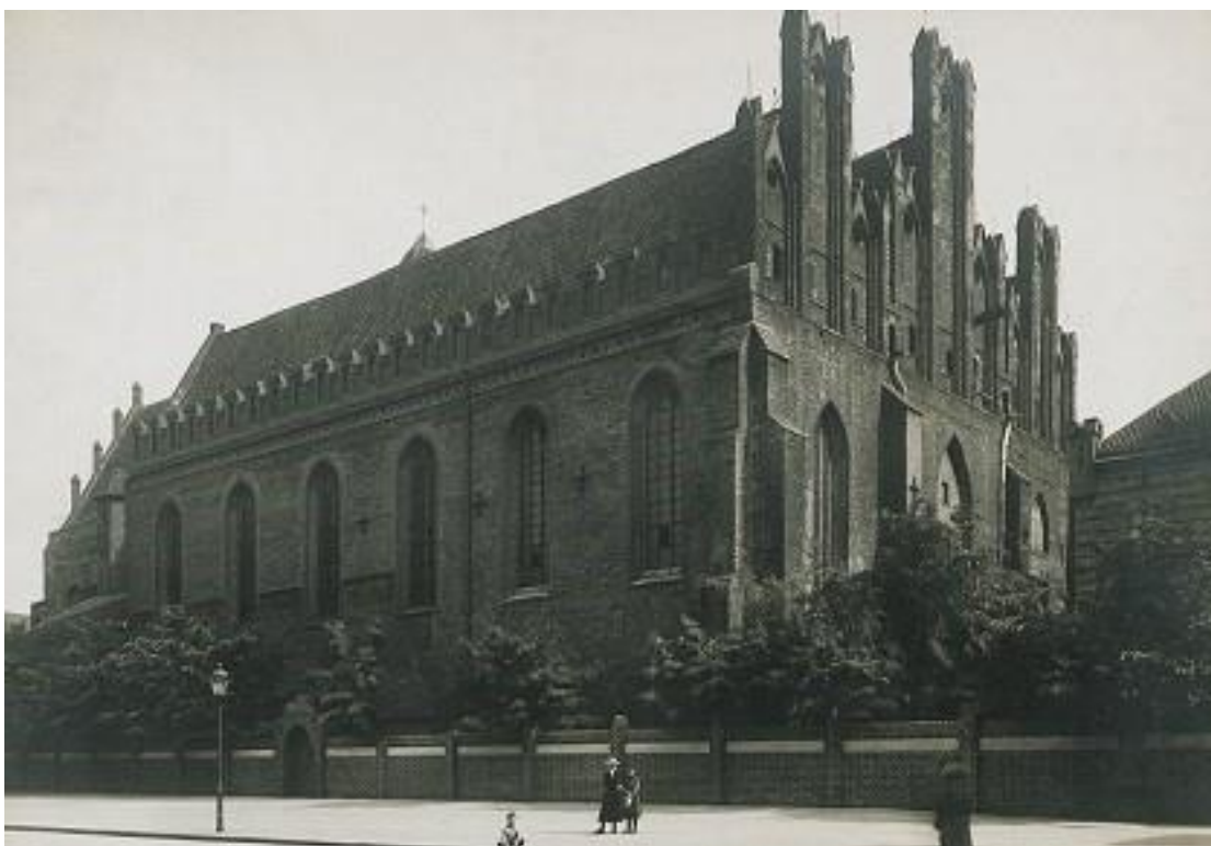
Kościół Św. Mikołaja, elewacja północna i zachodnia, 1916-1923.
