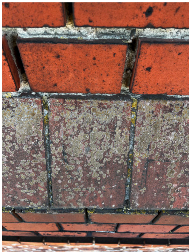
Przed konserwacją - attyka: porosty na powierzchni muru.
