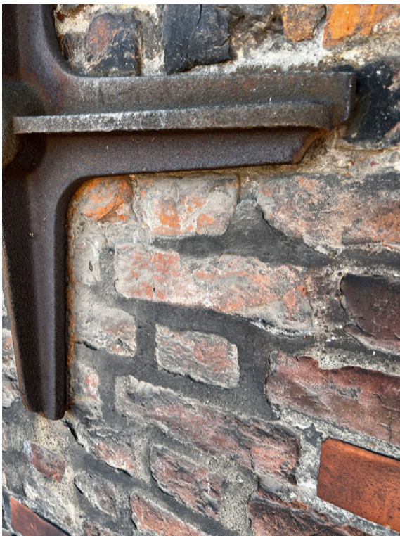
Przed konserwacją - wtórne spoiny w obrębie elewacji.
