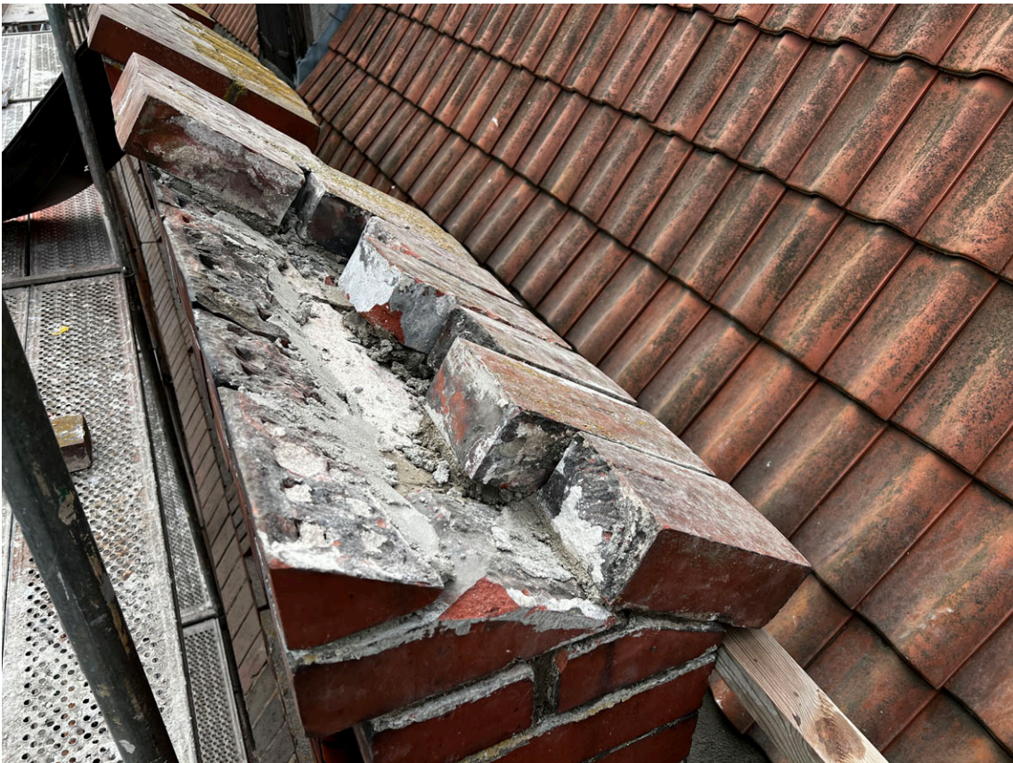
W trakcie konserwacji - usuwanie wtórnym odspojonych cegieł nakryw krenelazu.
