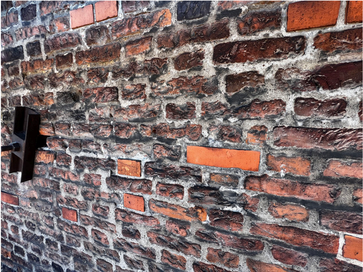
Przed konserwacją - stan zachowania elewacji: charakter zanieczyszczeń i wtórna spoina.
