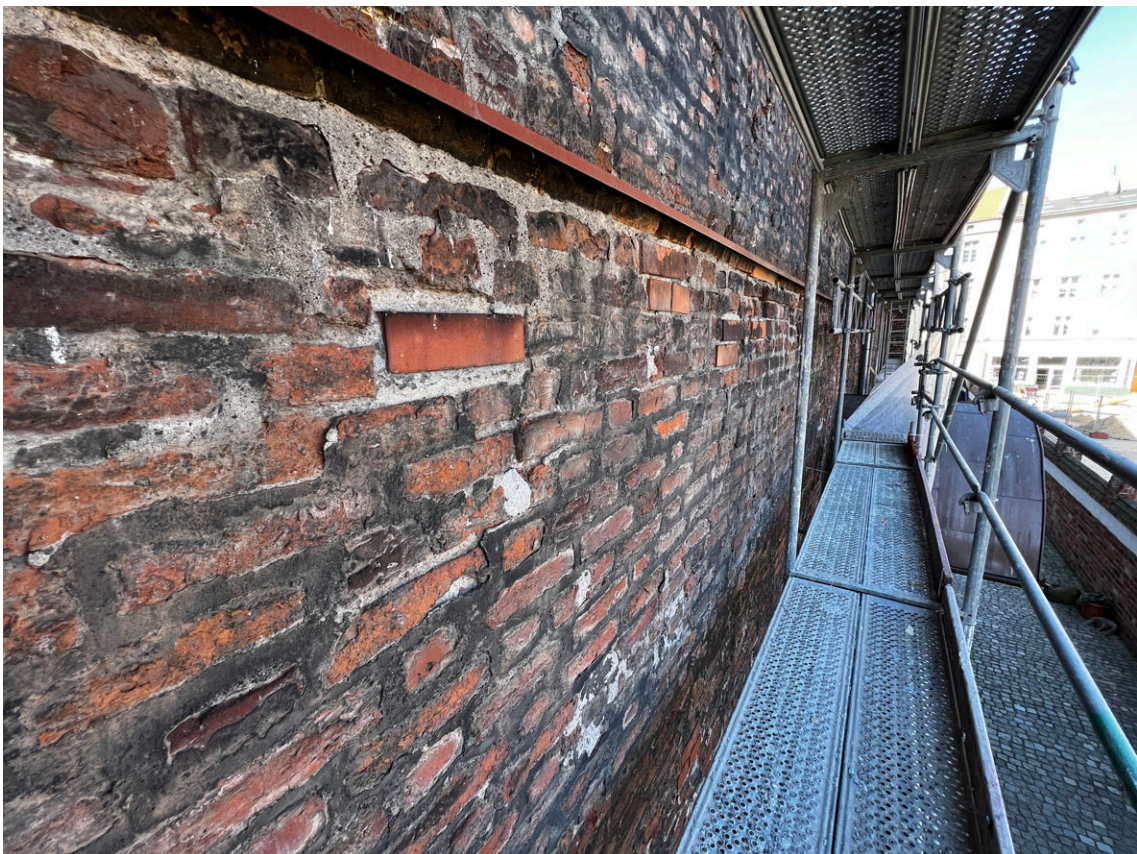
Przed konserwacją - stan zachowania partii przyziemia: wtórne spoiny i naprawy wątku.
