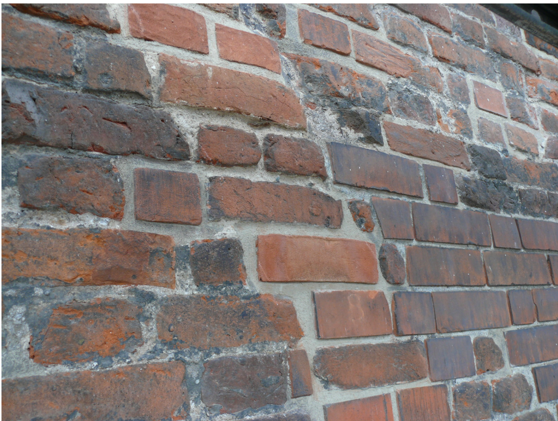
W trakcie prac - uczytelnianie śladów po zabudowie - laserunki, patynowanie.
