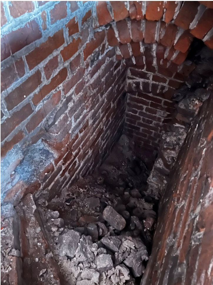
W trakcie prac - odkrywka dawnej klatki schodowej, zlokalizowanej w grubości muru, wiodącej z krużganków na ambonę w nawie północnej kościoła oraz jej wnętrze.
