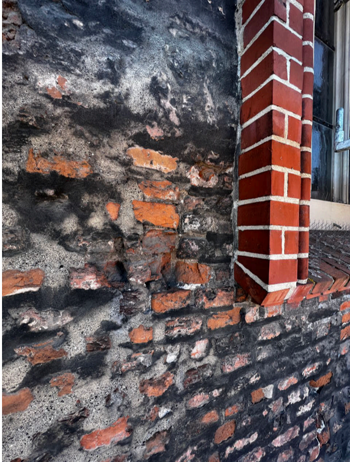
Przed konserwacją - zacierki i zabrudzenie powierzchni partii dawnego poddasza i kontrast ze współczesnym przemurowaniem okien.
