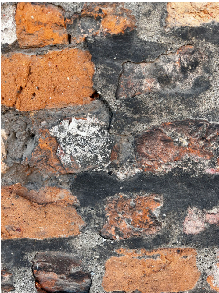
Relikty pobiału pokrywającej ścianę poddasza nieistniejących krużganków.
