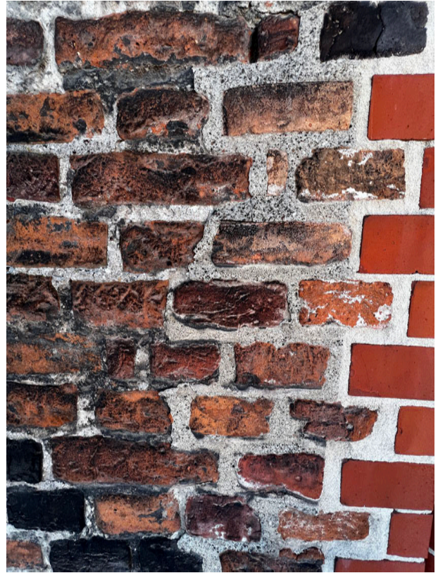
Przed konserwacją - kontrast pomiędzy współczesnymi przemurowaniami otworów okiennych i oryginalnego wążku elewacji.
