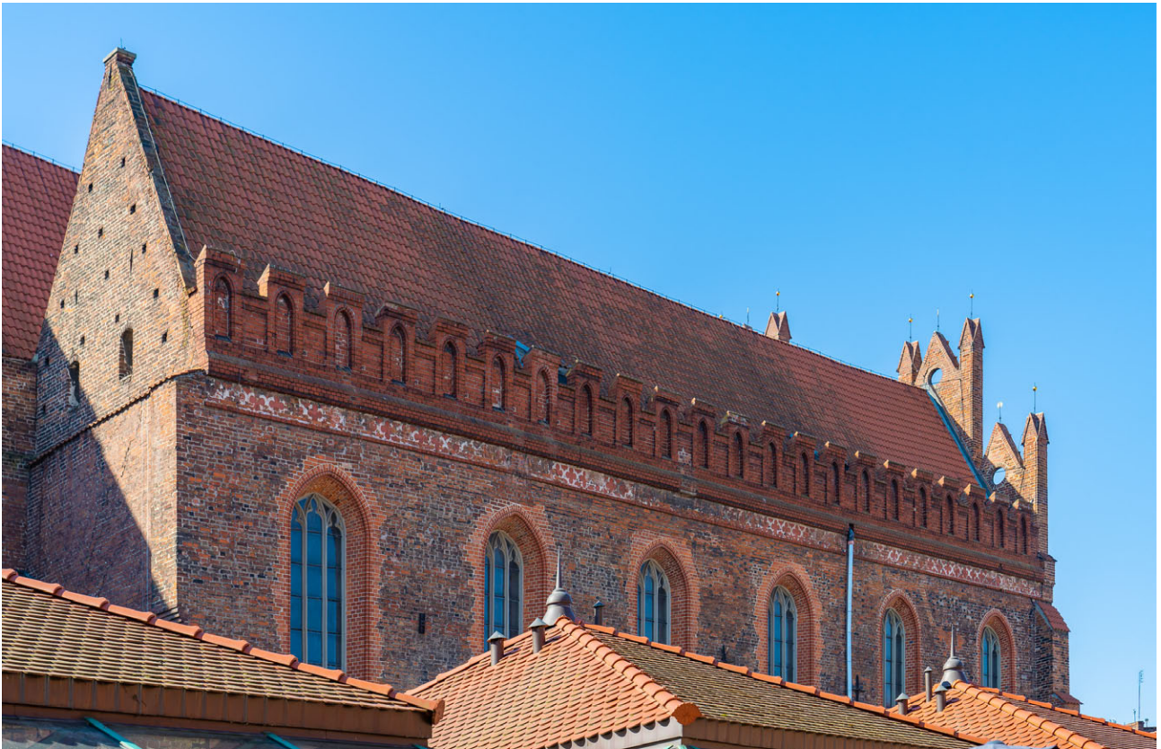
Przed konserwacją - elewacja północna widok ogólny.
