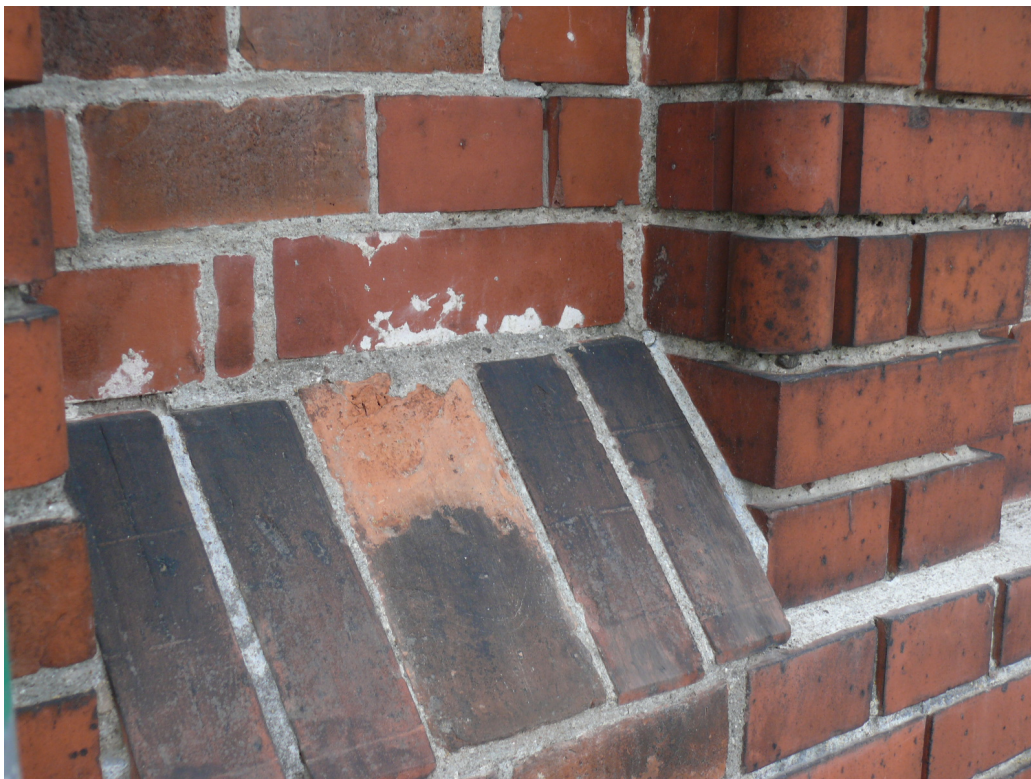
W trakcie konserwacji - usuwanie porostów z cegieł.
