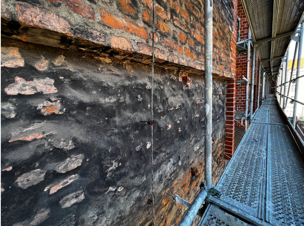
Przed konserwacją - partia elewacji będąca ścianą poddasza południowego skrzydła nieistniejących krużganków klasztoru. Stan zacierki pokrywającej wążek.
