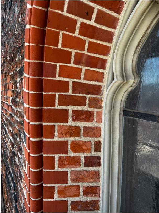
Przed konserwacją - kontrast pomiędzy współczesnymi przemurowaniami otworów okiennych i oryginalnego wążku elewacji.
