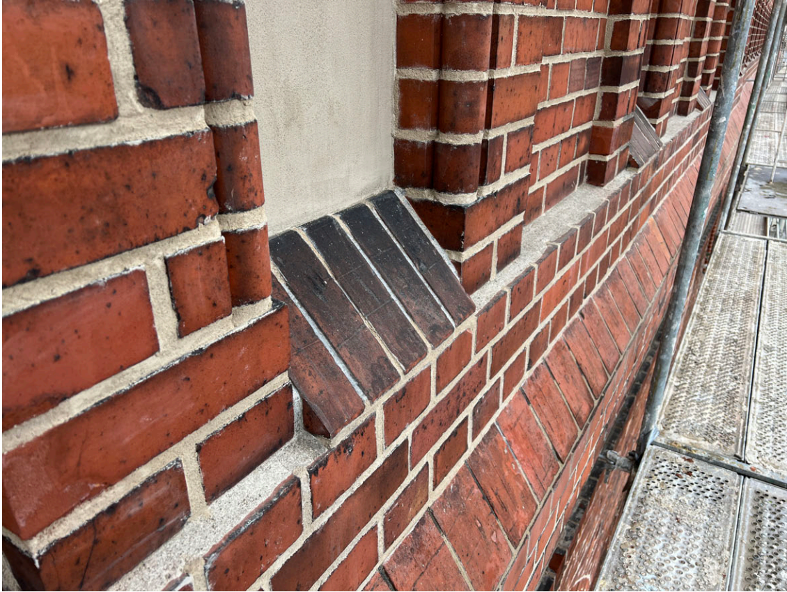
Po konserwacji - atyka po usunięciu glonów, uzupełnieniu spoin i odtworzeniu tynków.
