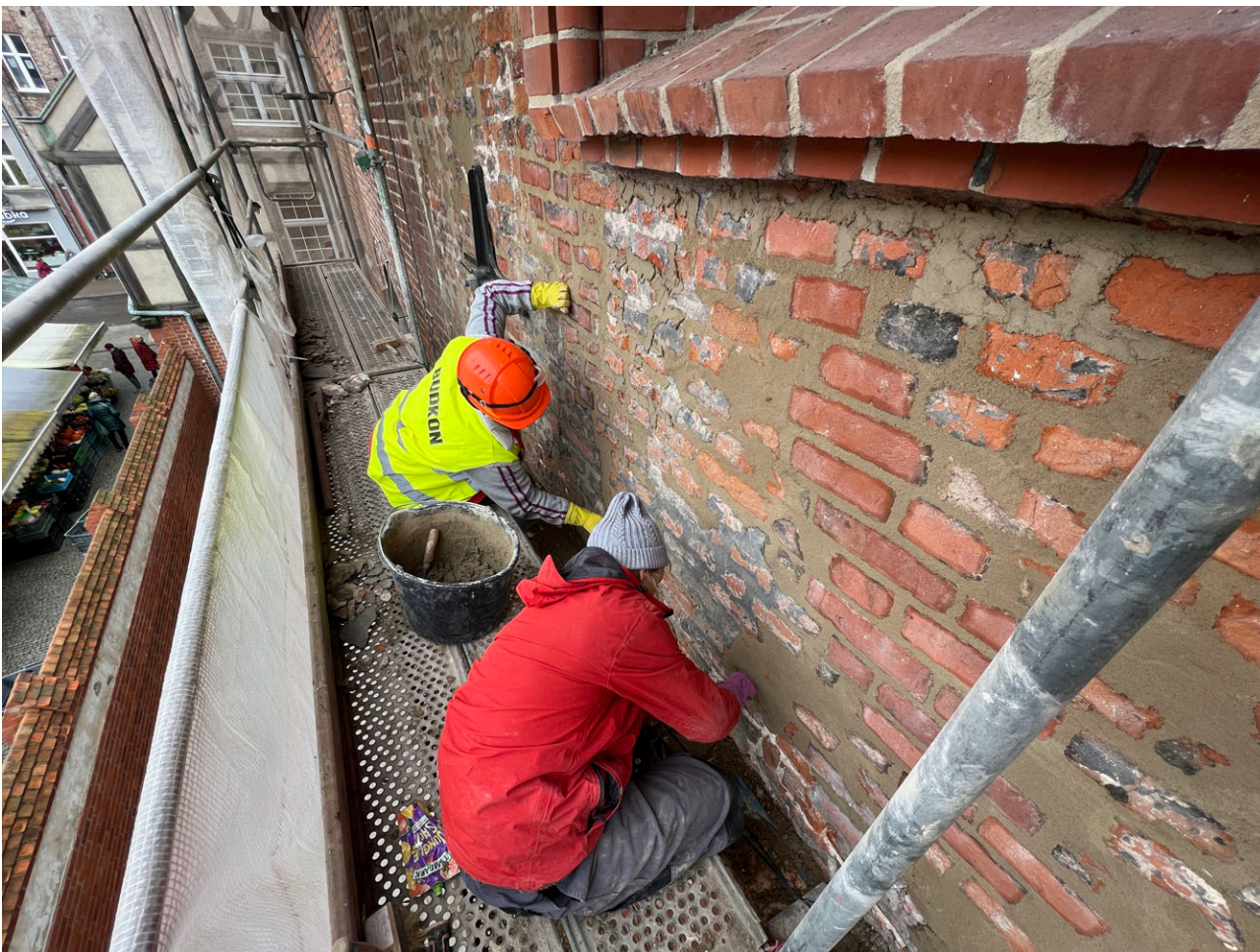
W trakcie prac - uzupełnianie ubytków spoin.
