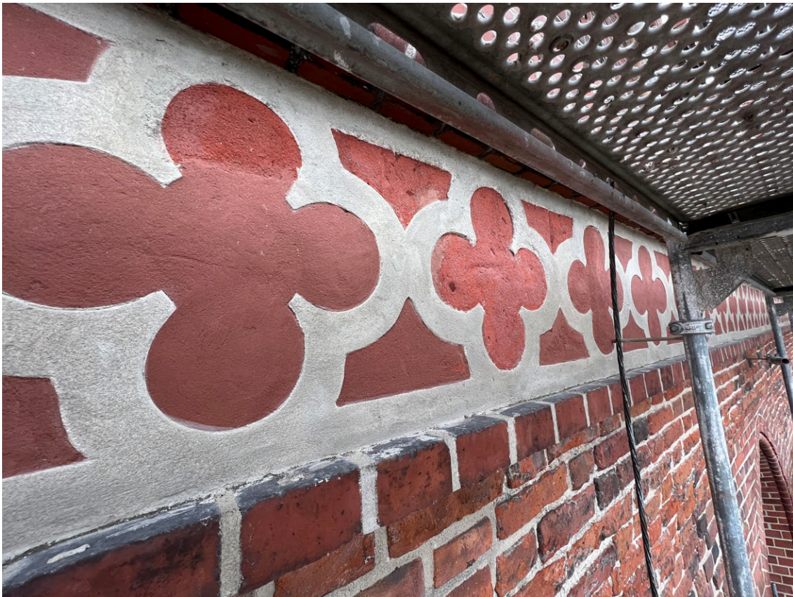
Po konserwacji - dekoracja fryzu po odtworzeniu i walorowym ujednocnieniu z elewacją.
