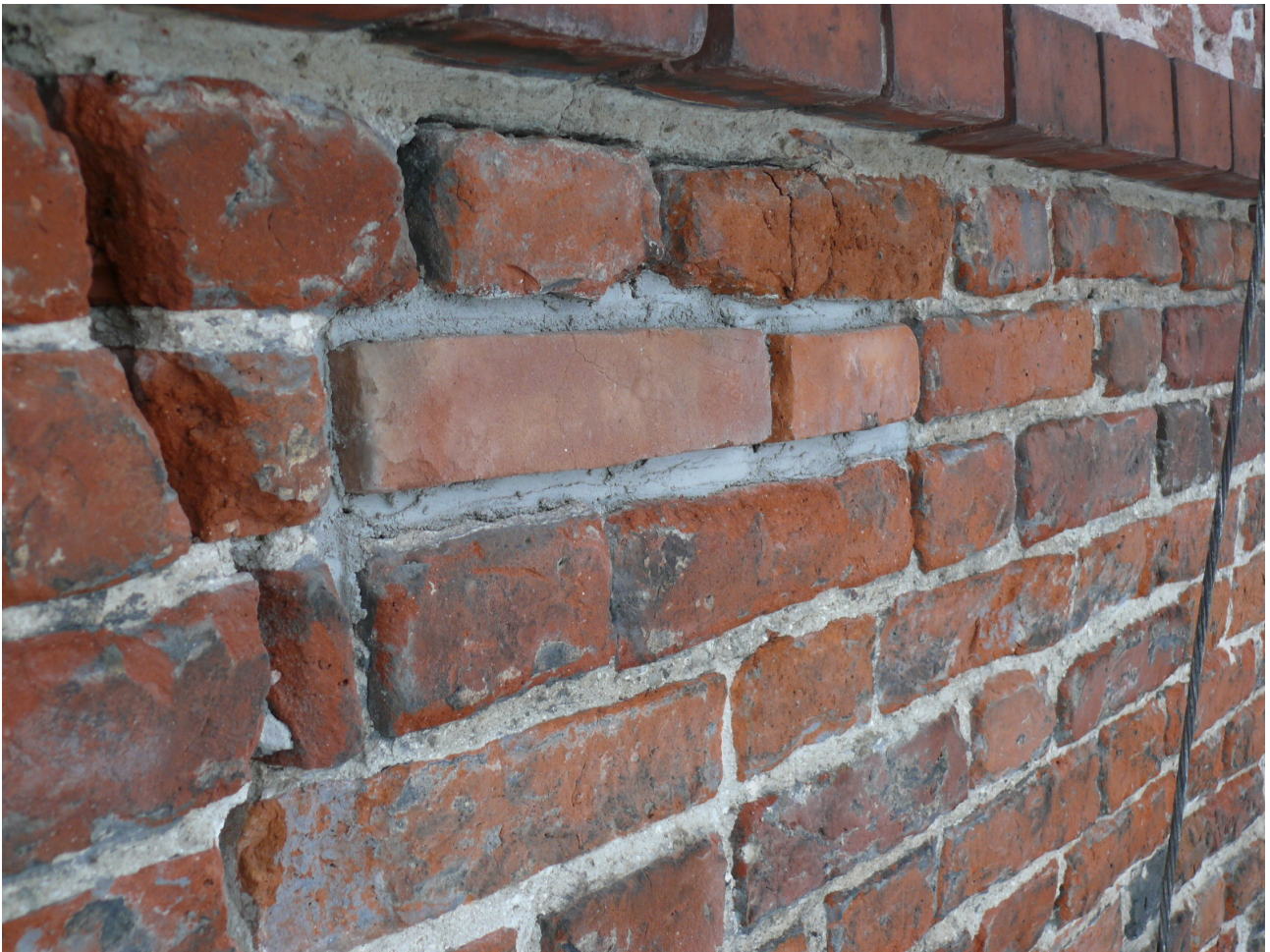
W trakcie prac - uzupełnianie ubytków spoin.
