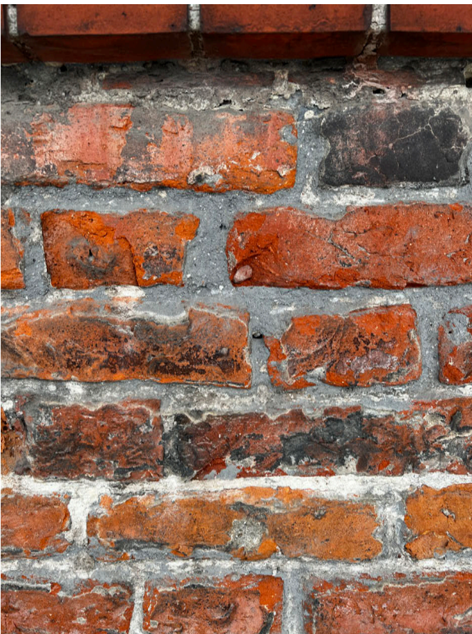
W trakcie prac - po usunięciu spoin odsłonięta wtórna cementowa zaprawa.
