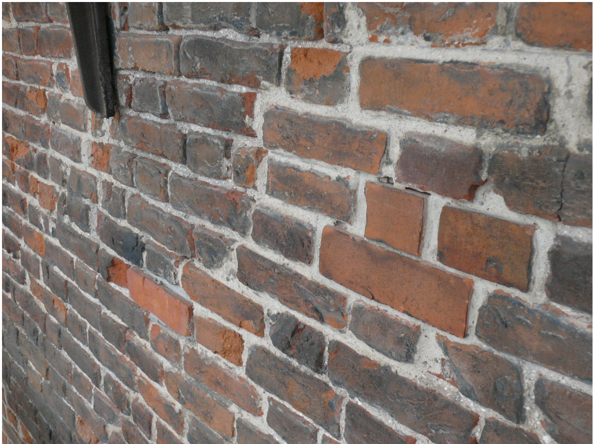
W trakcie prac - usuwanie wtórnych spoin.
