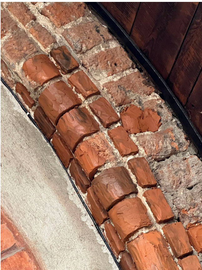
W trakcie prac - uzupełnianie ubytków cegieł kitami mineralnymi.
