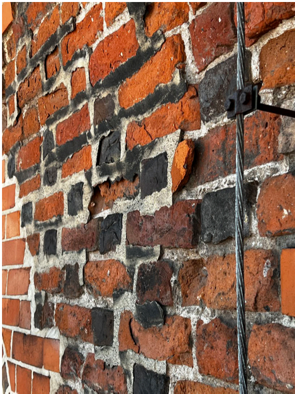
Przed konserwacją - stan zachowania elewacji: odspojenia, uzupełnienia ubytków cegieł i spoin wtórną zaprawą.
