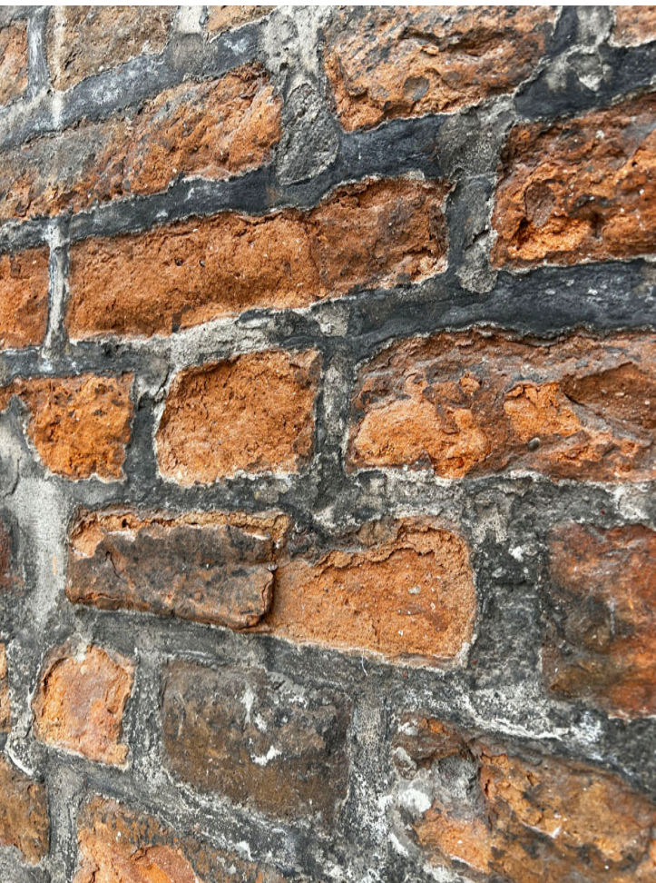
Stan zachowania lica cegieł wstku w partii przyziemia.
