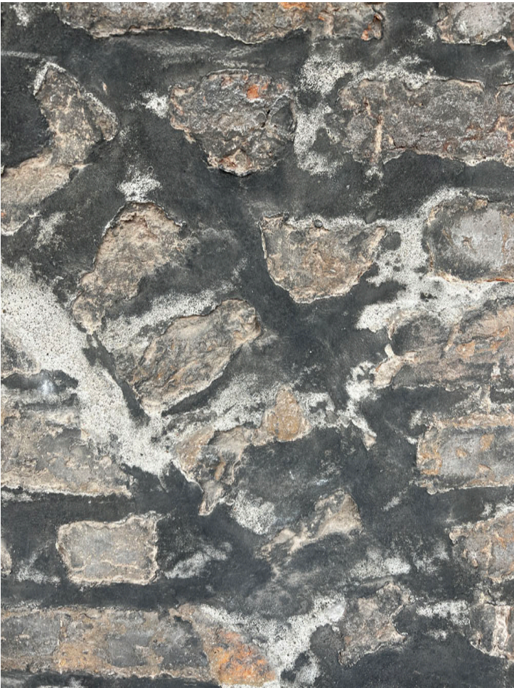
Przed konserwacją - wtórne spoiny w obrębie reliktyw zabudowy klasztornej w partii przyziemi.
