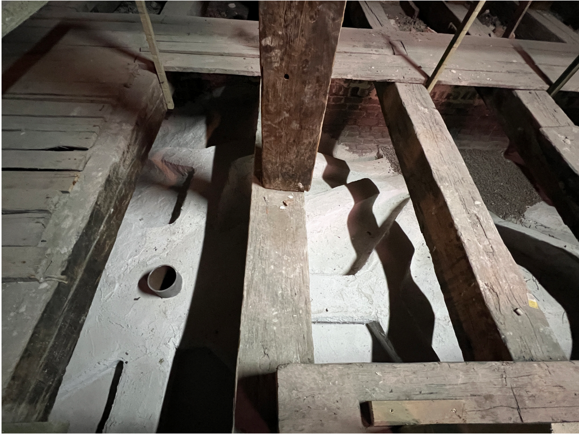
Powierzchnia sklepień po zakończeniu prac.
