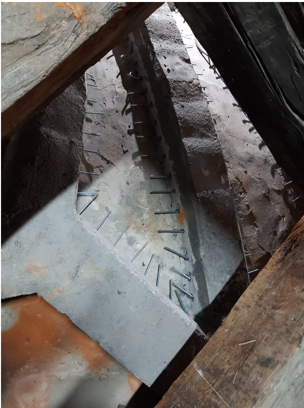
Wzmocnienia wysklepek zespalane z gurtami.
