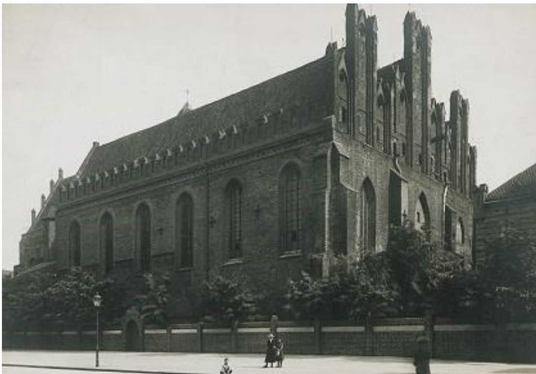
Kościół Św. Mikołaja, elewacja północna i zachodnia, 1916-1923.
