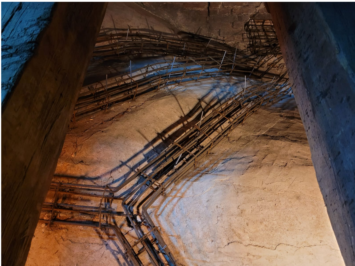
Zbrojenia gurtów. Widoczne kotwy wklejone w żebra sklepienne.
