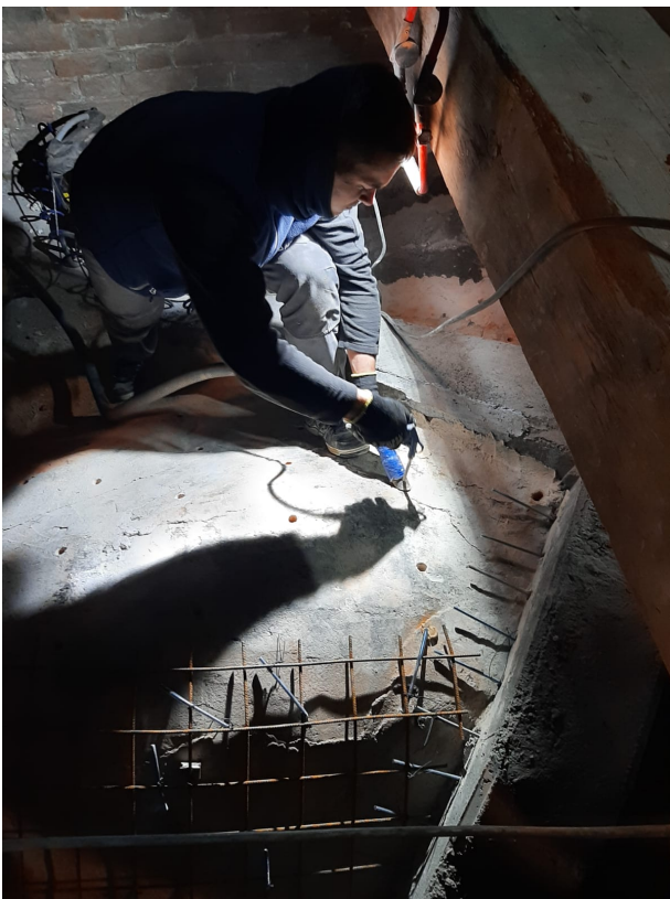
Montaż kotewek z włókien bazaltowych w wysklepkach.
