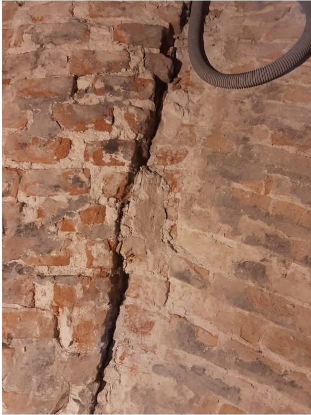
Oczyszczanie szczelin i spękań w sklepieniu.
