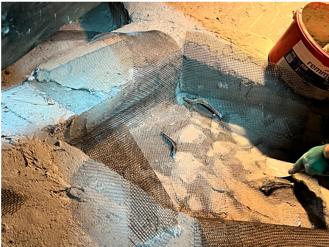
Polepa wzmacniana siatką łączoną z kotewkami.
