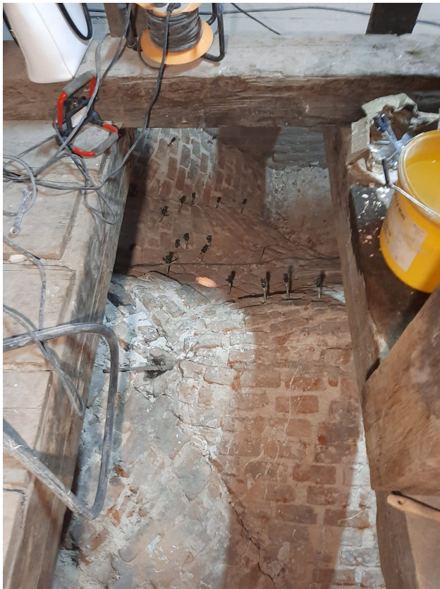
Iniekcja spękań, szczelin i pustek.
