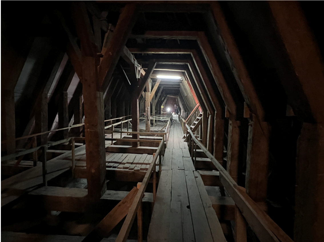
Poddasze nawy południowej po zakończeniu prac.
