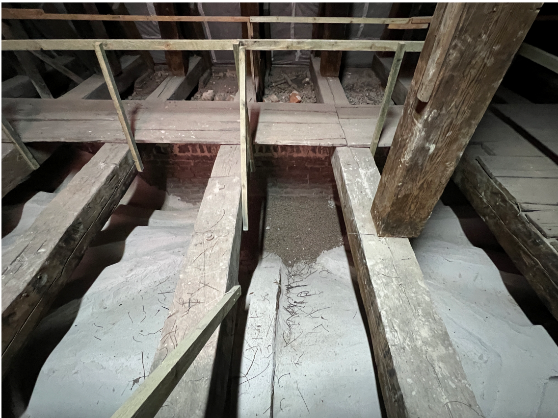
Wypełnienie pach sklepiennych keramzytem.
