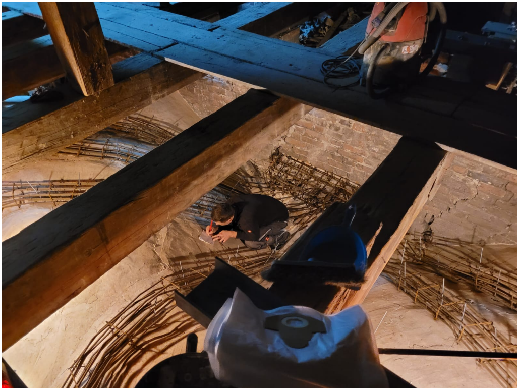
Zbrojenia gurtów wzmacniających żebra.
