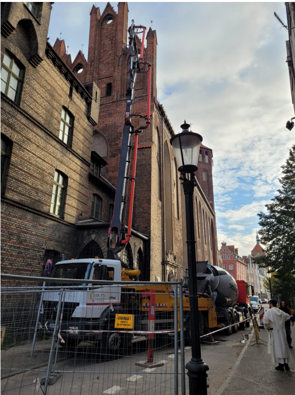
Betonowanie konstrukcji gurtów.
