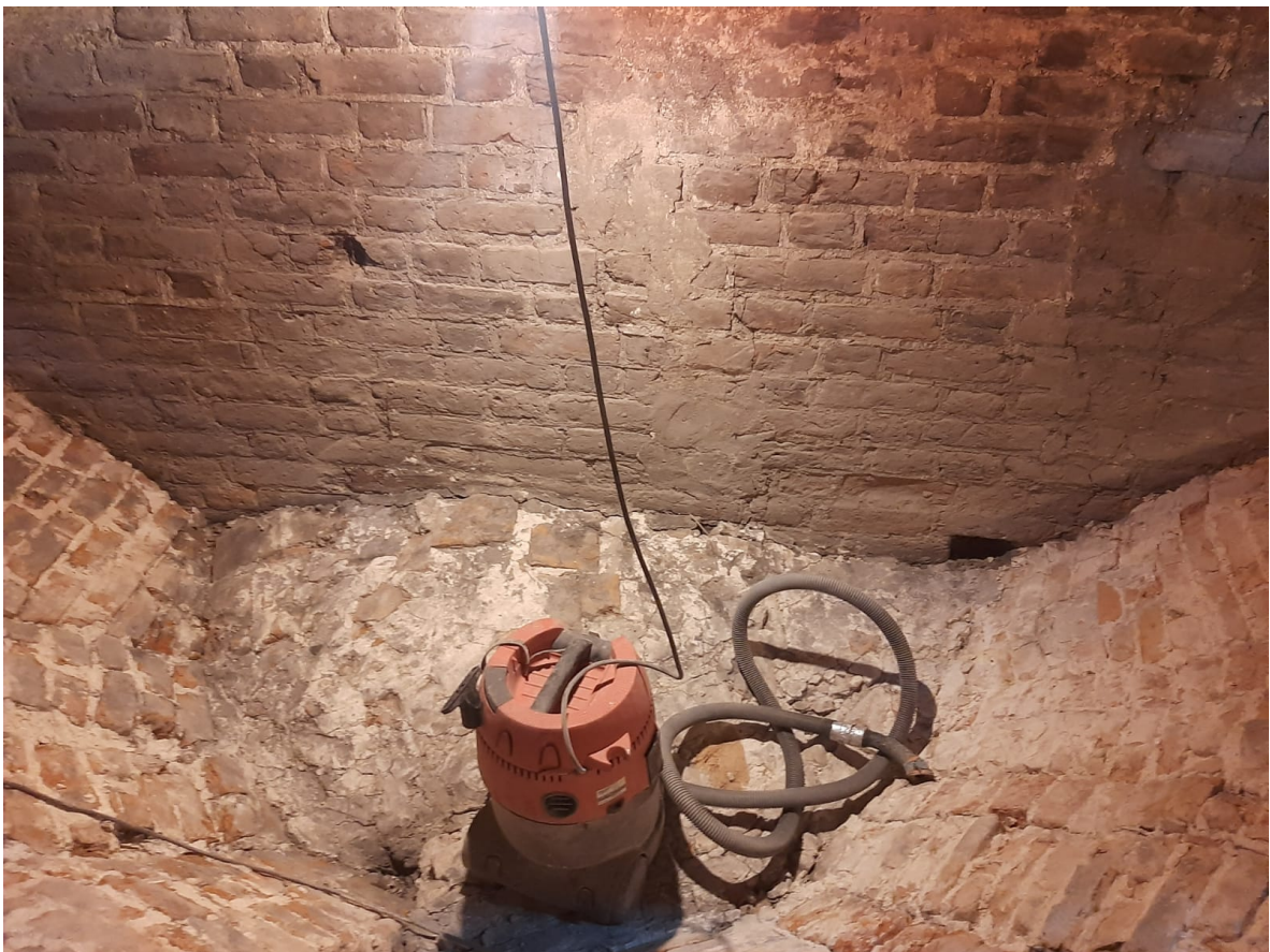
Oczyszczanie powierzchni sklepień z polepy i zanieczyszczeń.
