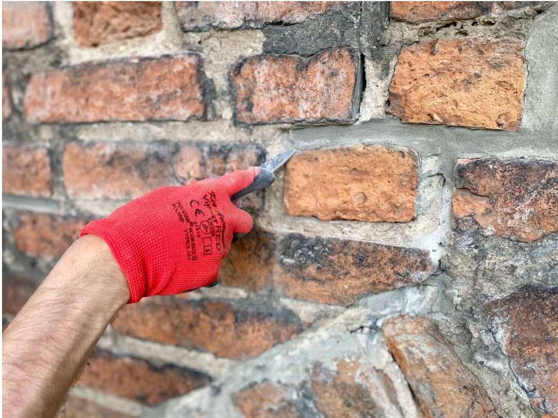
Ilustracja 20. Usuwanie zapraw cementowych stanowiących zagrożenie dla materii zabytkowej.
