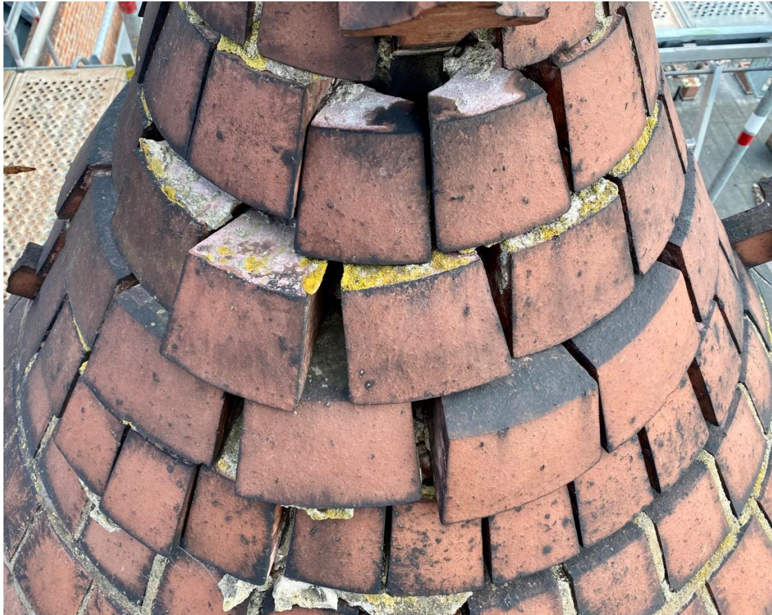
Ilustracja 17. Uszkodzone sterczyny wieńczące pseudotranseptu, przeznaczone do naprawy ze środków MKiDN.
