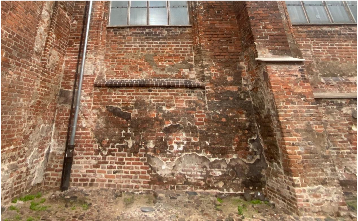
Ilustracja 48. Drugie przęsło nawy południowej po zakończeniu prac konserwatorskich
