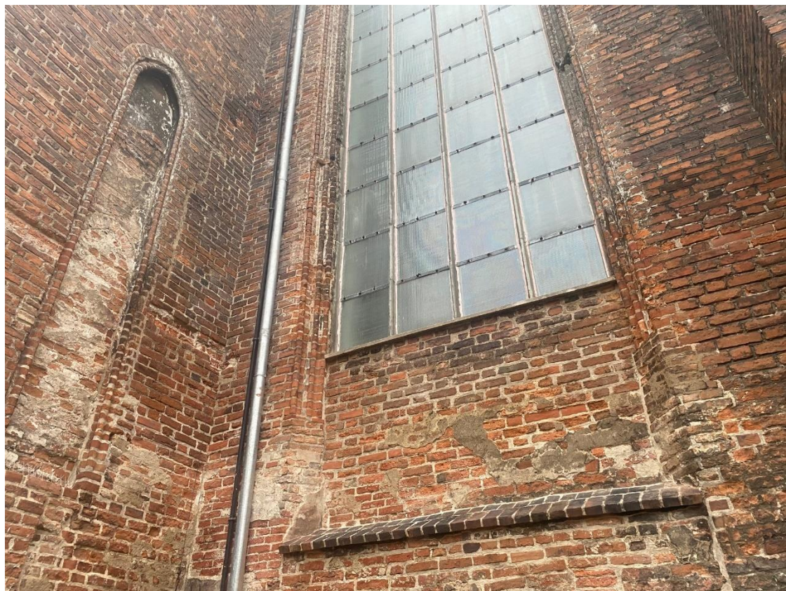
Ilustracja 43. Drugie przęsło oraz wschodnia ściana pseudotranseptu po zakończeniu prac konserwatorskich
