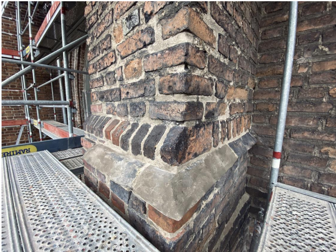
Ilustracja 32. Obiekt po zakończeniu prac konserwatorskich.
