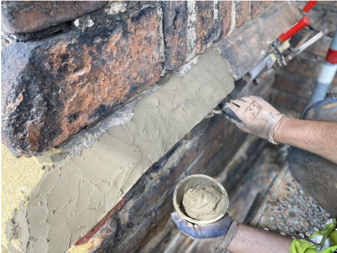
Ilustracja 26. Uzupełnianie ubytków detalu kamiennego.
