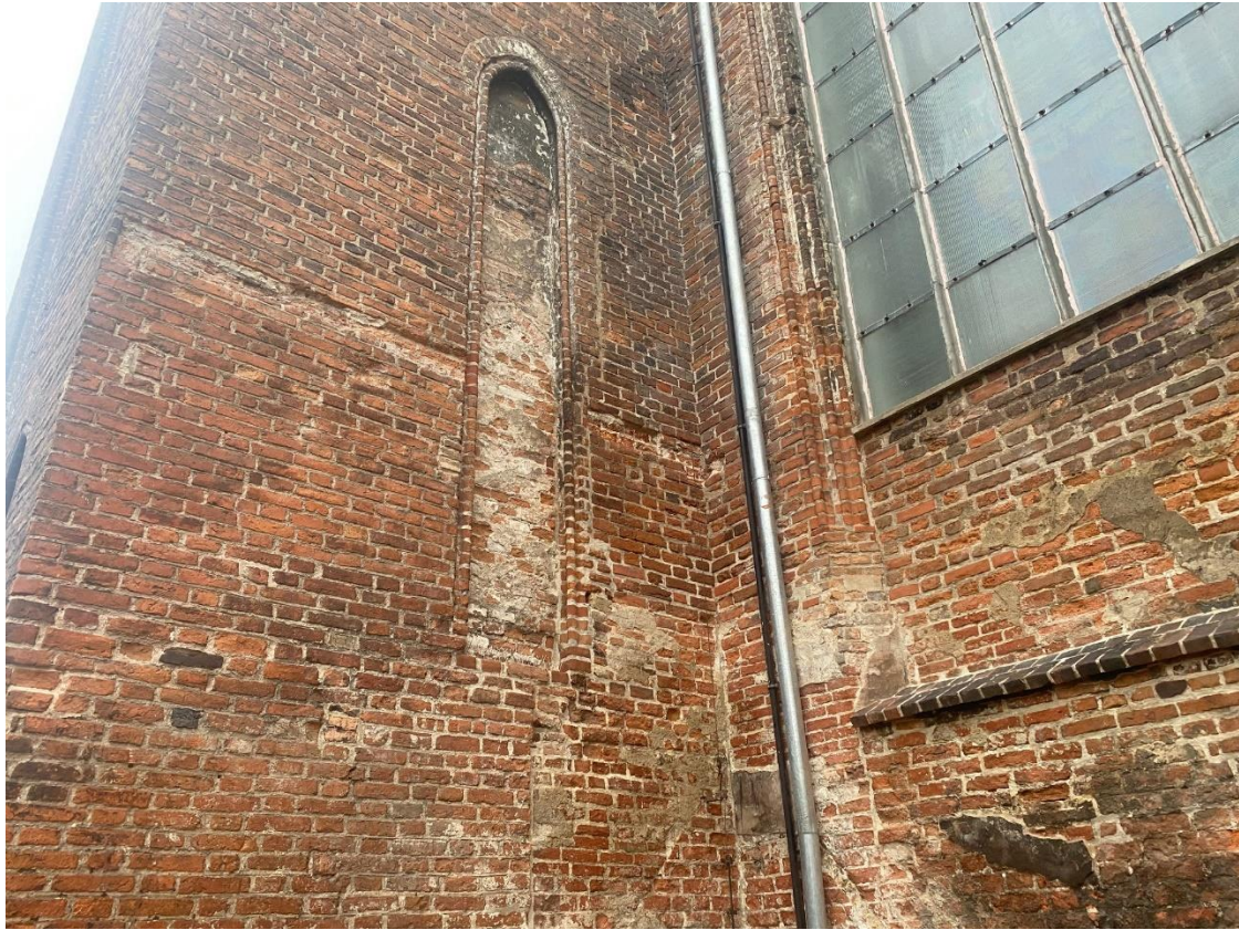
Ilustracja 42. Drugie przęsło oraz wschodnia ściana pseudotranseptu po zakończeniu prac konserwatorskich
