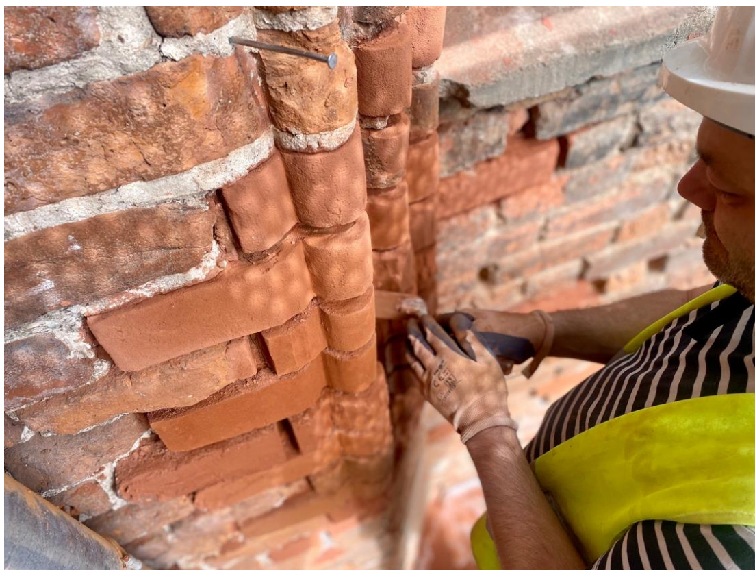
Ilustracja 24. Obróbka mechaniczna zaprawy do uzupełnienia ubytków.
