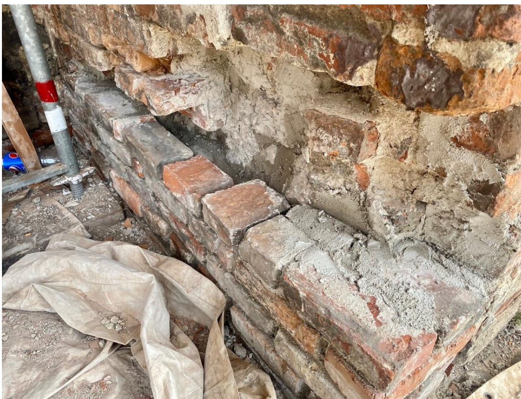
Ilustracja 22. Prace murarskie w obrębie przypory.
