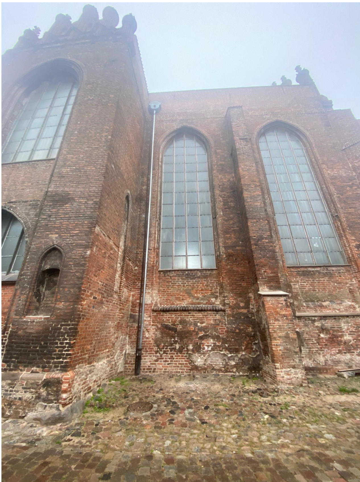
Ilustracja 40. Drugie przęsło oraz wschodnia ściana pseudotranseptu po zakończeniu prac konserwatorskich
