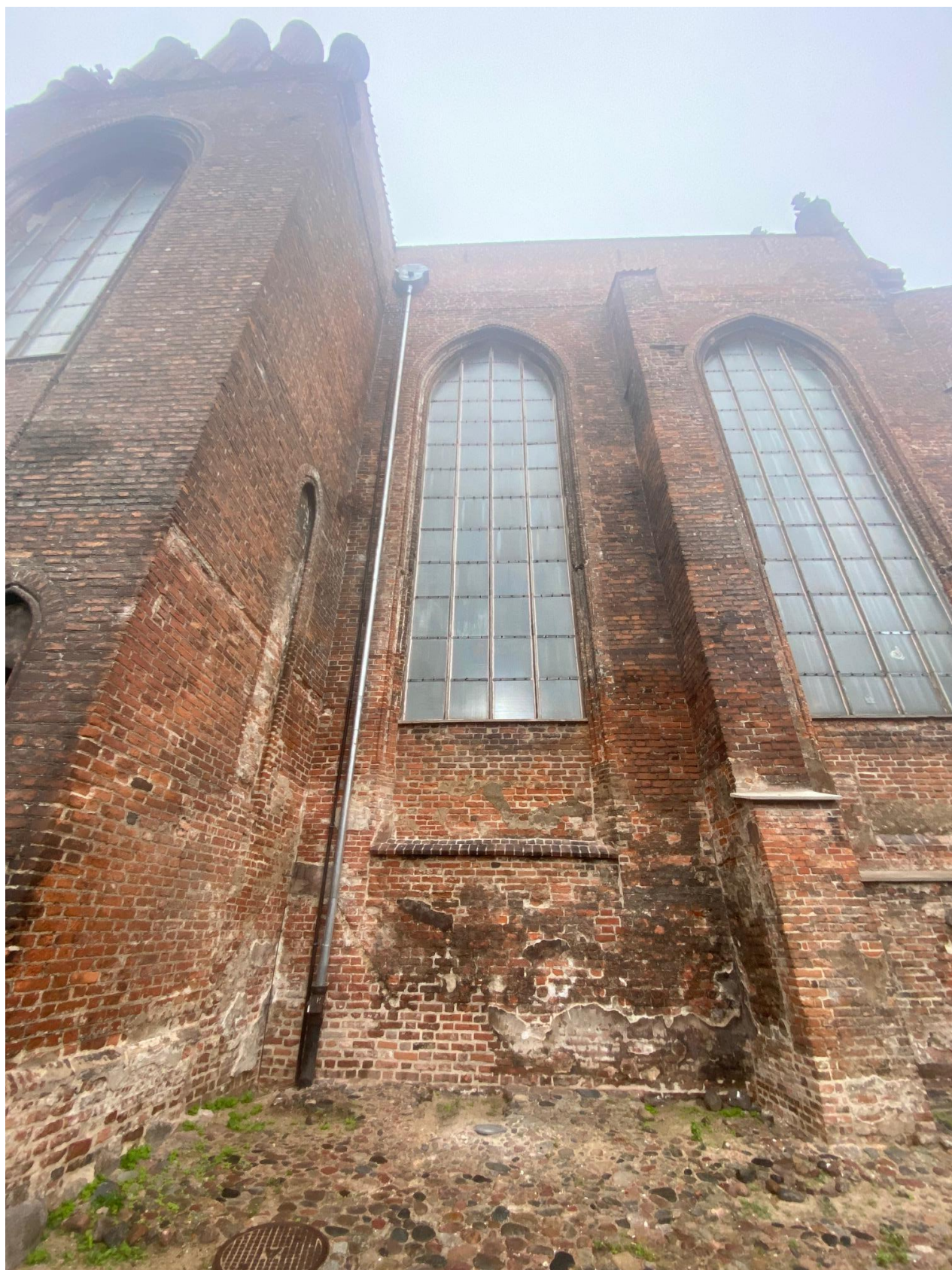
Ilustracja 41. Drugie przęsło oraz wschodnia ściana pseudotranseptu po zakończeniu prac konserwatorskich
