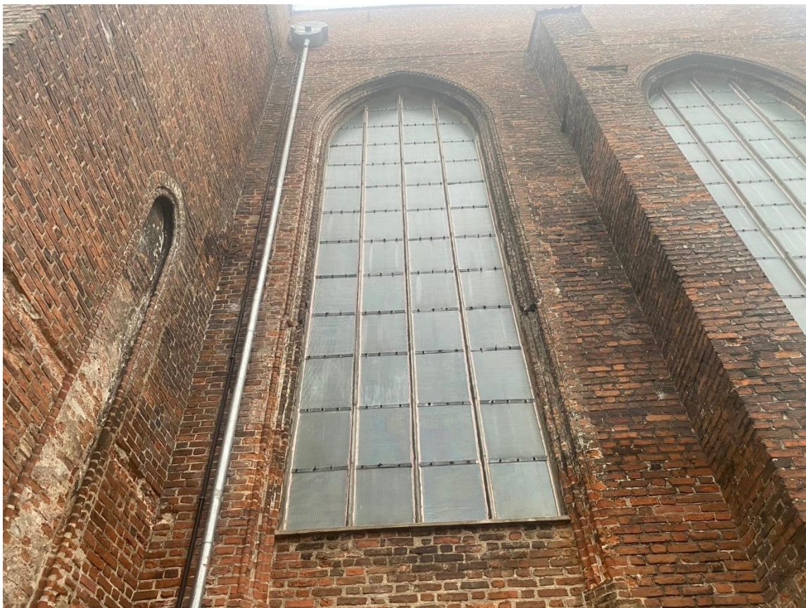
Ilustracja 46. Drugie przęsło nawy południowej po zakończeniu prac konserwatorskich
