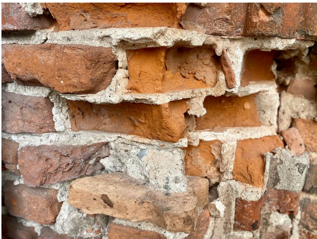
Ilustracja 10. Erozja ceramicznych kształtek.
