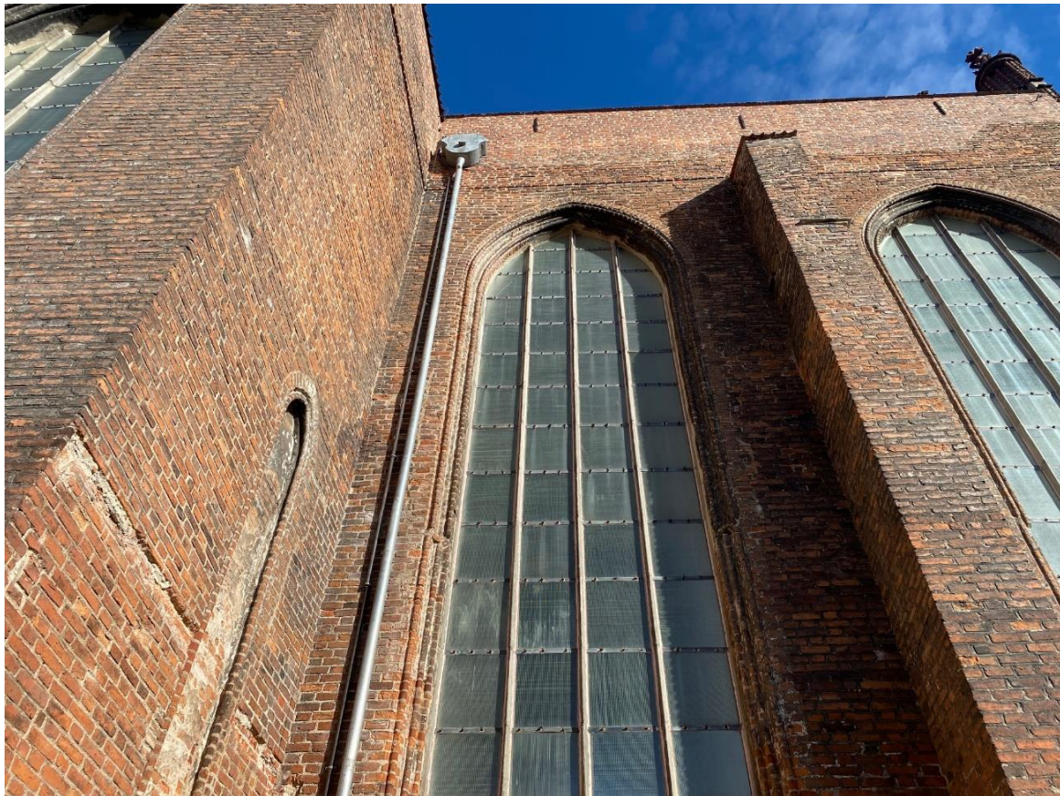
Ilustracja 38. Drugie przęsło oraz wschodnia ściana pseudotranseptu po zakończeniu prac konserwatorskich.
