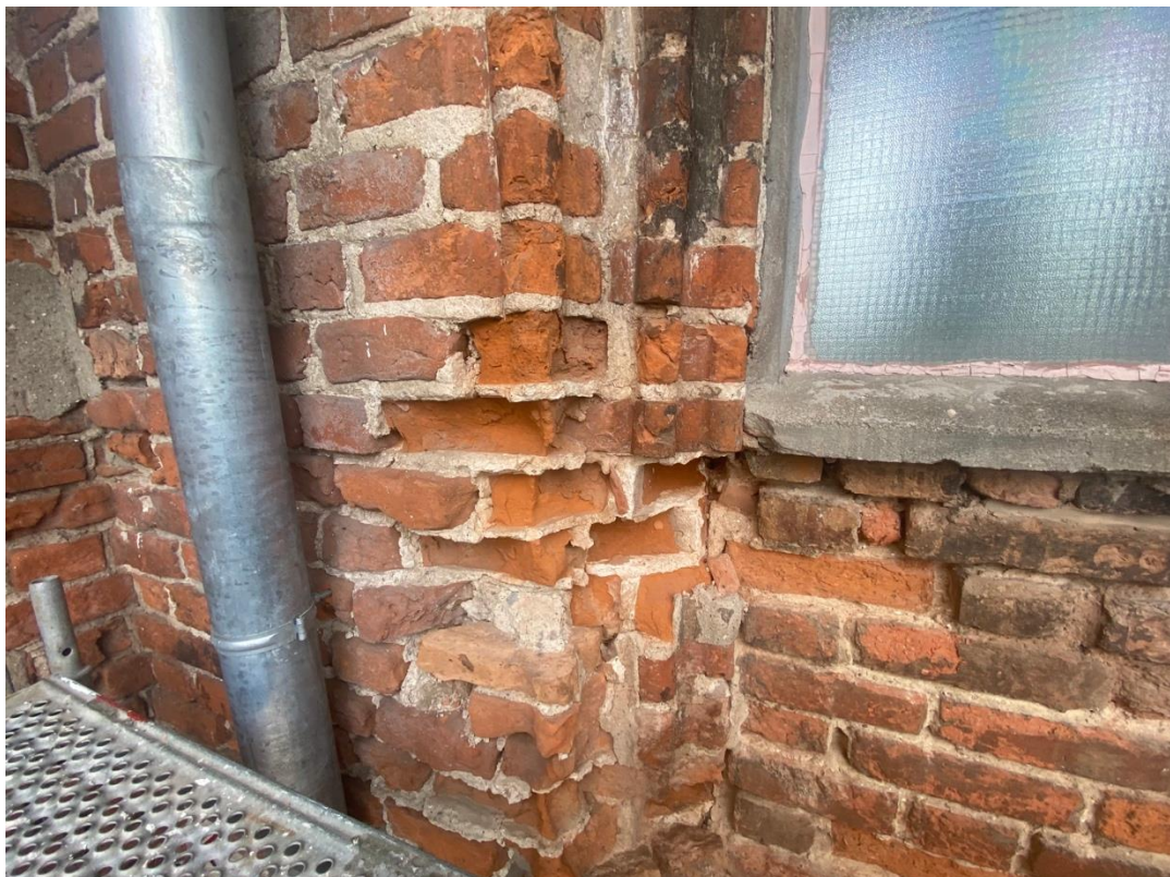
Ilustracja 9. Erozja ceramicznych kształtek.
