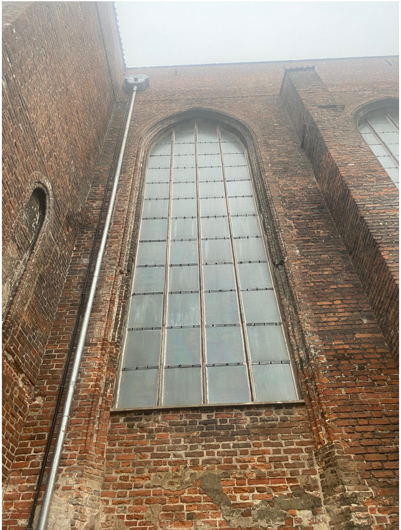
Ilustracja 47. Drugie przęsło nawy południowej po zakończeniu prac konserwatorskich
