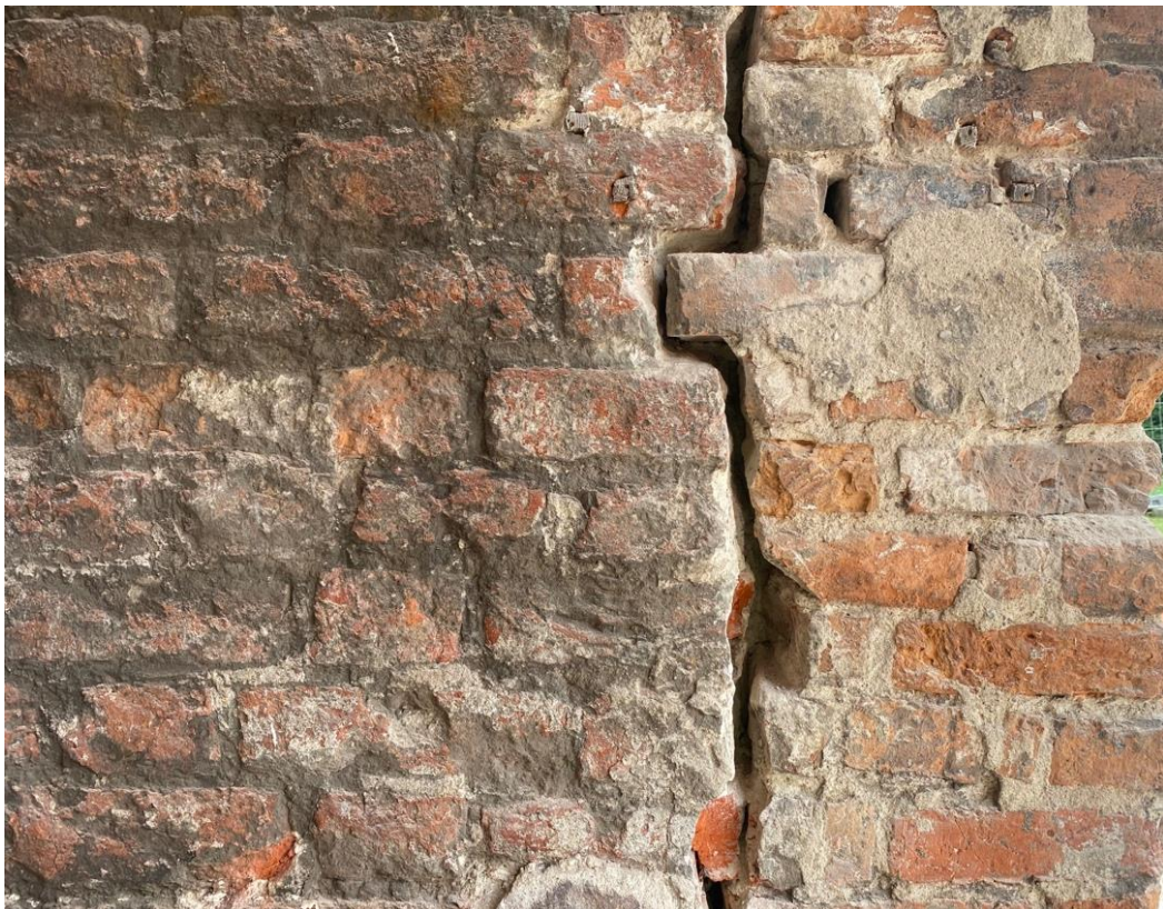
Ilustracja 21. Oczyszczenie pęknięć w murze.
