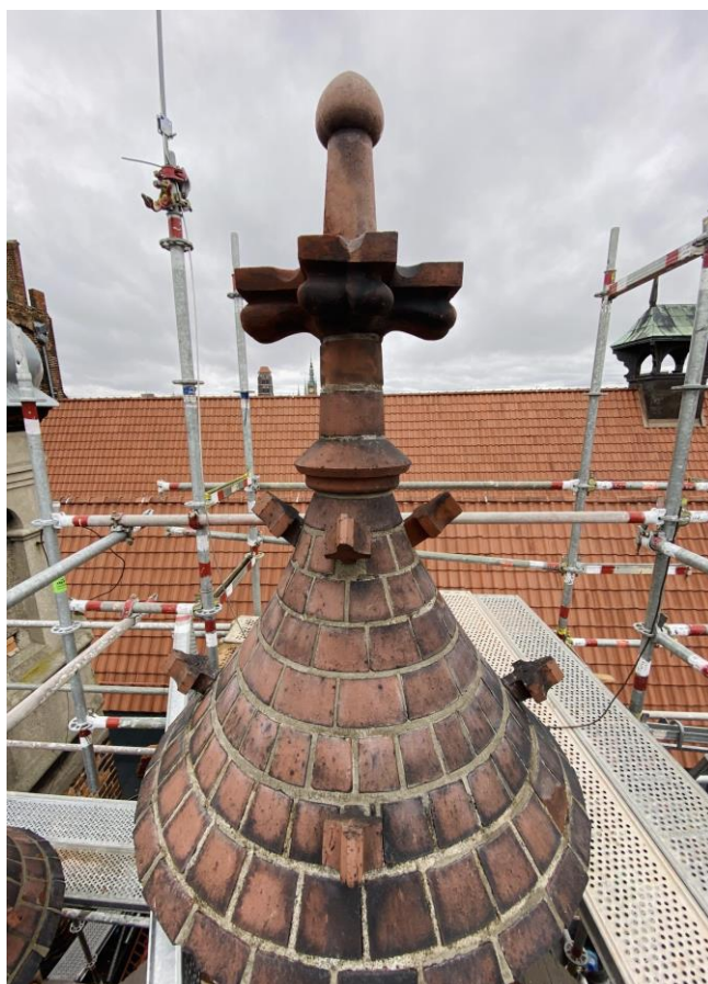
Ilustracja 36. Obiekt po zakończeniu prac konserwatorskich.
