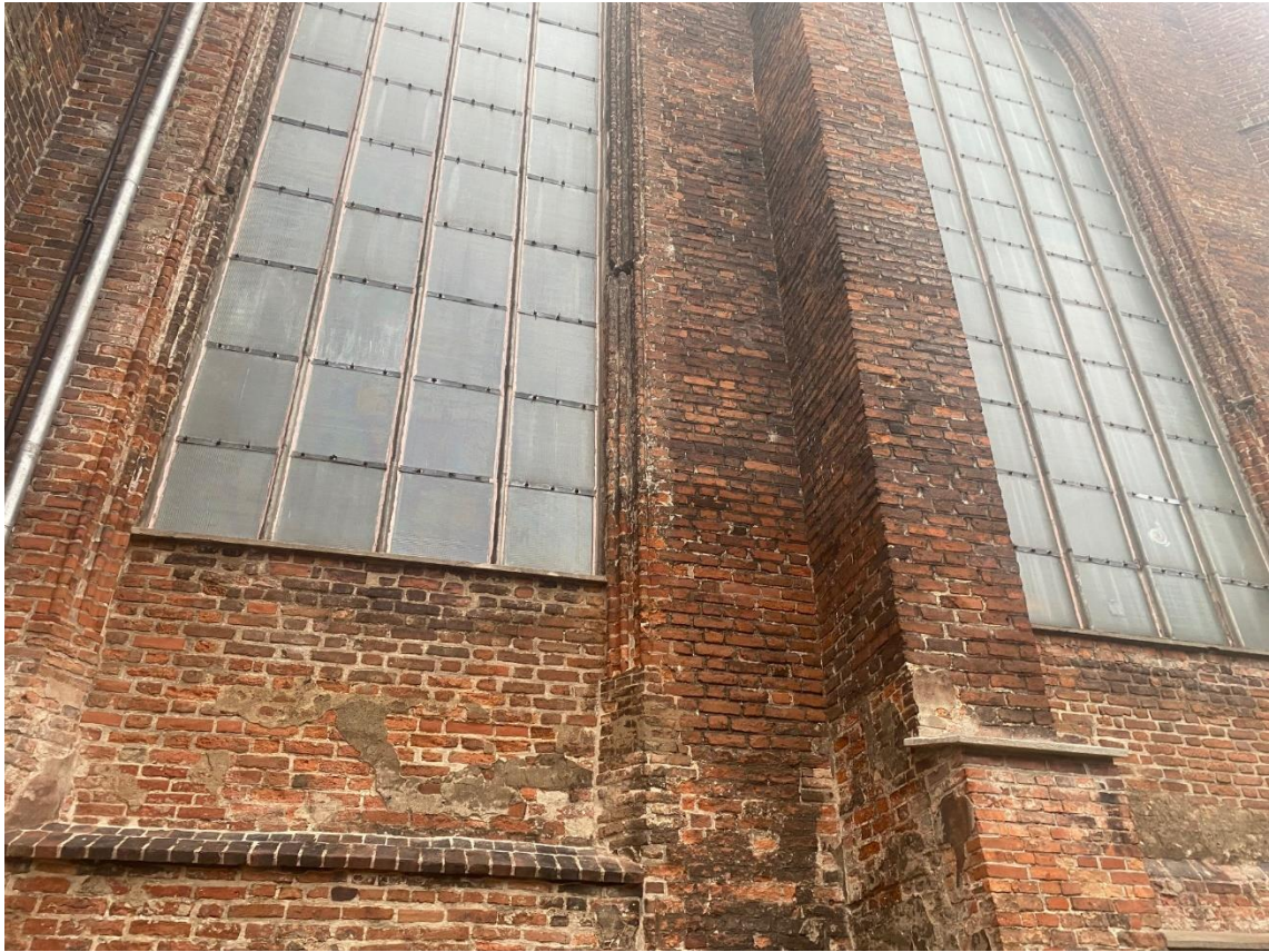
Ilustracja 45. Drugie przęsło nawy południowej po zakończeniu prac konserwatorskich
