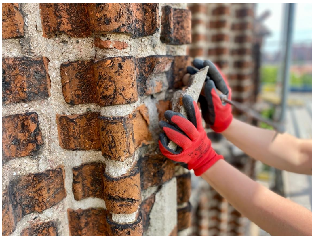
Ilustracja 19. Demontaż elementów, które powodowały zagrożenie.
