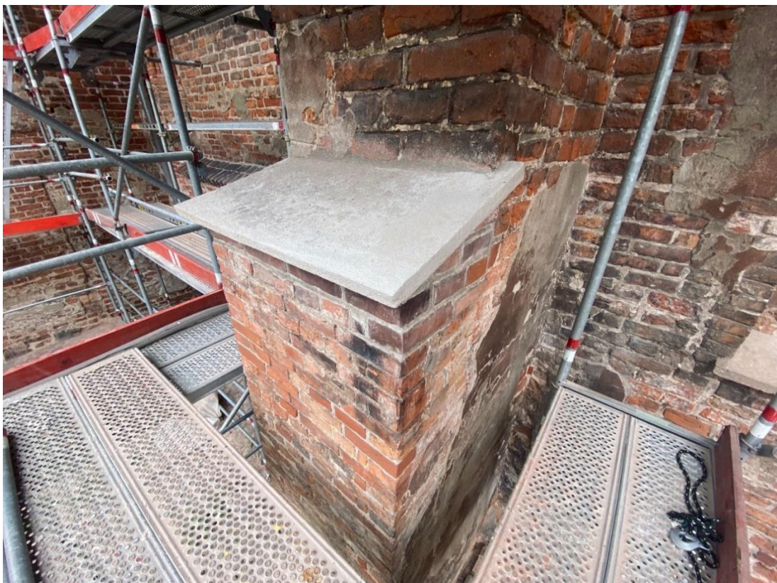
Ilustracja 33. Obiekt po zakończeniu prac konserwatorskich.
