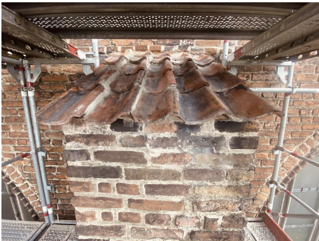
Ilustracja 35. Obiekt po zakończeniu prac konserwatorskich.
