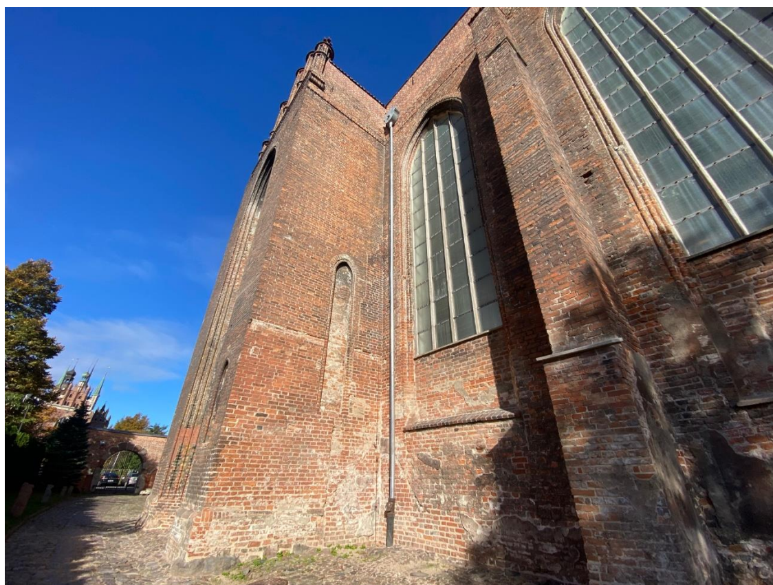
Ilustracja 37. Drugie przęsło oraz wschodnia ściana pseudotranseptu po zakończeniu prac konserwatorskich.
