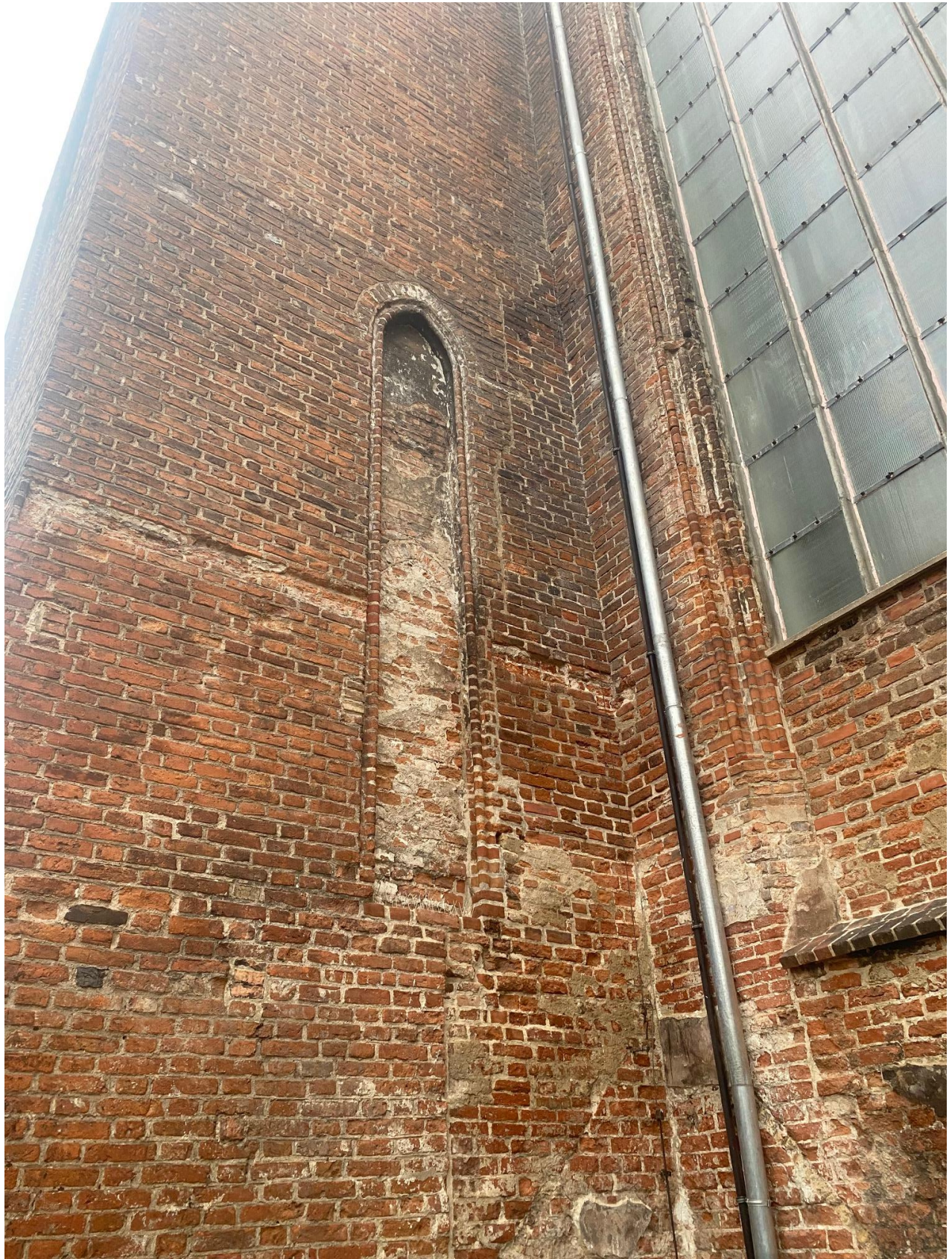
Ilustracja 44. Drugie przęsło oraz wschodnia ściana pseudotranseptu po zakończeniu prac konserwatorskich
