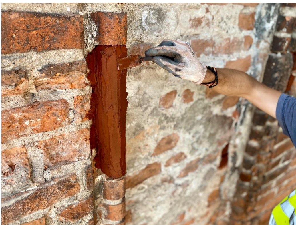
Ilustracja 23. Uzupełnianie ubytków ceramicznych kształtek.
