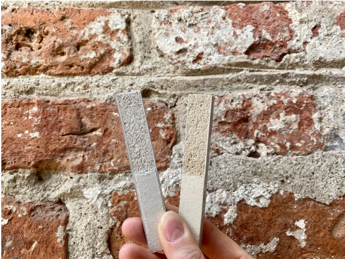
Ilustracja 28. Dobieranie koloru zaprawy spoinującej.
