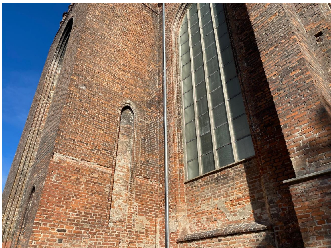
Ilustracja 39. Drugie przęsło oraz wschodnia ściana pseudotranseptu po zakończeniu prac konserwatorskich
