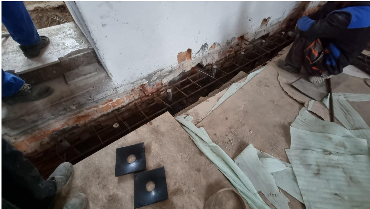
Ilustracja 25. Zbrojenie oczepu
