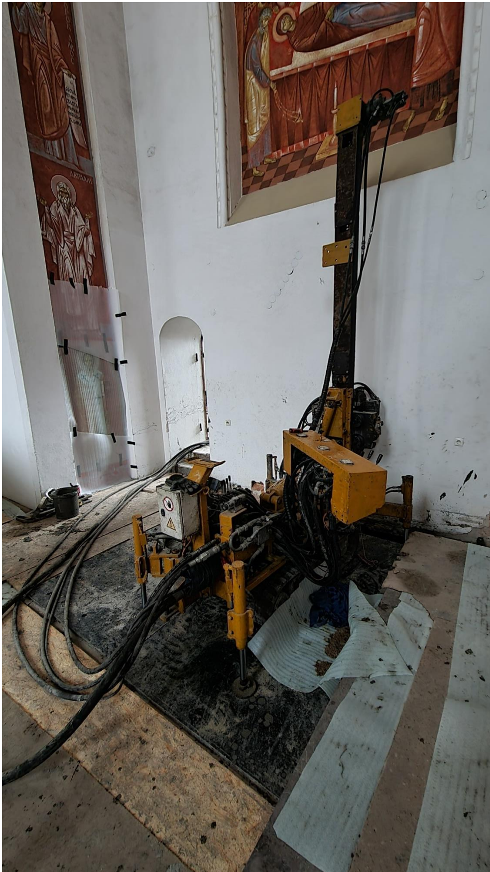
Ilustracja 29. W trakcie prac
