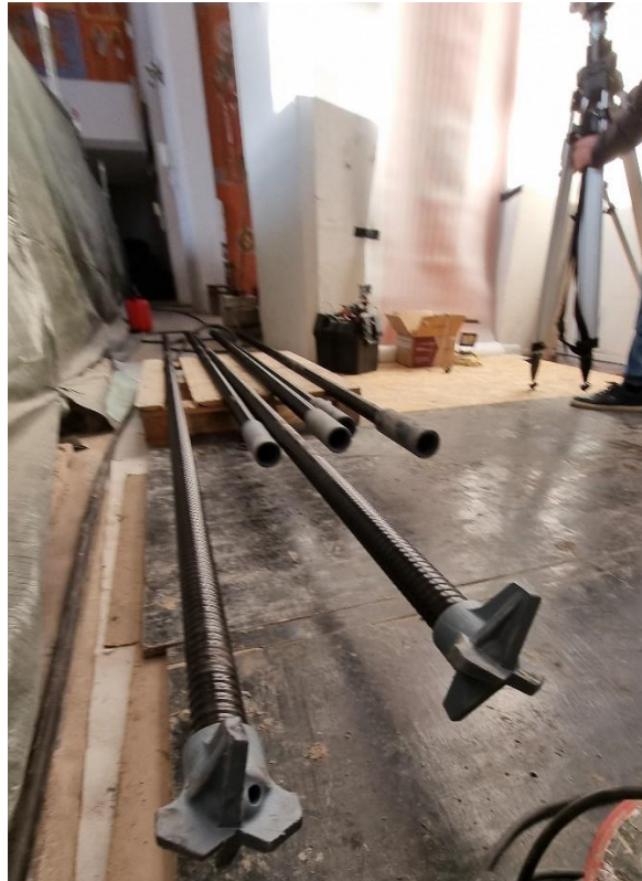
Ilustracja 23. Zbrojenie z głowicami przed osadzeniem
