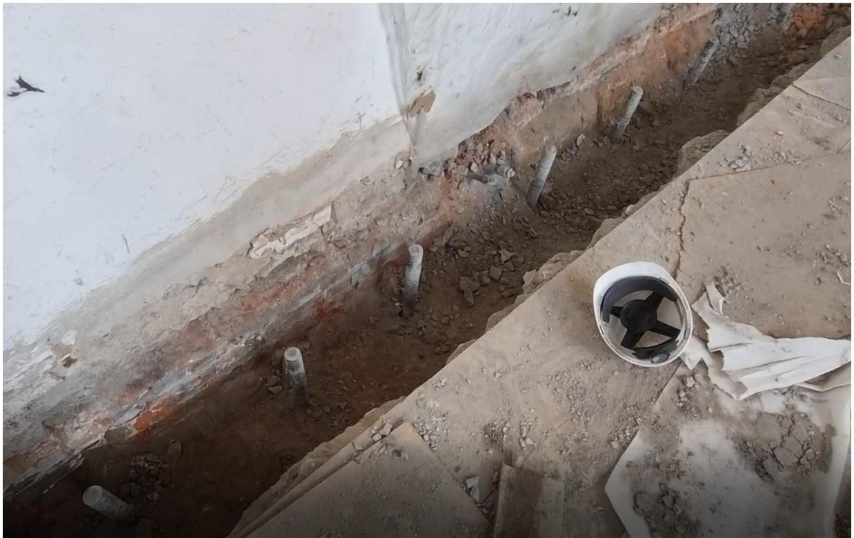
Ilustracja 21. Osadzenie zbrojenia mikropali
