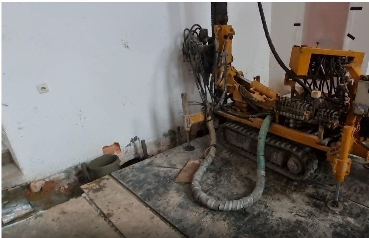
Ilustracja 24. W trakcie prac
