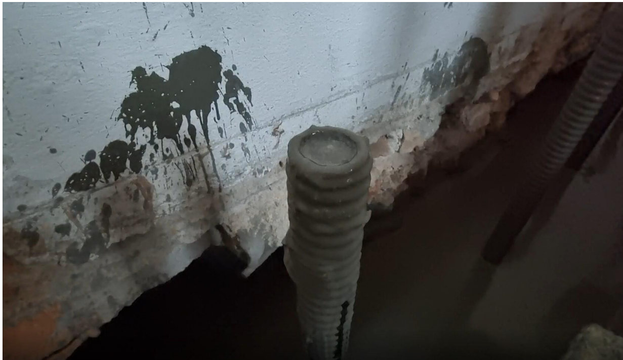
Ilustracja 26. Zbliżenie na zbrojenie mikropali
