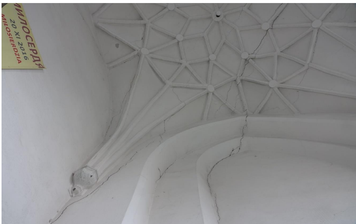
Ilustracja 14. Silnie spękanе sklepienie kaplicy północnej
