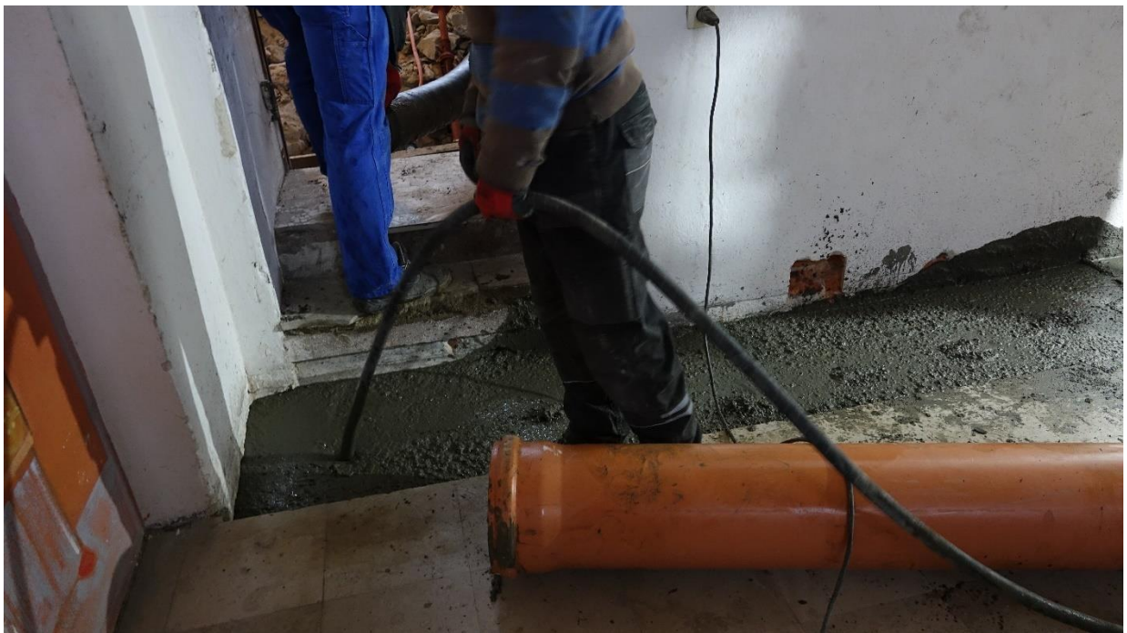
Ilustracja 36. Zalewanie powierzchni betonem
