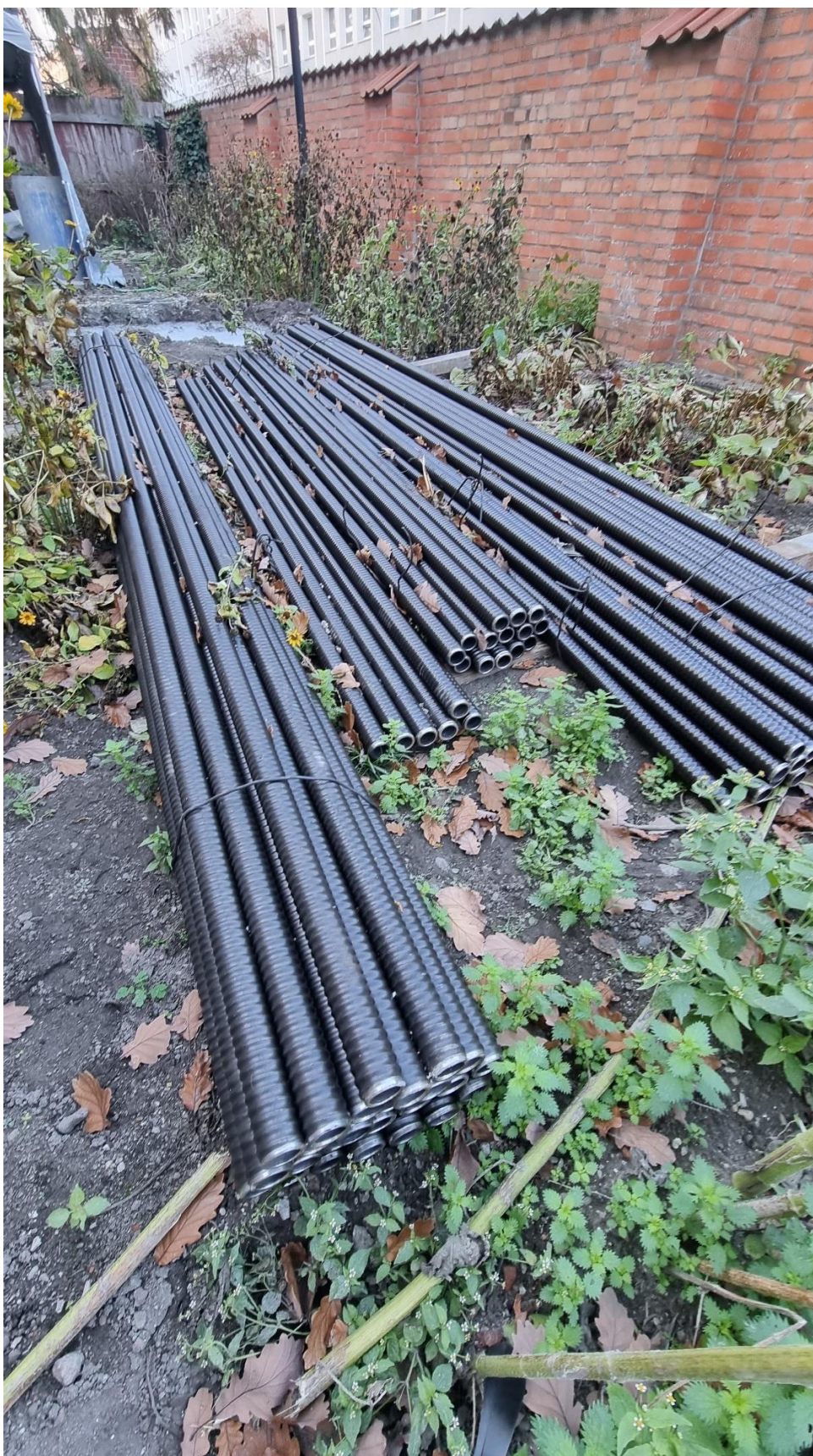
Ilustracja 17. Zbrojenia mikropali
