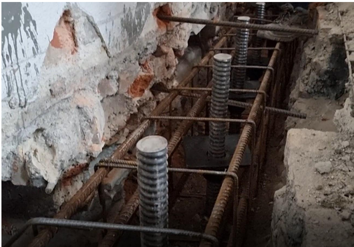
Ilustracja 31. Zbrojenie oczepu
