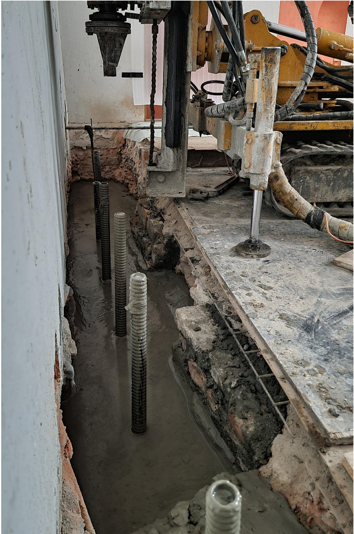
Ilustracja 25. Iniekcja zaczynu cementowego
