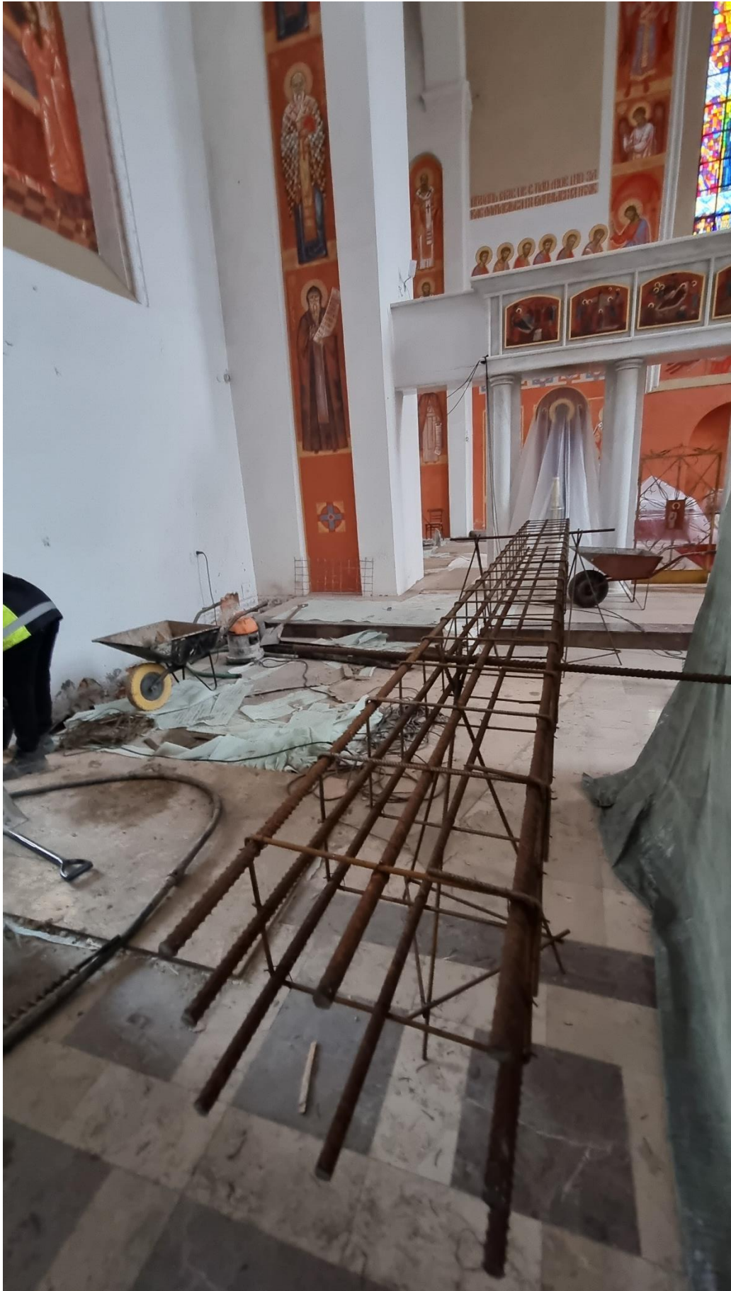
Ilustracja 30. W trakcie prac – zbrojenie oczepu
