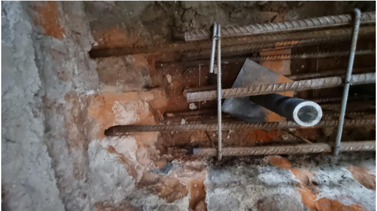
Ilustracja 32. Zbrojenie oczepu
