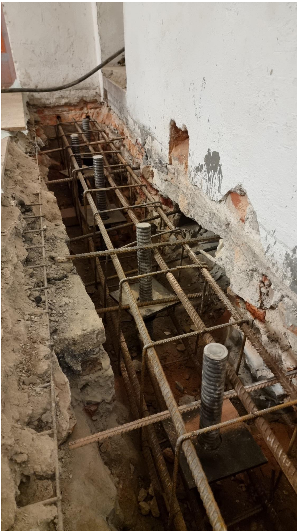
Ilustracja 34. Zbrojenie oczepu
