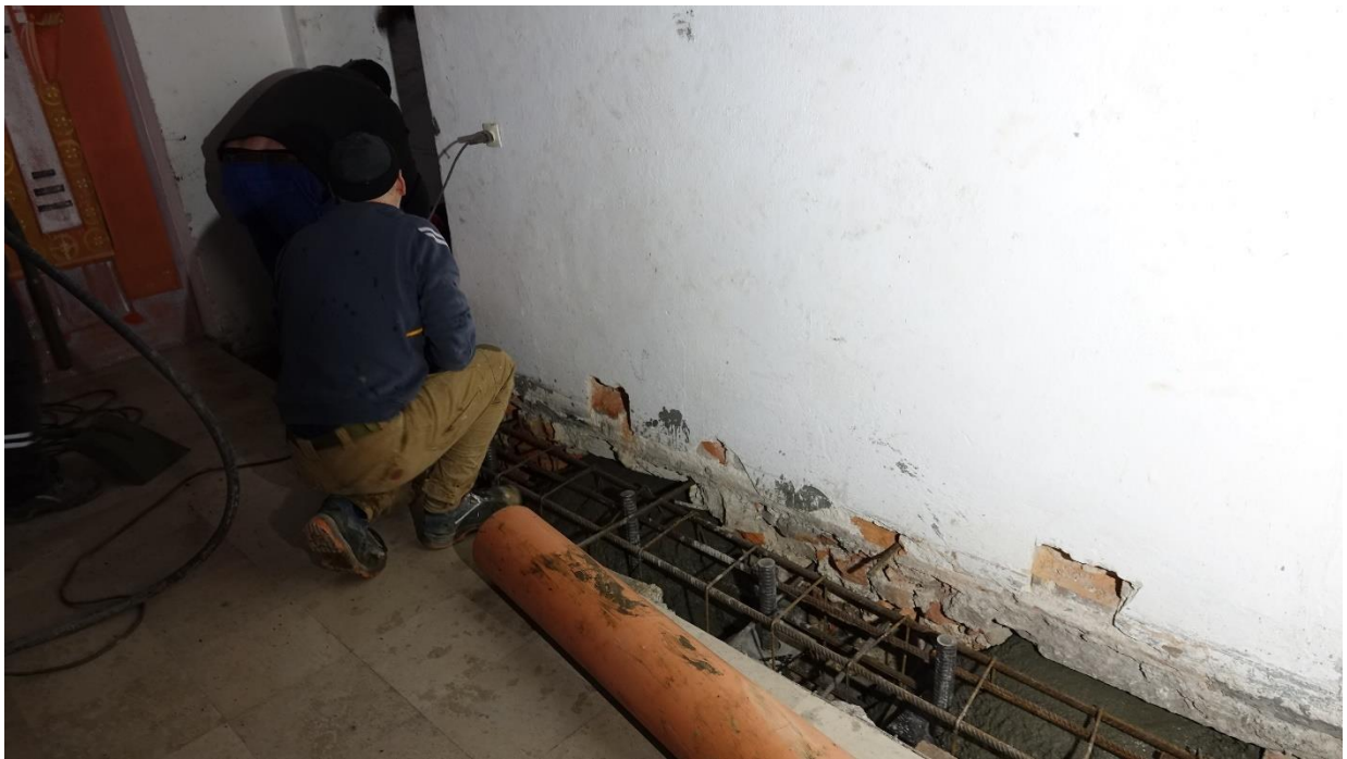
Ilustracja 35. Zalewanie powierzchni betonem
