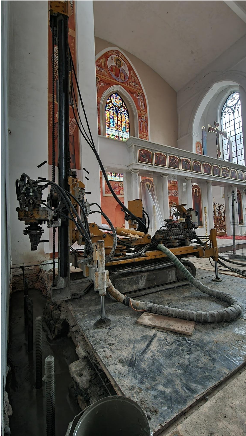
Ilustracja 28. W trakcie prac
