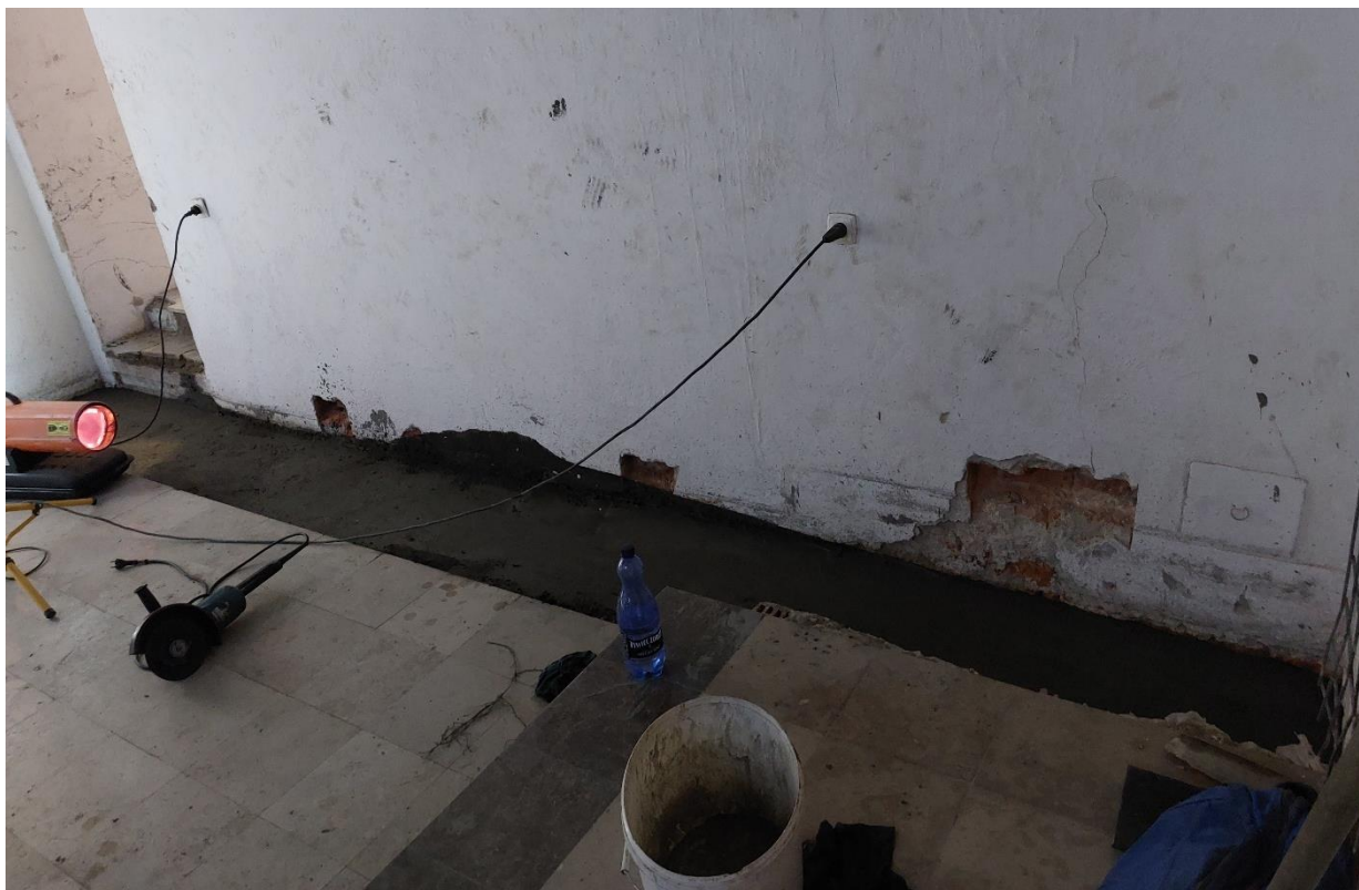
Ilustracja 37. Po zakończeniu prac
