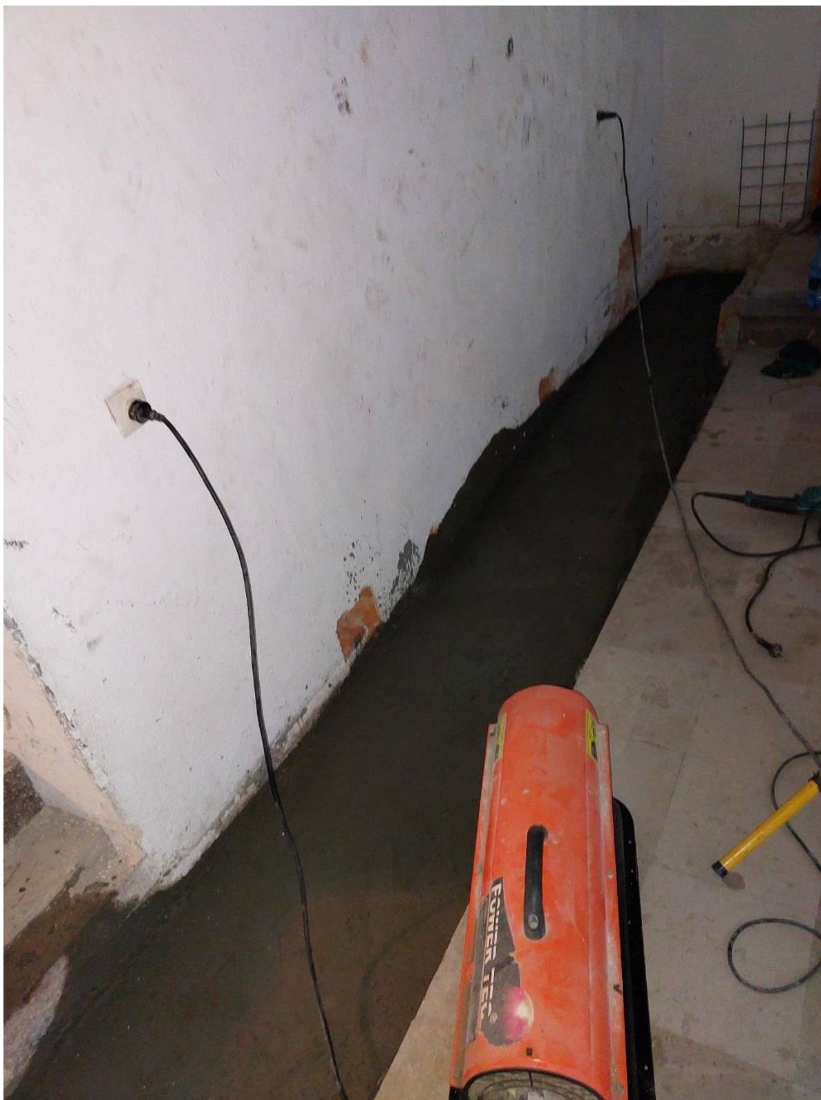
Ilustracja 39. Po zakończeniu prac
