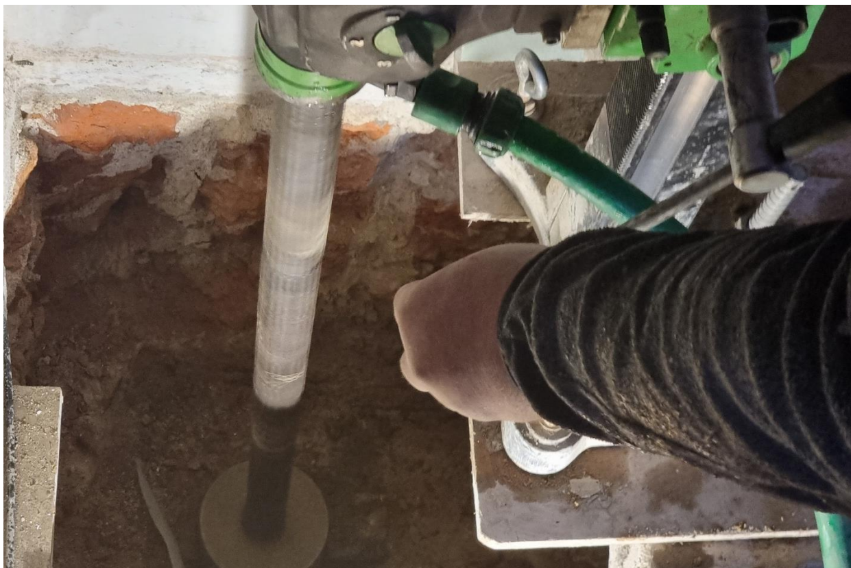
Ilustracja 27. Osadzenie zbrojenia mikropali
