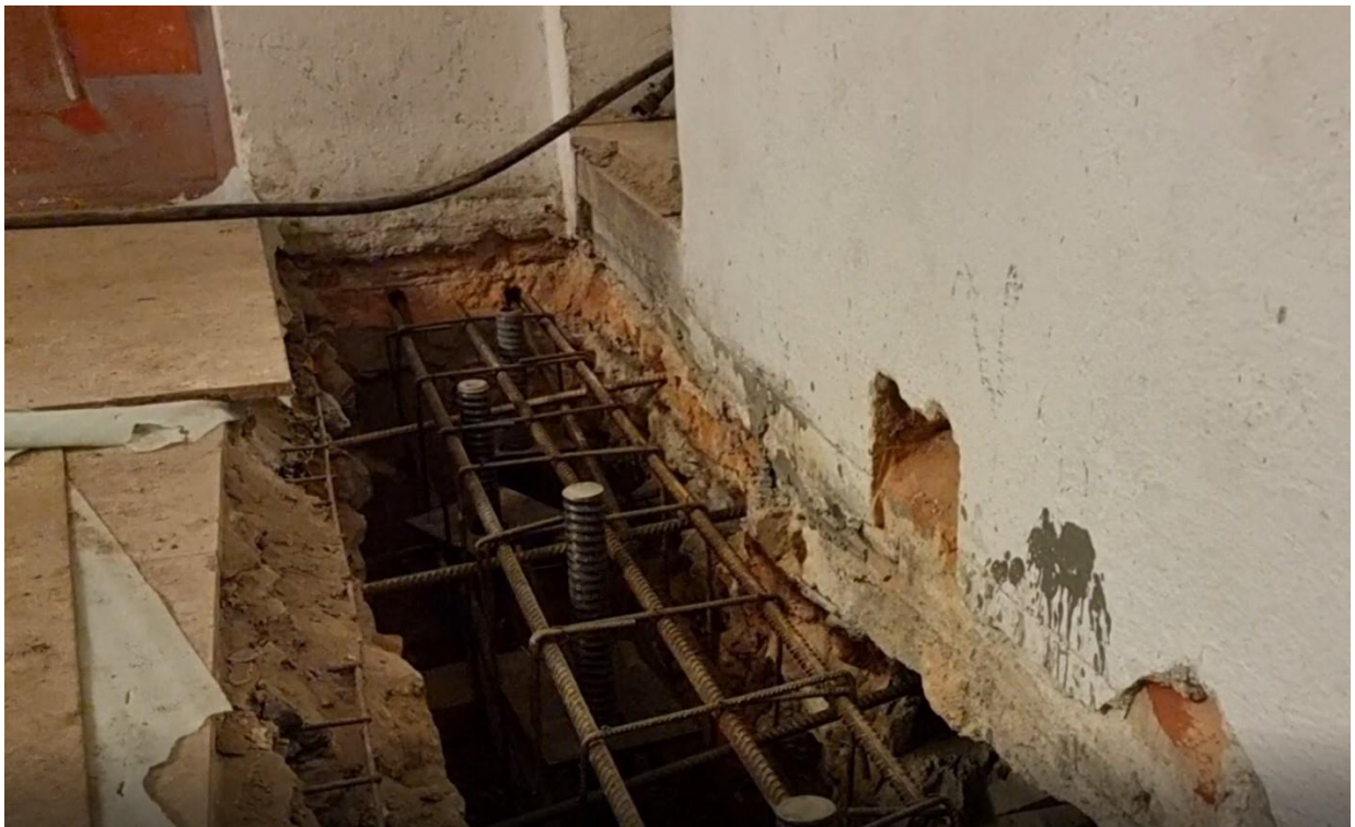
Ilustracja 33. Zbrojenie oczepu
