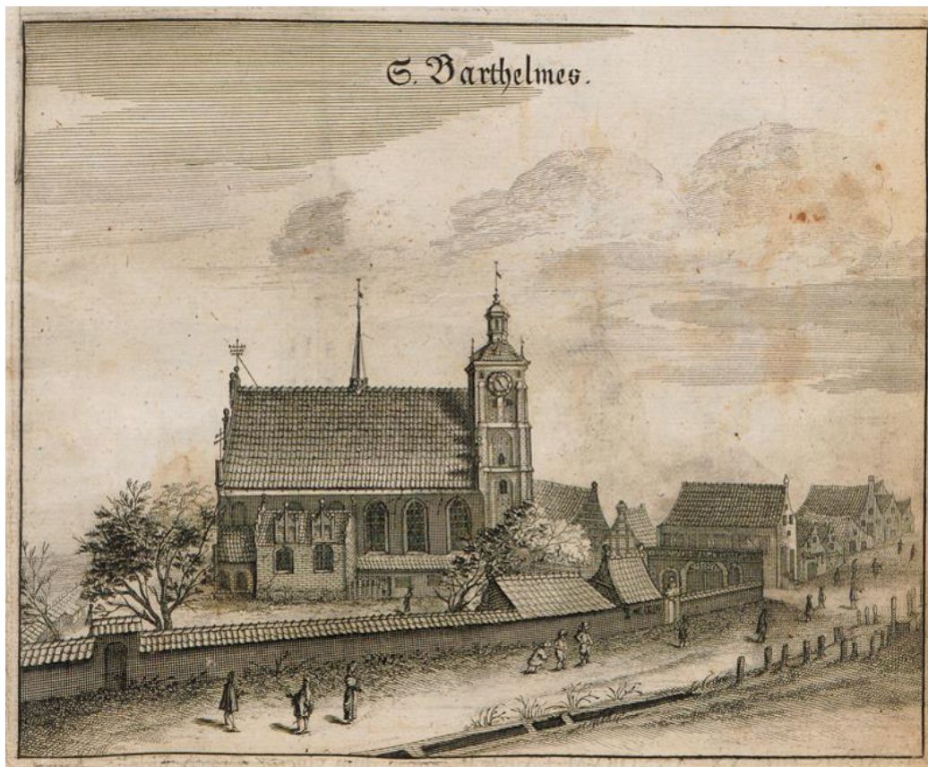
Ilustracja 3. Kościół pw. św. Bartłomieja od strony północnej, 1687, P. Willer [źródło: gedanopedia]
