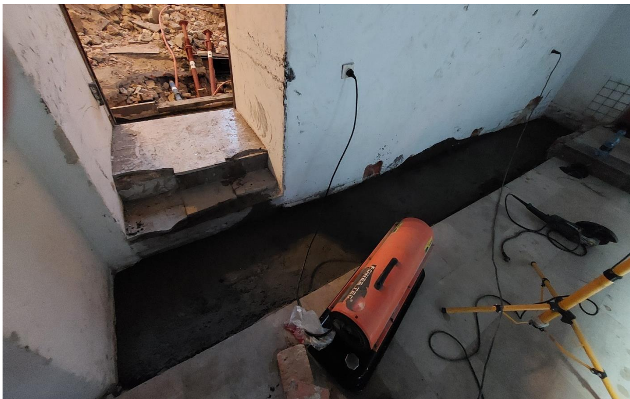
Ilustracja 38. Po zakończeniu prac
