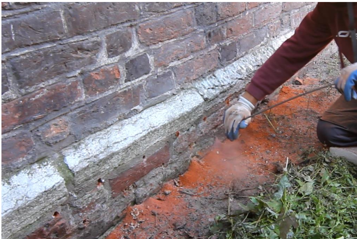
Ilustracja 22. Oczyszczanie otworów z materiałów luźnych.
