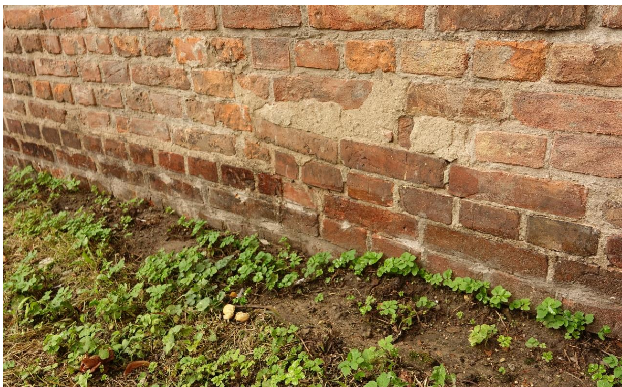
Ilustracja 35. Obiekt po zakończeniu prac konserwatorskich.
