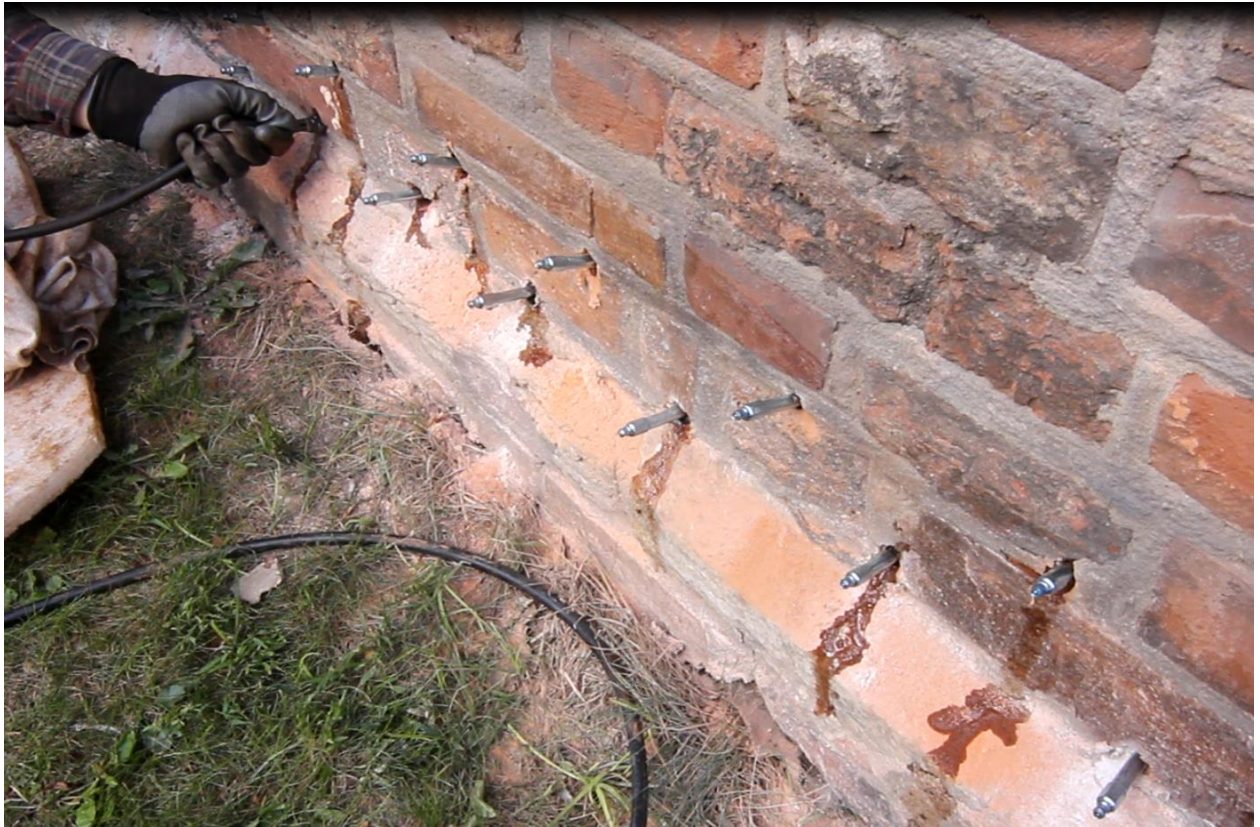
Ilustracja 27. Ciśnieniowa aplikacja żywicy – powtórna aplikacja do wysycenia szczelin.
