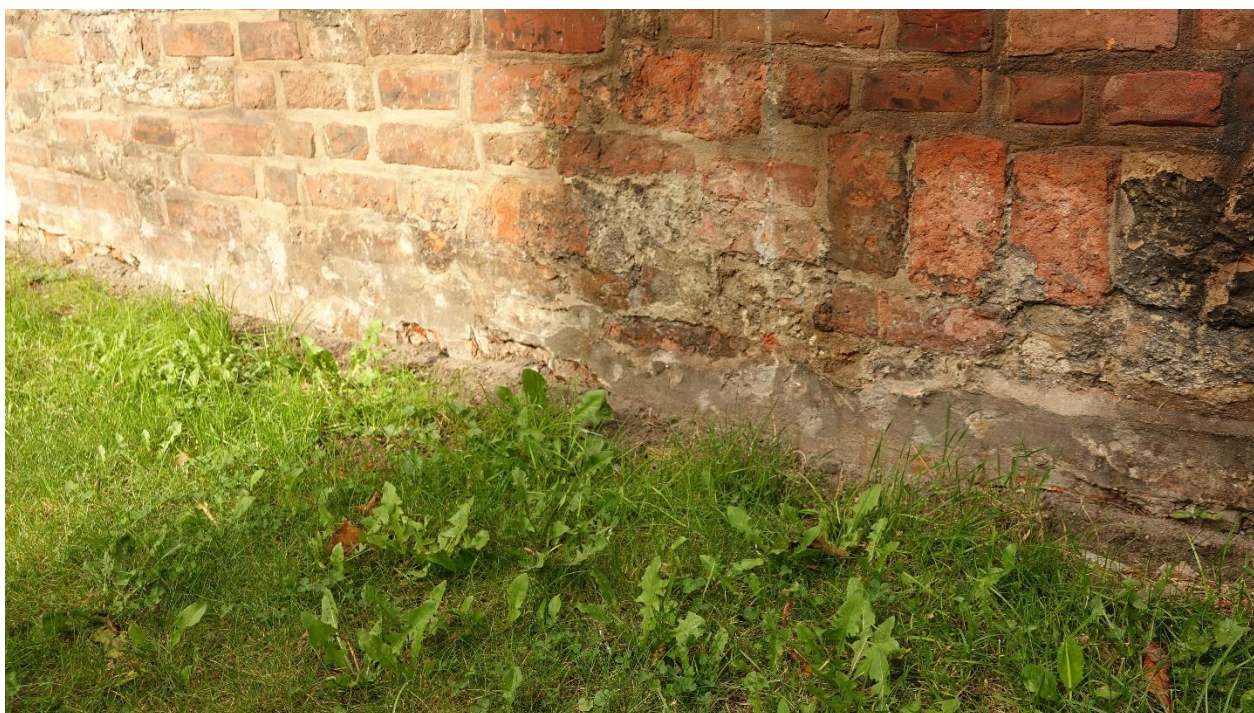
Ilustracja 31. Obiekt po zakończeniu prac konserwatorskich.
