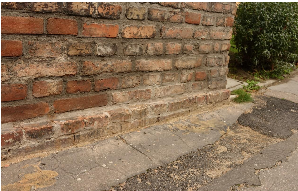
Ilustracja 37. Obiekt po zakończeniu prac konserwatorskich.
