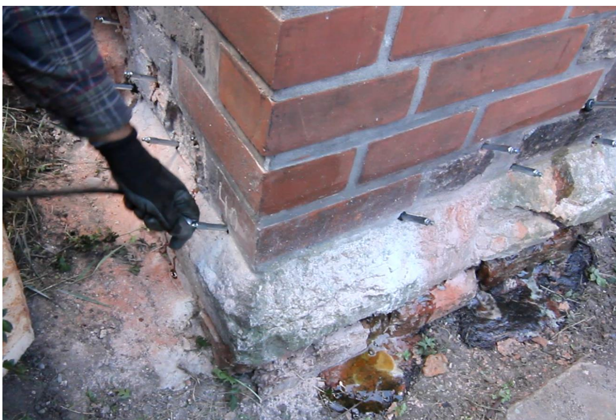
Ilustracja 30. Ciśnieniowa aplikacja żywicy – powtórna aplikacja do wysycenia szczelin.
