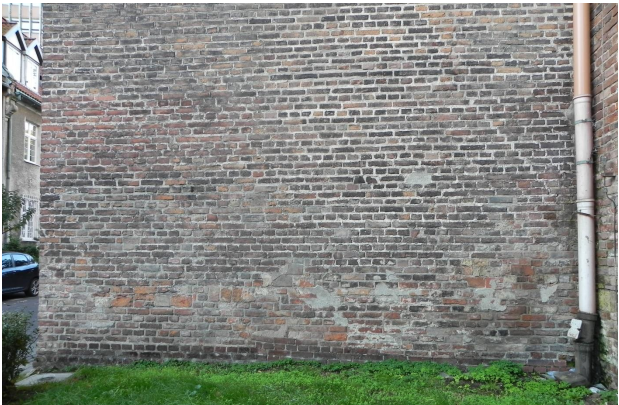
Ilustracja 40. Obiekt po zakończeniu prac konserwatorskich. Widok na wschodnią ścianę kruchty przy południowej ścianie kościoła.
