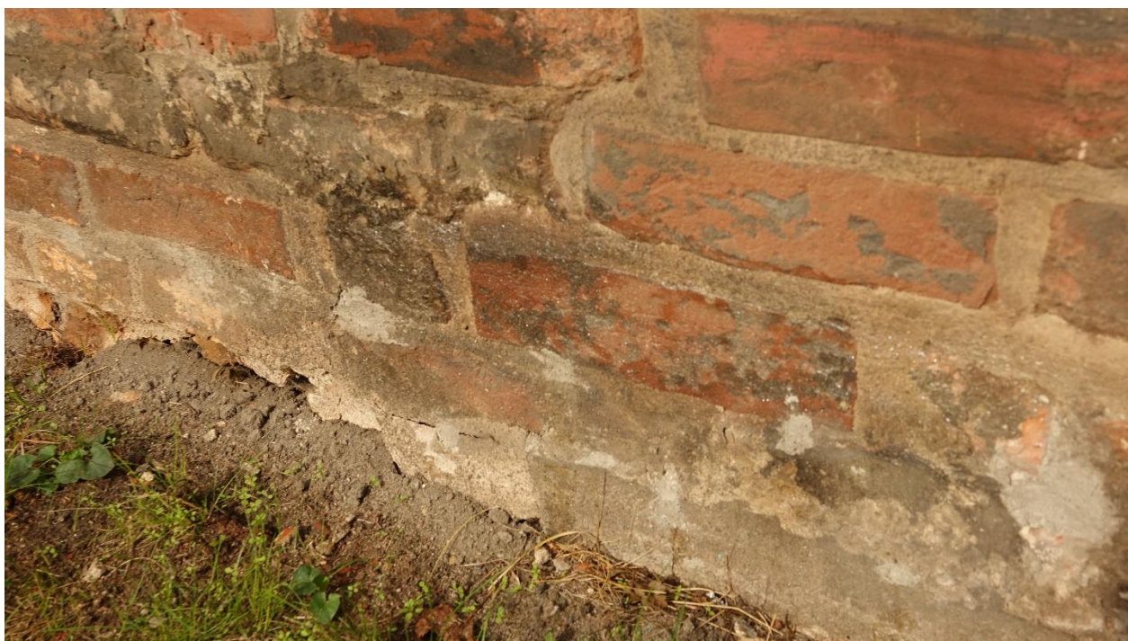
Ilustracja 32. Obiekt po zakończeniu prac konserwatorskich.
