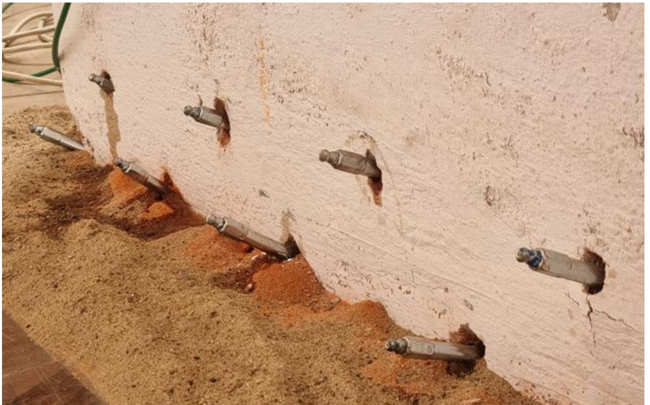
Ilustracja 20. Stan po wysyceniu odwiertów żywicą.
