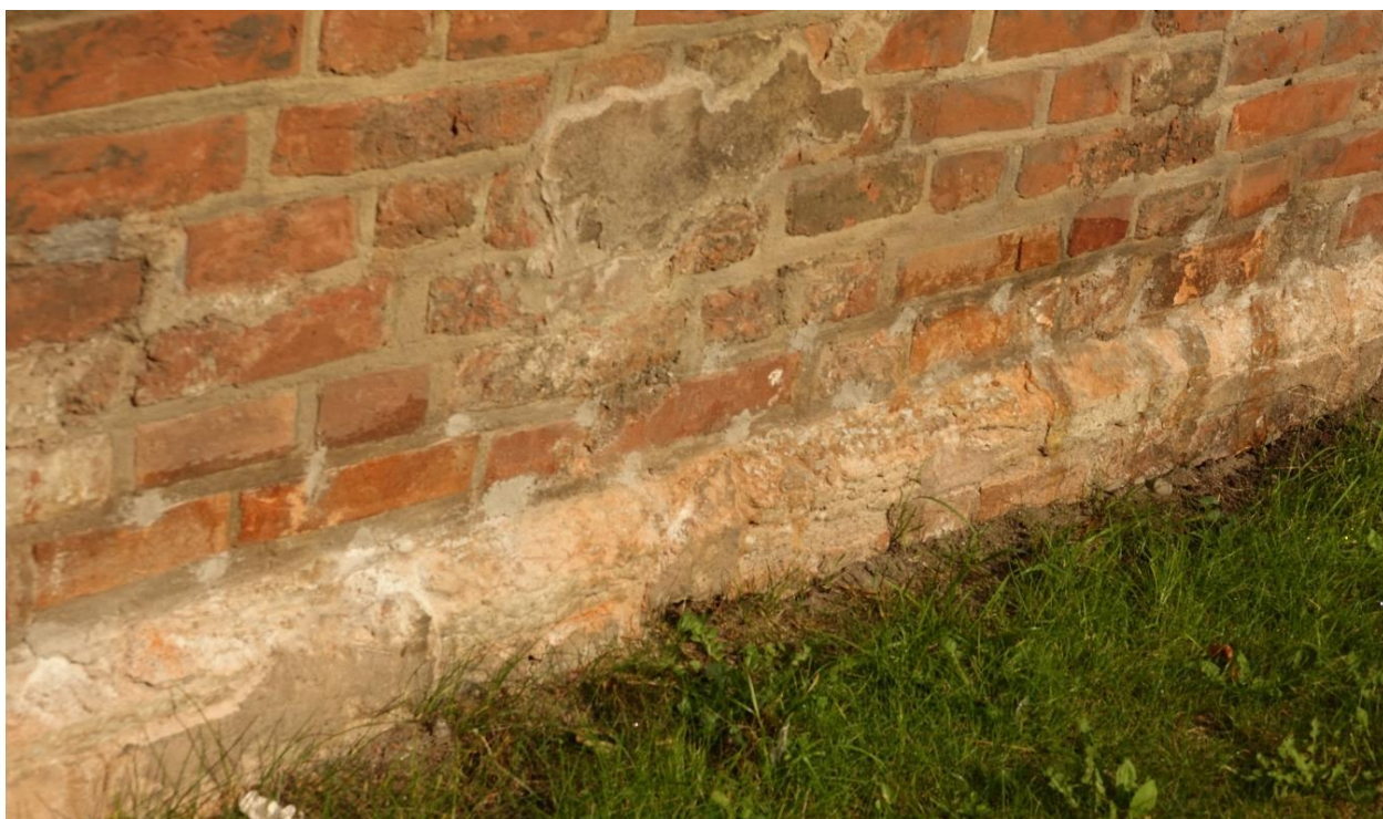
Ilustracja 33. Obiekt po zakończeniu prac konserwatorskich.
