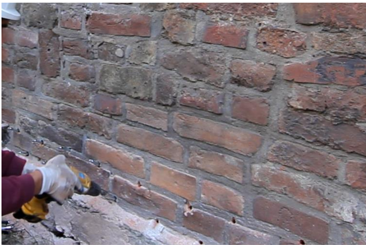
Ilustracja 17. Wykonywanie odwiertów pod iniektory.
