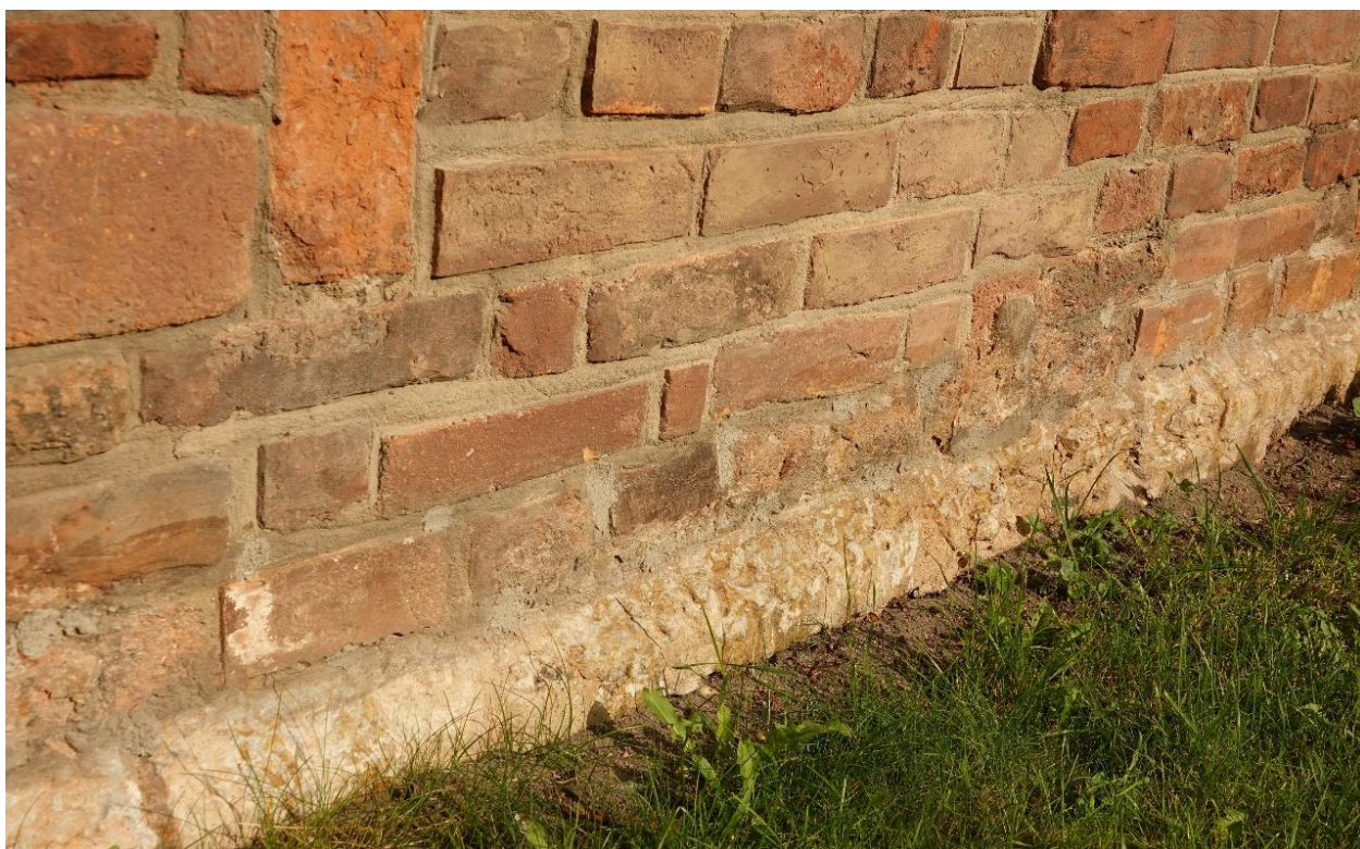
Ilustracja 34. Obiekt po zakończeniu prac konserwatorskich.
