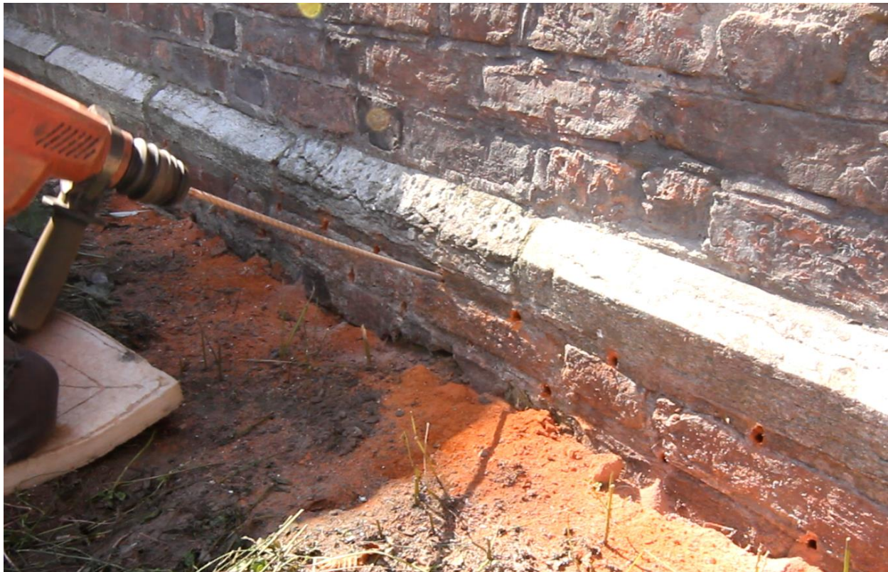
Ilustracja 21. Wykonywanie odwiertów pod iniektory. Pogłębianie otworów przy użyciu dłuższego wiertła.
