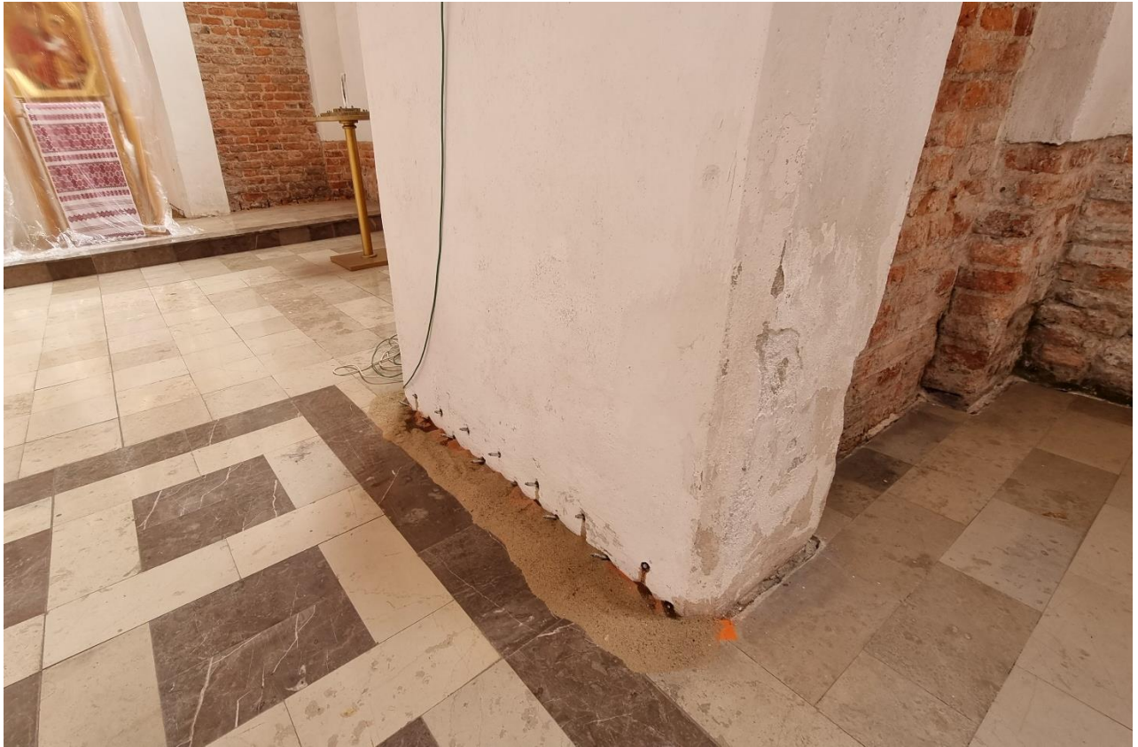
Ilustracja 19. Iniektory osadzone w odwiertach pod iniekcję.
