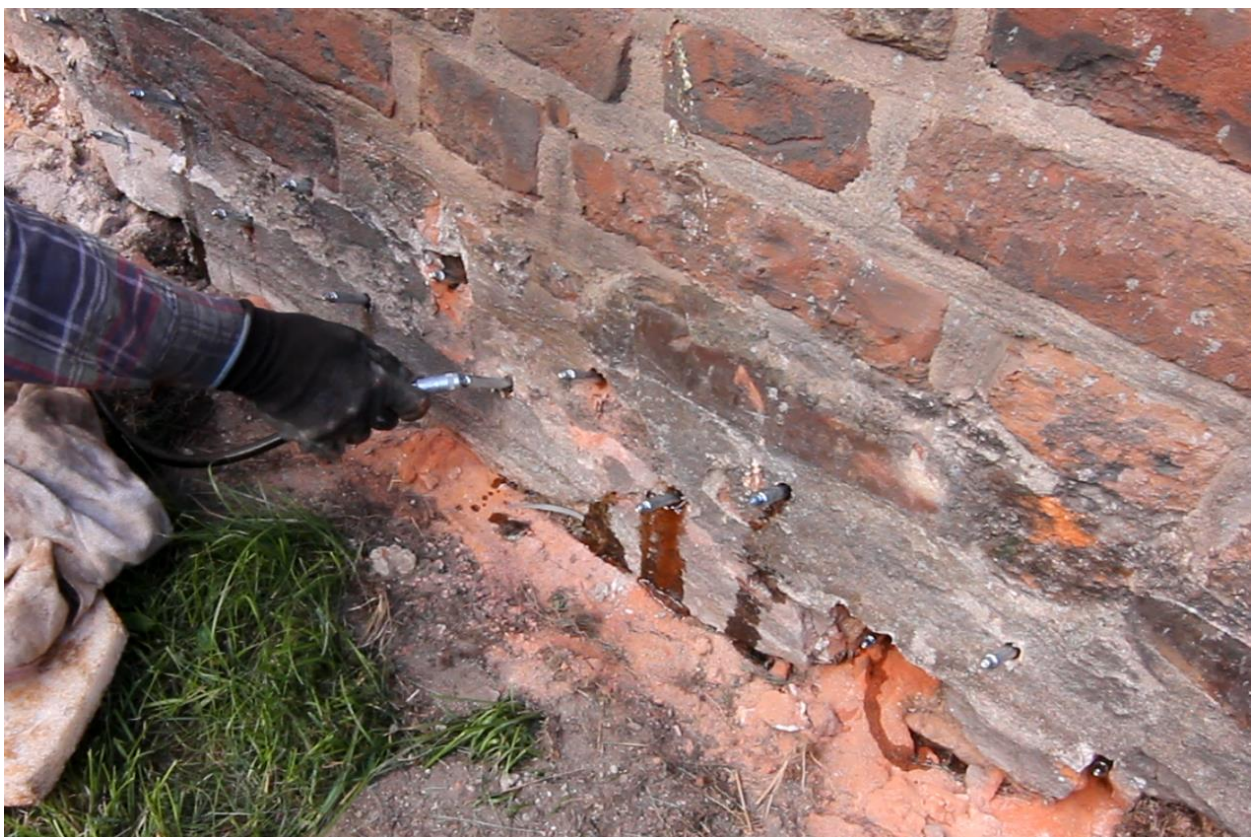
Ilustracja 28. Ciśnieniowa aplikacja żywicy – powtórna aplikacja do wysycenia szczelin.
