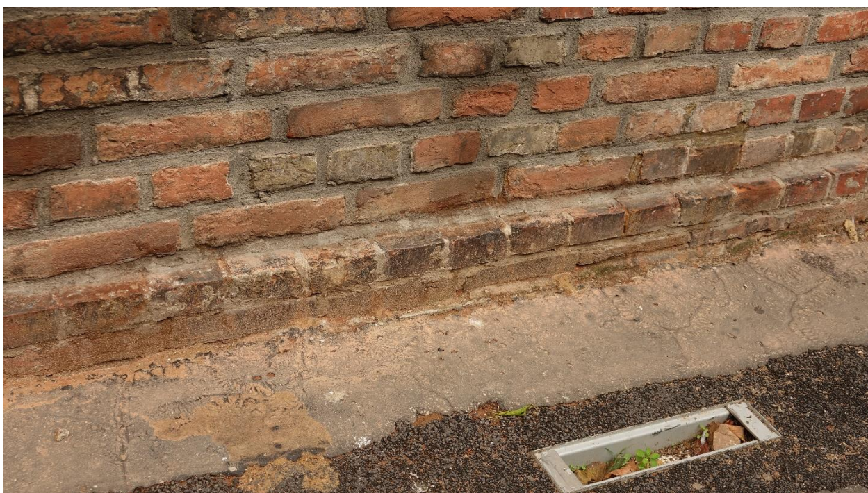
Ilustracja 38. Obiekt po zakończeniu prac konserwatorskich.
