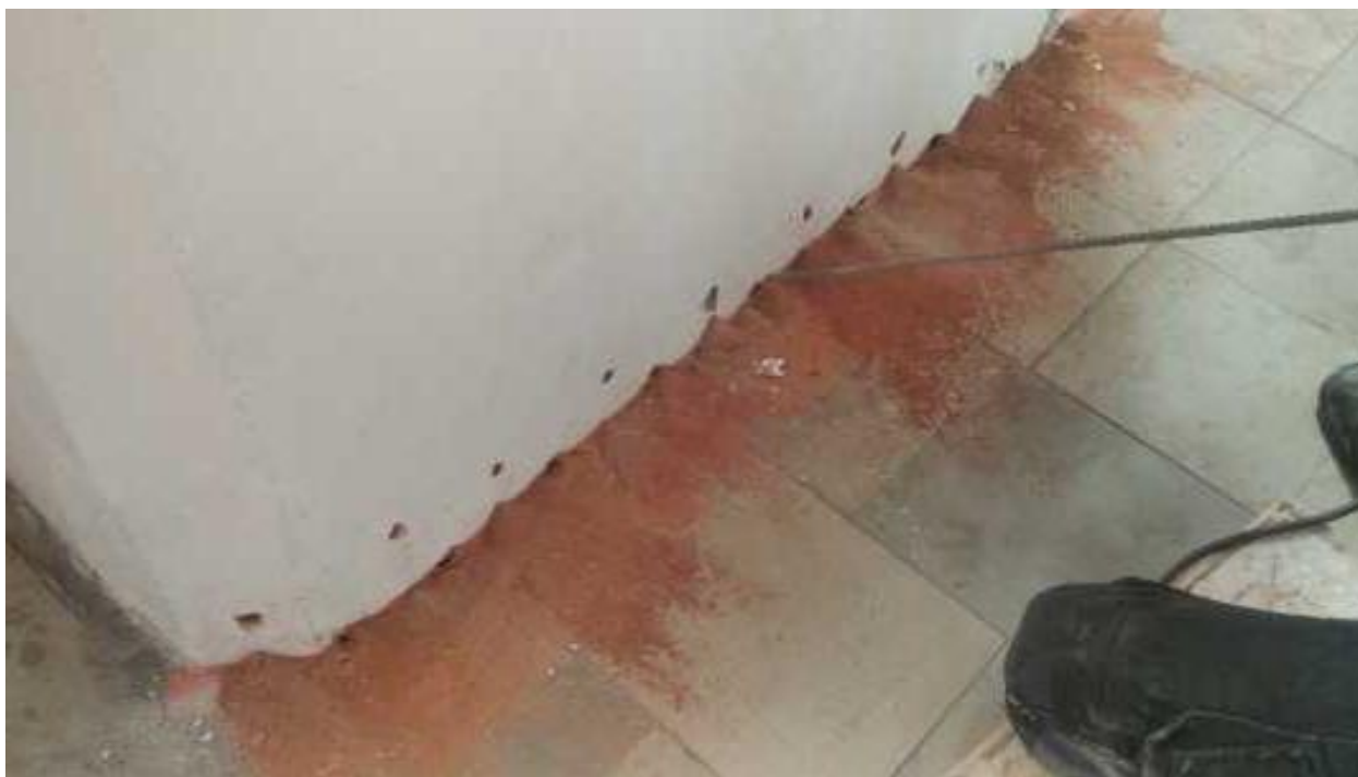
Ilustracja 18. Wykonywanie odwiertów pod iniektory.
