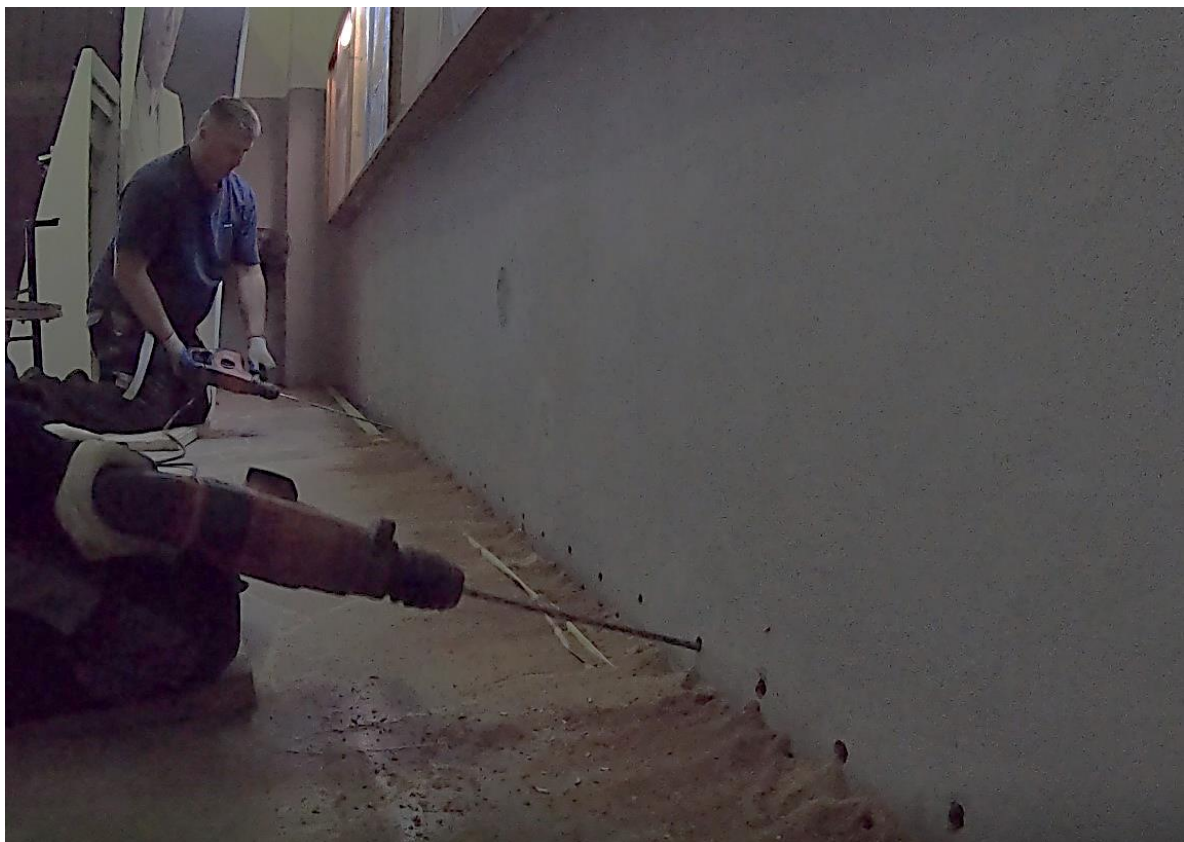
Ilustracja 20. Wywiercanie otworów pod iniektory
