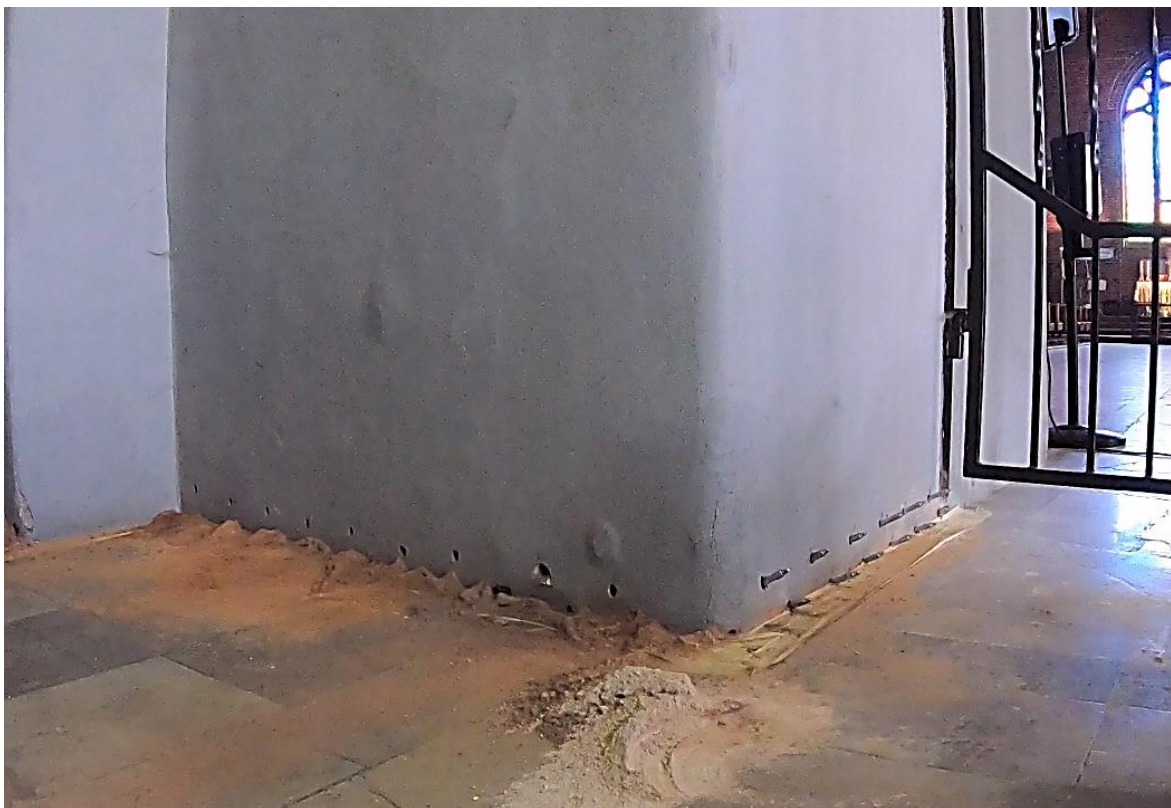
Ilustracja 22. Iniektory osadzone w wywierconych otworach
