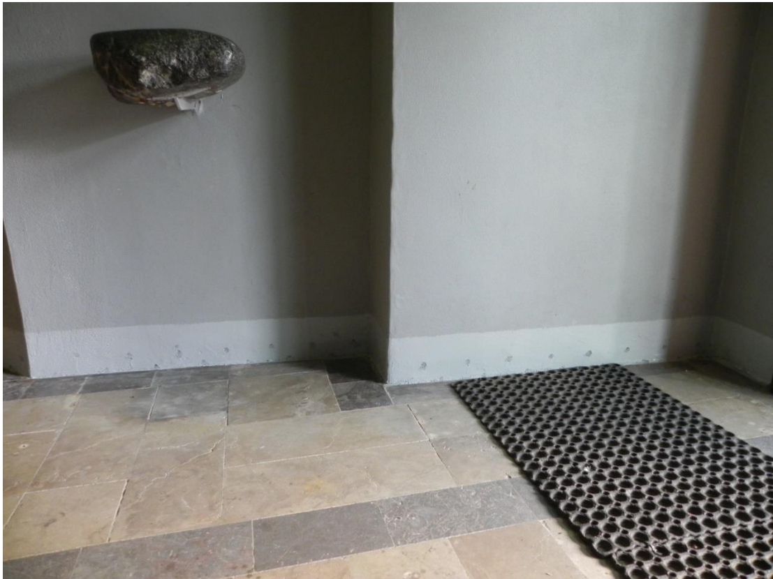
Ilustracja 39. Obiekt po zakończeniu prac
