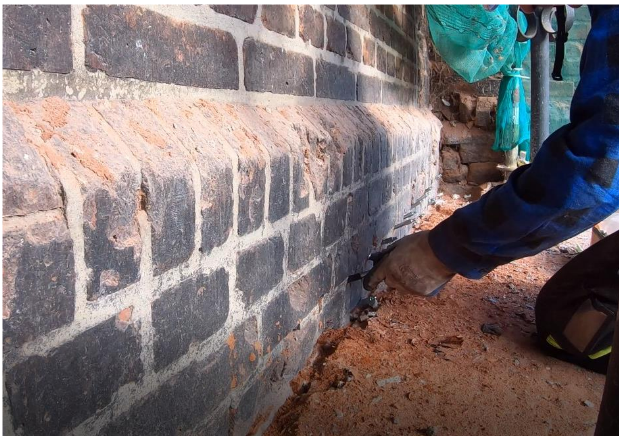
Ilustracja 34. Osadzanie iniektorów w wywierconych otworach
