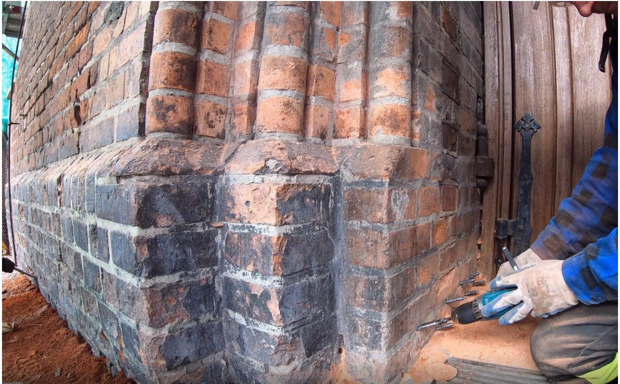
Ilustracja 35. Osadzanie iniektorów w wywierconych otworach
