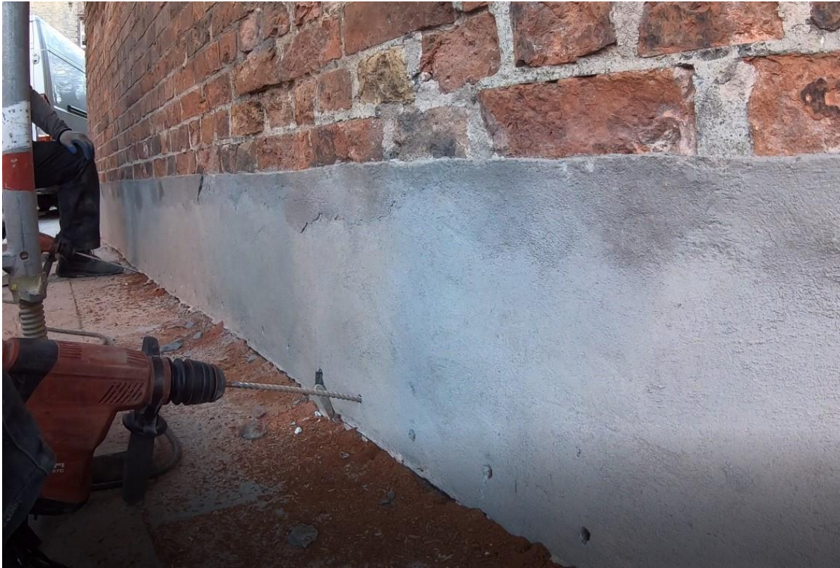
Ilustracja 31. Wywiercanie otworów pod iniekcję
