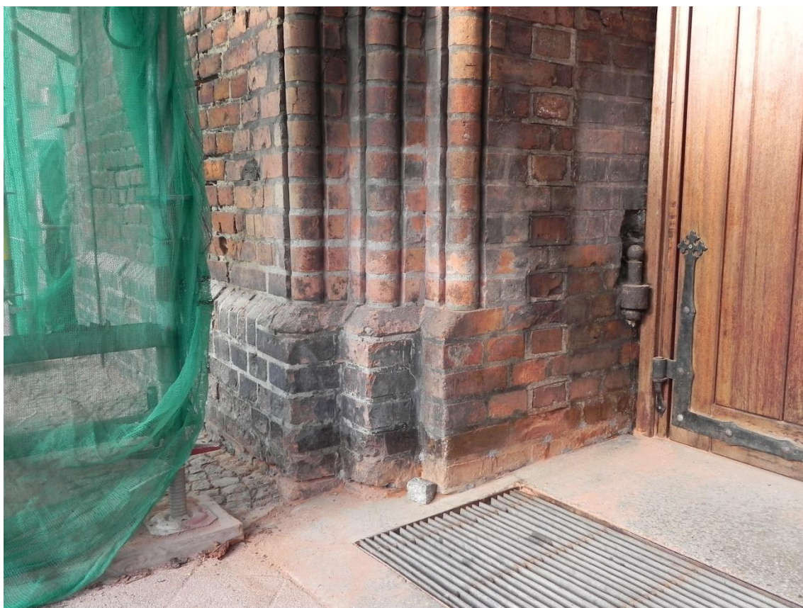
Ilustracja 44. Obiekt po zakończeniu prac
