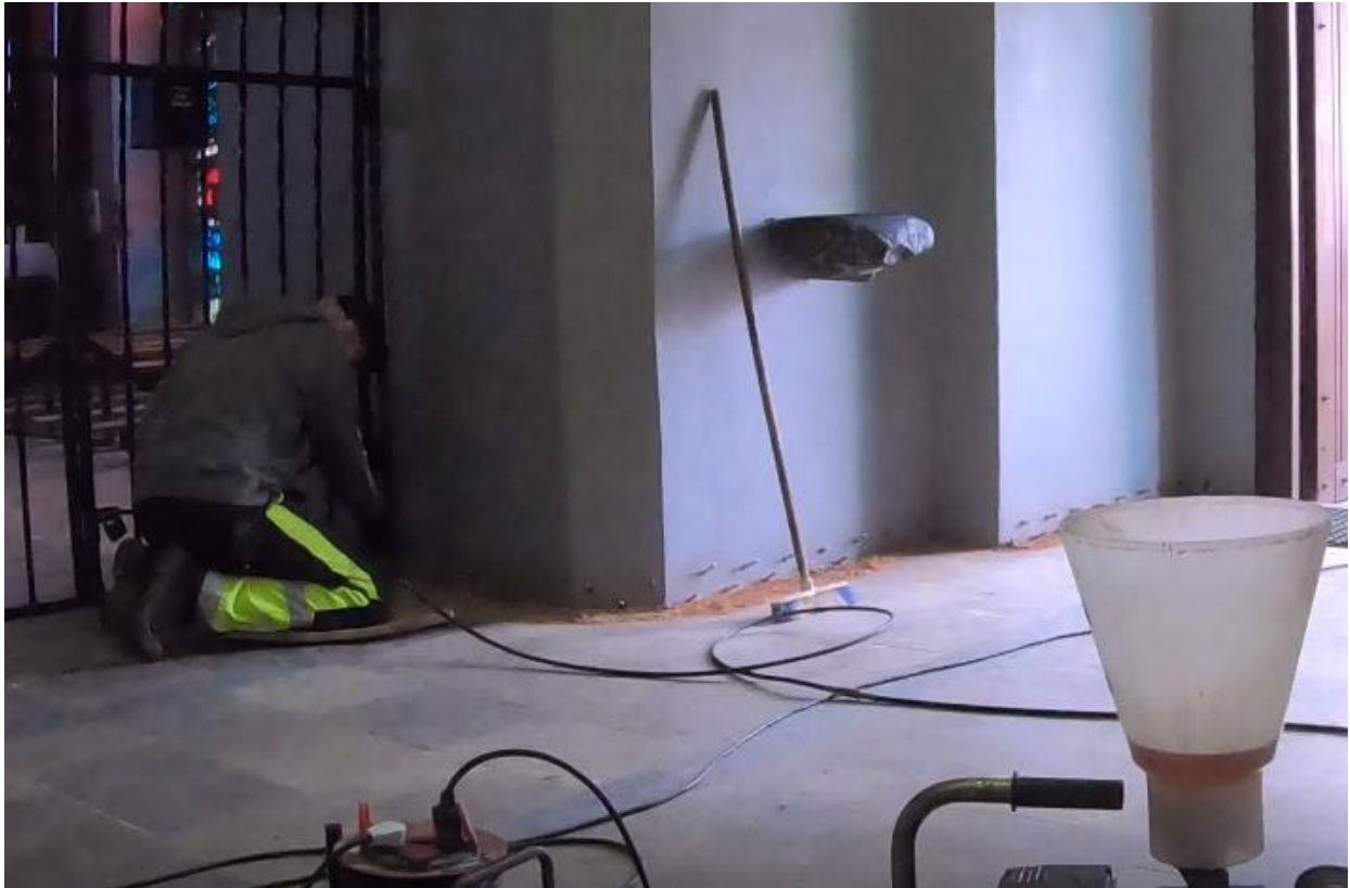
Ilustracja 24. Aplikacja środka iniekcyjnego
