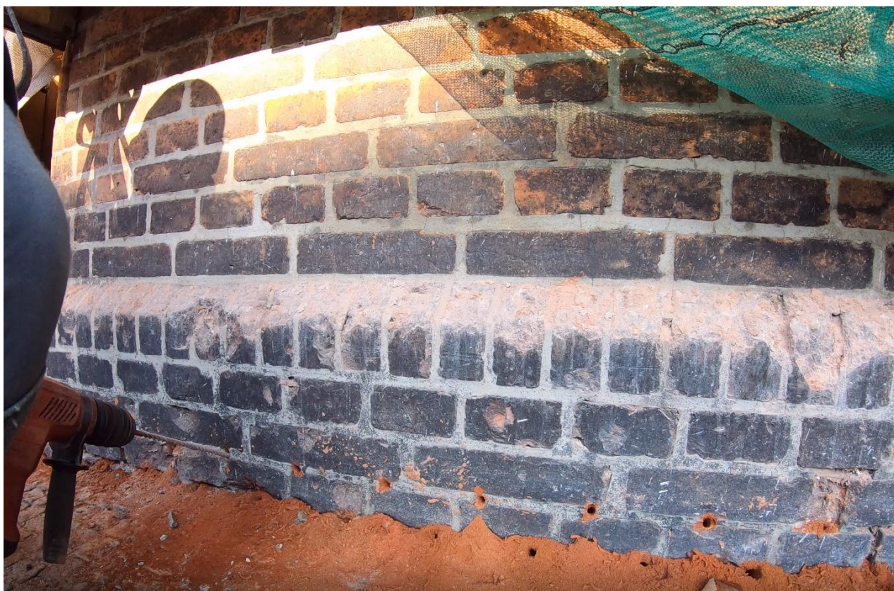
Ilustracja 26. Wywiercanie otworów pod iniekcję
