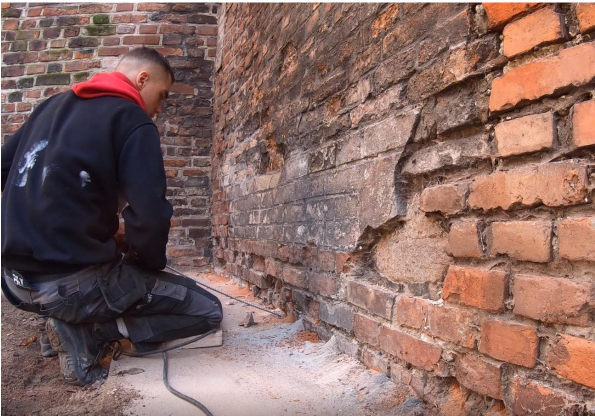
Ilustracja 32. Wywiercanie otworów pod iniekcję
