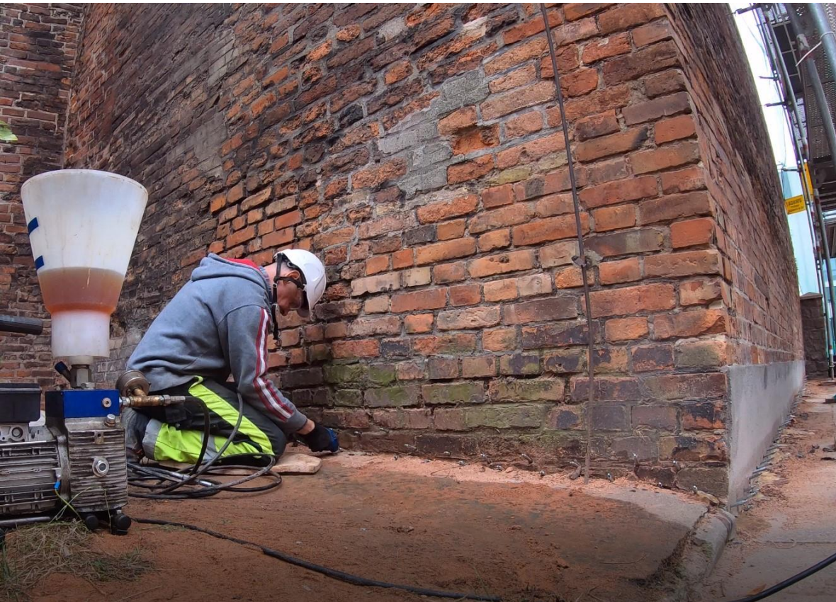
Ilustracja 38. Aplikacja środka iniekcyjnego
