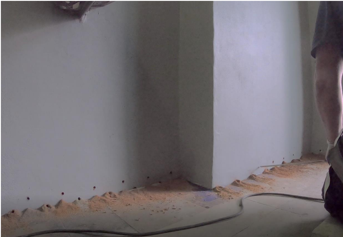
Ilustracja 17. Wywiercanie otworów pod iniektory
