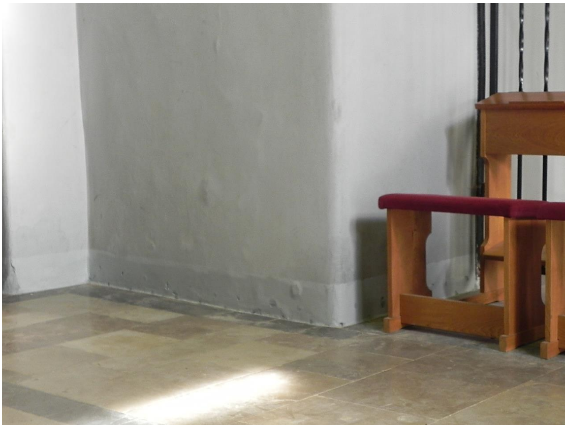
Ilustracja 40. Obiekt po zakończeniu prac
