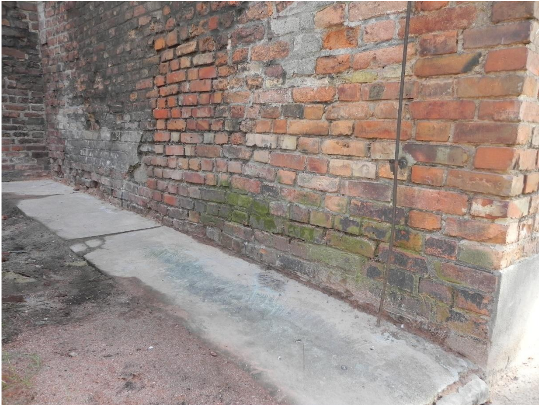
Ilustracja 47. Obiekt po zakończeniu prac
