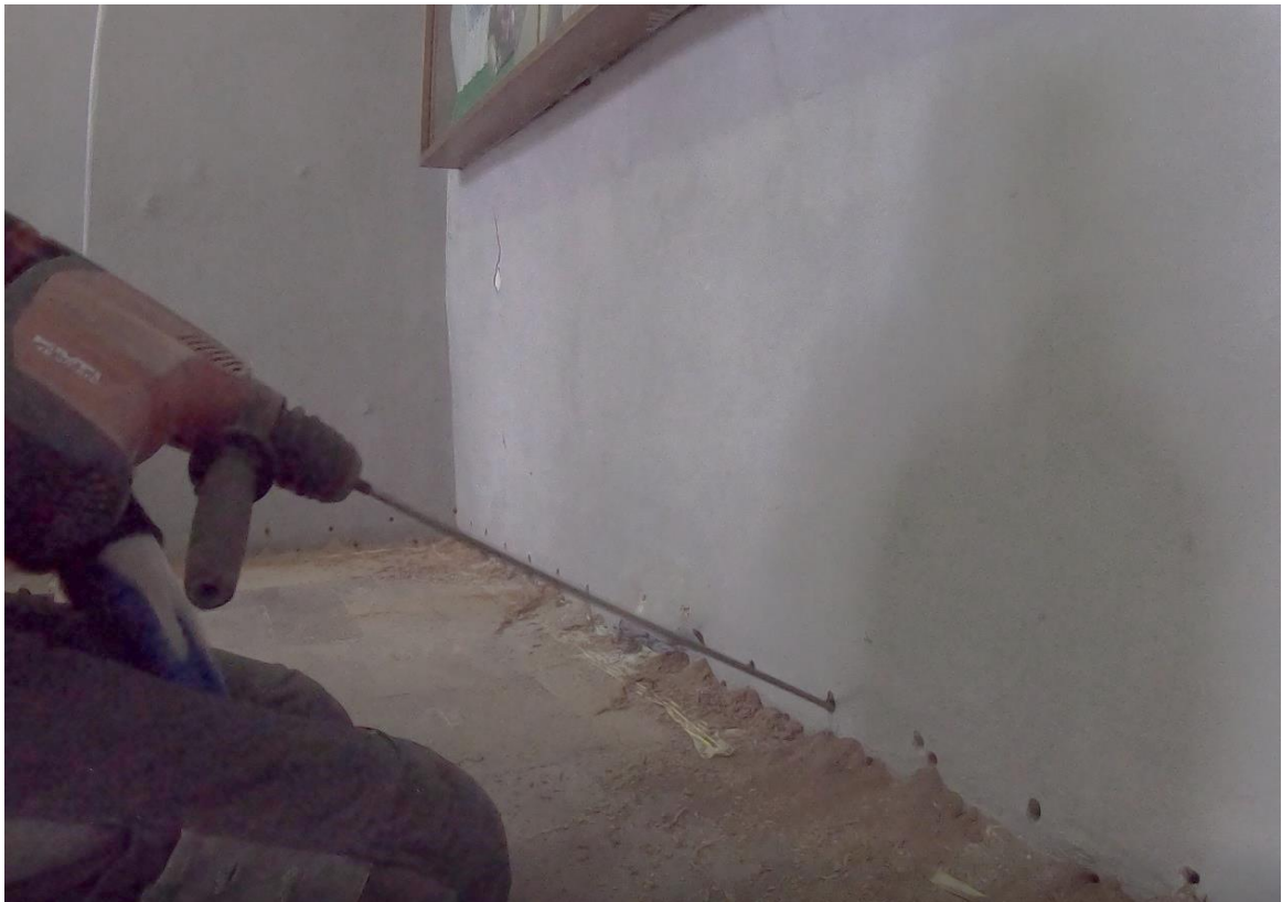
Ilustracja 18. Wywiercanie otworów pod iniektory
