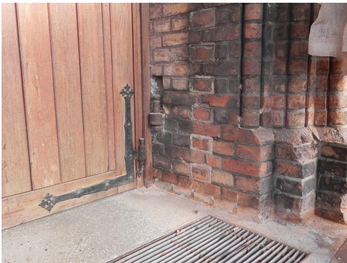
Ilustracja 43. Obiekt po zakończeniu prac
