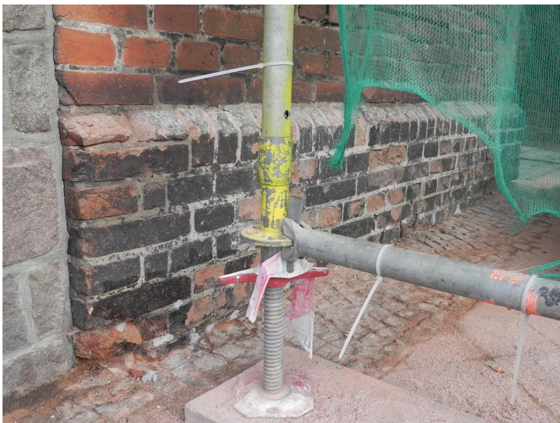
Ilustracja 46. Obiekt po zakończeniu prac
