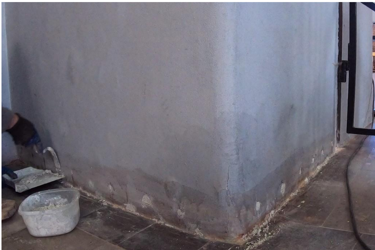
Ilustracja 25. Zasklepianie otworów po iniekcji zaprawą
