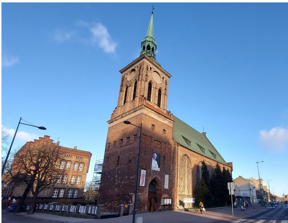
Ilustracja 6. Kościół pw. św. Barbary. Widok ogólny od strony południowo-zachodniej
