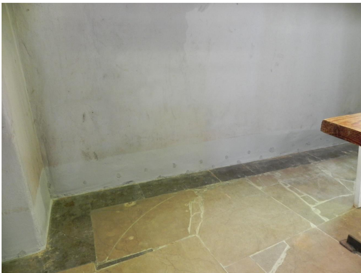
Ilustracja 41. Obiekt po zakończeniu prac
