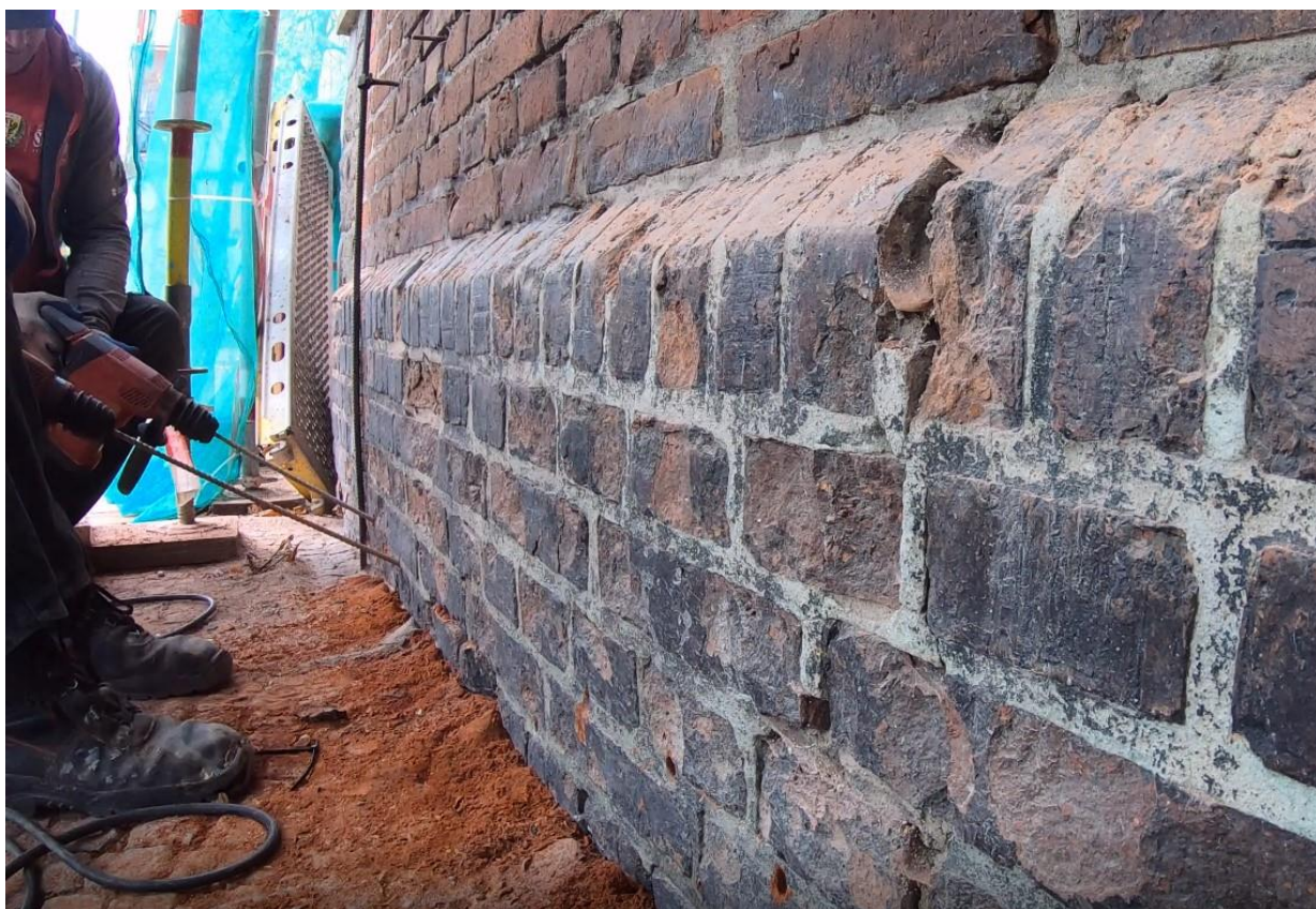
Ilustracja 29. Wywiercanie otworów pod iniekcję
