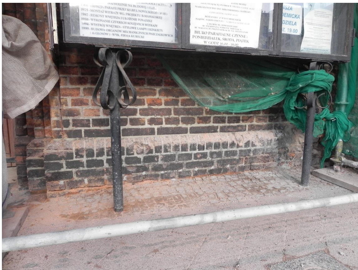
Ilustracja 45. Obiekt po zakończeniu prac
