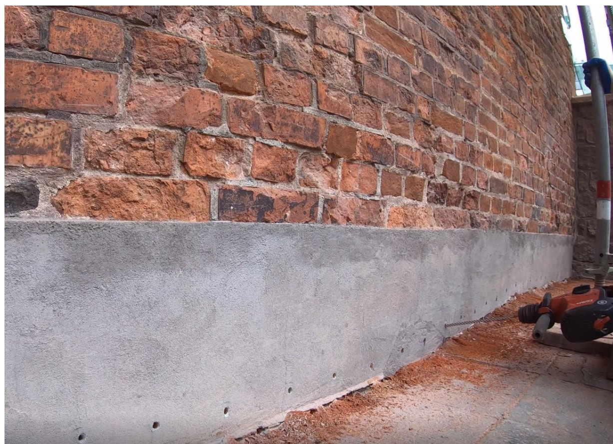
Ilustracja 30. Wywiercanie otworów pod iniekcję
