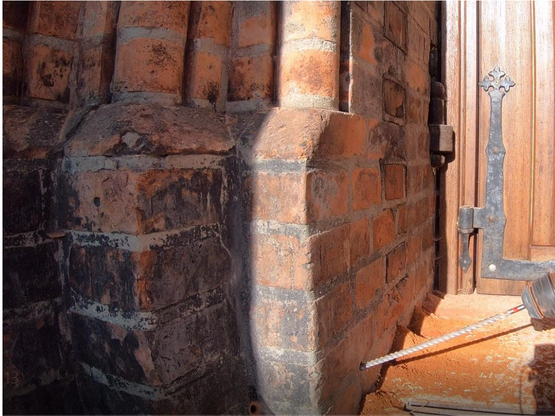
Ilustracja 28. Wywieranie otworów pod iniekcję
