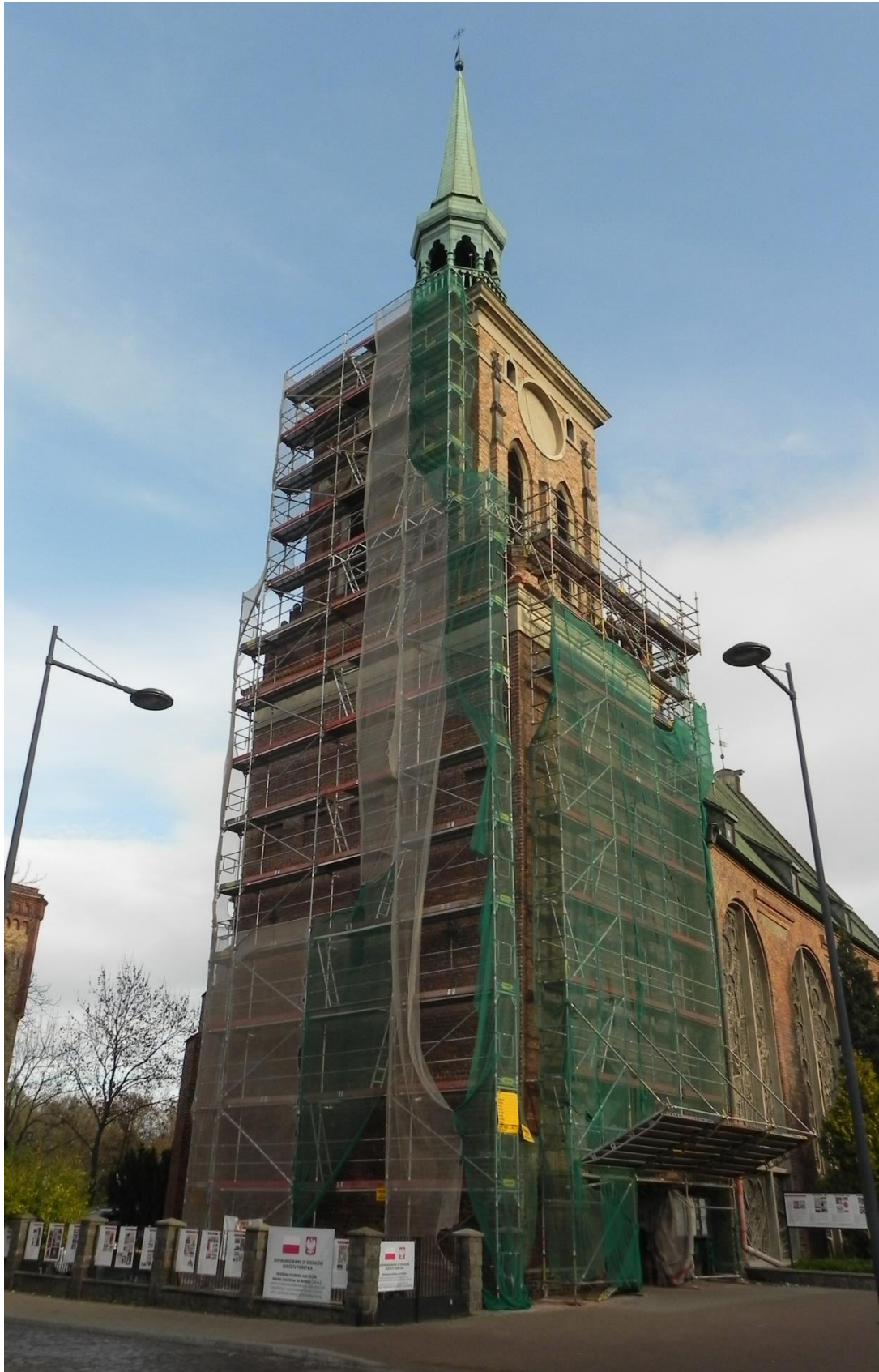
Ilustracja 49. Obiekt po zakończeniu prac
