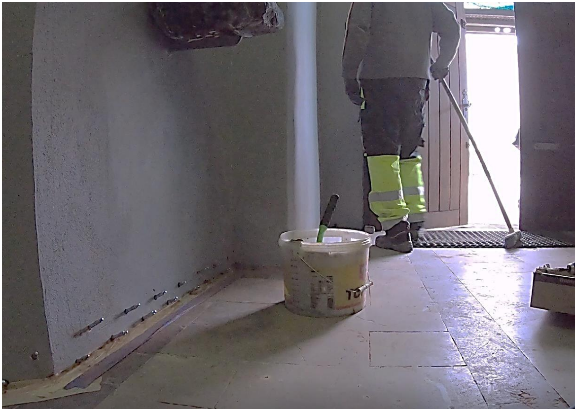
Ilustracja 21. Iniektory osadzone w wywierconych otworach
