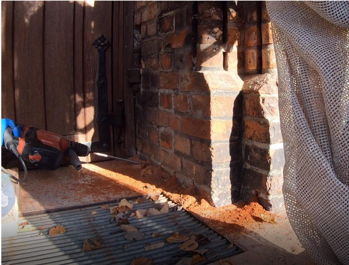
Ilustracja 27. Wywieranie otworów pod iniekcję
