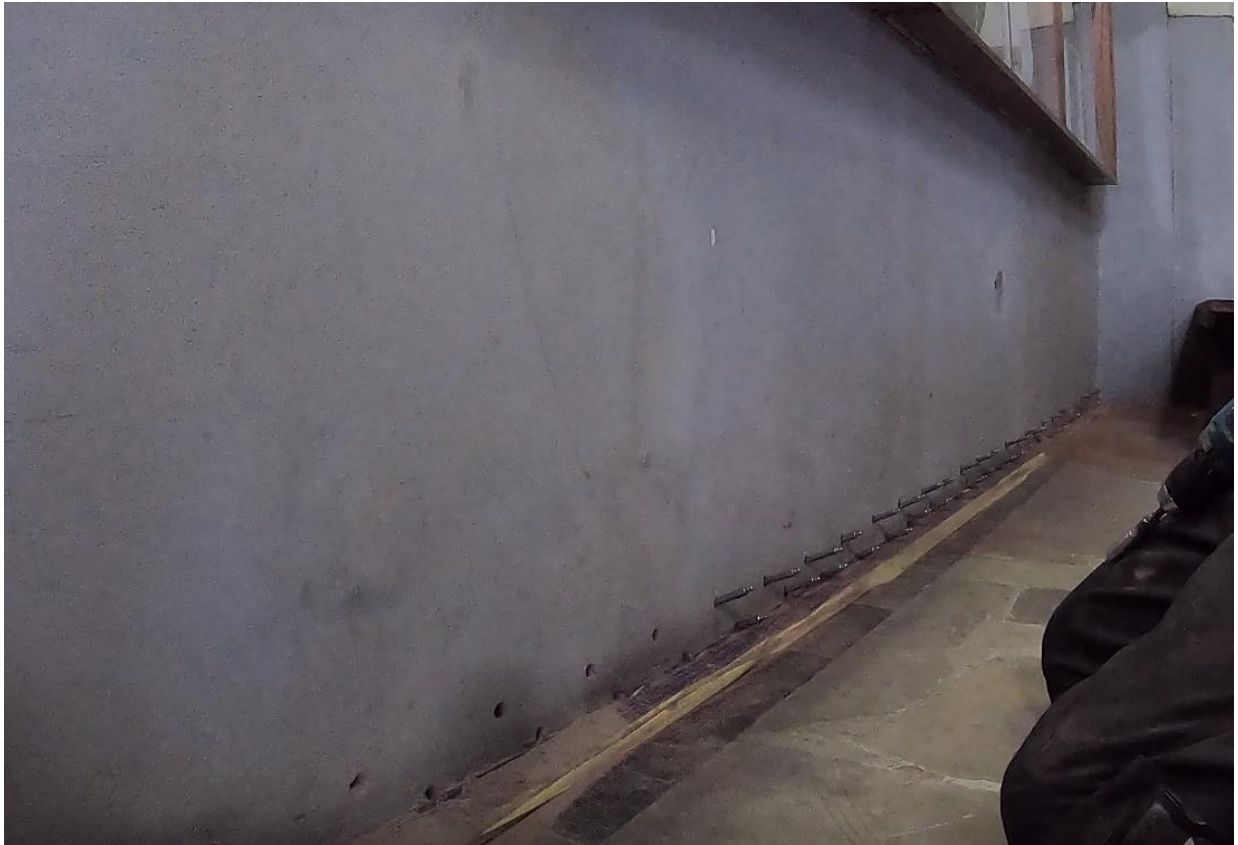
Ilustracja 23. Iniektory osadzone w wywierconych otworach
