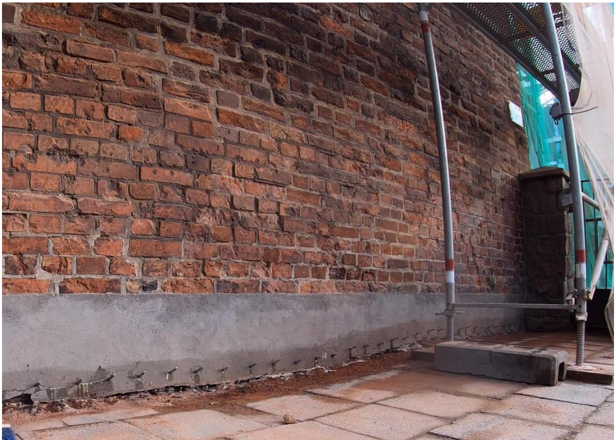
Ilustracja 36. Iniektory osadzone w wywierconych otworach
