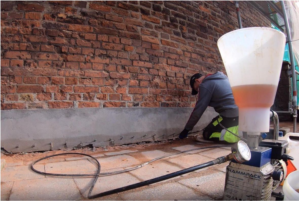
Ilustracja 37. Aplikacja środka iniekcyjnego
