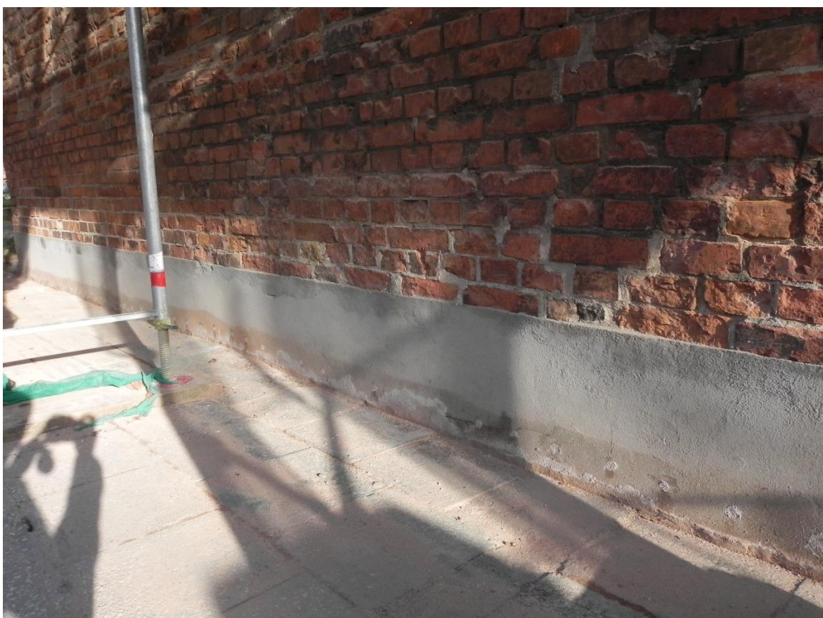
Ilustracja 42. Obiekt po zakończeniu prac
