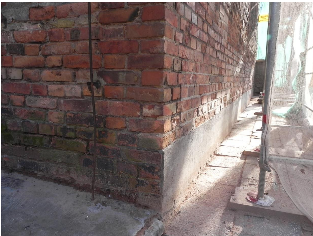
Ilustracja 48. Obiekt po zakończeniu prac
