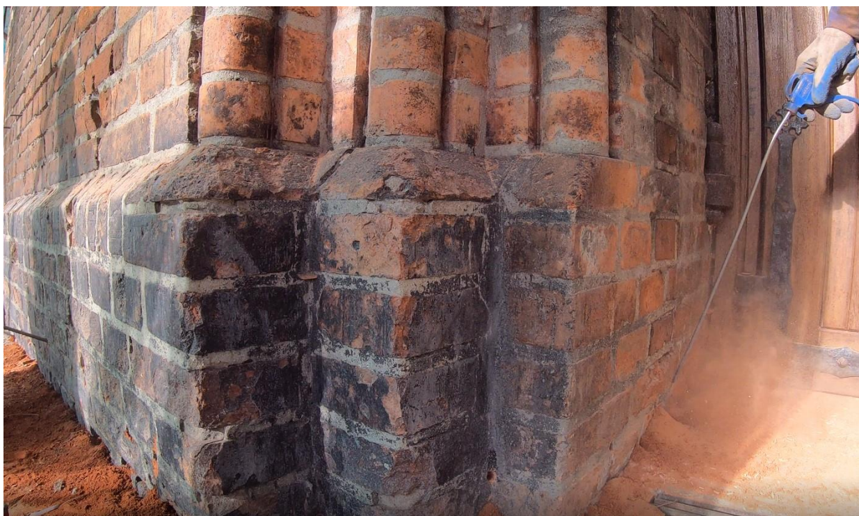
Ilustracja 33. Oczyszczanie wywierconych otworów przed osadzeniem iniektorów
