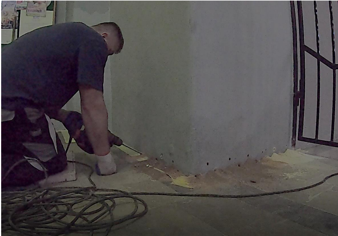
Ilustracja 19. Wywiercanie otworów pod iniektory
