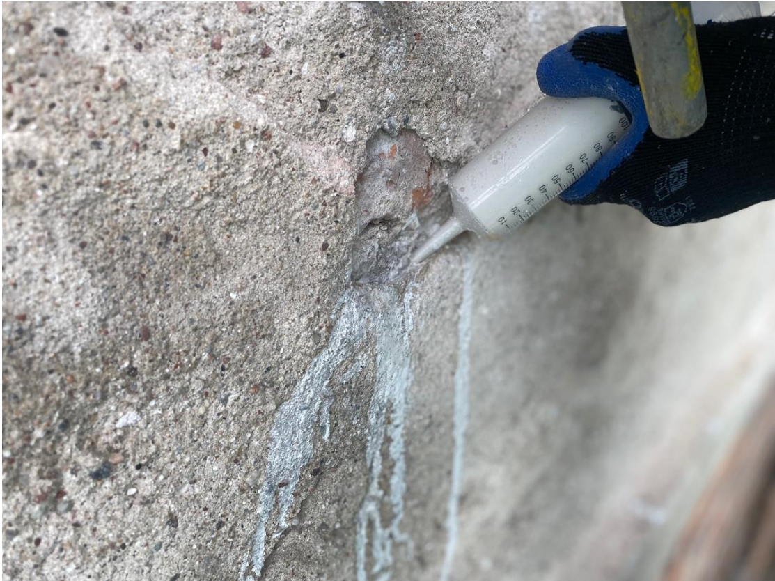
Ilustracja 29. Wypełnianie pustek w tynku zaprawą PLM M.
