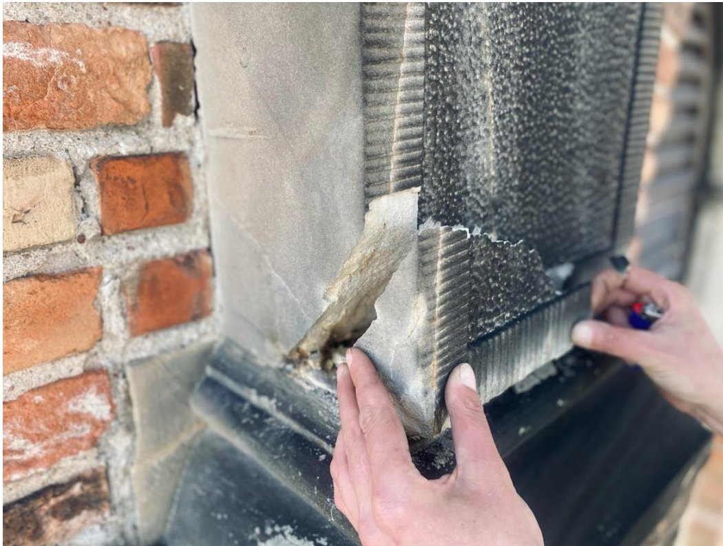
Ilustracja 17. Demontaż luźnych elementów powodujących zagrożenie.
