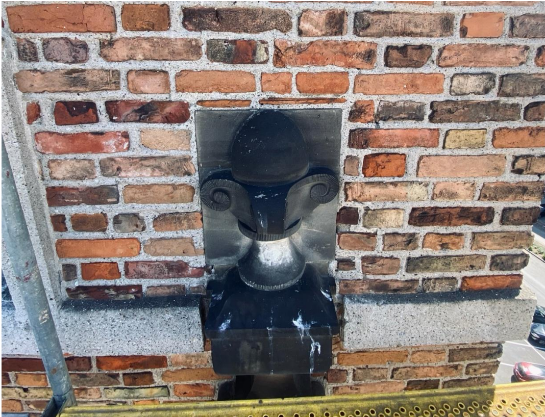
Ilustracja 12. Nawarstwienia miejskie na detalach kamiennych.
