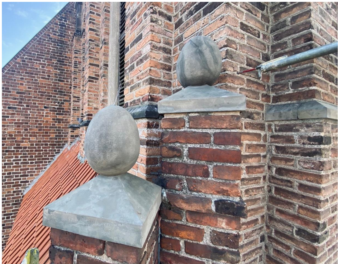
Ilustracja 36. Obiekt po przeprowadzeniu prac konserwatorskich.
