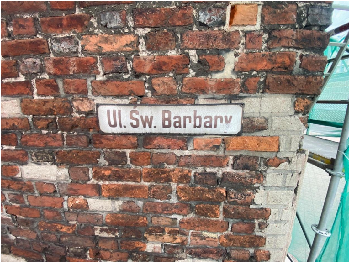
Ilustracja 16. Nieestetyczne betonowe kity z wypłukaną warstwą barwną, która kiedyś imitowała cegłę.
