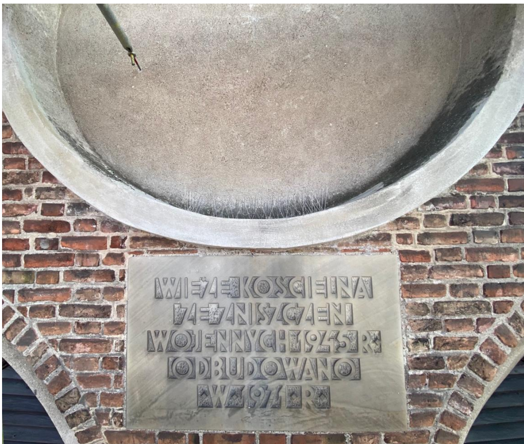
Ilustracja 31. Obiekt po przeprowadzeniu prac konserwatorskich.
