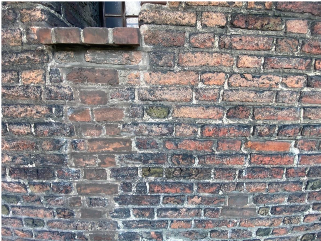
Ilustracja 37. Obiekt po przeprowadzeniu prac konserwatorskich.
