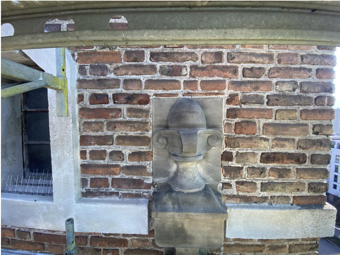
Ilustracja 35. Obiekt po przeprowadzeniu prac konserwatorskich.
