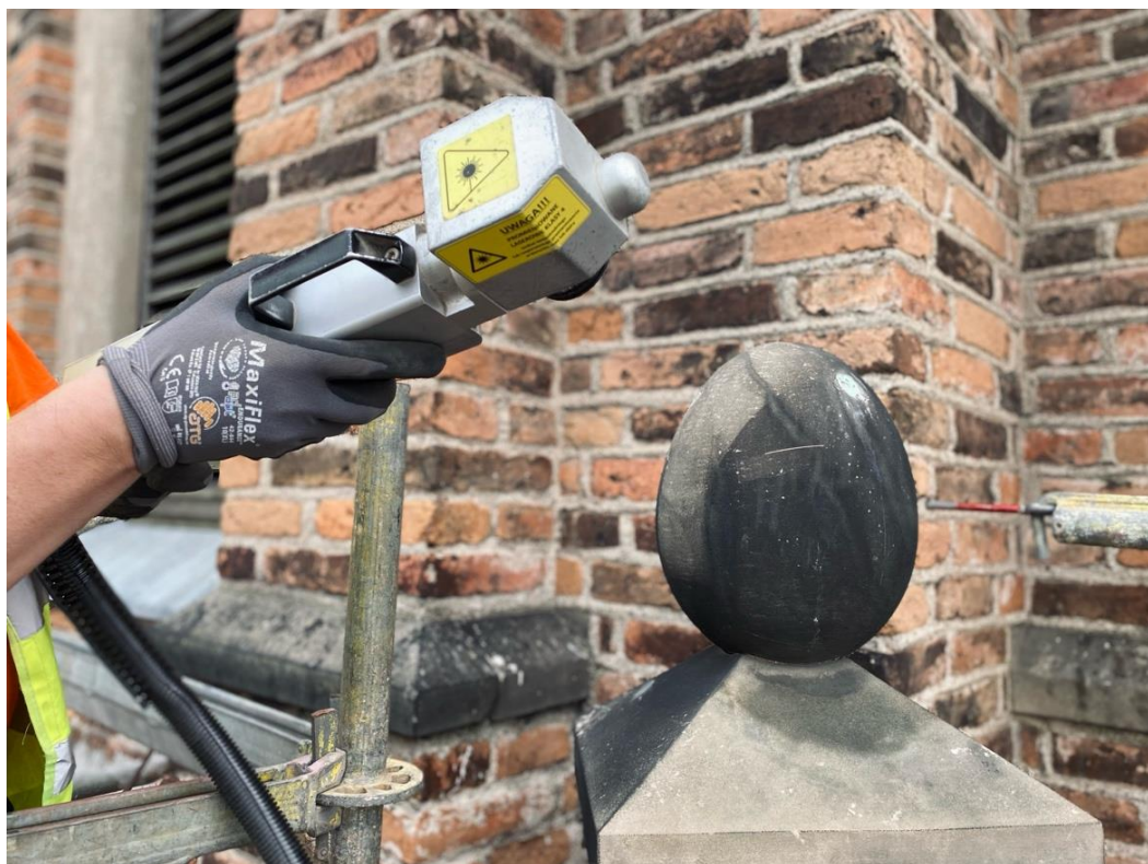
Ilustracja 18. Oczyszczanie laserowe kamiennych detali.
