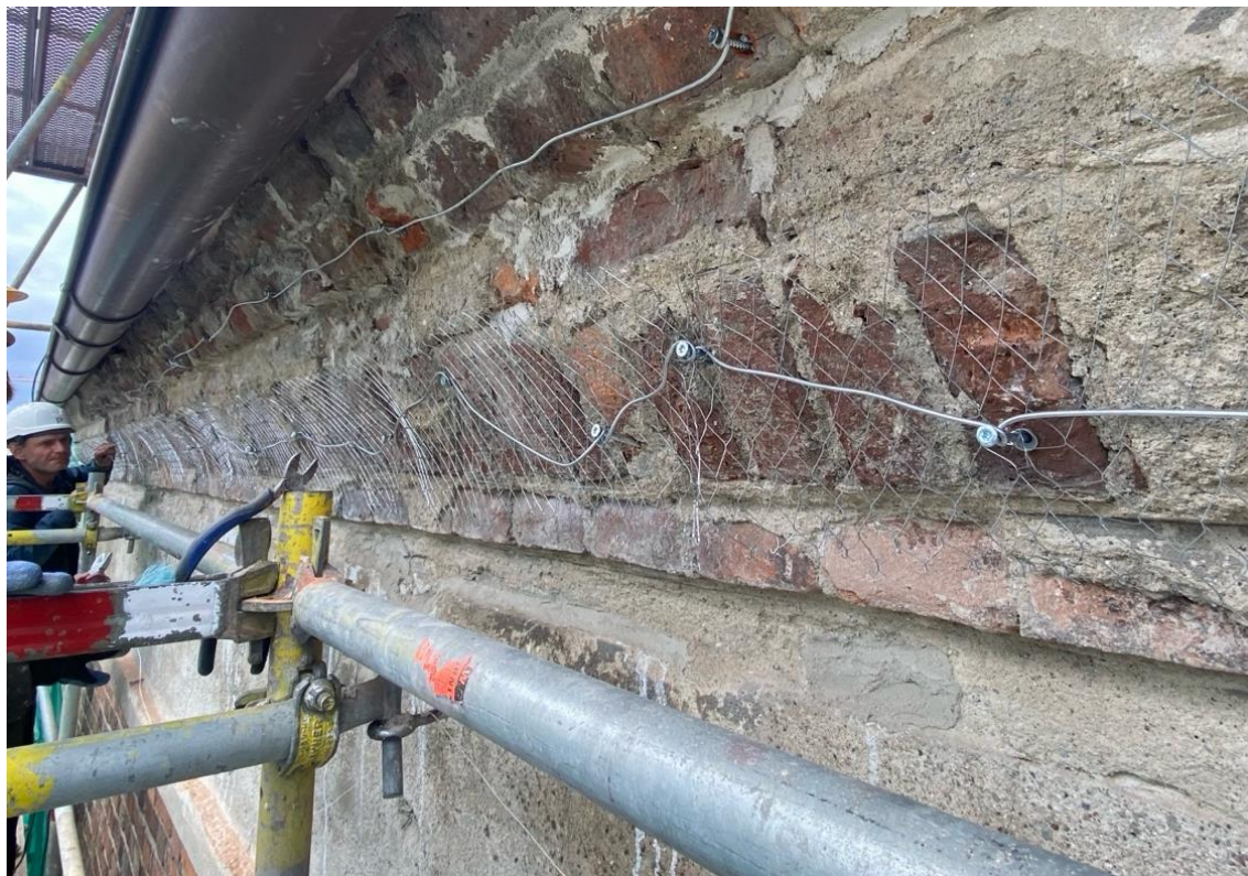
Ilustracja 28. Montaż siatki zbrojeniowej pod uzupełnienia ubytków tynku.
