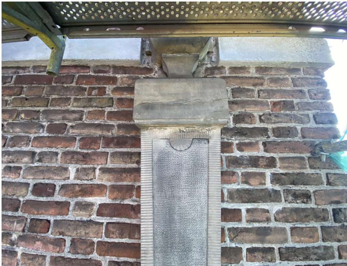
Ilustracja 34. Obiekt po przeprowadzeniu prac konserwatorskich.
