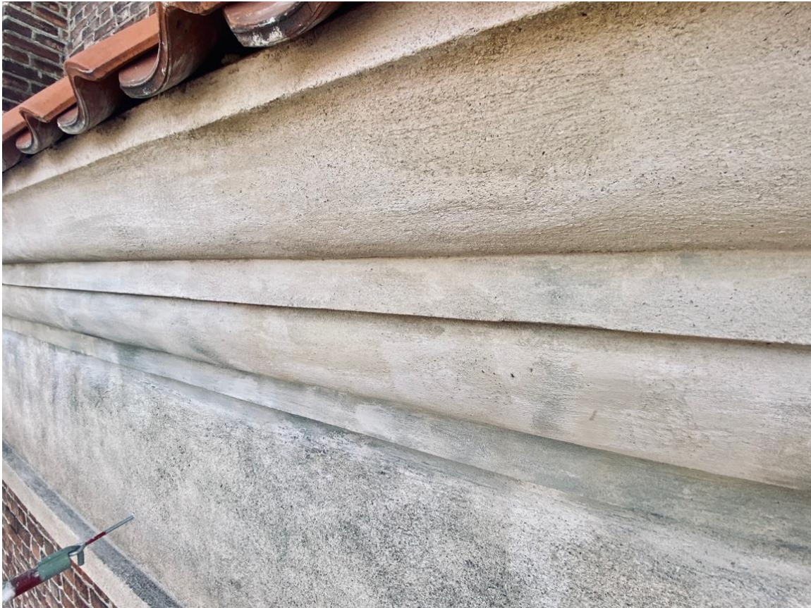
Ilustracja 33. Obiekt po przeprowadzeniu prac konserwatorskich.
