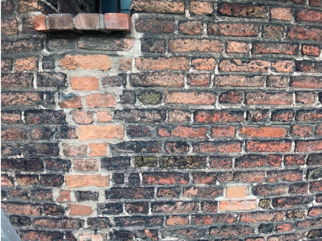
Ilustracja 14. Duże różnice w odbiorze estetycznym powojennych uzupełnień.
