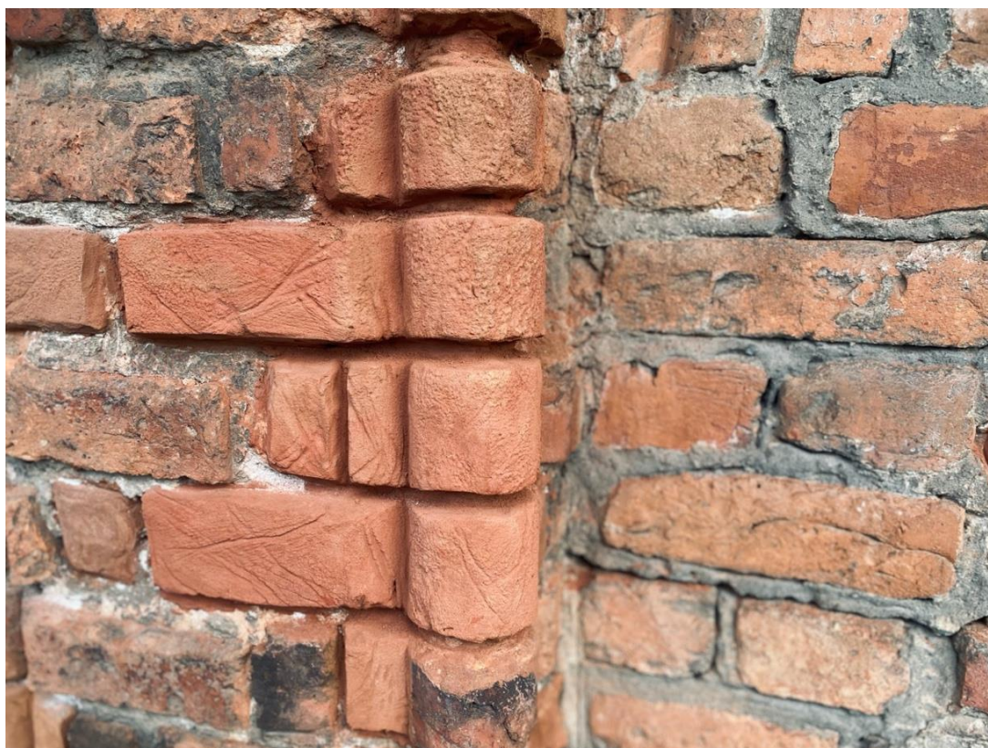
Ilustracja 25. Uzupelnianie ubytków po wykonaniu obróbki mechanicznej zaprawy.
