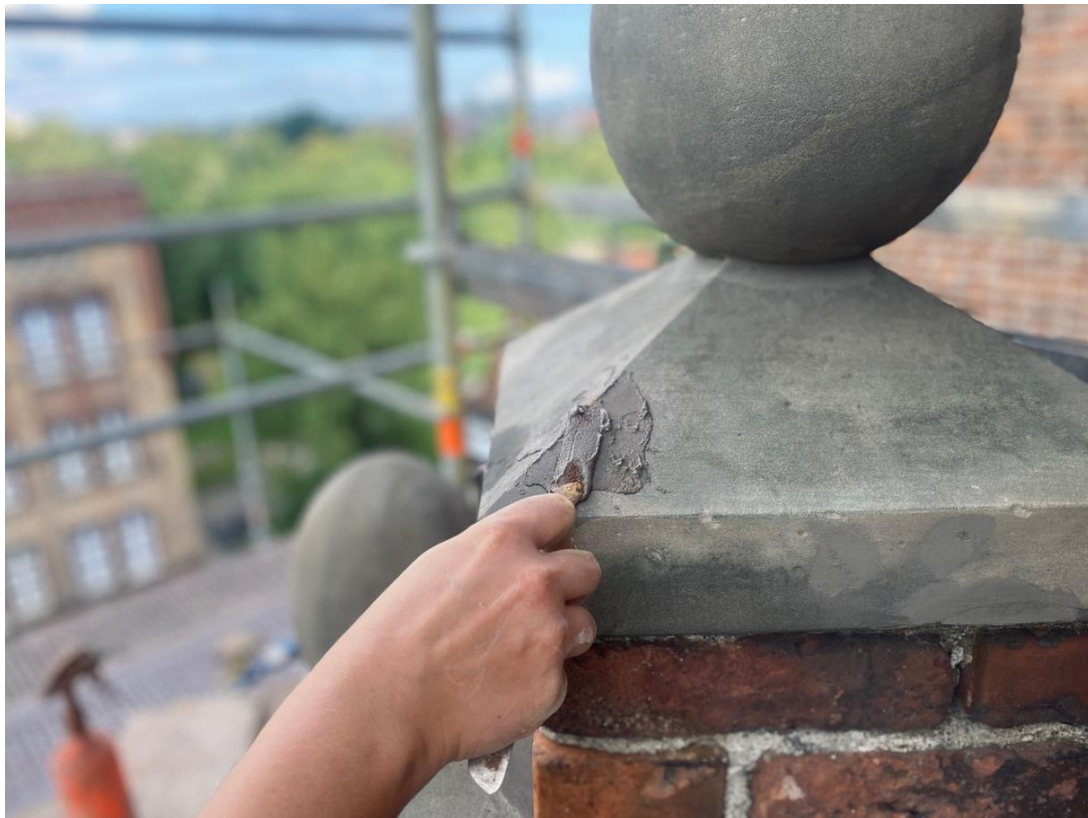
Ilustracja 22. Uzupełnianie ubytków kamiennych detali.
