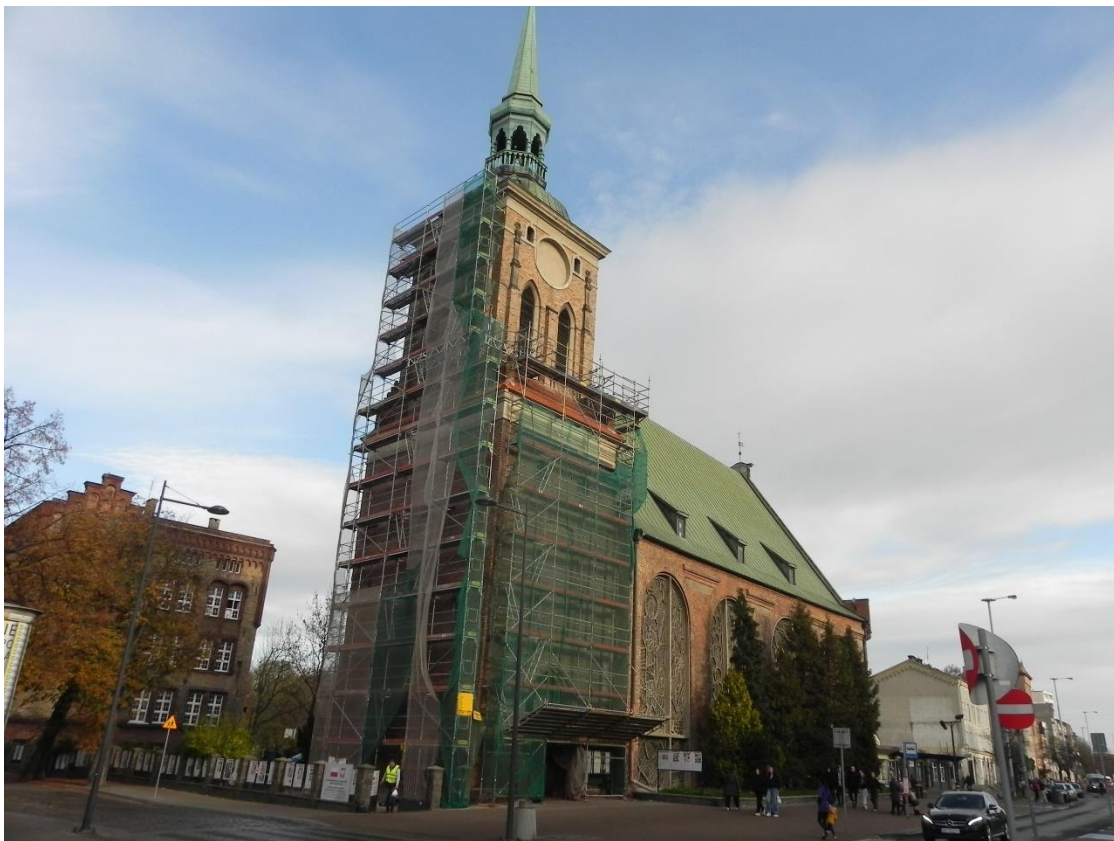
Ilustracja 40. Obiekt po przeprowadzeniu prac konserwatorskich.
