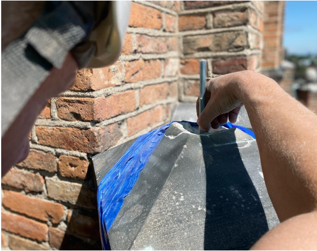
Ilustracja 21. Montaż karbowanego pręta zbrojeniowego.
