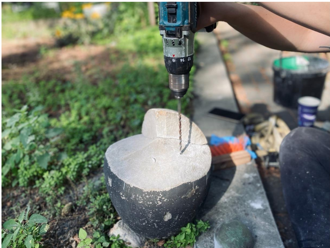
Ilustracja 20. Przygotowanie otworów umożliwiających sklejenie uszkodzonego obelisku.
