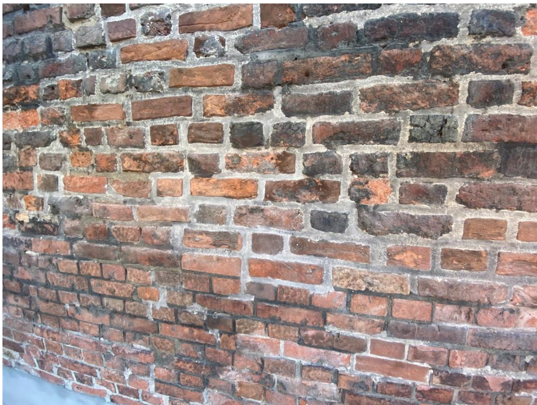
Ilustracja 38. Obiekt po przeprowadzeniu prac konserwatorskich.
