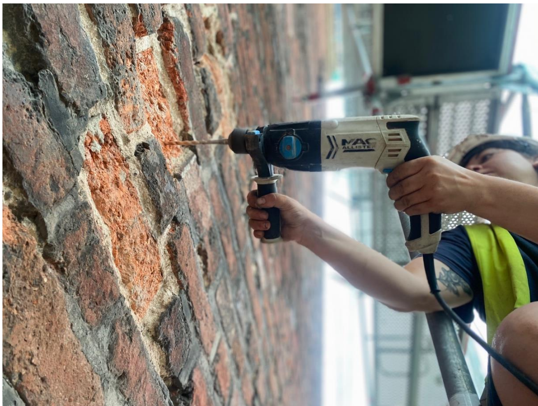
Ilustracja 23. Nawiercanie otworów w ceglach pod zbrojenia.
