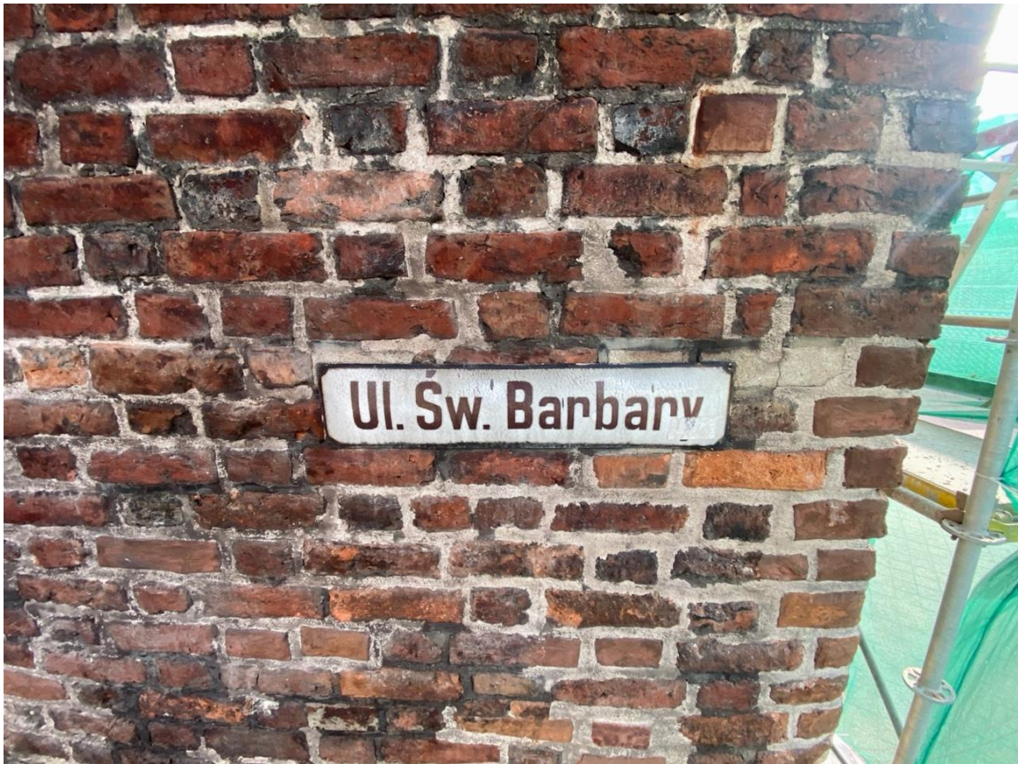
Ilustracja 39. Obiekt po przeprowadzeniu prac konserwatorskich.
