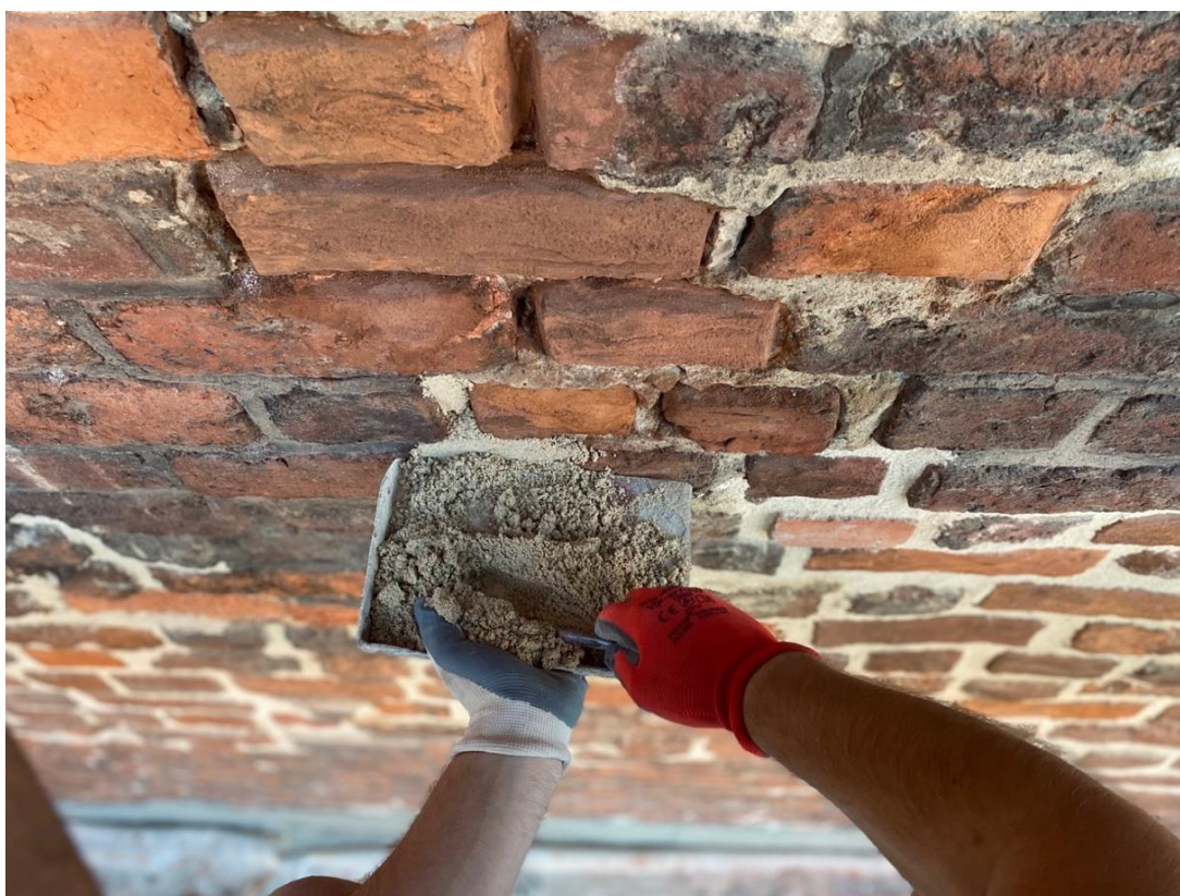
Ilustracja 26. Spoinowanie muru.
