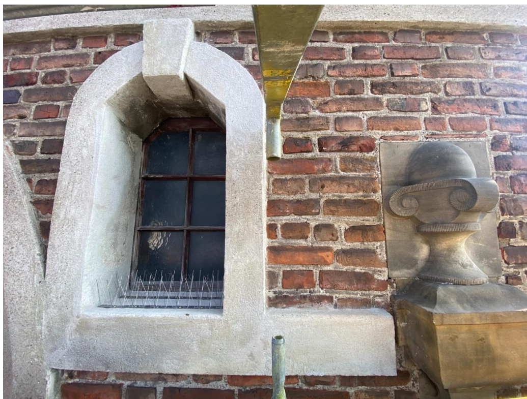
Ilustracja 32. Obiekt po przeprowadzeniu prac konserwatorskich.
