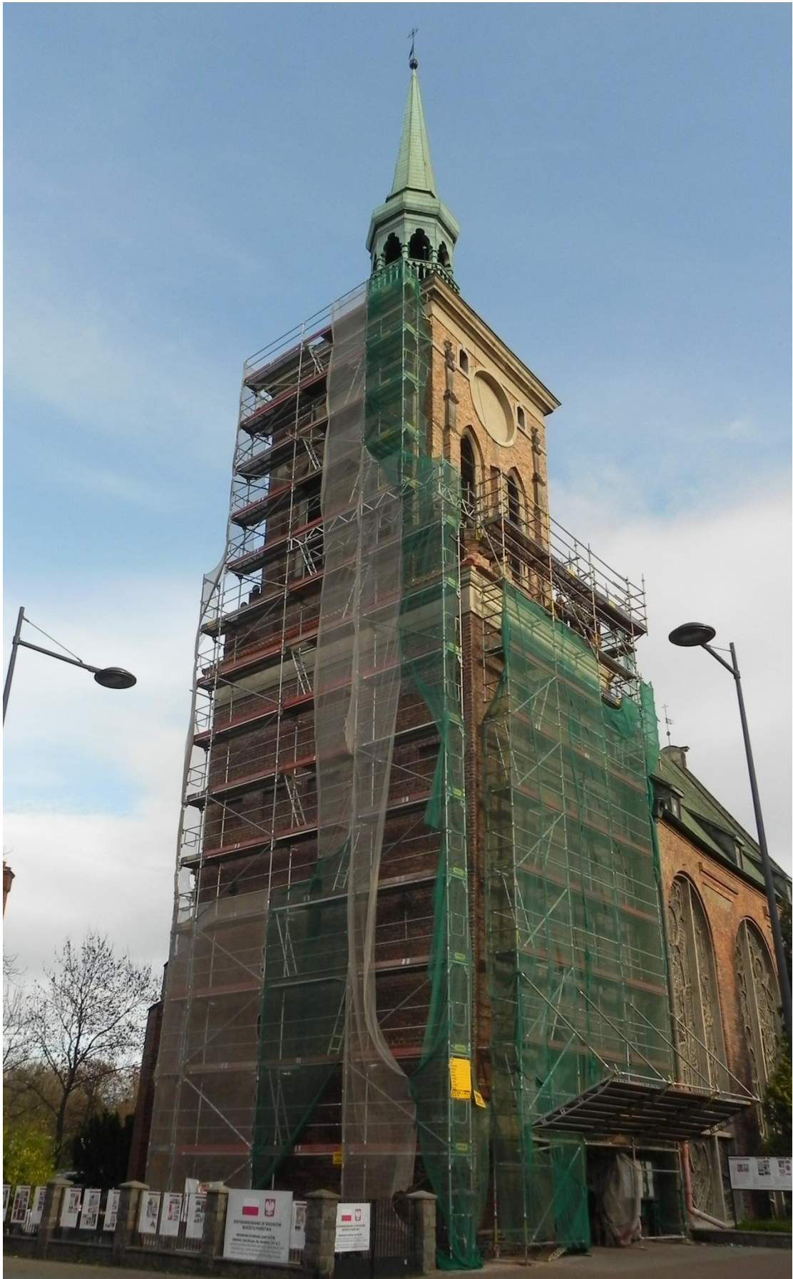
Ilustracja 41. Obiekt po przeprowadzeniu prac konserwatorskich.
