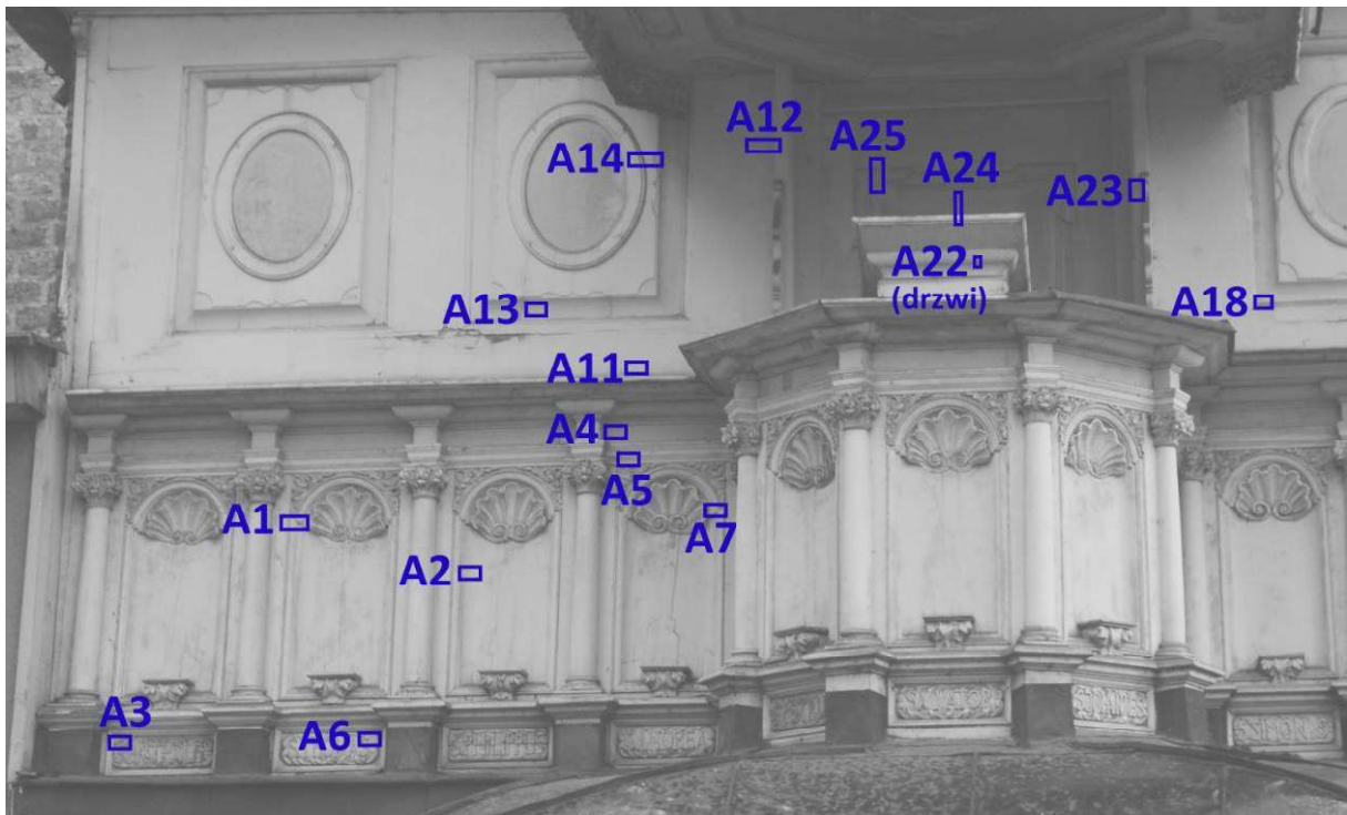
Il. , mapowanie rozmieszczenia odkrywek na ambonie zewnętrznej.
