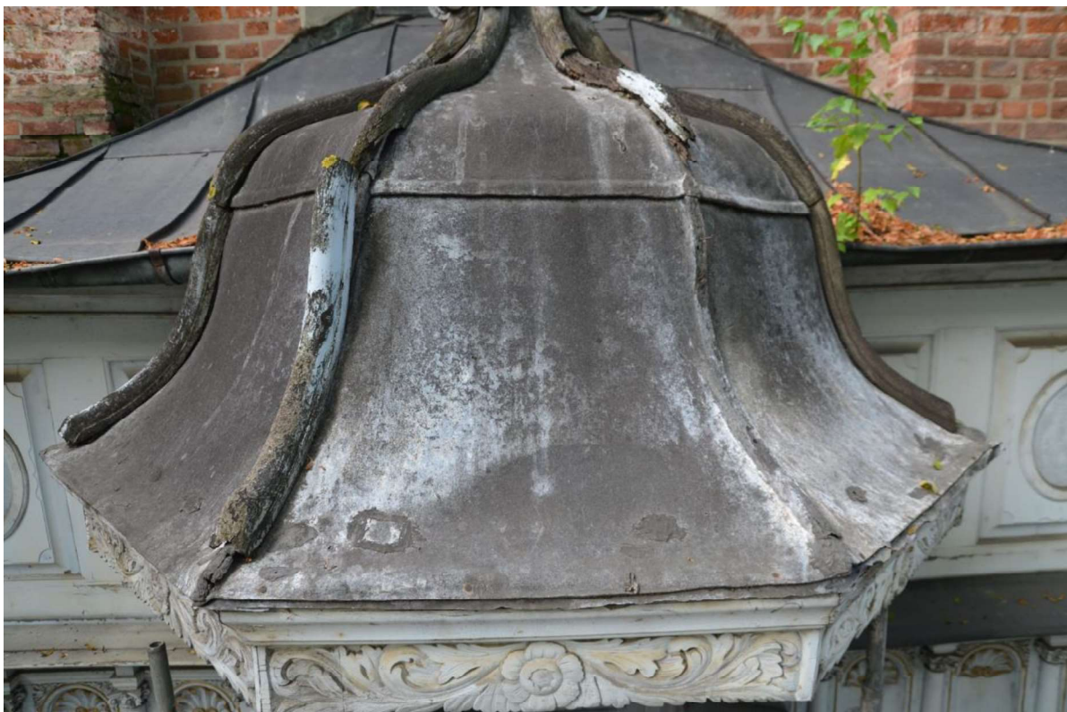
il 5 Zadaszenie baldachimu - widoczne zniszczenia drewnianych elementów. Fot. M.Palka
