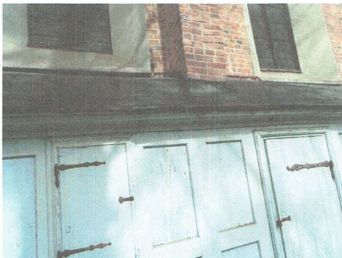
Zdjęcie 17, dach, tymczasowe pokrycie z papy.
