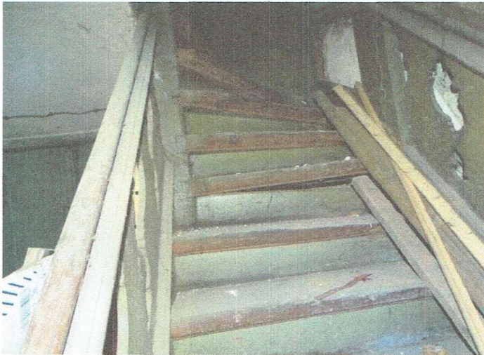
Zdjęcie 16, schody widok na zabieg.
