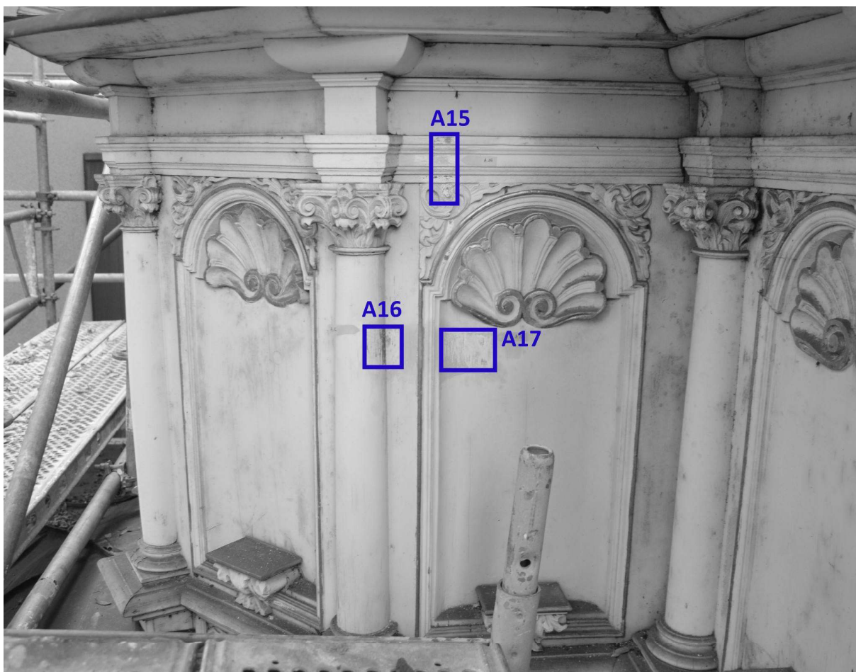
Il. , mapowanie rozmieszczenia odkrywek na ambonie zewnętrznej.
