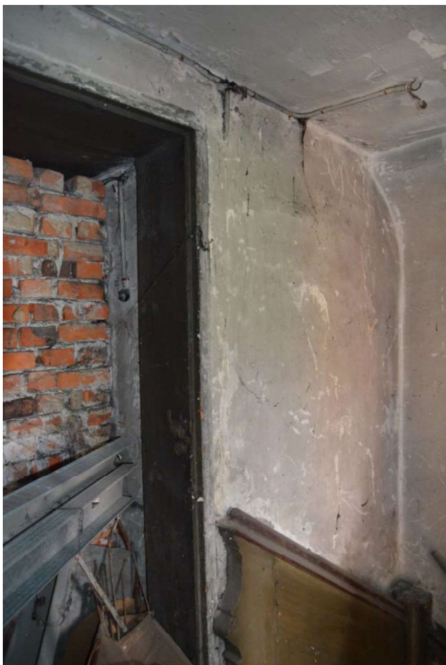
il 14 Wnętrze ambony - widoczna balustrada schodów. Fot. A.Faron.
