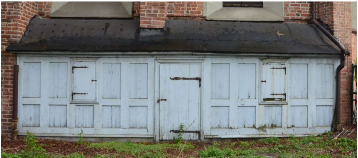
il 2 Przybudówka, stan przed pracami badawczymi. Fot. A. Faron
