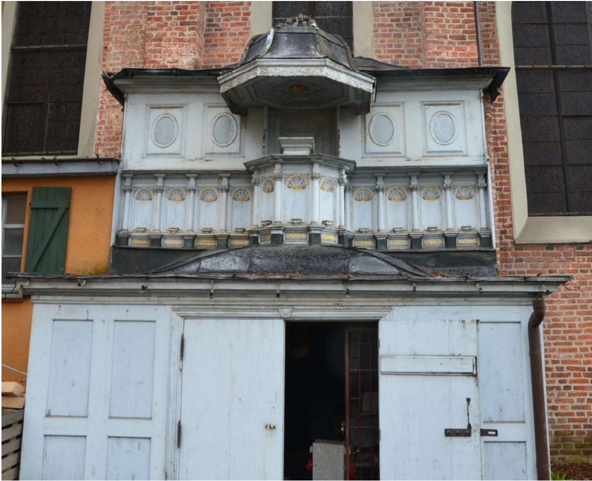
il 1 Ambona i kruchta, stan zachowania przed pracami badawczymi. Fot. A. Faron.
