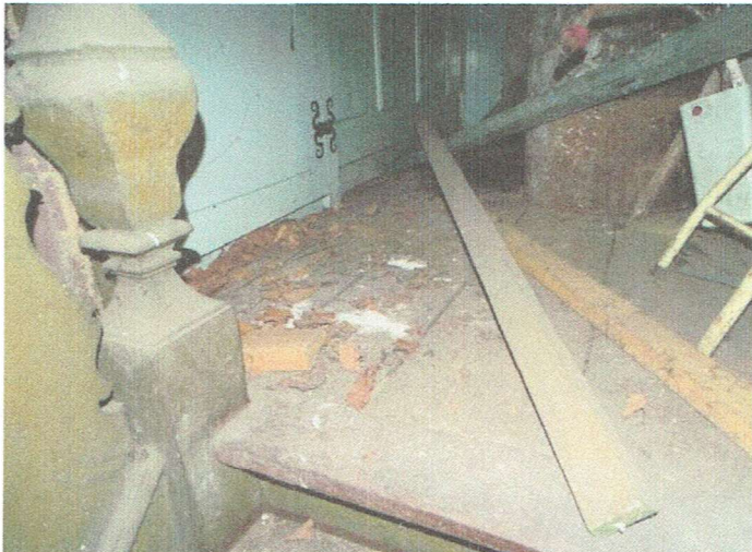
Zdjęcie 14, schody i podłoga górna z desek.
