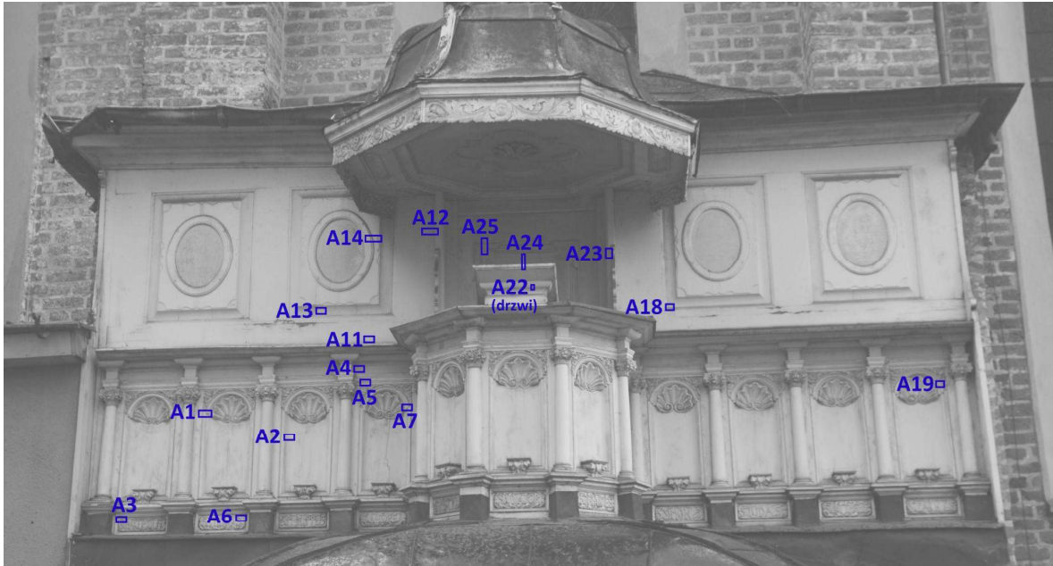
Il. , mapowanie rozmieszczenia odkrywek na ambonie zewnętrznej.
