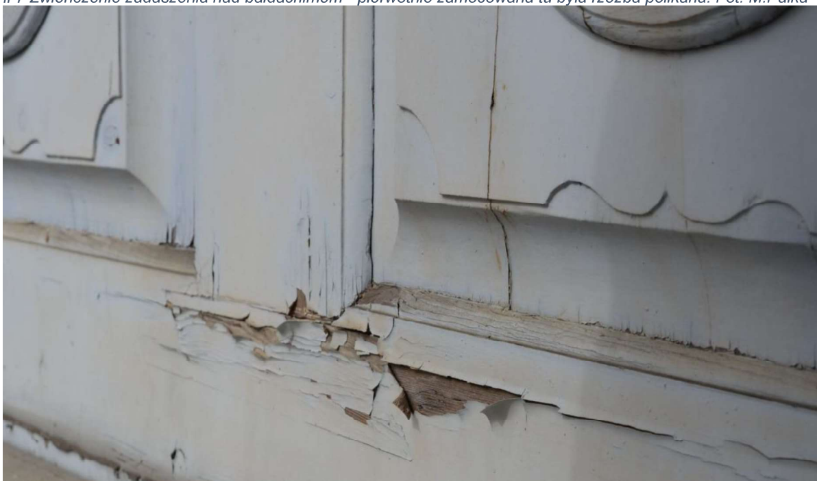
il 8 Góma część ambony - widoczne zniszczenia warstw malarskich. Fot. A. Faron.
