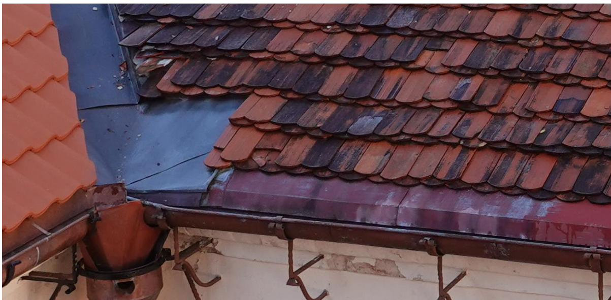
Ilustracja 14. Widok na część północną wschodniej połaci dachu skrzydła zachodniego przed pracami
