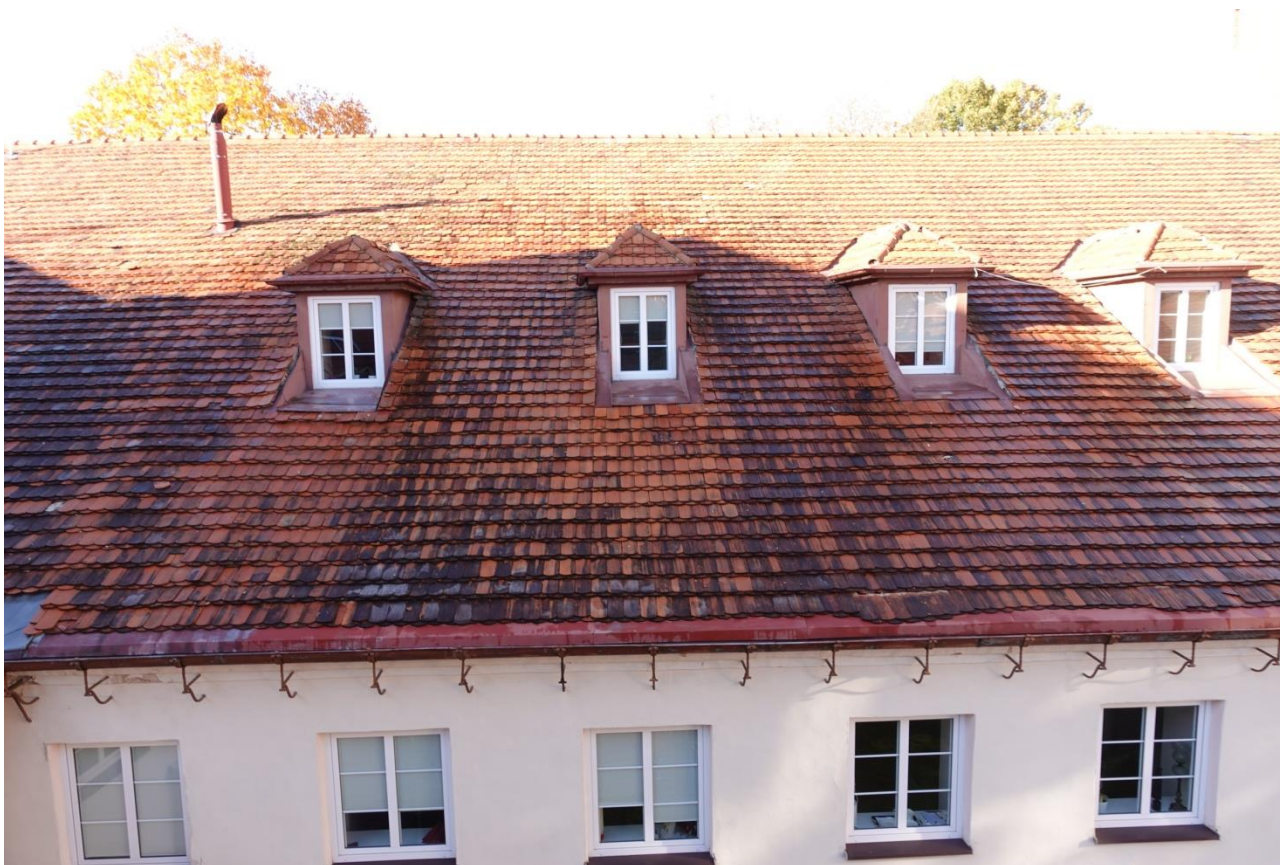
Ilustracja 12. Widok na część północną wschodniej połaci dachu skrzydła zachodniego przed pracami
