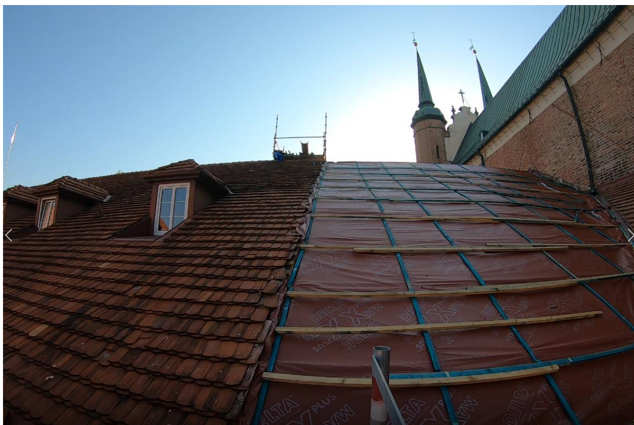
Ilustracja 21. Montaż membrany i kontrłat
