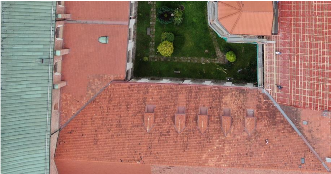
Ilustracja 8. Widok na część północną wschodniej połaci dachu skrzydła zachodniego przed pracami
