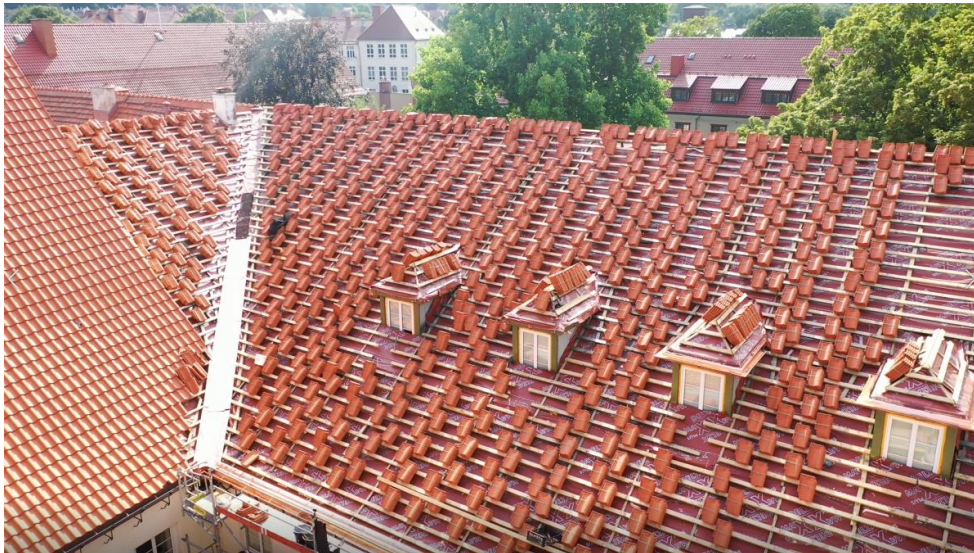
Ilustracja 26. Montaż dachówek
