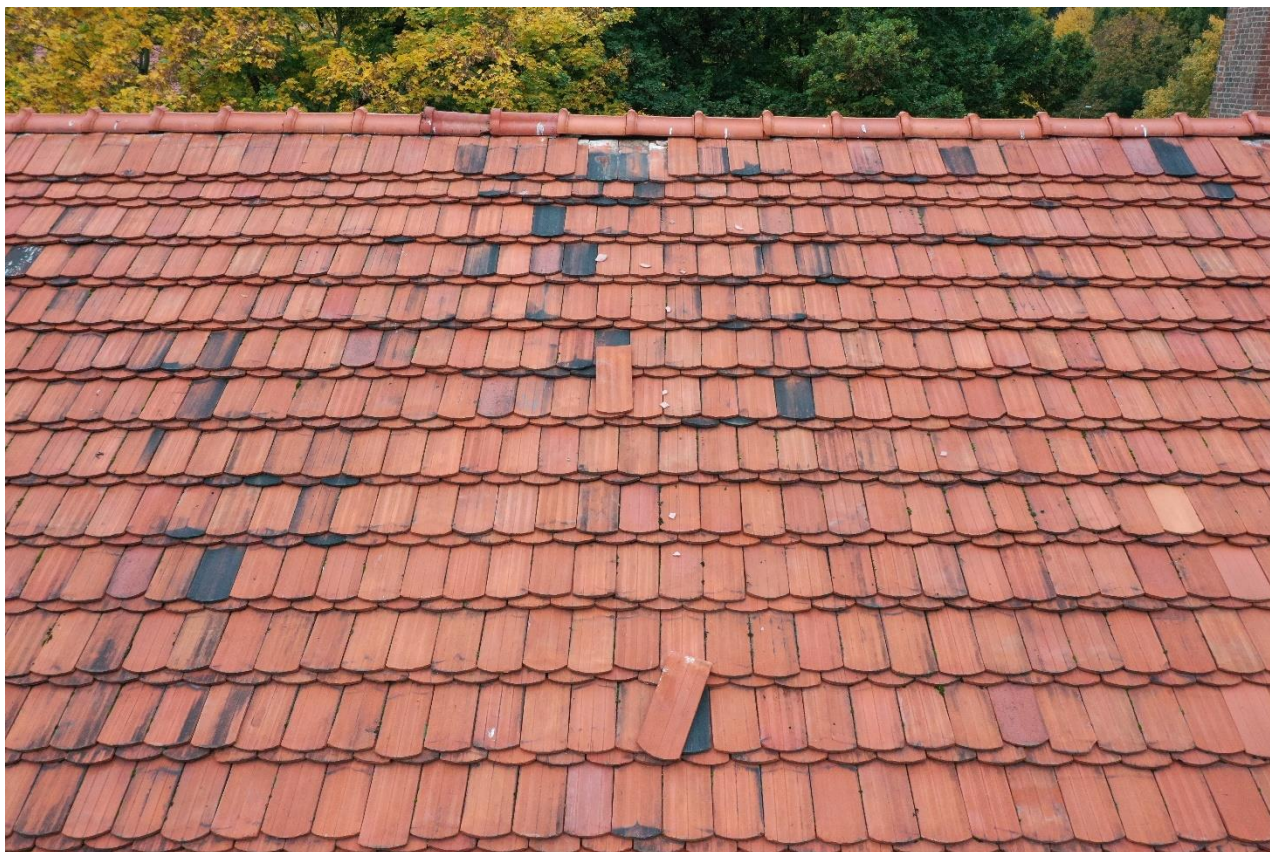
Ilustracja 18. Widok zsuwających się dachówek - część północna wschodniej połaci dachu skrzydła zachodniego.
