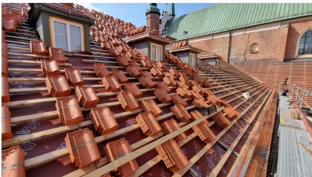
Ilustracja 25. Montaż dachówek
