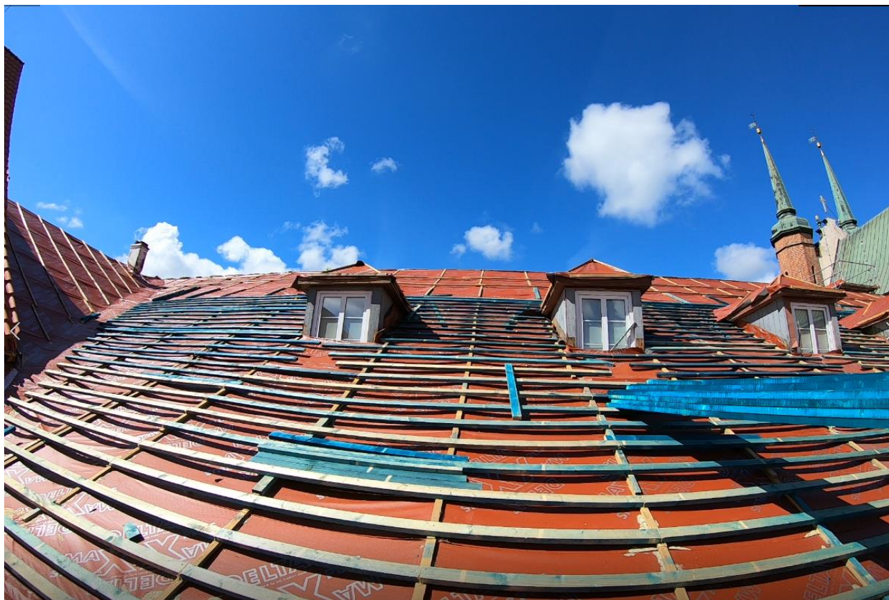
Ilustracja 24. Montaż łąt i kontrłat
