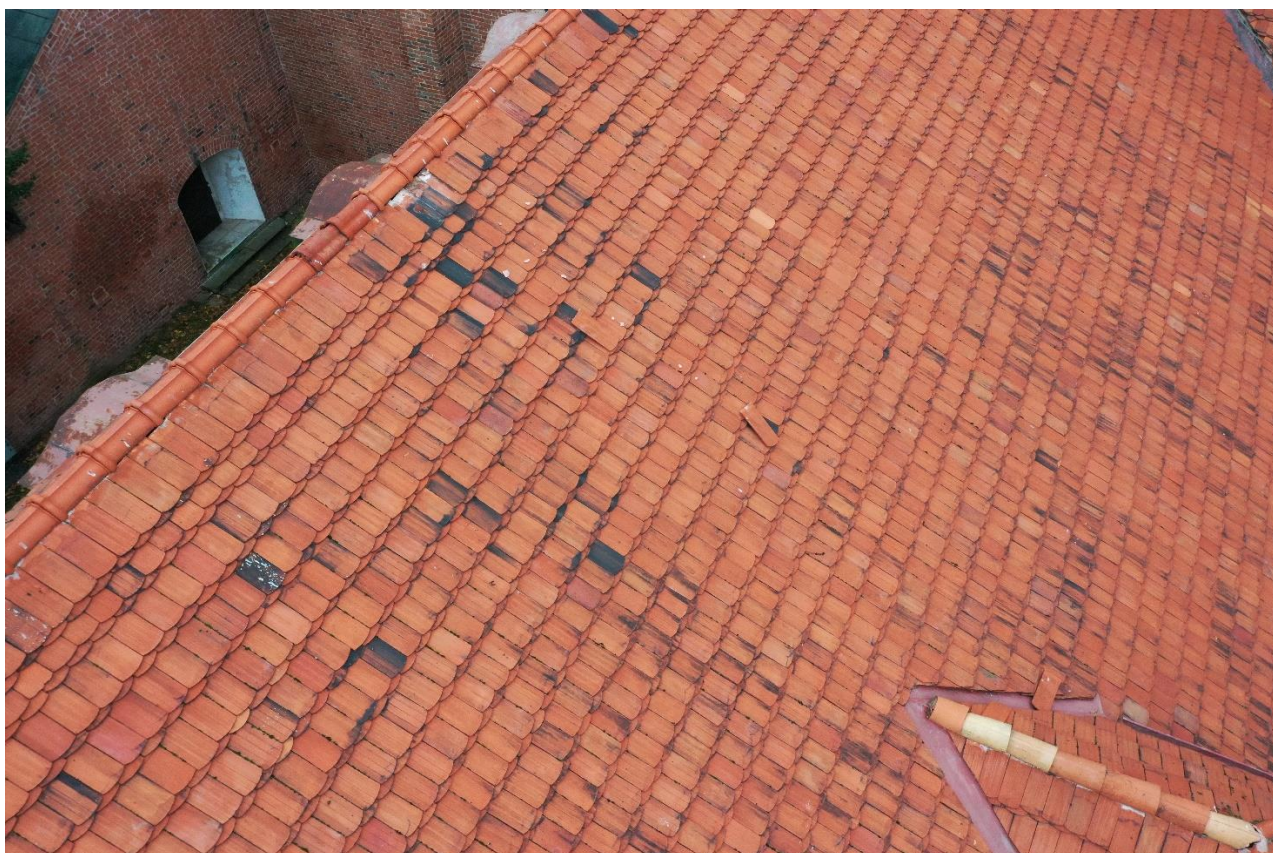
Ilustracja 17. Widok zsuwających się dachówek - część północna wschodniej połaci dachu skrzydła zachodniego.
