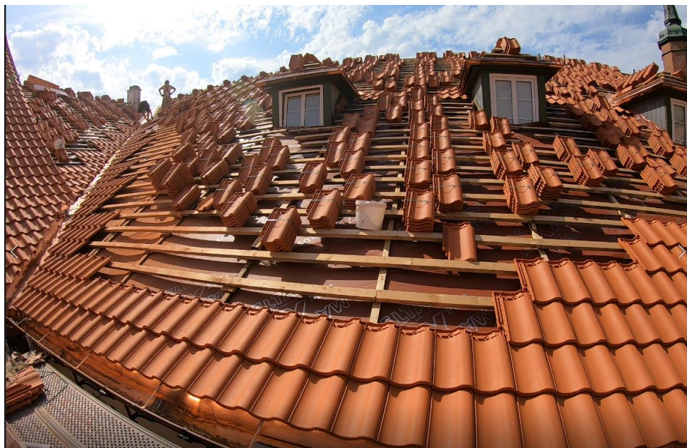
Ilustracja 28. Montaż dachówek
