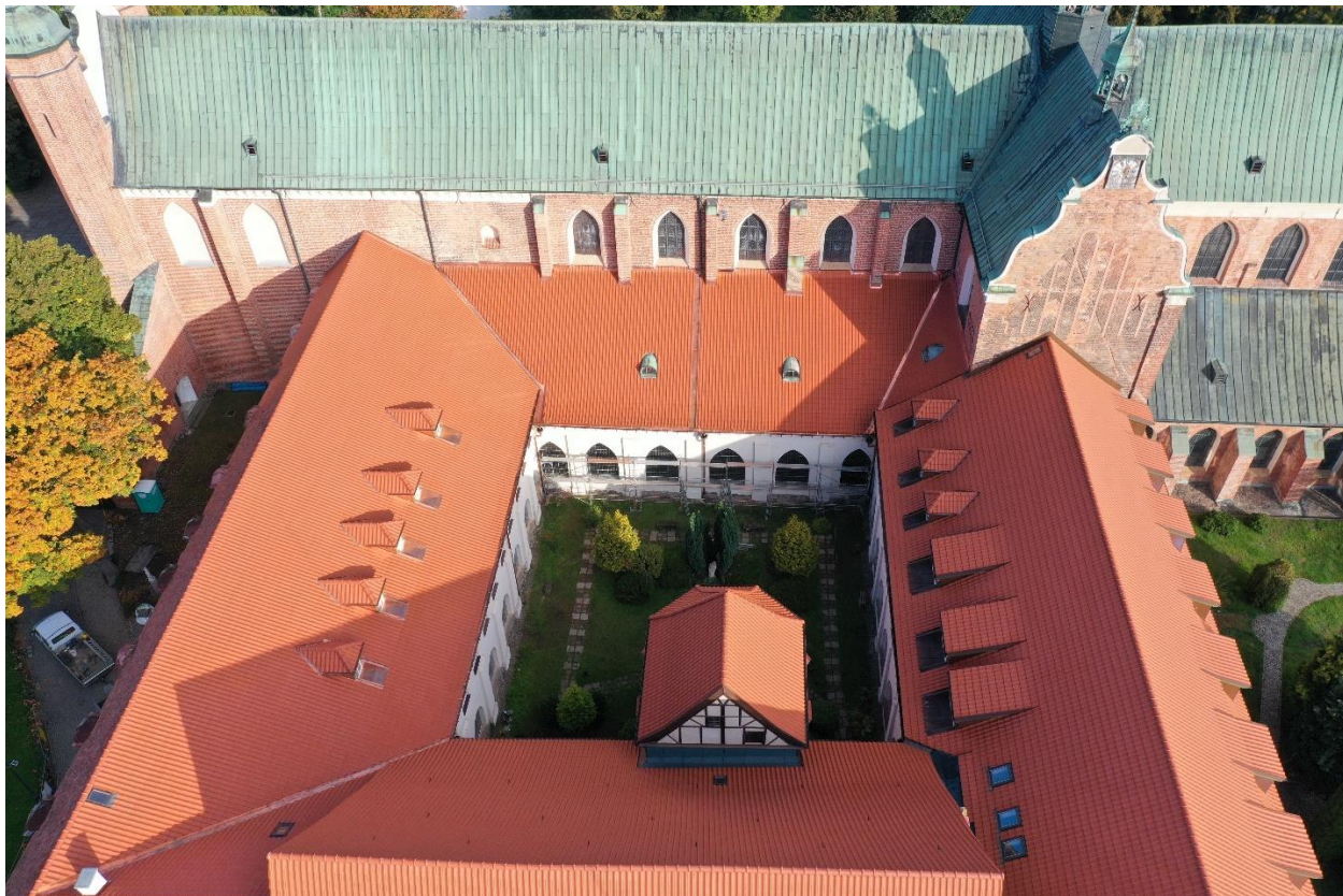
Ilustracja 39. Widok ogólny na dachy Seminarium, w tym połać wyremontowana dzięki dotacji Gminy Miasta Gdańska
