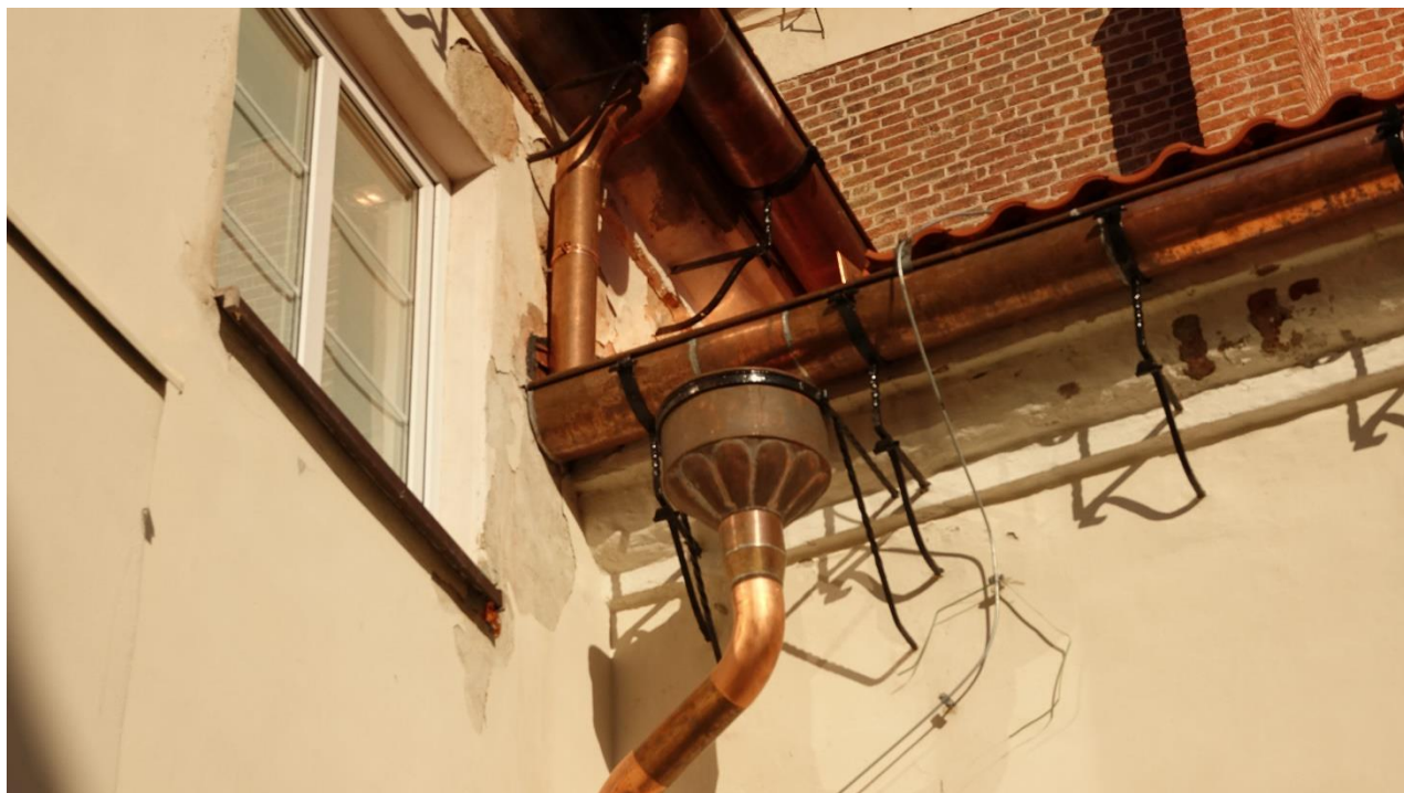
Ilustracja 35. Widok na nowe obróbki blacharskie – lejek spustowy
