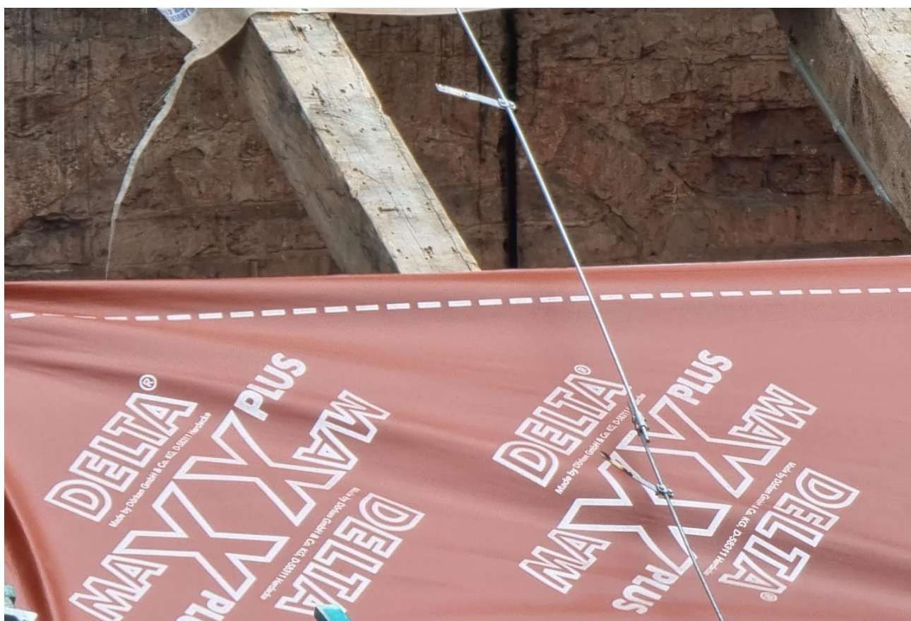
Ilustracja 22. Montaż membrany
