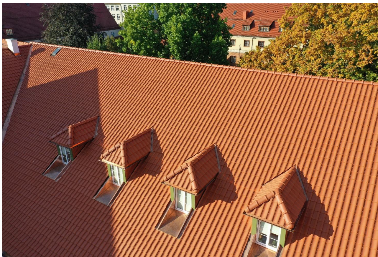
Ilustracja 34. Widok na wyremontowaną połąć
