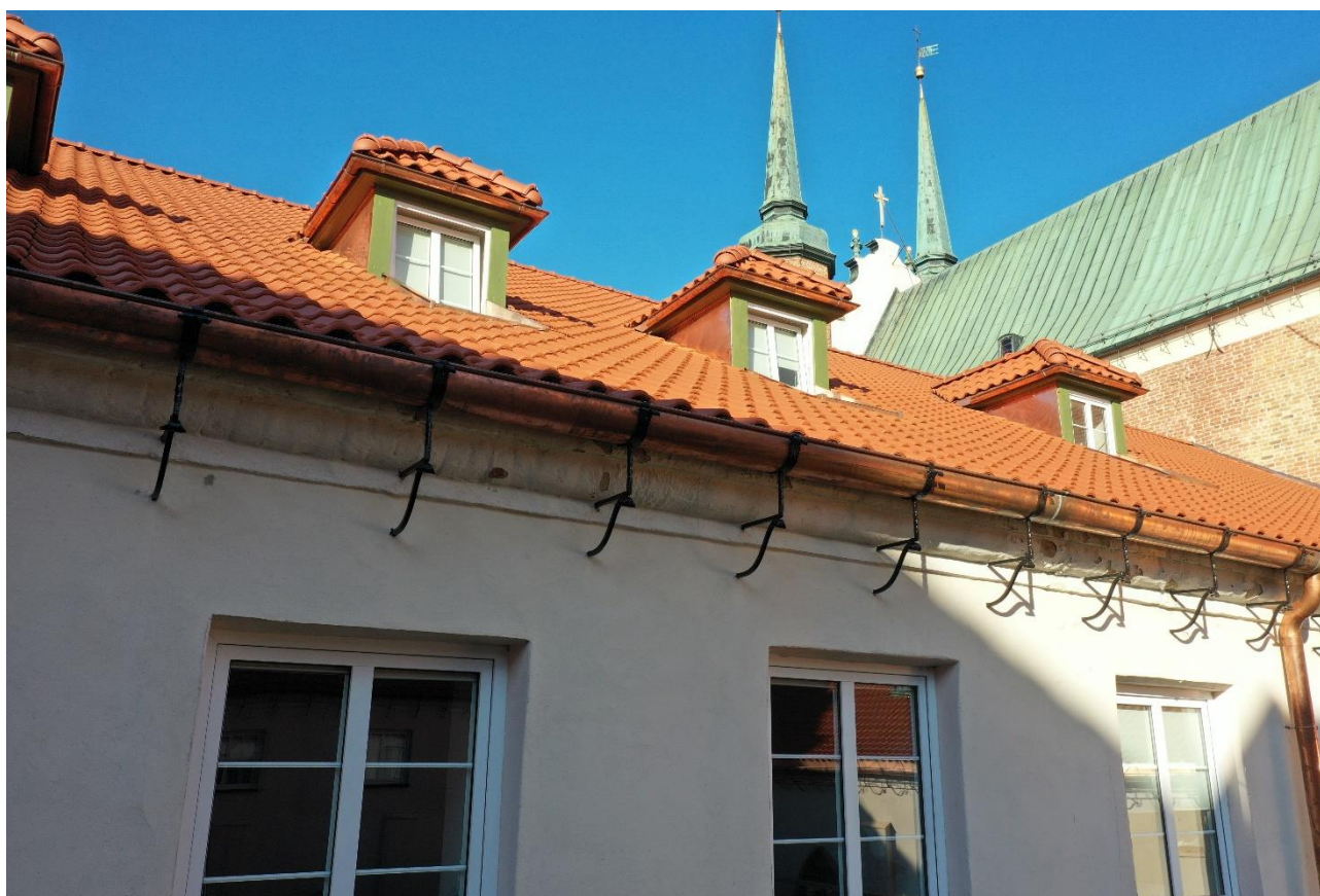
Ilustracja 30. Widok na nową połać z orynnowaniem
