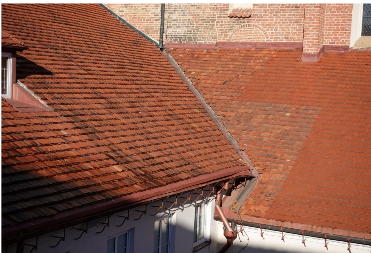
Ilustracja 15. Widok na część północną wschodniej połaci dachu skrzydła zachodniego przed pracami
