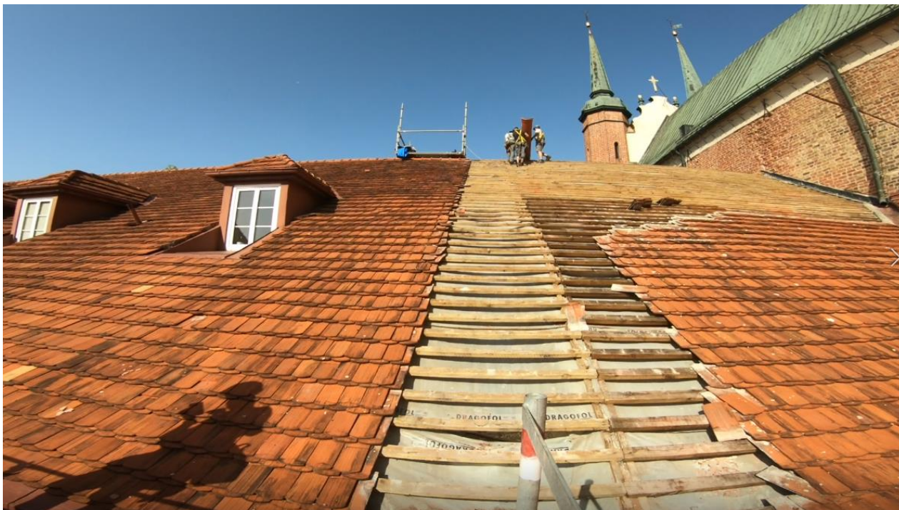
Ilustracja 20. Demontaż starej dachówki
