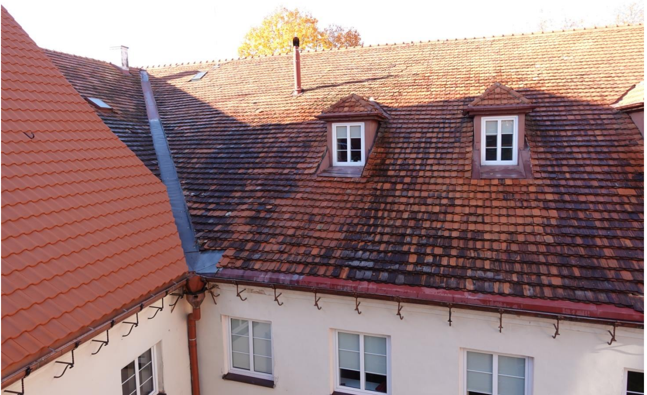
Ilustracja 11. Widok na część północną wschodniej połaci dachu skrzydła zachodniego przed pracami
