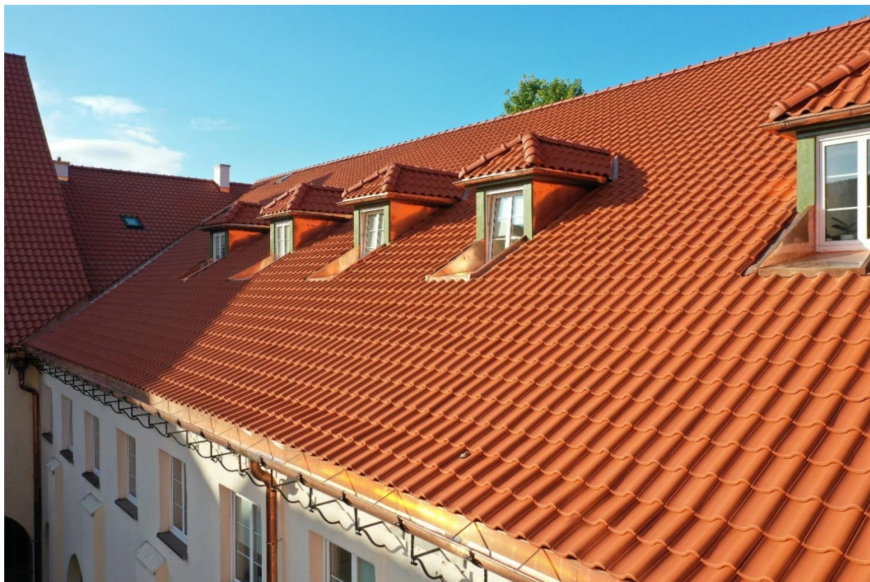
Ilustracja 31. Połac z nowym pokryciem i obróbkami blacharskimi
