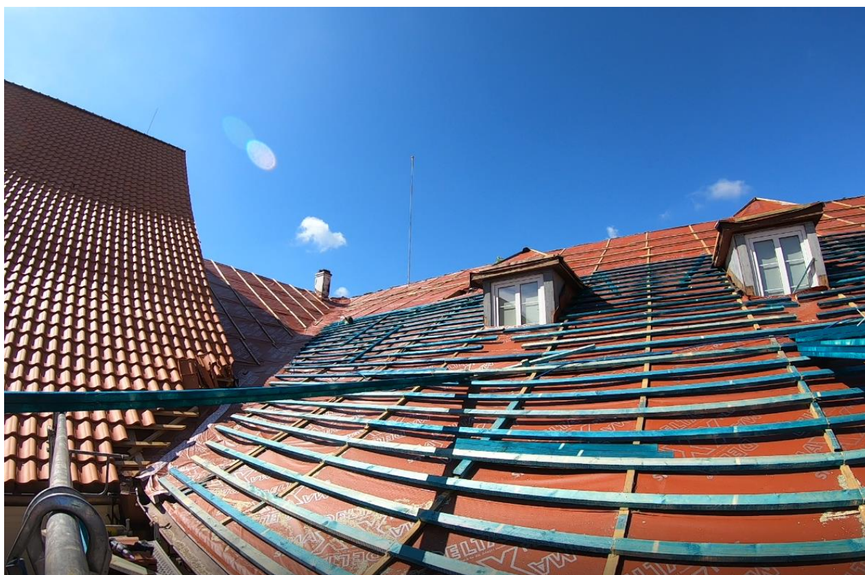
Ilustracja 23. Montaż łąt i kontrłąt
