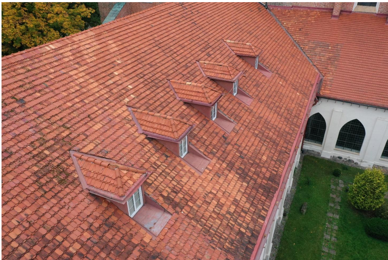
Ilustracja 16. Widok na część północną wschodniej połaci dachu skrzydła zachodniego przed pracami
