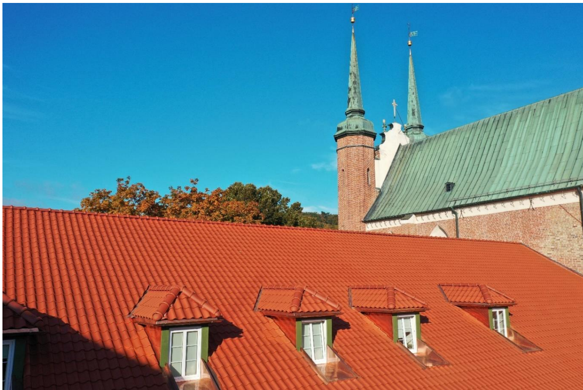
Ilustracja 29. Wyremontowana połać dachu
