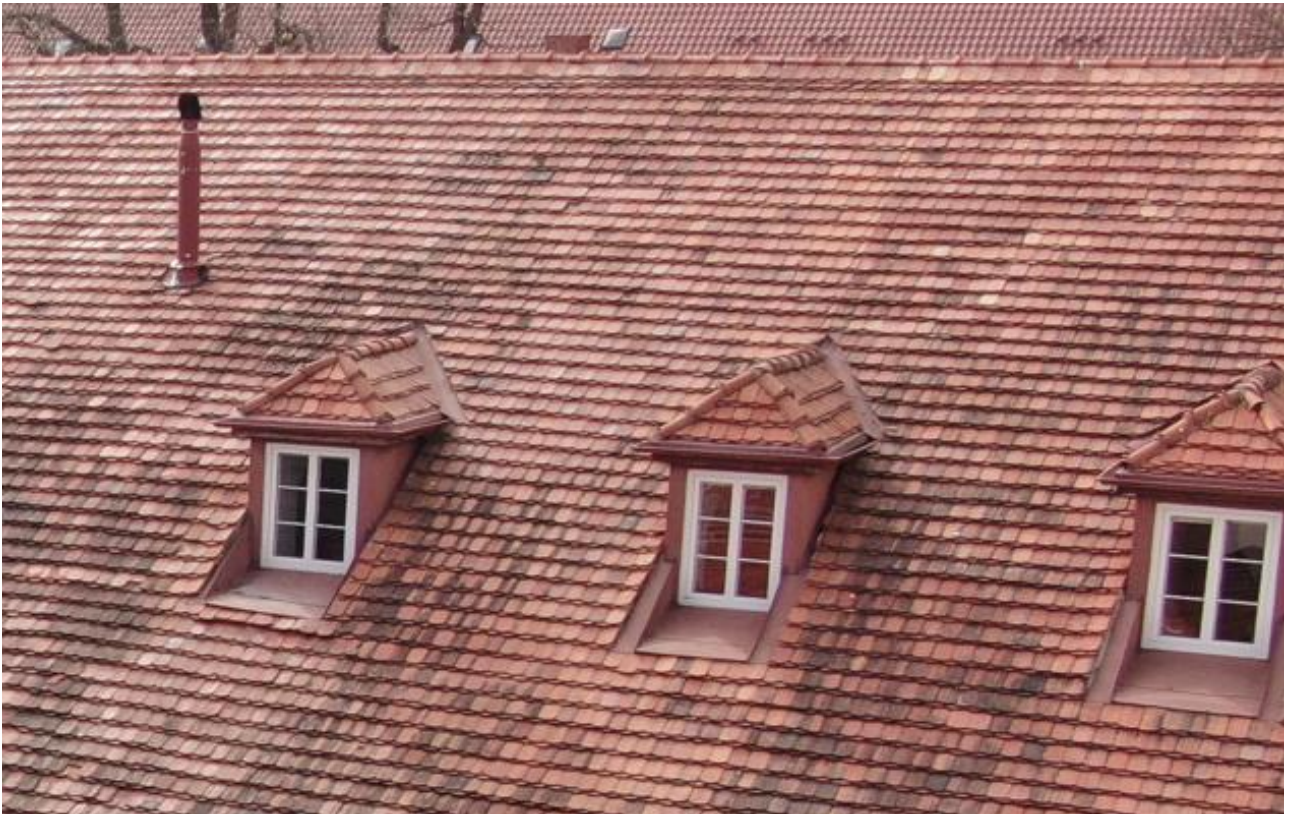
Ilustracja 10. Widok na część północną wschodniej połaci dachu skrzydła zachodniego przed pracami
