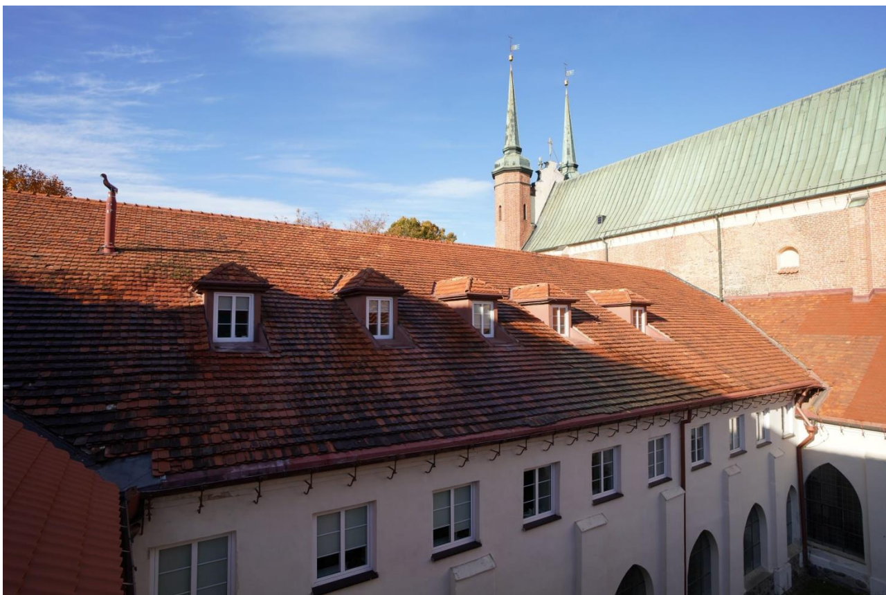
Ilustracja 13. Widok na część północną wschodniej połaci dachu skrzydła zachodniego przed pracami
