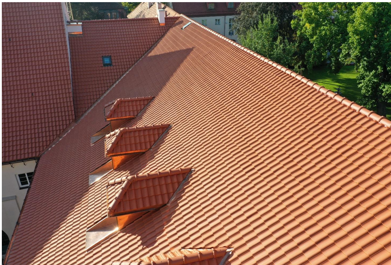
Ilustracja 33. Widok na wyremontowaną połąć
