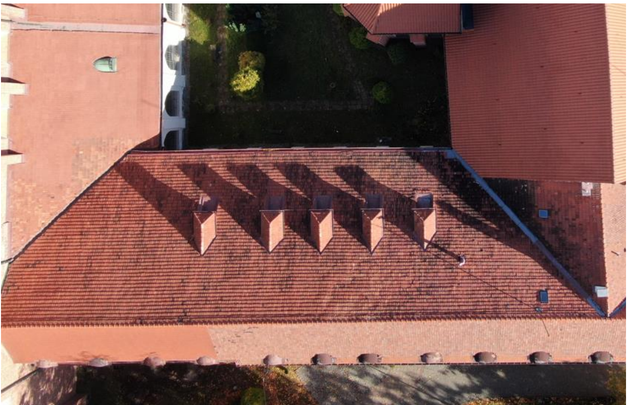
Ilustracja 9. Widok na część północną wschodniej połaci dachu skrzydła zachodniego przed pracami
