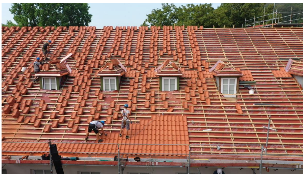
Ilustracja 27. Montaż dachówek
