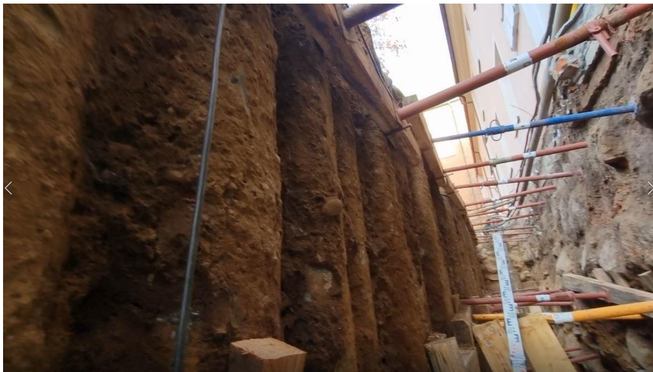
Ilustracja 23. Prace przygotowawcze do zabezpieczenia powierzchni między palami zaczynem cementowym
