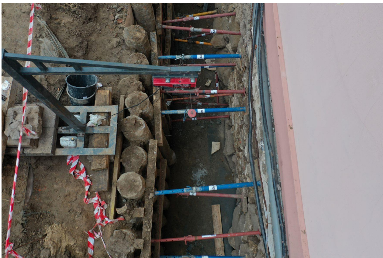
Ilustracja 27. Zdjęcia po zakończeniu pierwszej części prac - - wykonanie palisady oraz podbudowy płyty dennej
