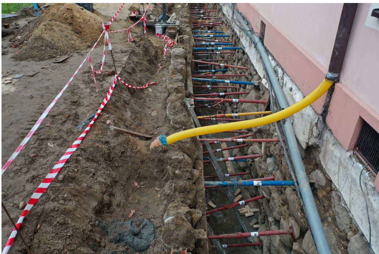
Ilustracja 25. Zdjęcia po zakończeniu pierwszej części prac - wykonanie palisady oraz podbudowy płyty dennej
