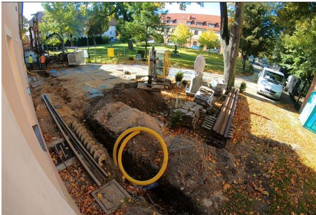
Ilustracja 19. Wykonanie kolejnych odwiertów pod pale
