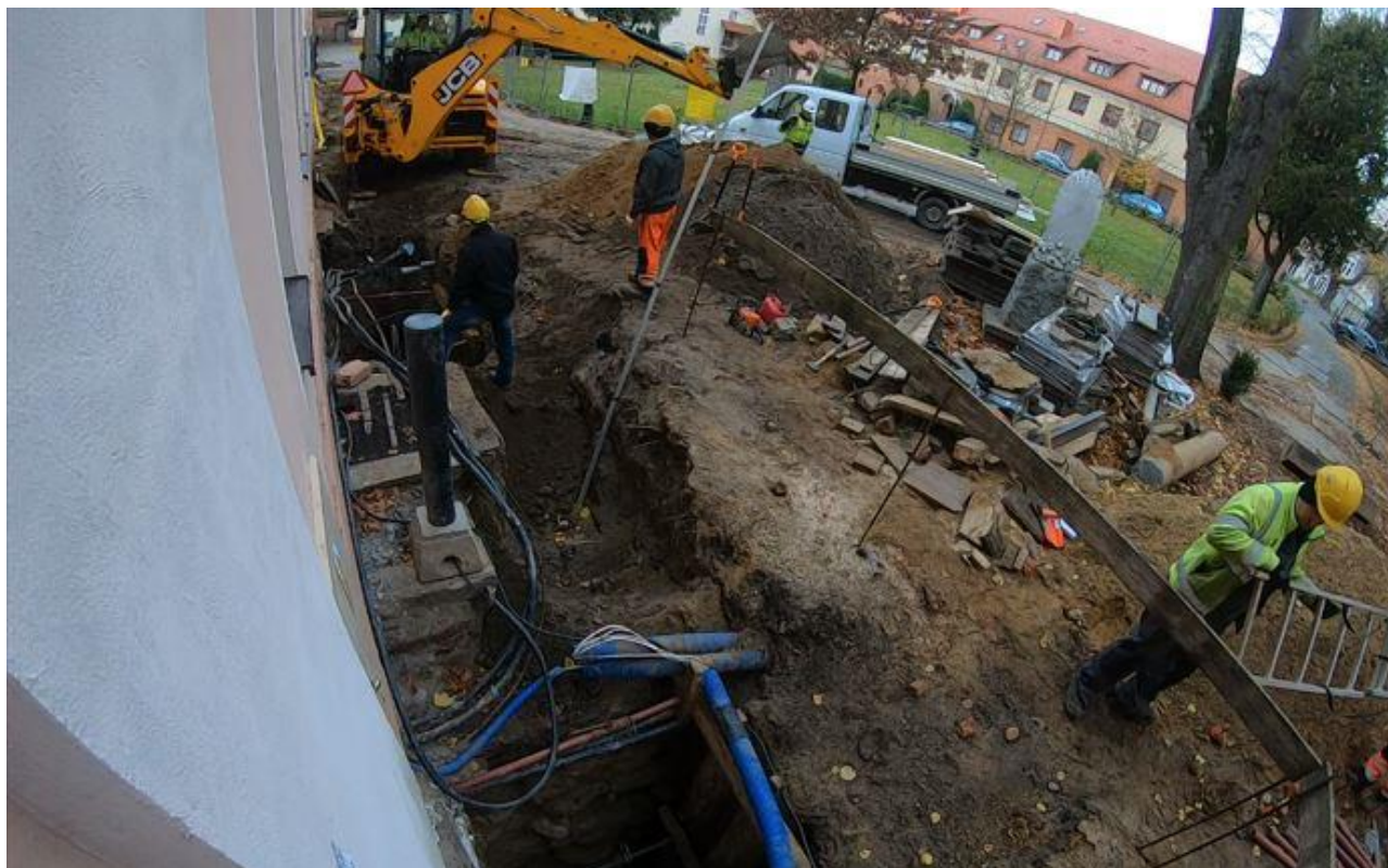
Ilustracja 21. W trakcie prac – pogłębianie wykopu
