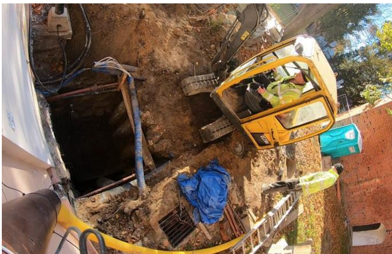
Ilustracja 20. W trakcie prac
