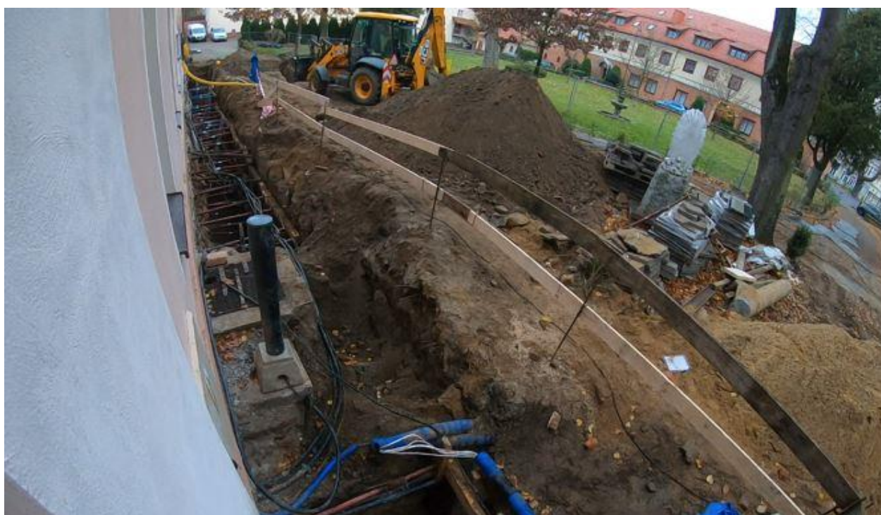
Ilustracja 22. W trakcie prac – pogłębianie wykopu
