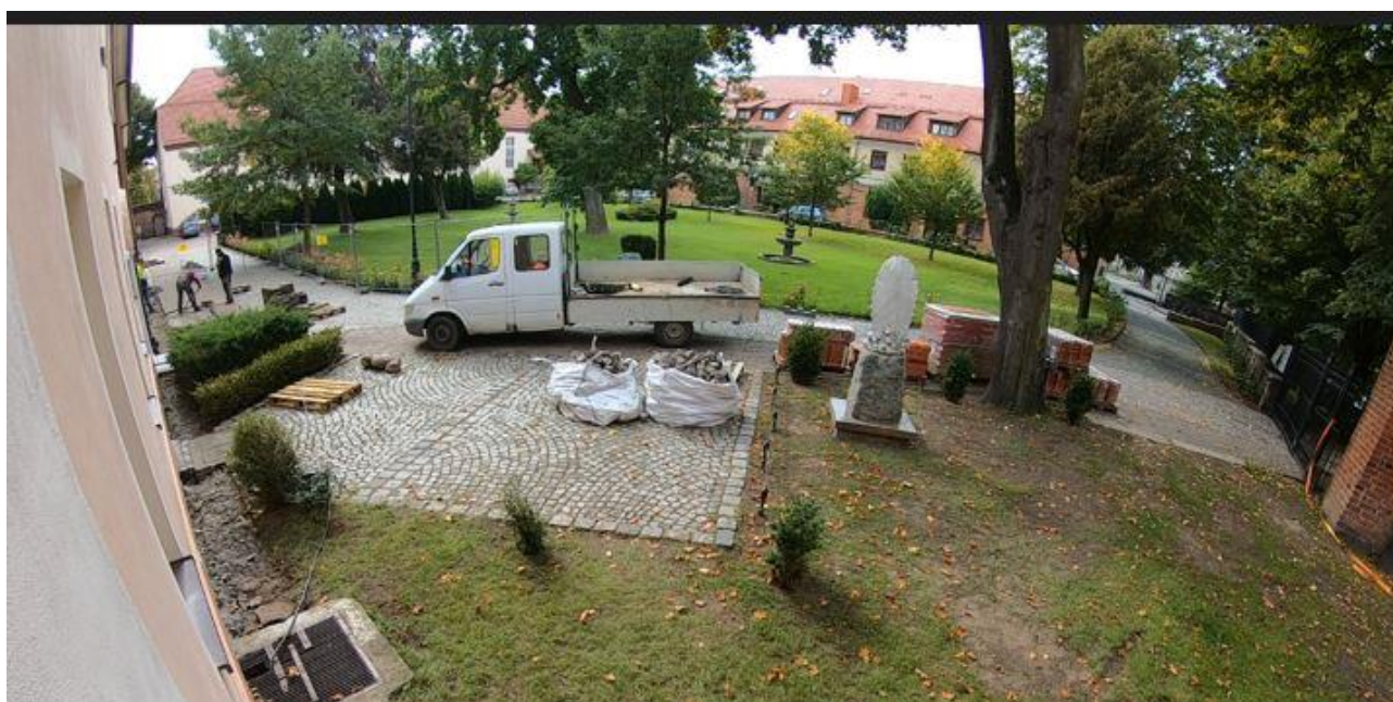
Ilustracja 14. Demontaż kostki brukowej
