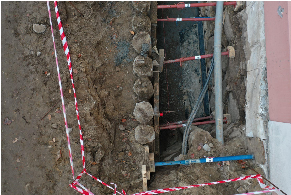
Ilustracja 26. Zdjęcia po zakończeniu pierwszej części prac - wykonanie palisady oraz podbudowy płyty dennej
