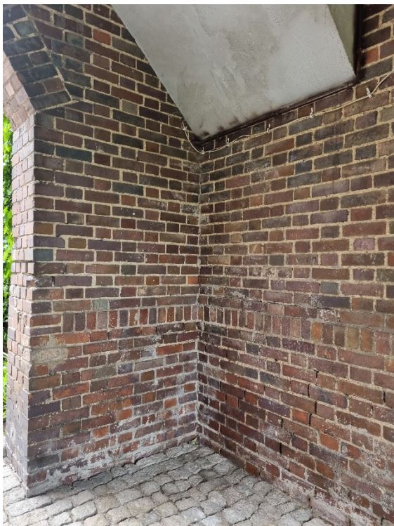
Ściany ceglane wnętrza bramy przejazdowej z widocznymi ubytkami w spoinowaniu , zabrudzeniami oraz uszkodzeniami mechanicznymi cegieł
