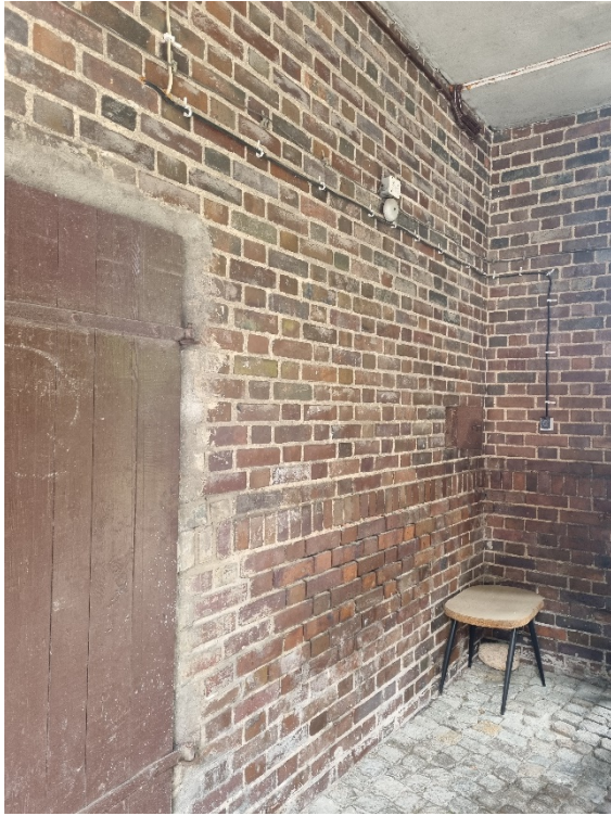
Wtórne przemurowanie ościeża drzwiowego /przemurowanie wykonane na zaprawie cementowej, na cegle pozostałości zaprawy/
