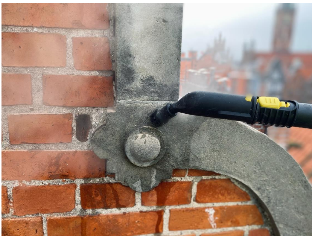
Ilustracja 22. Oczyszczanie kamiennych detali parownicą in situ
