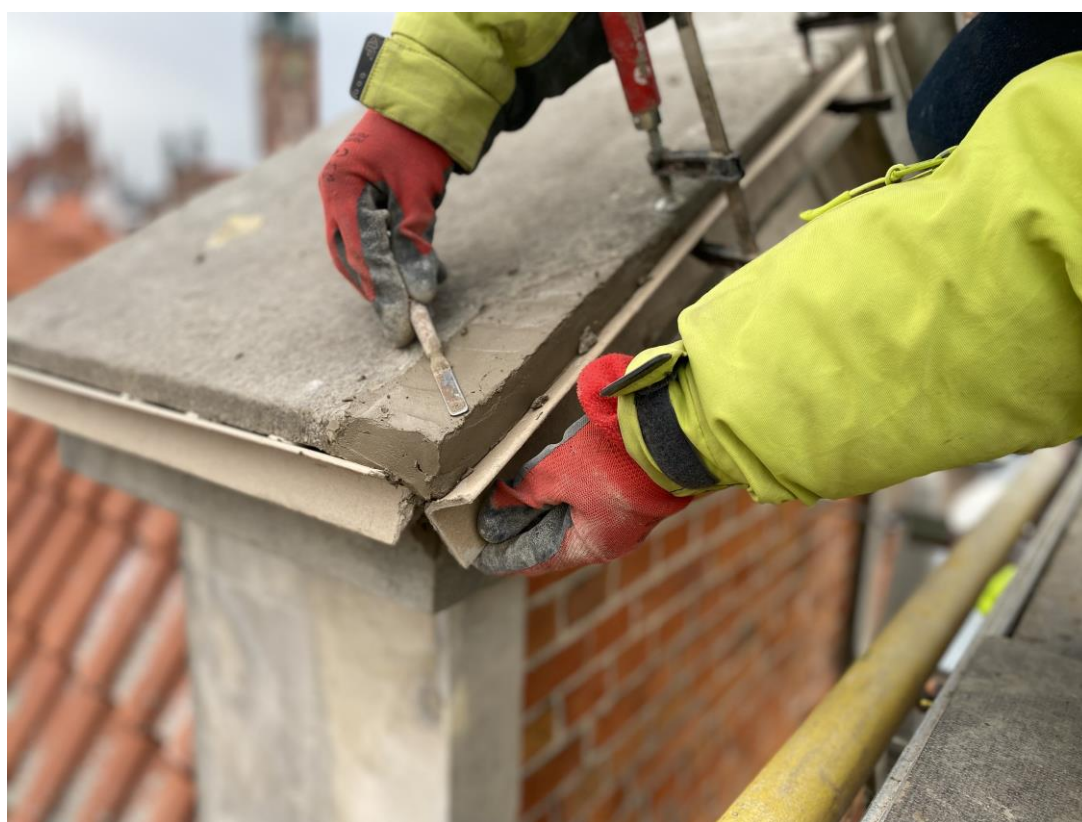
Ilustracja 27. Uzupełnienie większych ubytków in situ
