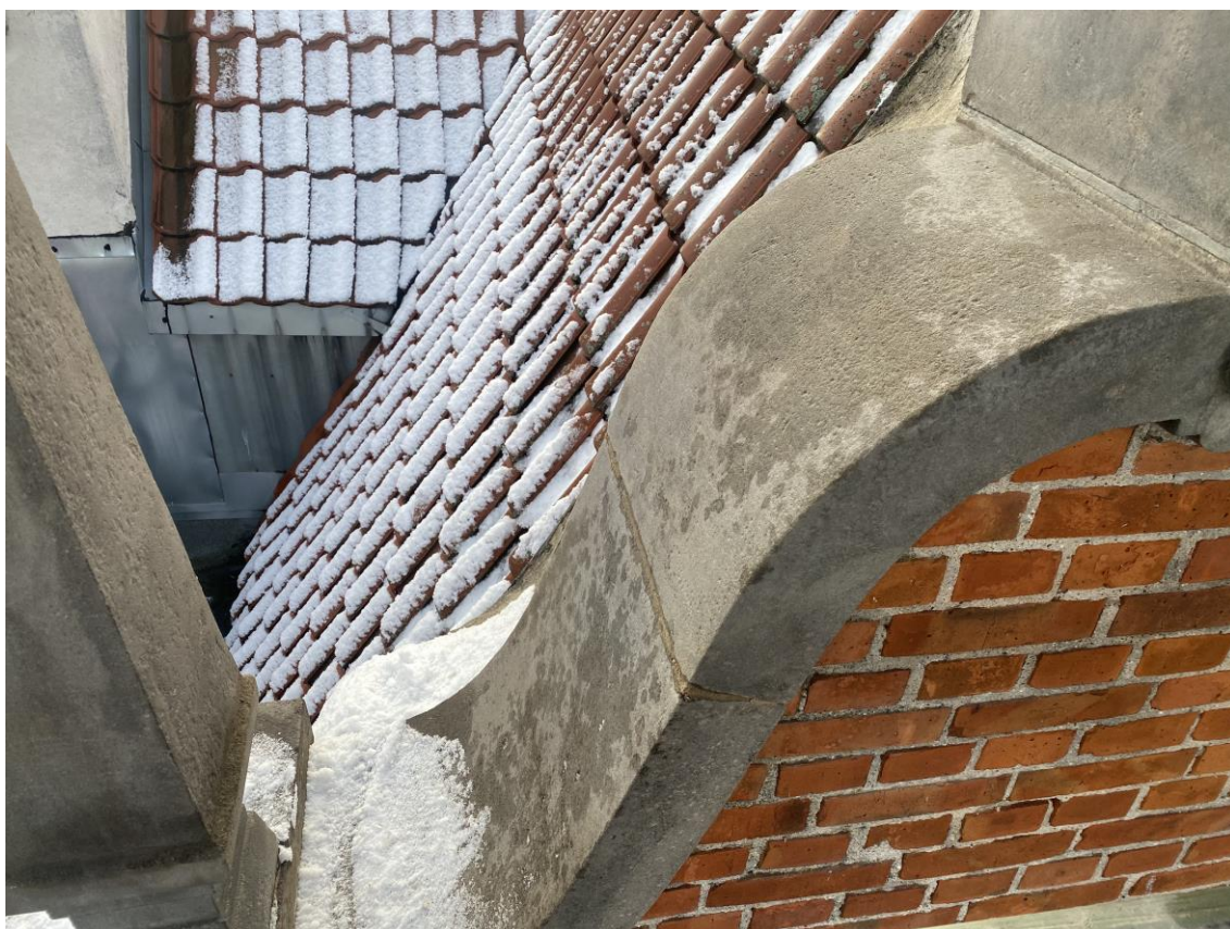
Ilustracja 30. Obiekt po zakończeniu prac konserwatorskich
