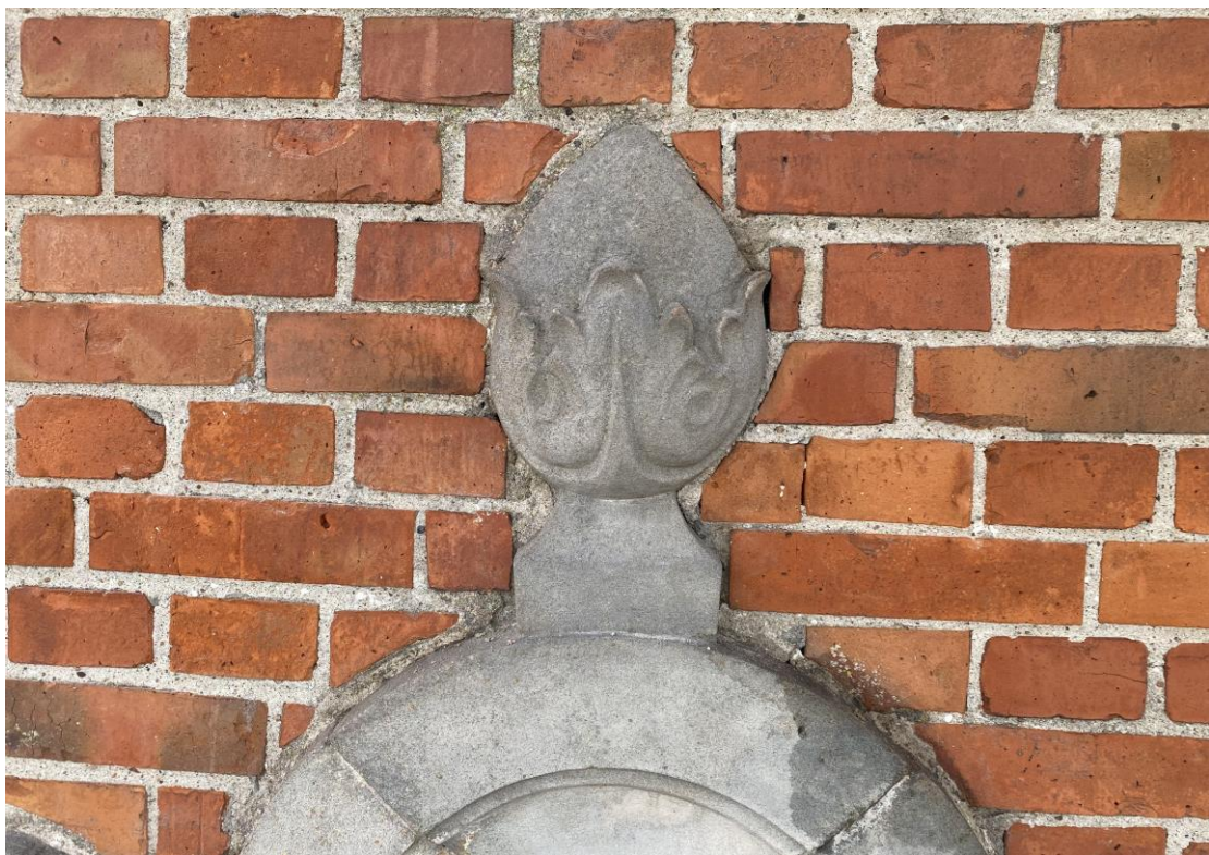
Ilustracja 33. Obiekt po zakończeniu prac konserwatorskich
