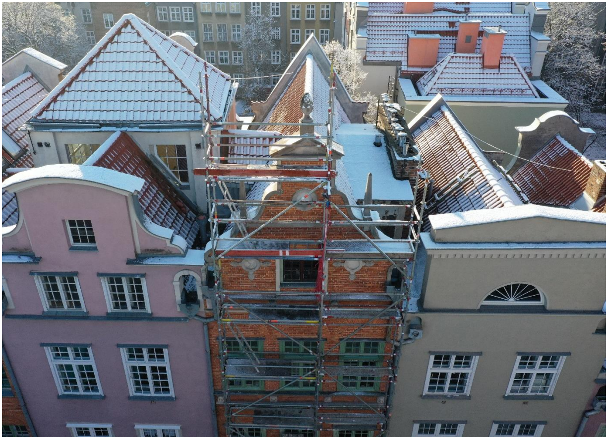
Ilustracja 34. Obiekt po zakończeniu prac konserwatorskich
