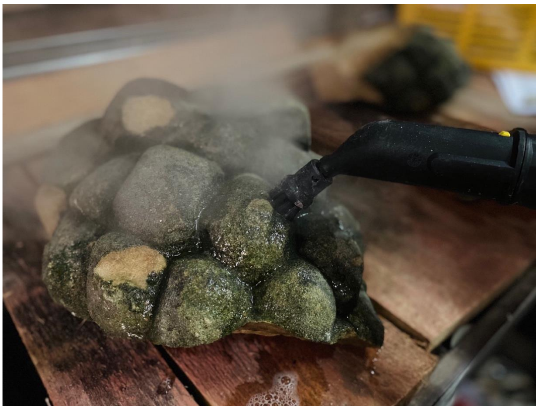
Ilustracja 14. Dezynfekcja oraz oczyszczanie detalu kamiennego parą wodną
