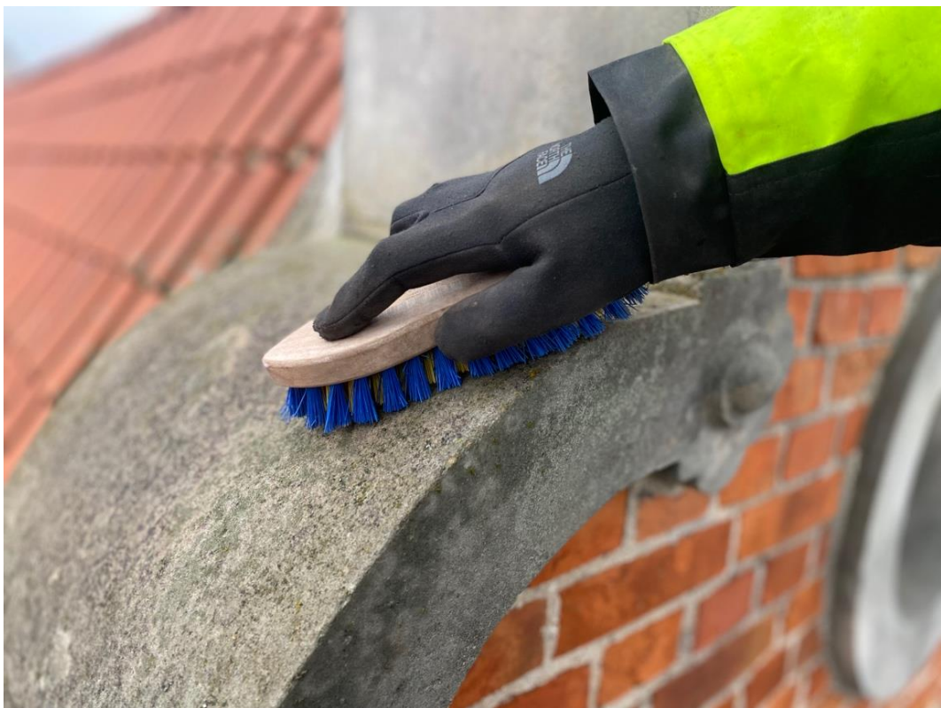
Ilustracja 21. Oczyszczanie powierzchni in situ
