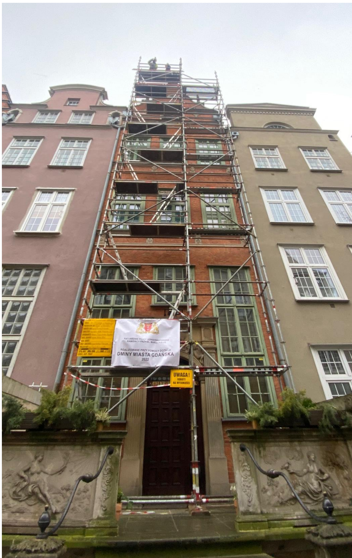
Ilustracja 36. Kamienica po zakończeniu prac – w trakcie odbioru konserwatorskiego
