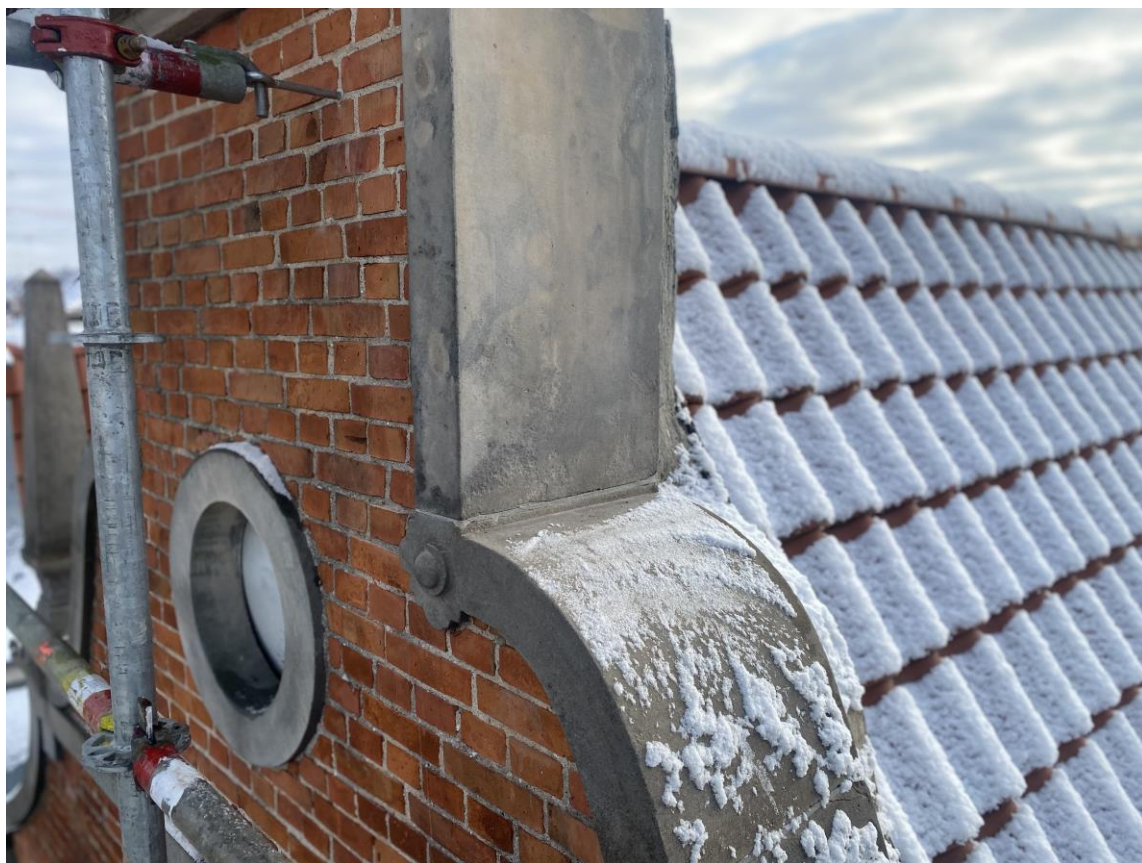
Ilustracja 31. Obiekt po zakończeniu prac konserwatorskich.
