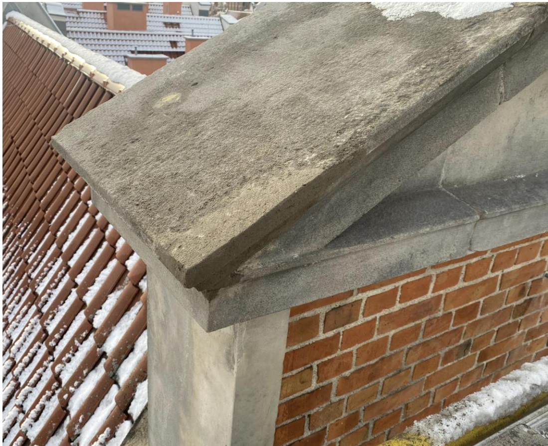
Ilustracja 32. Obiekt po zakończeniu prac konserwatorskich
