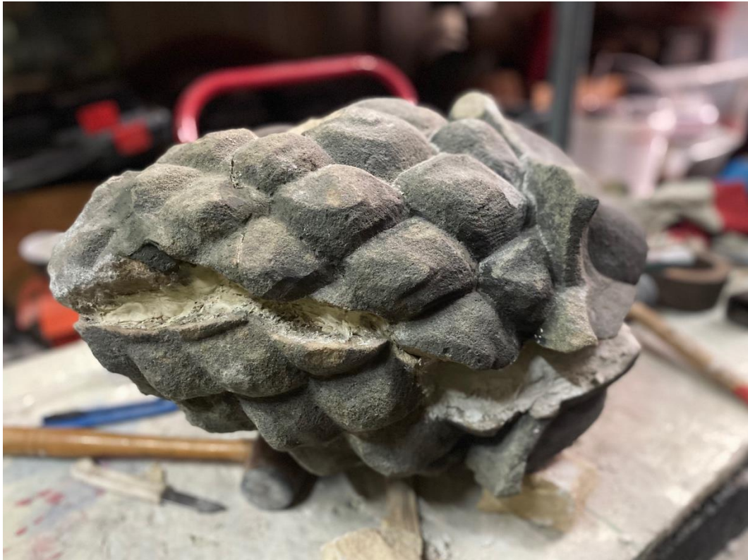
Ilustracja 18. Klejenie kamiennego elementu
