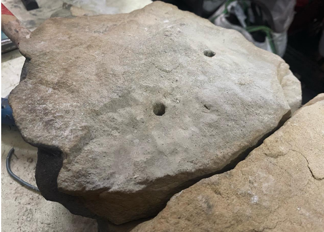
Ilustracja 16. Przygotowanie otworów pod zbrojenia
