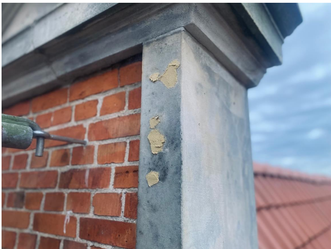
Ilustracja 26. Uzupełnienie drobnych elementów in situ
