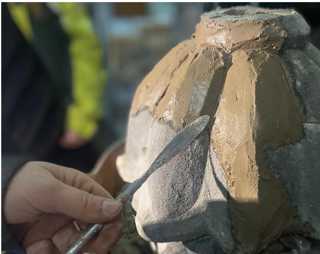
Ilustracja 19. Uzupelnienie większych ubytków
