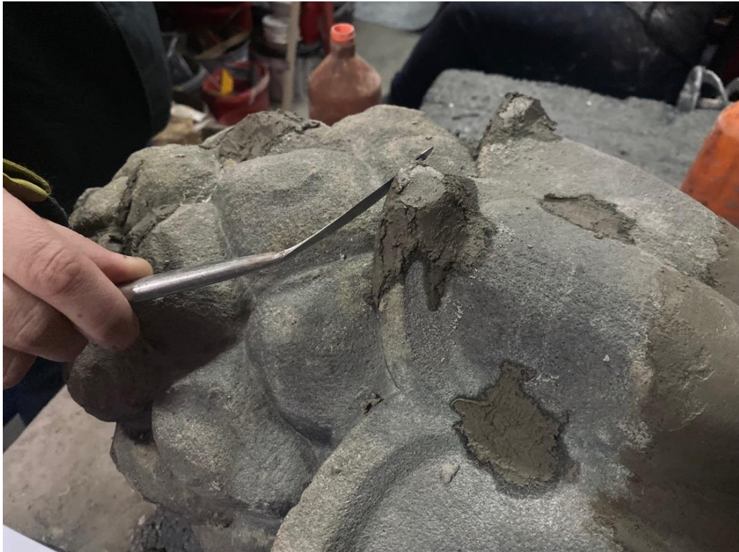
Ilustracja 20. Uzupelnienie mniejszych ubytków
