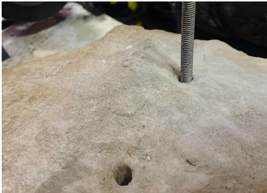
Ilustracja 17. Osadzenie prętów zbrojeniowych we wcześniej przygotowanych otworach, przelamy przygotowane do zabiegu sklepania
