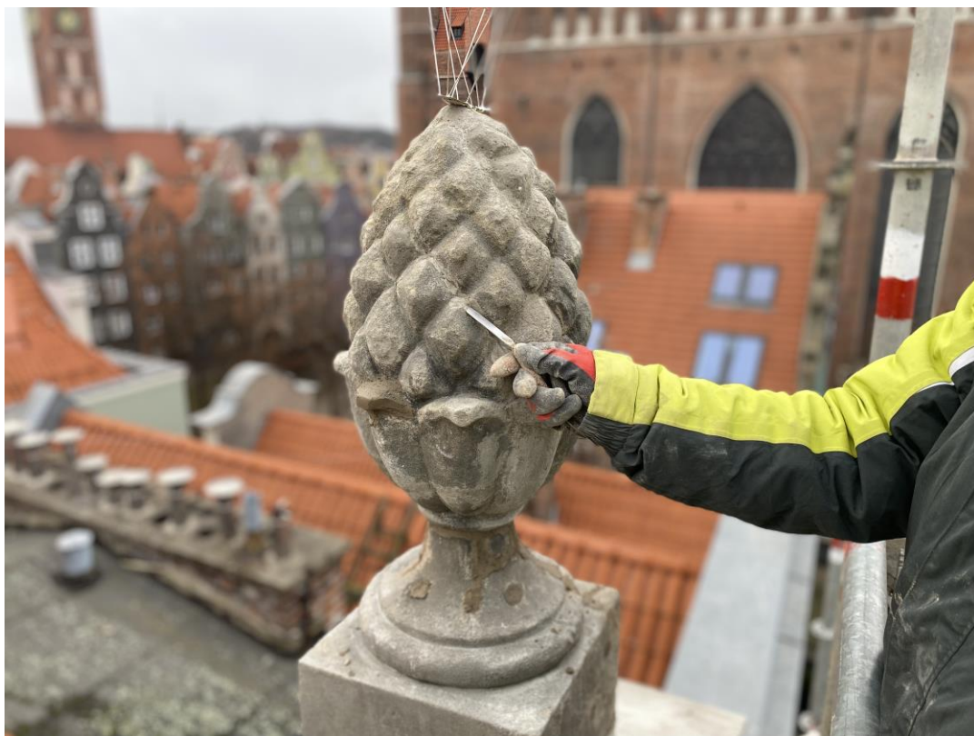
Ilustracja 25. Uzupelnienie drobnych ubytków in situ
