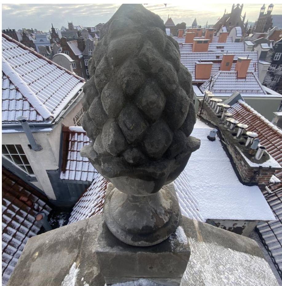
Ilustracja 29. Obiekt po zakończeniu prac konserwatorskich
