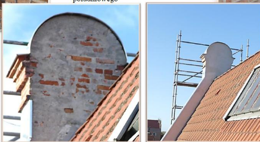
21-24. Odtworzenie wątków ceglanych części cokołowych elewacji tylnej
