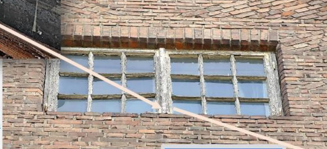
27,28,29. Po wejściu na rusztowanie stwierdzono konieczność wymiany zdestruowanych, powojennych okien nieużytkowego poddasza
