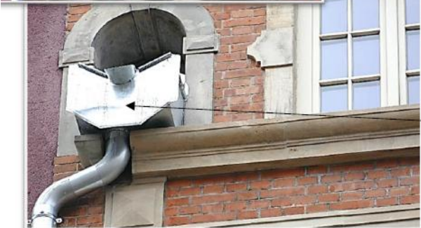
Widoczny jeden z trzech nowych koszy i rur spustowych
