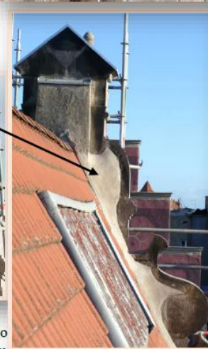
30-33. Oczyszczanie oryginalnego piaskowca oraz zabezpieczanie ścian tylnych tynkiem.
