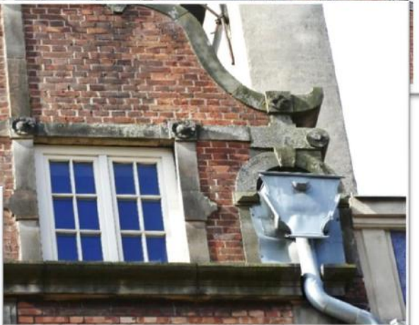
Widoczny jeden z trzech nowych koszy i rur spustowych
