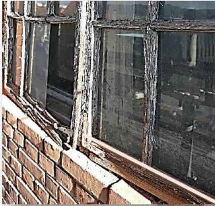
27,28,29. Po wejściu na rusztowanie stwierdzono konieczność wymiany zdestruowanych, powojennych okien nieużytkowego poddasza
