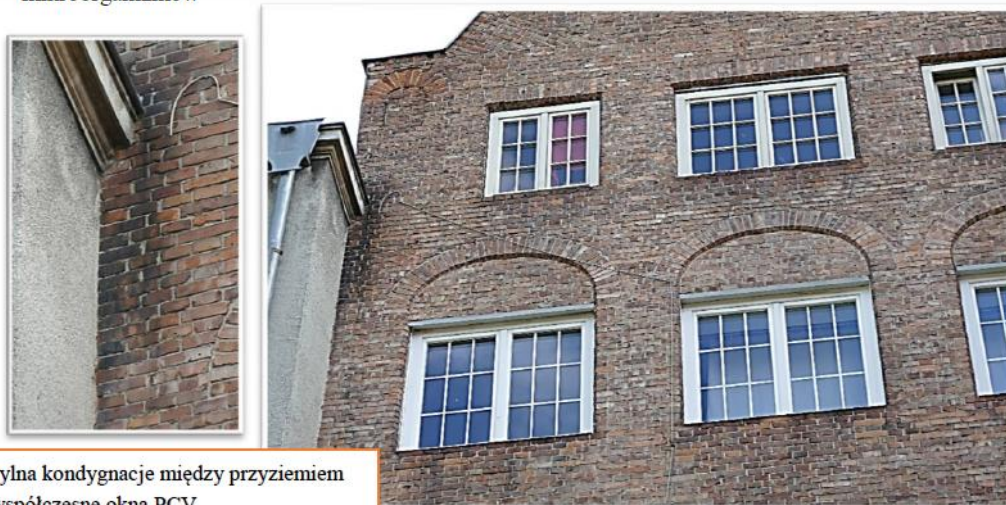
37. Zabrudzenia elewacji w wyniku ściekania deszczówki z opierzenia, namakania cegieł i porostu mikroorganizmów
