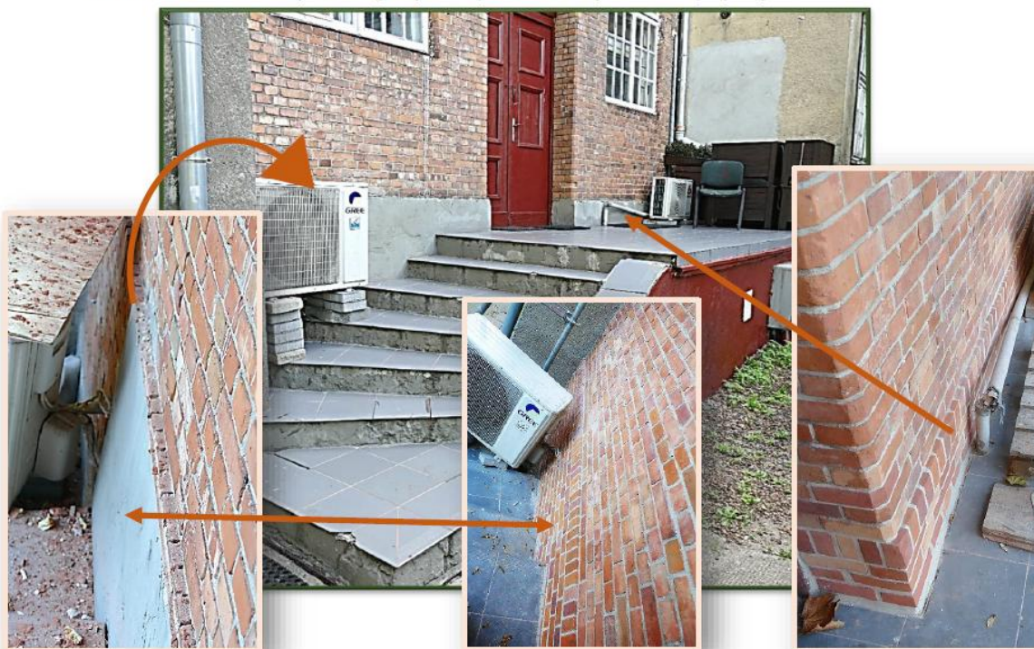
21-24. Odtworzenie wątków ceglanych części cokołowych elewacji tylnej
