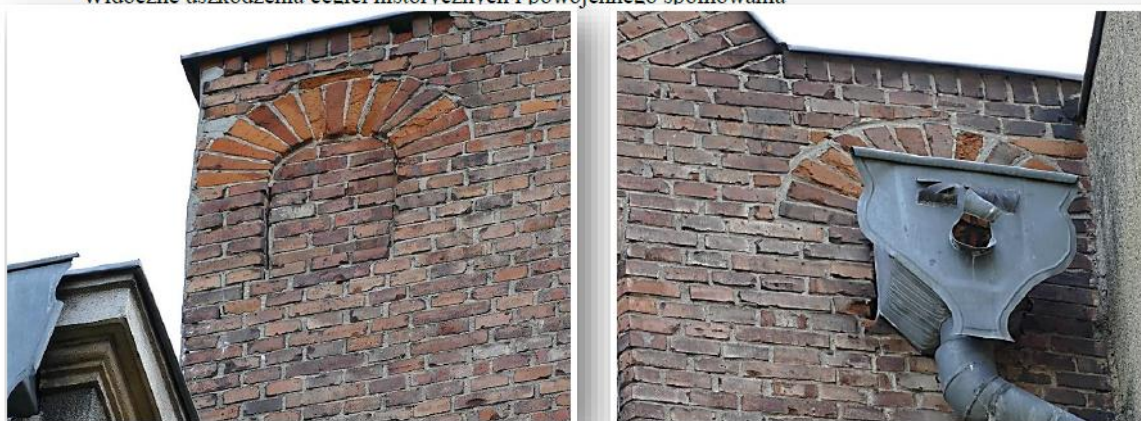
37. Zabrudzenia elewacji w wyniku ściekania deszczówki z opierzenia, namakania cegieł i porostu mikroorganizmów
