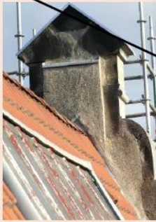
34,35,36. Proces czyszczenia kamienia oraz konstrukcyjnego wzmacniania elementu szczytu
