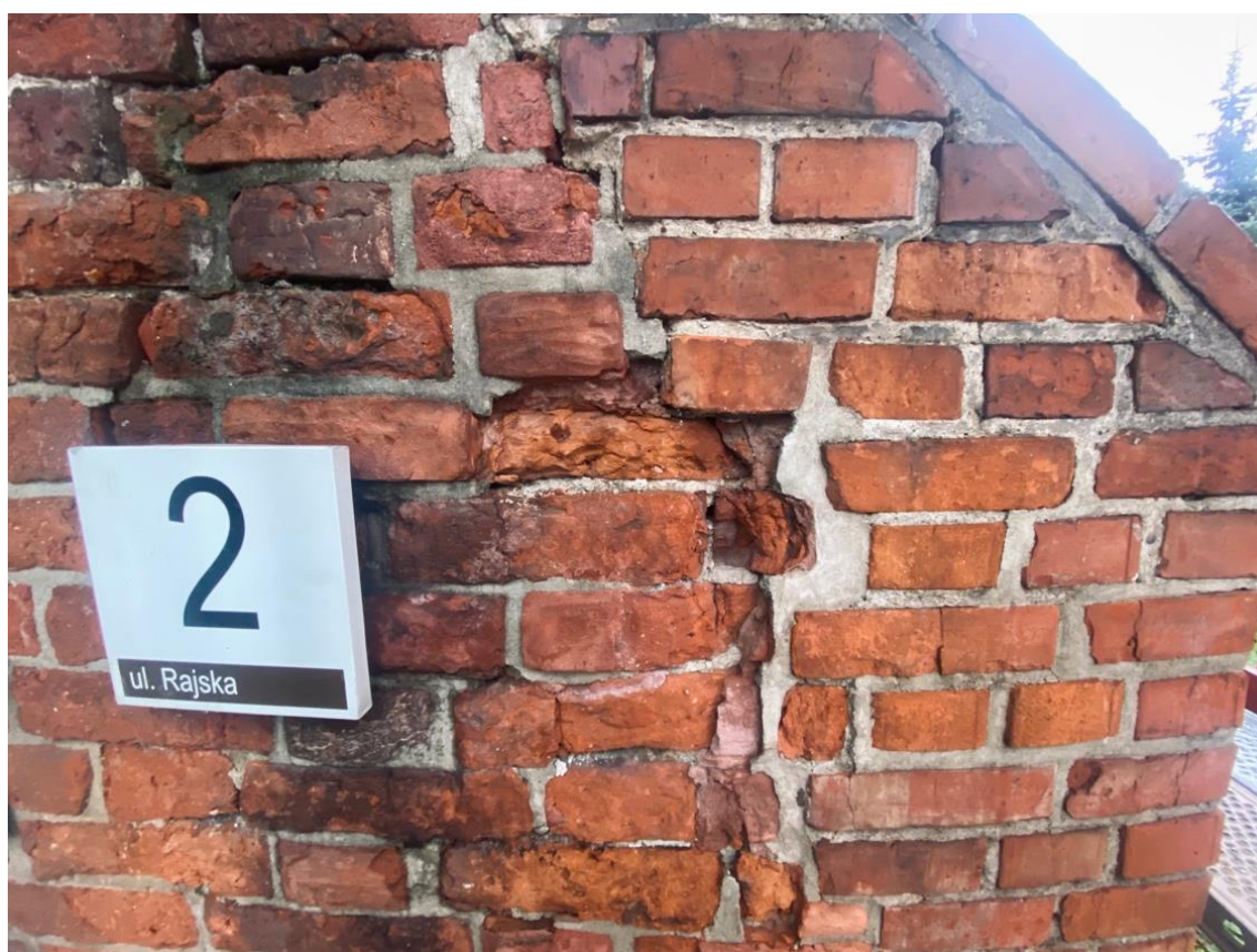
Ilustracja 8 Obiekt przed rozpoczęciem prac konserwatorskich.
