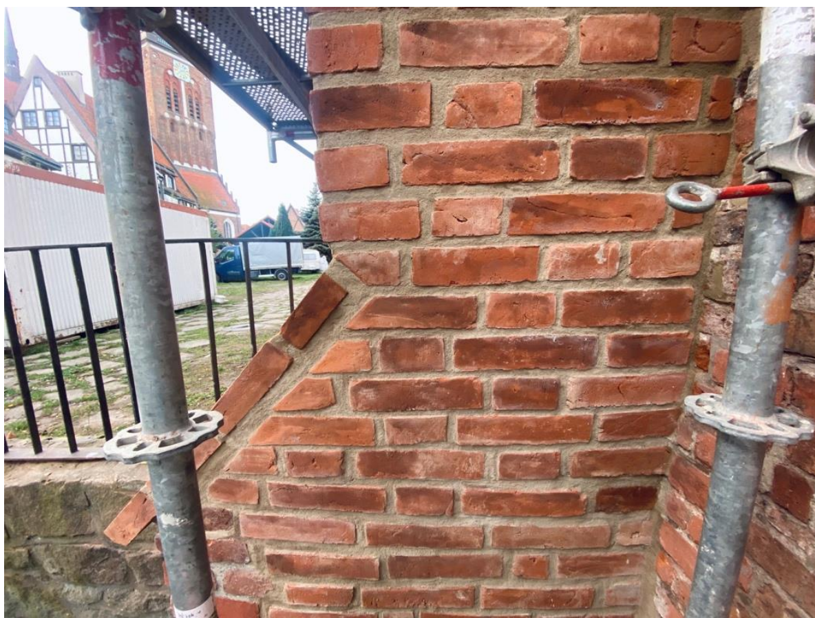
Ilustracja 30 Obiekt po zakończeniu prac konserwatorskich.
