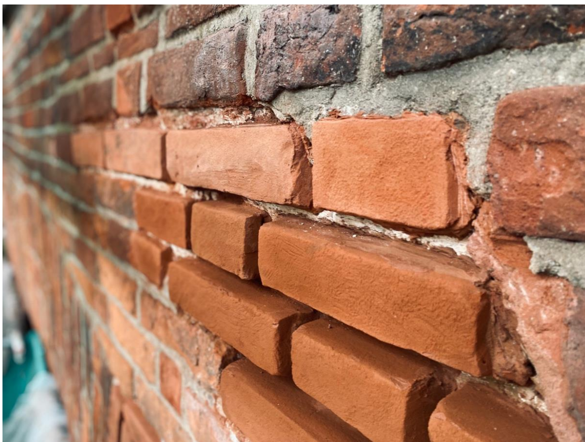
Ilustracja 23 Uzupelnienie ubytków w ceglach zaprawą mineralną.
