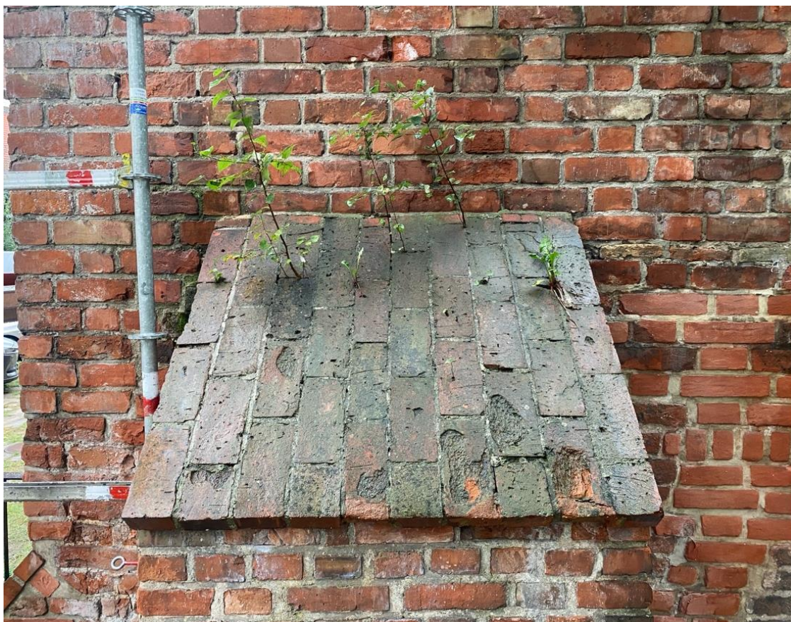
Ilustracja 9 Obiekt przed rozpoczęciem prac konserwatorskich.
