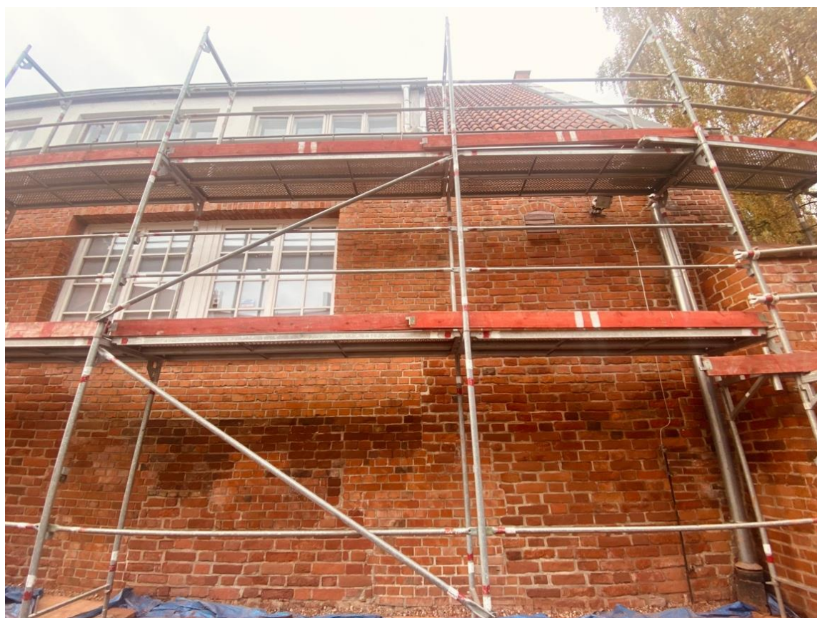
Ilustracja 26 Obiekt po zakończeniu prac konserwatorskich.
