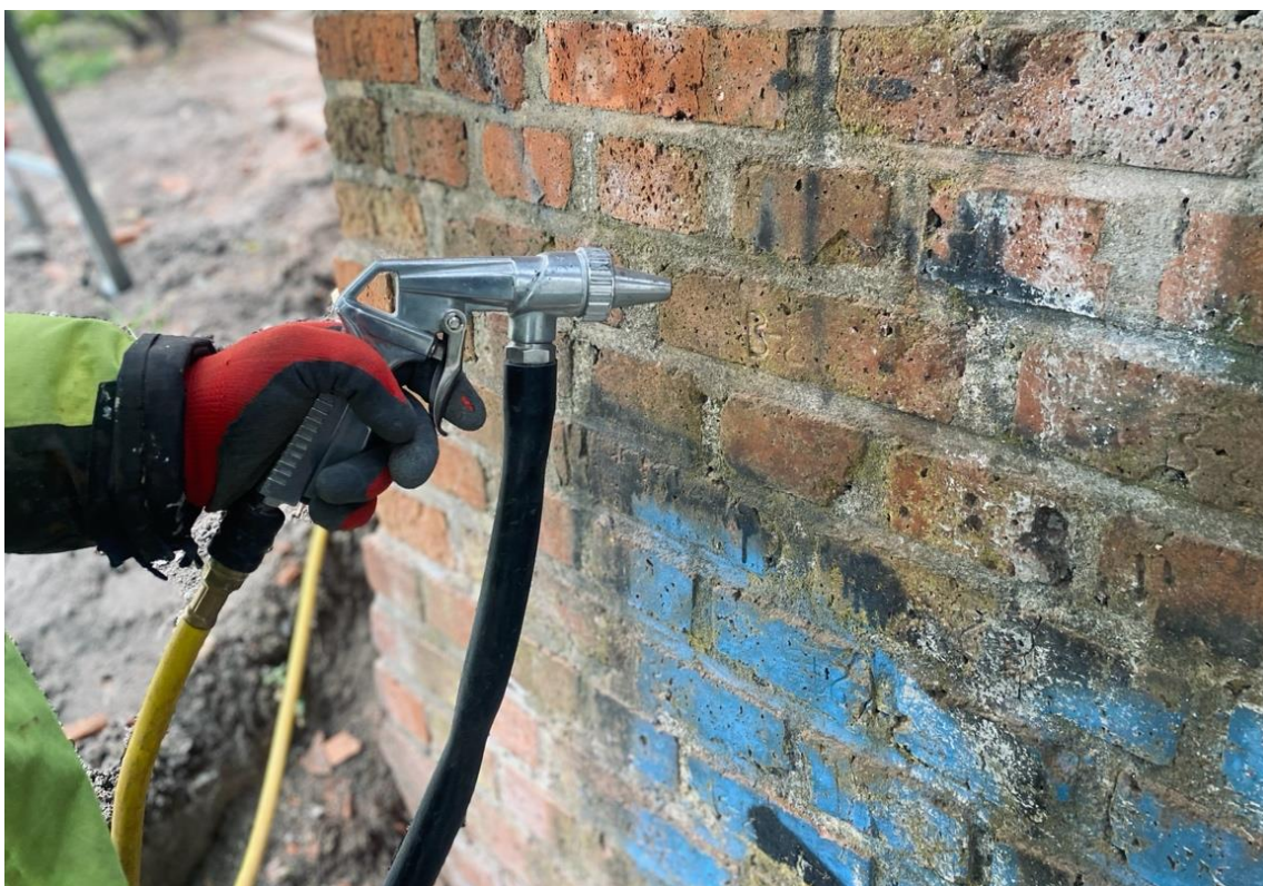
Ilustracja 16 Usuwanie wtórnych nawarstwień (graffiti).
