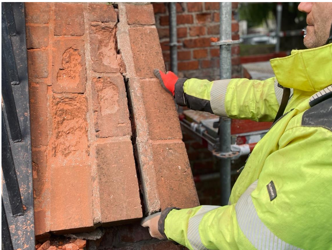
Ilustracja 15 Demontaż luźnych elementów.
