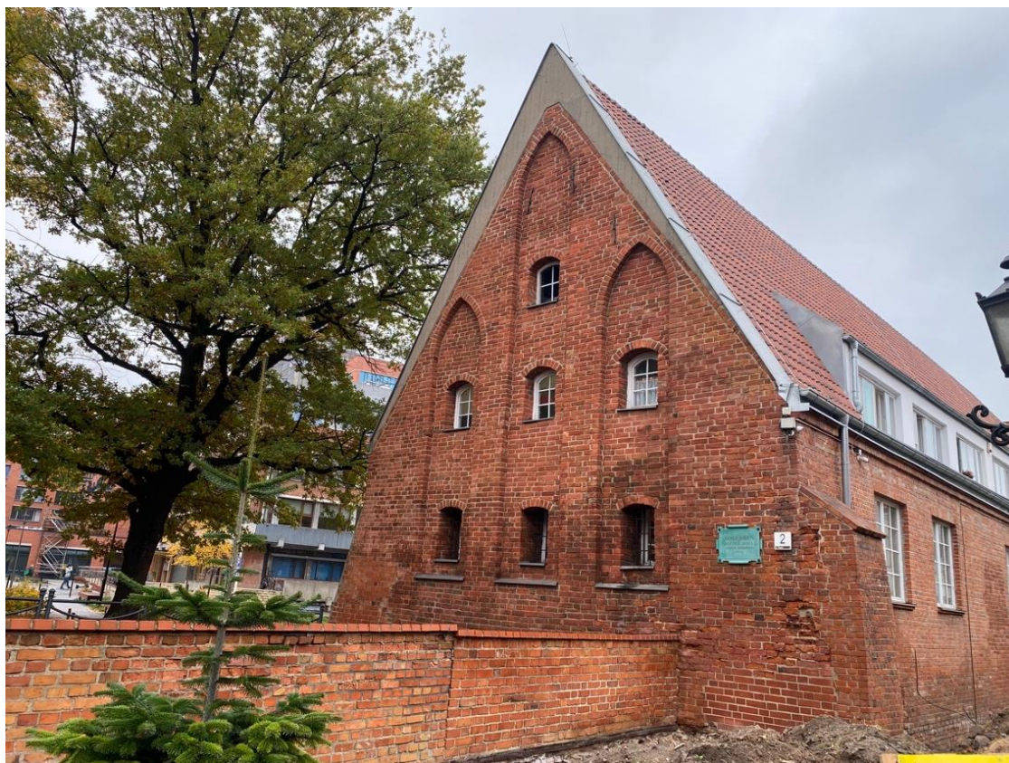
Ilustracja 5 Obiekt przed rozpoczęciem prac konserwatorskich.
