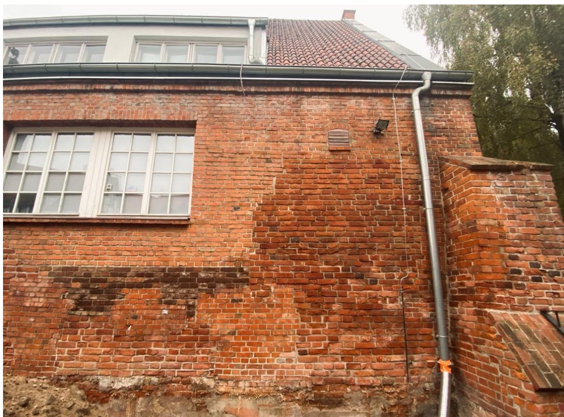
Ilustracja 6 Obiekt przed rozpoczęciem prac konserwatorskich.
