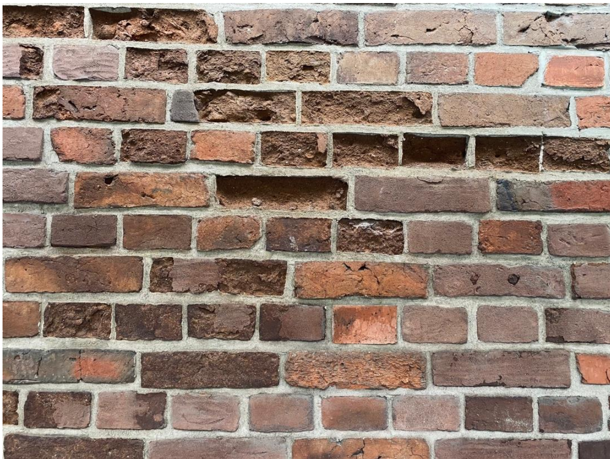
Ilustracja 12 Obiekt przed rozpoczęciem prac konserwatorskich.
