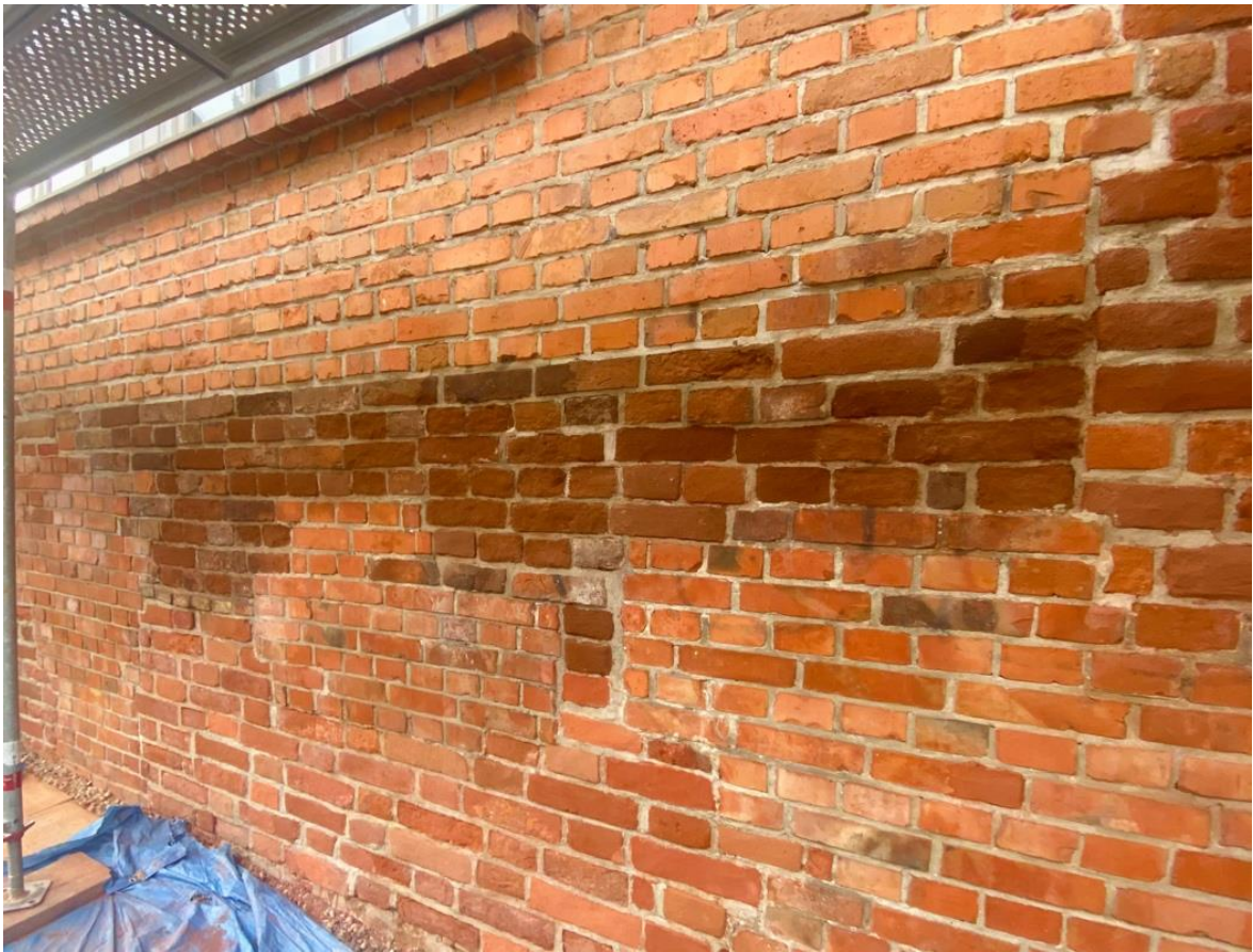
Ilustracja 27 Obiekt po zakończeniu prac konserwatorskich.
