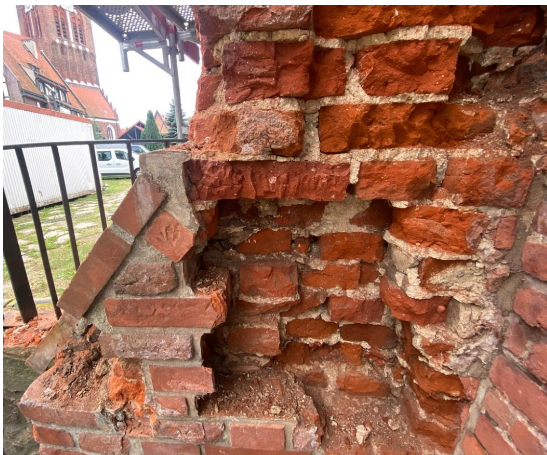
Ilustracja 10 Obiekt przed rozpoczęciem prac konserwatorskich.
