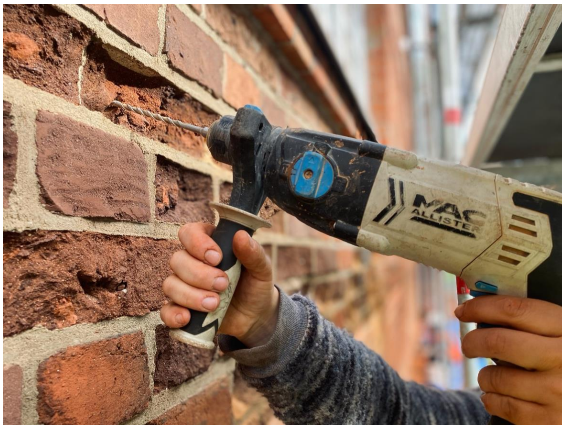
Ilustracja 19 Nawiercanie otworów pod zbrojenia.
