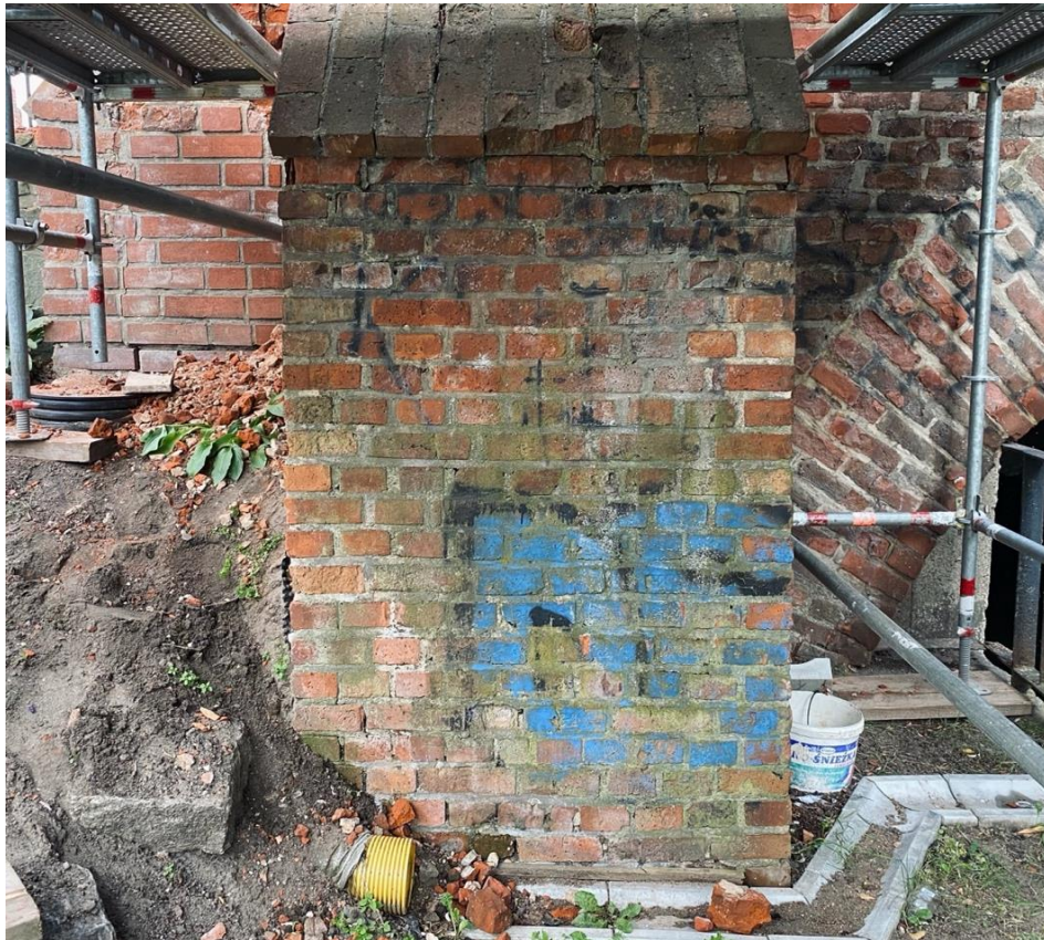
Ilustracja 14 Obiekt przed rozpoczęciem prac konserwatorskich.
