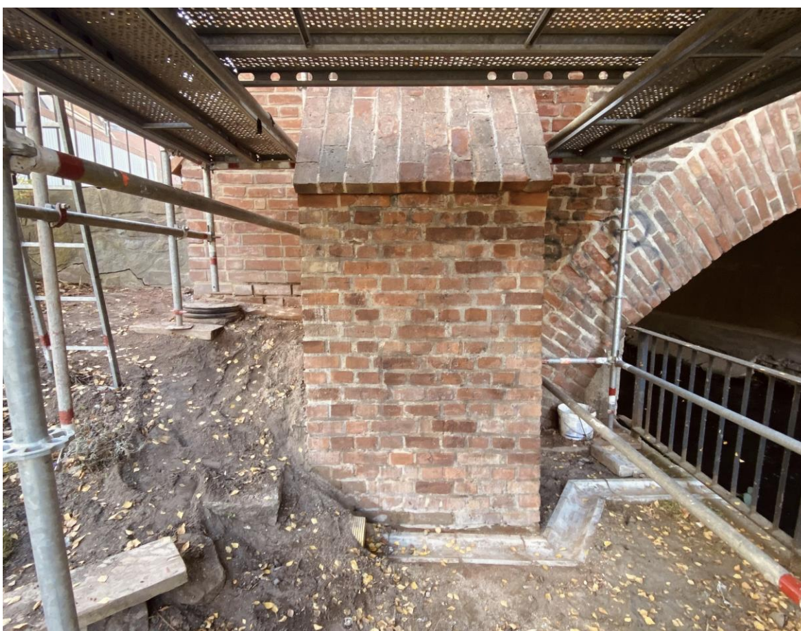
Ilustracja 34 Obiekt po zakończeniu prac konserwatorskich.
