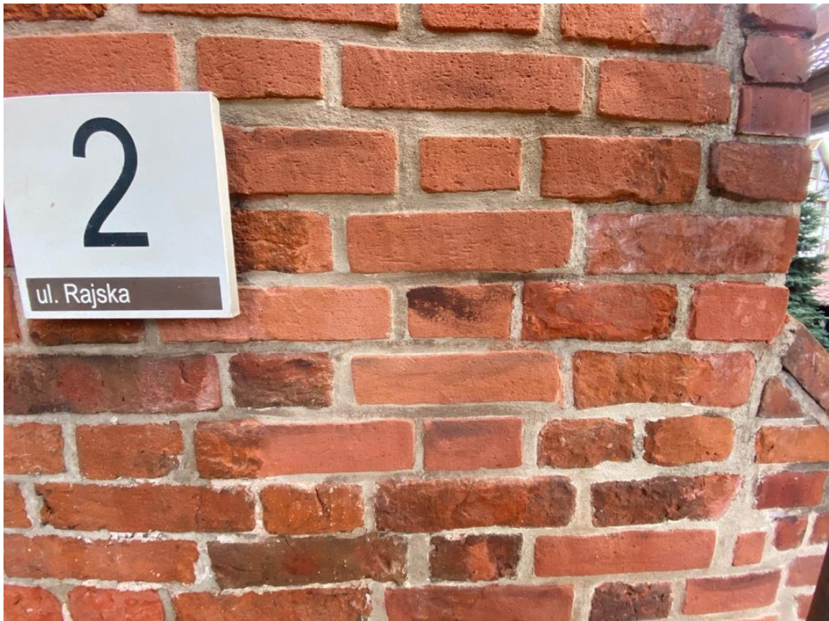
Ilustracja 28 Obiekt po zakończeniu prac konserwatorskich.
