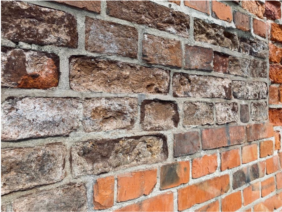
Ilustracja 13 Obiekt przed rozpoczęciem prac konserwatorskich.
