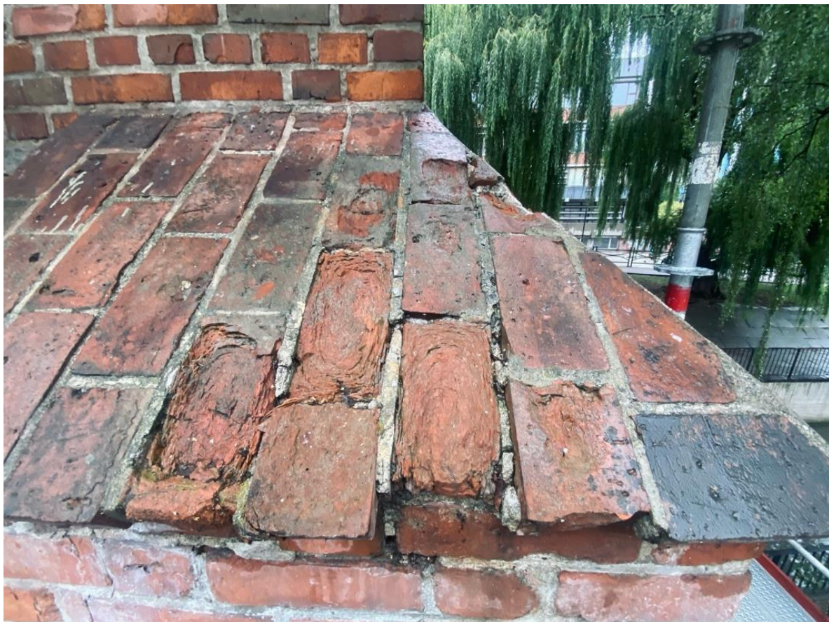
Ilustracja 11 Obiekt przed rozpoczęciem prac konserwatorskich.
