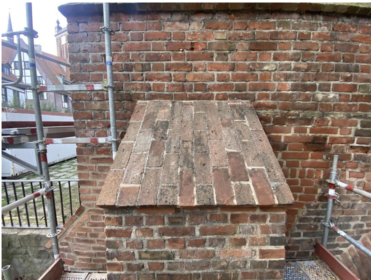
Ilustracja 29 Obiekt po zakończeniu prac konserwatorskich.
