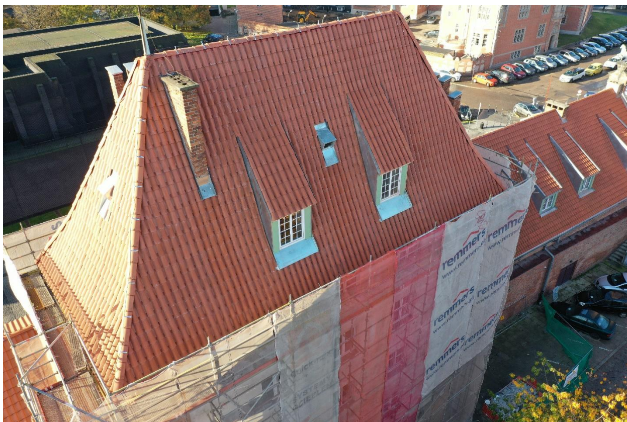
Ilustracja 48. Widok Baszty Schultza od strony północno-wschodniej
