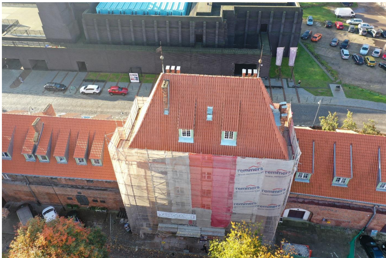
Ilustracja 47. Widok Baszty Schultza od strony północnej.
