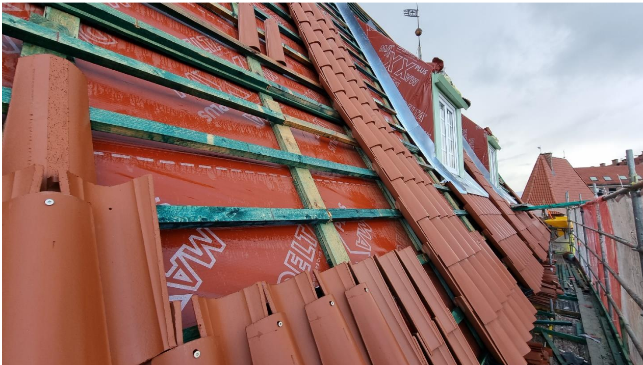
Ilustracja 36. Montaż dachówki.
