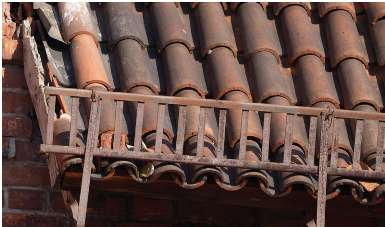
Ilustracja 13. Wysuwające się dachówki.
