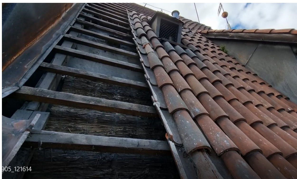
Ilustracja 28 Demontaż dachówki.
