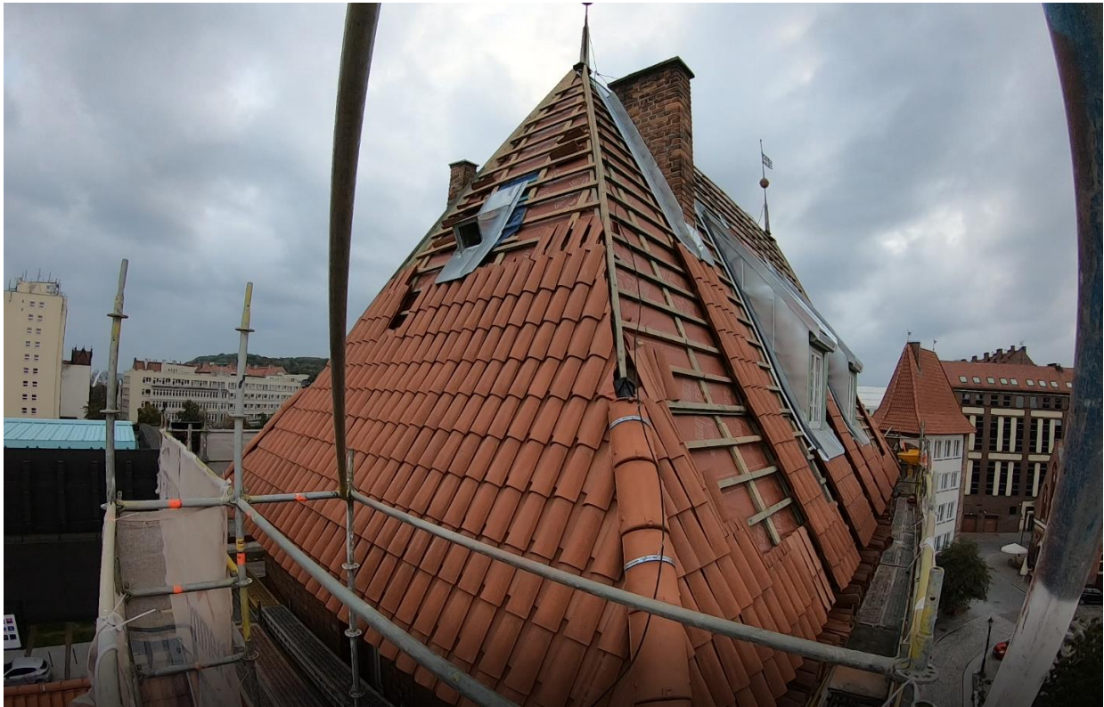
Ilustracja 33. Montaż dachówki.
