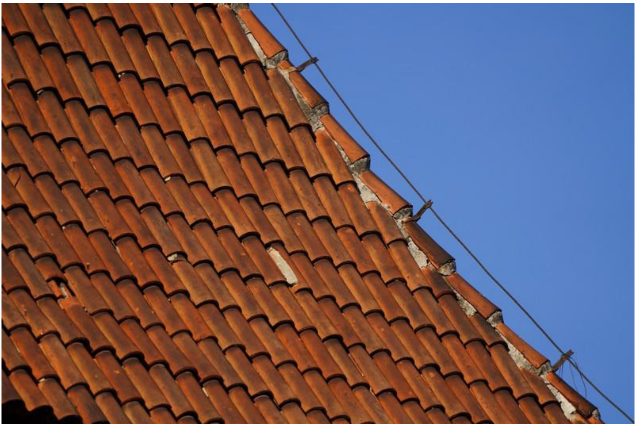
Ilustracja 18. Uszkodzone dachówki
