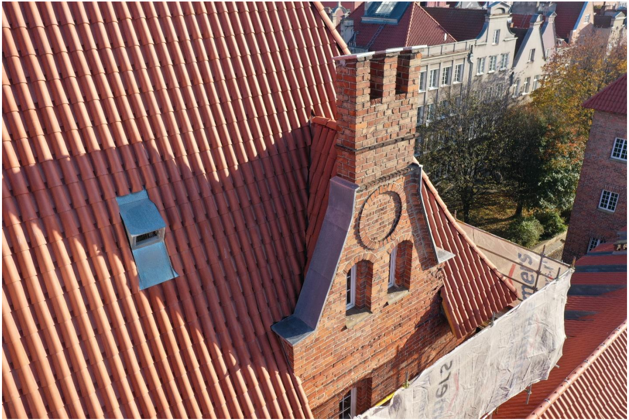
Ilustracja 43. Widok Baszty Schultza od strony południowej.
