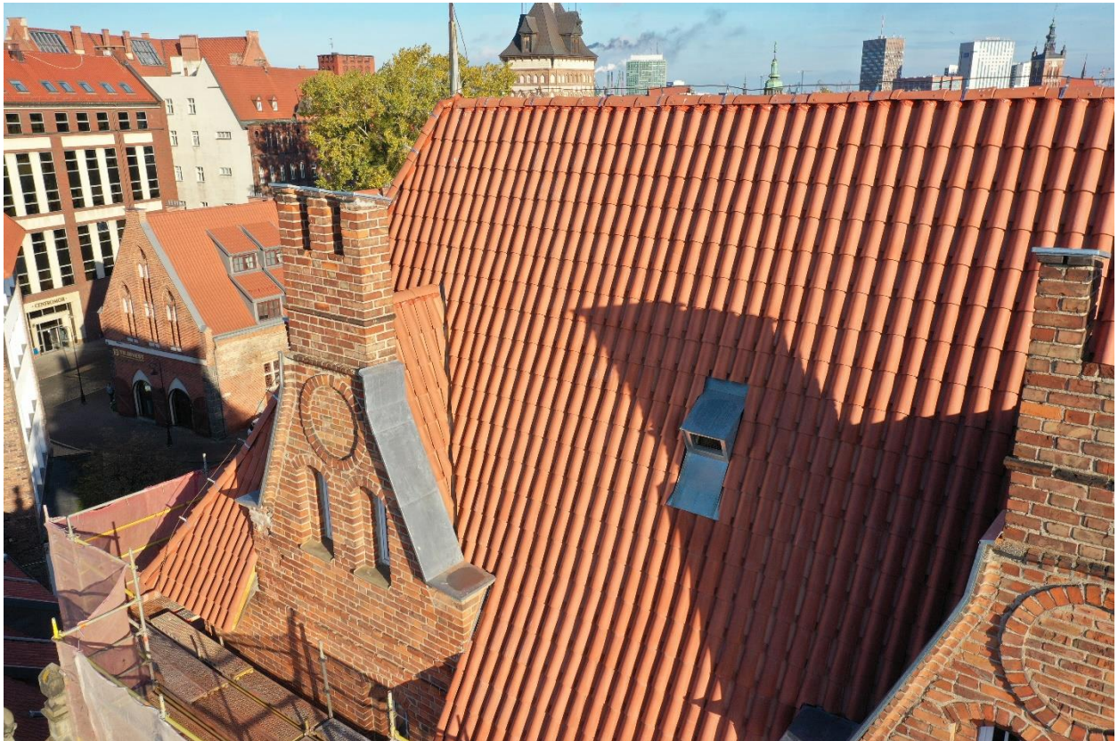
Ilustracja 44. Widok Baszty Schultza od strony południowej.
