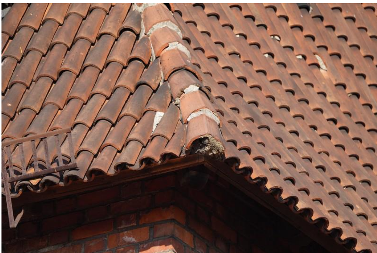
Ilustracja 16. Gąsioy z wykruszającą się zaprawą.
