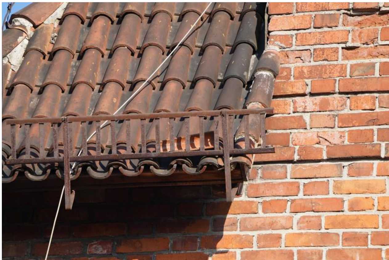
Ilustracja 11. Obluzowana dachówka, która zsunęła się z połaci.
