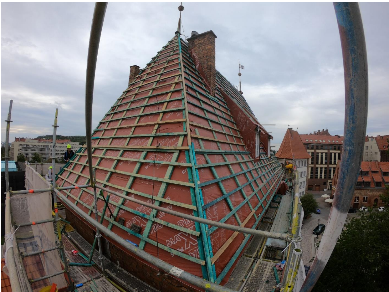
Ilustracja 32. Montaż membrany, kontrłat i łat.
