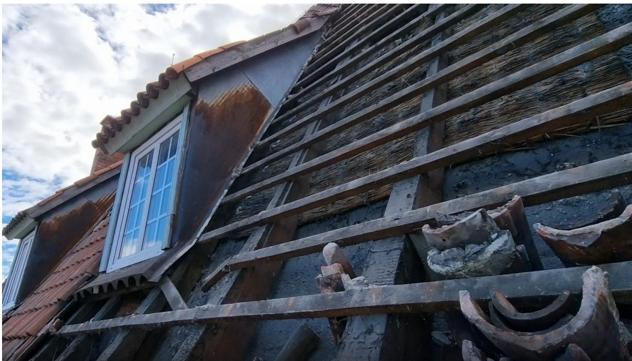
Ilustracja 30. Demontaż dachówki.
