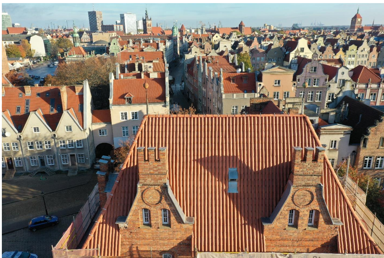
Ilustracja 40. Widok Baszty Schultza od strony południowej.
