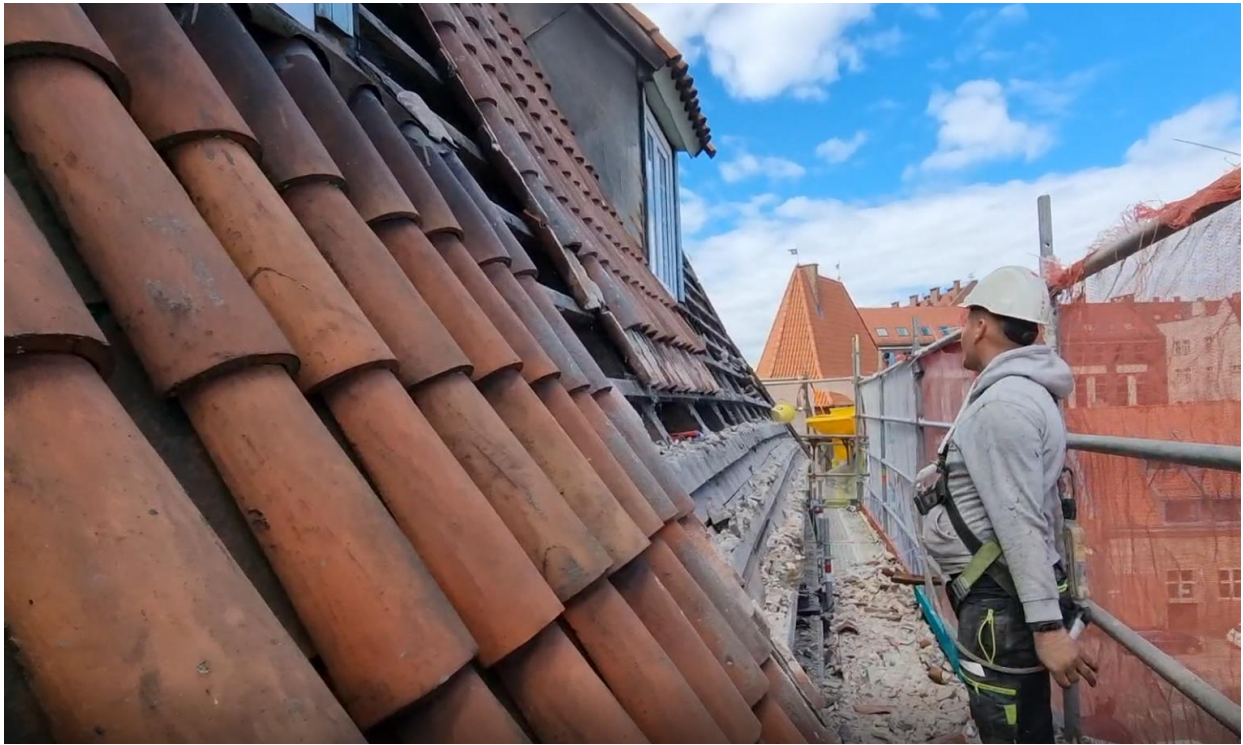
Ilustracja 31. Demontaż dachówki oraz usunięcie gruzu z poddasza.
