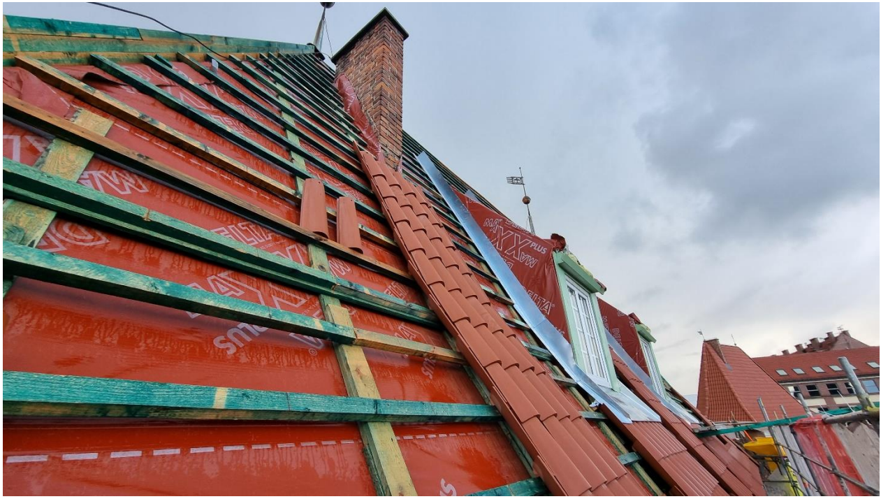
Ilustracja 35. Montaż dachówki.
