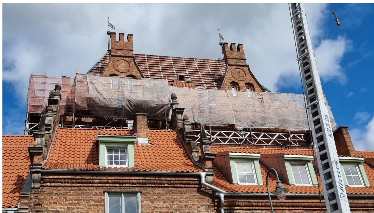
Ilustracja 38. Montaż dachówki.
