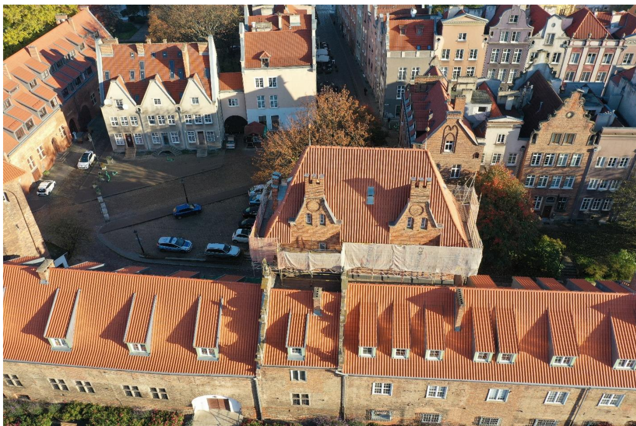
Ilustracja 39. Widok Baszty Schultza od strony południowej.
