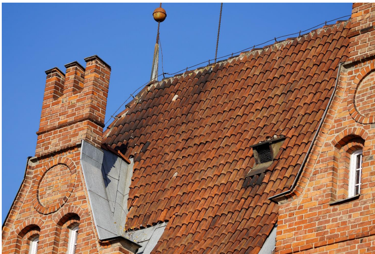
Ilustracja 20. Widok dachu Baszty Schultza od strony południowej.
