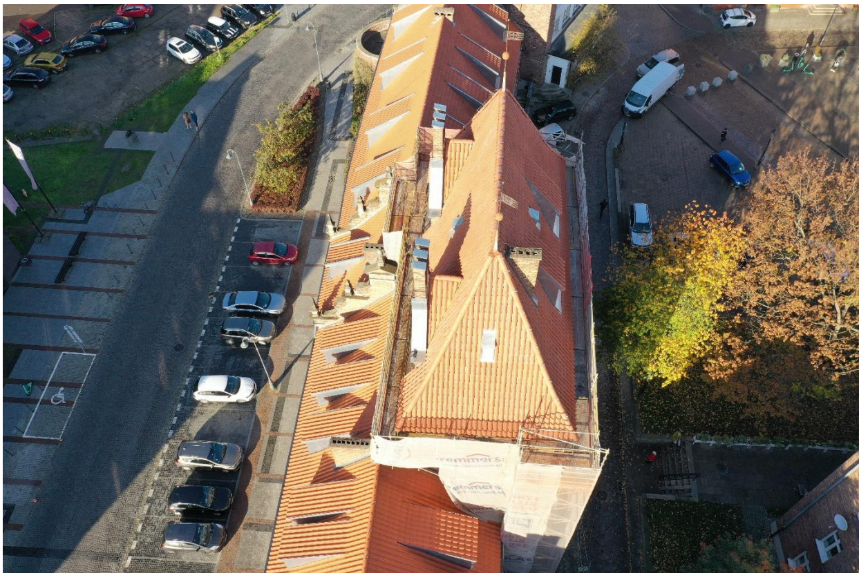
Ilustracja 52. Widok Baszty Schultza od strony wschodniej.
