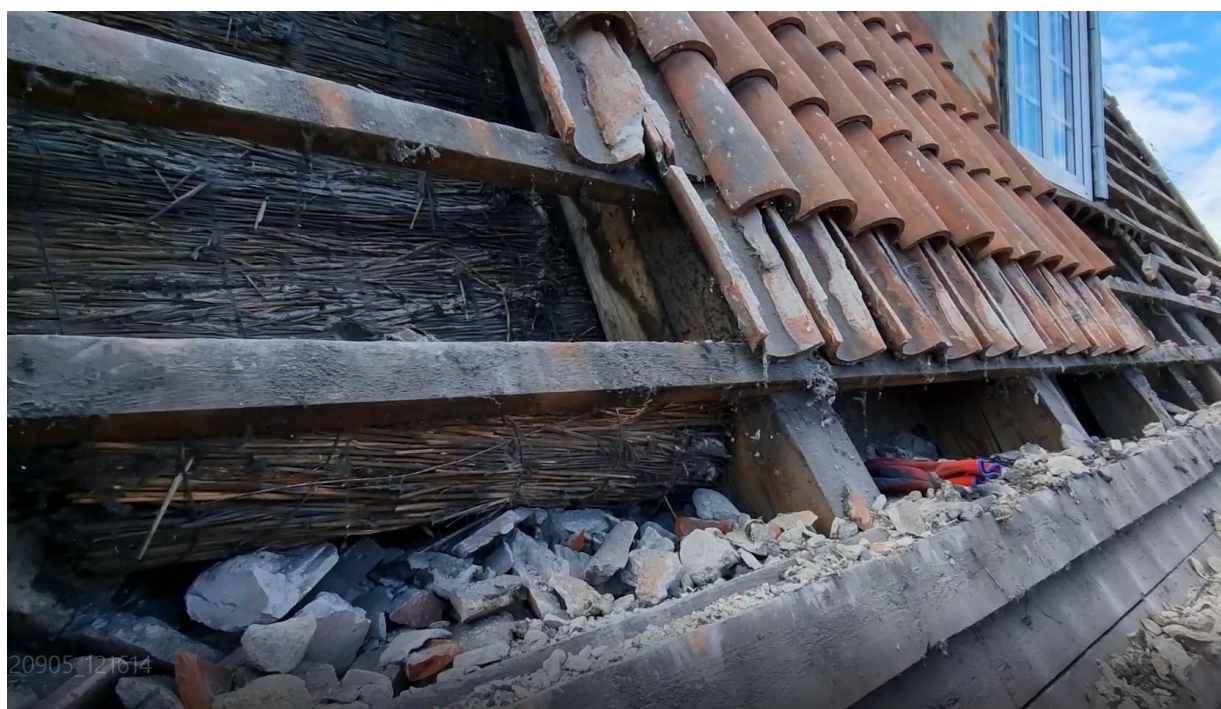
Ilustracja 27. Demontaż dachówki.
