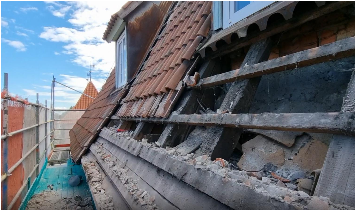
Ilustracja 29. Demontaż dachówki oraz warstwy izolacyjnej.
