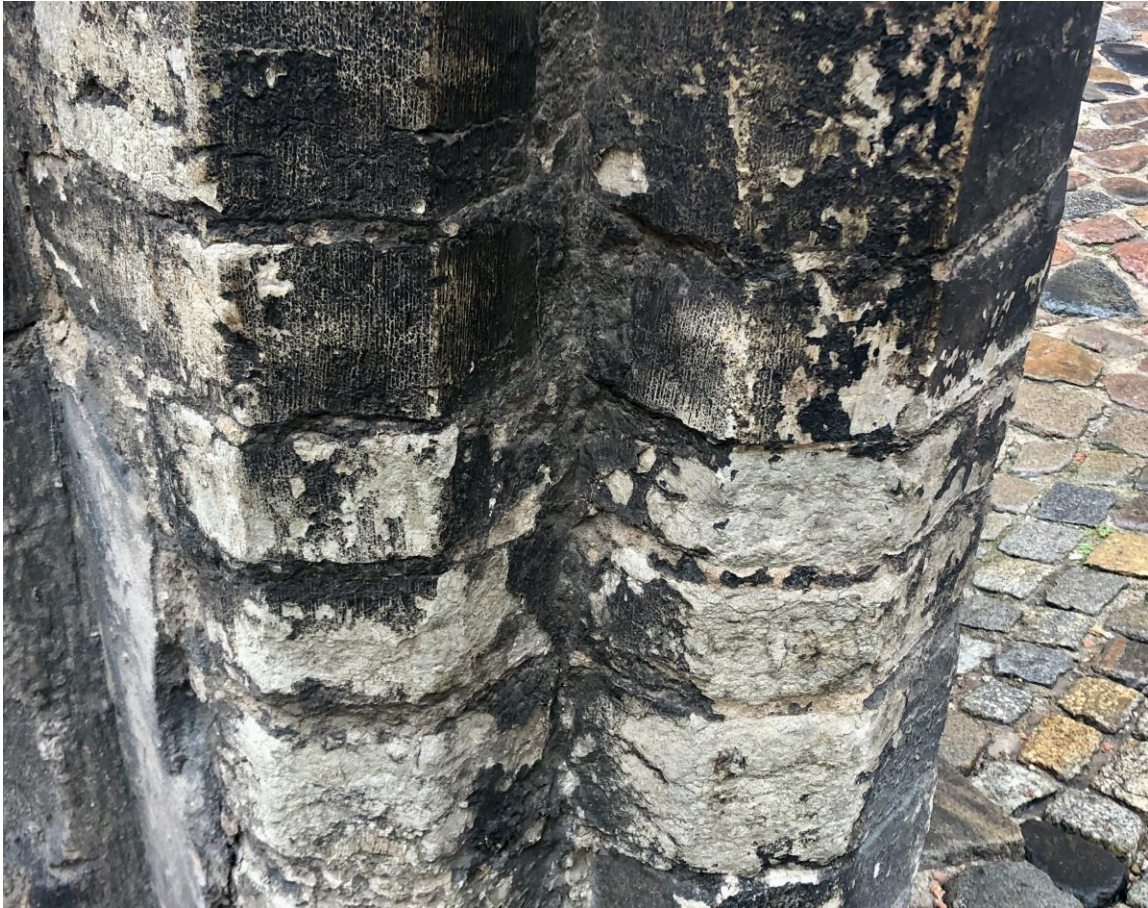
13. Przed konserwacją: filar zachodni od strony południowej - stan zachowania powierzchni elementów z wapienia.
