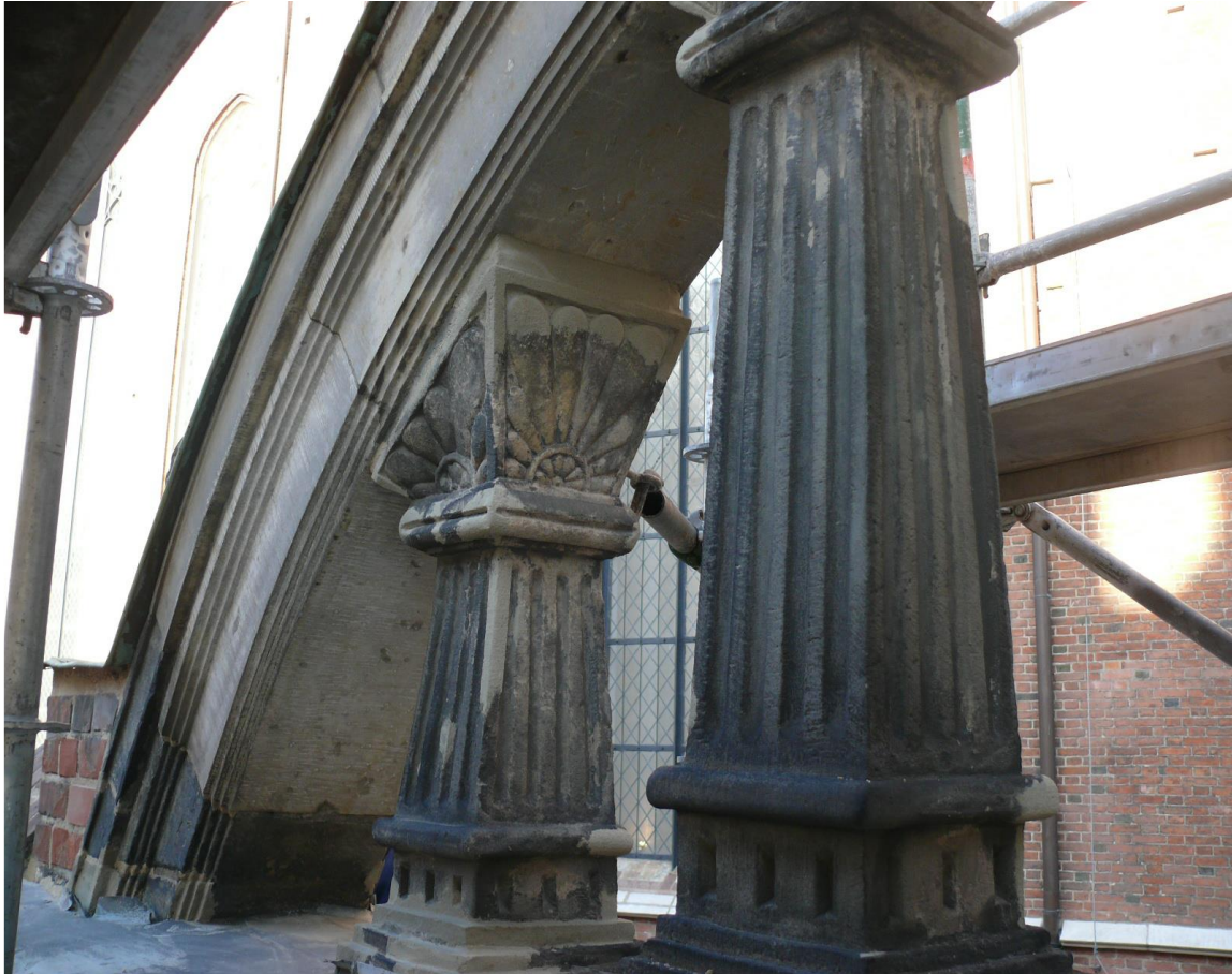
23. Po konserwacji: uzupełnienie ubytków kamienia - tralki w łuku zwieńczenia.
