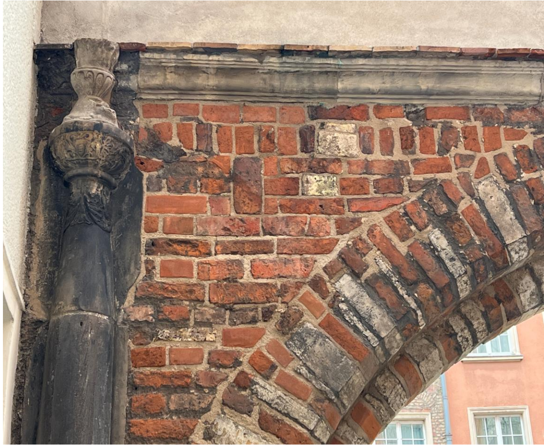
5. Po konserwacji: wschodni narożnik łęku od strony północnej.
