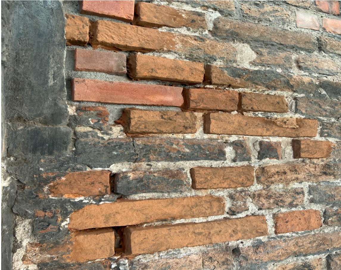
16. W trakcie konserwacji : naprawa wążku zachodniej części bramy od strony północnej.
