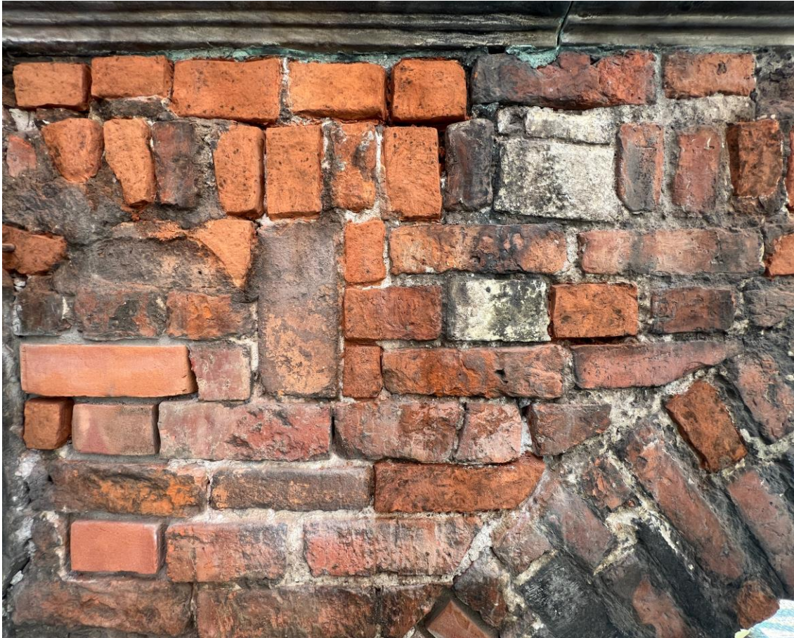
15.W trakcie konserwacji: uzupełnianie ubytków cegieł kitem mineralnym - strona północna, wschodnia część łęku.
