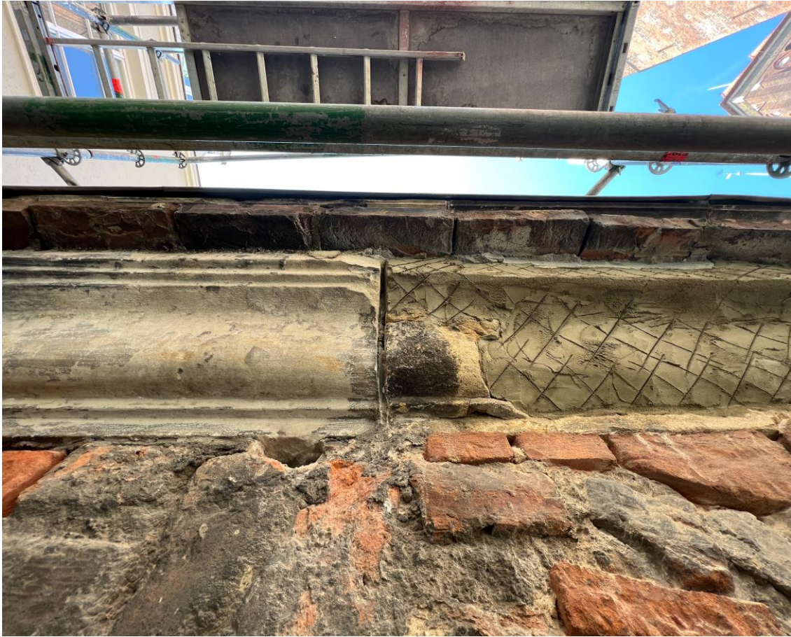
17.W trakcie konserwacji: uzupełnianie ubytków elementów kamiennych kitem mineralnym.
