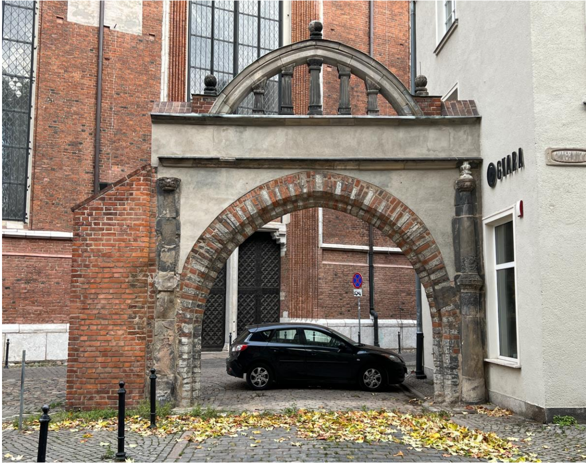
2. Po konserwacji: widok ogólny od strony południowej.
