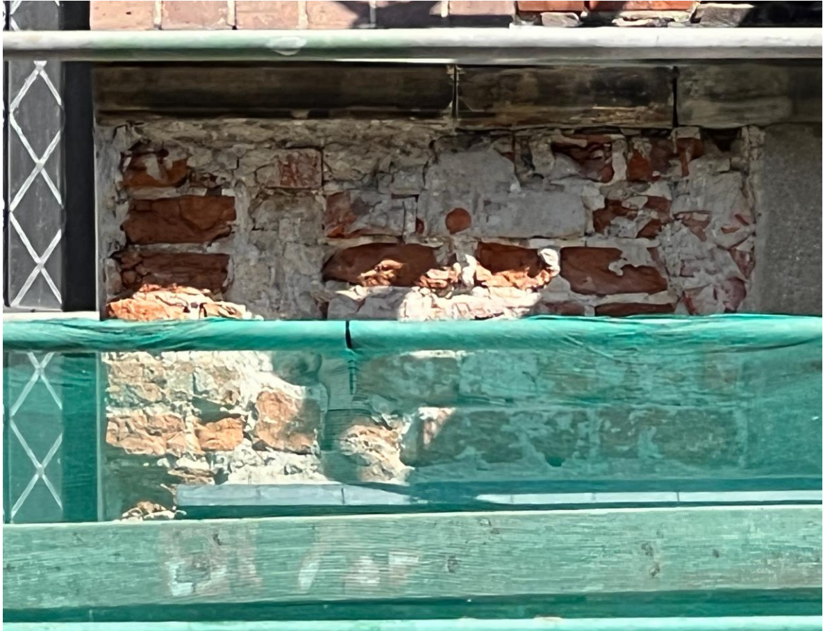
19. W trakcie konserwacji: Odkrywka we fryzie pod strony południowej - widoczna destrukcja wątku.
