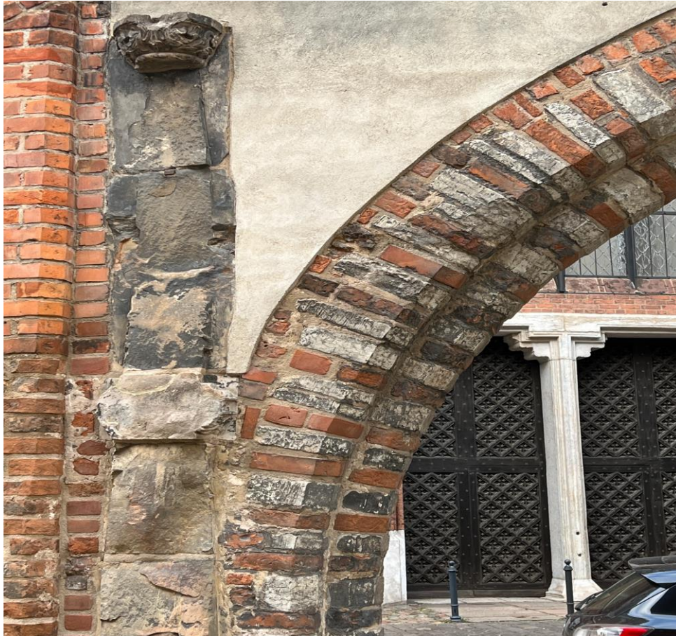
12. Po konserwacji: zachodnia część łuku od strony południowej.
