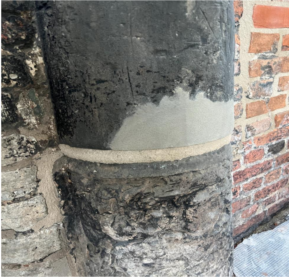
27. W trakcie konserwacji: laserunki przyciemniające uzupełnienia ubytków.
