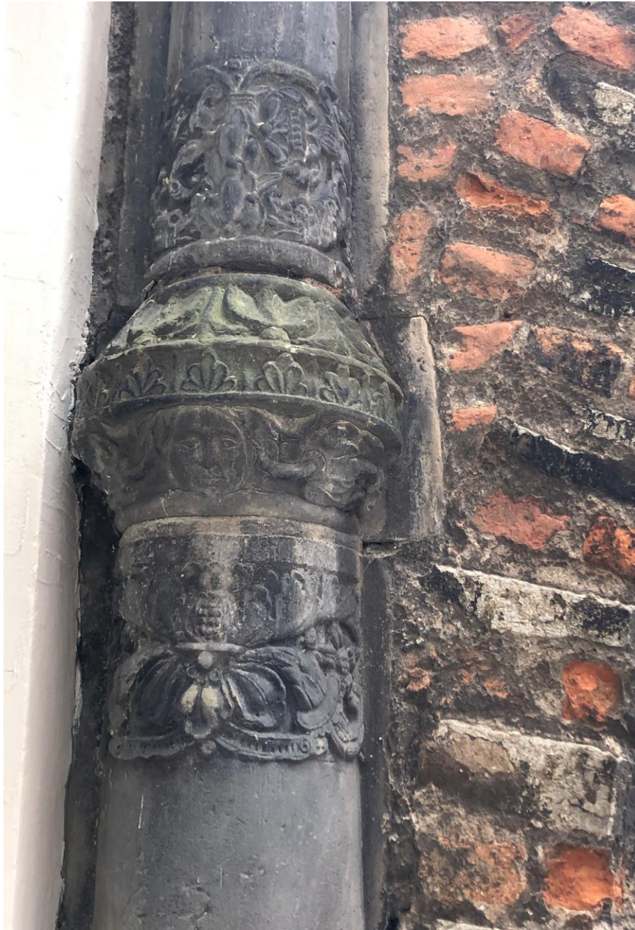
4. Detal rzeźbiarski z widocznymi zanieczyszczeniami powierzchni i porażeniem glonami.
