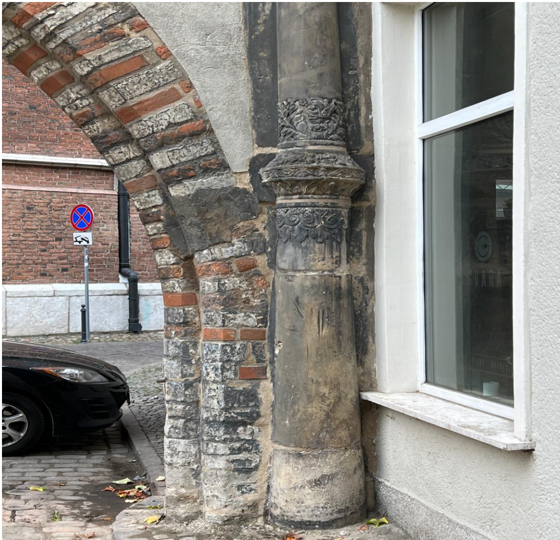
11. Po konserwacji: filar wschodni od strony południowej.
