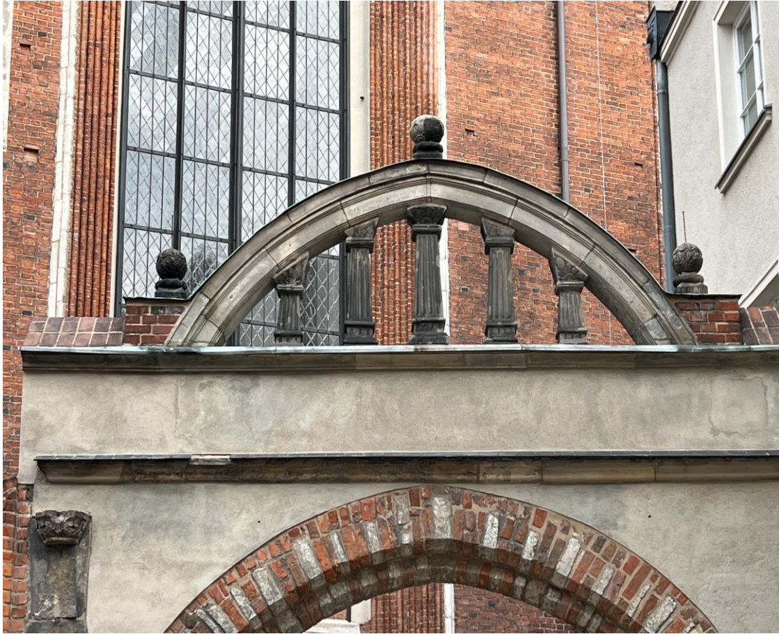
4. Po konserwacji: zwieńczenie bramy od strony południowej.
