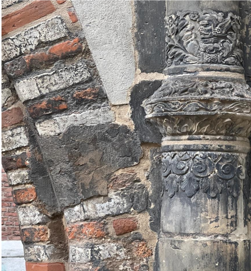
13. Po konserwacji: wschodni filar od strony południowej - relikty tynków historycznych i detal rzeźbiarski.
