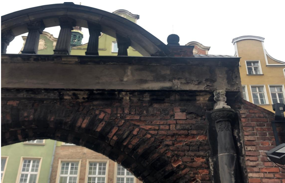
1. Fragment narożnika północno-zachodniego bramy.
