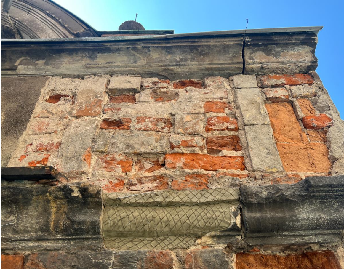
18. W trakcie konserwacji: fryz po stronie północnej - odkrywka tynku ujawniająca stan zachowania wątku.
