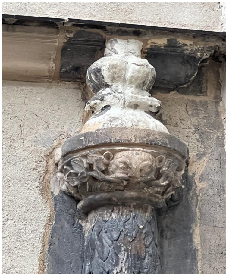
14. Po konserwacji: zwieńczenie wschodniej półkolumny od strony południowej - detal rzeźbiarski głowicy i gazon z wapienia po wzmocnieniu i zabezpieczeniu.
