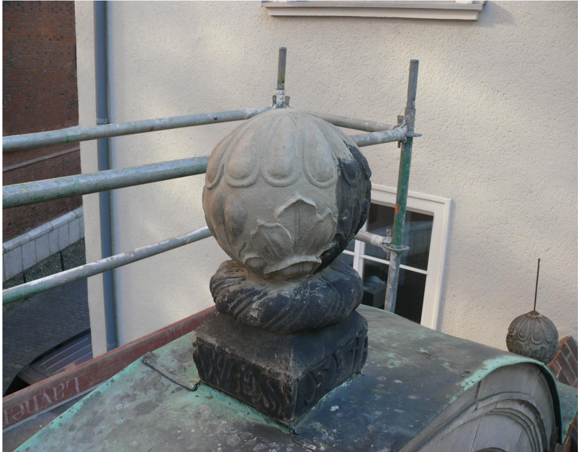
21. Po konserwacji: detal wieńczący - uzupełnienie ubytku kitem mineralnym.
