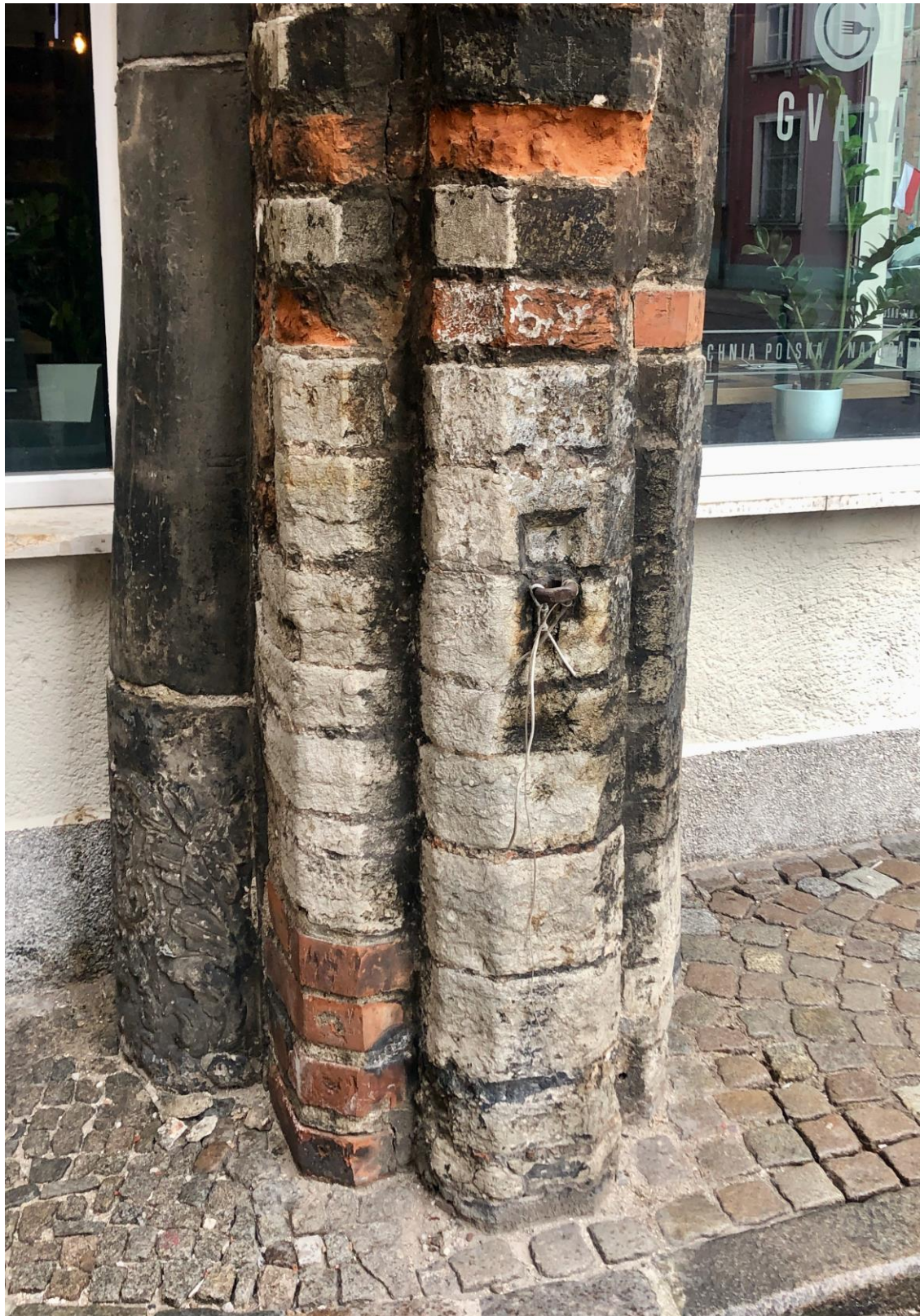
6. Przed konserwacją: filar wschodni, elementy z wapienia.
