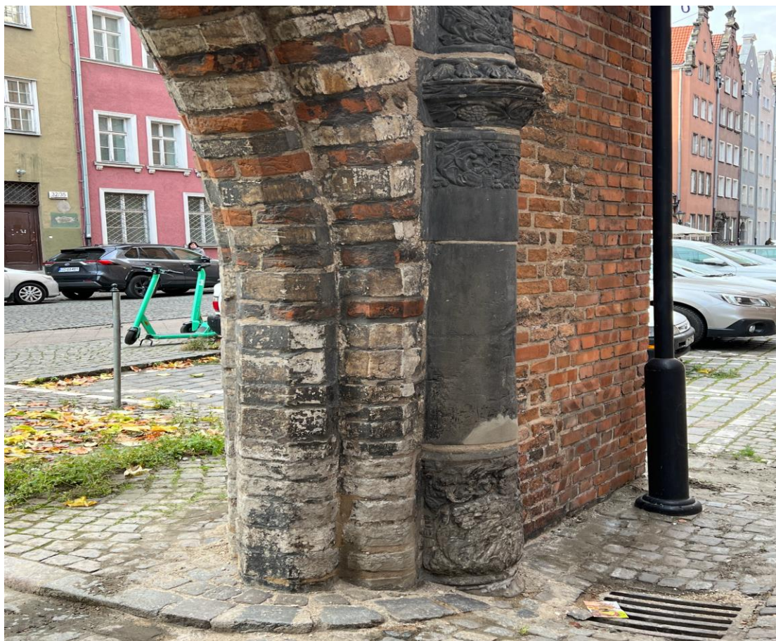
10. Po konserwacji: filar zachodni od strony północnej.
