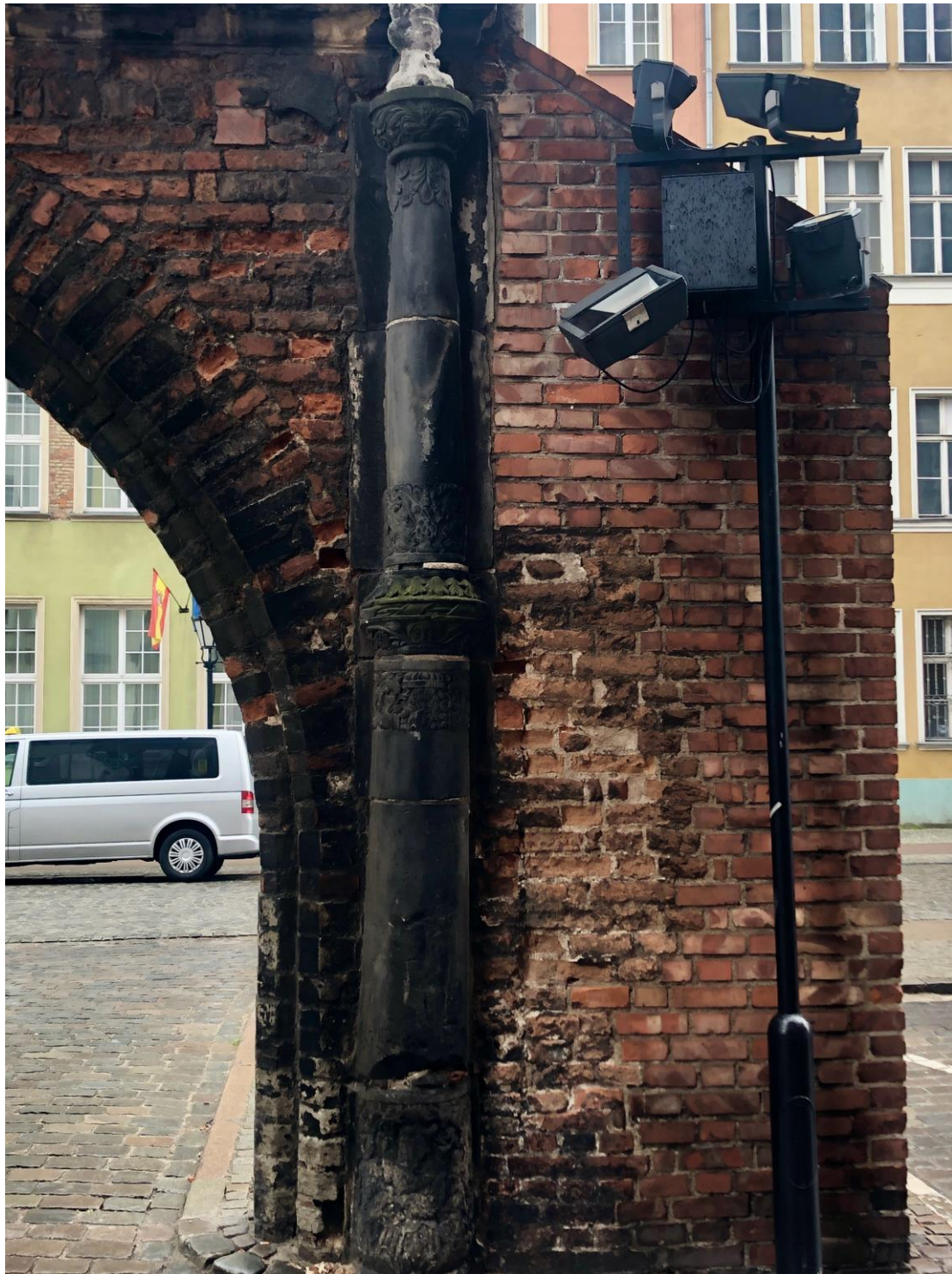
4. Przed konserwacją: zachodni filar bramy od strony północnej.
