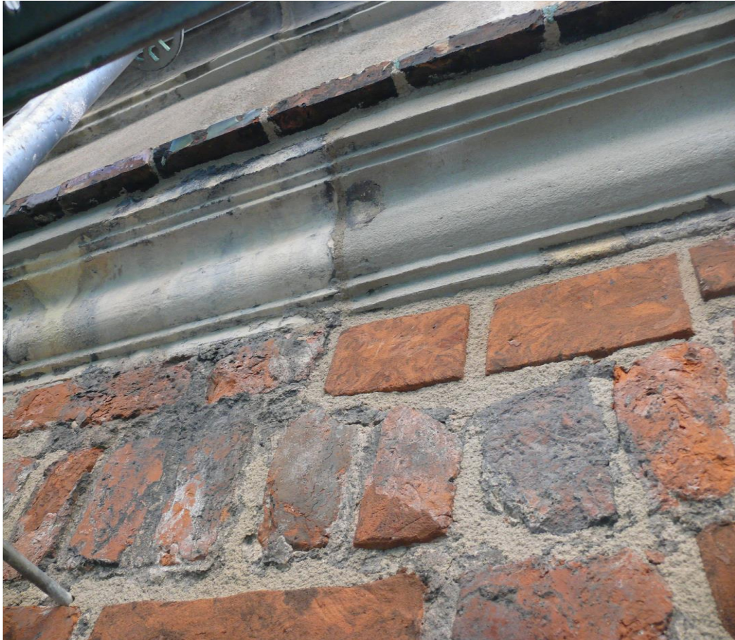
25. W trakcie konserwacji: uzupełnianie ubytków spoin.
