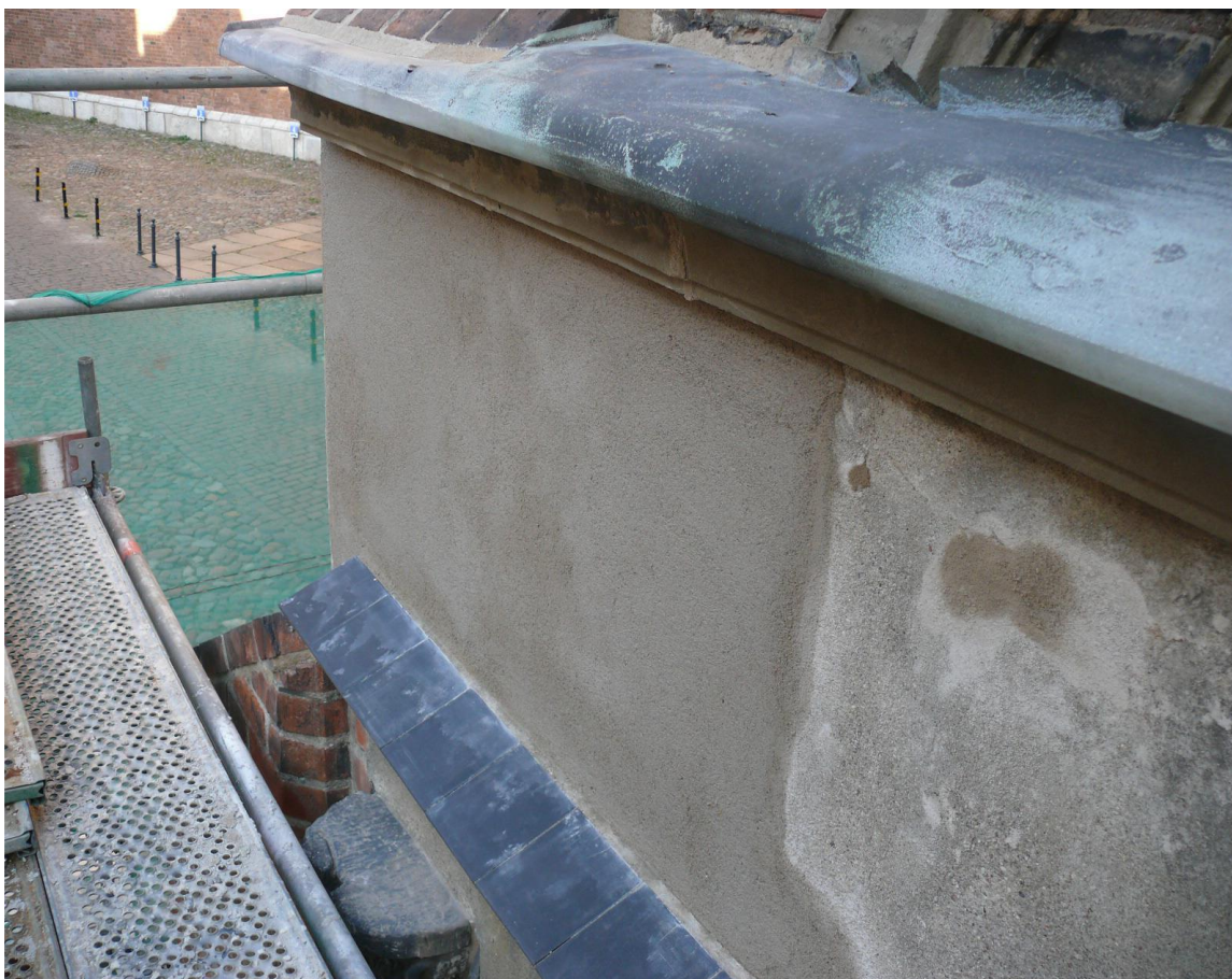
24. W trakcie konserwacji - naprawa tynków.
