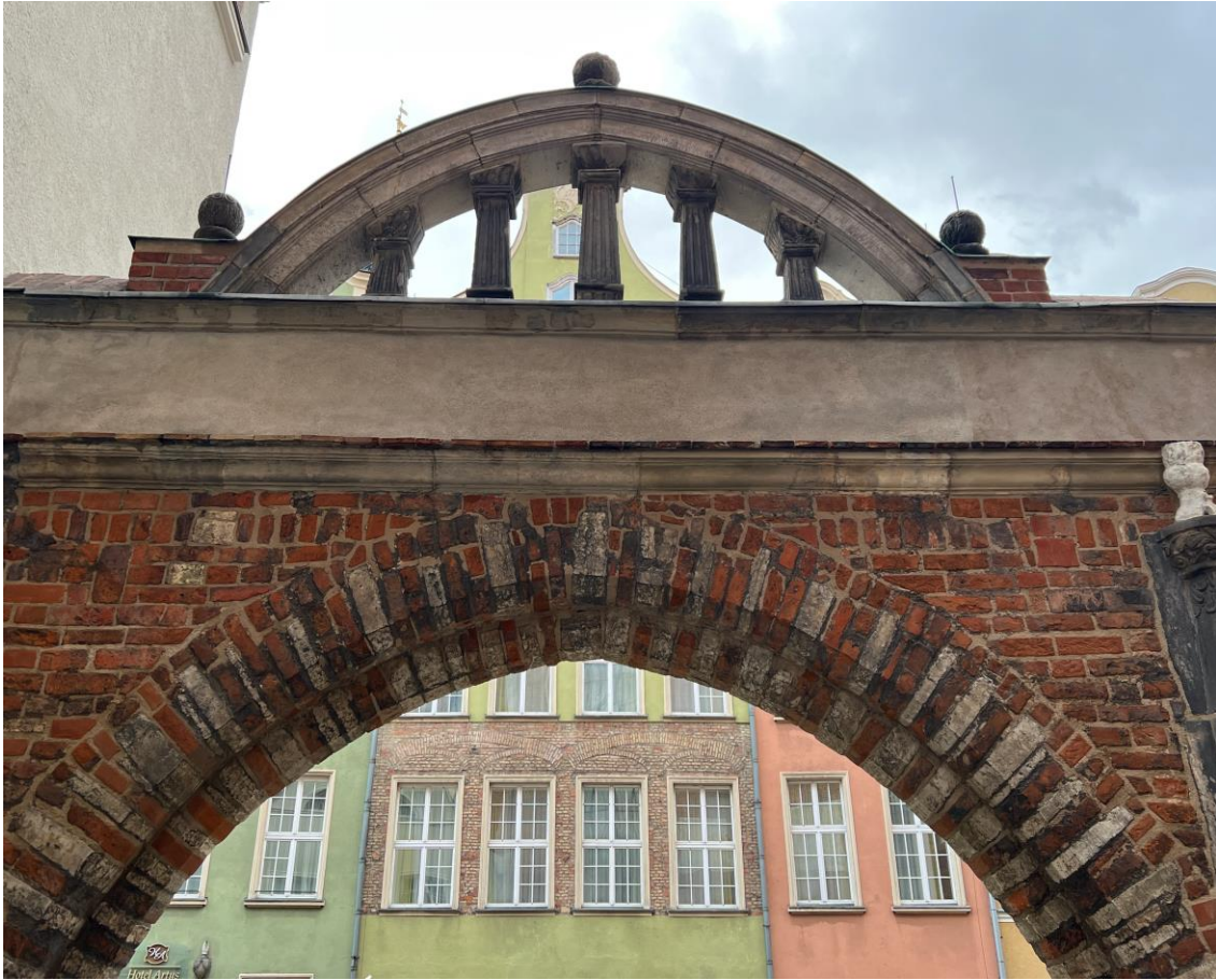
3. Po konserwacji: zwieńczenie bramy od strony północnej.
