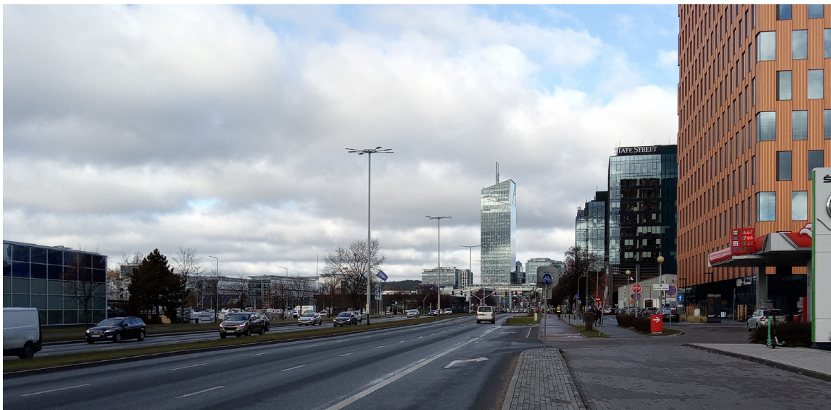
Fot. 13. Nowa Oliwa – w obu perspektywach widoczna dominanta wysokościowa Olivia Star. Ściana centrum biurowego tworzy pierzeję, ale odsuniętą od alei Grunwaldzkiej i oddzieloną od niej wjazdami do garaży, parkingami i wewnętrznymi drogami dojazdowymi. Po przeciwnej stronie brak pierzei i czytelnych zamknięć wnętrz. Fot. BRG
