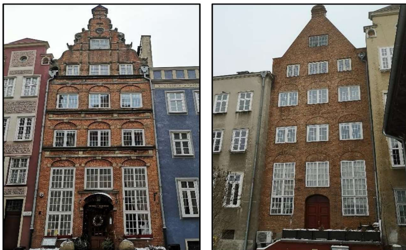
Wspólnota Mieszkaniowa Ogarna 11/12 Gdańsk - kamienica przy ul. Ogarnej11 Prace konserwatorskie elewacji frontowej i tylnej
