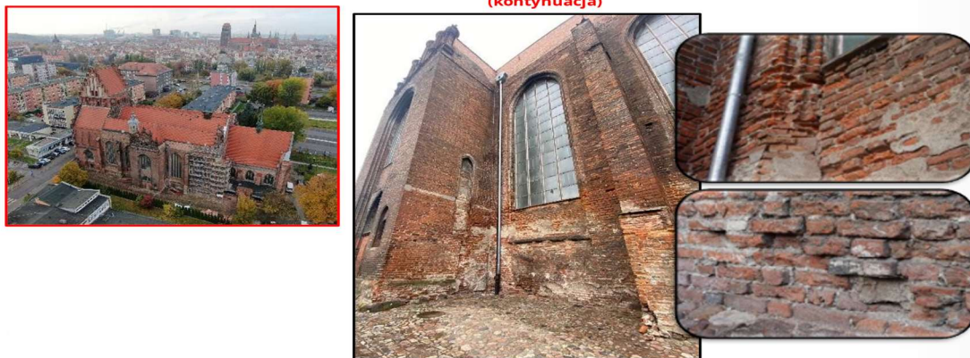
Parafia Rzymskokatolicka pw. św. Apostołów Piotra i Pawła Kościół pw. Św. Apostołów Piotra i Pawła Prace konserwatorskie elewacji kościoła- etap III - nawa południowa, przeszło drugie liczone od strony wschodniej oraz wschodnia ściana transeptu (kontynuacja)
