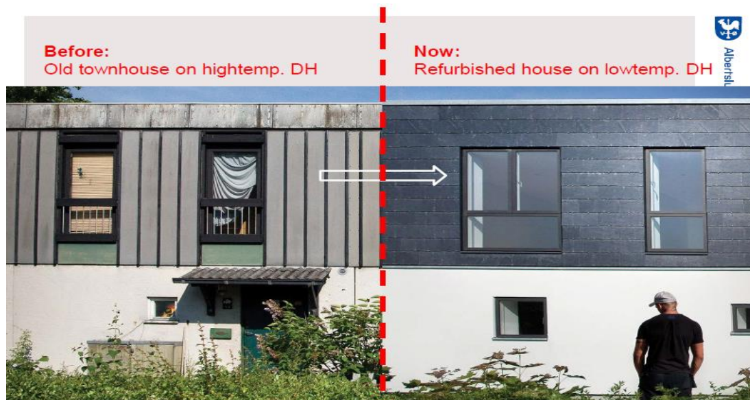
Rys. 1. Fasada budynku przed i po modernizacji.[2]
