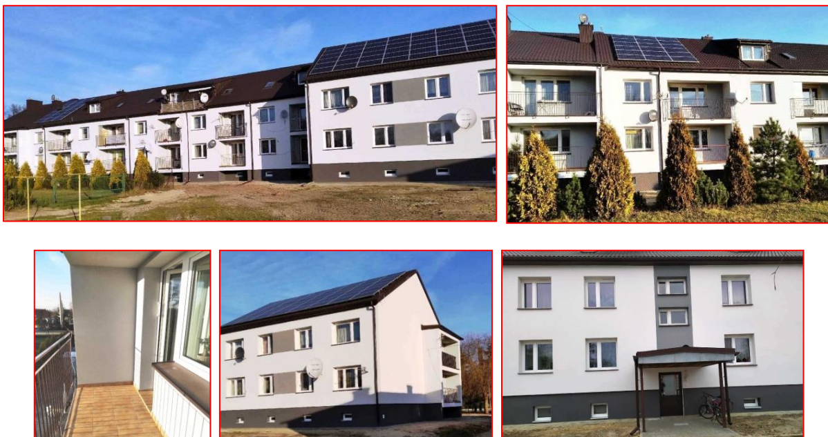
Rys. 5. Budynki po modernizacji. Źródło: T. Żurek – IMP PAN Gdańsk
