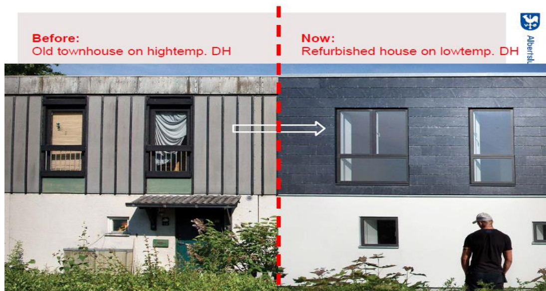
Rys. 2. Fasada budynku przed i po modernizacji. Źródło: Christian Oxenvad, Albertslund Municipality and District Heating Plant
