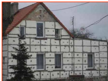
Fot. 11÷12 Przykłady nieprofesjonalnego wykonawstwa docieplenia
