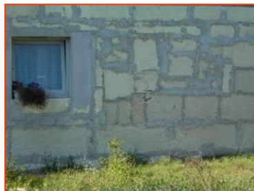
Fot. 11÷12 Przykłady nieprofesjonalnego wykonawstwa docieplenia
