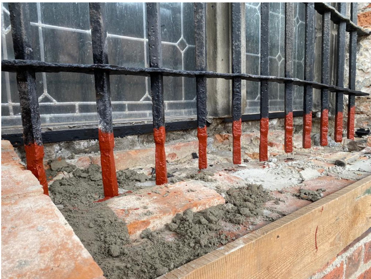
Fot. 13. Zabezpieczenie antykorozyjne metalowych krat po usunięciu wtórnego cementowego parapetu (fot. W. Domagała).
