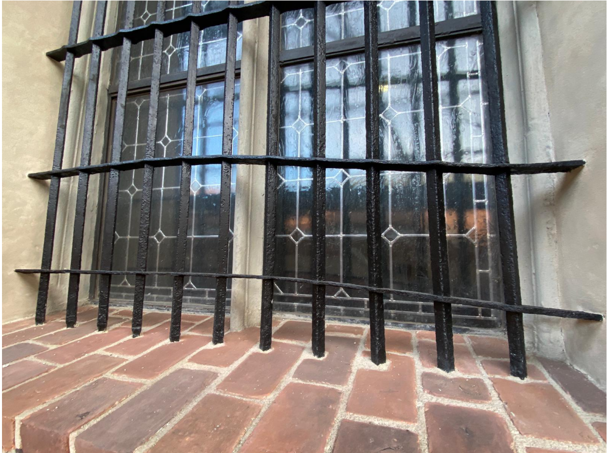
Fot. 24. Wykonano konserwację i restaurację metalowych krat. Tynki w gładzi zabezpieczono, wykonano uzupełnienie ubytków i scalanie kolorystyczne (fot. W. Domagała).
