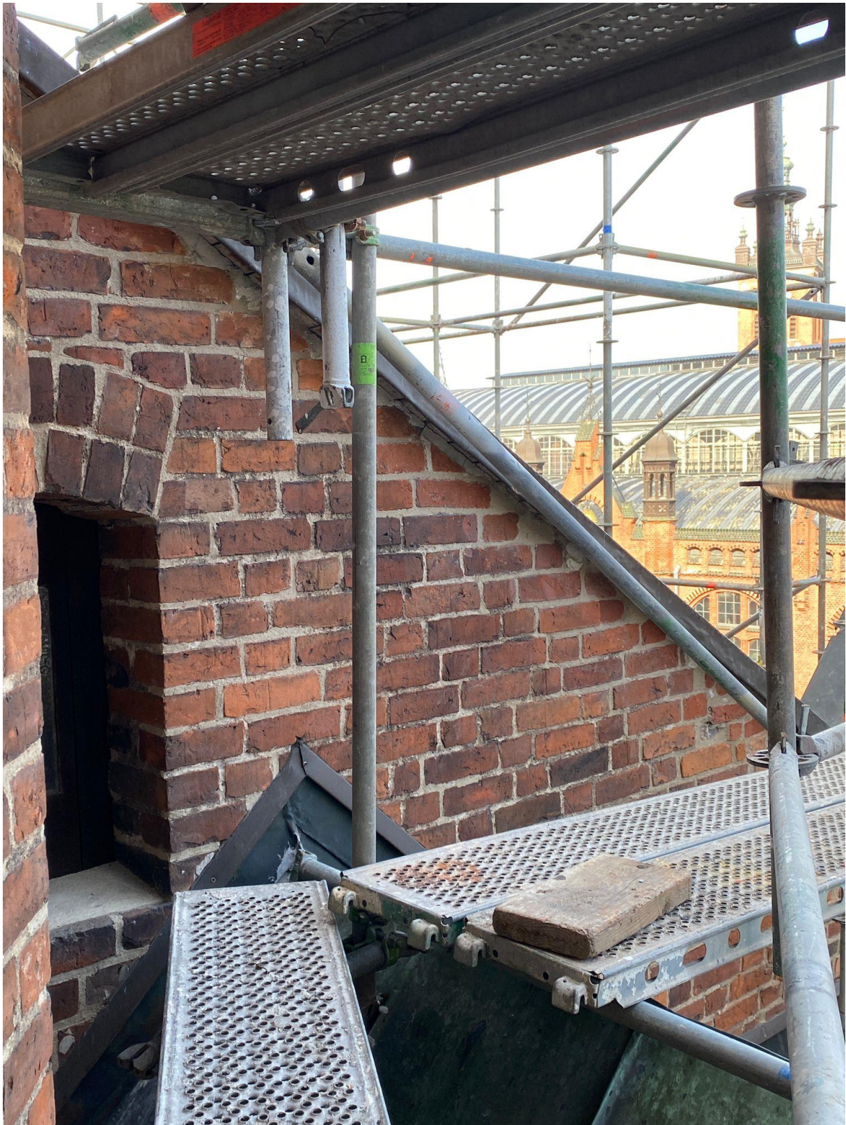
Fot. 22. Przestrzeń pod opierzeniem została dokładnie oczyszczona i uzupełniona (fot. W. Domagała)
