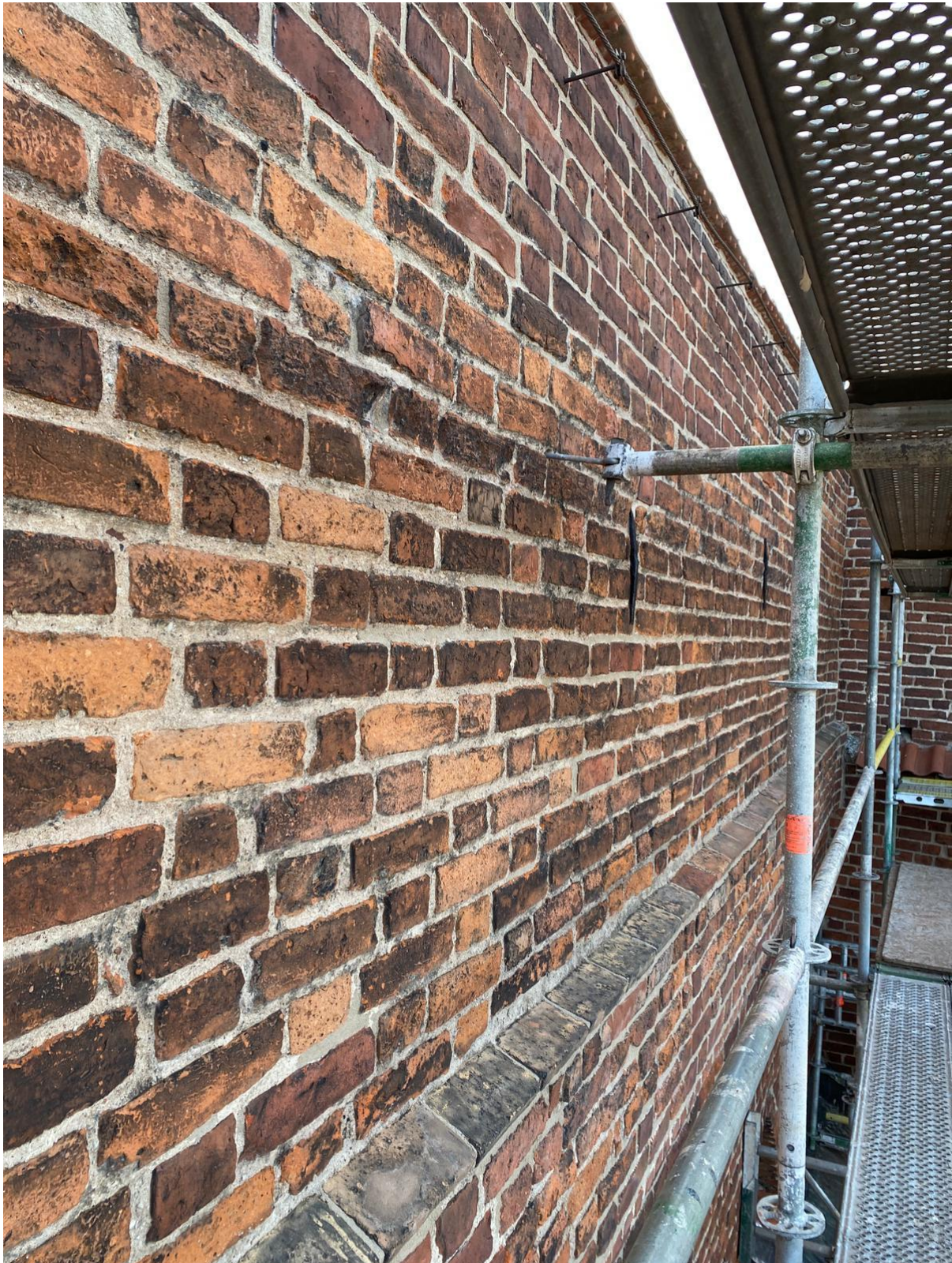
Fot. 17. Elewacja ceglana po zabiegach konserwatorskich (fot. W.Domagała)
