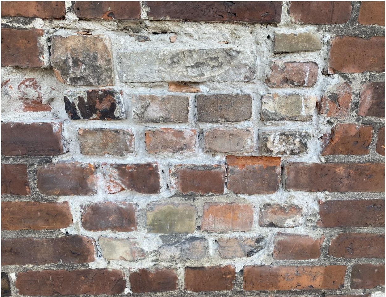
Fot. 7. Wtórne przemurowanie wyróżniające się na tle oryginału - stan przed konserwacją (fot. W. Domagała).
