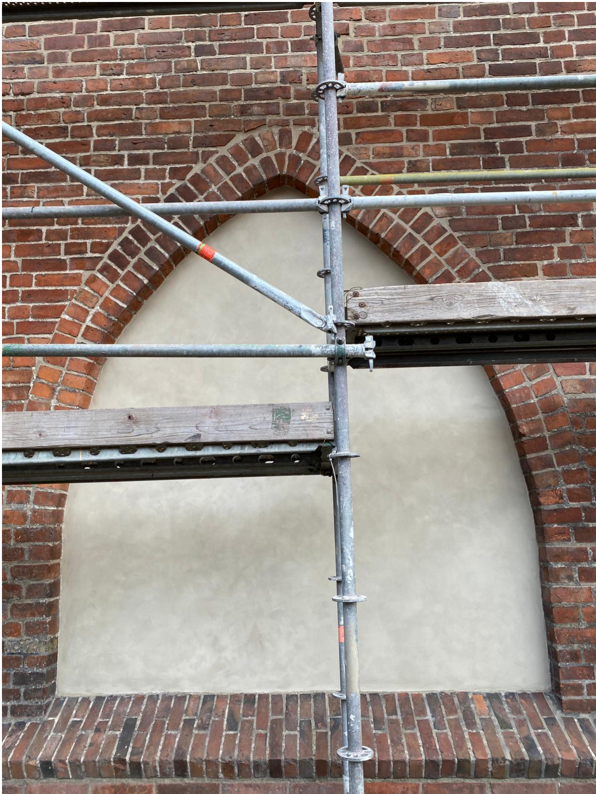
Fot. 25. Zabezpieczono i zrekonstruowano tynki w blendzie (fot. W. Domagała).
