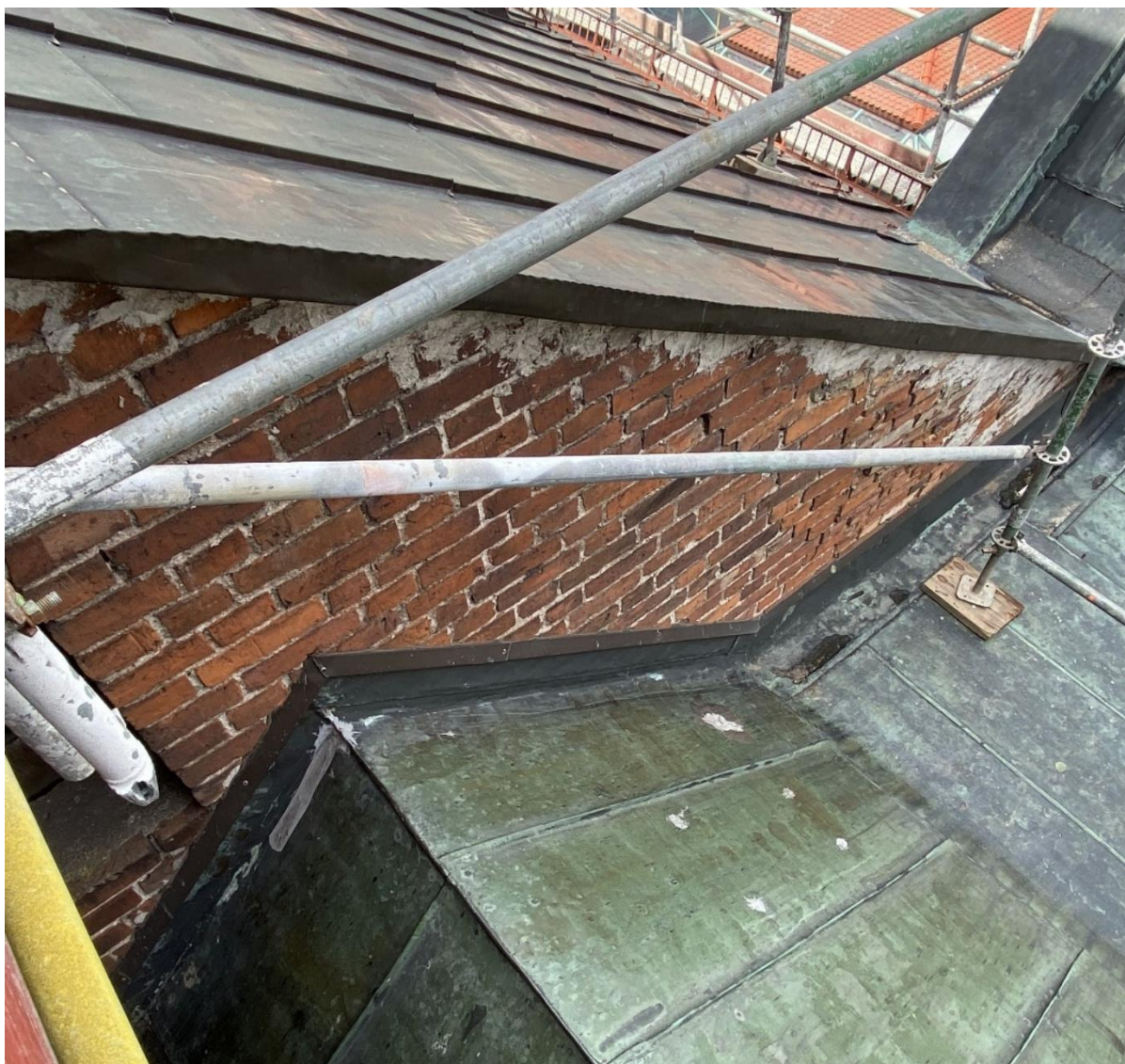
Fot. 9. Nieestetycznie wykonane uzupełnienia w miejscu styku elewacji ceglanej z dachem (fot. W. Domagała).
