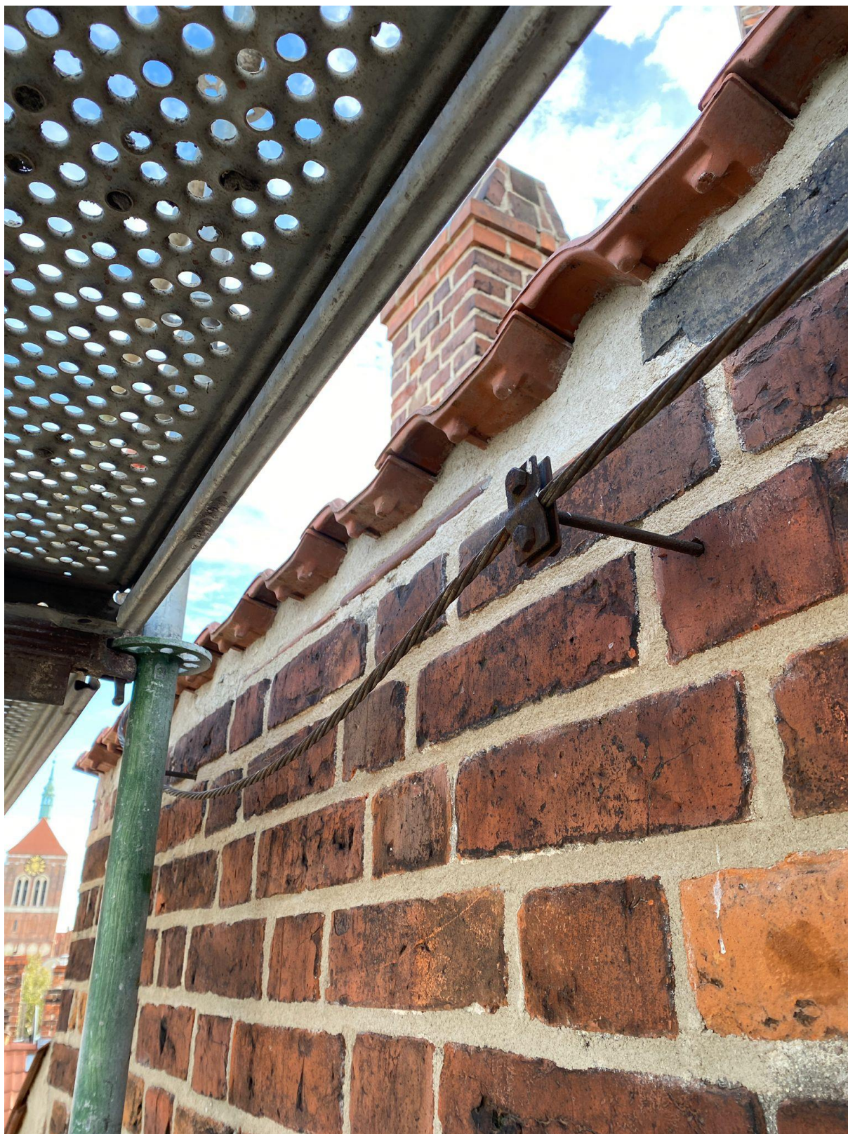
Fot. 20. Przestrzeń pod dachówką została dokładnie oczyszczona z wtórnych zapraw oraz uzupełniona (fot. W. Domagała)
