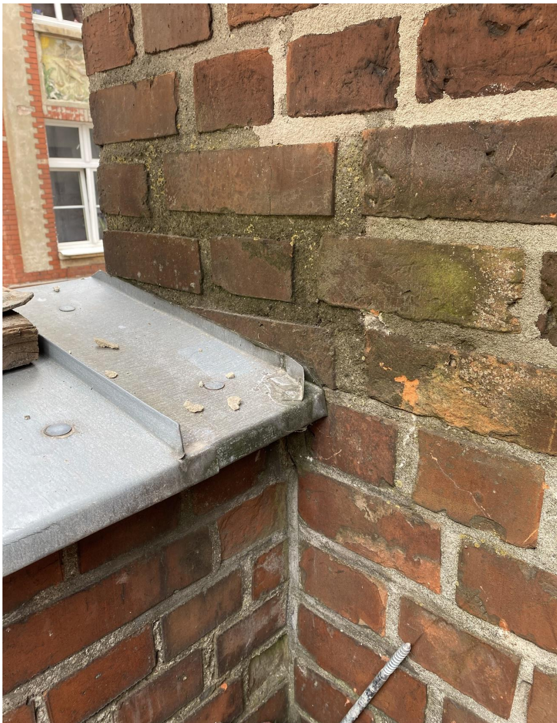
Fot. 5. Nawarstwienia mikrobiologiczne miejscowo pojawiające się na elewacji przed konserwacją (fot. W. Domagała).
