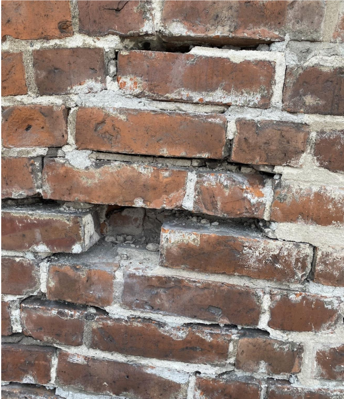
Fot. 8. Niechlujnie wykonane spoinowanie po wstępnym usunięciu wtórnych, luźnych spoin (fot. W. Domagała).
