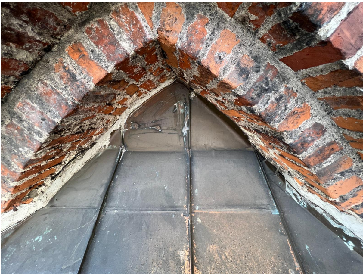
Fot. 15. Blenda nad dachem ze śladowymi pozostałościami pierwotnego tynku po wstępnym oczyszczeniu (fot. W. Domagała).
