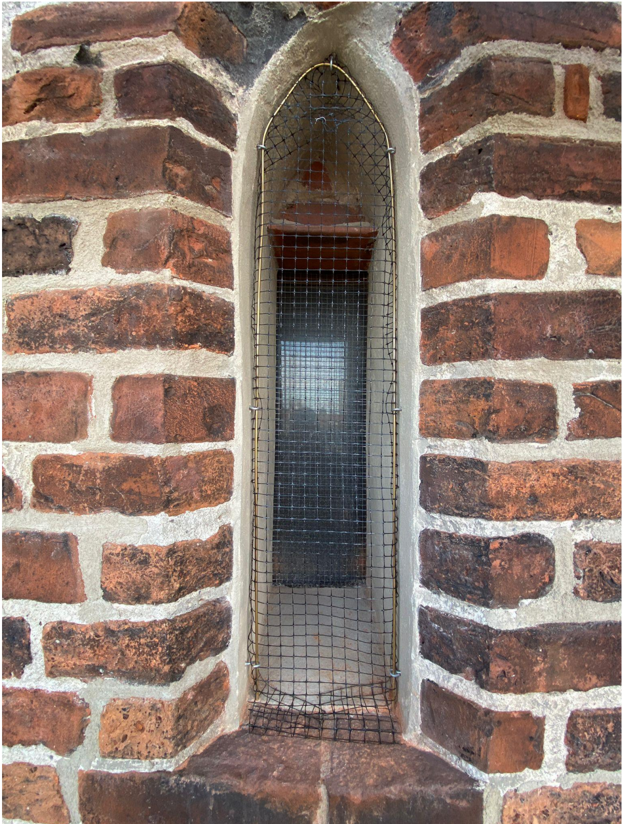
Fot. 26. Zabezpieczono i zrekonstruowano tynki w oknie, zabezpieczono cegłę w zwieńczeniu okna. Zamontowano siatkę ochronną (fot. W. Domagała).
