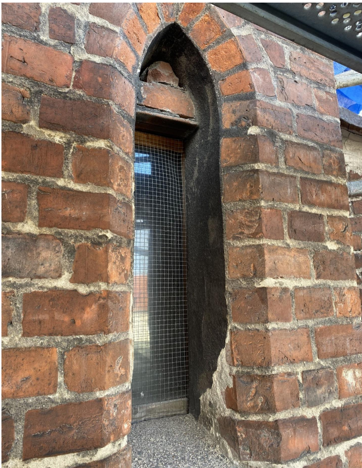
Fot. 14. Małe okno elewacji kaplicy św. Jacka z pozostałościami mocno spatynowanego tynku – stan przed konserwacją (fot. W. Domagała).
