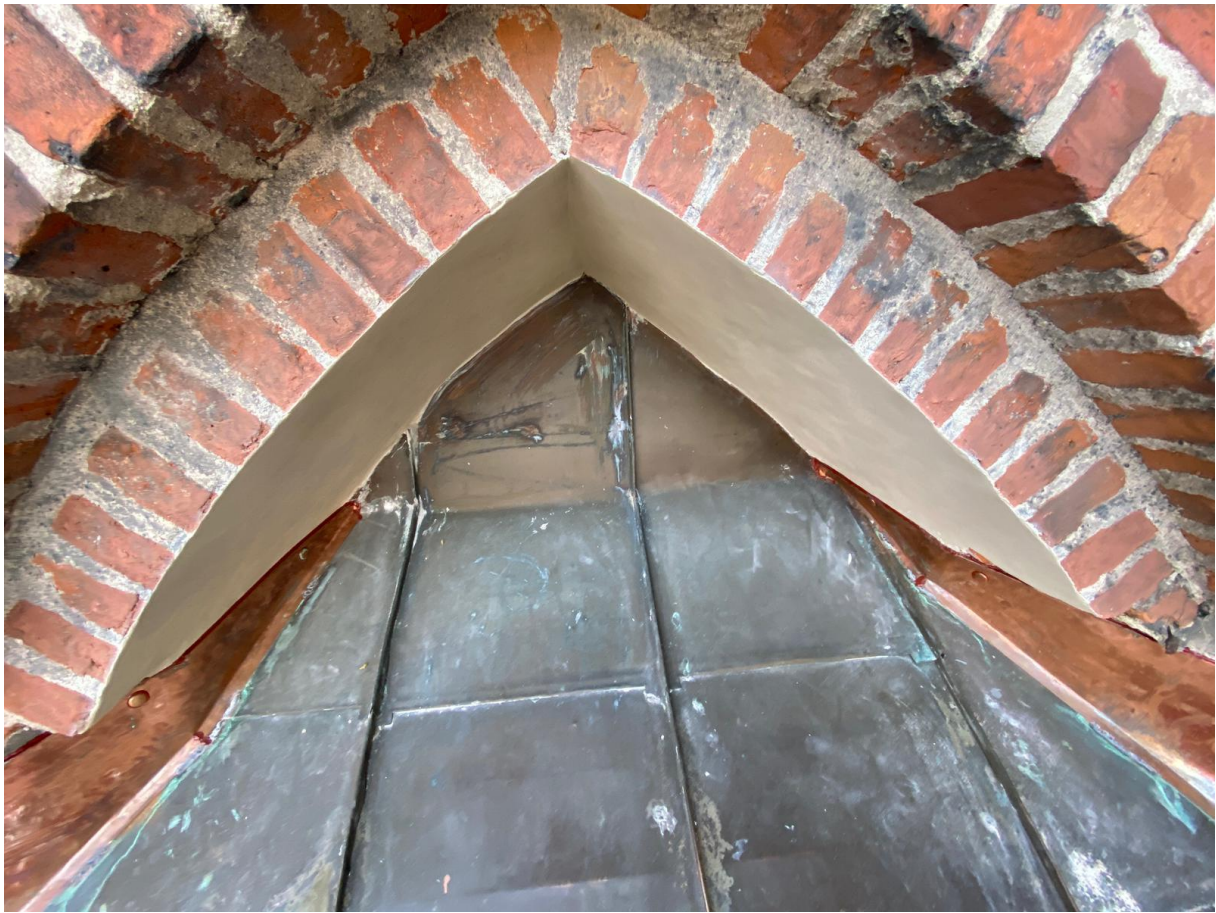
Fot. 27. Zabezpieczono i zrekonstruowano tynki w blendzie oraz oczyszczono materiał ceramiczny łuku (fot. W. Domagała).
