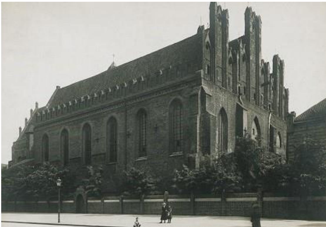
4. Kościół Św. Mikołaja, elewacja północna i zachodnia, 1916-1923.
