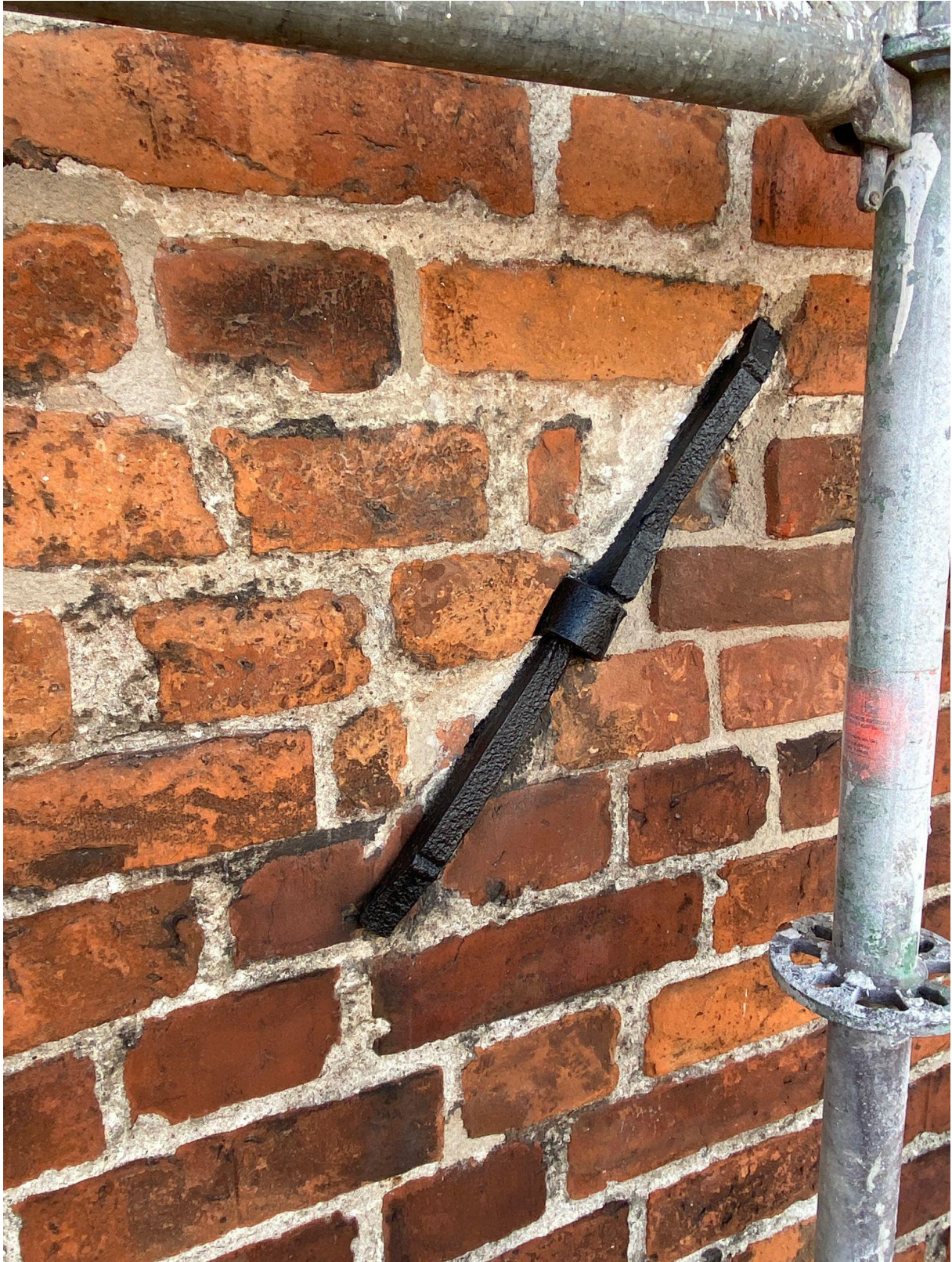
Fot. 28. Metalowa ankra po zabezpieczeniu i przemalowaniu (fot. W. Domagała).
