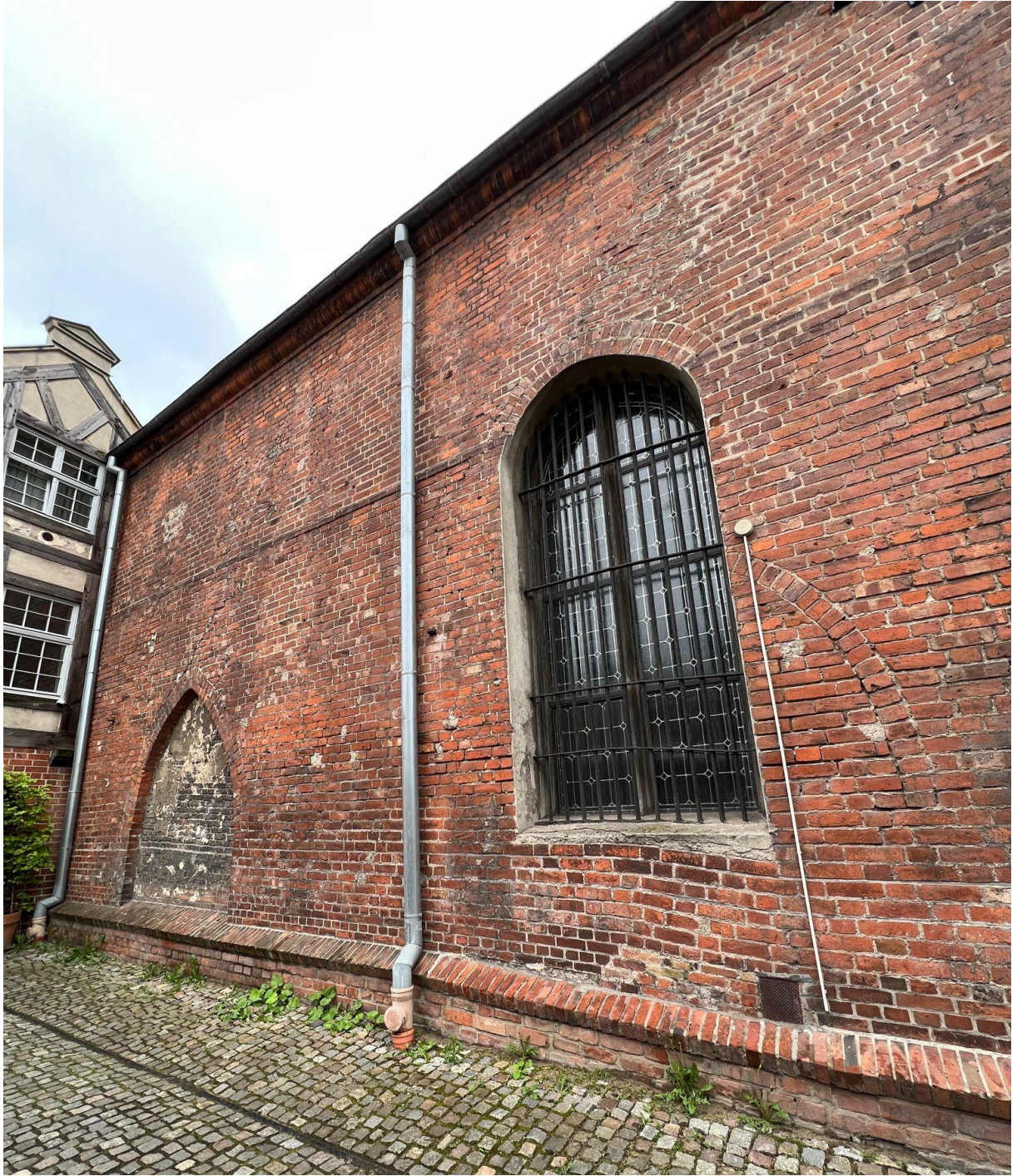
Fot. 3. Widok na elewację północną przed konserwacją (fot. M. Szczepkowski).
