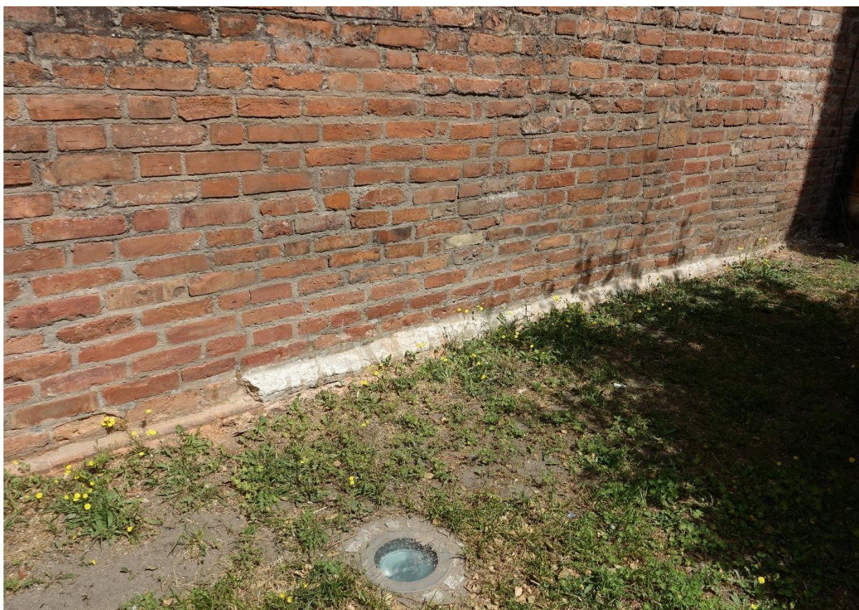
Ilustracja 47. Po zasklepieniu odwiertów.
