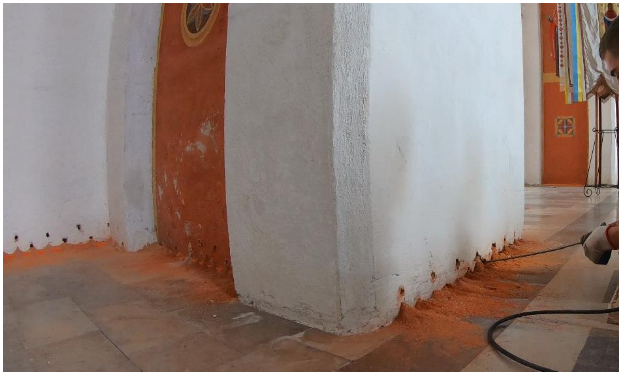
Ilustracja 29. Pogłębianie otworów przy użyciu dłuższego wiertła.
