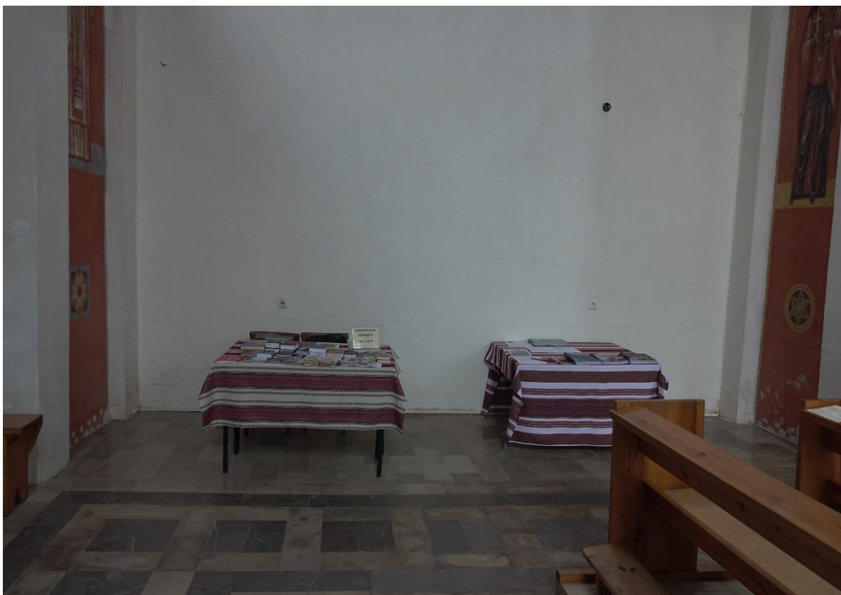
Ilustracja 42. Widok na zachodnią część ściany północnej kościoła po pracach dotowanych w 2023 r. ze środków Gminy Miasta Gdańska oraz MKiDN i wkładu własnego.
