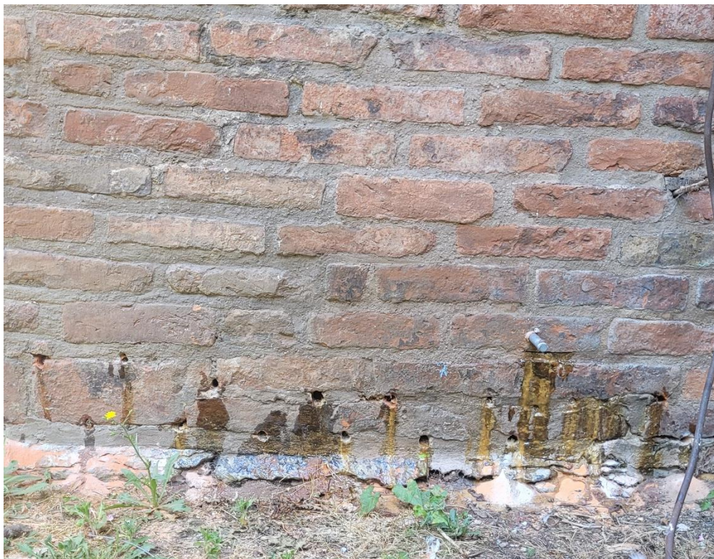
Ilustracja 34. Odwierty po wysyceniu żywicą.
