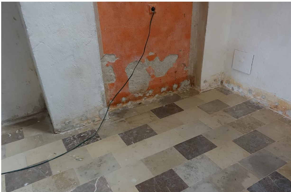
Ilustracja 35. Po zasklepieniu odwiertów.
