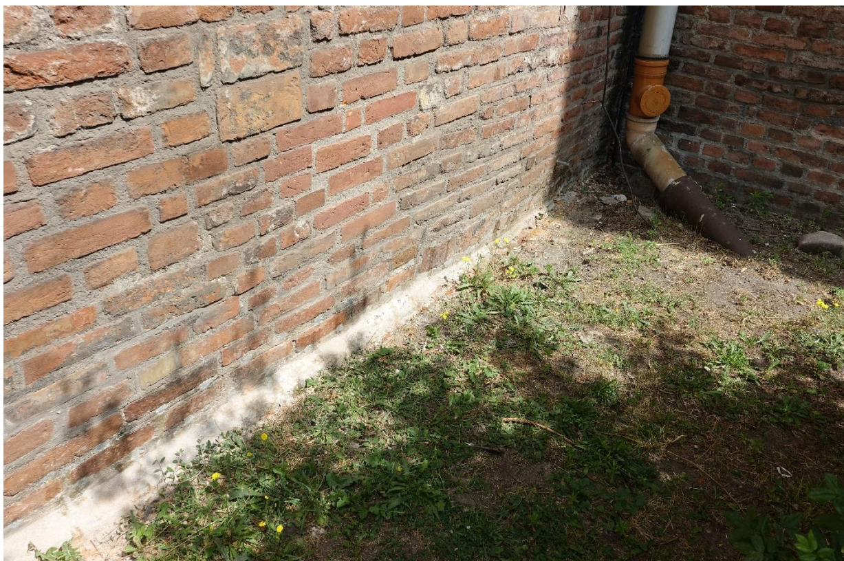
Ilustracja 48. Po zasklepieniu odwiertów.
