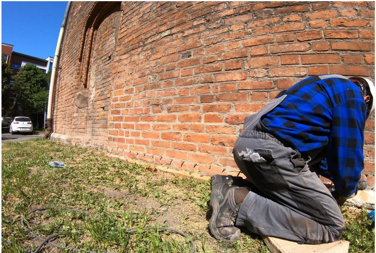
Ilustracja 21. Osadzanie iniektorów w odwiertach.
