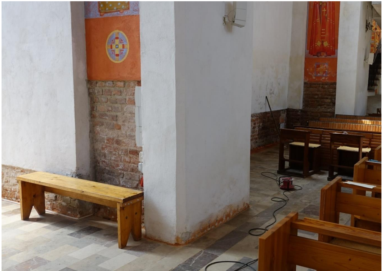
Ilustracja 37. Po zasklepieniu odwiertów.
