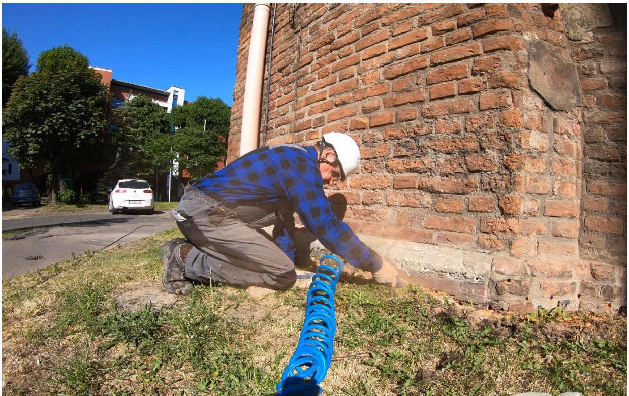
Ilustracja 20. Oczyszczanie otworów z materiałów luźnych.
