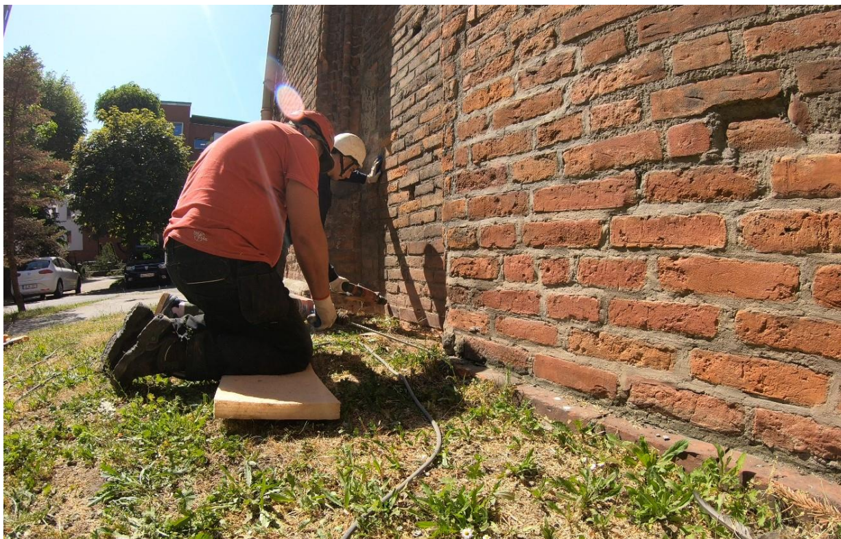
Ilustracja 17. Wykonywanie odwiertów pod iniektory.
