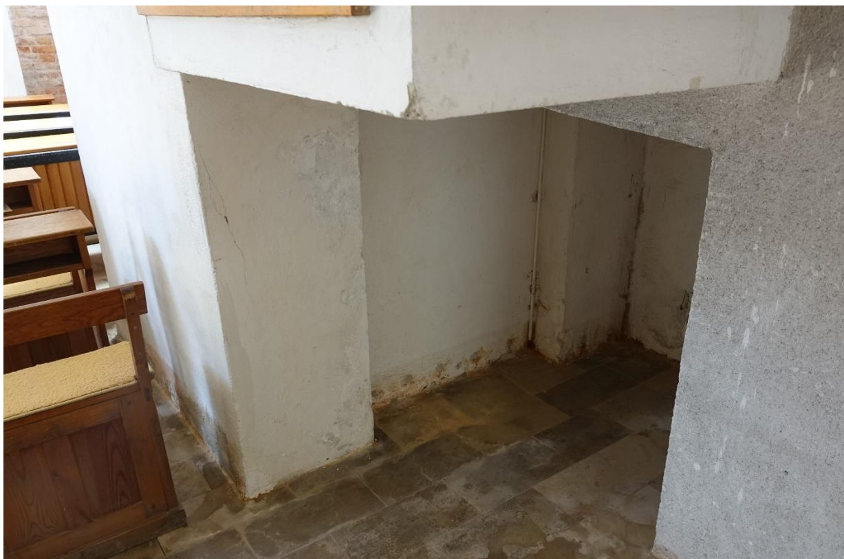
Ilustracja 36. Po zasklepieniu odwiertów.
