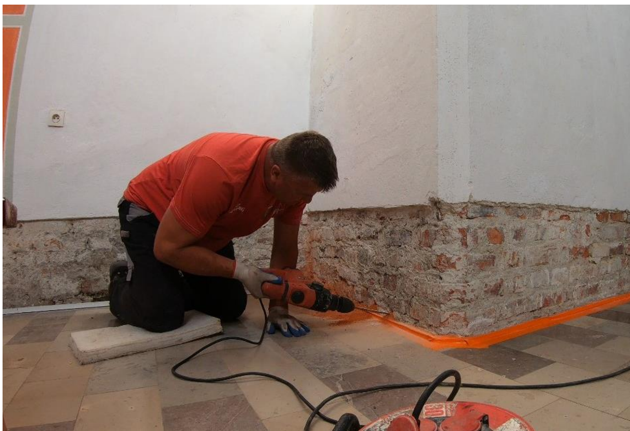
Ilustracja 23. Wykonywanie odwiertów pod iniektory.
