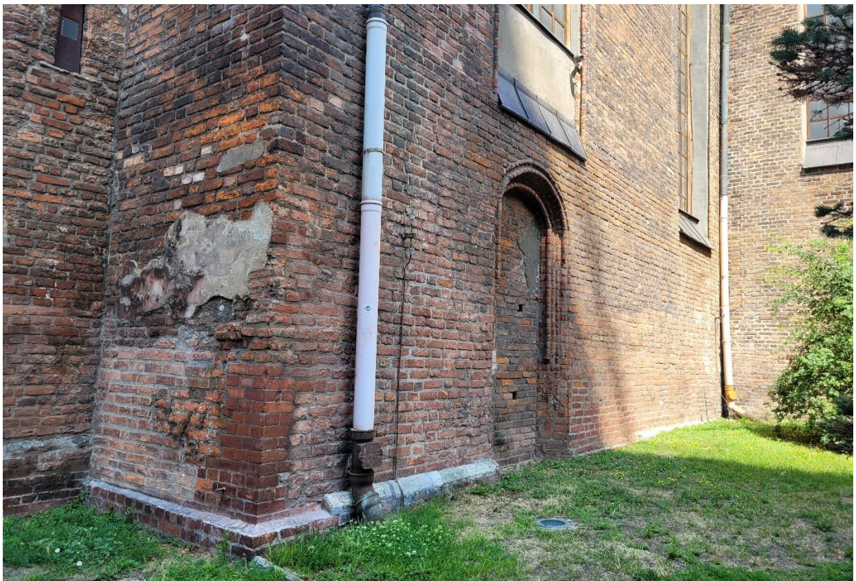
Ilustracja 44. Widok na zachodnią część południowej ściany kościoła po pracach dotowanych w 2023 r. ze środków Gminy Miasta Gdańska oraz MKiDN i wkładu własnego.
