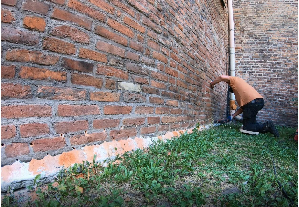
Ilustracja 19. Wykonywanie odwiertów pod iniektory.
