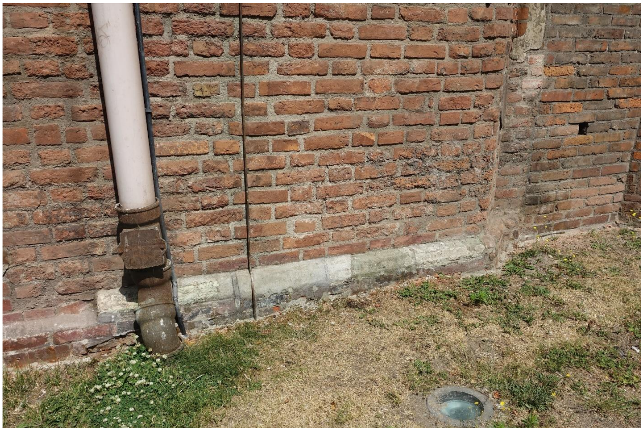
Ilustracja 46. Po zasklepieniu odwiertów.
