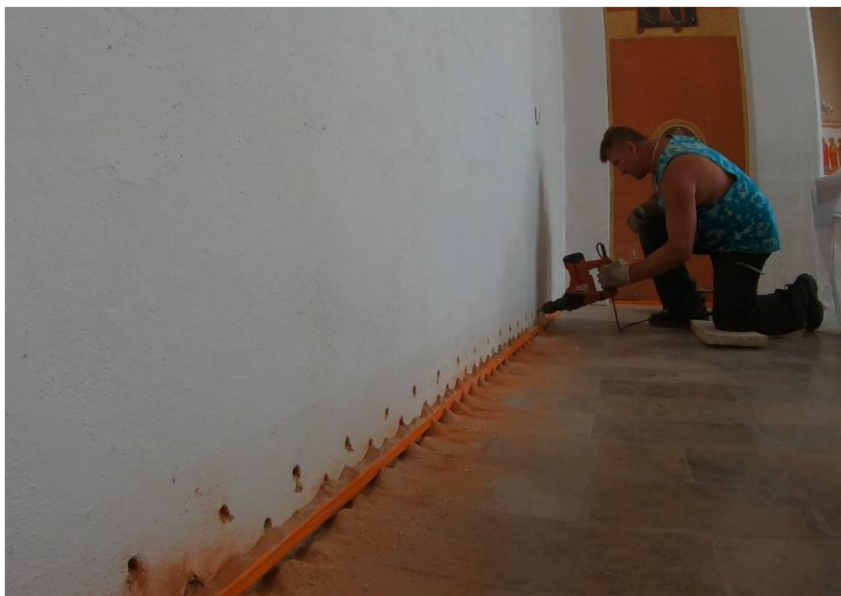
Ilustracja 28. Wykonywanie odwiertów pod iniektory.
