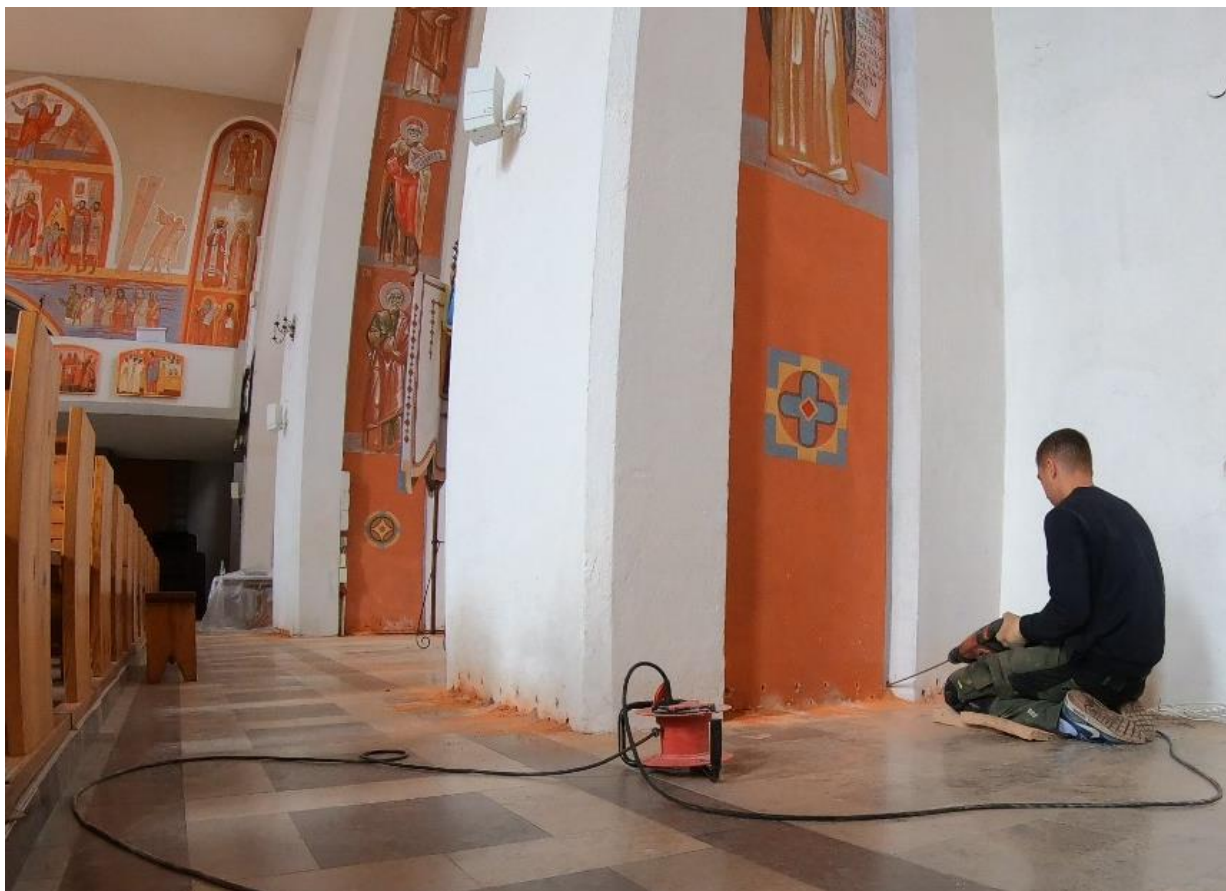
Ilustracja 30. Wykonywanie odwiertów pod iniektory.
