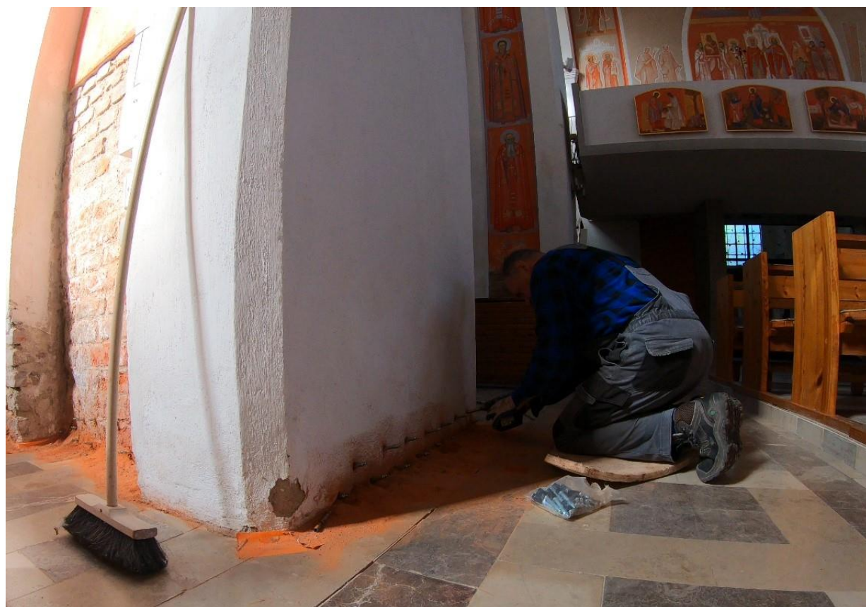
Ilustracja 26. Osadzanie iniektorów w odwiertach.
