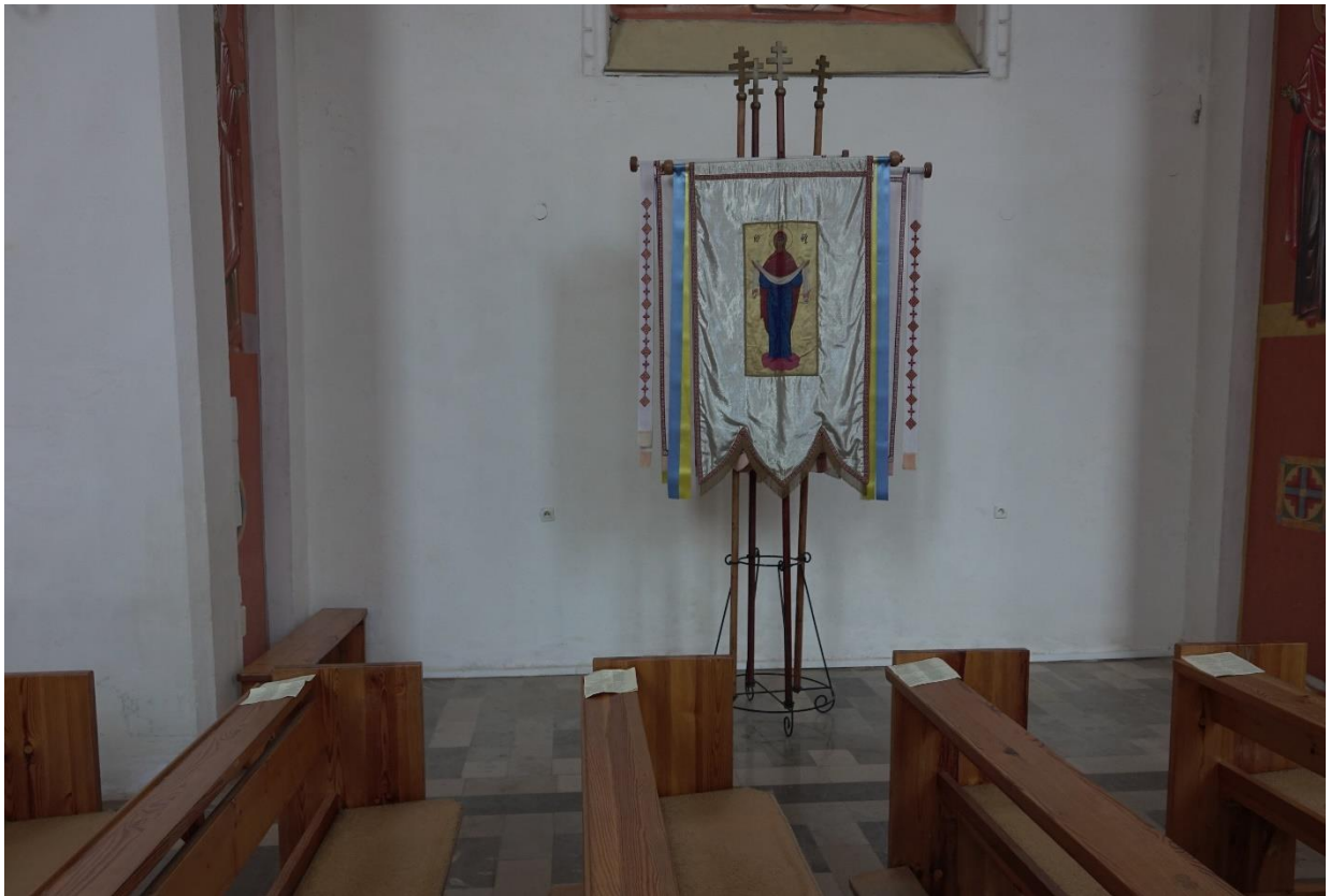
Ilustracja 43. Widok na zachodnią część ściany północnej kościoła po pracach dotowanych w 2023 r. ze środków Gminy Miasta Gdańska oraz MKiDN i wkładu własnego.
