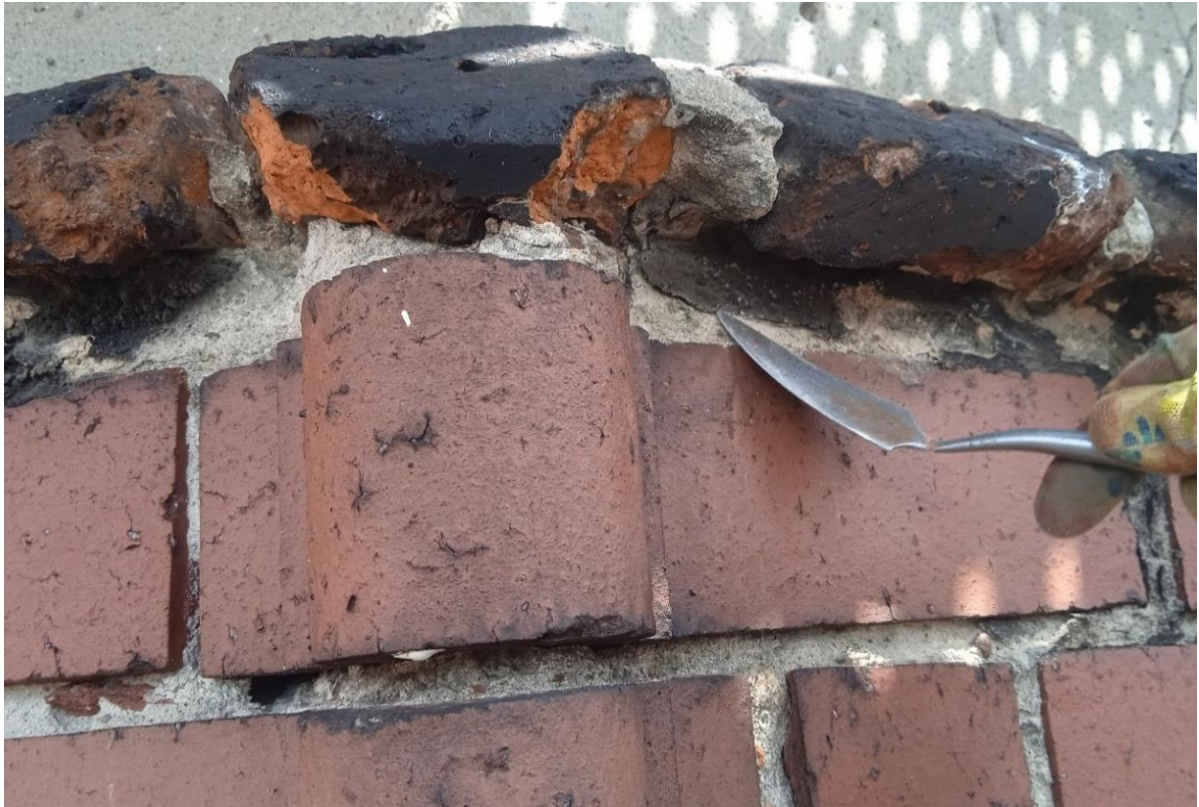
Ilustracja 28. Usuwanie zapraw cementowych stanowiących zagrożenie dla materii zabytkowej.
