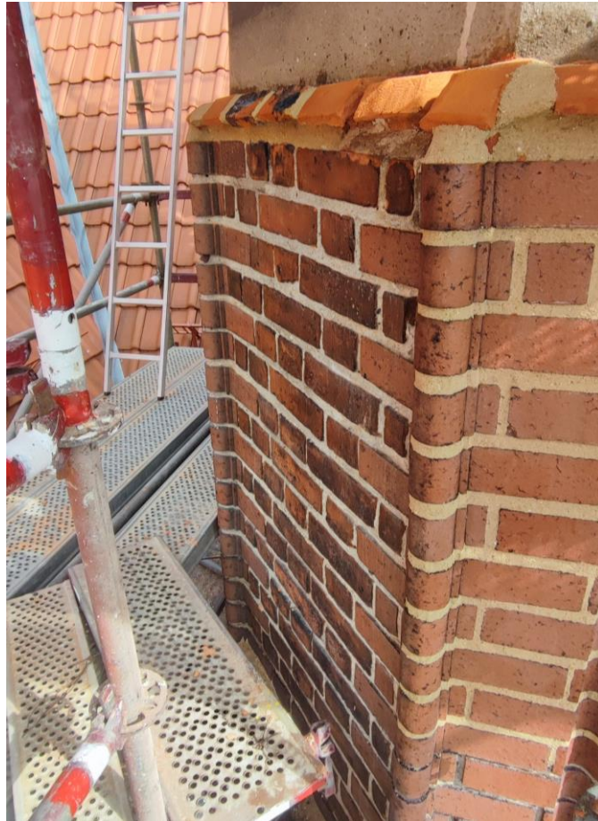
Ilustracja 48. Stan bezpośrednio po uzupełnieniu ubytków cegły, przed scalaniem kolorystycznym.
