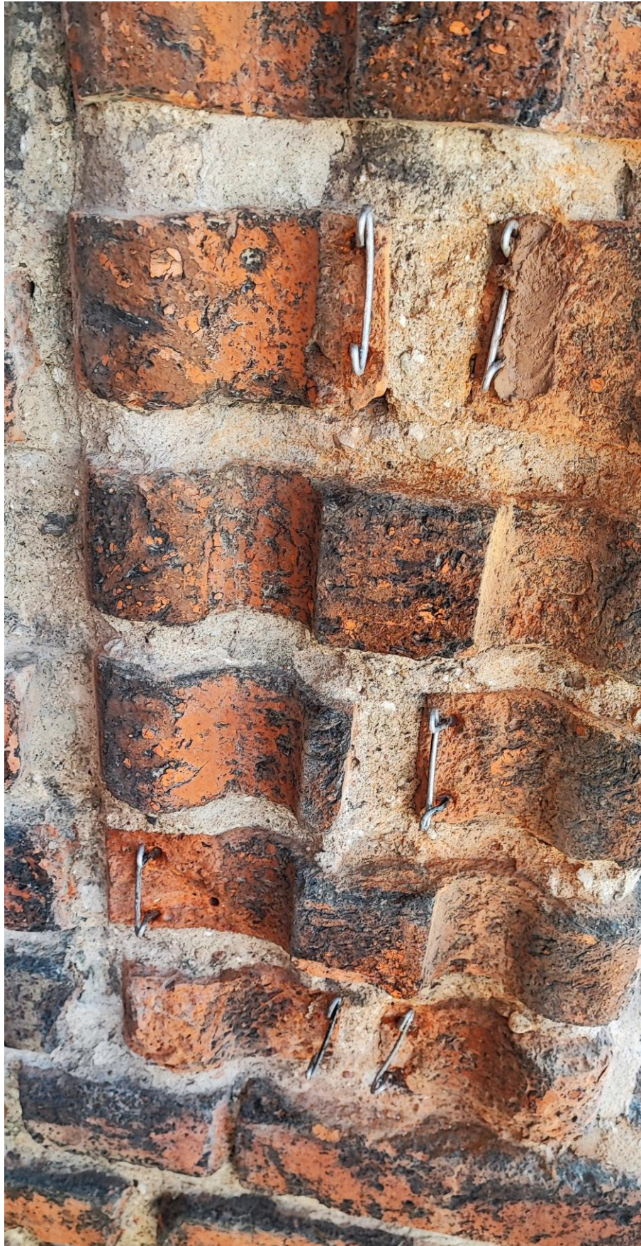
Ilustracja 33. Zbrojenia pod uzupełnienia ubytków cegły.
