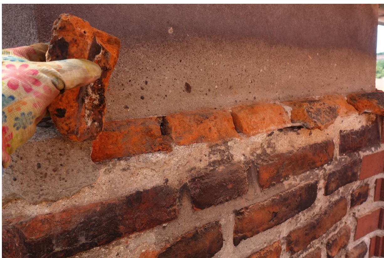
Ilustracja 23. Demontaż elementów, które powodowały zagrożenie.
