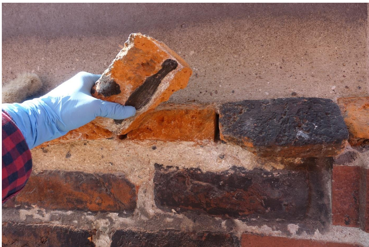
Ilustracja 22. Demontaż elementów, które powodowały zagrożenie.
