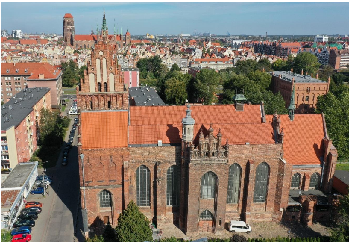
Ilustracja 51. Obiekt po zakończeniu prac konserwatorskich. Widok od południa.
