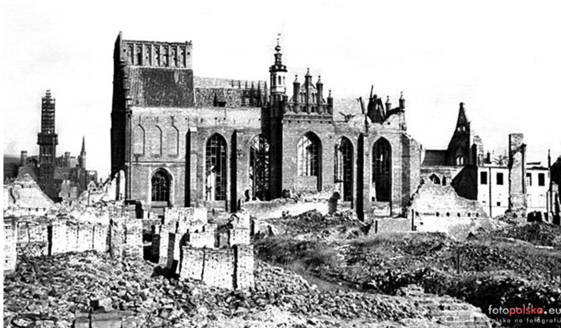
Ilustracja 5. Ruiny kościoła pw. Św. Apostołów Piotra i Pawła w latach 1945-1947. Na pierwszym planie materiał ceramiczny przeznaczony do odbudowy świątyni [źródło: fotopolska.eu]
