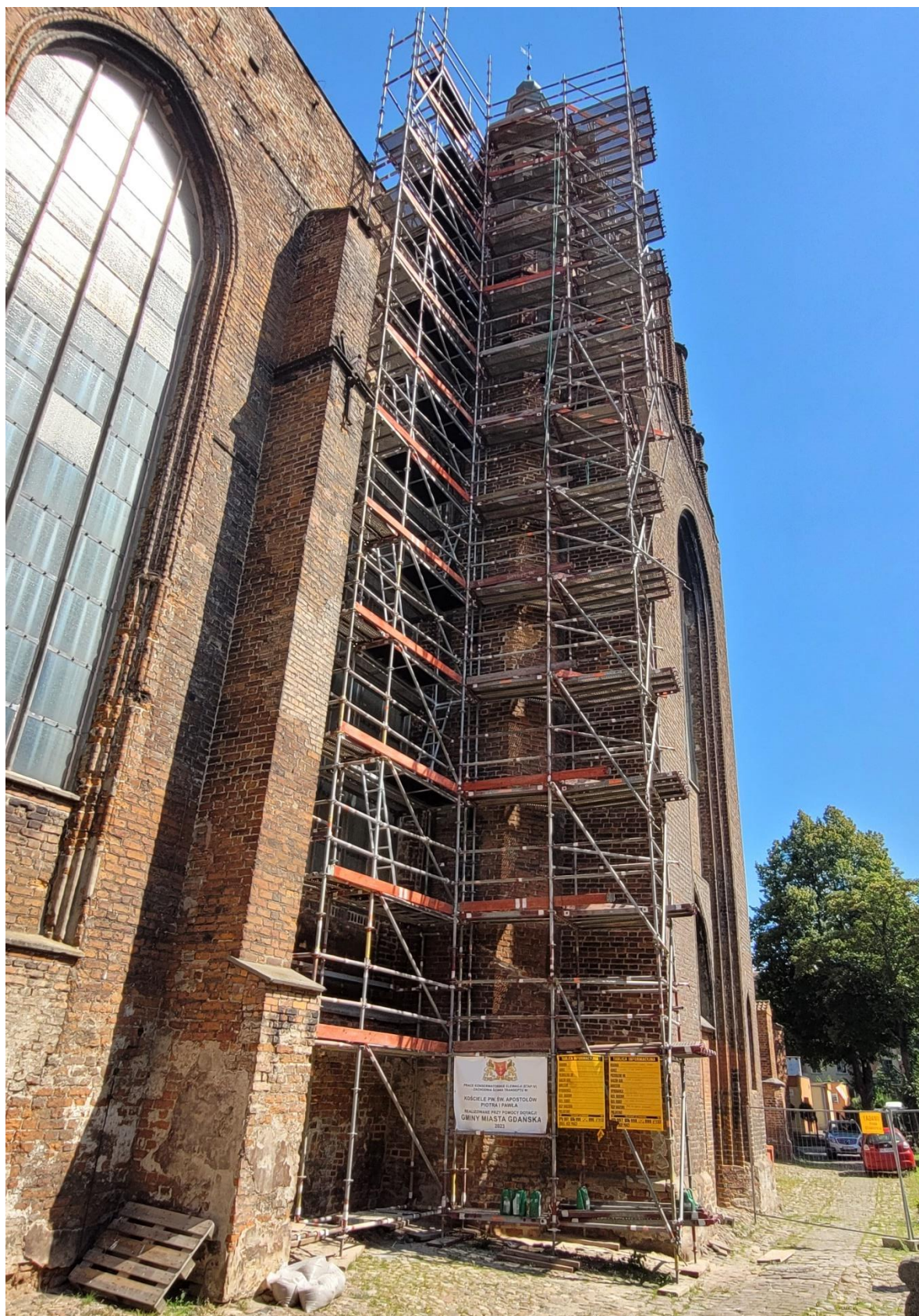
Ilustracja 20. Zachodnia ściana pseudotranseptu w trakcie prac konserwatorskich.
