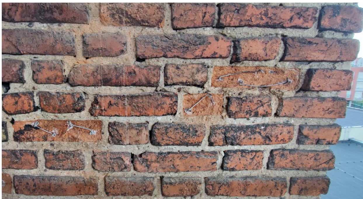
Ilustracja 36. Zbrojenia pod uzupełnienia ubytków cegły.
