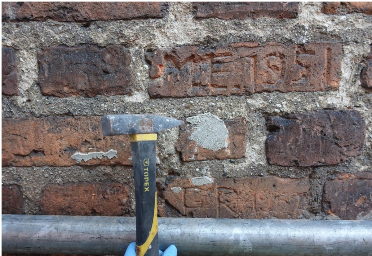
Ilustracja 27. Usuwanie szpecących zapraw cementowych.
