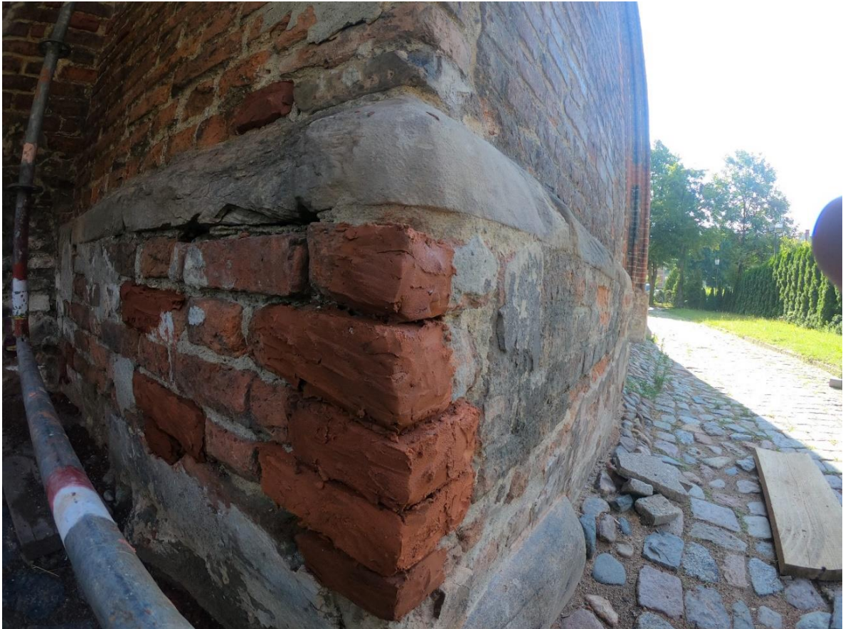
Ilustracja 38. Uzupełnianie ubytków cegły.
