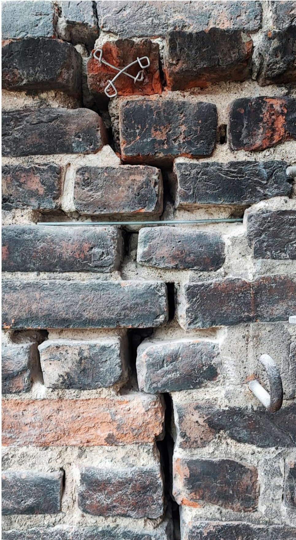
Ilustracja 32. Oczyszczenie spoin i wykonanie zbrojenia pod uzupełnienia ubytków cegły.
