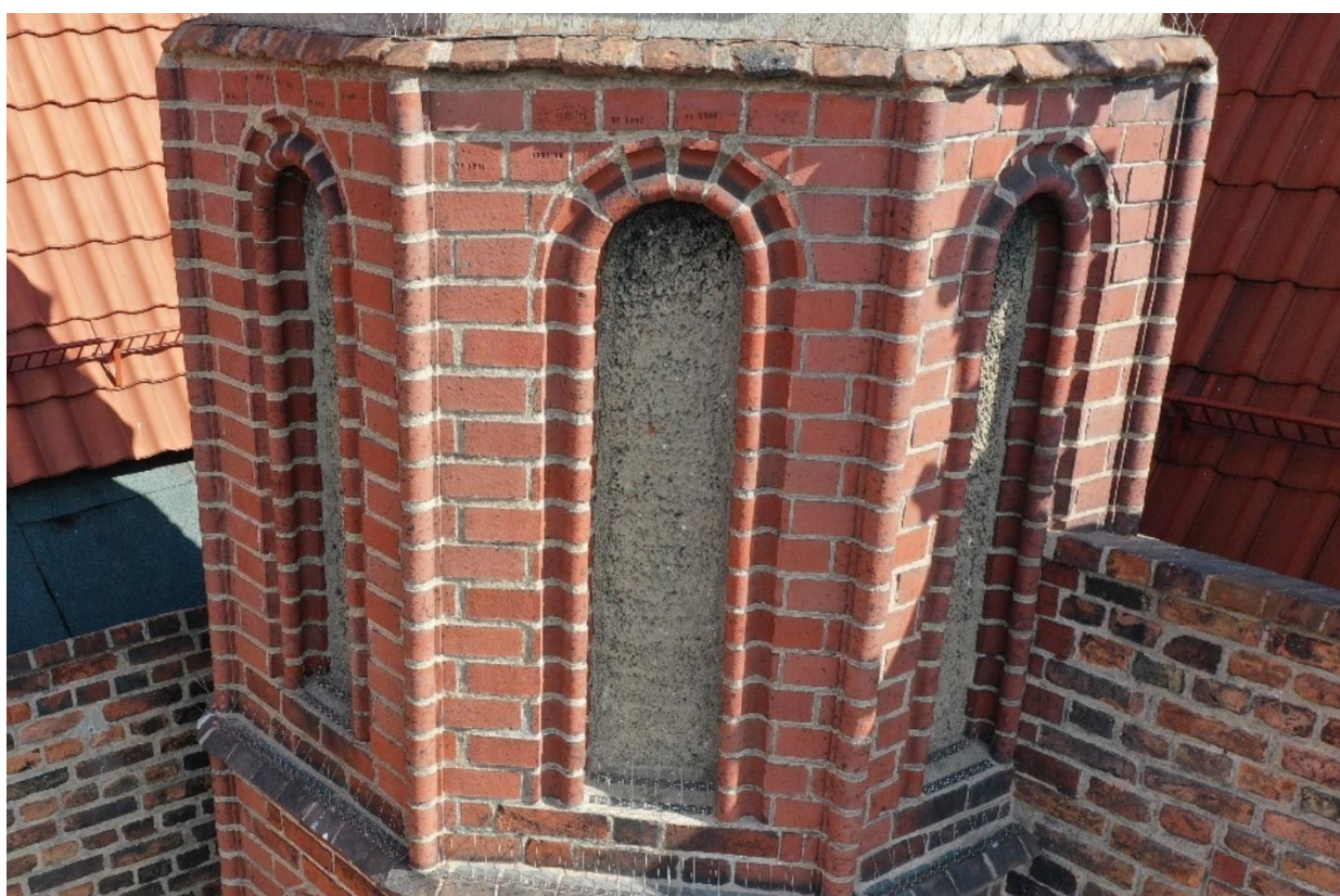
Ilustracja 68. Elewacja górnej części wieżyczki.
