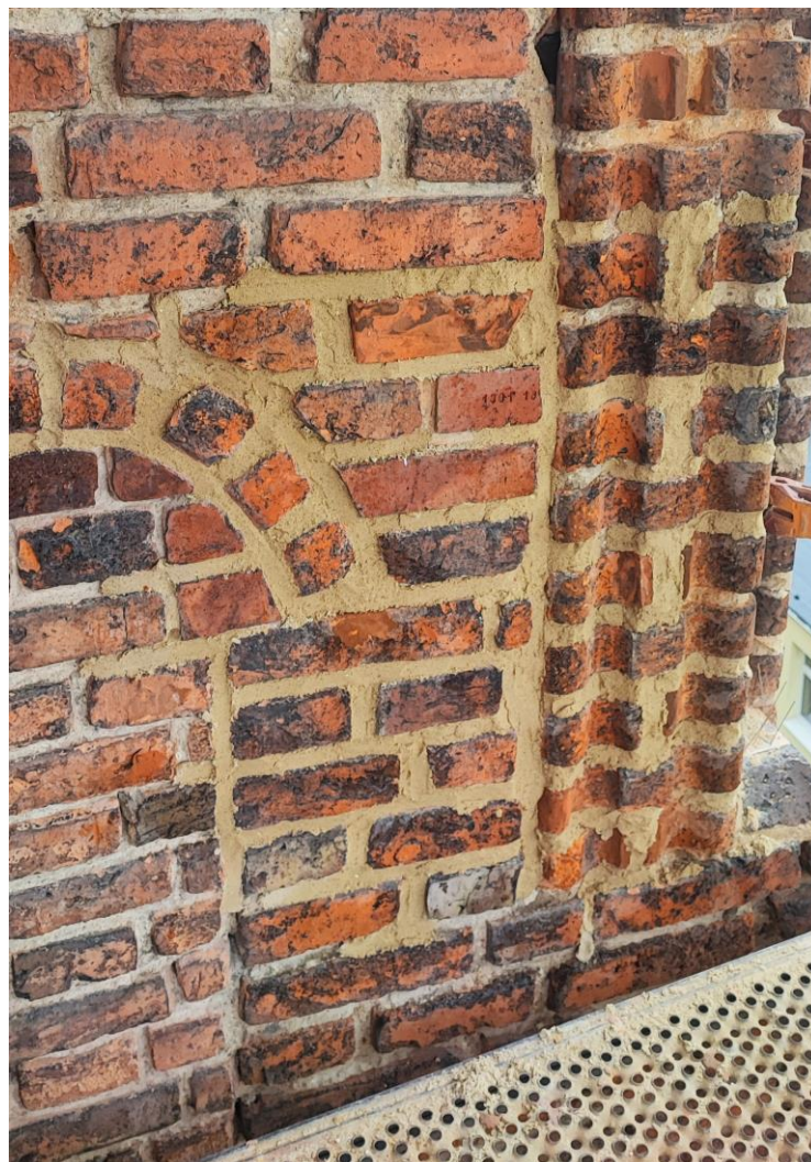
Ilustracja 47. Stan bezpośrednio po uzupełnieniu ubytków cegieł i zapraw (murowanie, spoinowanie).
