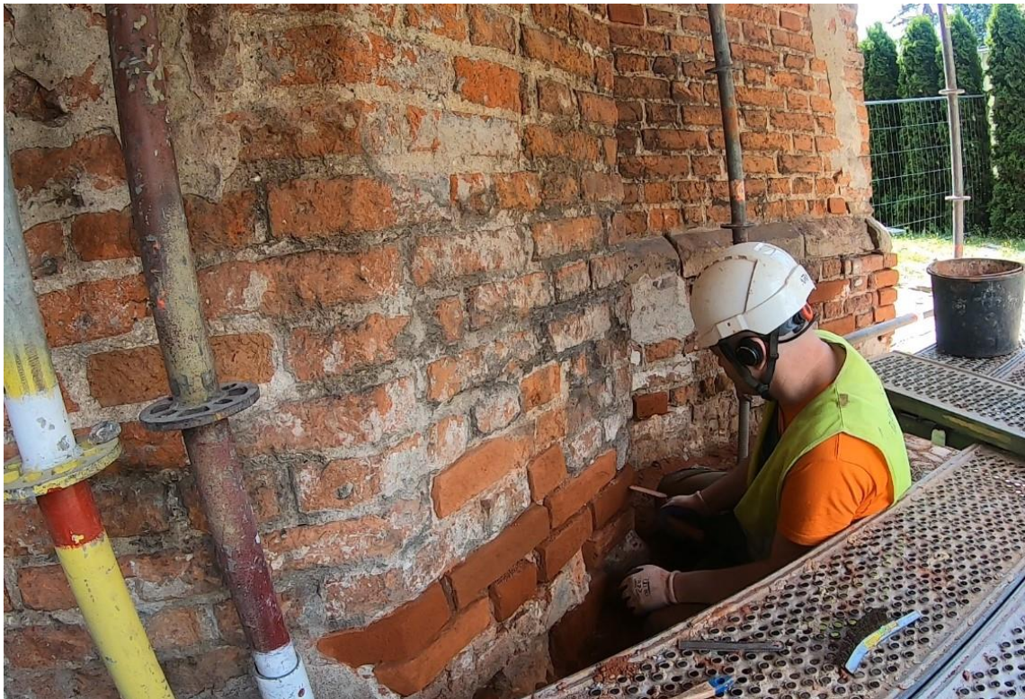
Ilustracja 39. Uzupełnianie ubytków cegły.
