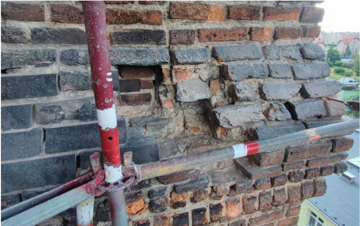
Ilustracja 26. Stan po zdemontowaniu luźnych elementów, które powodowały zagrożenie.
