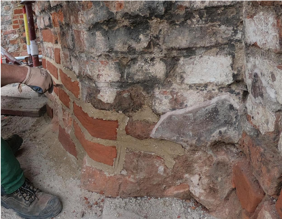
Ilustracja 42. Uzupełnianie ubytków zapraw (spoinowanie).
