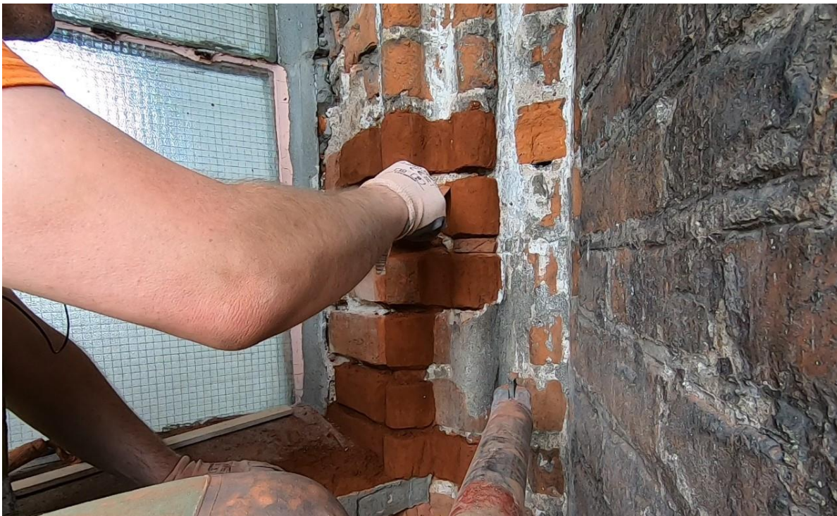
Ilustracja 41. Uzupelnianie ubytków kształtek ceramicznych.
