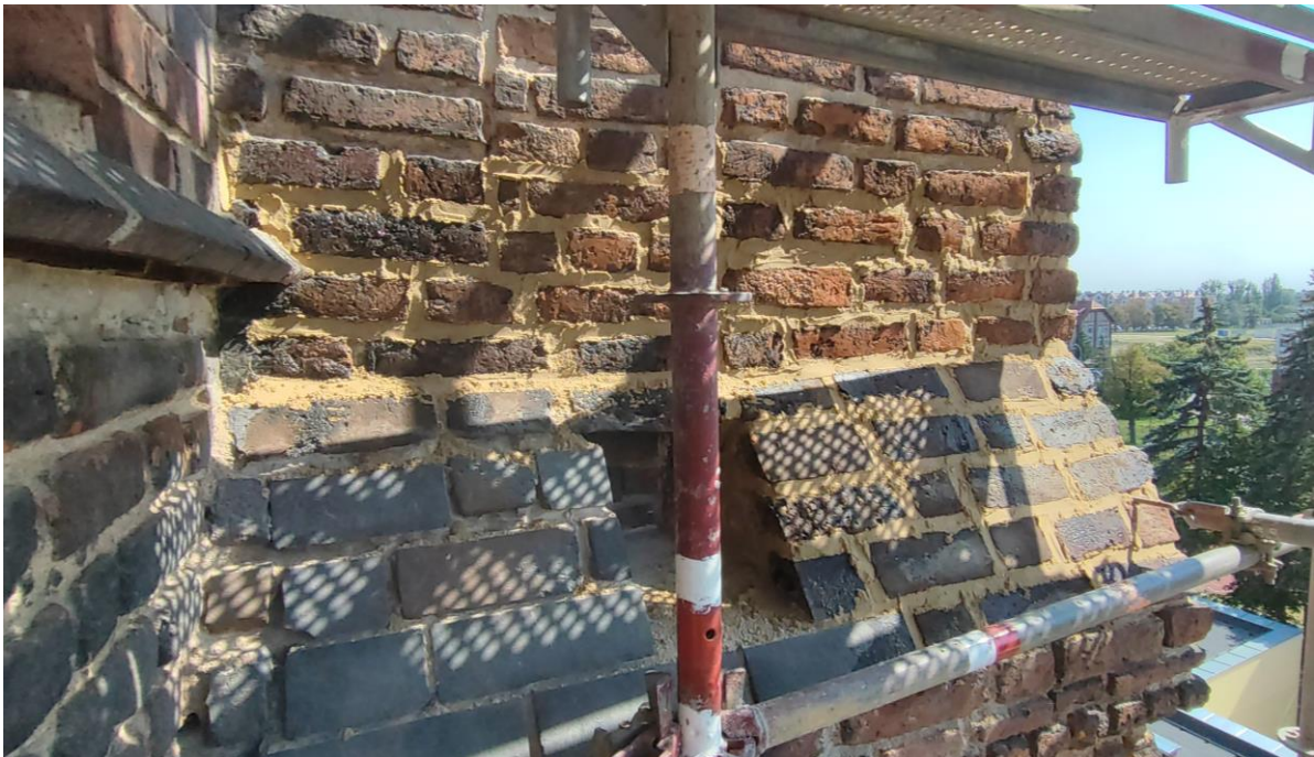
Ilustracja 45. Stan bezpośrednio po uzupełnieniu ubytków cegieł i zapraw (murowanie, spoinowanie).
