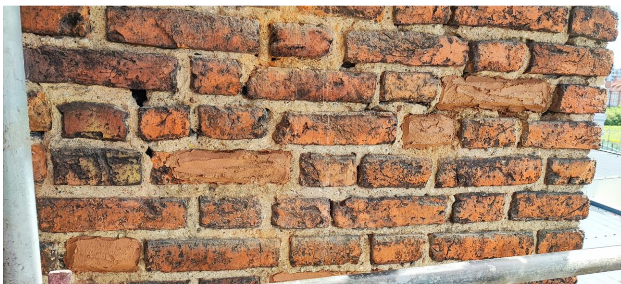
Ilustracja 37. Stan bezpośrednio po uzupełnieniu ubytków cegły widocznych na ilustracji 36.
