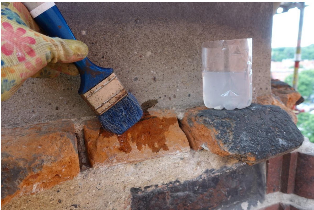
Ilustracja 29. Wzmacnianie osłabionych cegieł preparatem KSE 300.
