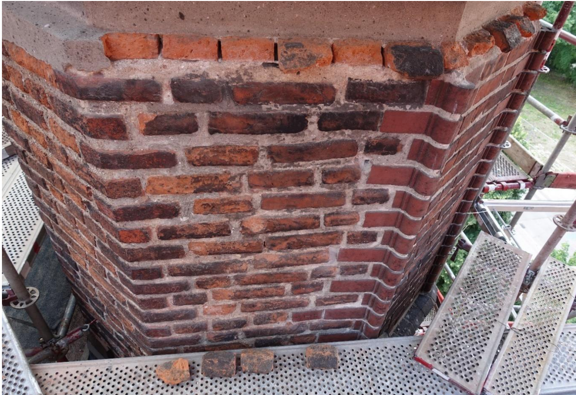
Ilustracja 24. Demontaż elementów, które powodowały zagrożenie.
