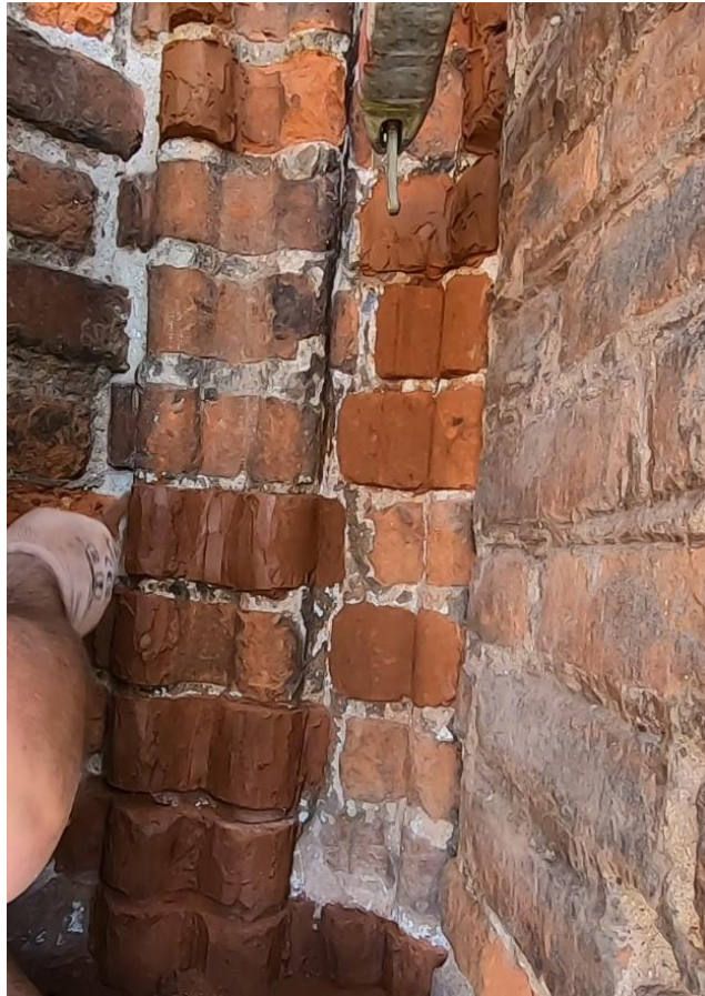
Ilustracja 40. Uzupelnianie ubytków kształtek ceramicznych w narożu zachodniej ściany pseudotranseptu i południowej elewacji korpusu kościoła.
