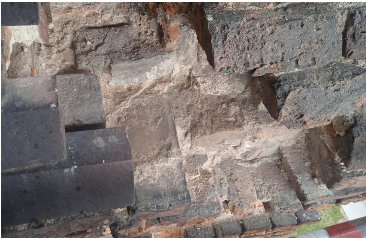
Ilustracja 25. Stan po zdemontowaniu luźnych elementów, które powodowały zagrożenie.
