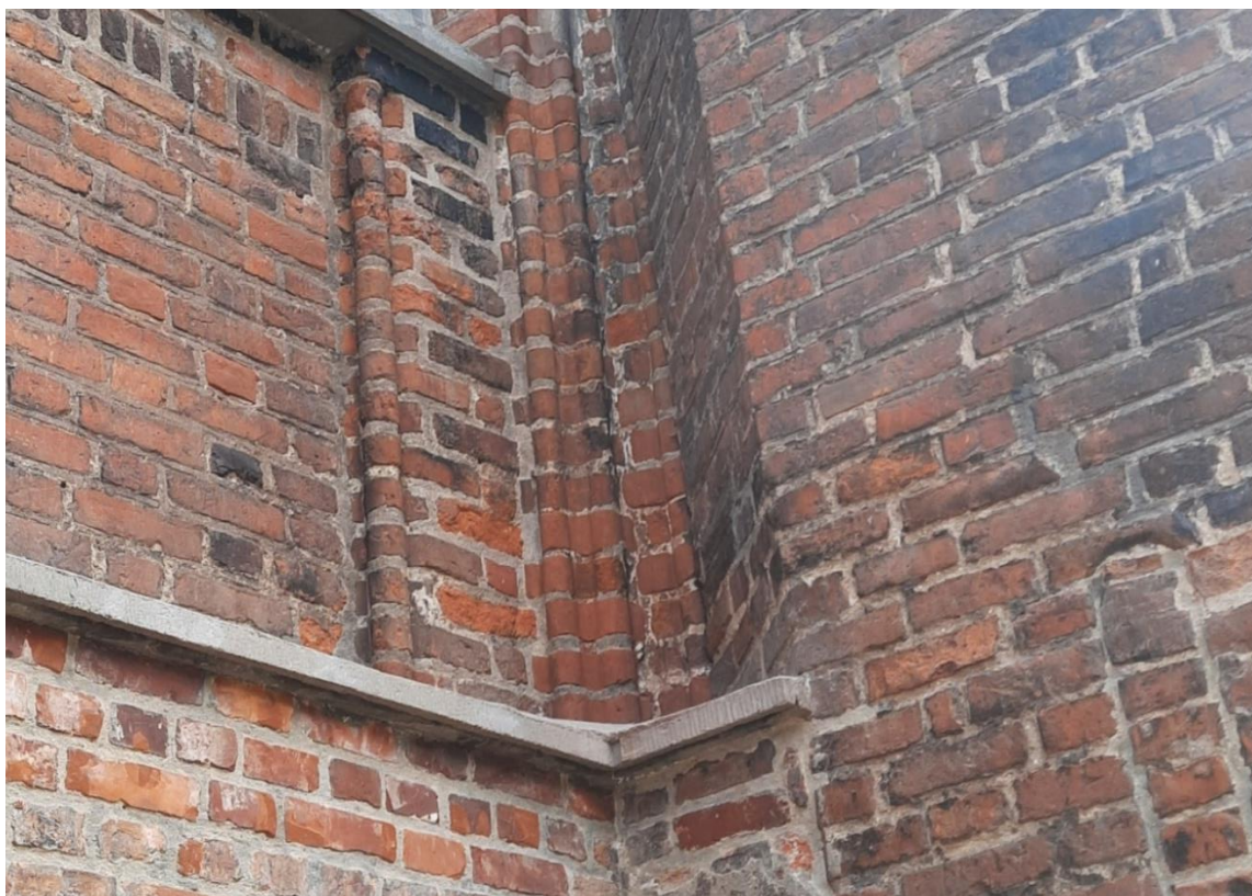
Ilustracja 59. Naroże zachodniej ściany pseudotranseptu i południowej elewacji korpusu kościoła.
