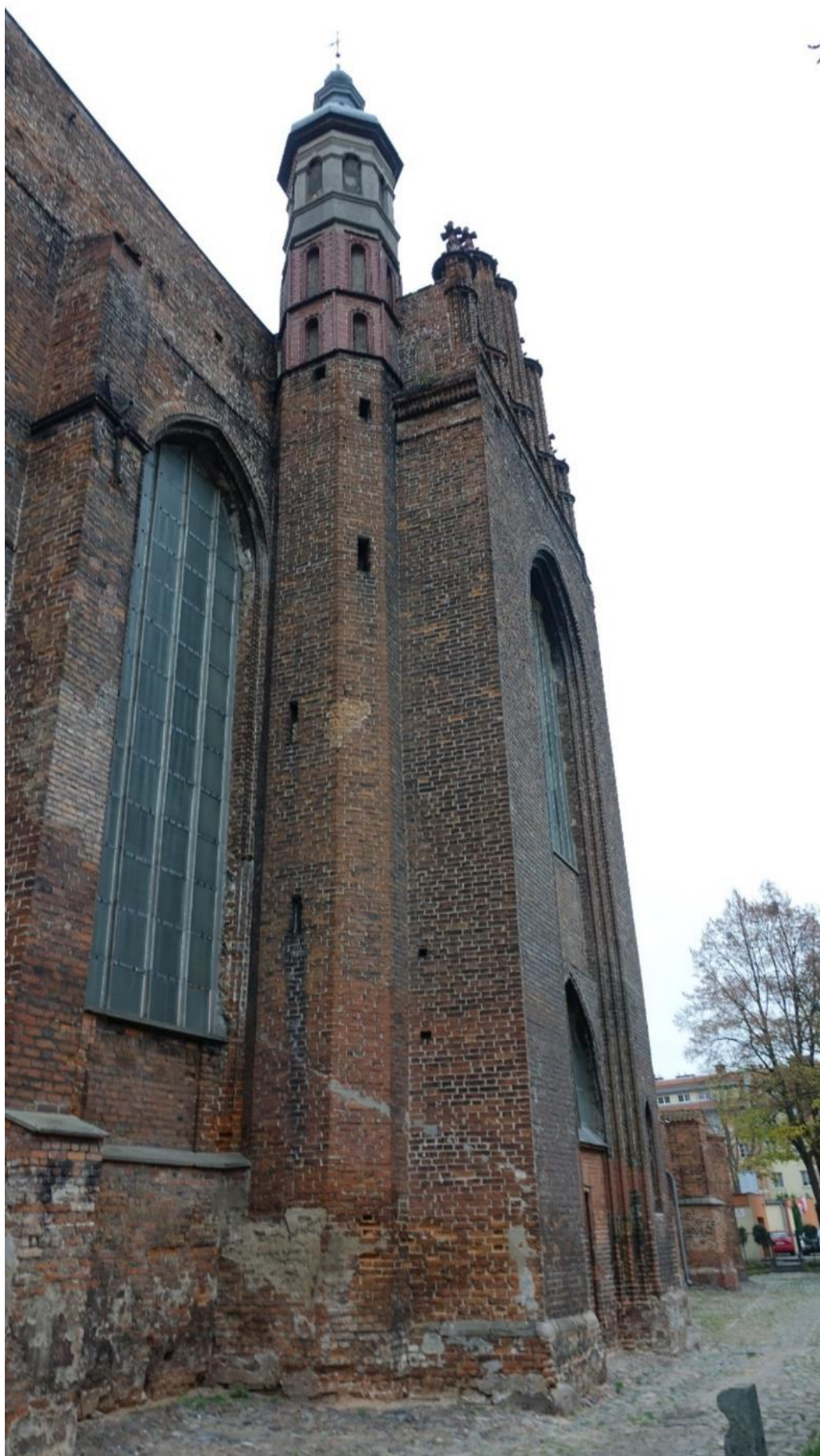
Ilustracja 9. Zachodnia ściana pseudotranseptu przed rozpoczęciem prac konserwatorskich.
