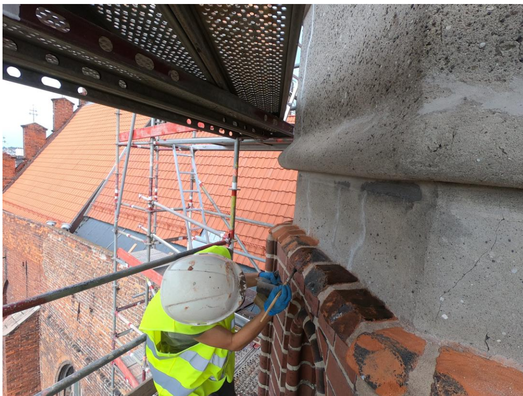
Ilustracja 49. Scalanie kolorystyczne uzupełnień.
