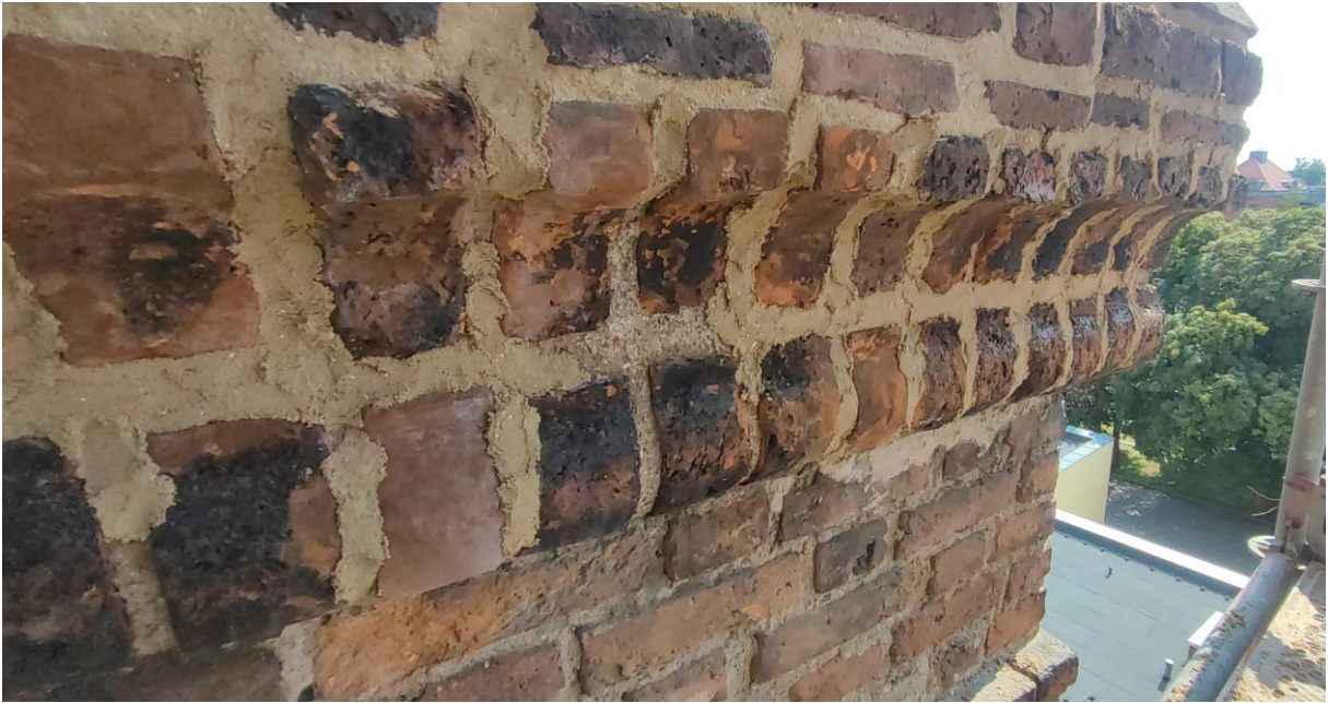
Ilustracja 46. Stan bezpośrednio po spoinowaniu, przed usunięciem nadmiaru zaprawy.
