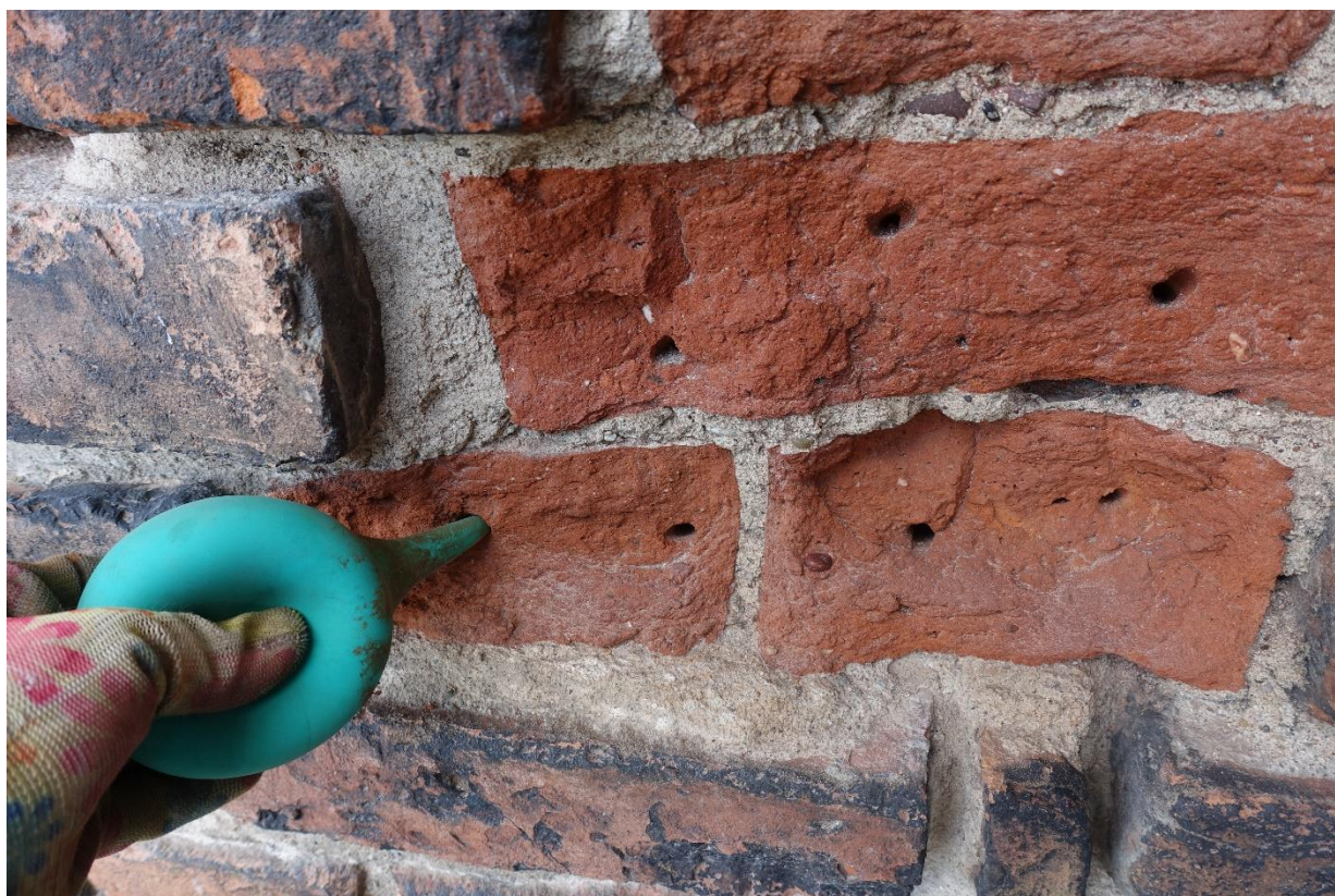
Ilustracja 30. Wzmacnianie osłabionych cegieł preparatem KSE 300.
