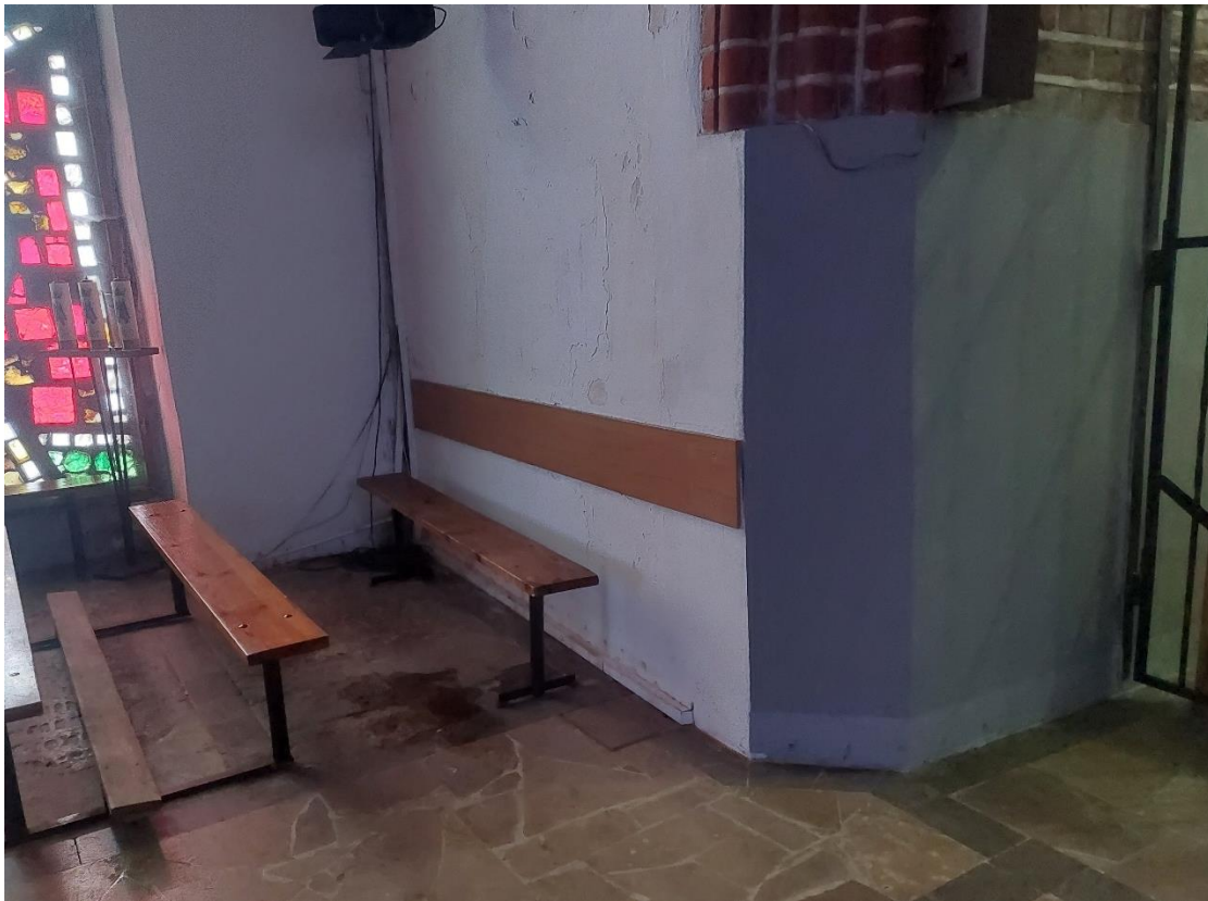
Ilustracja 65. Obiekt po zakończeniu prac (izolacja przeciwwilgociowa)
