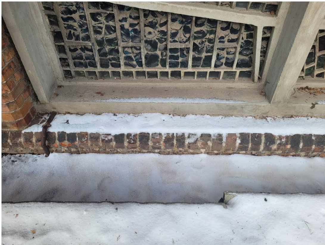
Ilustracja 60. Obiekt po zakończeniu prac (izolacja przeciwwilgociowa)
