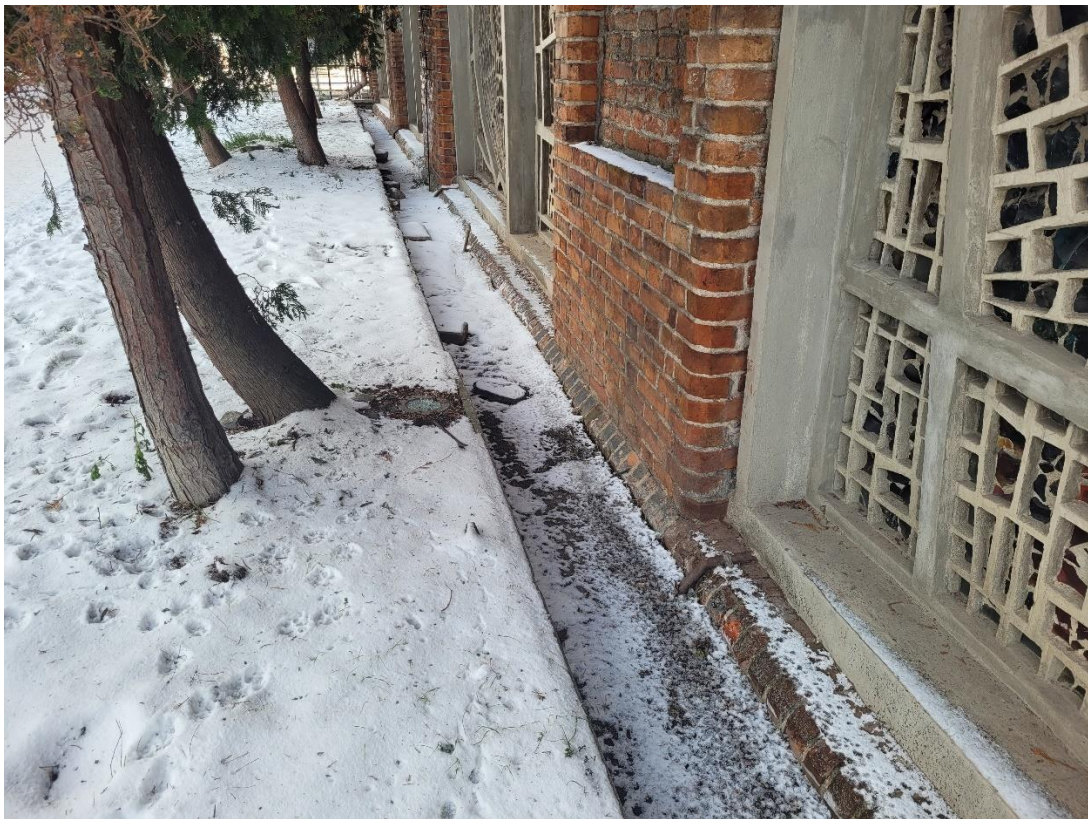
Ilustracja 56. Obiekt po zakończeniu prac (izolacja przeciwwilgociowa)
