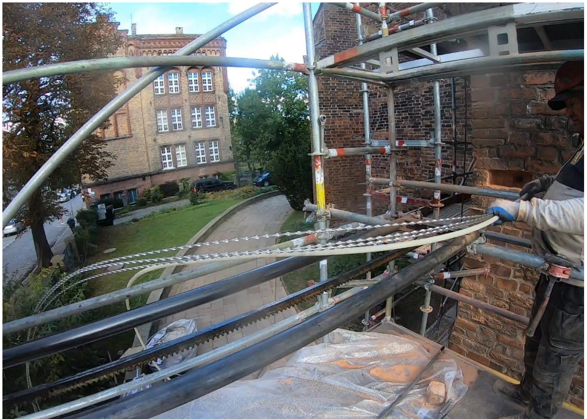
Ilustracja 31. Wprowadzanie wiązki trzech prętów spiralnych
