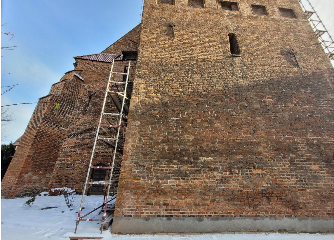
Ilustracja 49. Obiekt po zakończeniu prac (wzmocnienie rdzeniowe)
