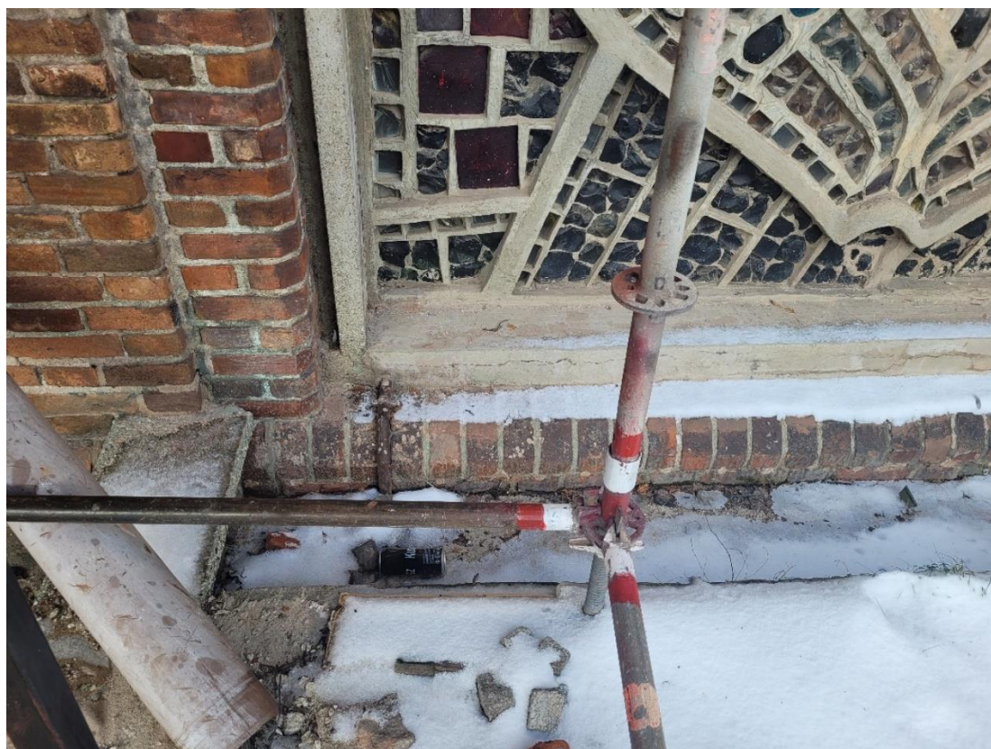
Ilustracja 64. Obiekt po zakończeniu prac (izolacja przeciwwilgociowa)
