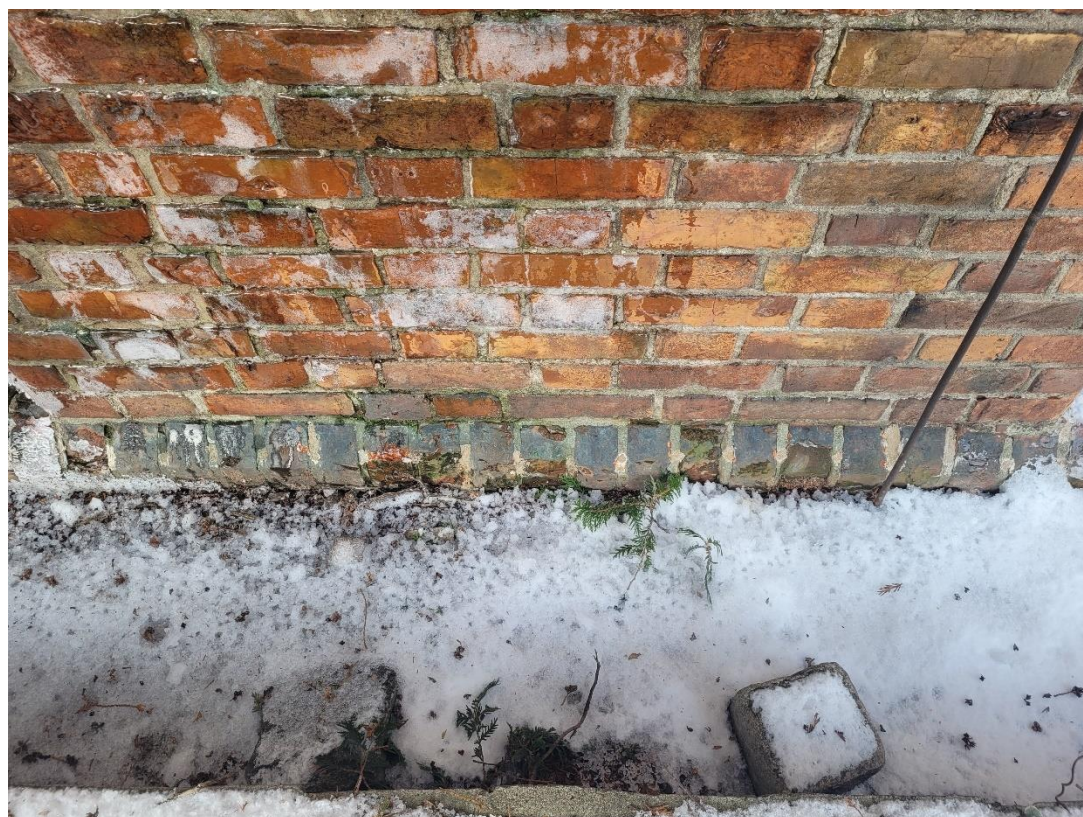
Ilustracja 58. Obiekt po zakończeniu prac (izolacja przeciwwilgociowa)
