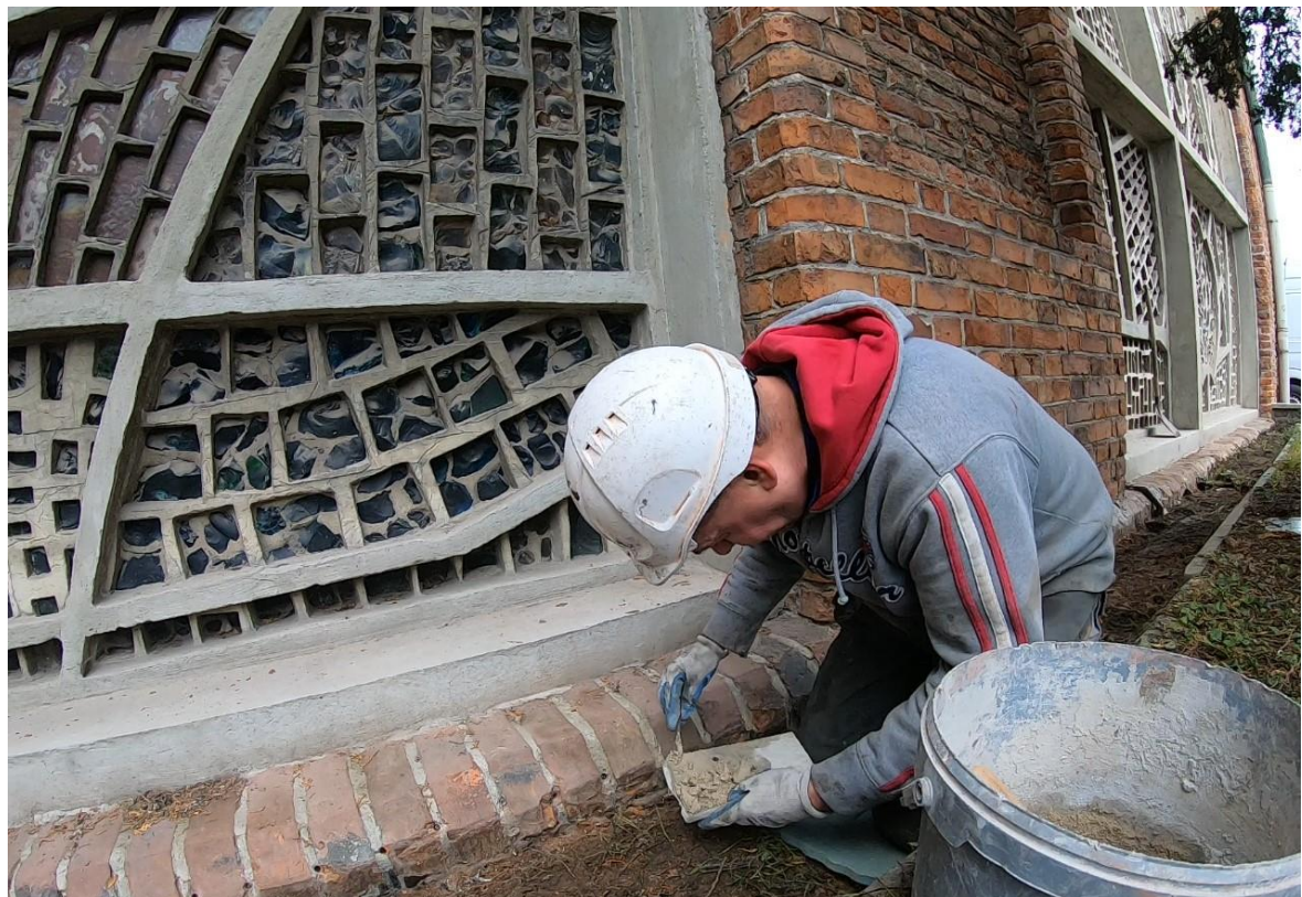
Ilustracja 45. Zabezpieczanie otworów zaprawą
