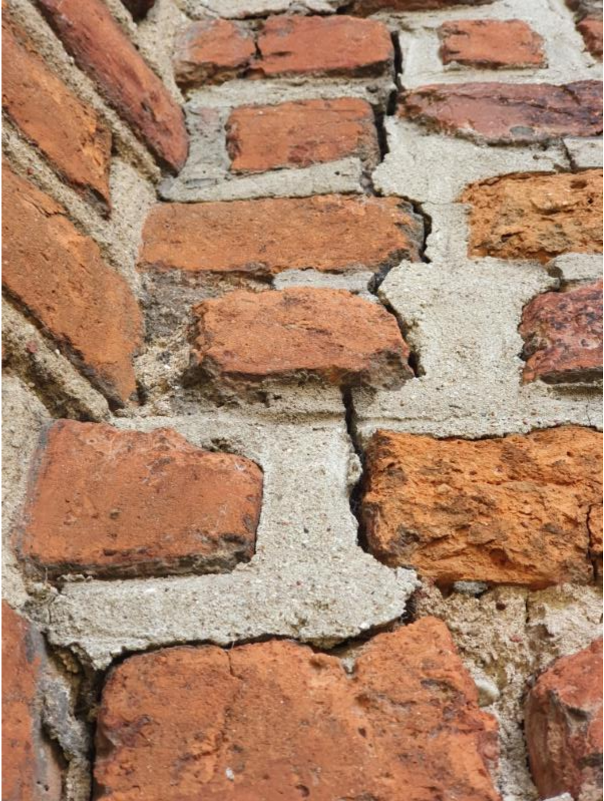
Ilustracja 16. Spękania murów
