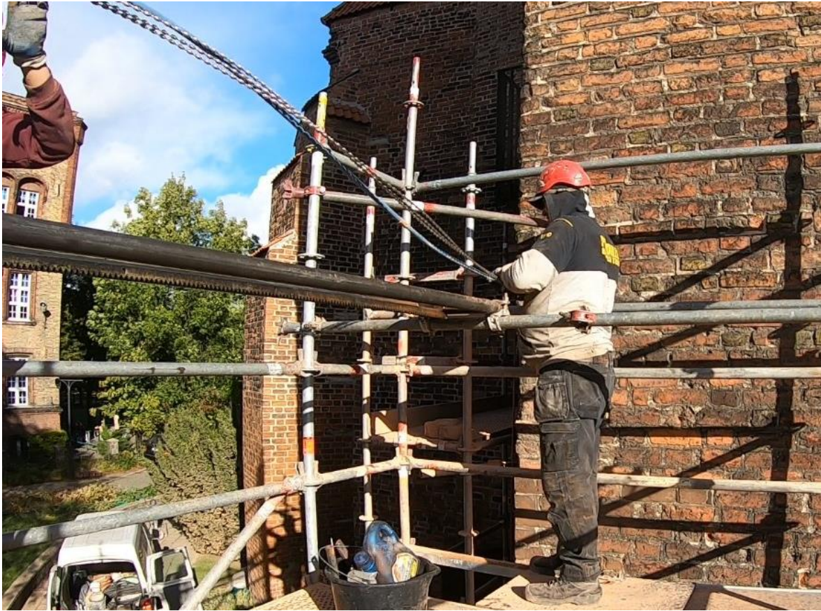
Ilustracja 32. Wprowadzanie wiązki trzech prętów spiralnych
