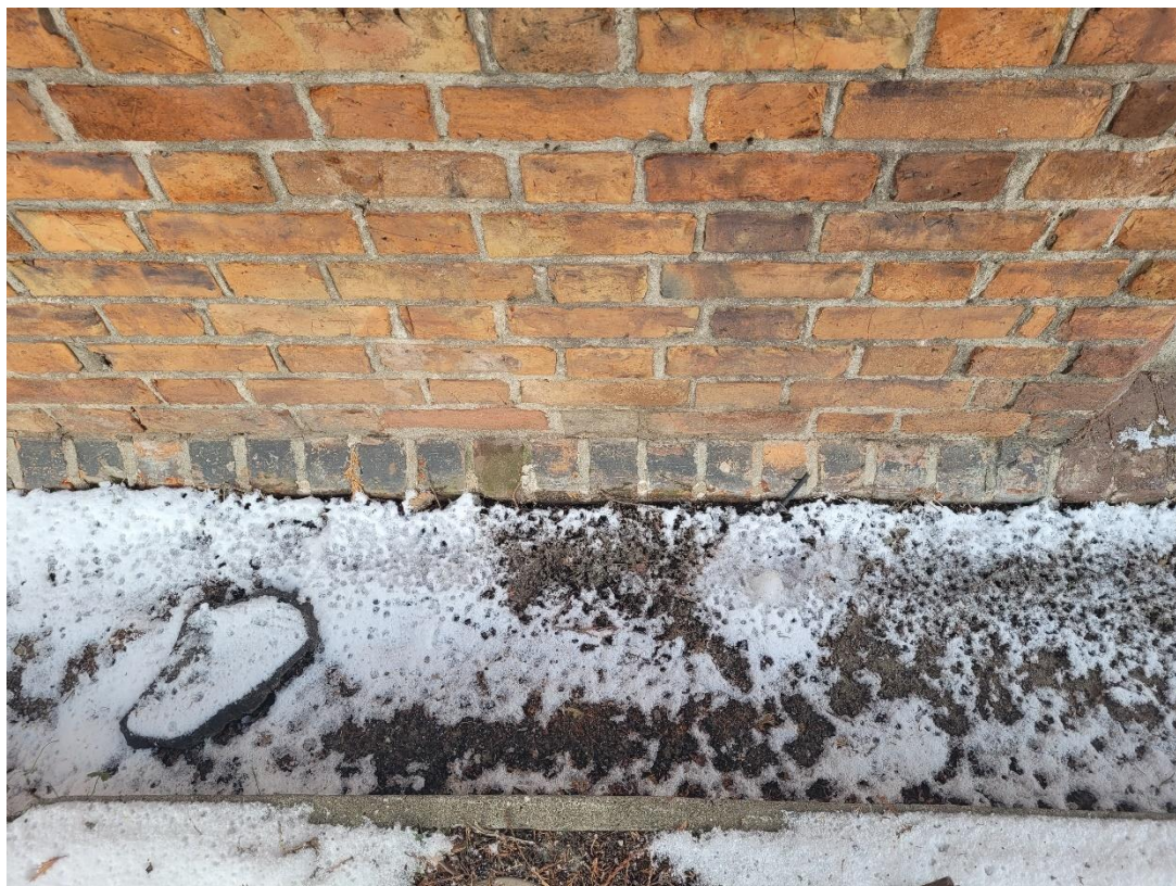
Ilustracja 57. Obiekt po zakończeniu prac (izolacja przeciwwilgociowa)
