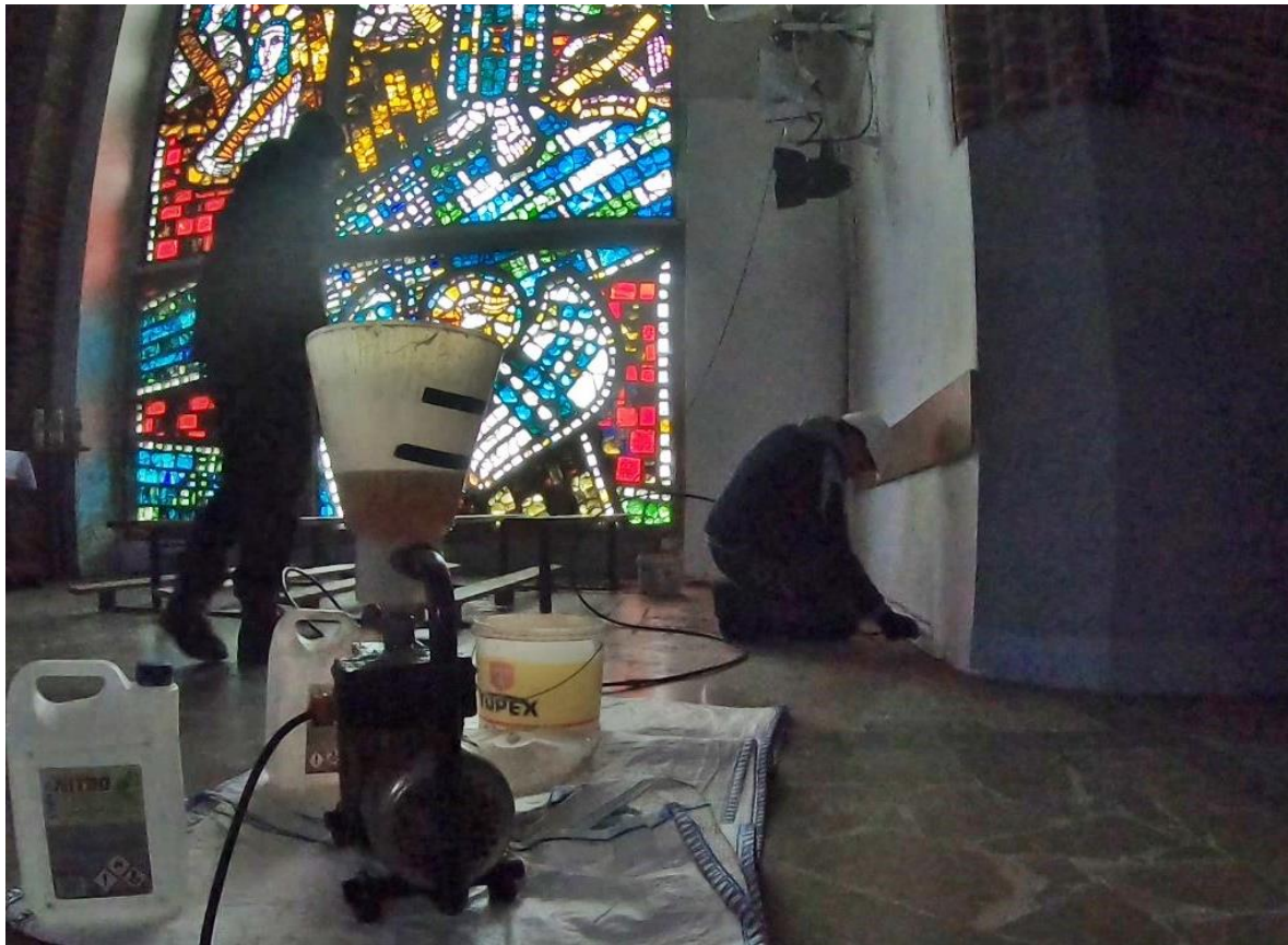
Ilustracja 44. Aplikacja środka iniekcyjnego
