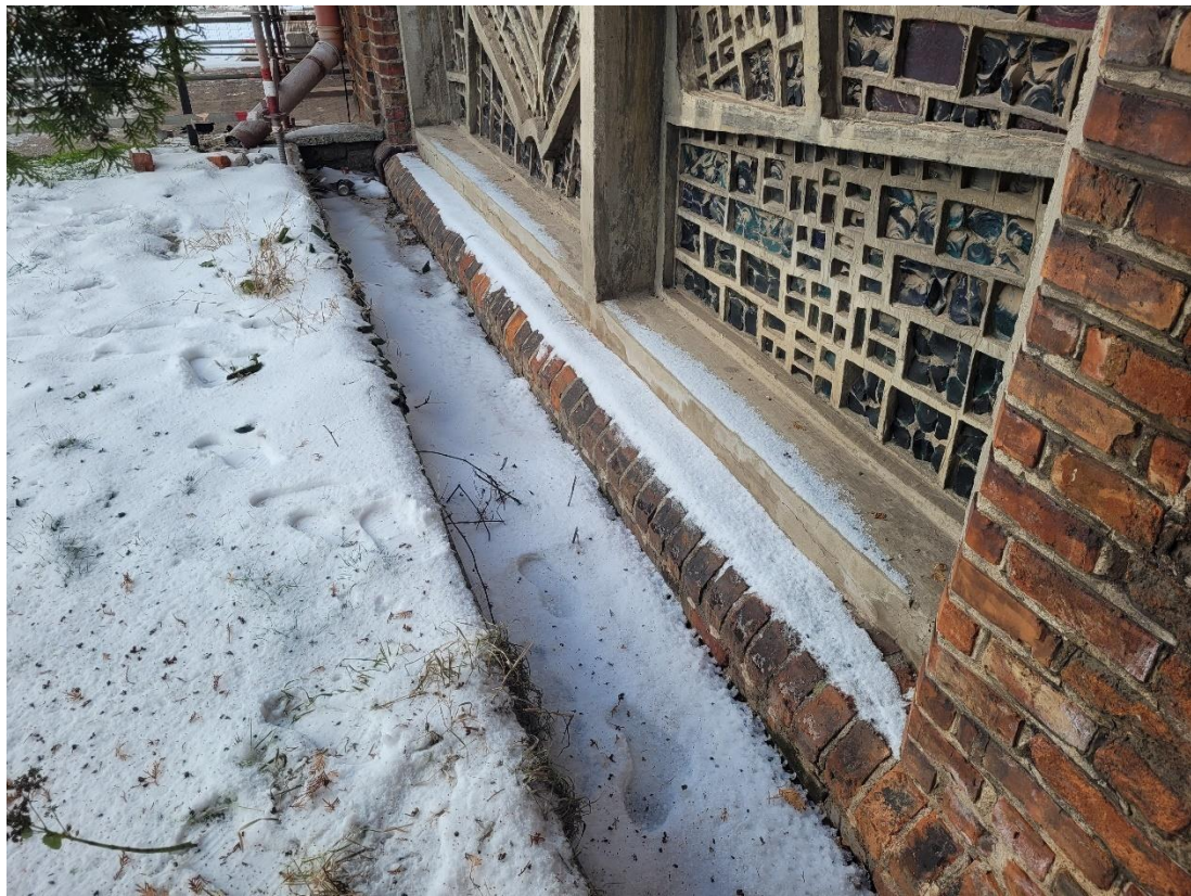
Ilustracja 62. Obiekt po zakończeniu prac (izolacja przeciwwilgociowa)
