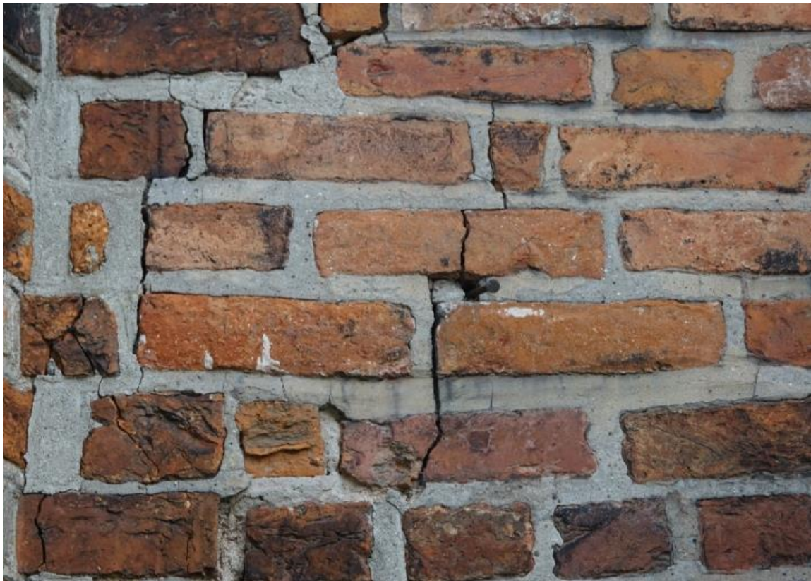
Ilustracja 15. Spękania murów
