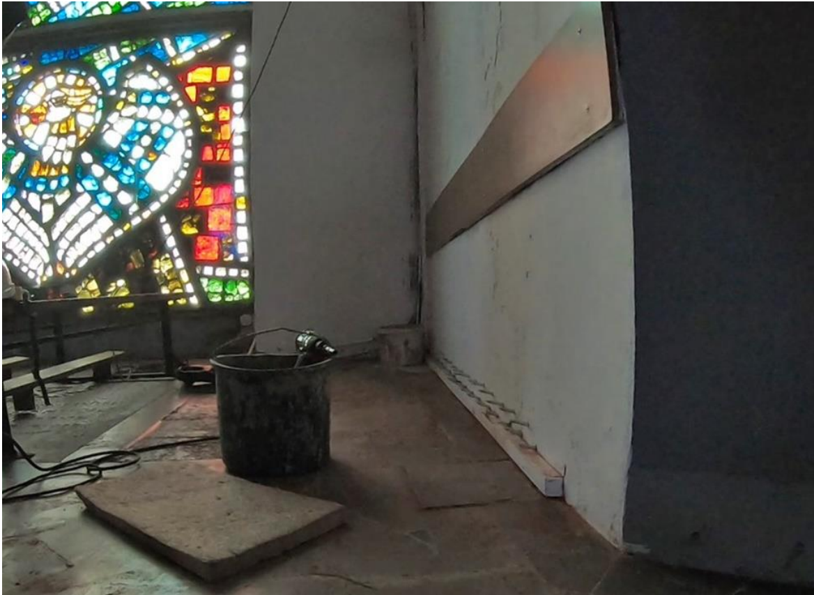
Ilustracja 38. Osadzenie iniektorów w odwiertach
