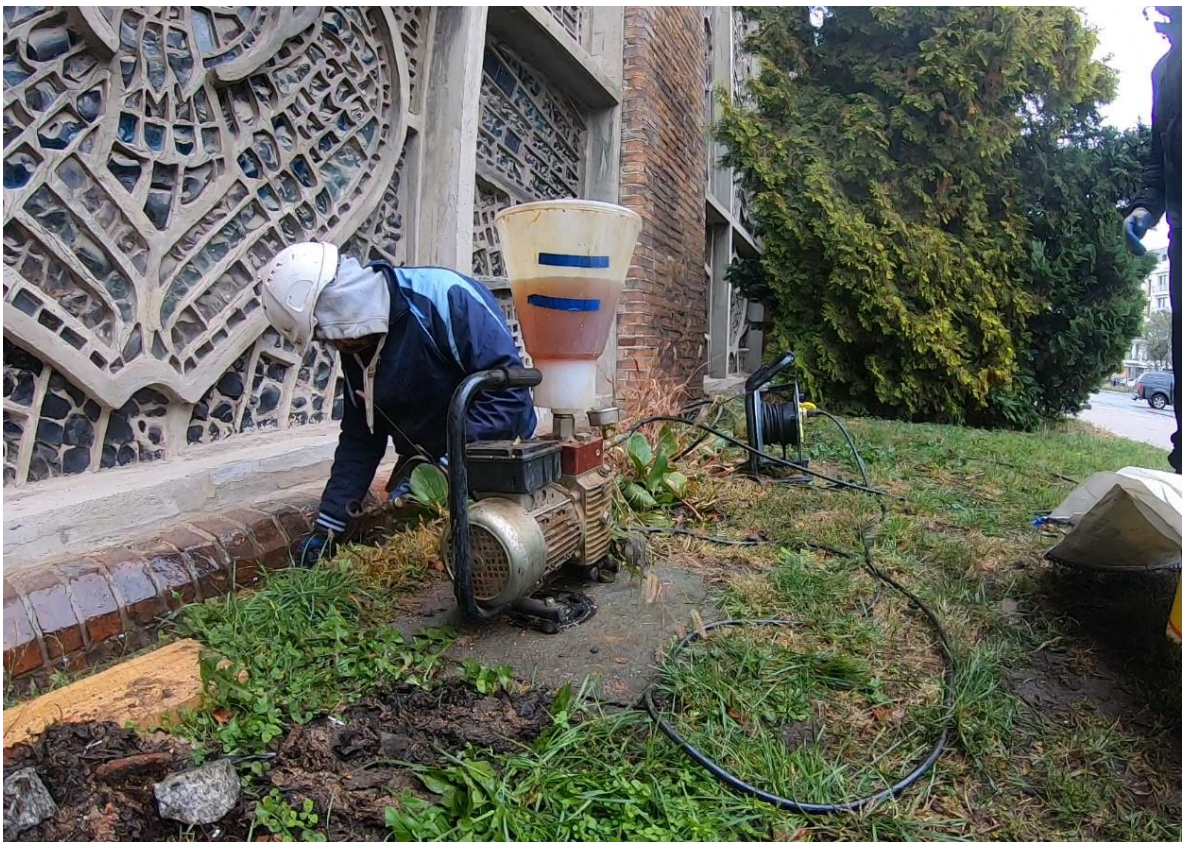
Ilustracja 43. Aplikacja środka iniekcyjnego
