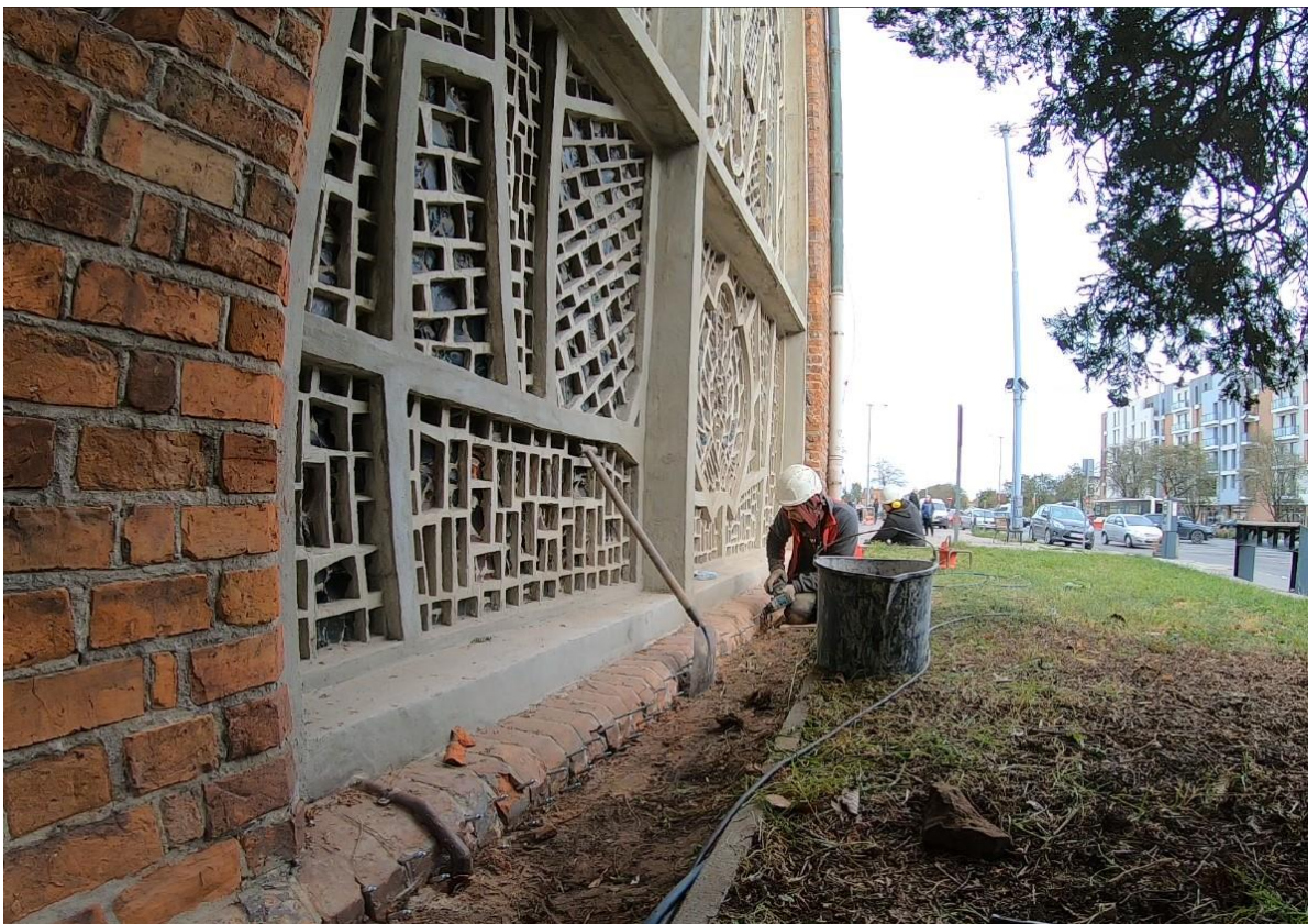
Ilustracja 37. Osadzanie iniektorów w odwiertach
