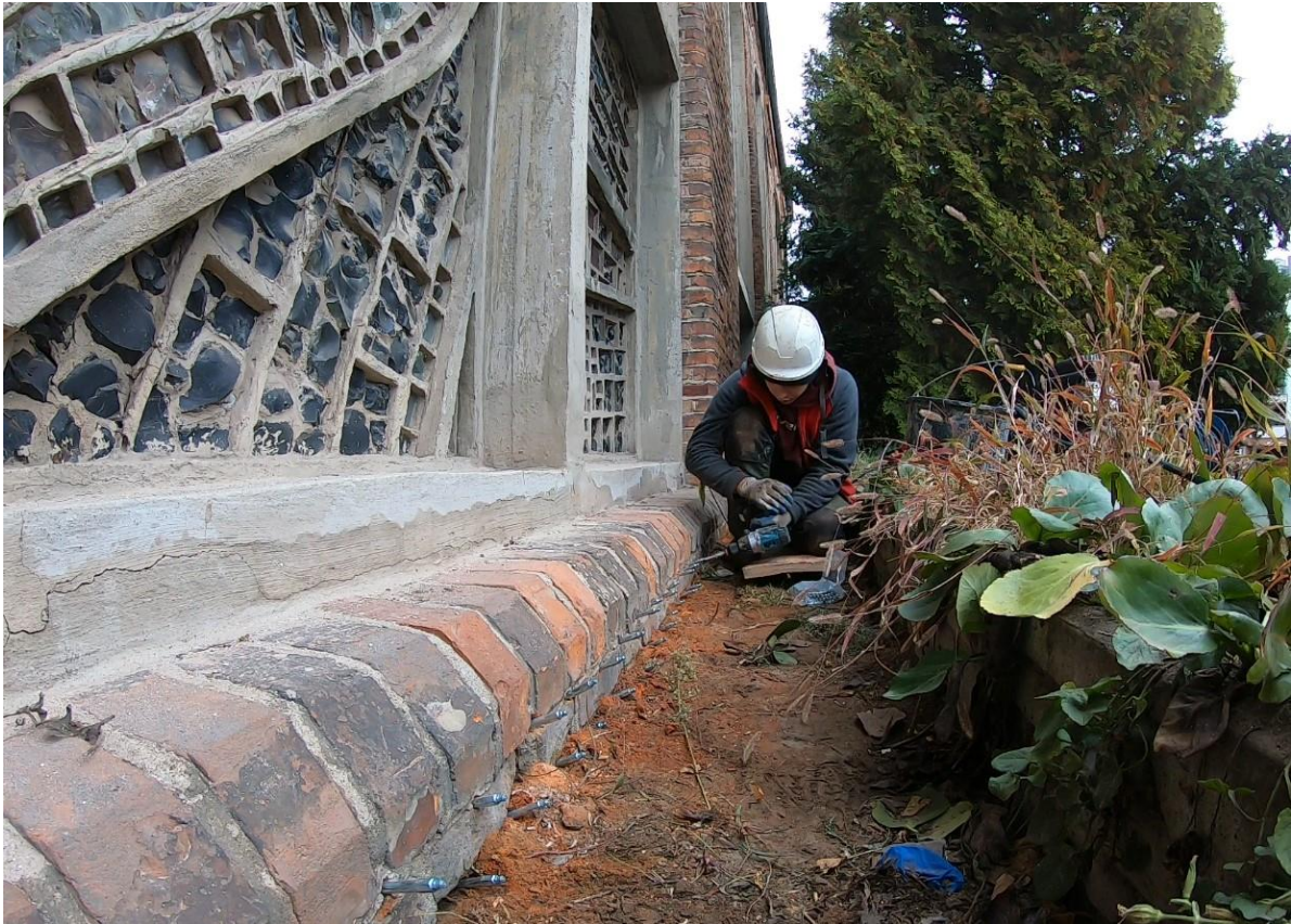
Ilustracja 36. Osadzanie iniektorów w odwiertach
