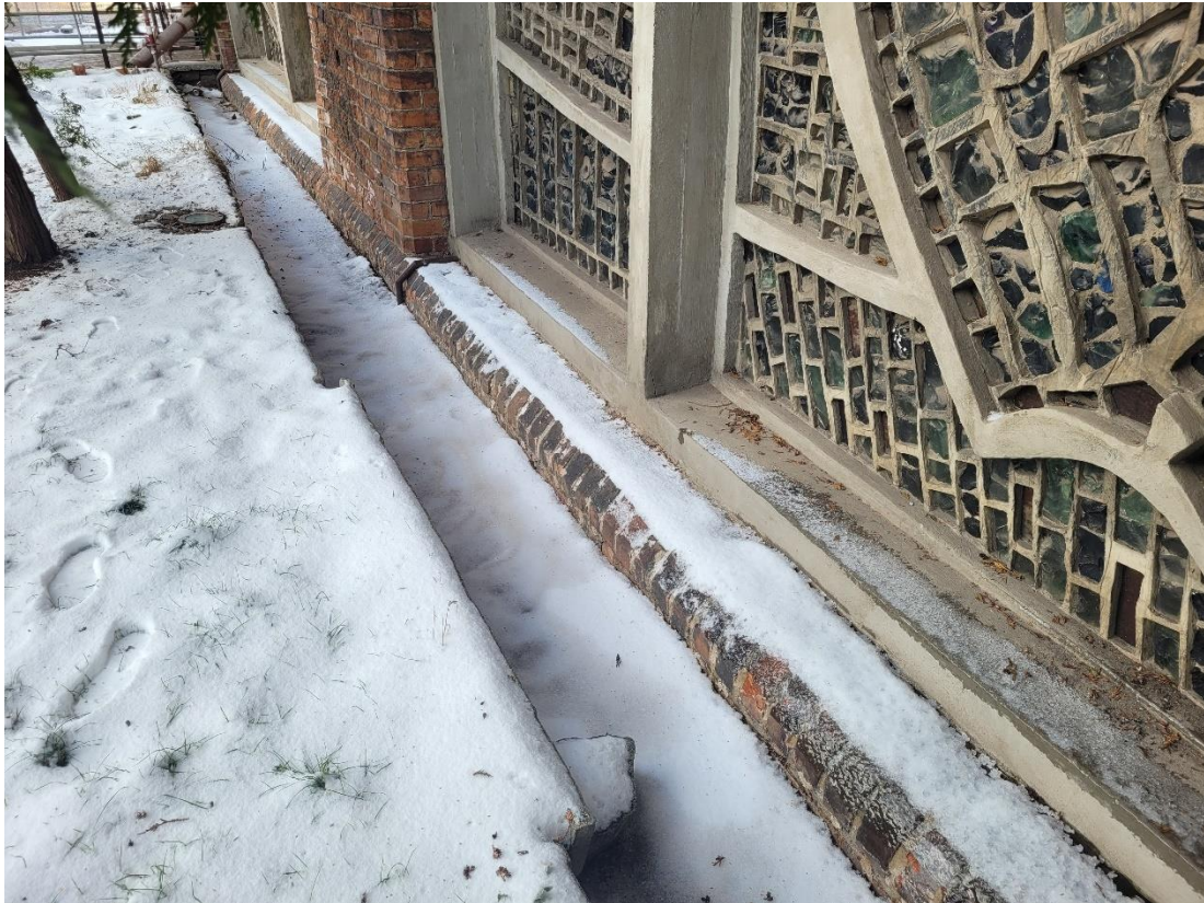
Ilustracja 59. Obiekt po zakończeniu prac (izolacja przeciwwilgociowa)
