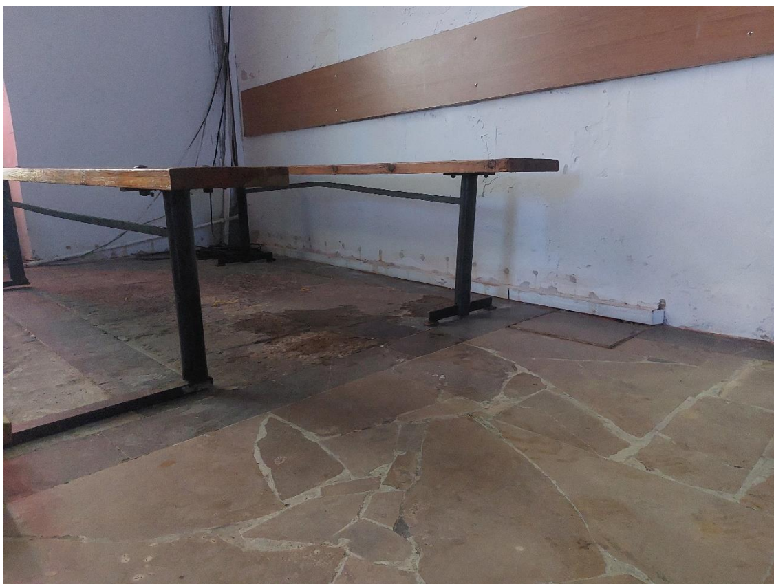
Ilustracja 66. Obiekt po zakończeniu prac (izolacja przeciwwilgociowa)
