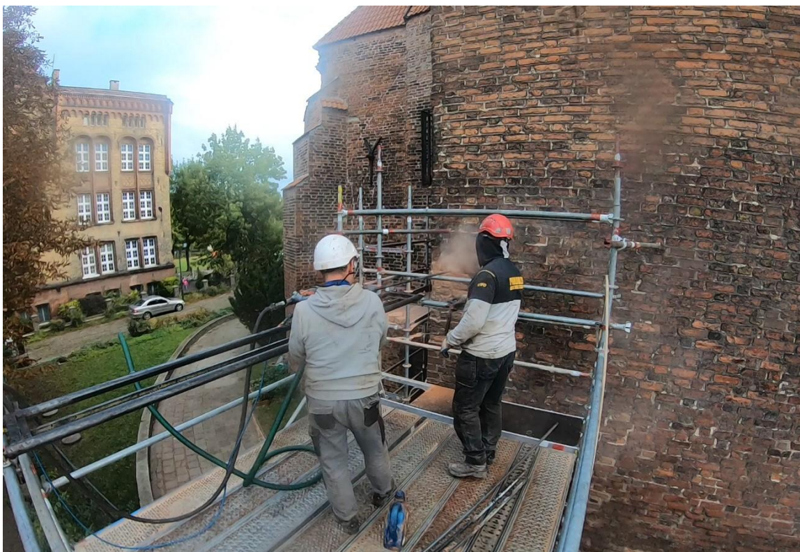
Ilustracja 27. Wykonywanie odwiertu w strefie rdzeniowej muru
