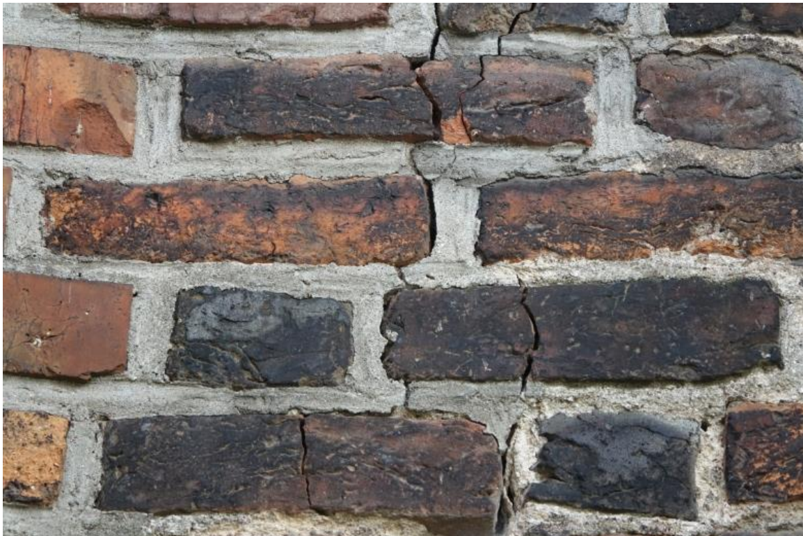
Ilustracja 17. Spękania murów
