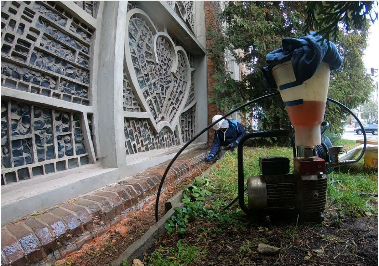
Ilustracja 42. Aplikacja środka iniekcyjnego
