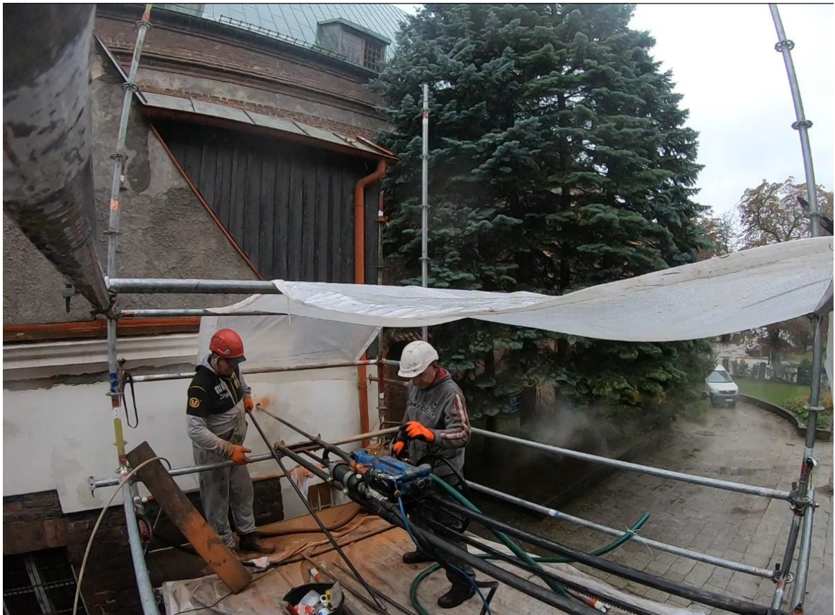
Ilustracja 28. Wykonywanie odwiertu w strefie rdzeniowej muru
