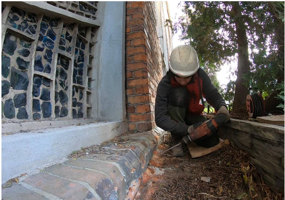
Ilustracja 33. Nawiercanie otworów pod iniektory
