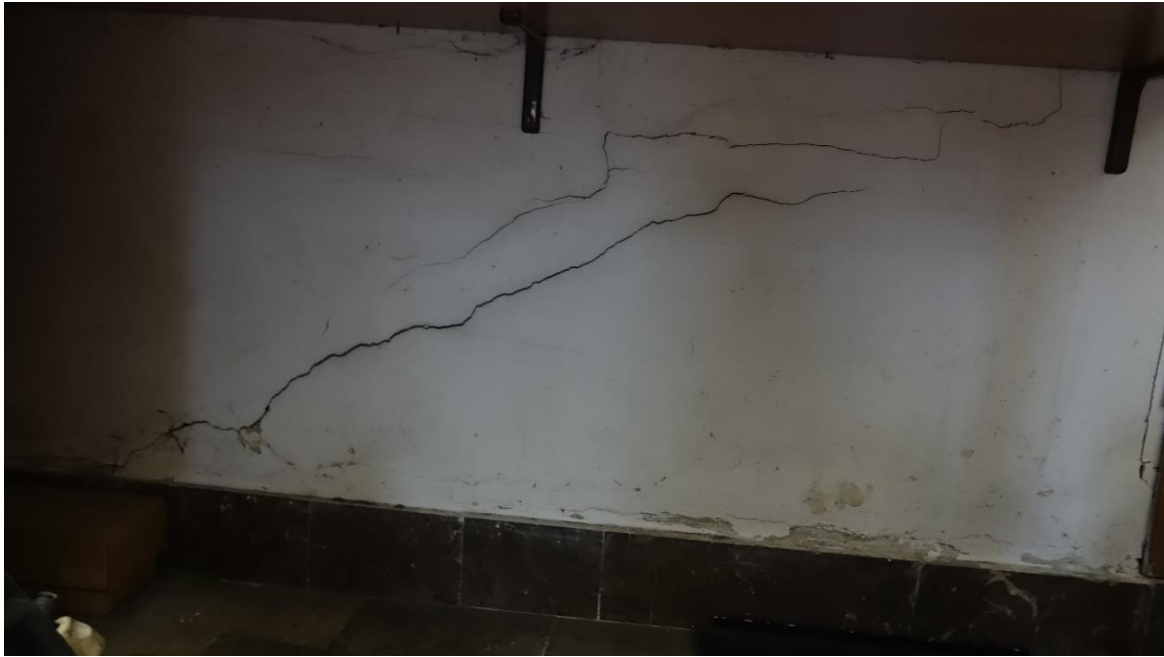
Ilustracja 14. Spękania ścian
