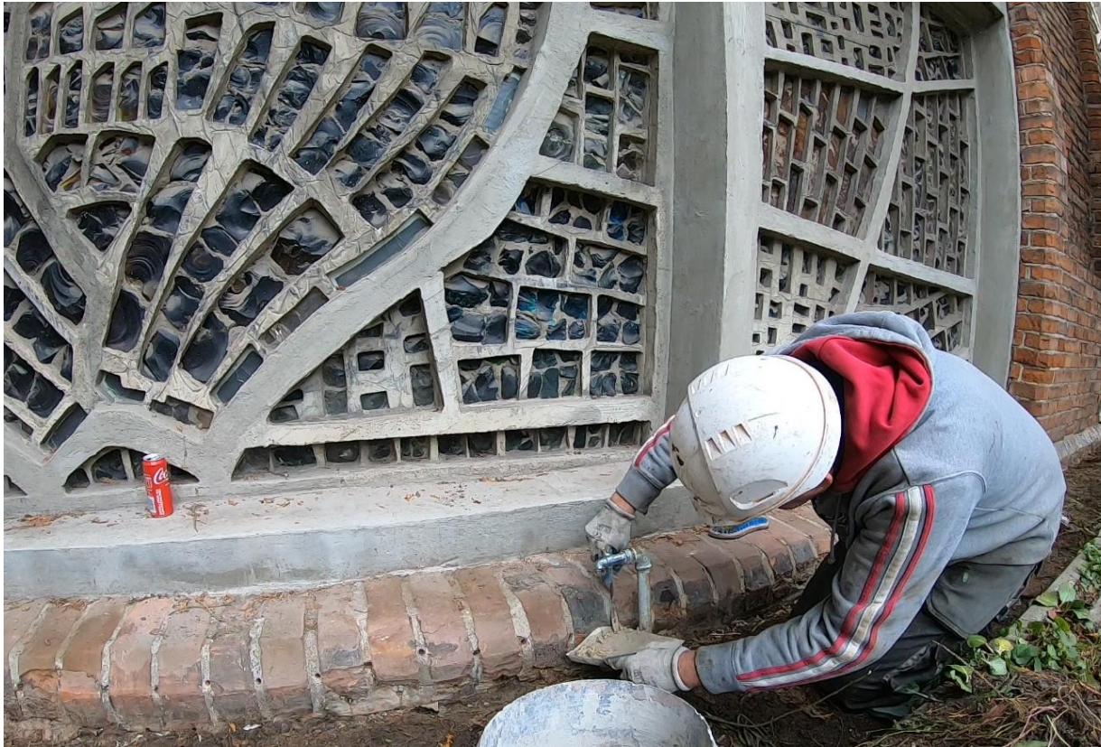
Ilustracja 46. Zabezpieczanie otworów zaprawą
