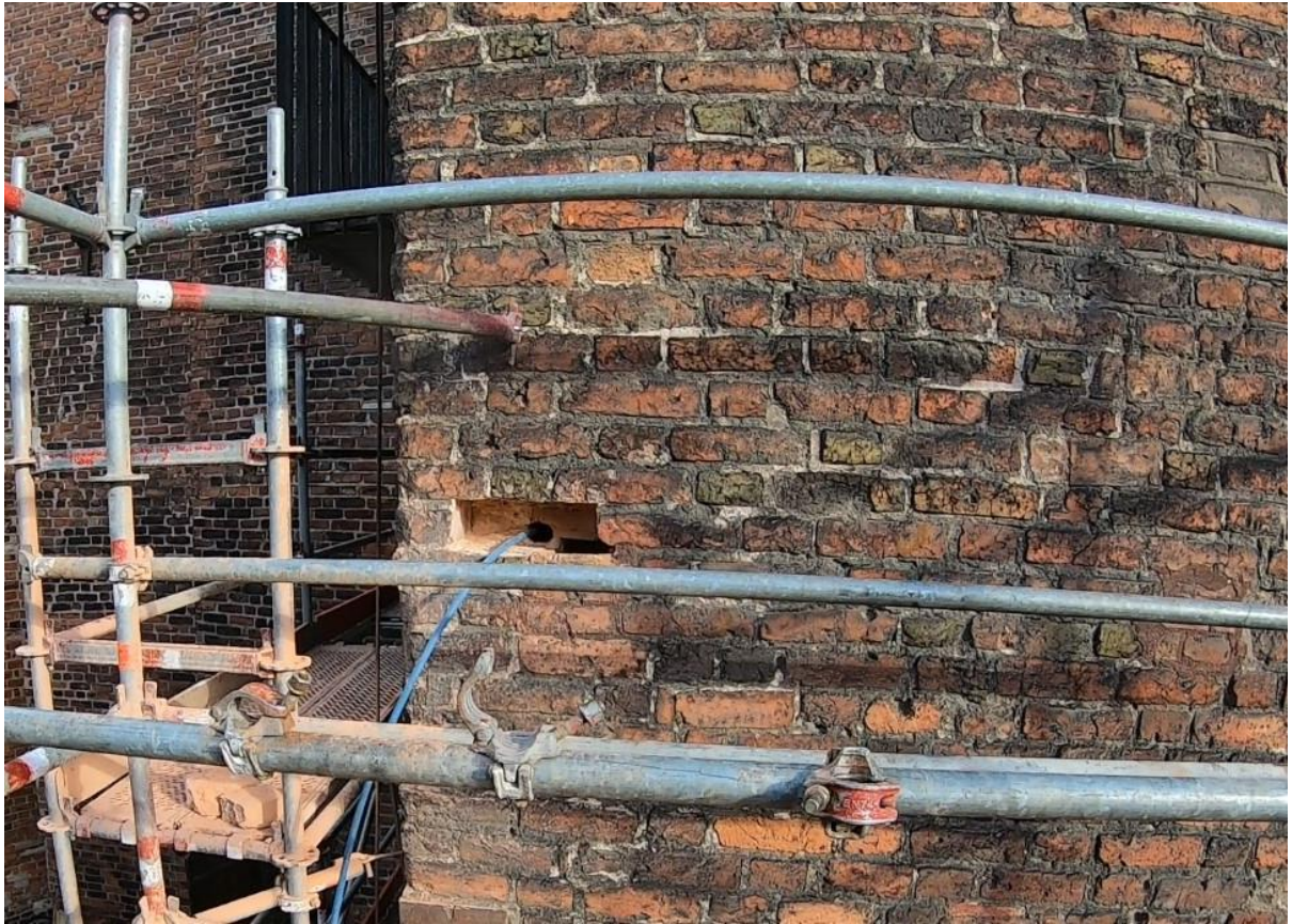
Ilustracja 30. Otwór przygotowany do wprowadzenie wiązki trzech prętów spiralnych
