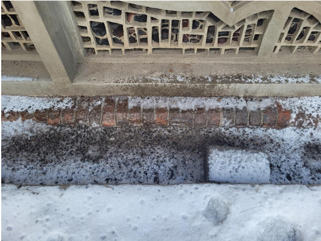
Ilustracja 55. Obiekt po zakończeniu prac (izolacja przeciwwilgociowa)
