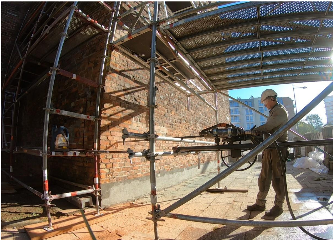
Ilustracja 26. Wykonywanie odwiertu w strefie rdzeniowej muru
