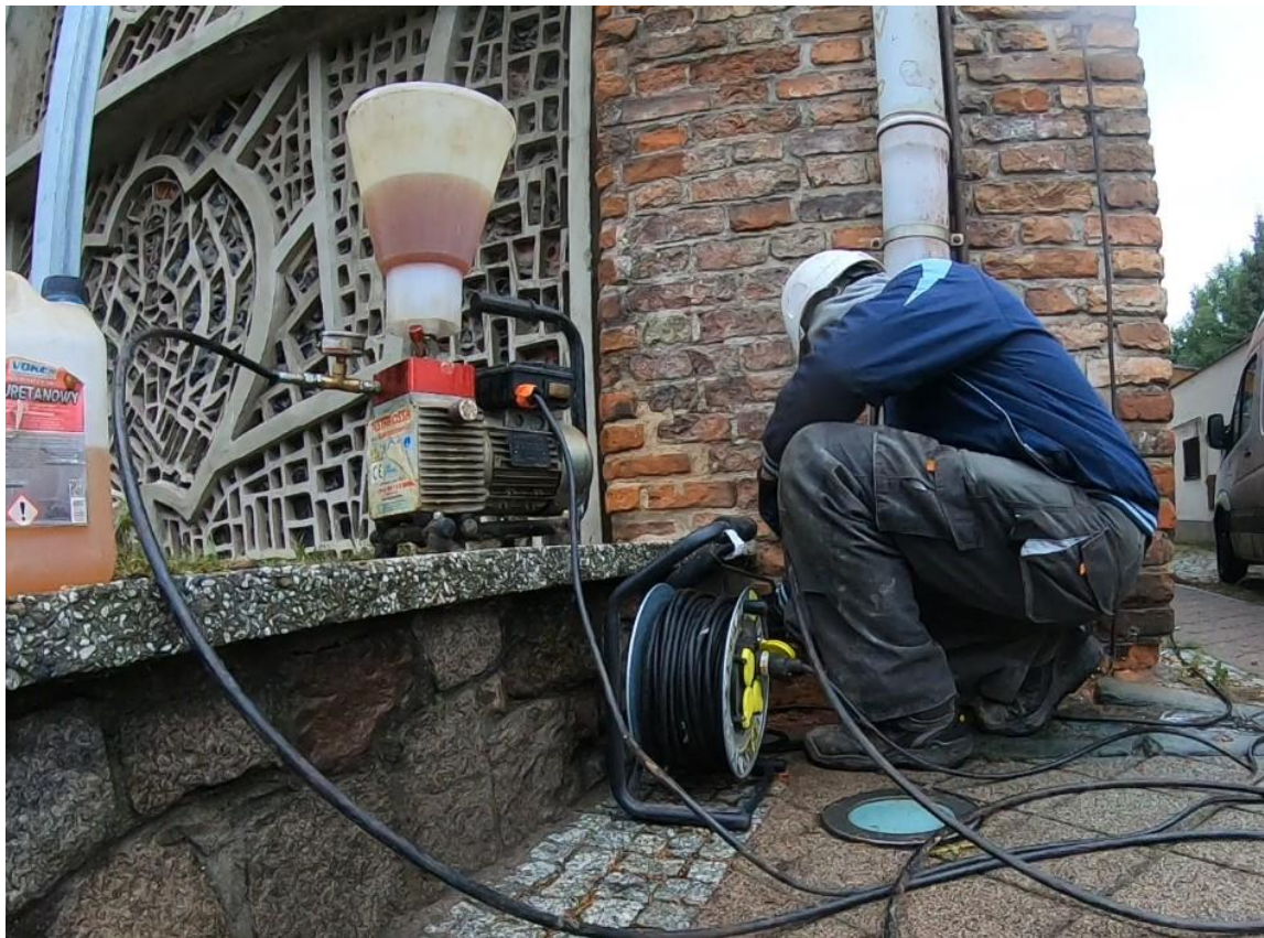
Ilustracja 39. Aplikacja środka iniekcyjnego
