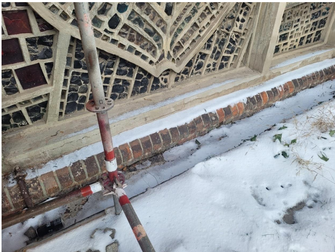
Ilustracja 63. Obiekt po zakończeniu prac (izolacja przeciwwilgociowa)
