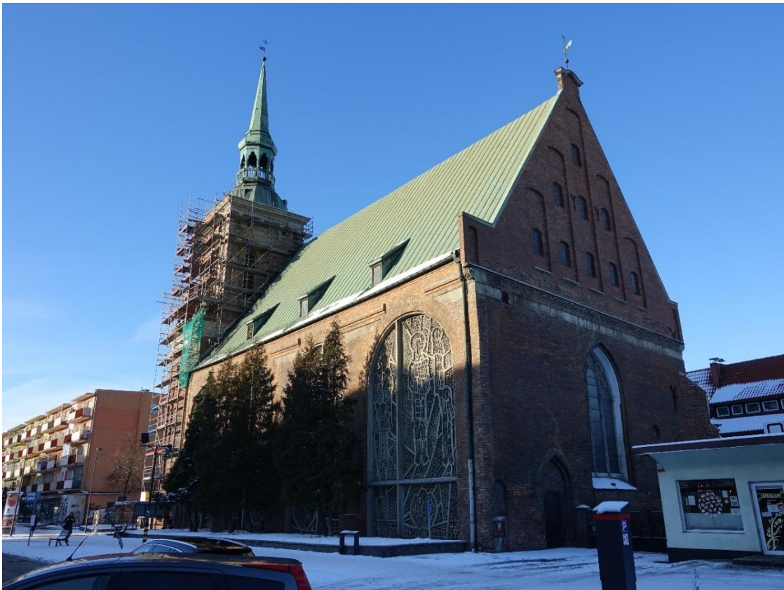
Ilustracja 52. Obiekt po zakończeniu prac
