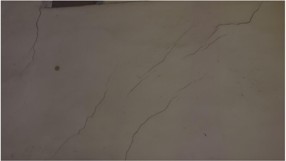
Ilustracja 12. Spękania ścian
