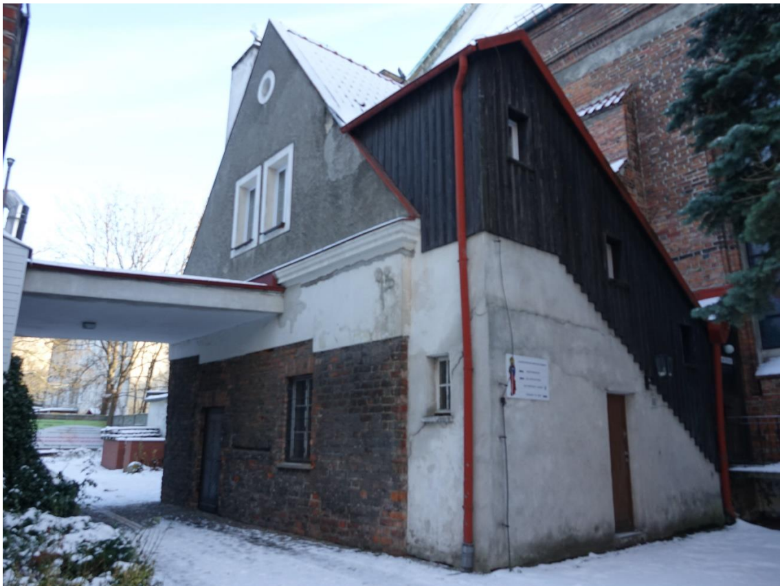
Ilustracja 50. Obiekt po zakończeniu prac (wzmocnienie rdzeniowe)
