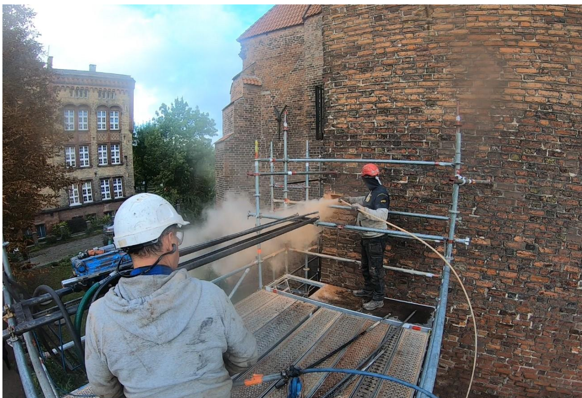
Ilustracja 29. Oczyszczanie otworów z materiałów luźnych
