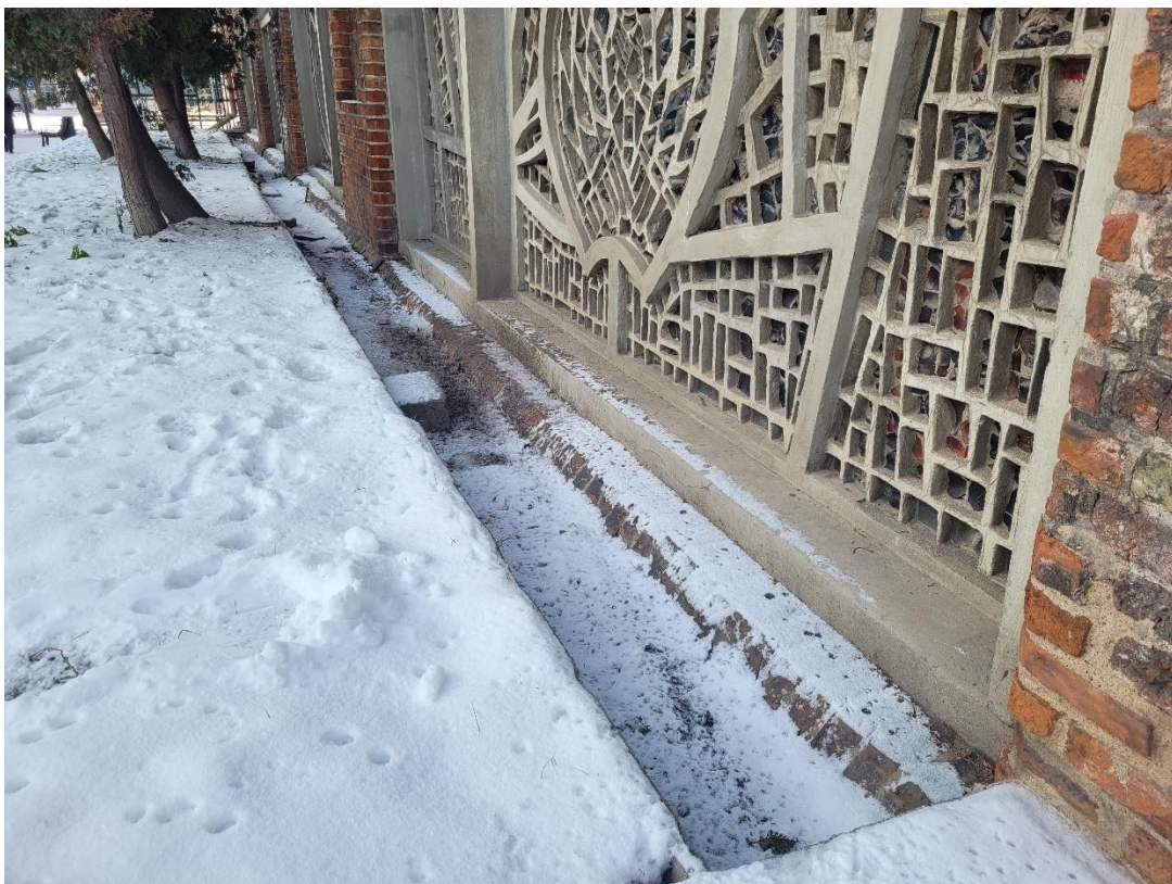
Ilustracja 54. Obiekt po zakończeniu prac (izolacja przeciwwilgociowa)
