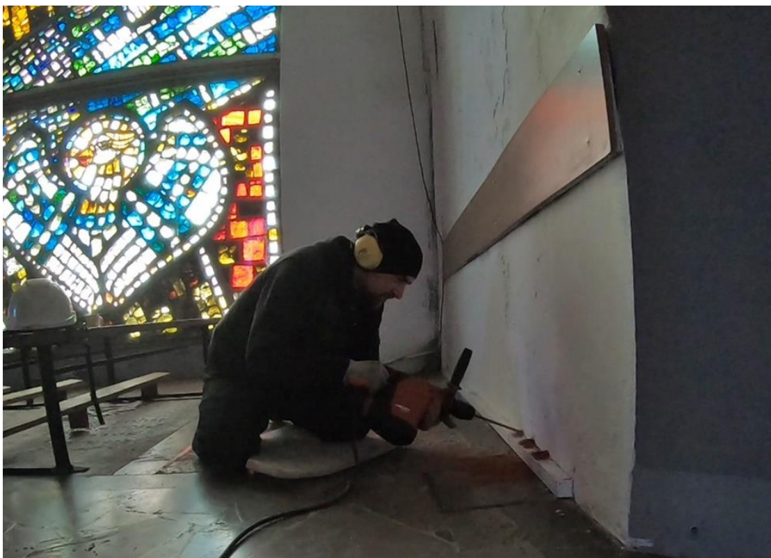
Ilustracja 35. Nawiercanie otworów pod iniektory
