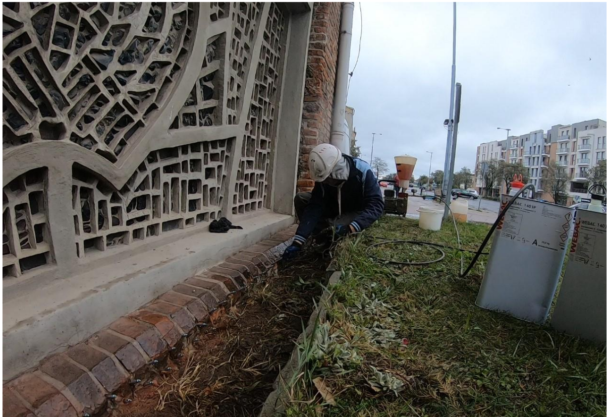
Ilustracja 40. Aplikacja środka iniekcyjnego
