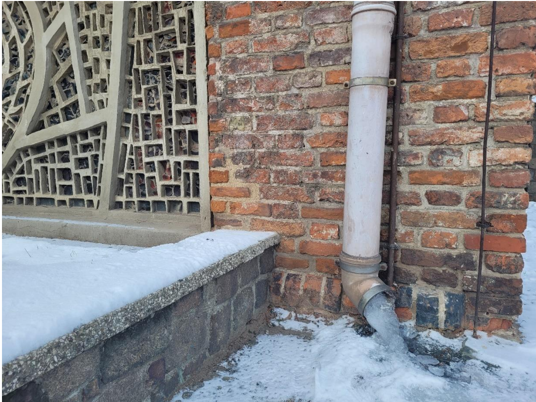
Ilustracja 53. Obiekt po zakończeniu prac (izolacja przeciwwilgociowa)
