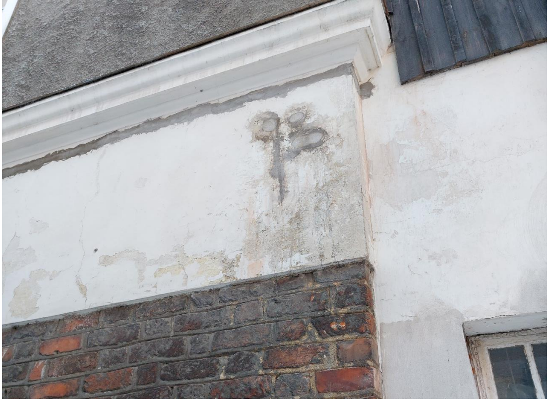
Ilustracja 51. Obiekt po zakończeniu prac (wzmocnienie rdzeniowe)
