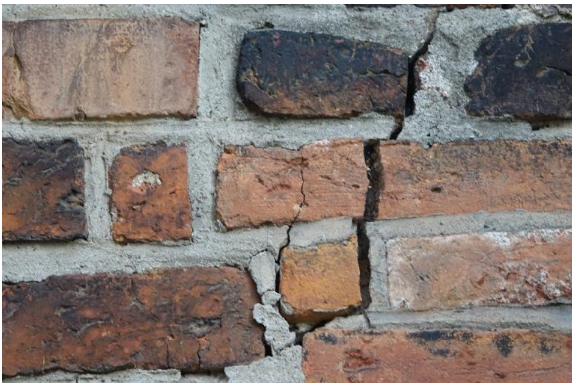
Ilustracja 18. Spękania murów
