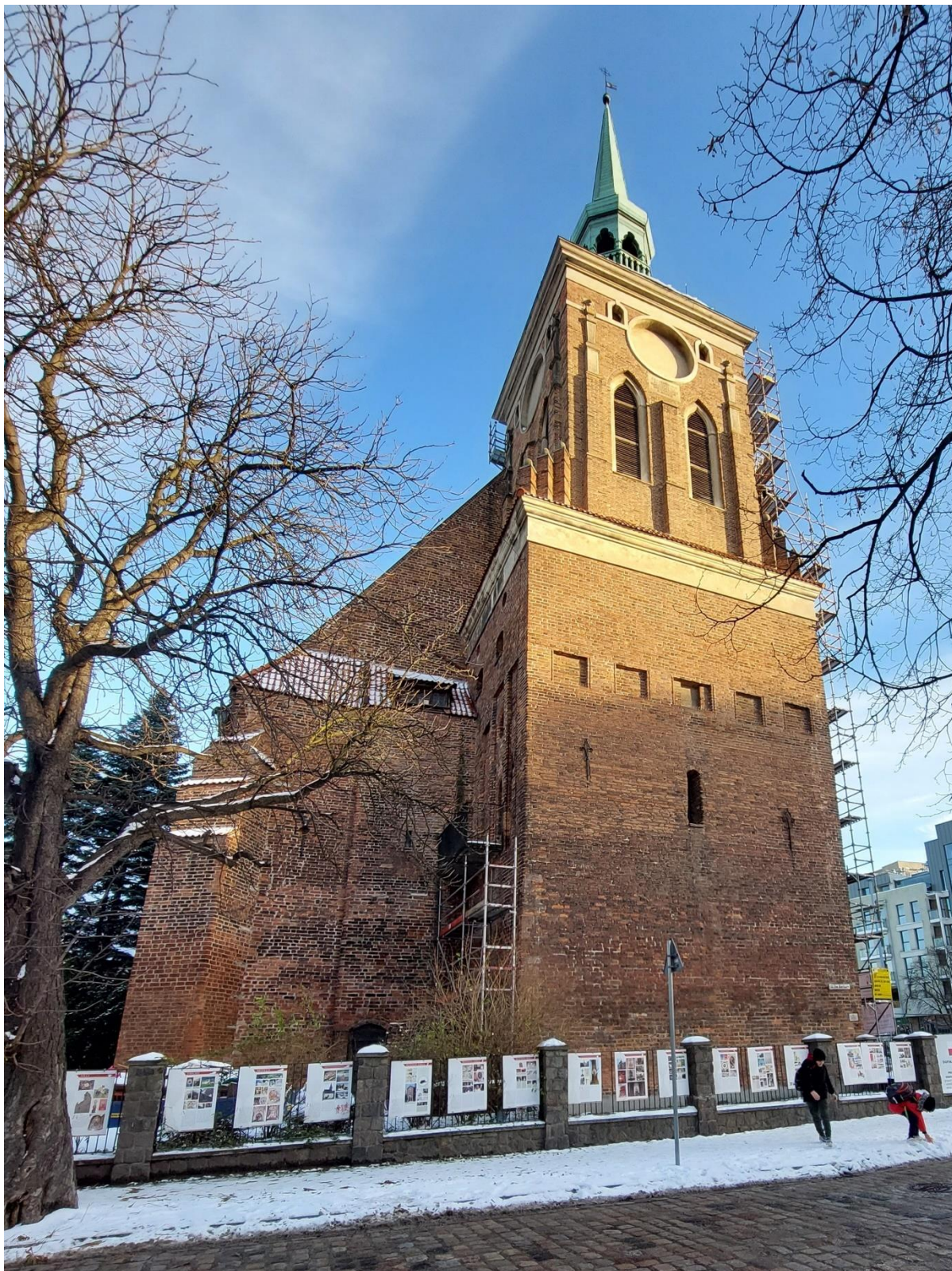
Ilustracja 48. Obiekt po zakończeniu prac
