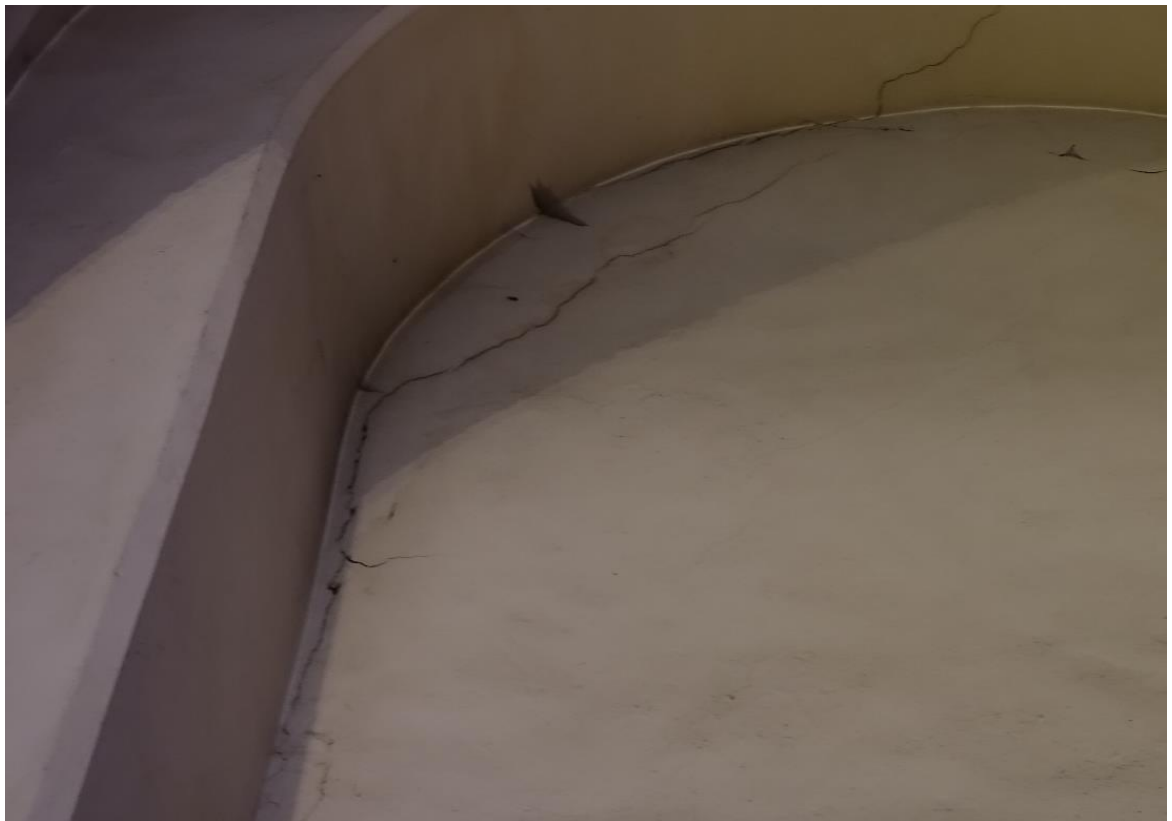
Ilustracja 13. Spękania ścian
