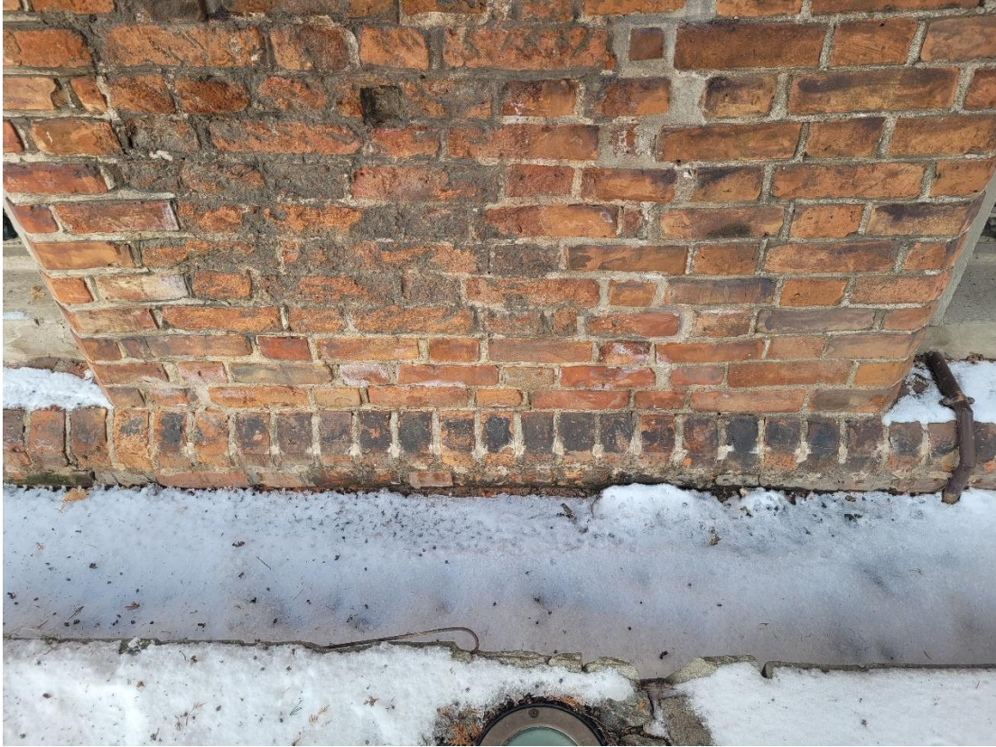
Ilustracja 61. Obiekt po zakończeniu prac (izolacja przeciwwilgociowa)
