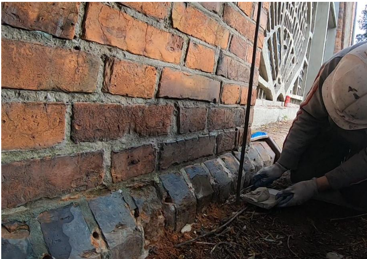
Ilustracja 47. Zabezpieczanie otworów zaprawą
