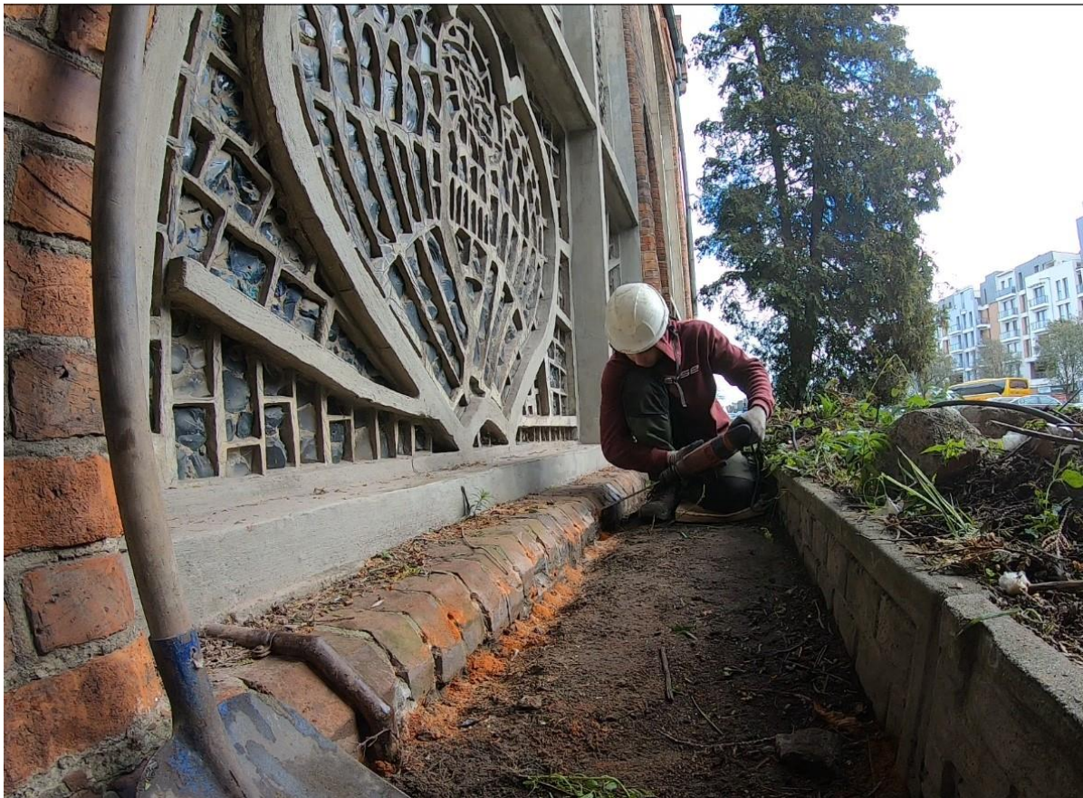
Ilustracja 34. Nawiercanie otworów pod iniektory
