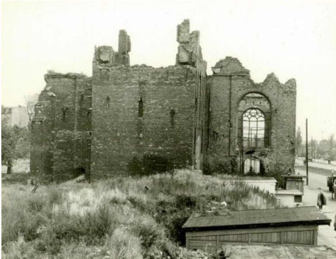
Ilustracja 8. Stan wieży i korpusu kościoła po zniszczeniach z 1945 r. [źródło: Gdańsk historyczny]
