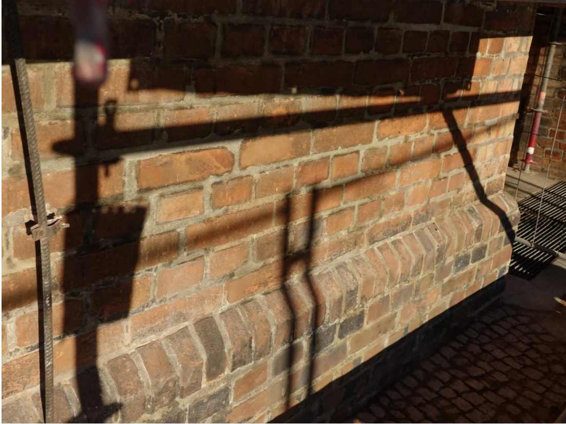
Ilustracja 77. Obiekt po zakończeniu prac
