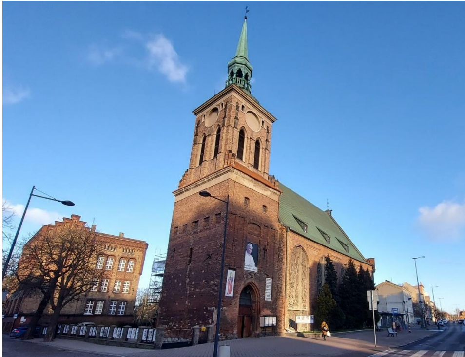
Ilustracja 10. Kościół pw. św. Barbary. Widok ogólny od strony południowo-zachodniej
