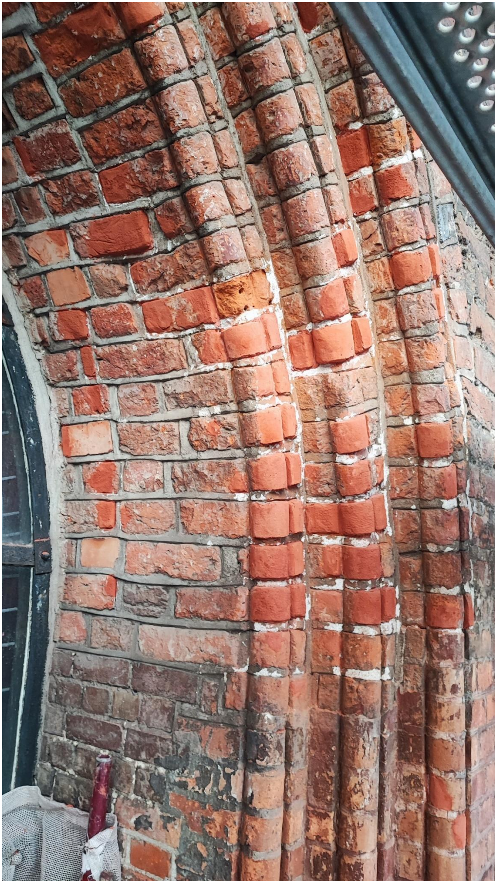
Ilustracja 52. W trakcie uzupełniania ubytków kształtek ceramicznych
