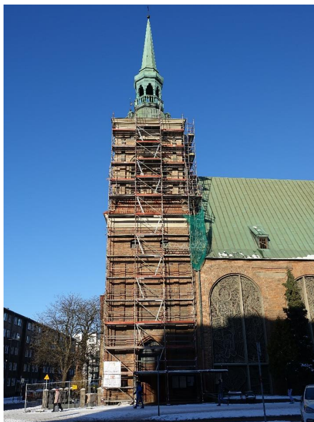
Ilustracja 58. Obiekt po zakończeniu prac
