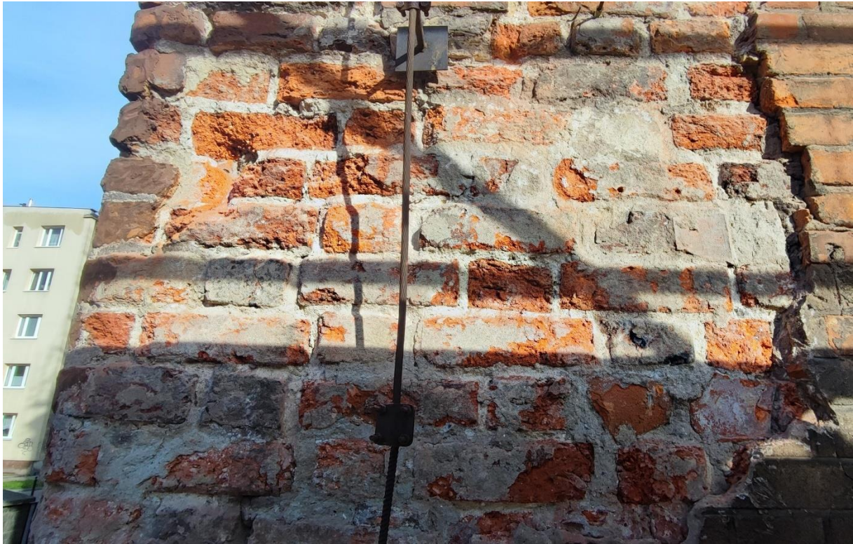
Ilustracja 41. Stan elewacji po usunięciu betonowych uzupełnień w cegle z okresu powojennych prac konserwatorskich
