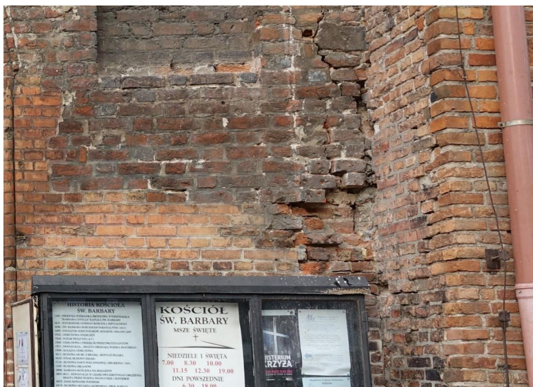
Ilustracja 23. Uszkodzenia elewacji
