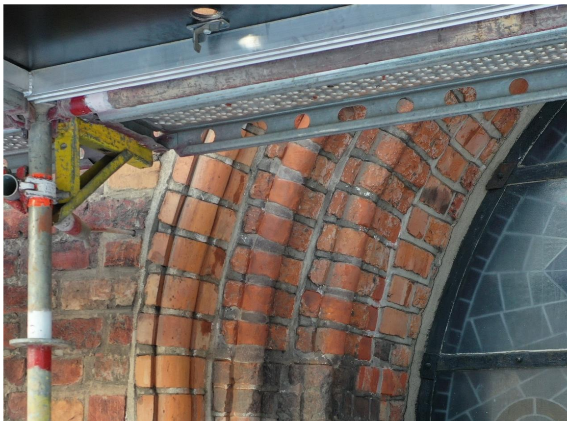
Ilustracja 66. Obiekt po zakończeniu prac
