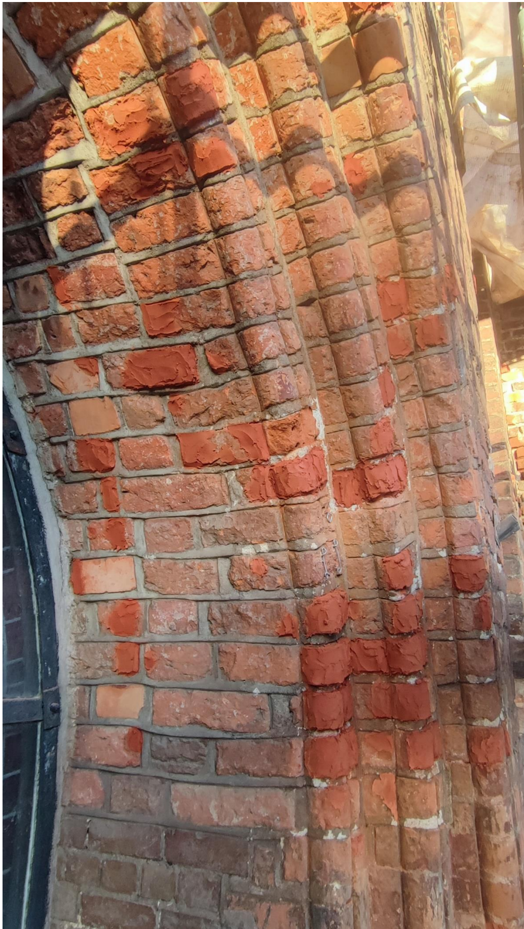
Ilustracja 51. W trakcie uzupełniania ubytków kształtek ceramicznych
