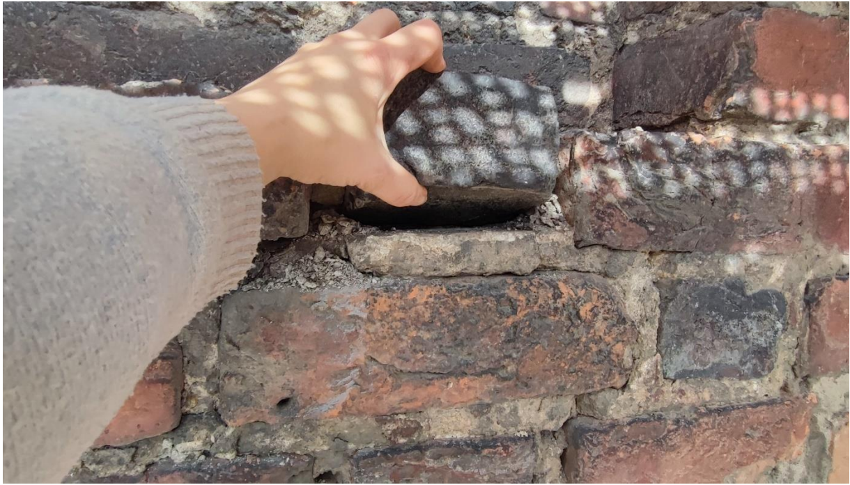
Ilustracja 36. Demontaż luźnych elementów, które powodowały zagrożenie
