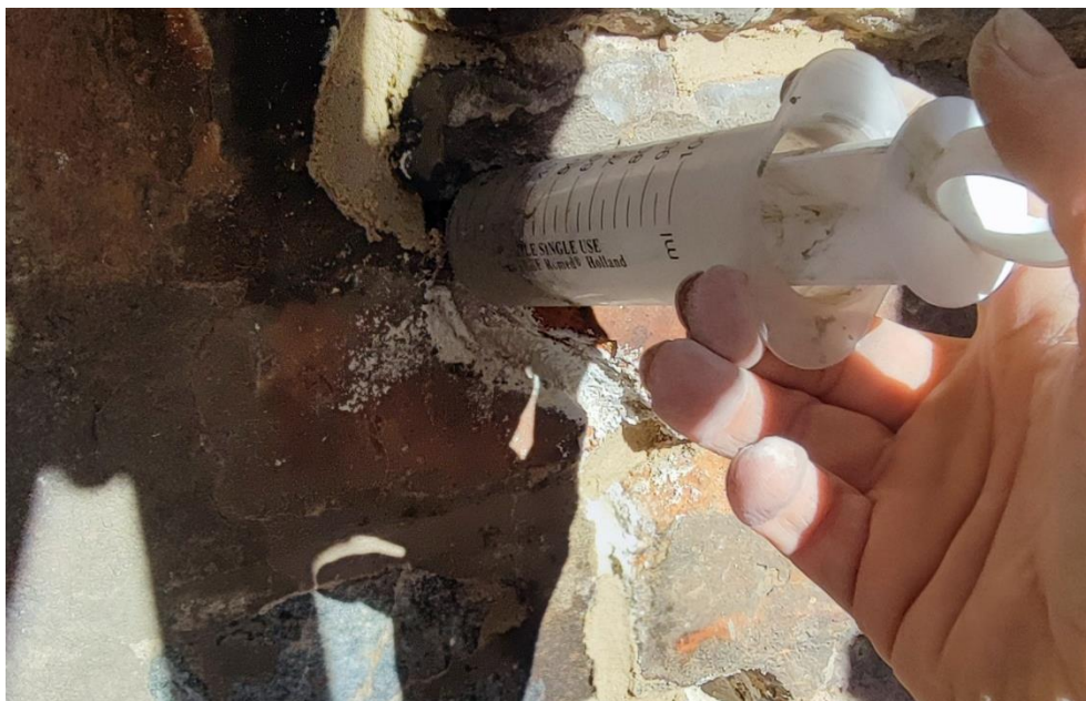
Ilustracja 40. Iniekcje w celu wypełnienia pustych przestrzeni w murze
