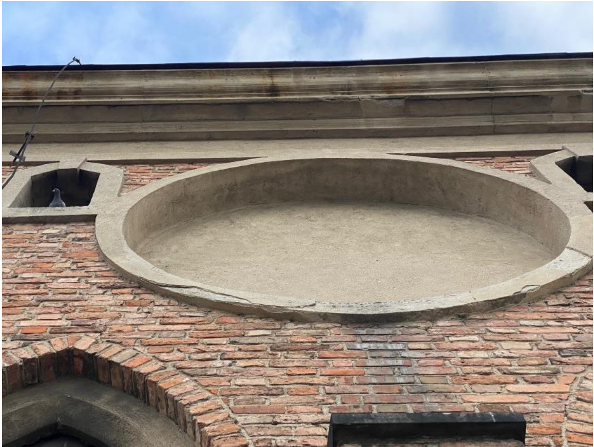
Ilustracja 14. Ubytki tynku
