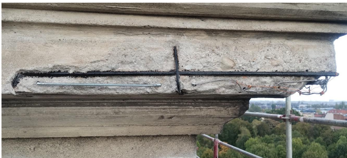
Ilustracja 32. Zbrojenia pod uzupełnienie ubytków
