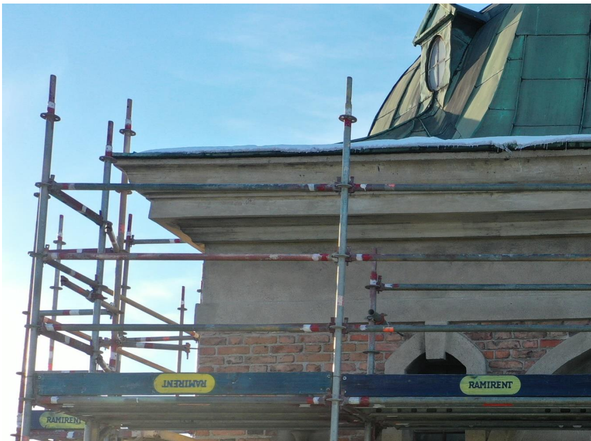
Ilustracja 61. Obiekt po zakończeniu prac
