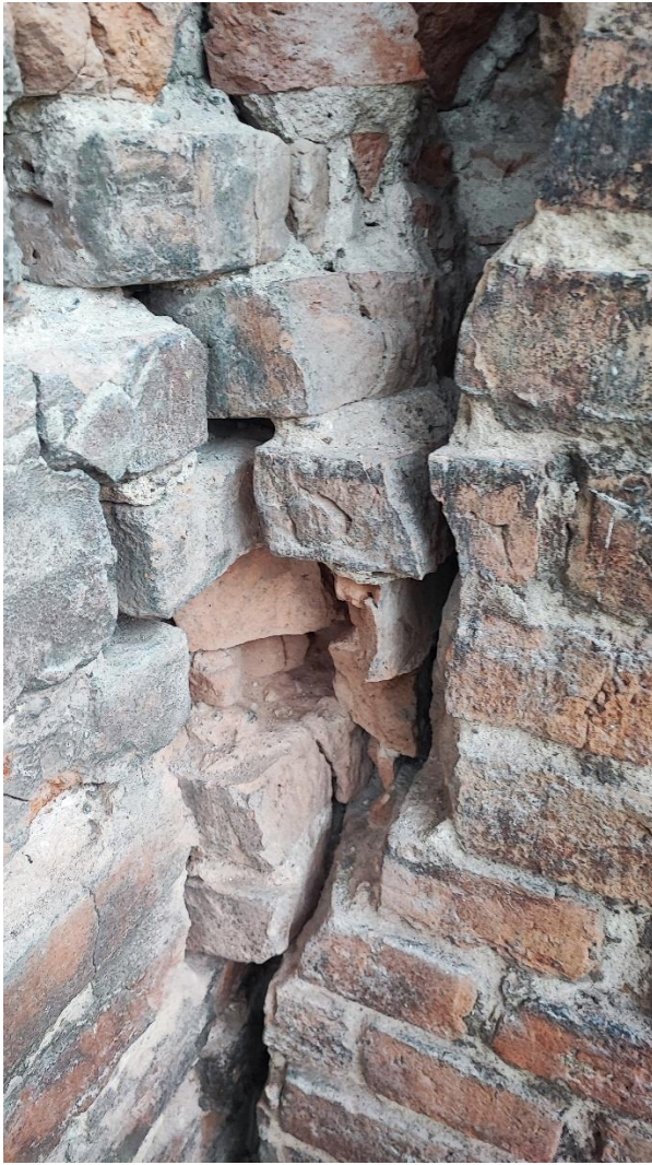
Ilustracje 38-39. Stan przed demontażem luźnych elementów oraz po demontażu – w trakcie prac murarskich
