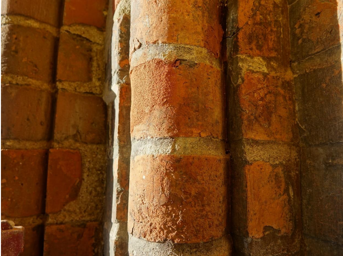
Ilustracja 67. Obiekt po zakończeniu prac
