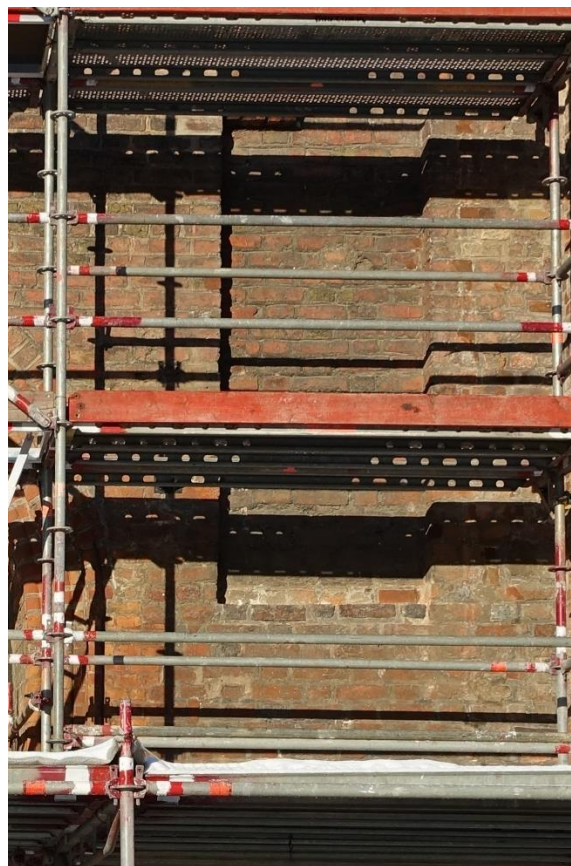
Ilustracja 72. Obiekt po zakończeniu prac
