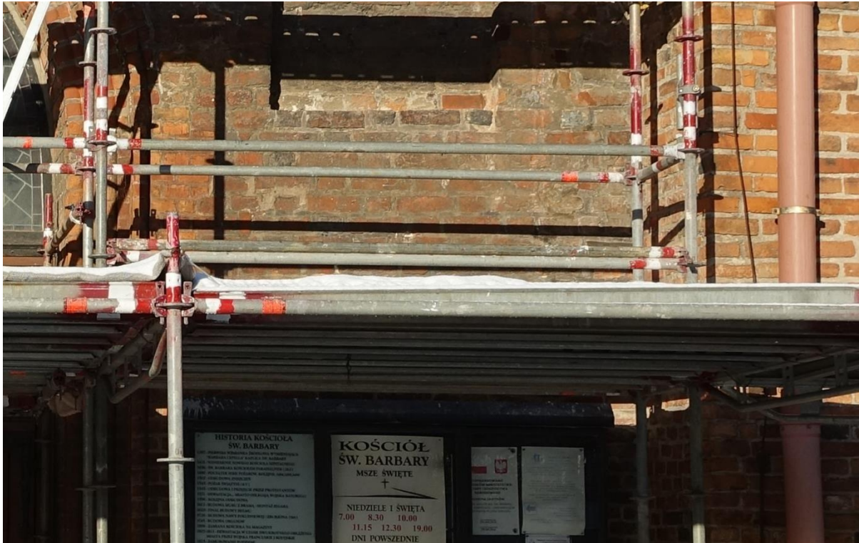
Ilustracja 73. Obiekt po zakończeniu prac
