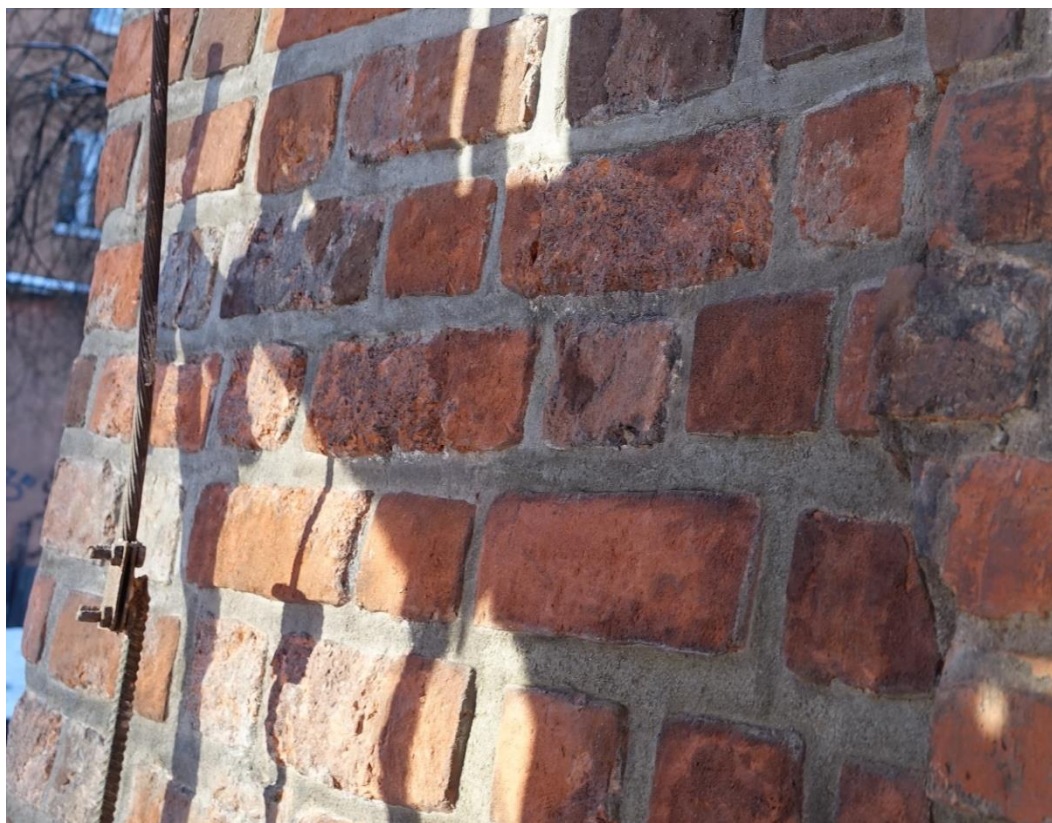
Ilustracja 70. Obiekt po zakończeniu prac
