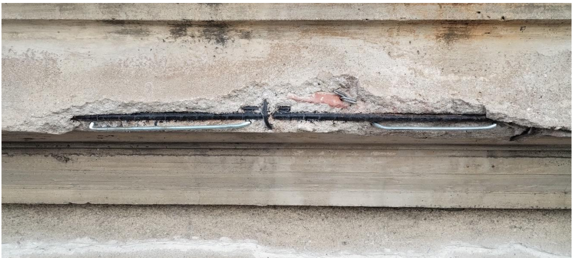
Ilustracja 35. Zbrojenia pod uzupełnienie ubytków
