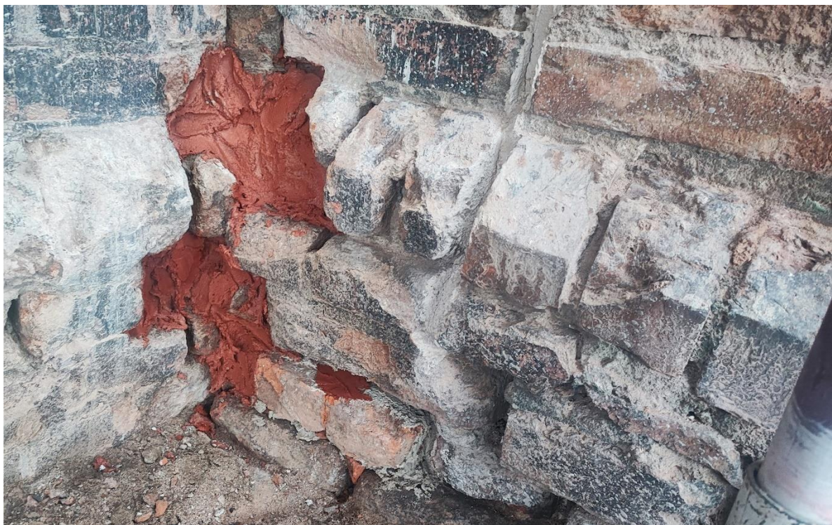
Ilustracja 54. W trakcie uzupełniania ubytków
