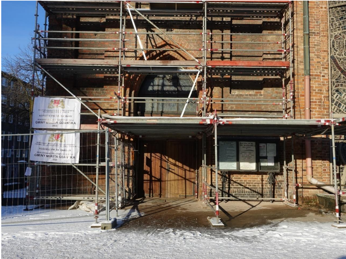
Ilustracja 63. Obiekt po zakończeniu prac
