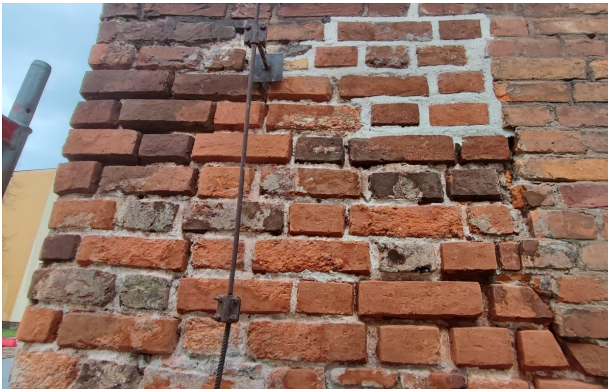
Ilustracja 42. W trakcie uzupełniania ubytków w cegle
