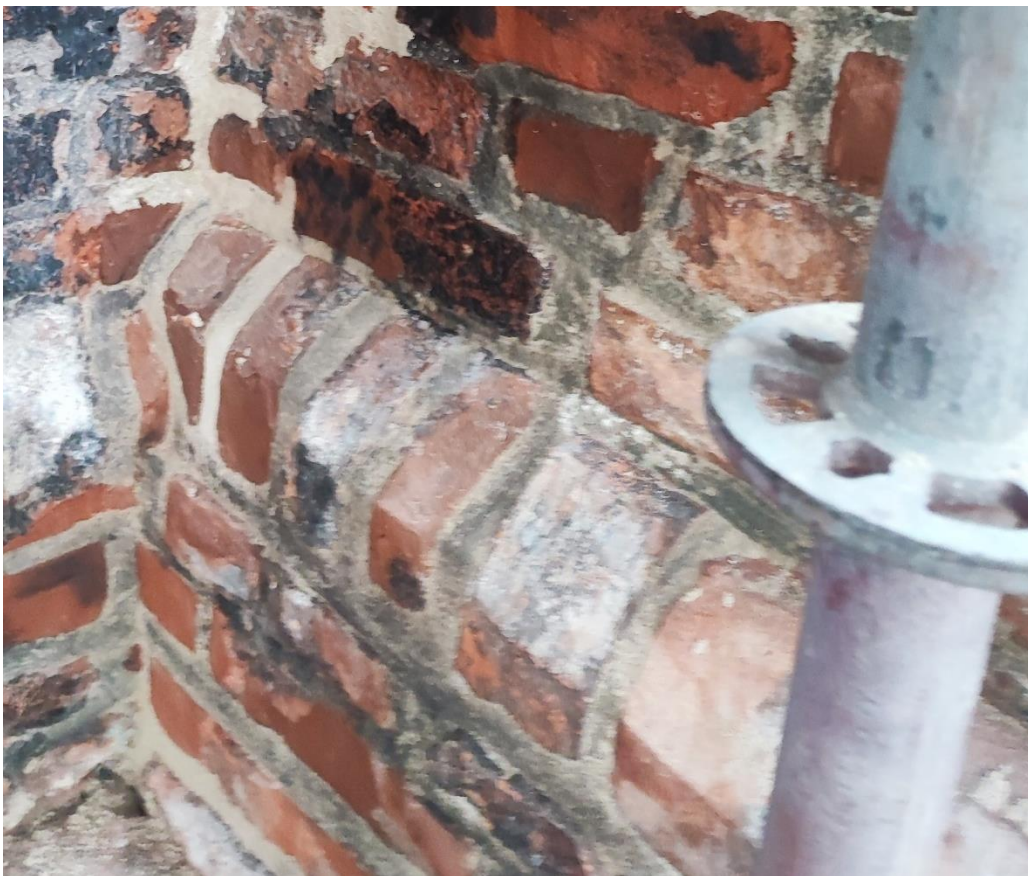
Ilustracja 56. Po uzupełnieniu ubytków
