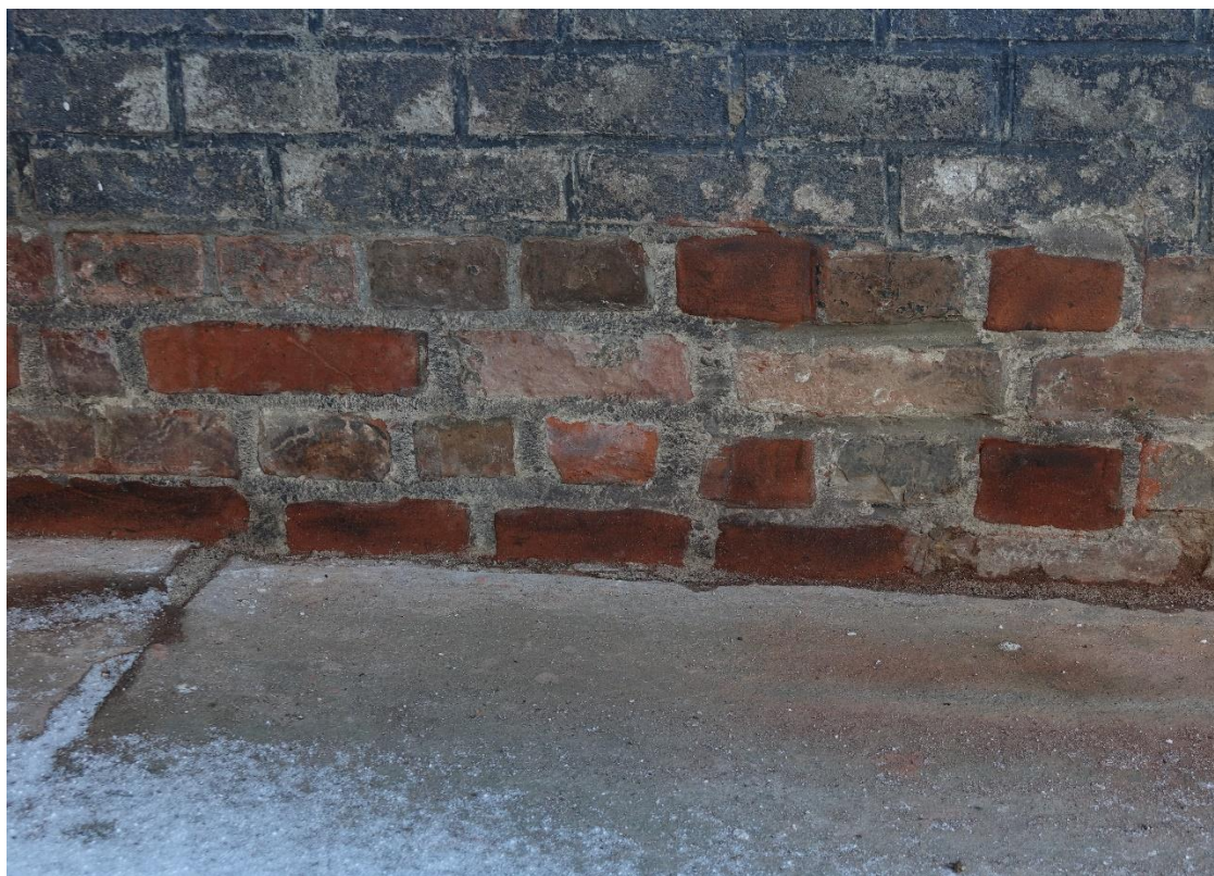
Ilustracja 76. Obiekt po zakończeniu prac
