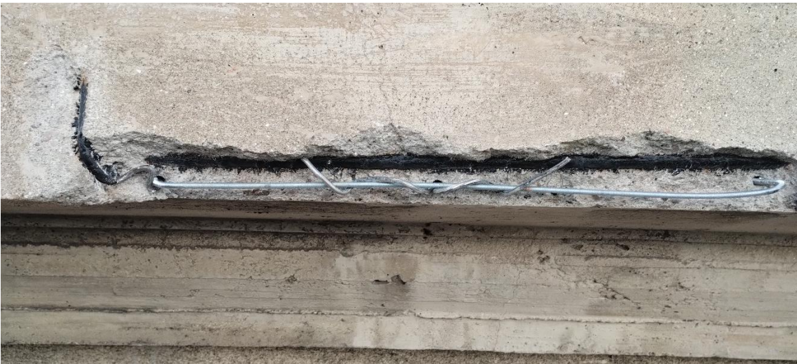
Ilustracja 34. Zbrojenia pod uzupełnienie ubytków
