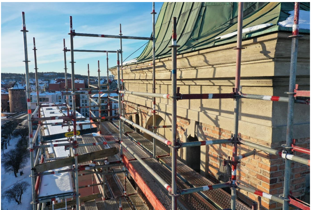
Ilustracja 60. Obiekt po zakończeniu prac
