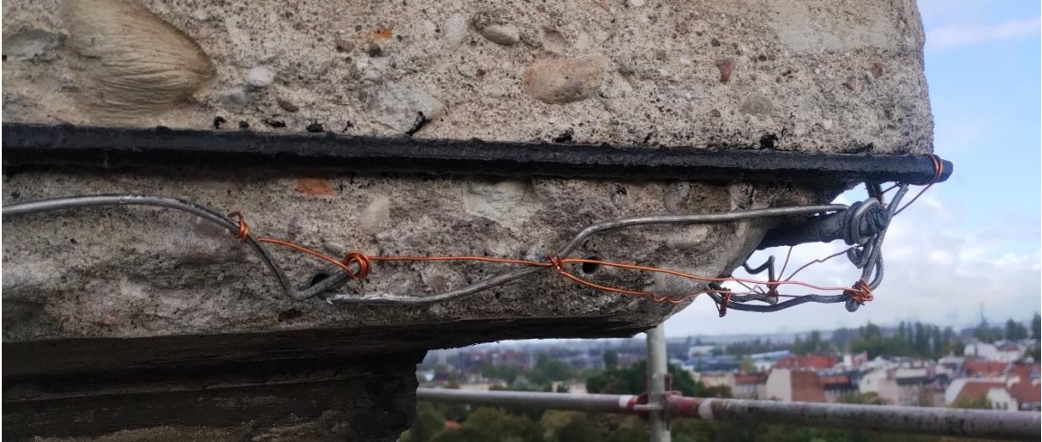
Ilustracja 33. Zbrojenia pod uzupełnienie ubytków
