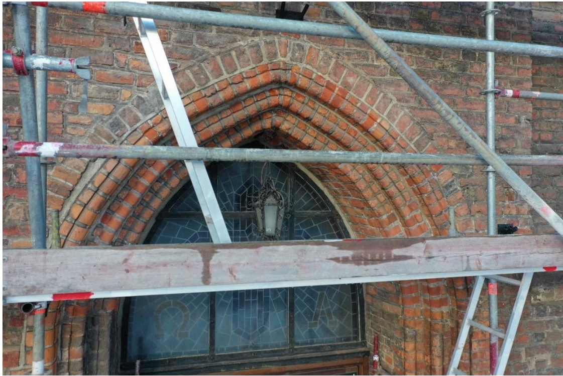
Ilustracja 64. Obiekt po zakończeniu prac
