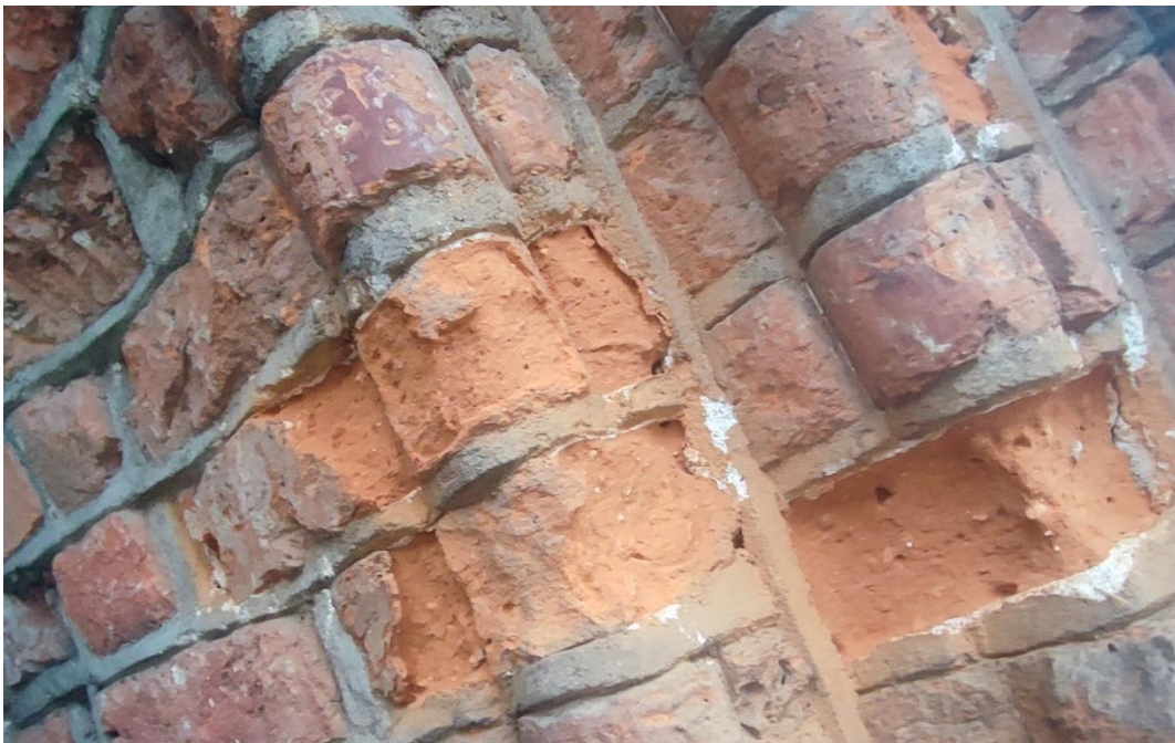
Ilustracja 48. Po nawierceniu otworów pod zbrojenia
