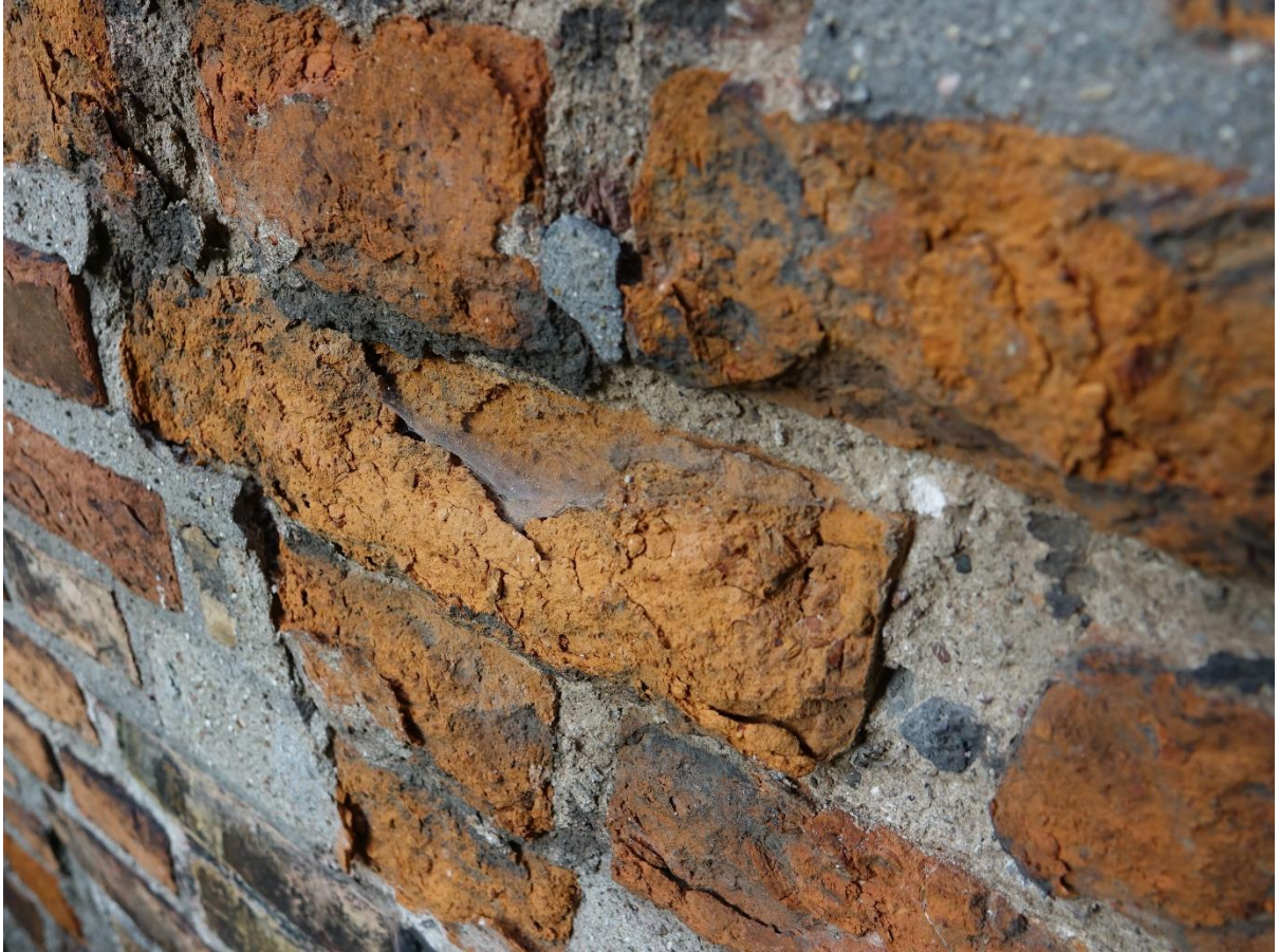
Ilustracja 24. Uszkodzenia elewacji
