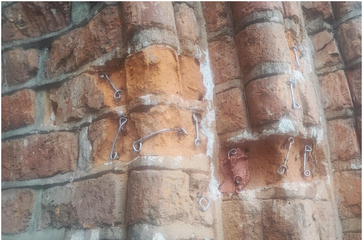
Ilustracja 49. Wykonanie zbrojeń pod uzupełnienie ubytków cegły
