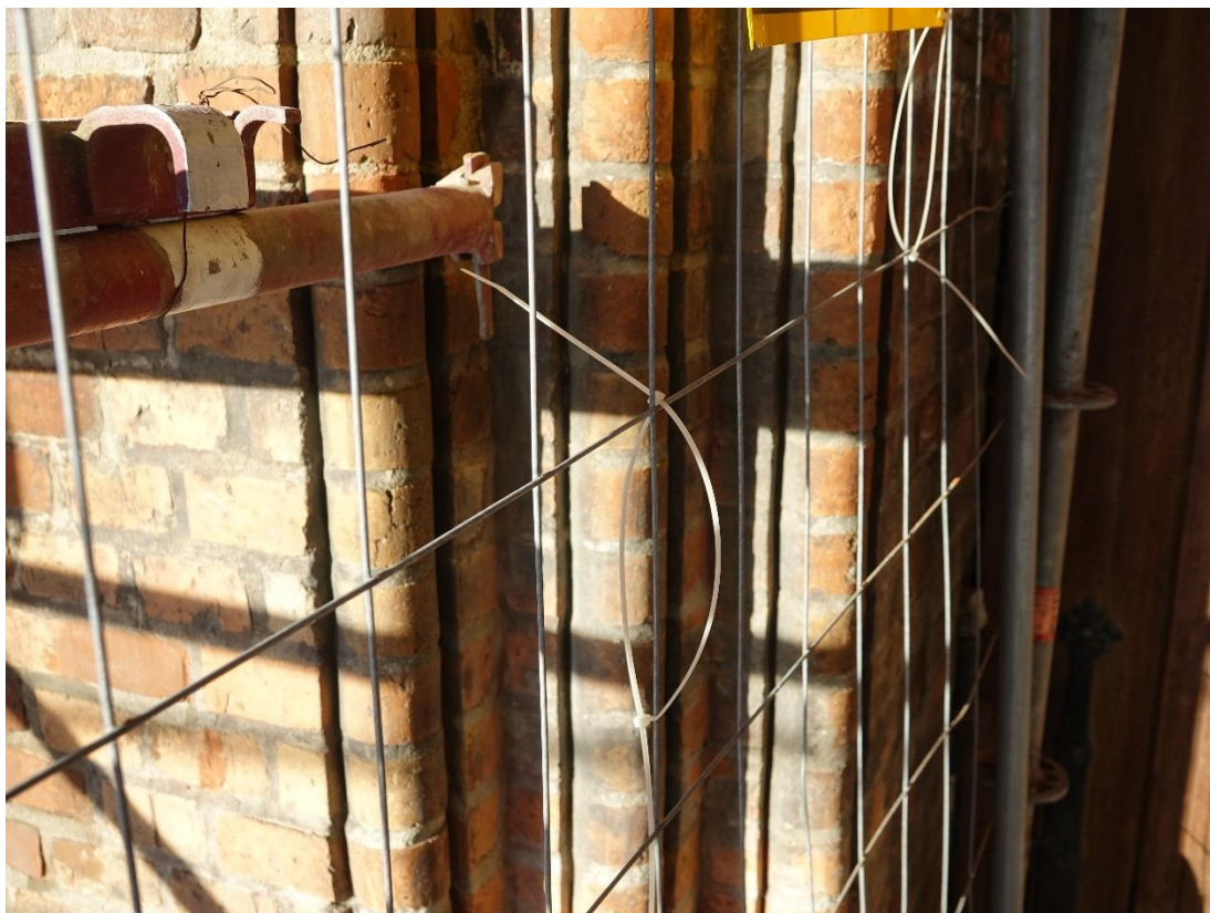
Ilustracja 69. Obiekt po zakończeniu prac
