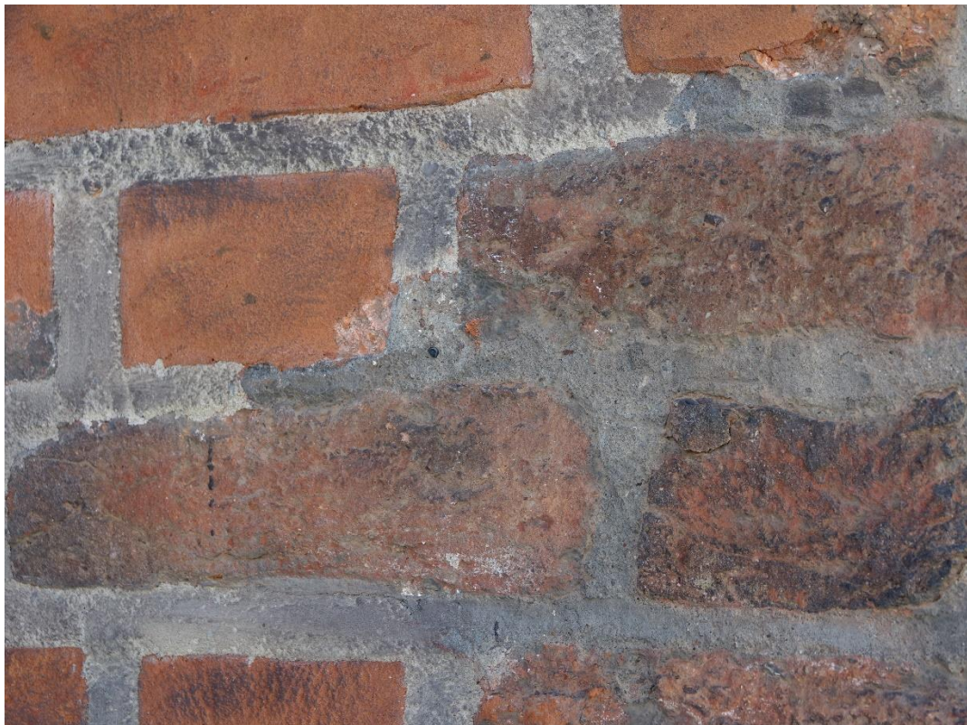
Ilustracja 74. Obiekt po zakończeniu prac
