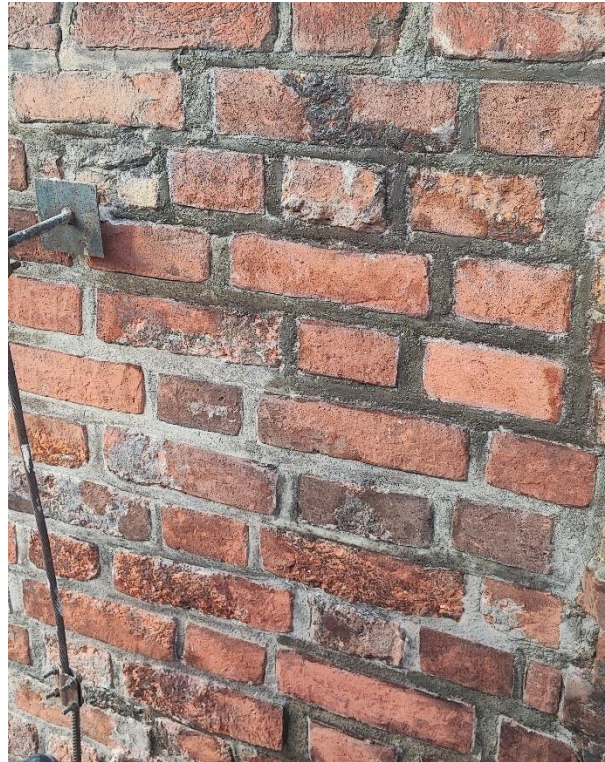
Ilustracja 43-44. Przed i w trakcie patynowania (scalania kolorystycznego) świeżo uzupełnionej zaprawy
