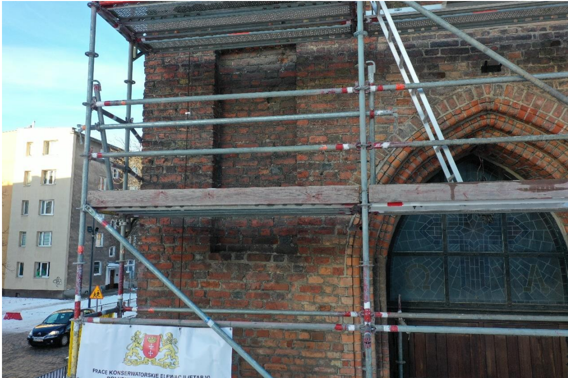
Ilustracja 71. Obiekt po zakończeniu prac
