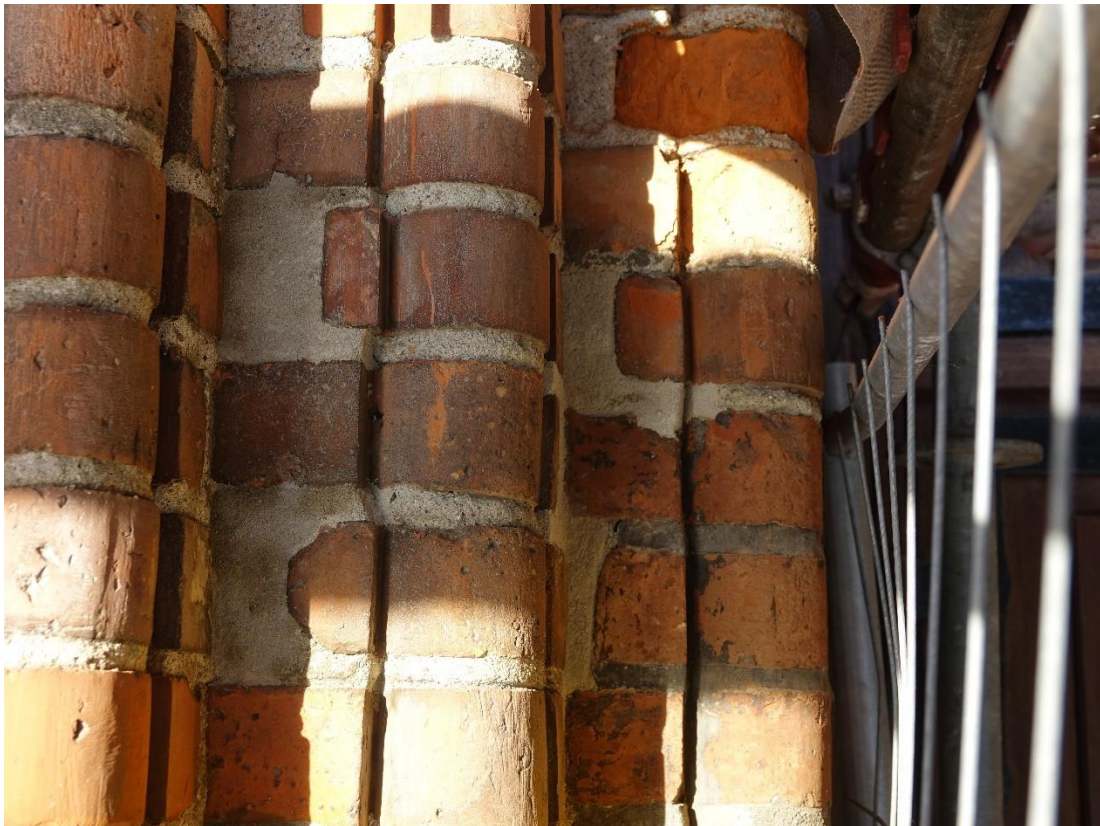
Ilustracja 68. Obiekt po zakończeniu prac
