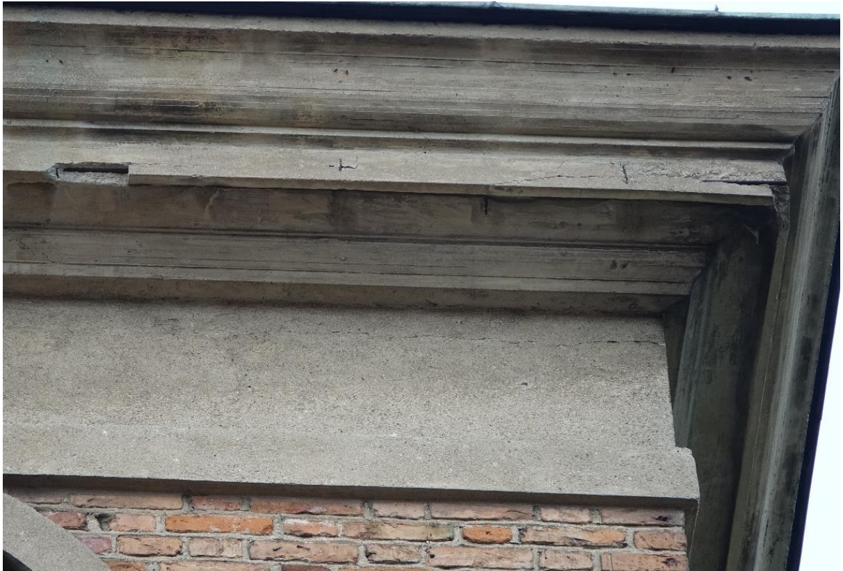
Ilustracja 12. Ubytki gzymsu
