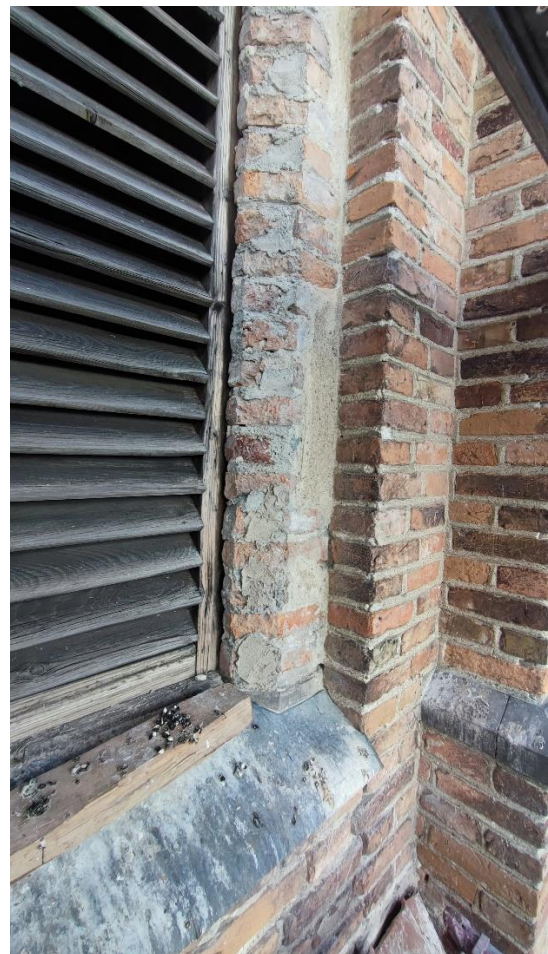
Ilustracja 45-46. Fragment ościeżnicy przed i po usunięciu odspojonego tynku
