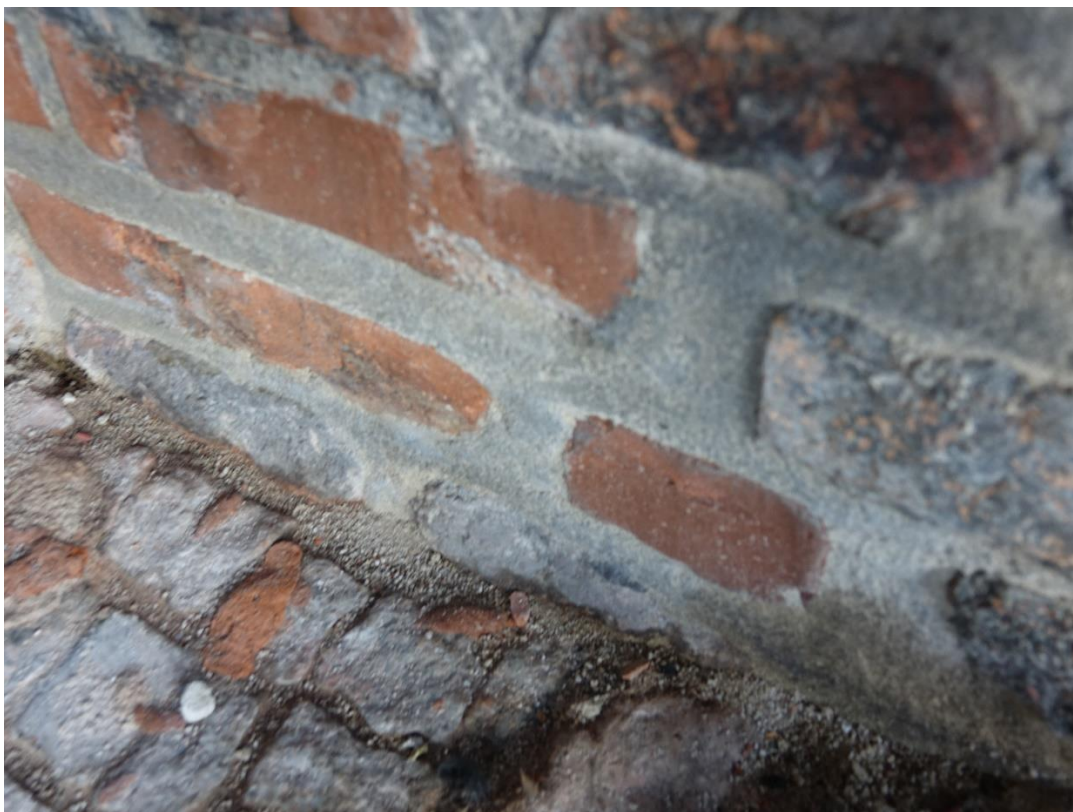
Ilustracja 75. Obiekt po zakończeniu prac
