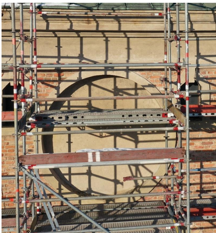
Ilustracja 62. Obiekt po zakończeniu prac
