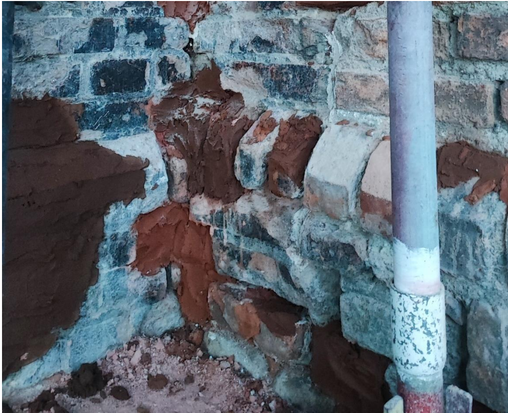
Ilustracja 55. W trakcie uzupełniania ubytków
