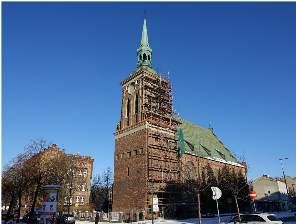
Ilustracja 57. Obiekt po zakończeniu prac
