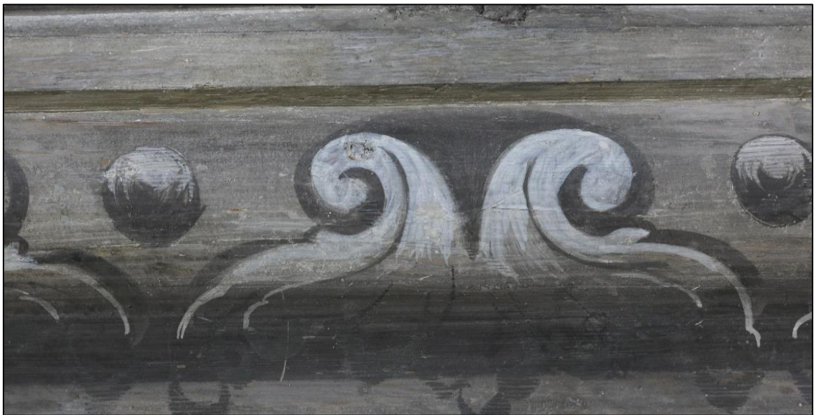
Fot. 43. Fragment gzymsu po zakończeniu prac.
