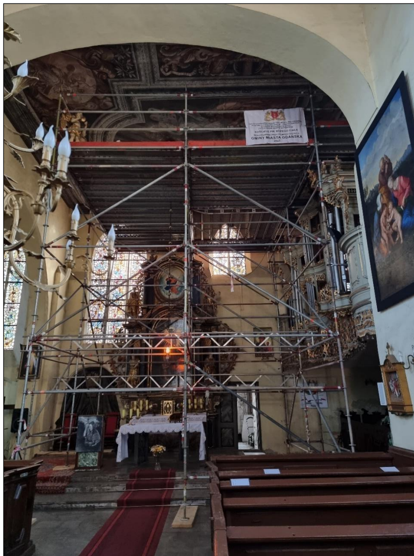
Fot. 6. Widok ogólny w trakcie prac 2023 r.
