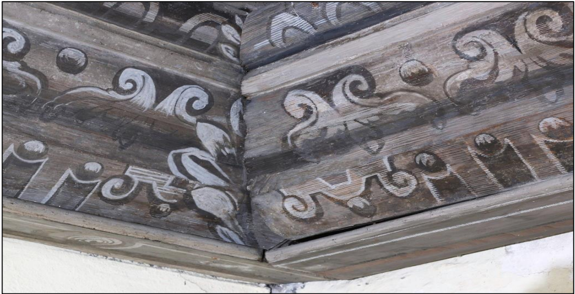
Fot. 42. Fragment gzymsu po pracach.
