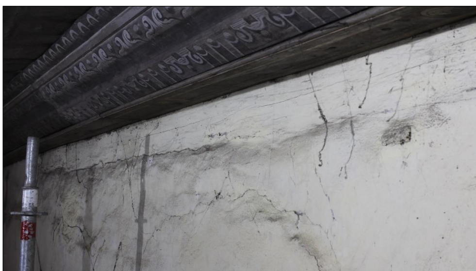
Fot. 27. Fragment ściany z gzymsem przed rozpoczęciem prac.
