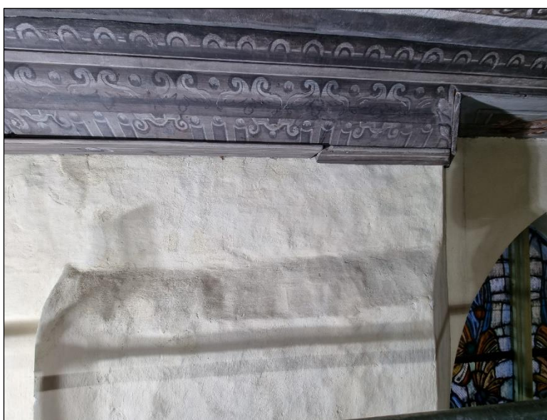
Fot. 46. Fragment ściany z gzymsem po zakończeniu prac w 2023 r.
