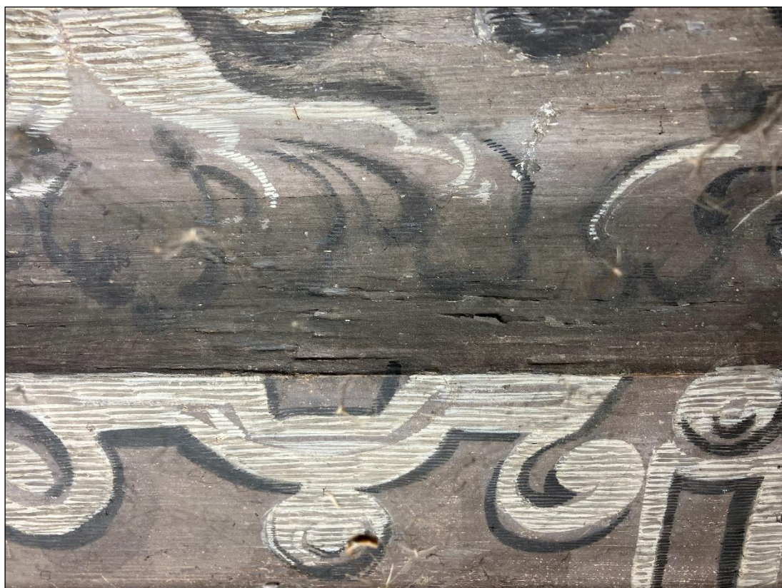
Fot. 22. Fragment gzymsu przed pracami.
