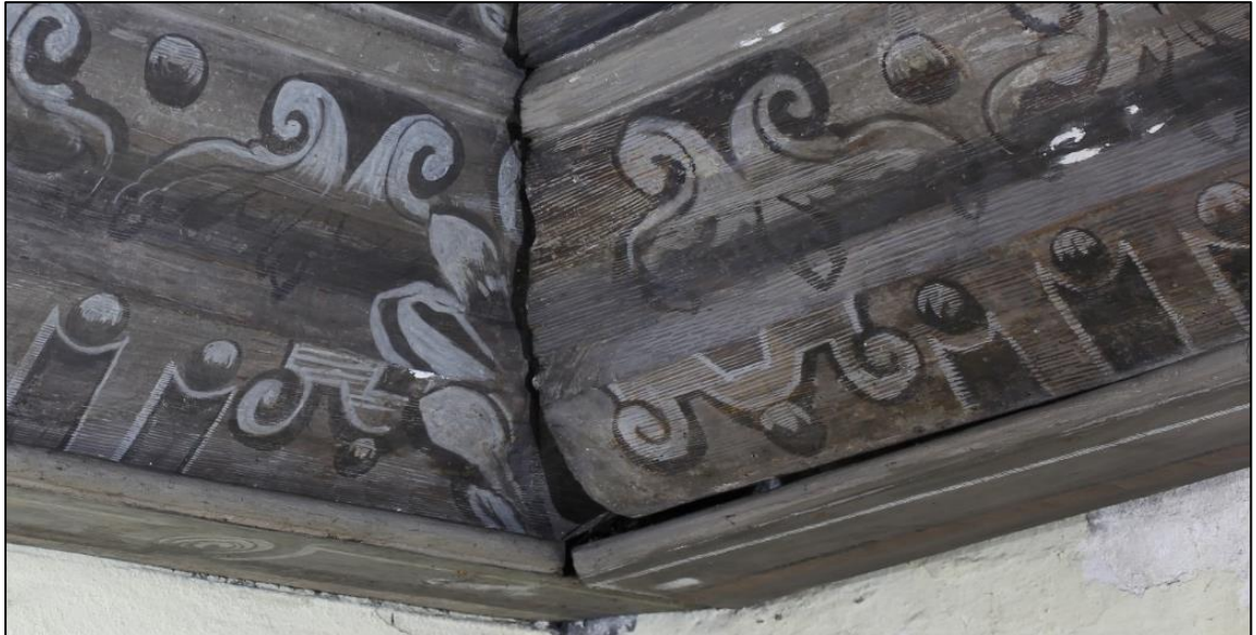
Fot. 34. Fragment gzymsu w trakcie trwania prac.
