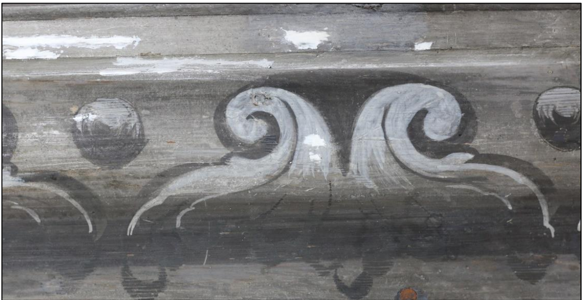
Fot. 35. Fragment gzymsu po uzupełnieniu ubytków zaprawy.
