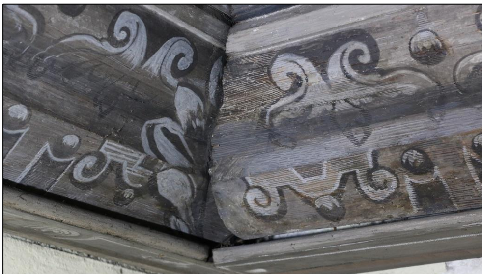
Fot. 25. Fragment gzymsu przed pracami.
