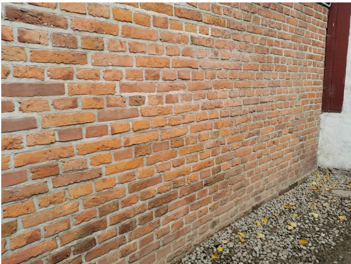
Ilustracja 52. Stan po zakończeniu prac
