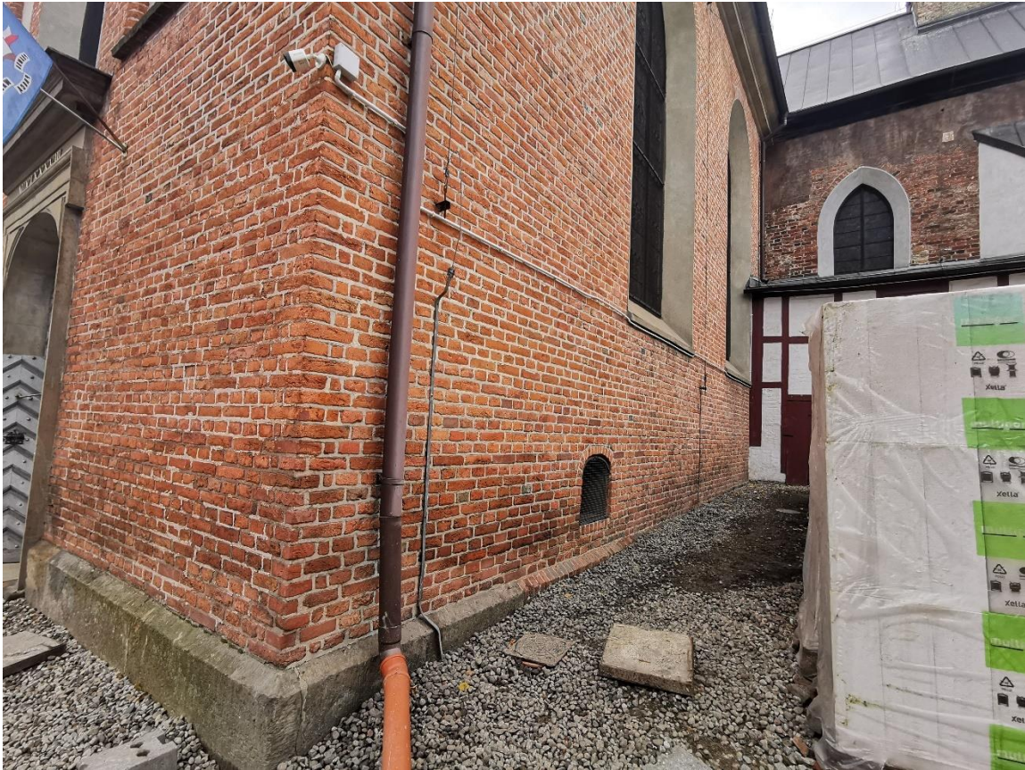
Ilustracja 49. Stan po zakończeniu prac
