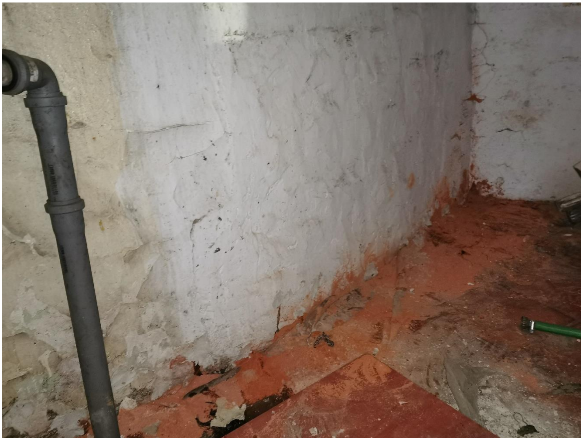
Ilustracja 56. Po zasklepieniu odwiertów i uzupełnieniu ubytków powstałych podczas prac
