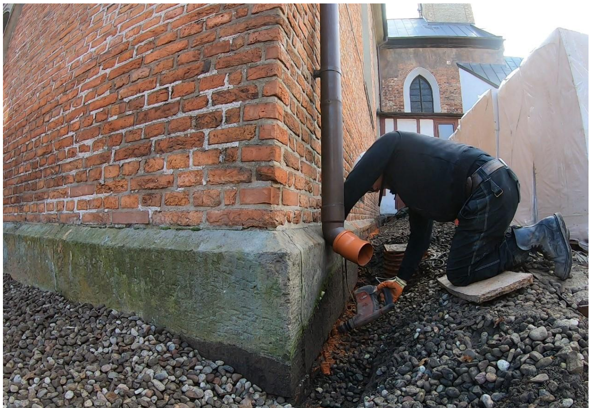
Ilustracja 28. Wykonywanie odwiertów pod iniektory
