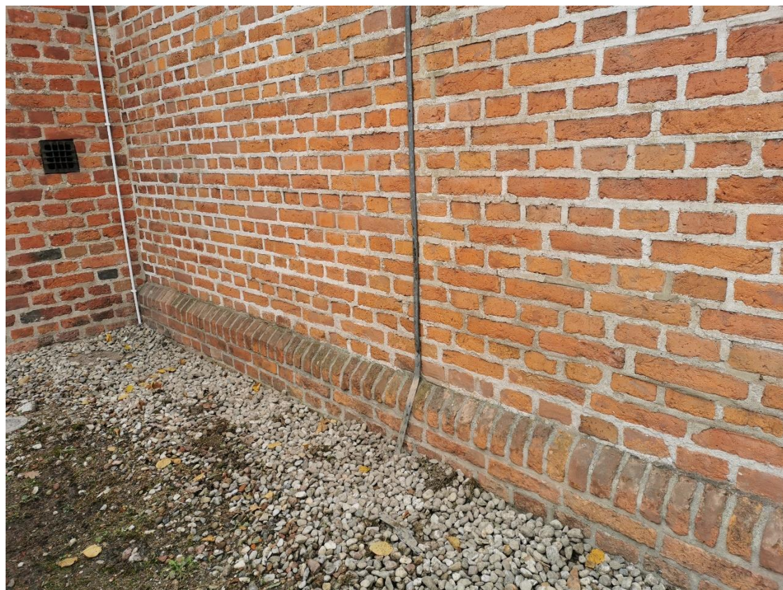
Ilustracja 44. Stan po zakończeniu prac
