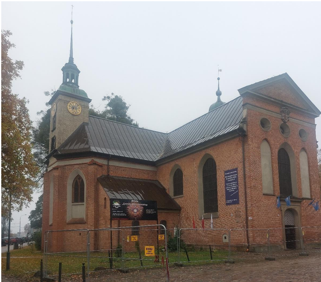
Ilustracja 57. Widok ogólny po zakończeniu prac
