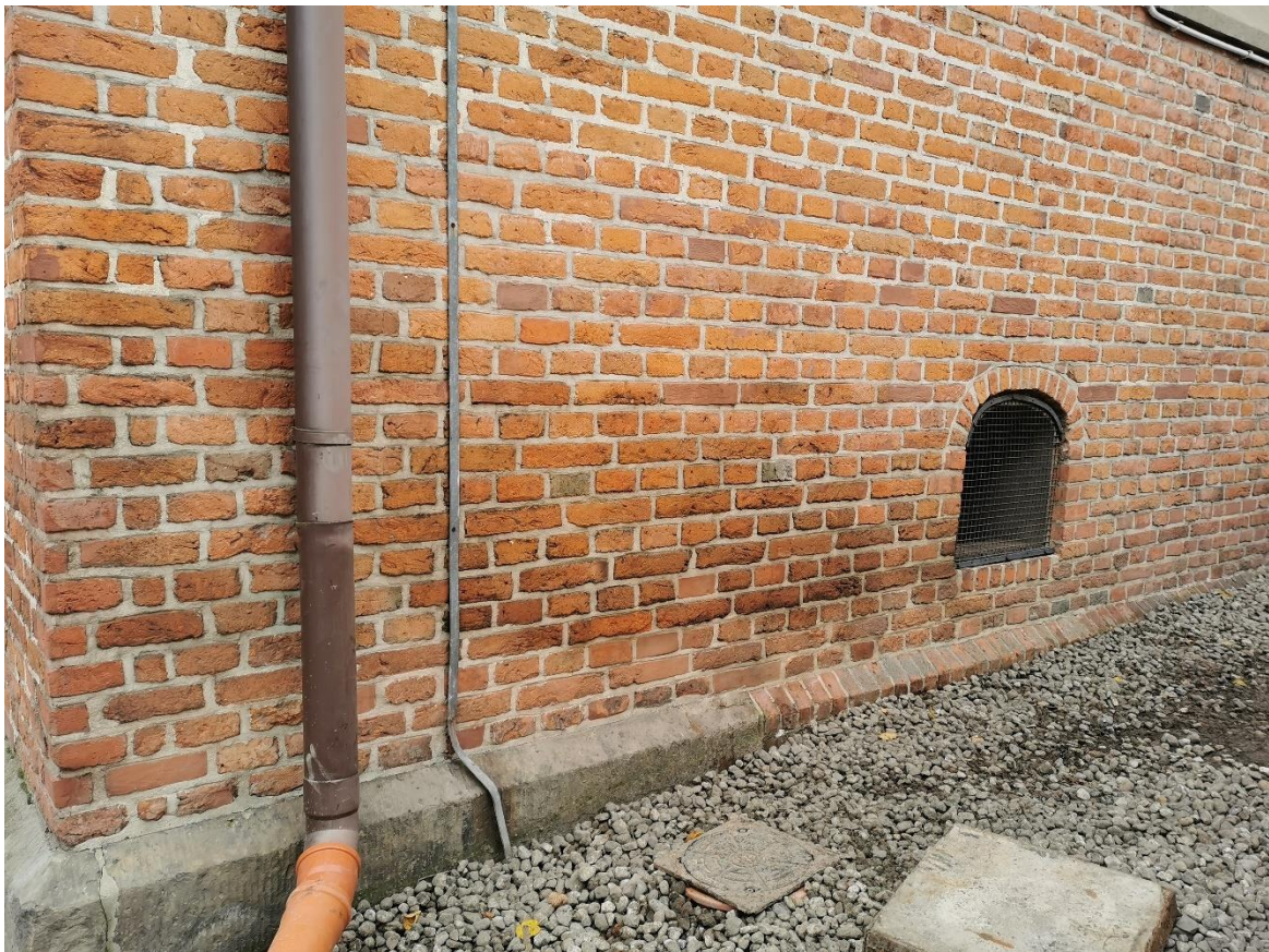
Ilustracja 50. Stan po zakończeniu prac
