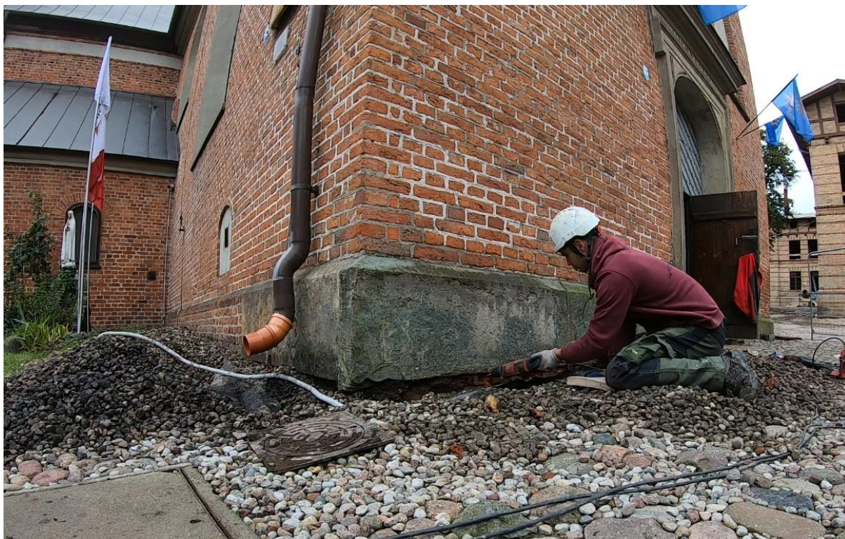
Ilustracja 25. Wykonywanie odwiertów pod iniektory
