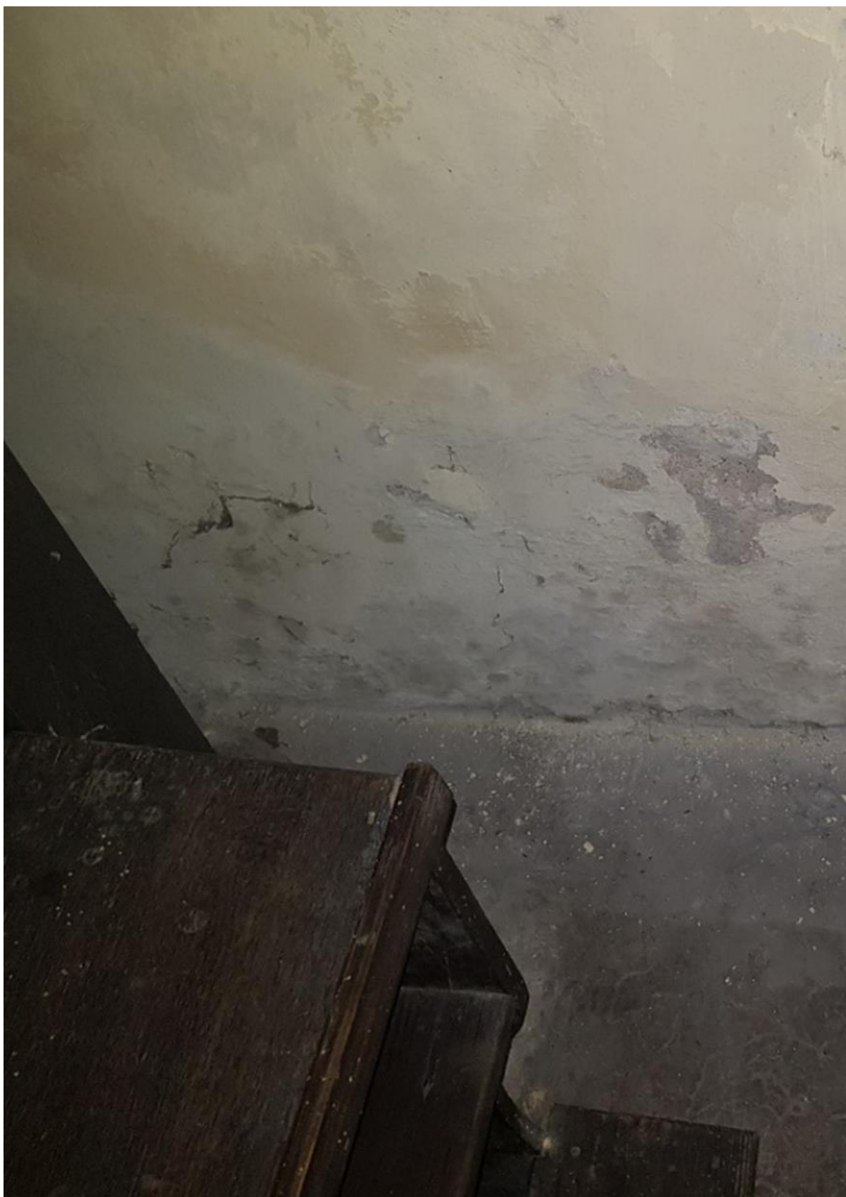
Ilustracja 21. Zacieki i tynki odspajające się od ścian w wyniku zawilgocenia murów
