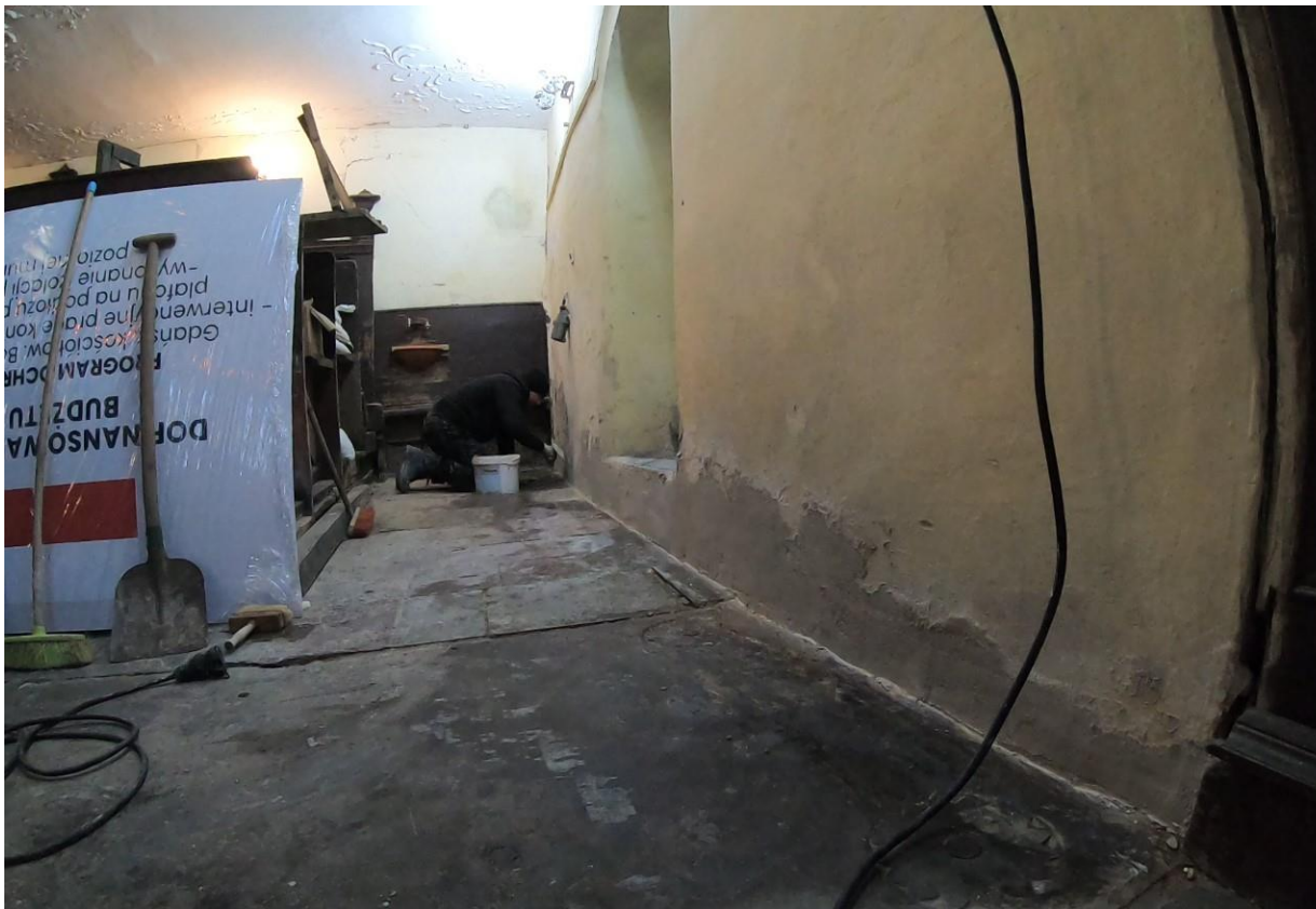
Ilustracja 54. Po zasklepieniu odwierć i uzupełnieniu ubytków powstałych podczas prac
