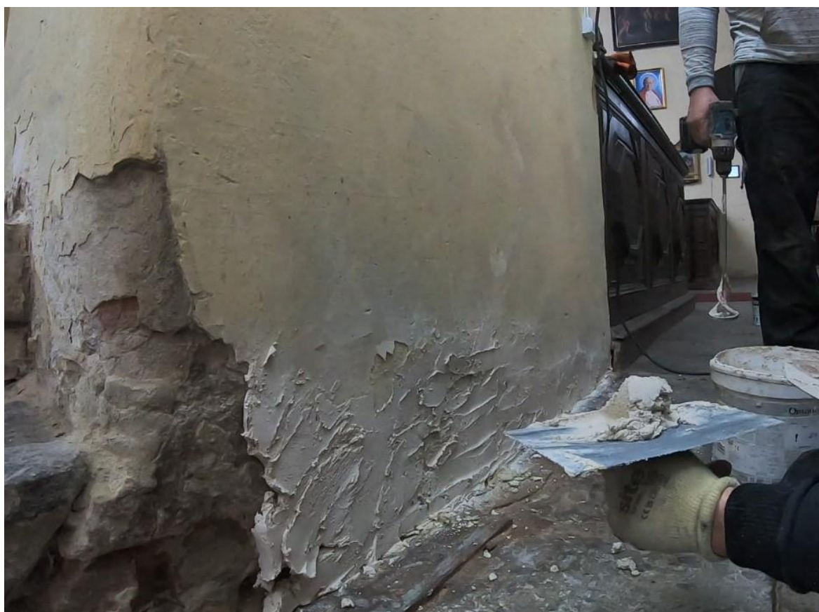
Ilustracja 42. Po aplikacji żywicy. Uzupelnianie ubytków powstałych podczas prac
