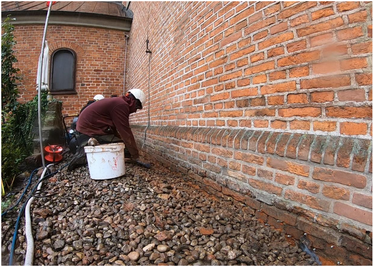
Ilustracja 33. Osadzanie iniektorów w odwiertach.
