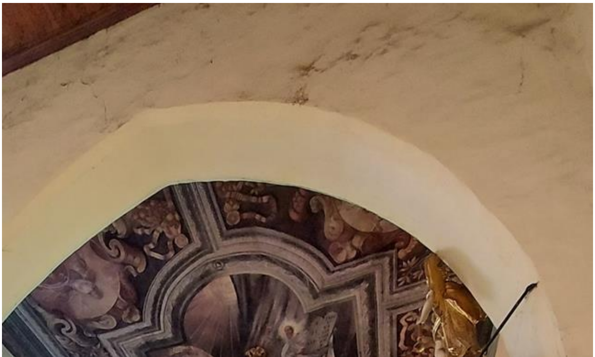
Ilustracja 24. Tynki odpajające się od ścian w wyniku zawilgocenia murów
