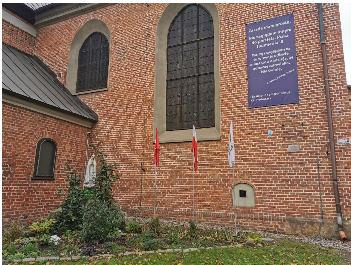
Ilustracja 43. Stan po zakończeniu prac
