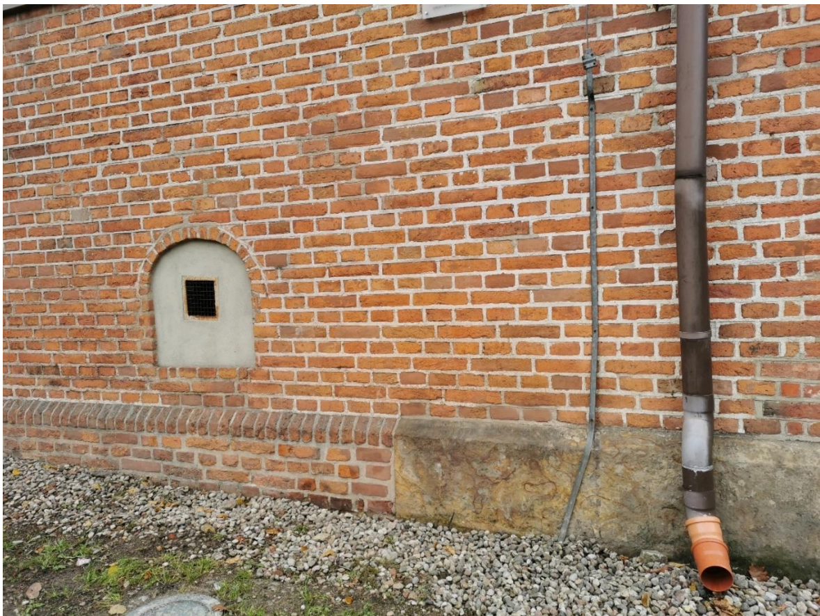
Ilustracja 46. Stan po zakończeniu prac
