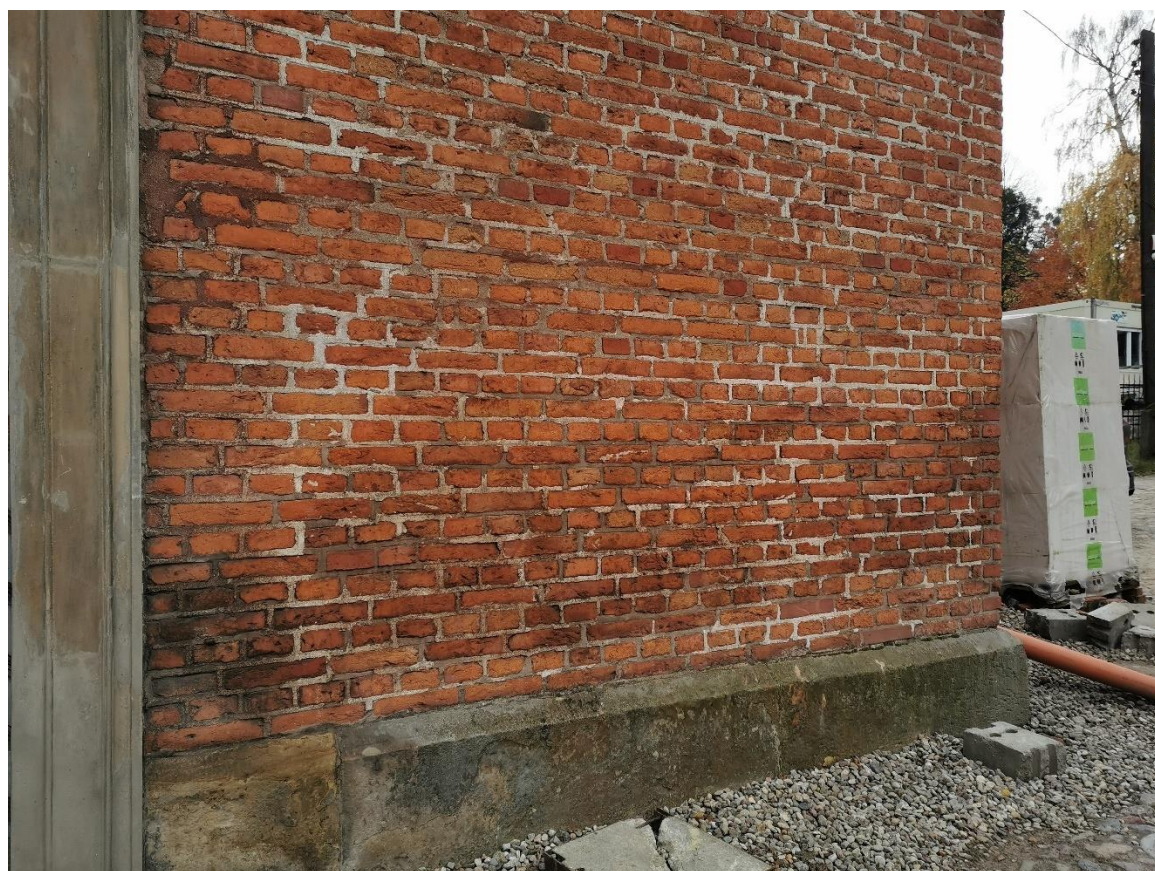
Ilustracja 48. Stan po zakończeniu prac
