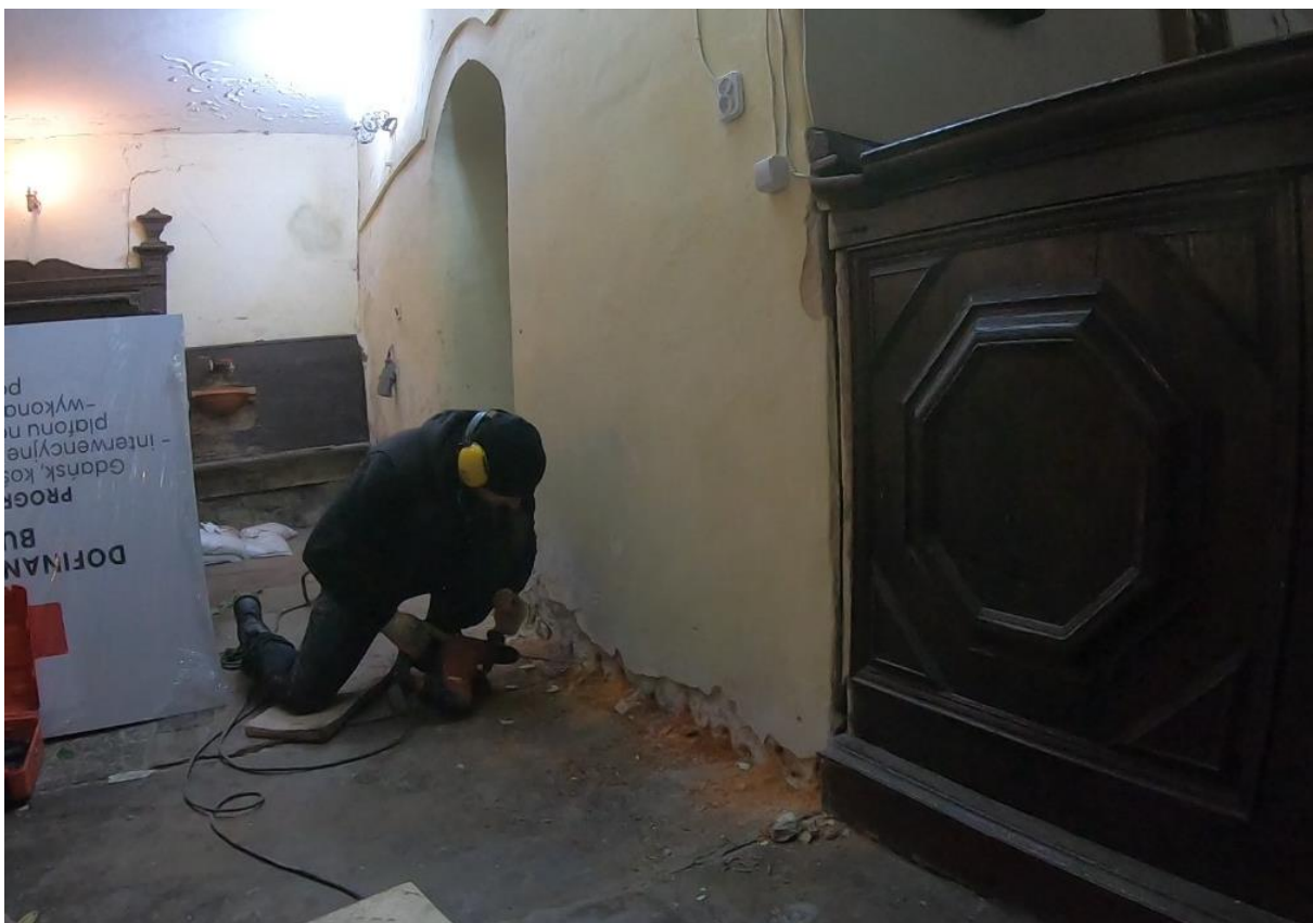
Ilustracja 30. Wykonywanie odwiertów pod iniektory
