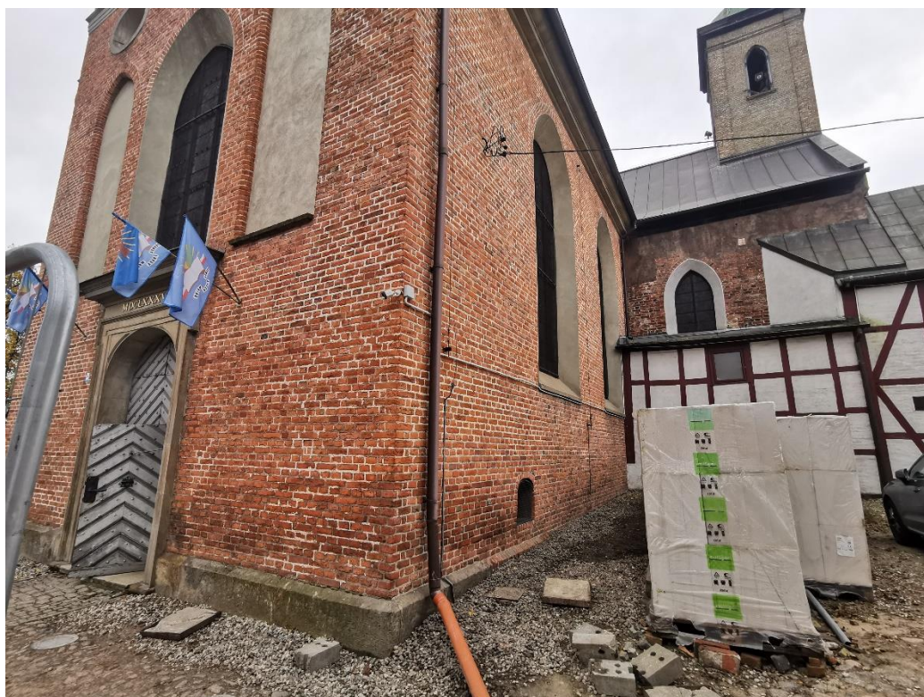
Ilustracja 58. Widok ogólny po zakończeniu prac
