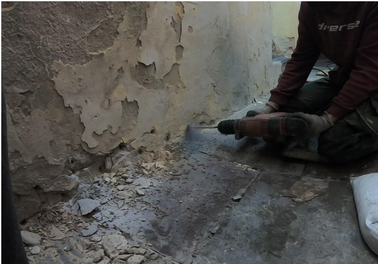
Ilustracja 29. Wykonywanie odwiertów pod iniektory
