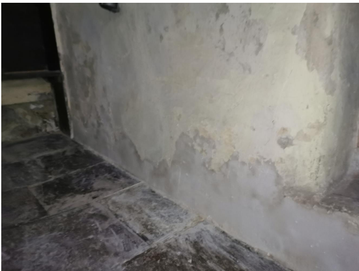
Ilustracja 55. Po zasklepieniu odwiertów i uzupełnieniu ubytków powstałych podczas prac
