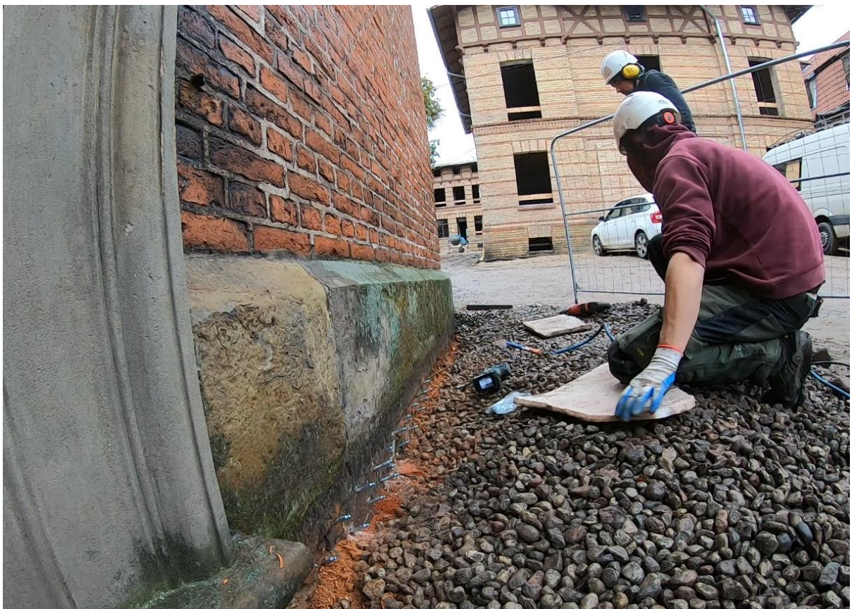
Ilustracja 34. Osadzanie iniektorów w odwiertach.
