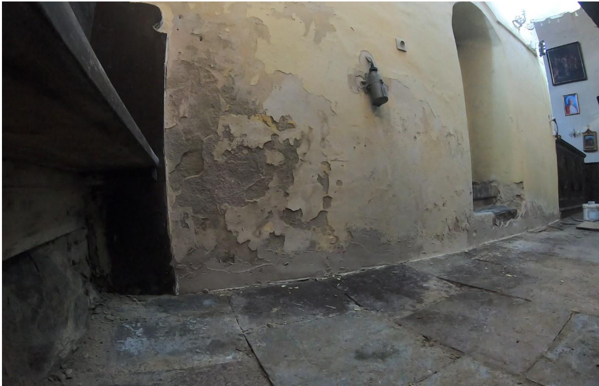
Ilustracja 53. Po zasklepieniu odwierć i uzupełnieniu ubytków powstałych podczas prac
