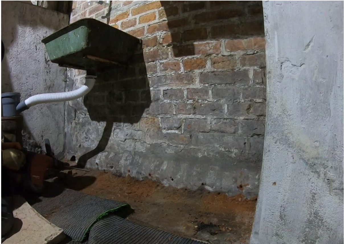
Ilustracja 31. Wykonywanie odwiertów pod iniektory
