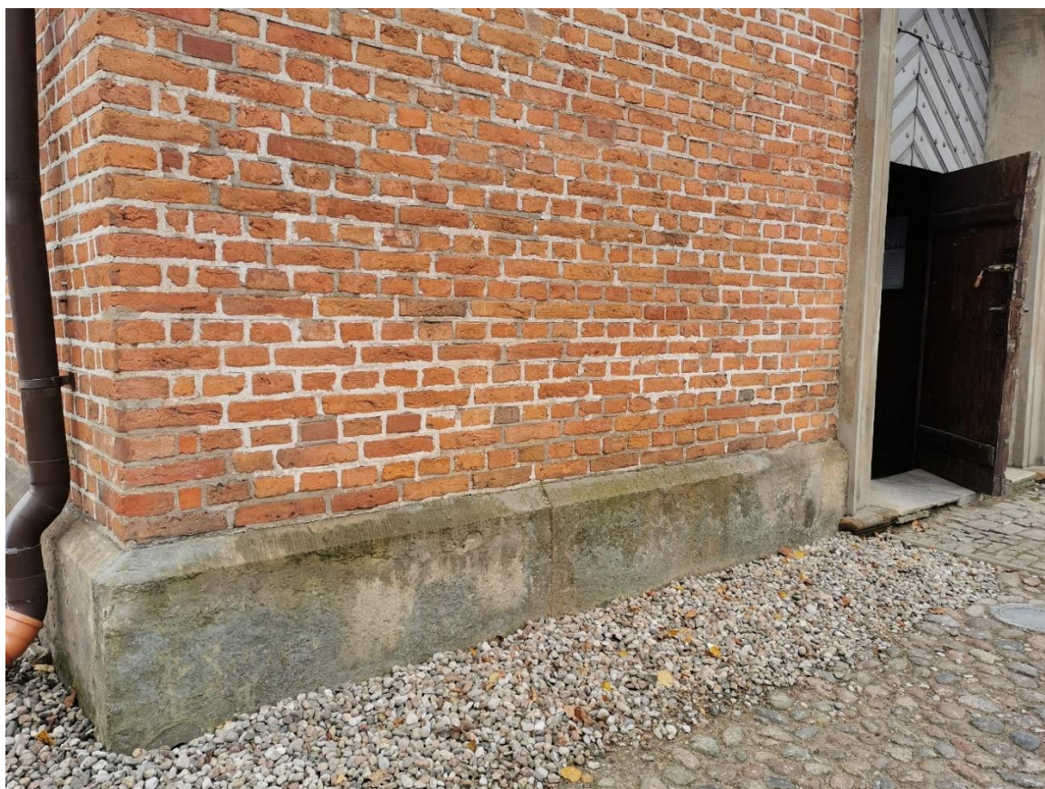
Ilustracja 47. Stan po zakończeniu prac
