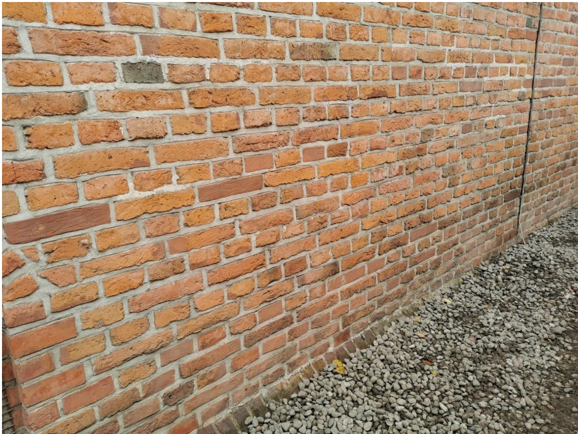
Ilustracja 51. Stan po zakończeniu prac
