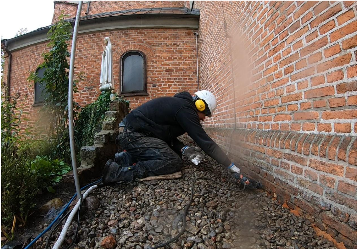
Ilustracja 27. Wykonywanie odwiertów pod iniektory
