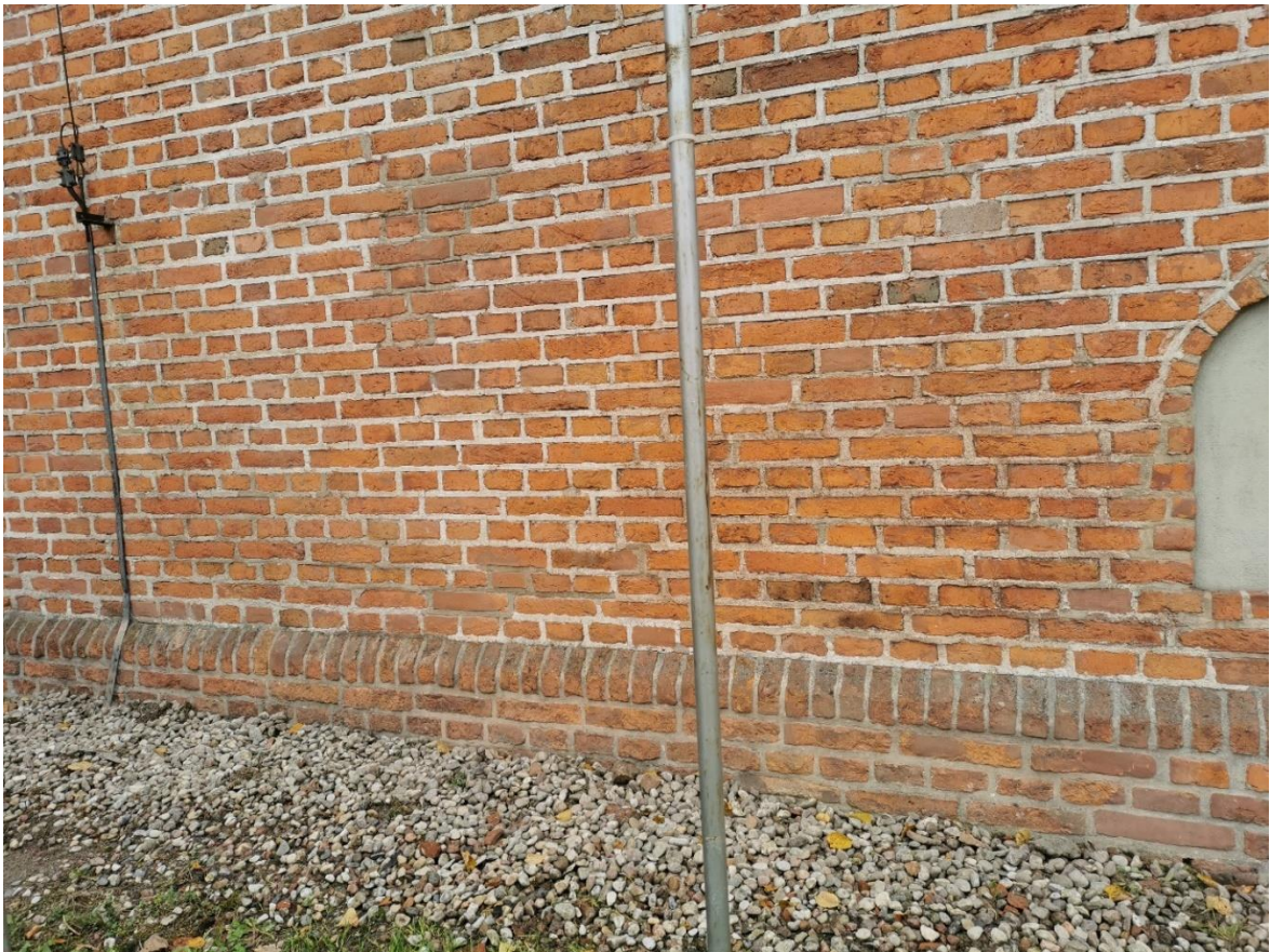
Ilustracja 45. Stan po zakończeniu prac
