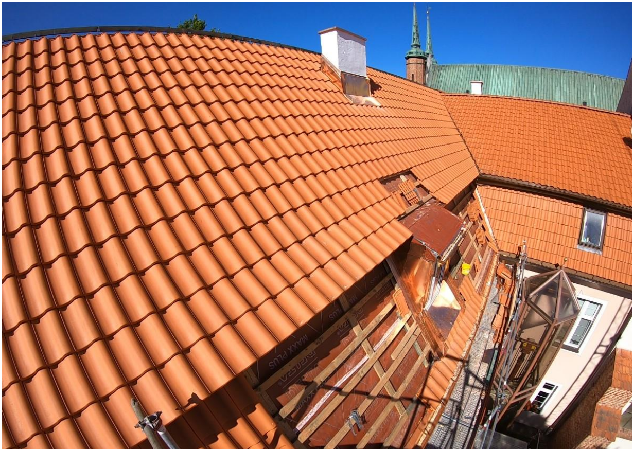
Ilustracja 39. Połączenie wschodniego skrzydła zachodniego. Montaż dachówek i obróbek blacharskich.
