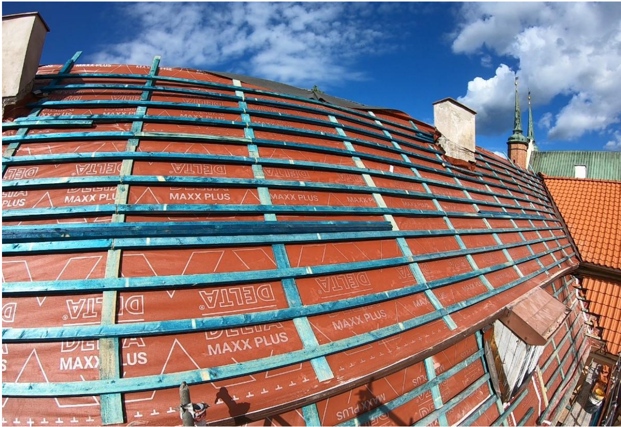
Ilustracja 37. Połąc wschodnia skrzydła zachodniego. Montaż łącenia.
