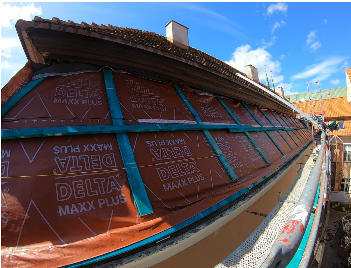
Ilustracja 35. Połąć wschodnia skrzydła zachodniego. Montaż łączenia.
