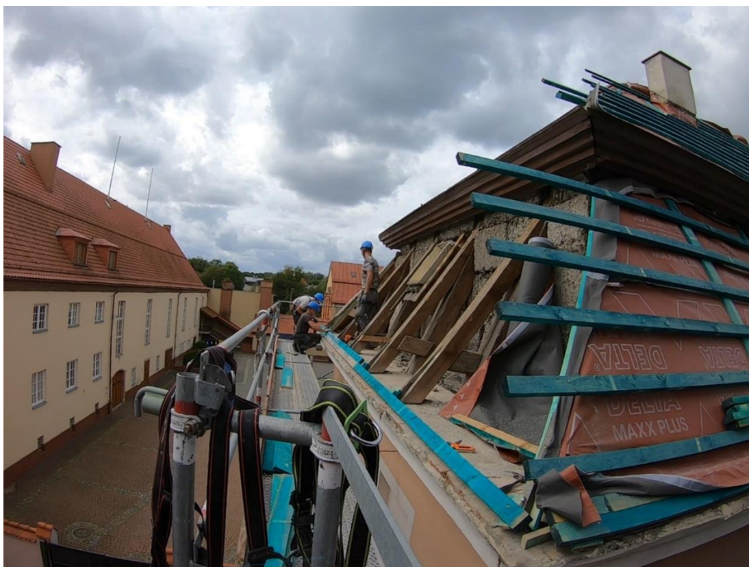
Ilustracja 21. Połączenie południowe skrzydła zachodniego. Stan po demontażu łączenia oraz membrany paroprzepuszczalnej. Widok od południowego wschodu.
