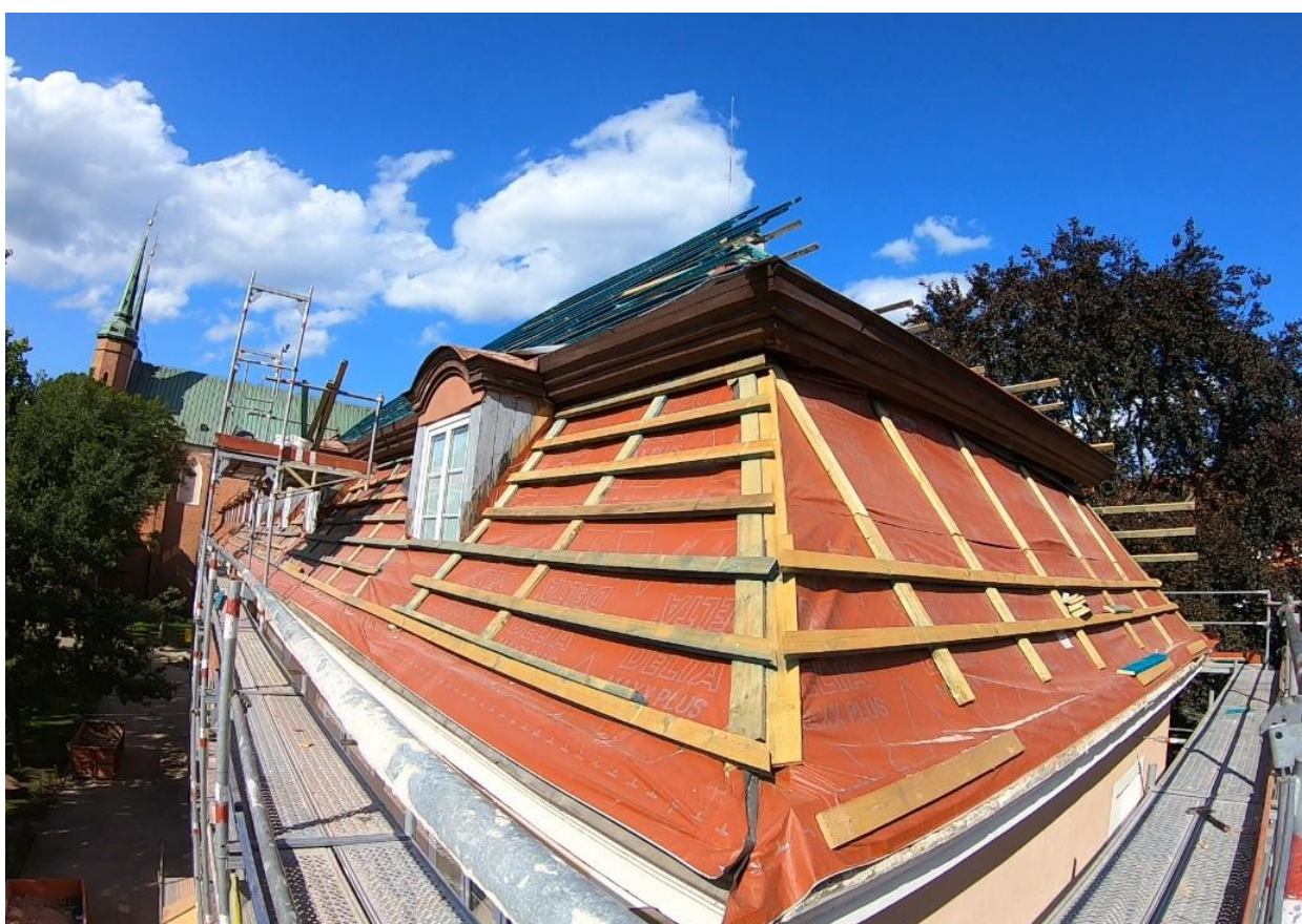
Ilustracja 24. Połączenie południowe skrzydła zachodniego. Montaż łączenia. Widok od południowego zachodu.
