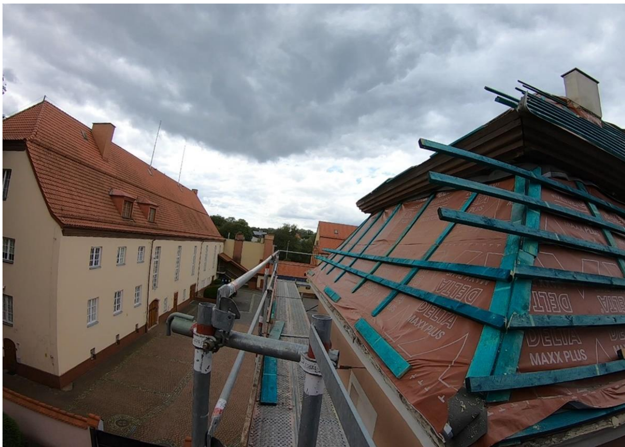
Ilustracja 23. Połączenie południowe skrzydła zachodniego. Montaż łączenia.
