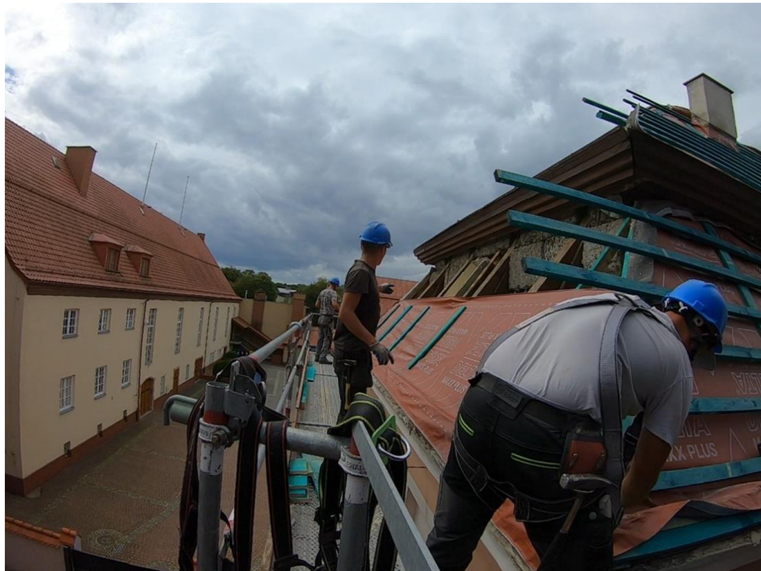
Ilustracja 22. Połączenie południowe skrzydła zachodniego. Montaż membrany paroprzepuszczalnej.
