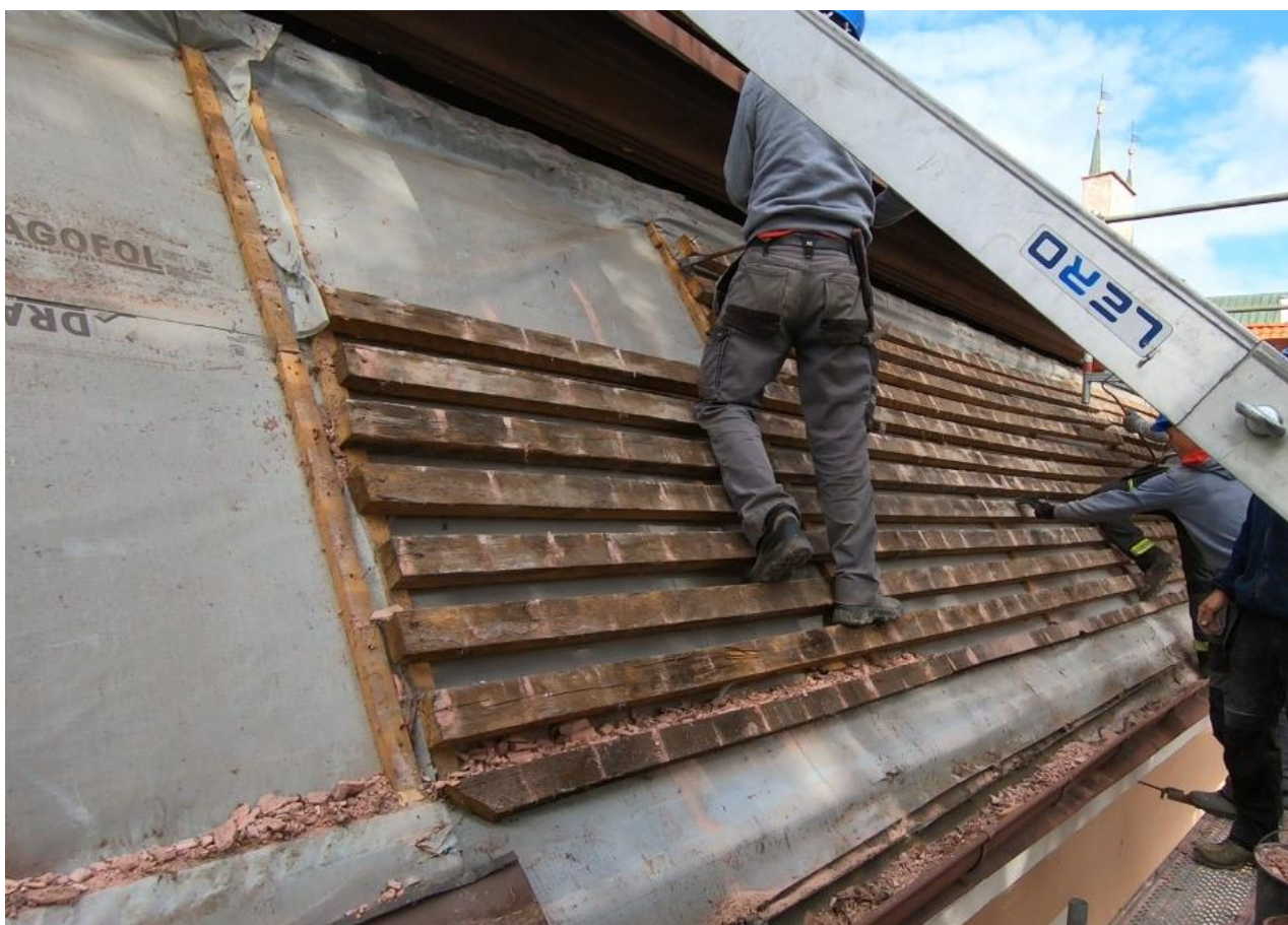
Ilustracja 30. Połąc wschodnia skrzydła zachodniego. Demontaż łączenia.
