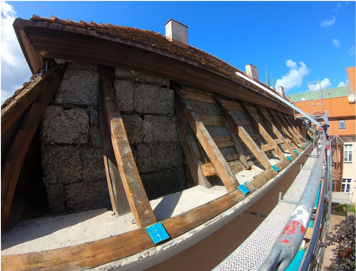
Ilustracja 33. Połączenie wschodniego skrzydła zachodniego. Stan po demontażu łączenia oraz membrany paroprzepuszczalnej.
