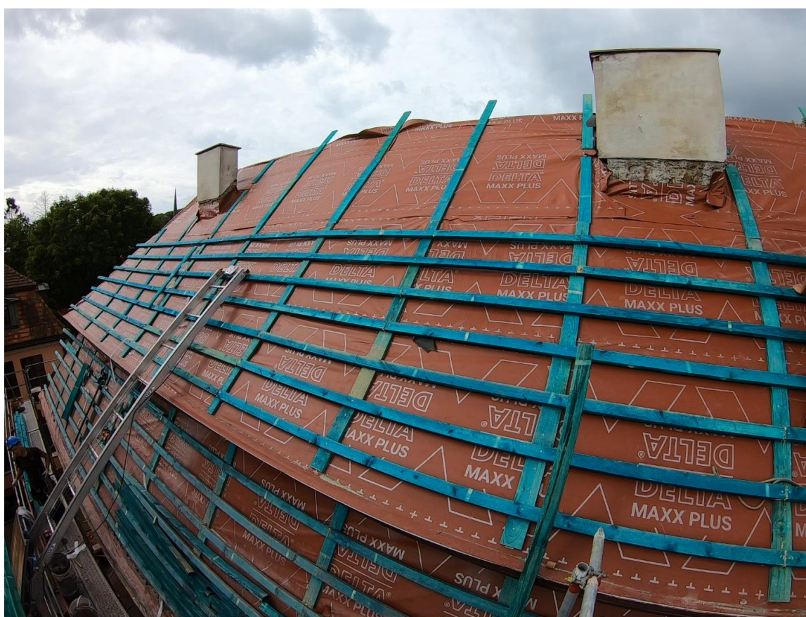
Ilustracja 36. Połąć wschodnia skrzydła zachodniego. Montaż łączenia.
