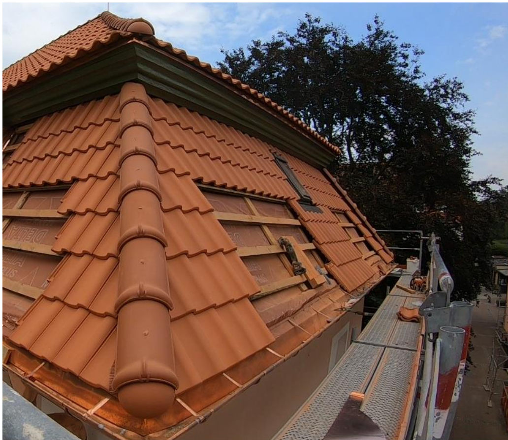
Ilustracja 27. Połączenie południowe skrzydła zachodniego w trakcie montażu dachówek.
