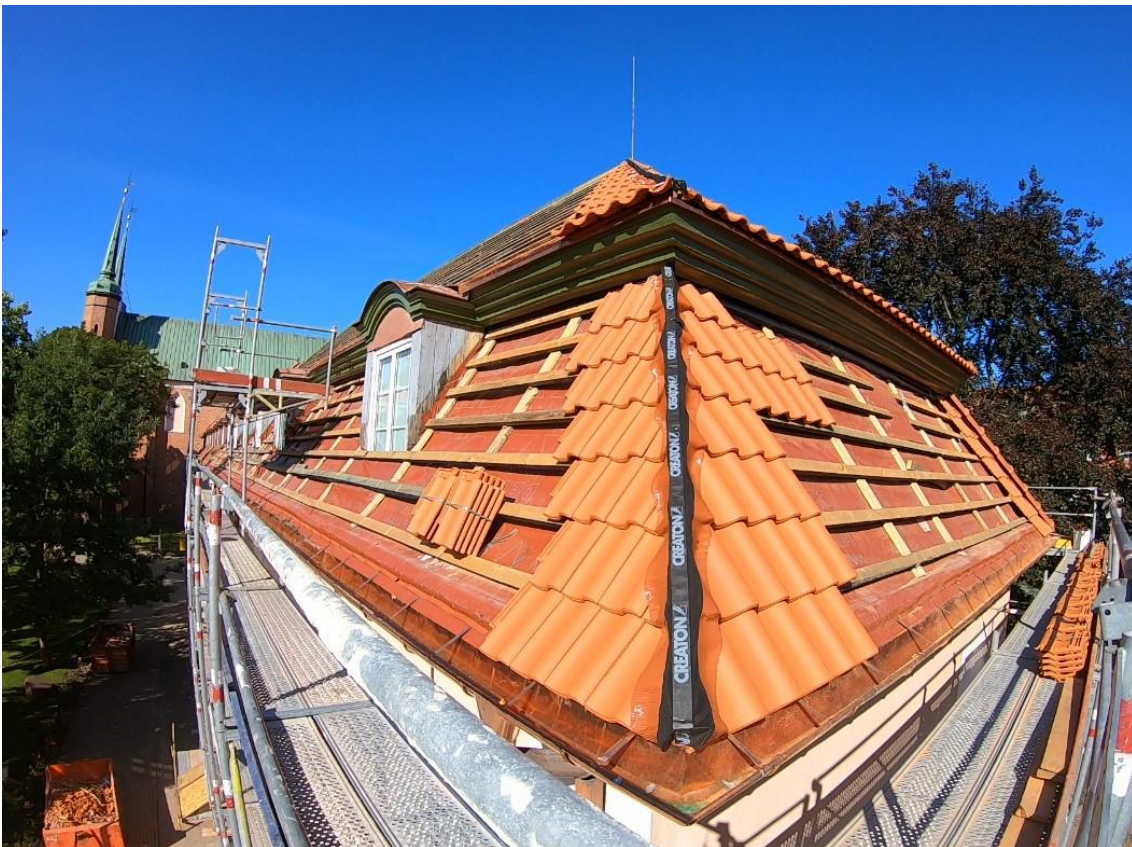
Ilustracja 26. Połacie południowa skrzydła zachodniego. Rozpoczęcie montażu dachówek oraz taśm kalenicowych.
