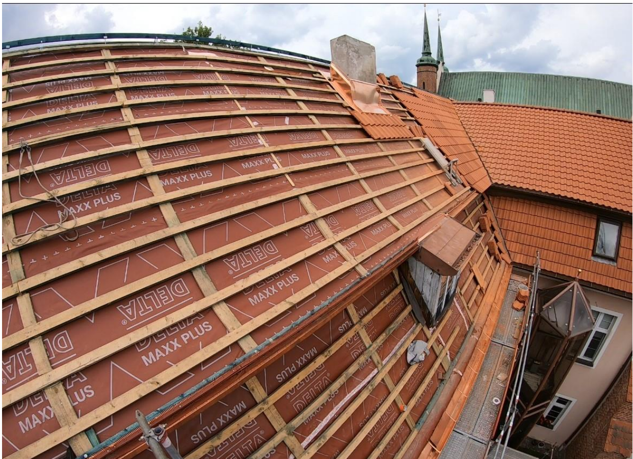
Ilustracja 38. Połąc wschodnia skrzydła zachodniego. Montaż dachówek i obróbek blacharskich.
