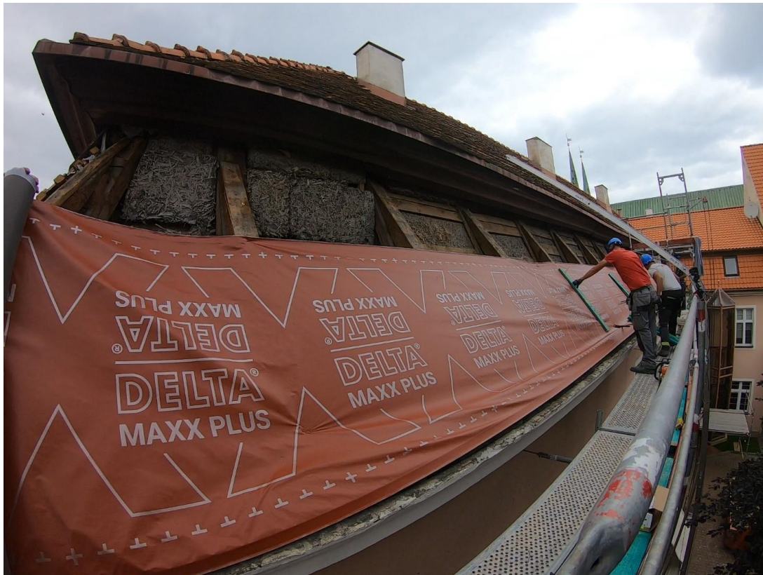
Ilustracja 34. Połączenie wschodniego skrzydła zachodniego. Montaż membrany paroprzepuszczalnej i kontrłaty.
