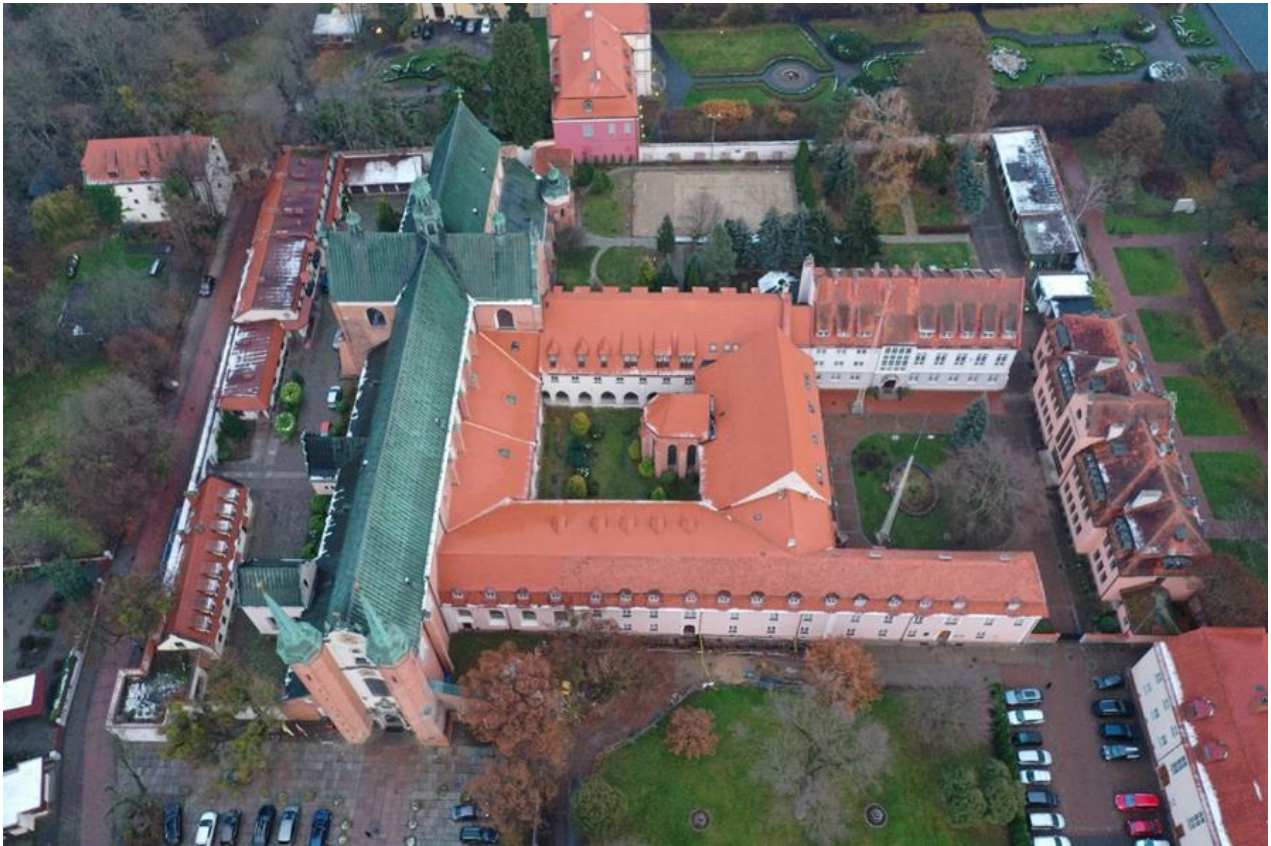
Ilustracja 6. Gdańskie Seminarium Duchowne. Widok ogólny obiektu od zachodu.
