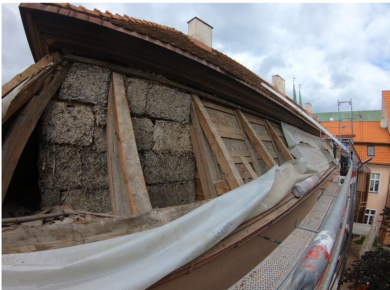
Ilustracja 32. Połąc wschodnia skrzydła zachodniego. Demontaż membrany paroprzepuszczalnej.
