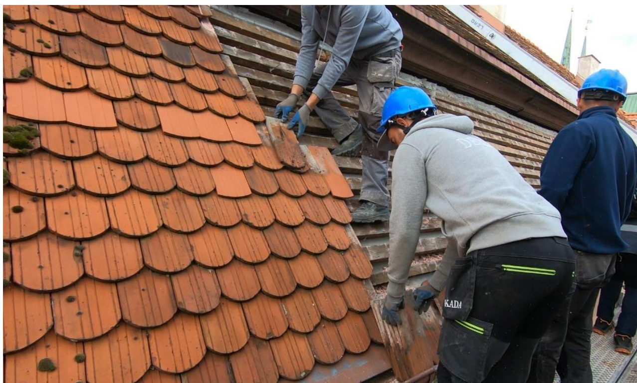
Ilustracja 28. Połączenie wschodnie skrzydła zachodniego. Demontaż dachówek. Widok od południowego wschodu.
