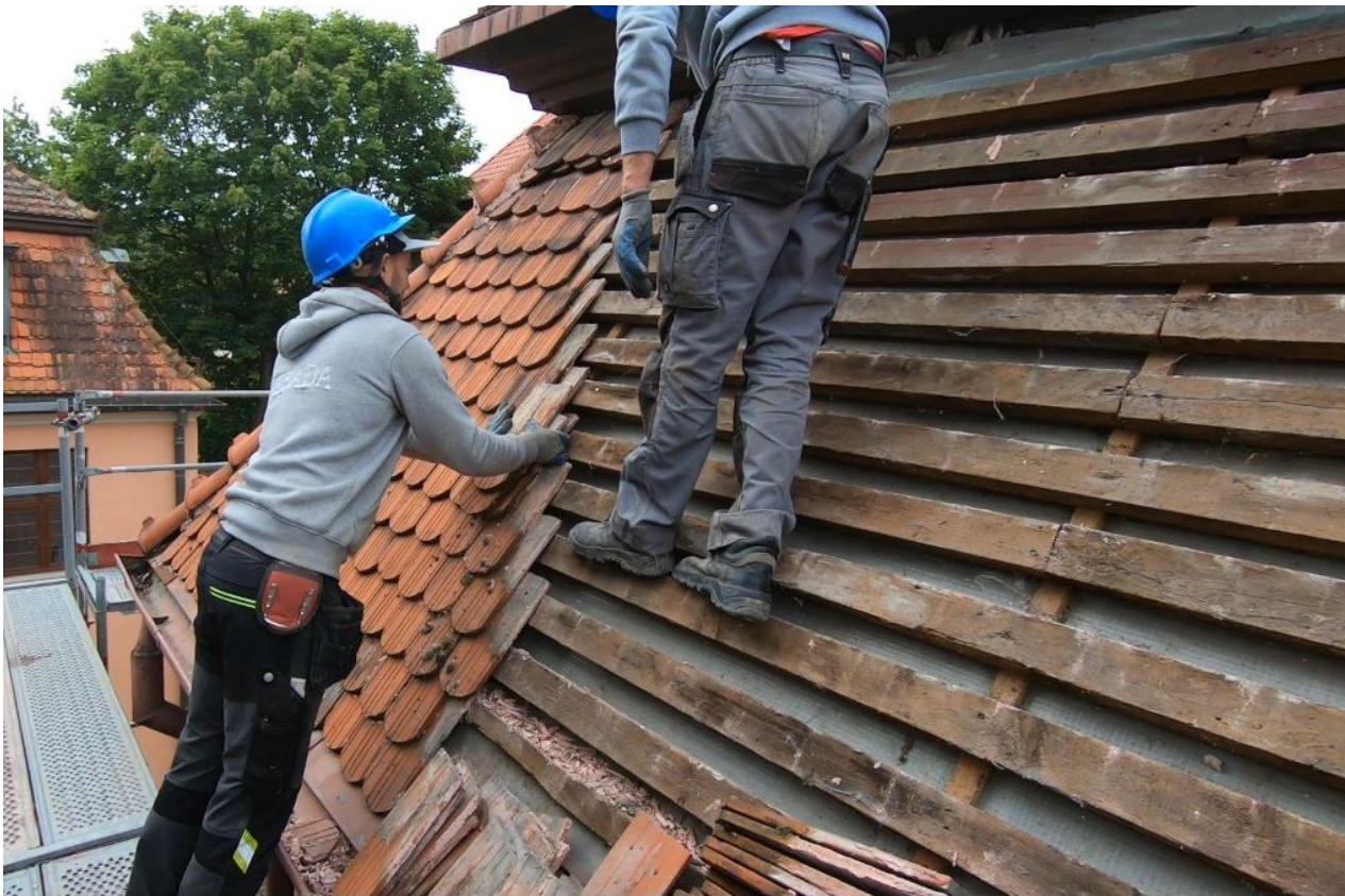
Ilustracja 29. Połąc wschodnia skrzydła zachodniego. Demontaż dachówek. Widok od północnego wschodu.
