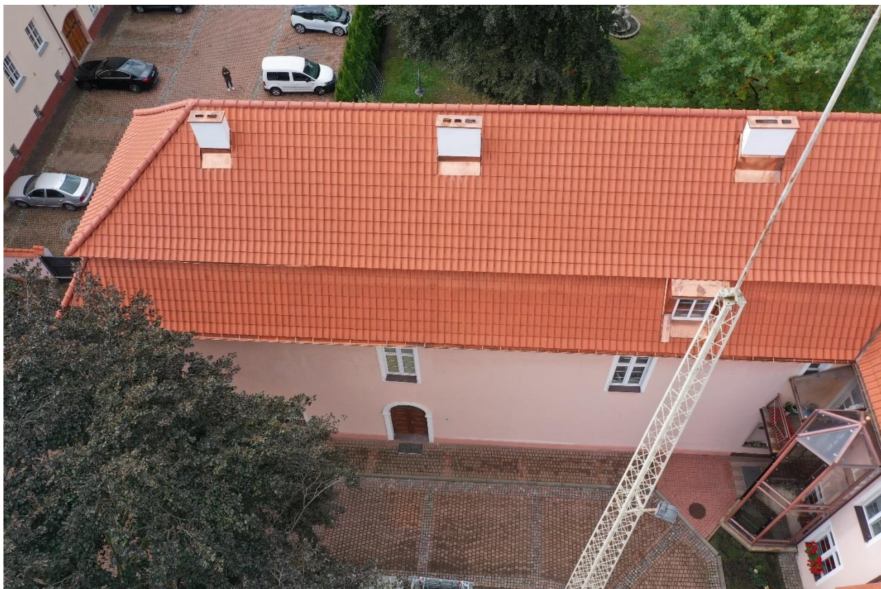
Ilustracja 47. Połąć wschodnia skrzydła zachodniego.
