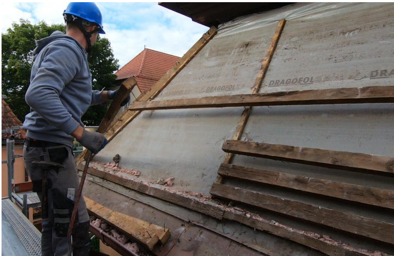
Ilustracja 31. Połąc wschodnia skrzydła zachodniego. Demontaż łącenia.
