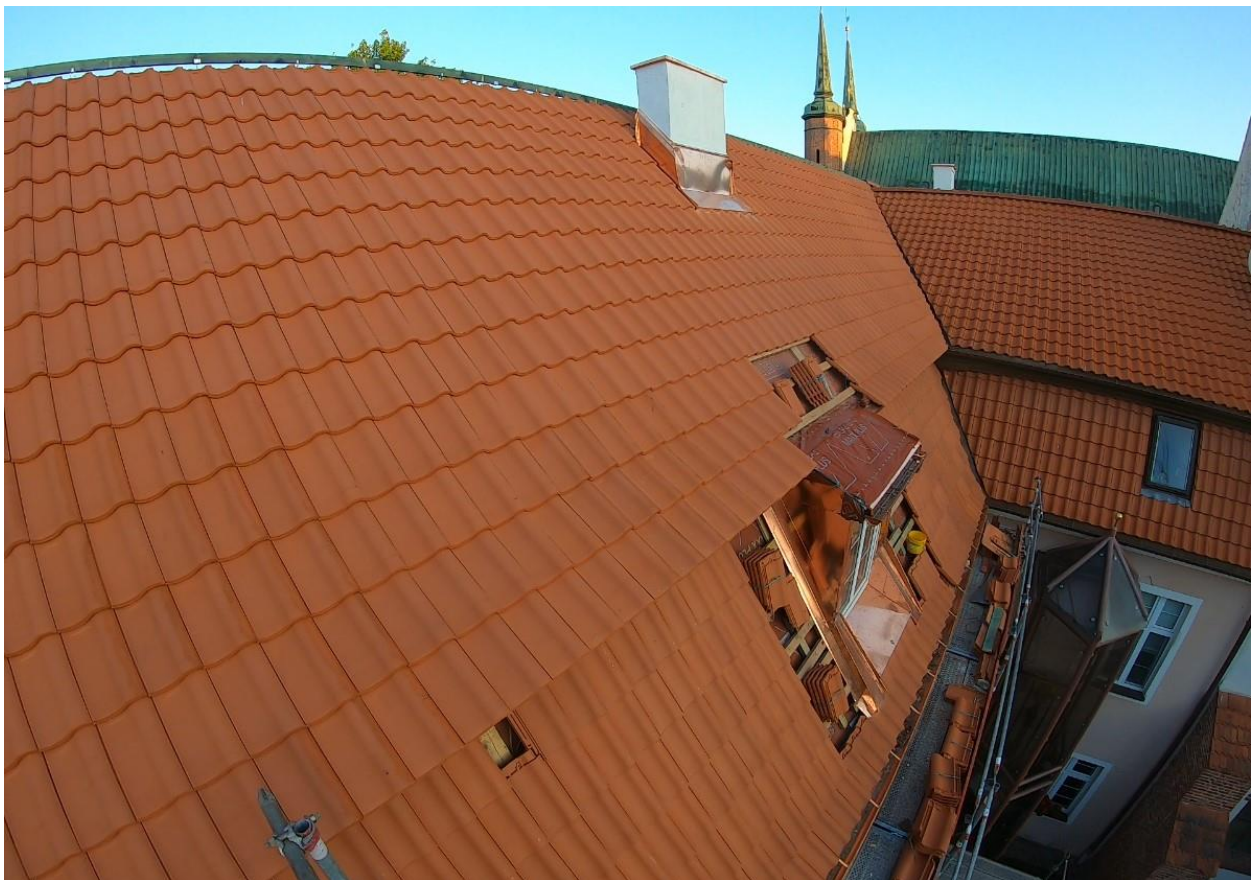
Ilustracja 40. Połączenie wschodniego skrzydła zachodniego. Montaż dachówek i obróbek blacharskich.
