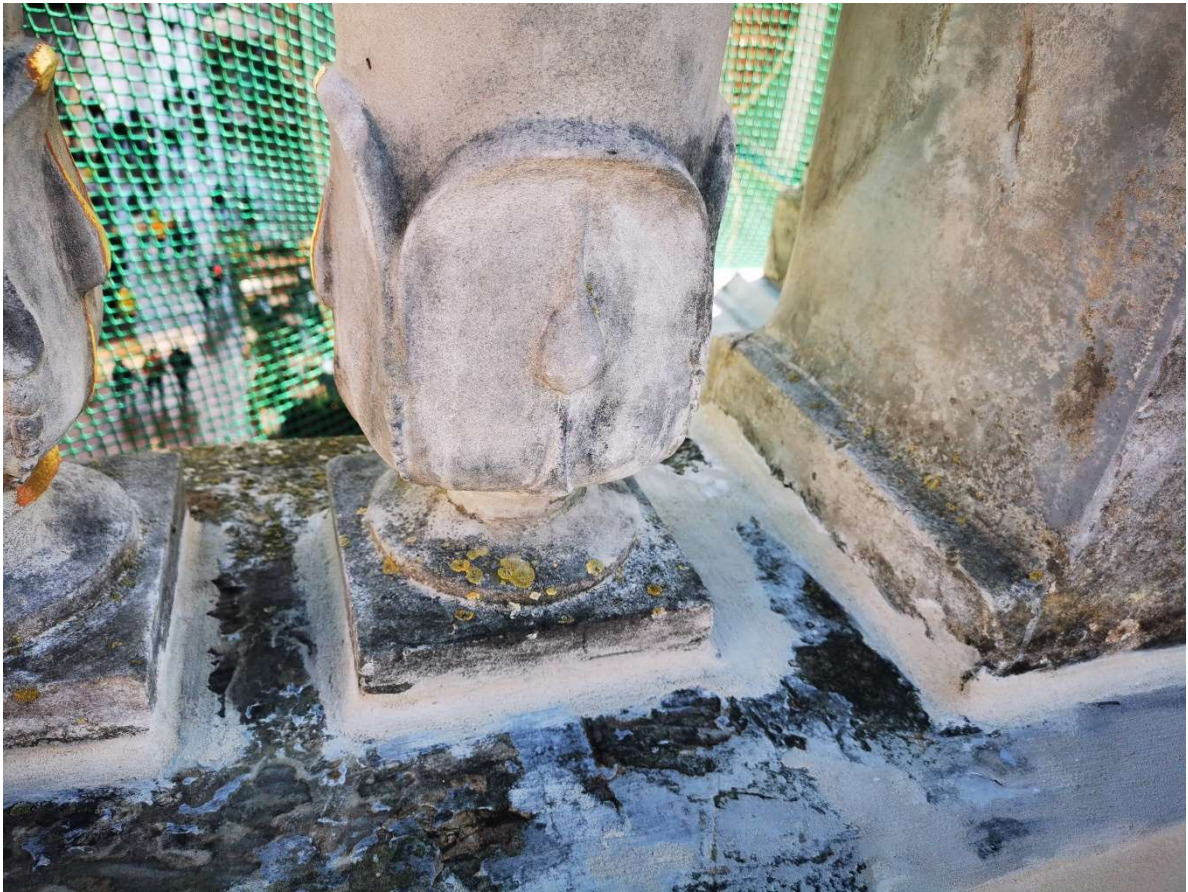
Fot. 29. Tymczasowe zabezpieczenie spoin zaprawą wapienną w oczekiwaniu na kolejny etap prac (fot. M. Gruchała-Więsierska)
