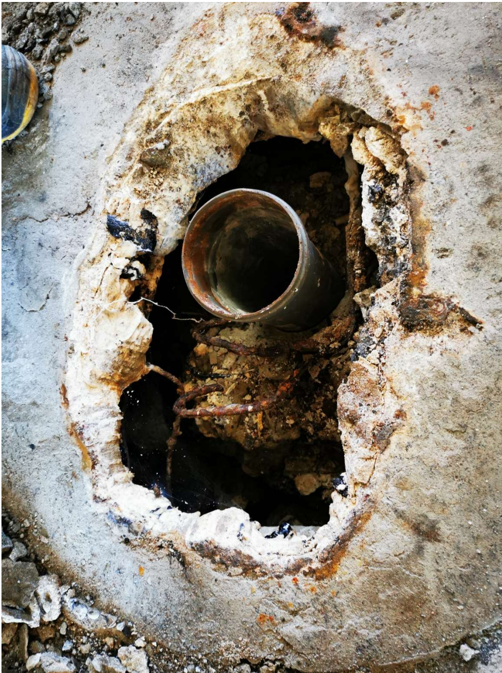
Fot. 10. W trakcie prac – odsłonięty odpływ tarasu po usunięciu wszystkich warstw (fot. M. Gruchała-Więsierska)
