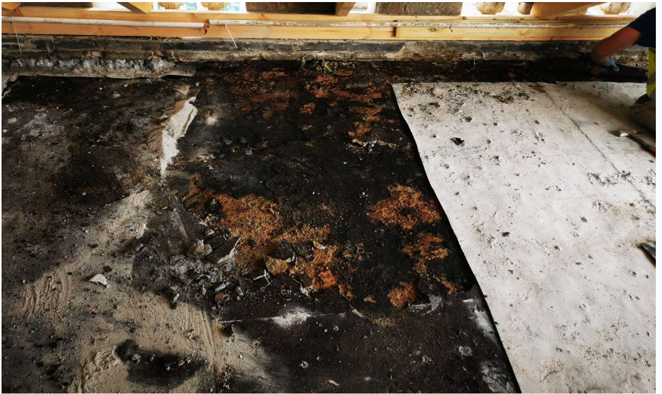
Fot. 9. W trakcie prac – usunięcie wtórnej warstwy bitumicznej (fot. M. Gruchała-Więsierska)
