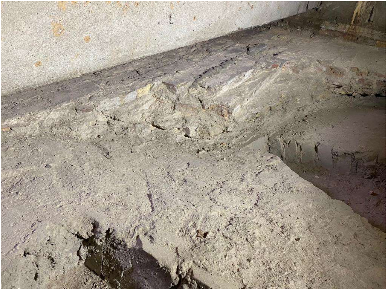
Fot. 15. Sklepienie widoczne po usunięciu betonowych płyt stropowych – miejsce łączenia się odbudowanego sklepienia powojennego z przedwojennym (fot. W. Domagała)
