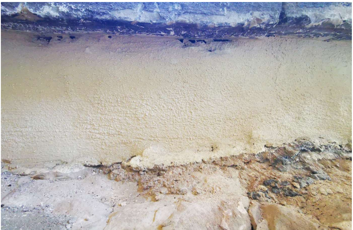
Fot. 12. Cokół w trakcie prac konserwatorskich. Po dokładnym oczyszczeniu, osuszeniu i wzmocnieniu został uzupełniony zaprawą z domieszką związków krzemooorganicznych o wysokiej dyfuzyjności (fot. W. Domagała)
