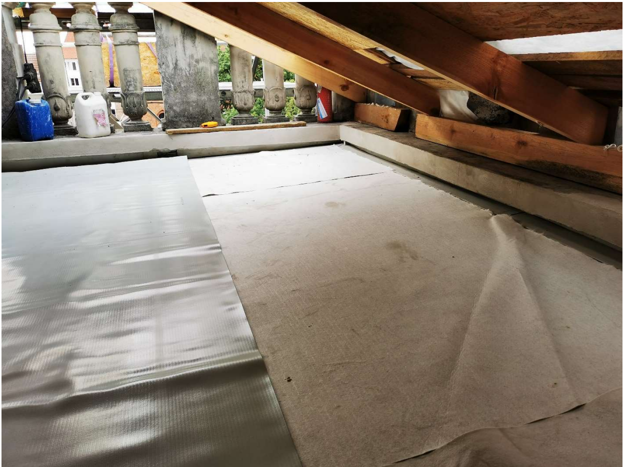
Fot. 23. W trakcie prac – montaż membrany izolacyjnej(fot. M. Gruchała-Więsierska)
