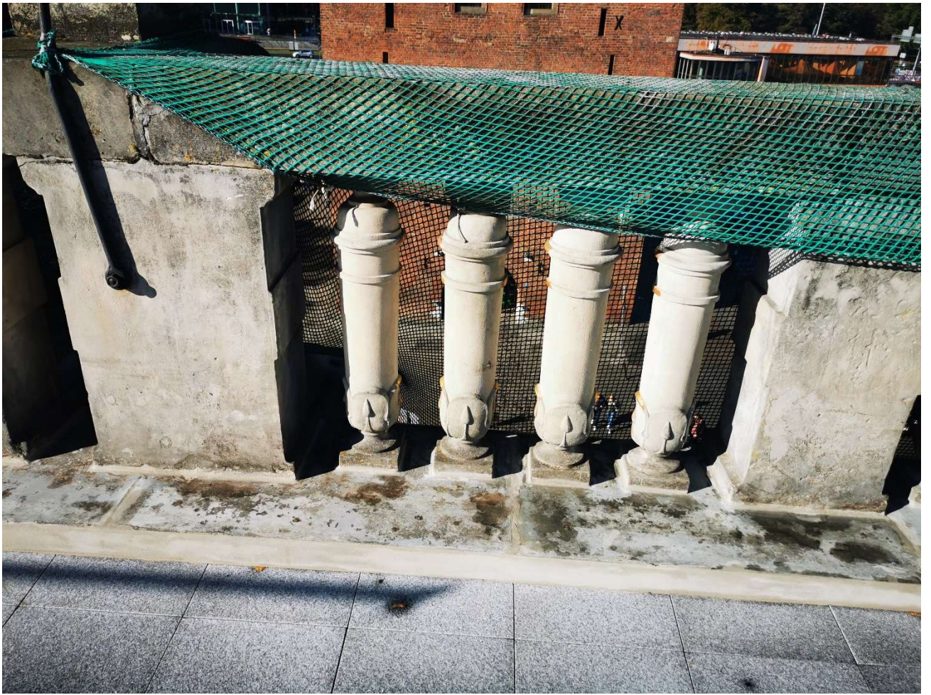
Fot. 30. Cokół po oczyszczeniu, uzupełnieniu ubytków i usunięciu glonów i porostów (fot. M. Gruchała-Więsierska)
