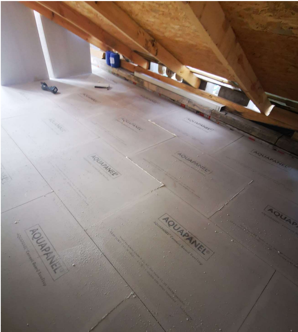
Fot. 22. W trakcie prac - płyty cementowe ułożone na płytach styropianowych (fot. M. Gruchała-Więsierska)
