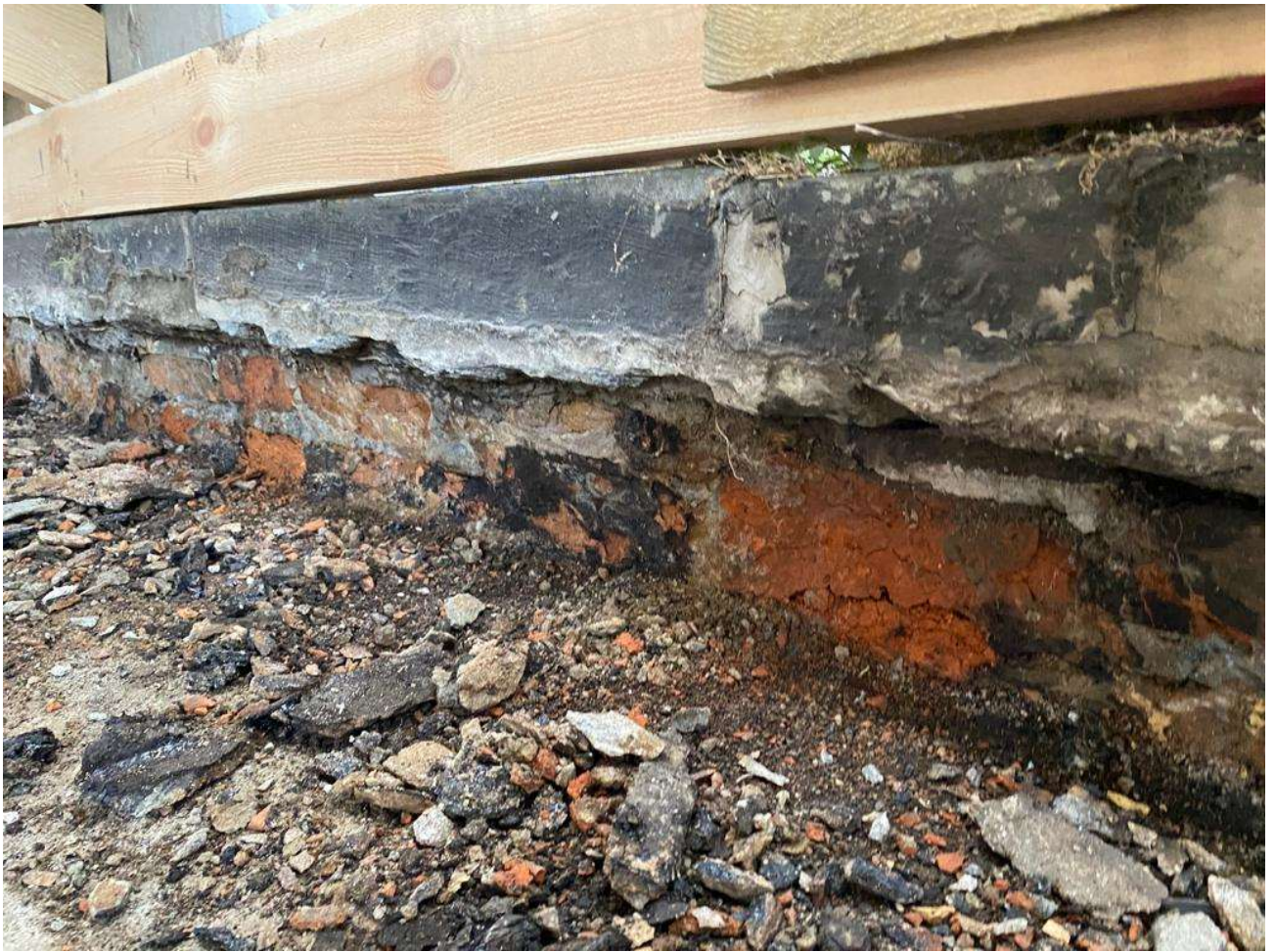
Fot. 6. W trakcie prac - kamienny i ceglany cokół tarasu po usunięciu granitowych płyt oraz betonowej wylewki. Ze względu na silne zawilgocenie kamień i cegła są zdeintegrowane. Po usunięciu warstw nadal utrzymywała się w nich wilgoć (fot. W. Domagała).
