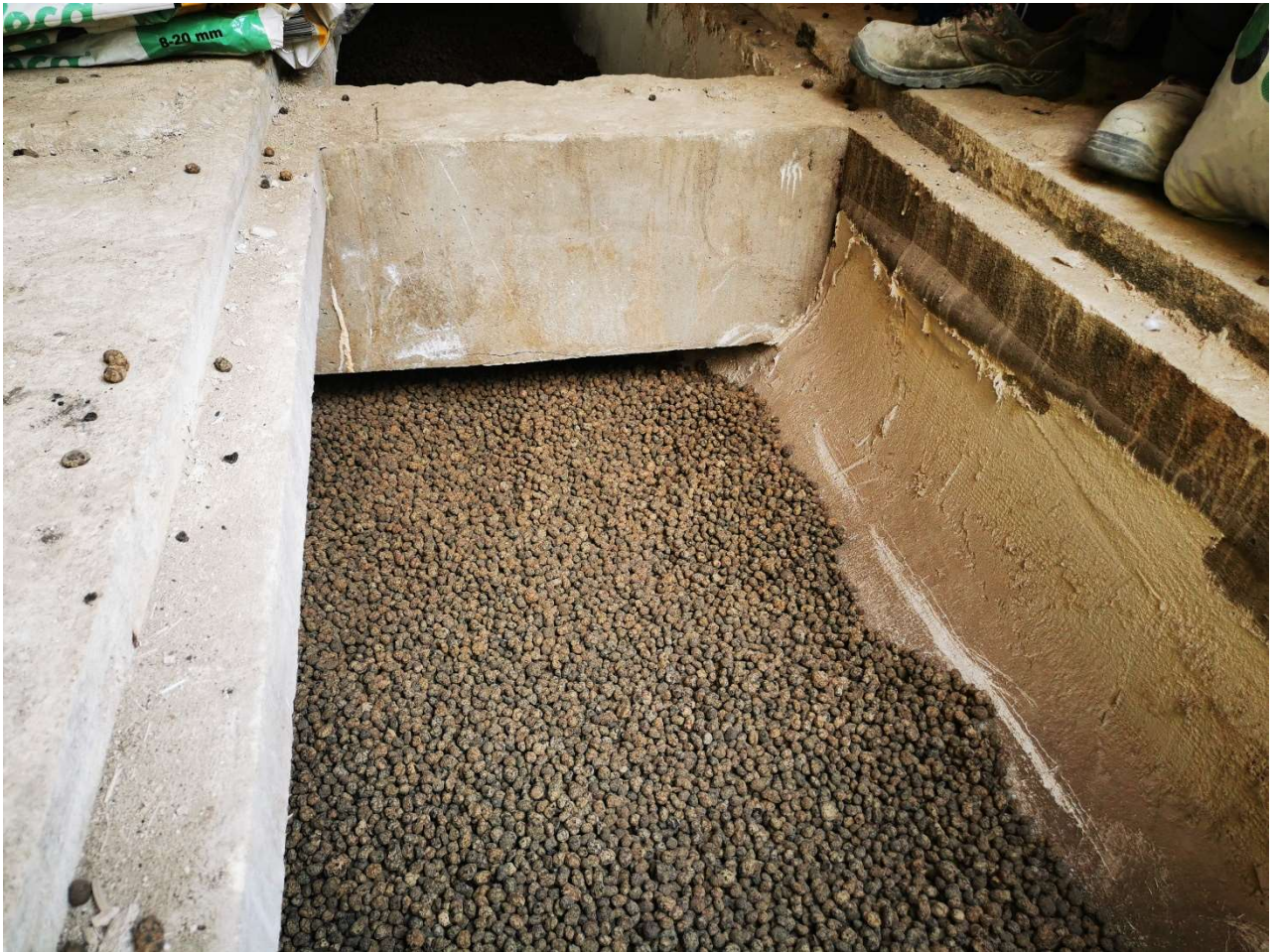
Fot. 19. W trakcie prac- wysypanie keramzytu na powierzchnię sklepień (fot. M. Gruchała-Więsierska)
