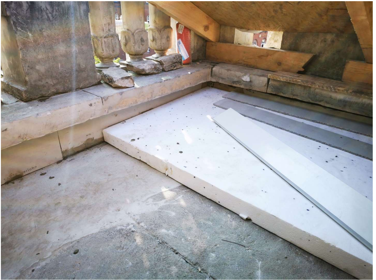
Fot. 21. Ułożenie płyt styropianowych na powierzchnię stropu betonowego (fot. M. Gruchała-Więsierska)
