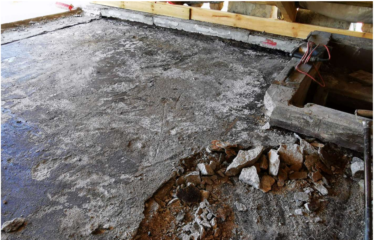
Fot. 8. W trakcie prac – usunięcie wtórnej warstwy betonu (fot. M. Gruchała-Więsierska)
