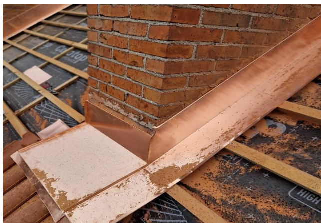
Fot. 5: Szczegół obróbek blacharskich przy kominie
