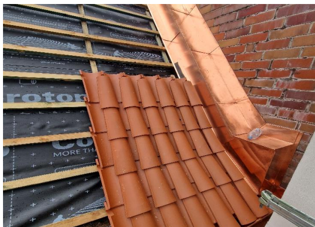
Fot. 14: Próbne ułożenie dachówki na potrzeby odbioru konserwatorskiego – widk ogólny
