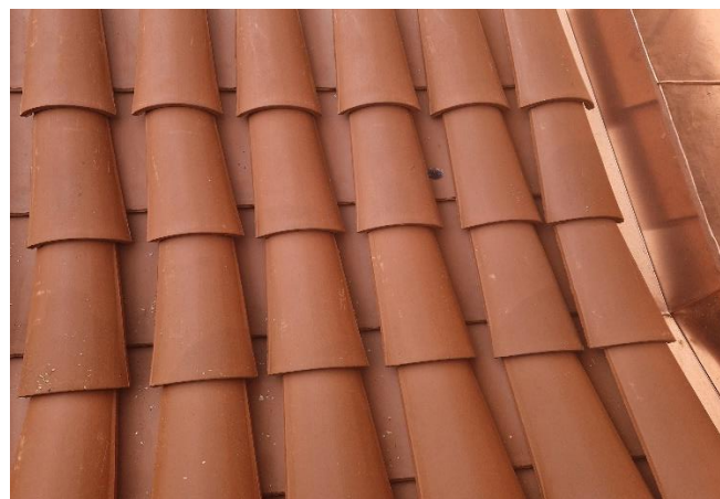
Fot. 15: Próbne ułożenie dachówki na potrzeby odbioru konserwatorskiego – zbliżenie
