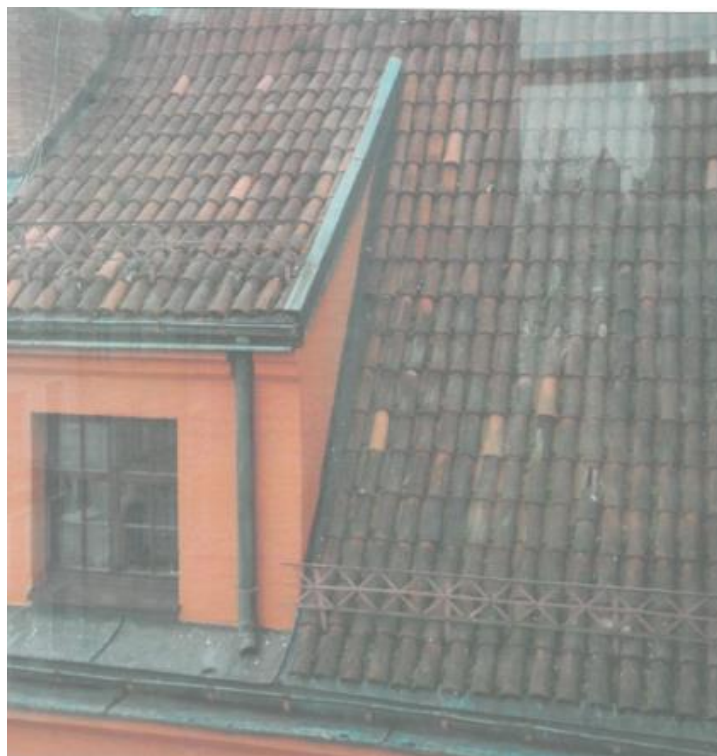
Fot. 3: Połąc zachodnia dachu Bramy Świętojańskiej przed rozpoczęciem prac remontowych: widok strony prawej w zbliżeniu (listopad 2021r.)
