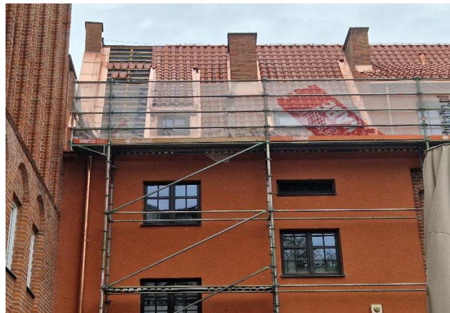
Fot. 17: Strona środkowa i lewa połaci zachodniej dachu budynku Brama Świętojańskiej w chwili układania dachówki mnich – mniszka
