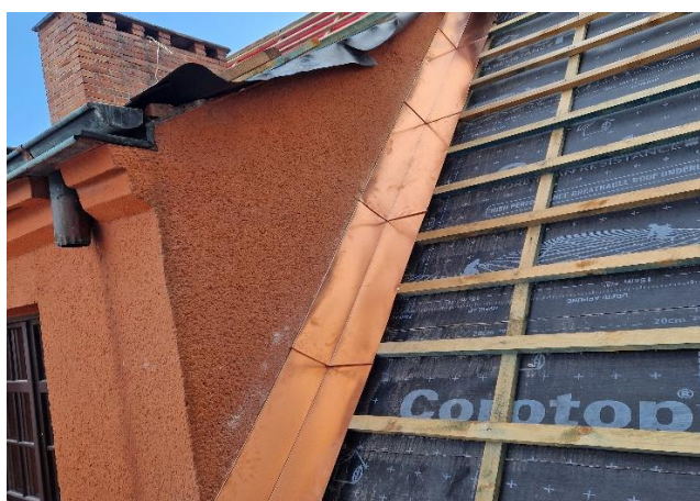
Fot. 8: Obróbki blacharskie oraz ołączenie dachu po stronie prawej mansardy dachowej
