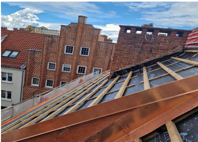
Fot. 10: Widok ołączenia połaci dachowej
