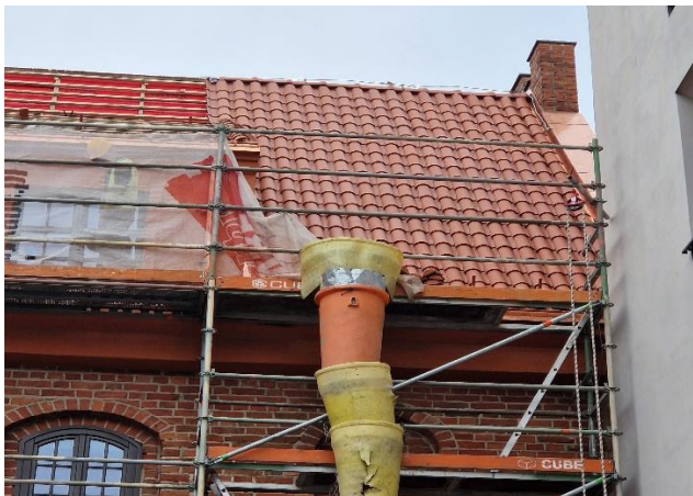
Fot. 16: Strona prawa połaci zachodniej dachu budynku Brama Świętojańskiej w chwili układania dachówki mnich – mniszka
