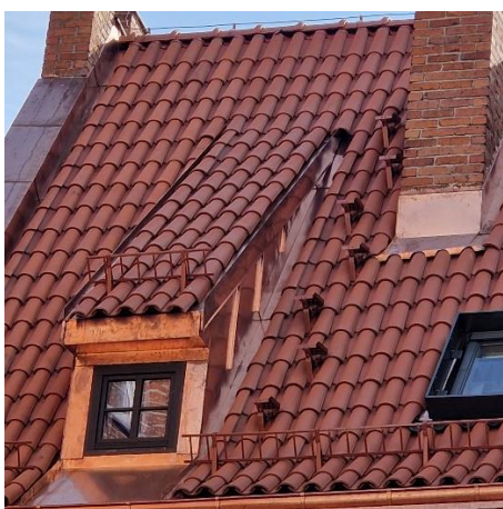
Fot. 18: Strona lewa połaci zachodniej dachu budynku Brama Świętojańskiej po zakończeniu prac remontowych
