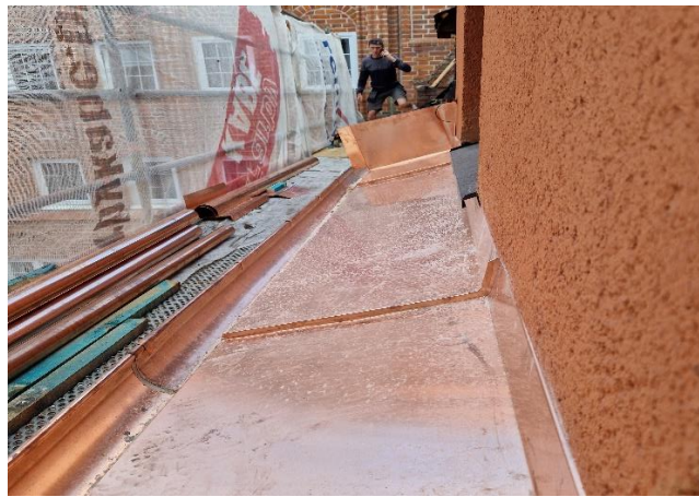
Fot. 11: Szczegół obróbki blacharskiej gzymsu wzdłuż elewacji zachodniej (1)
