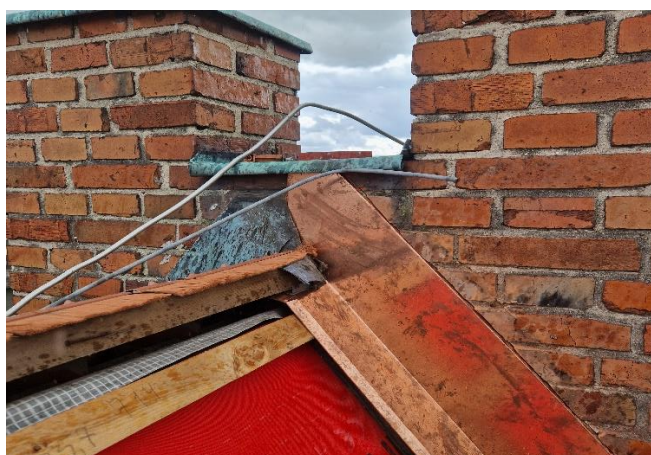
Fot. 7: Układ warstw dachu oraz szczegóły obróbek blacharskich w obszarze kalenicy po stronie prawej zachodniej połaci dachowej
