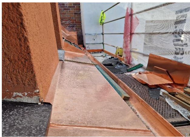
Fot. 12: Szczegół obróbki blacharskiej gzymsu wzdłuż elewacji zachodniej (2)
