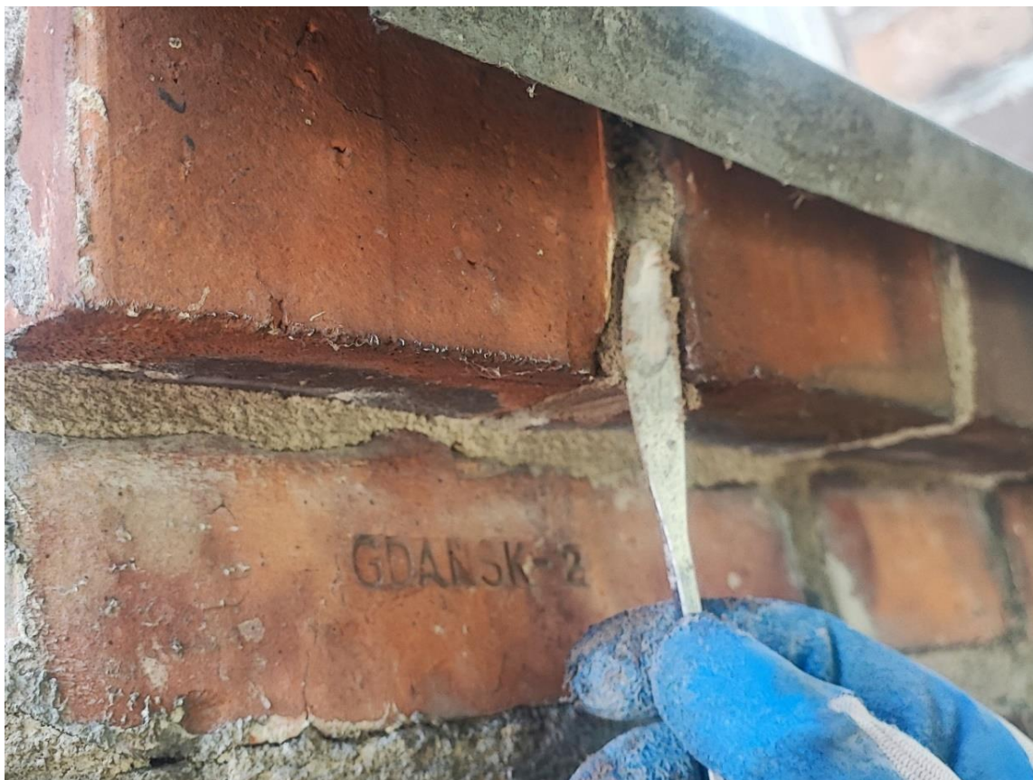
Ilustracja 22. Uzupelnianie spoin
