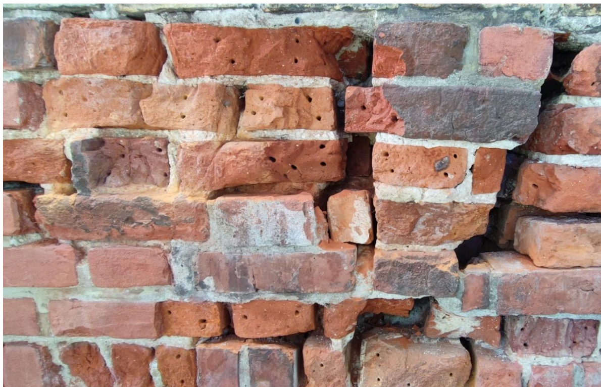
Ilustracja 18. Mur przygotowany do montażu zbrojeń
