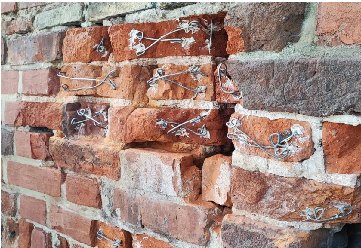
Ilustracja 19. Montaż zbrojeń pod uzupełnienia ubytków
