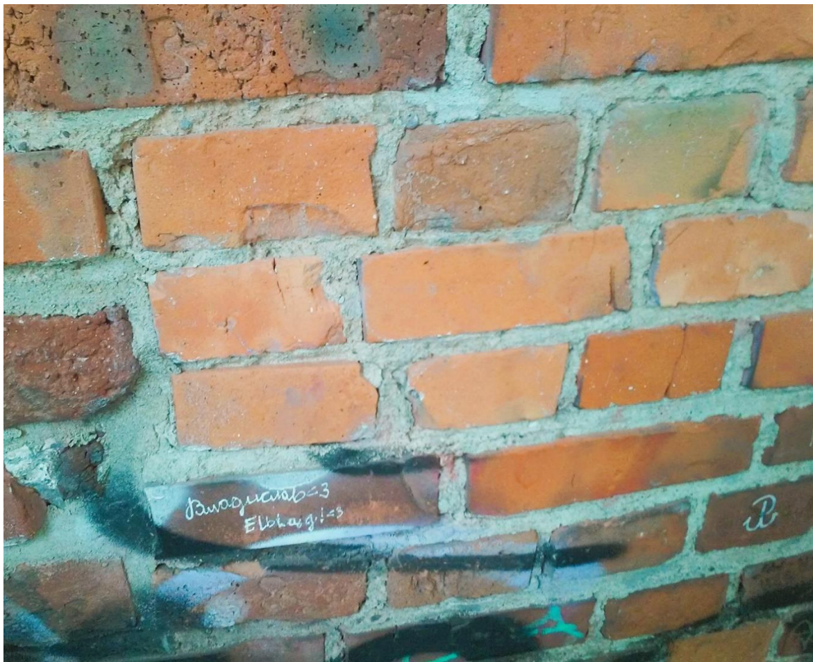
Ilustracja 17. W trakcie usuwania wtórnych nawarstwień (graffiti)
