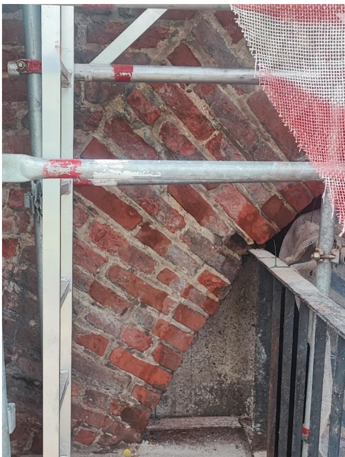
Ilustracja 30. Uzupełniona spoina oraz ubytki w cegle po scalaniu kolorystycznym.
