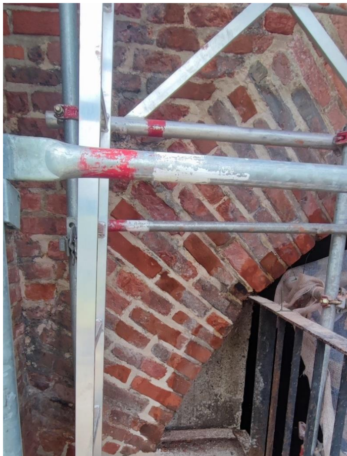
Ilustracja 29. Uzupełniona spoina oraz ubytki w cegle przed scalaniem kolorystycznym.
