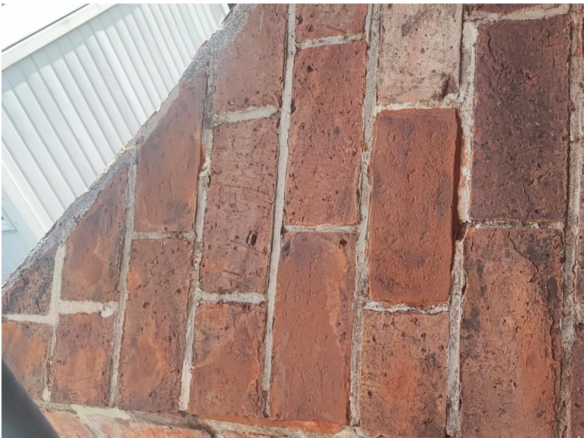
Ilustracja 24. Uzupelnienia ubytków w cegle po scalaniu kolorystycznym
