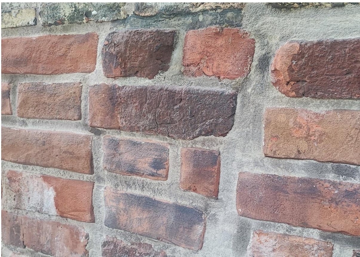
Ilustracja 28. Uzupelniona spoina po scalaniu kolorystycznym
