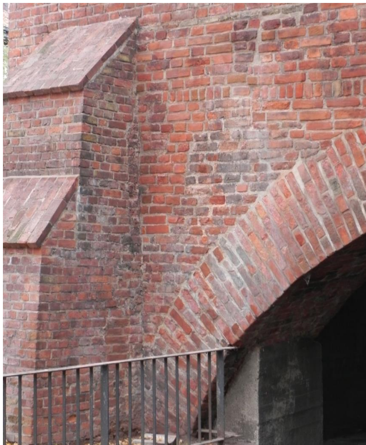
Ilustracja 37. Elewacja po pracach konserwatorskich
