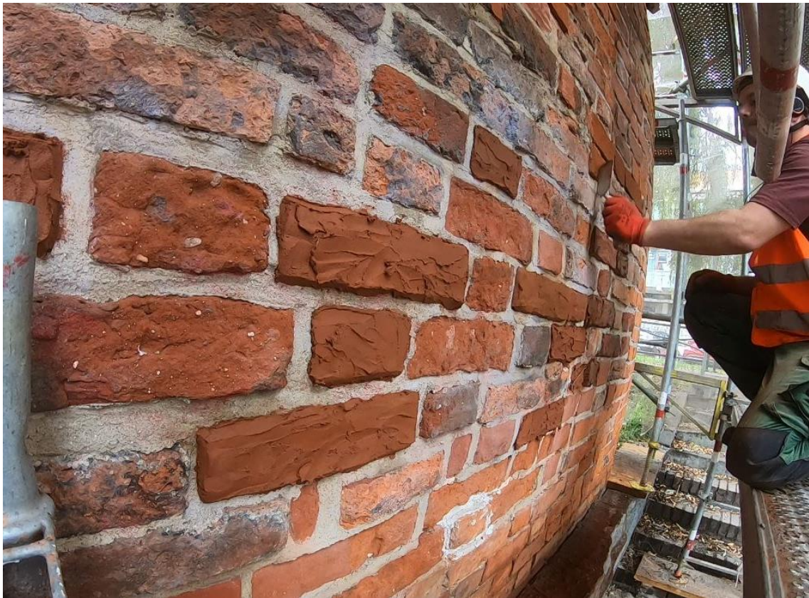
Ilustracja 21. Uzupelnianie ubytków w ceglach
