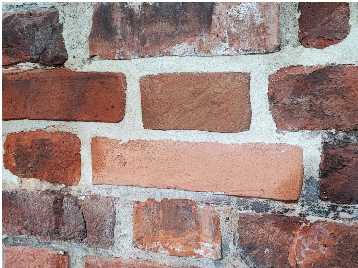
Ilustracja 25. Uzupełnienia ubytków cegle przed scalaniem kolorystycznym
