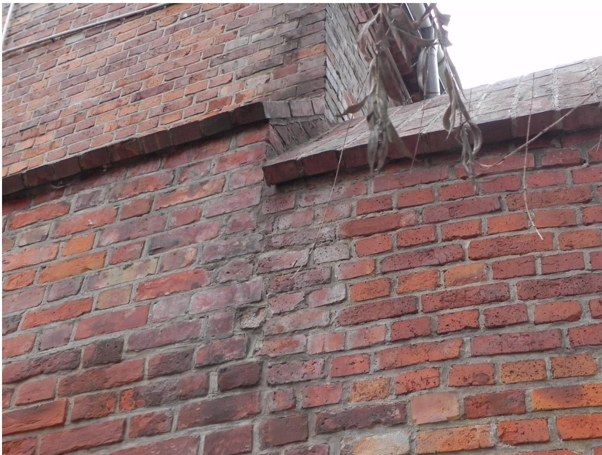
Ilustracja 35. Elewacja po pracach konserwatorskich
