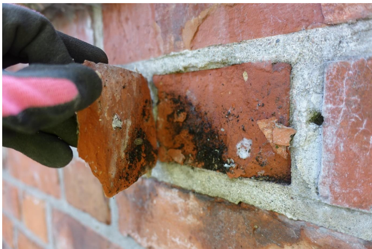
Ilustracja 14. Usuwanie luźnych elementów z elewacji
