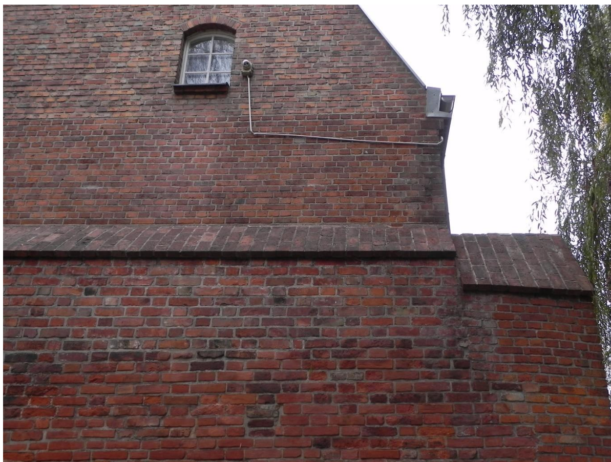
Ilustracja 36. Elewacja po pracach konserwatorskich
