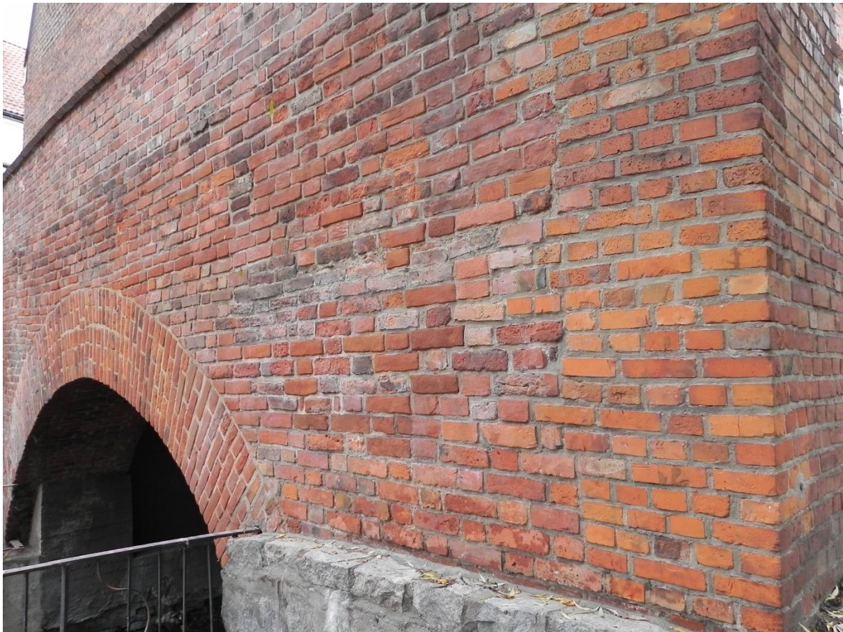
Ilustracja 33. Elewacja po pracach konserwatorskich
