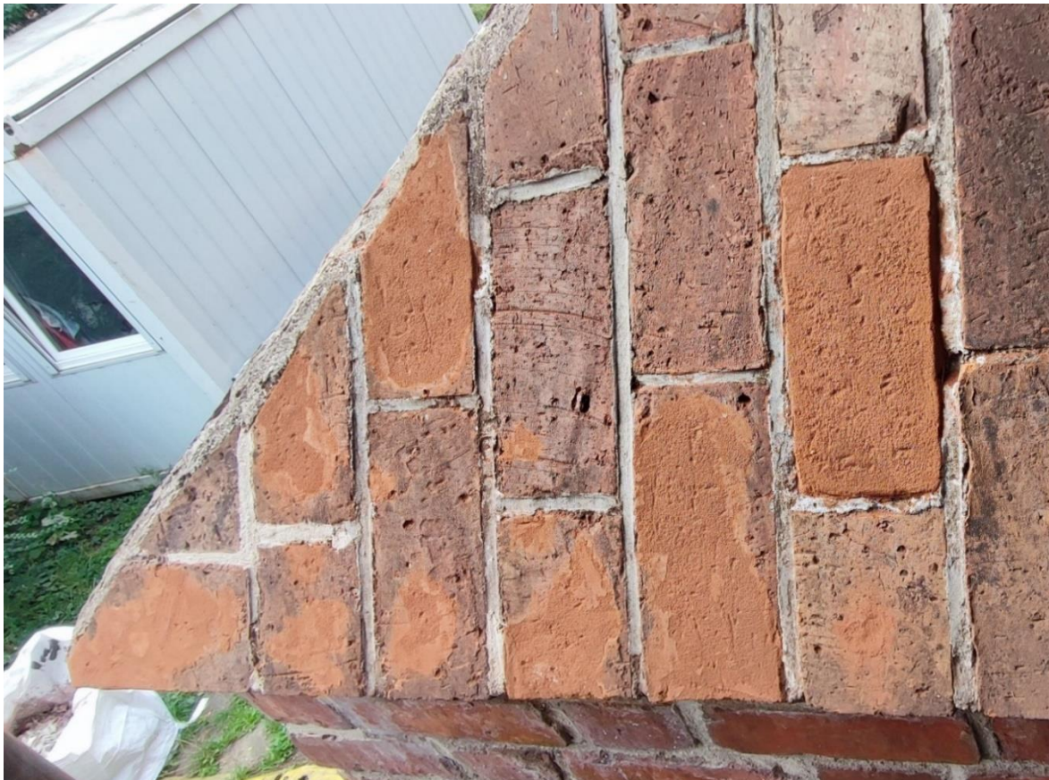
Ilustracja 23. Uzupelnienia ubytków w cegle przed scalaniem kolorystycznym
