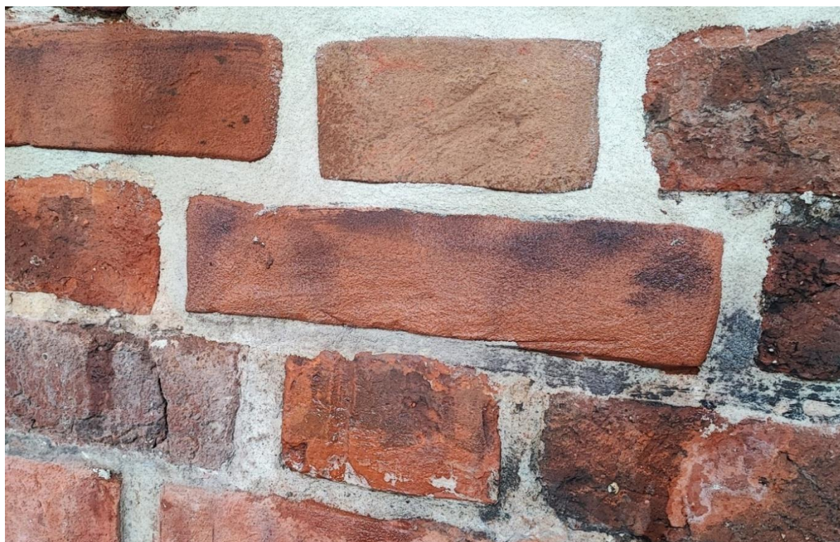
Ilustracja 26. Uzupełnienia ubytków w cegle po scalaniu kolorystycznym
