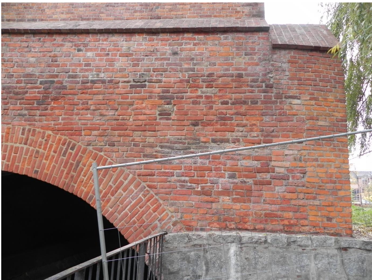
Ilustracja 34. Elewacja po pracach konserwatorskich
