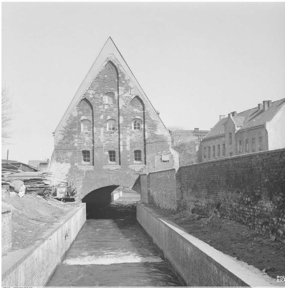
Ilustracja 4. Mały Młyn po przeprowadzeniu powojennej odbudowy, 1969 r. [źródło:polska-org.pl]
