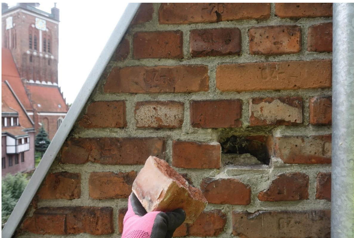
Ilustracja 13. Elewacja wschodnia. Demontaż luźnych elementów
